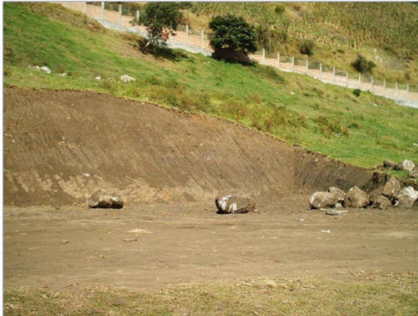
**Figura 47: Material reemplazado para facilitar el acceso de volquetas**
