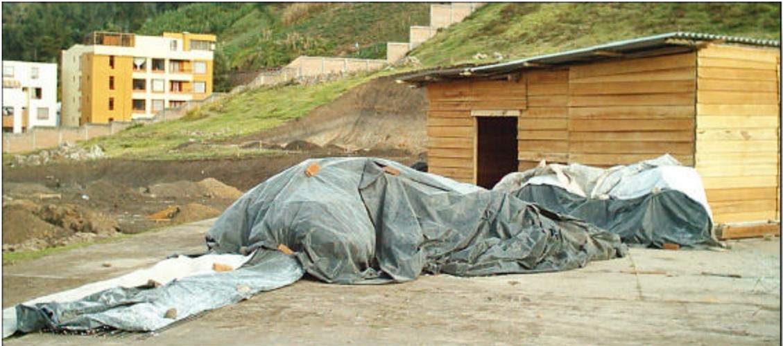
**Figura 95: Protección del acero de refuerzo con respecto a la humedad**
