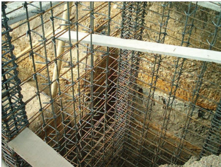
**Figura 111: Intersección de vigas de cimentación con pantallas y columnas en el Bloque 4**
