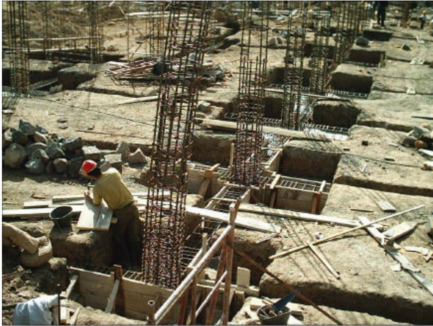
**Figura 102: Disposición de la formaleta en vigas con junta de dilatación**
