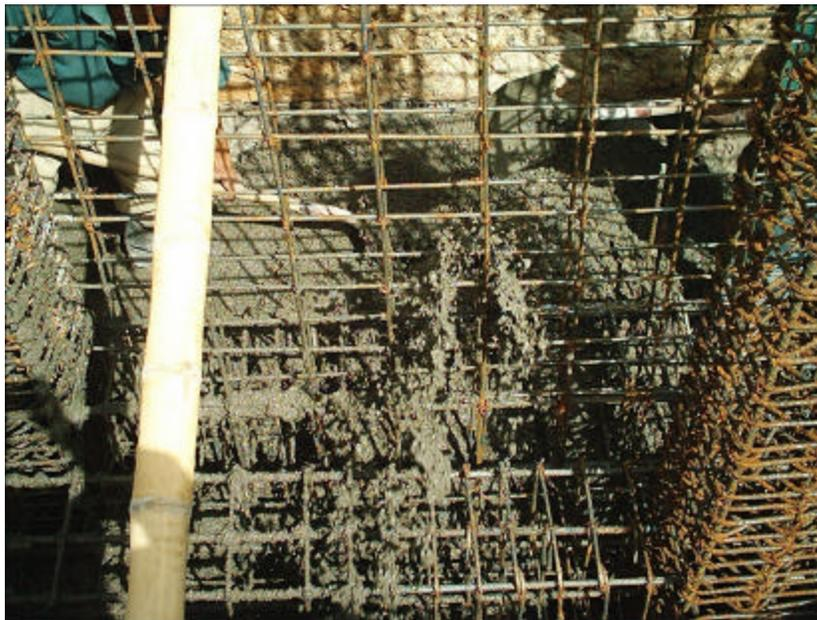
**Figura 116: Detalle del armado de pantallas**
