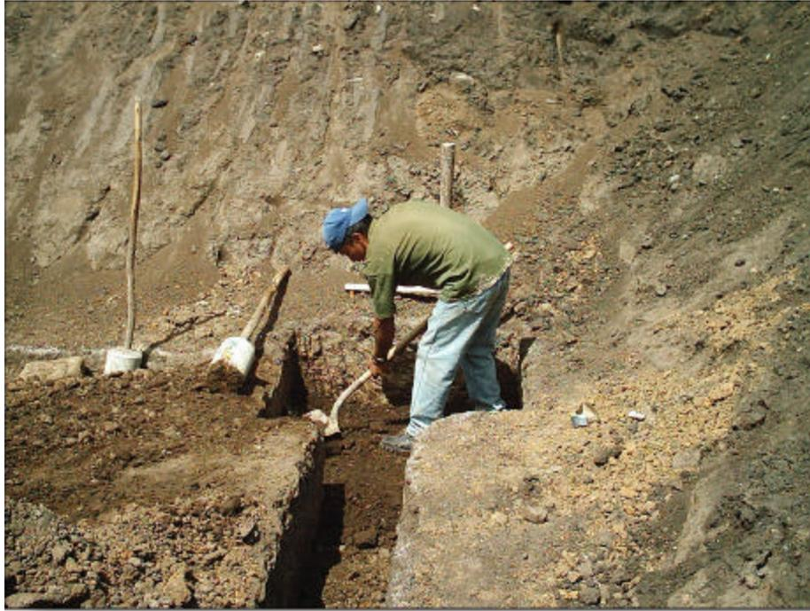
**Figura 74: Detalle de la compactación manual**
