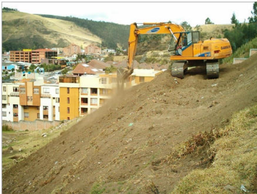
**Figura 29: Descargue del talud con retroexcavadora**
