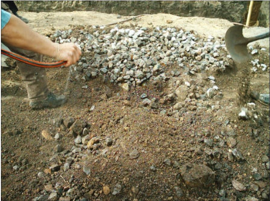
**Figura 77: Mezcla homogénea de los agregados**
