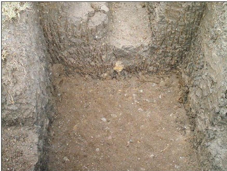
**Figura 69: Detalle 1 de la excavación de vigas**
