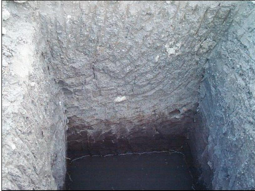
**Figura 58: Aguas negras infiltradas en la zapata A1 de Talleres**
