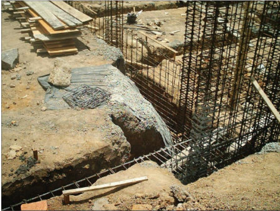
**Figura 117: Armado de viguetas bajo los muros de fachada**
