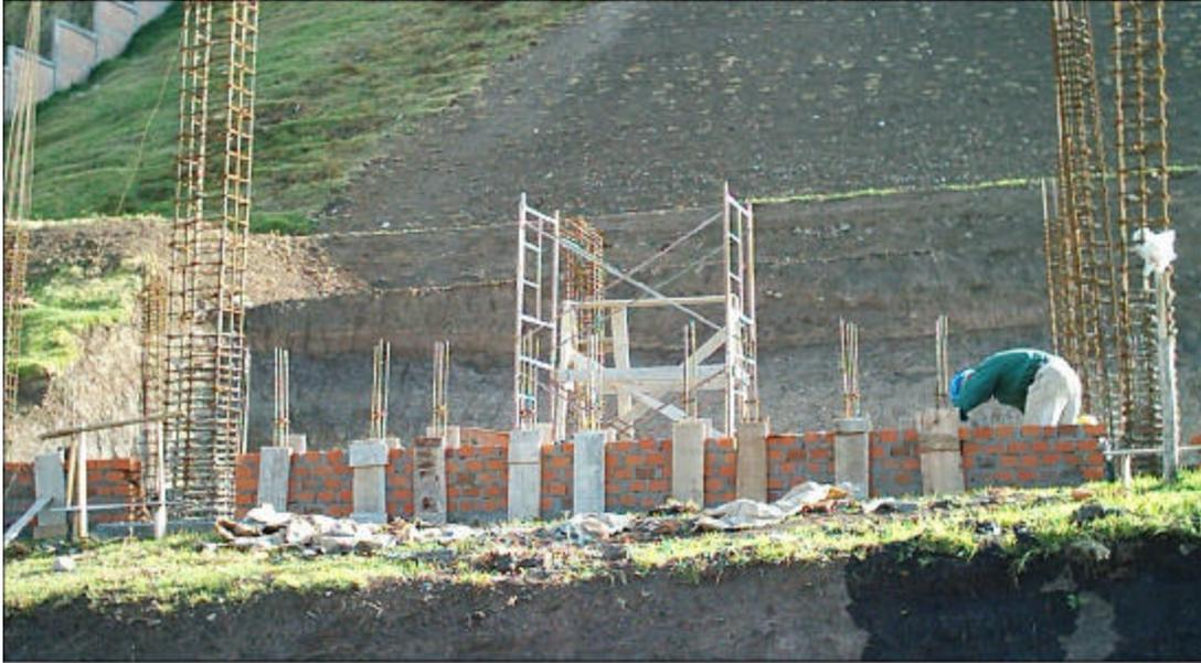
**Figura 119: Figurado de Ménsulas**
