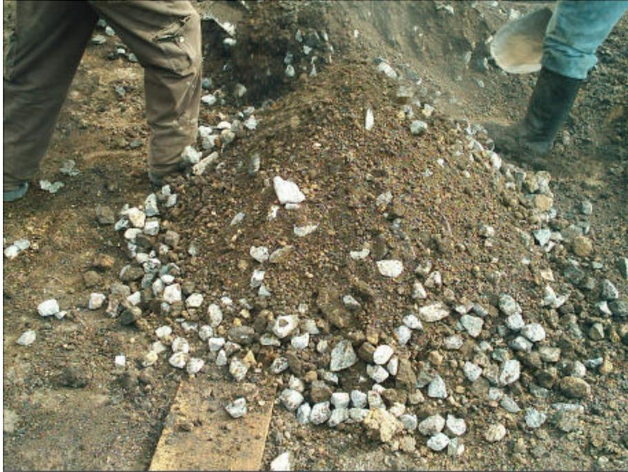
**Figura 78: Distribución del material a compactar en la zapata**
