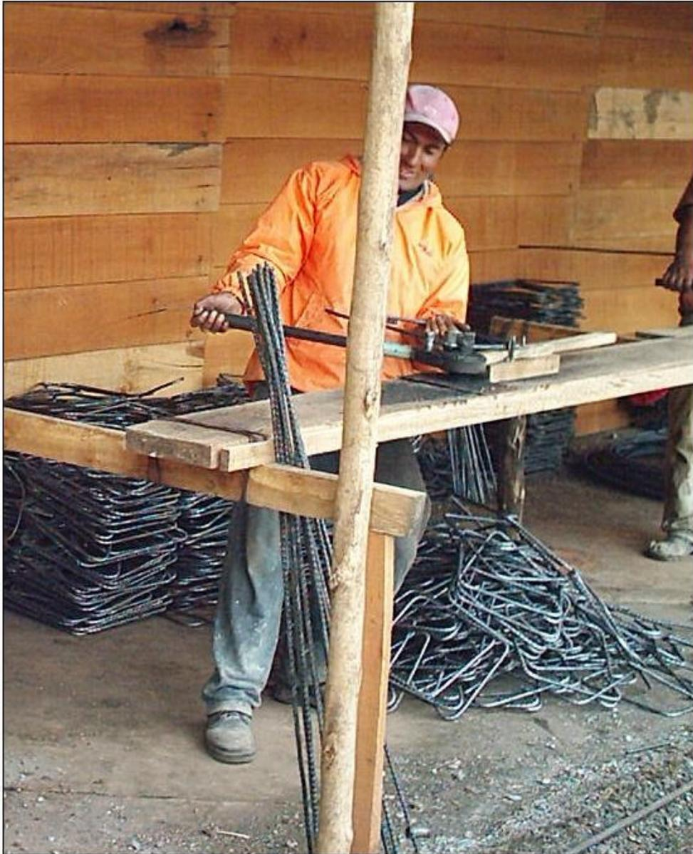
**Figura 91: Corte del alambre de amarre con cizalla**
