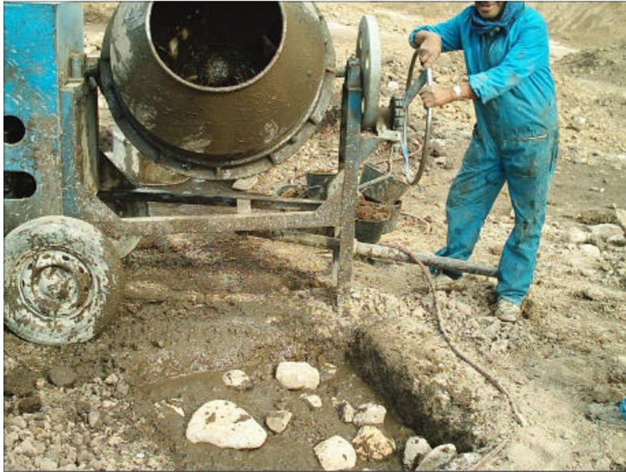
**Figura 72: Detalle de zapatas rellenadas con suelo cemento fluido**
