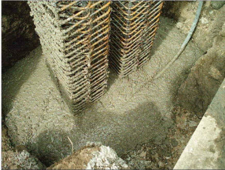
**Figura 100: Armado de parrillas bajo las pantallas**
