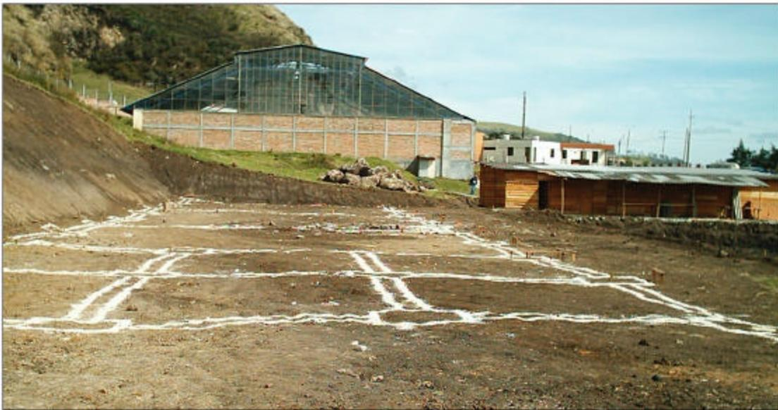
**Figura 21: Proyección de los ejes a los bloques inferiores**
