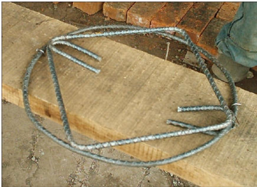
**Figura 104: Disposición de ganchos intercalados**
