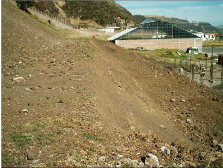
**Figura 38: Sustitución del material en el acceso al campamento**
