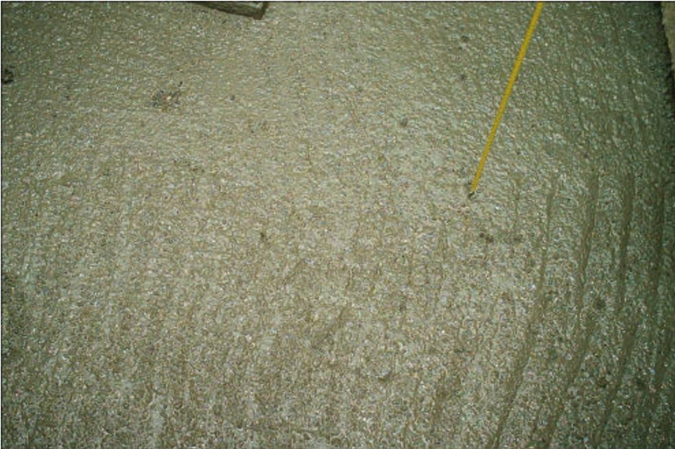
**Figura 87: Curado a partir de las seis horas siguientes a la fundición**
