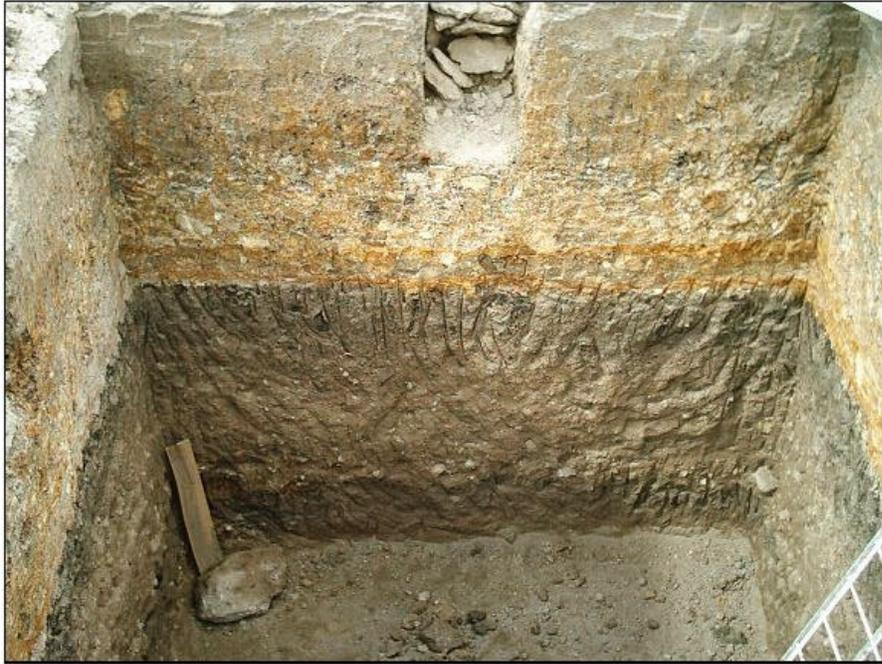
**Figura 62: Detalle de la excavación de la zapata J-2A**
