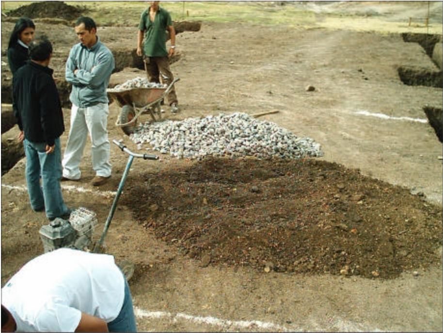
**Figura 76: Riego del material ligante hasta el punto de la humedad óptima**
