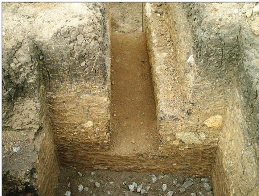
**Figura 70: Detalle 2 de la excavación de vigas**
