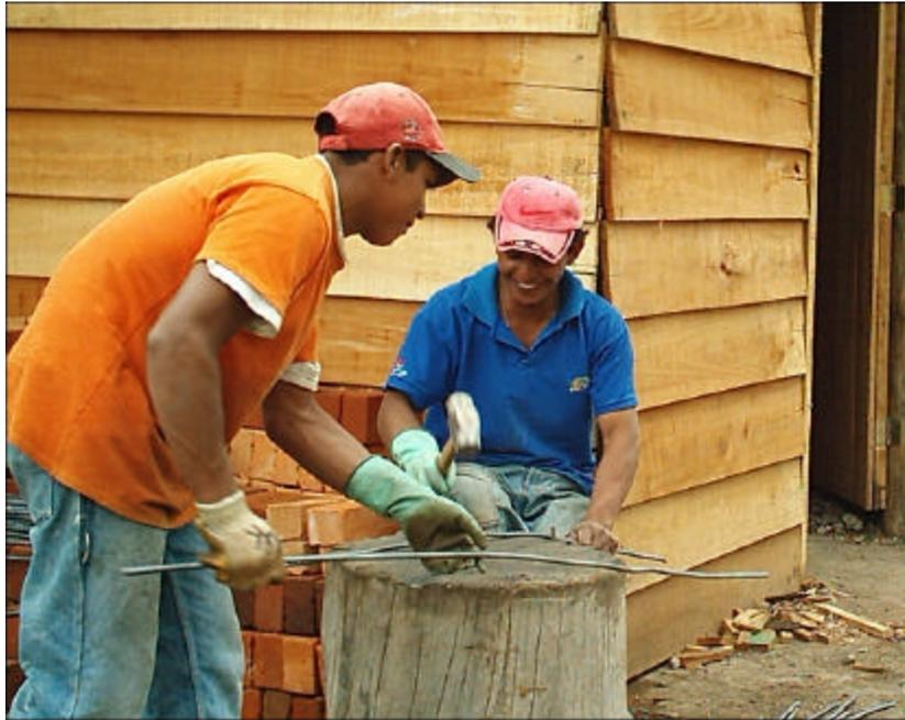
**Figura 89: Corte de Acero con cizalla**
