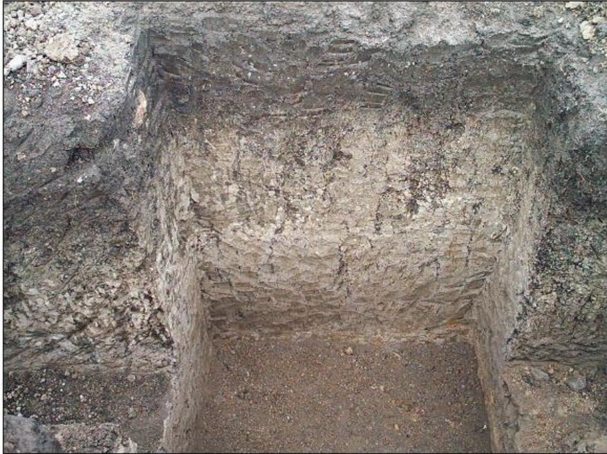
**Figura 66: Arcilla color gris encontrada en la zapata A1 del Bloque 1**
