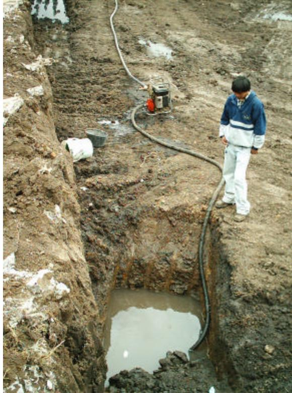
**Figura 51: Encharcamiento producido por la infiltración de agua**
