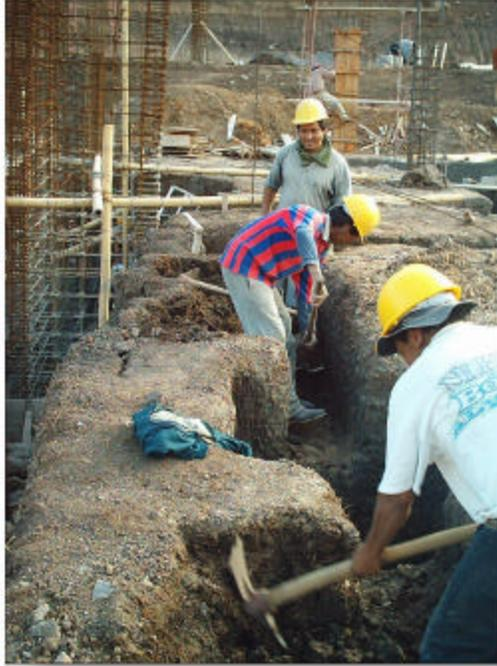
**Figura 64: Excavación de zapatas en el bloque 5**
