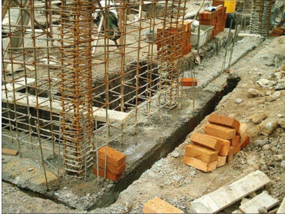
**Figura 122: Sobrecimiento bajo los muros internos**
