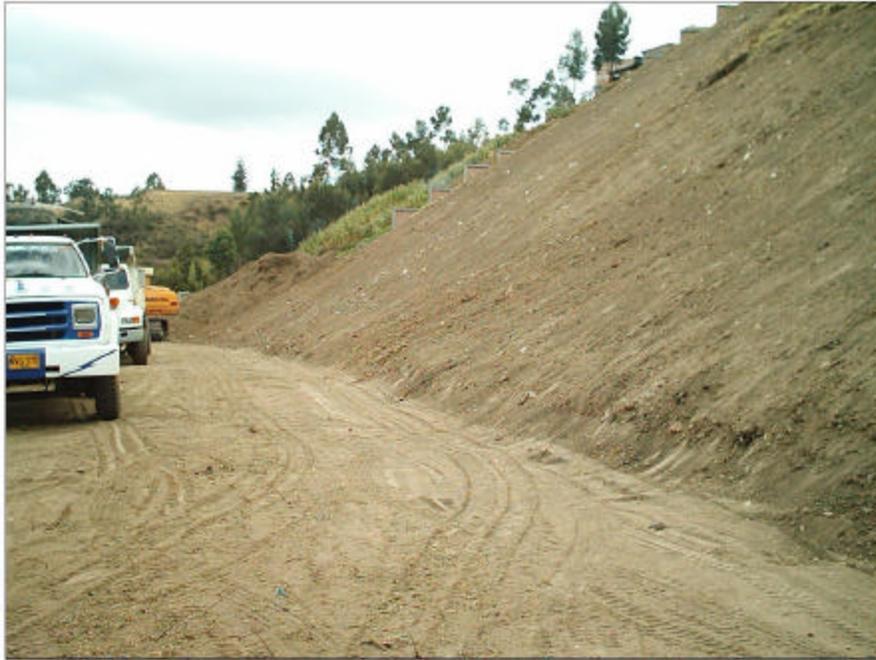
**Figura 34: Colocación de Chaflanes en el talud**
