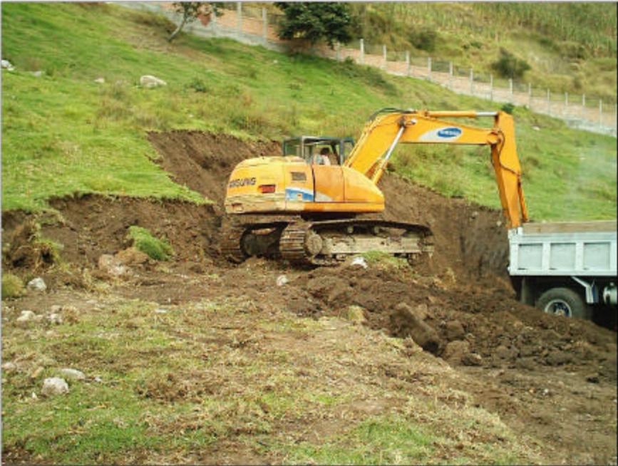
**Figura 43: Excavación del material y chequeo de niveles**
