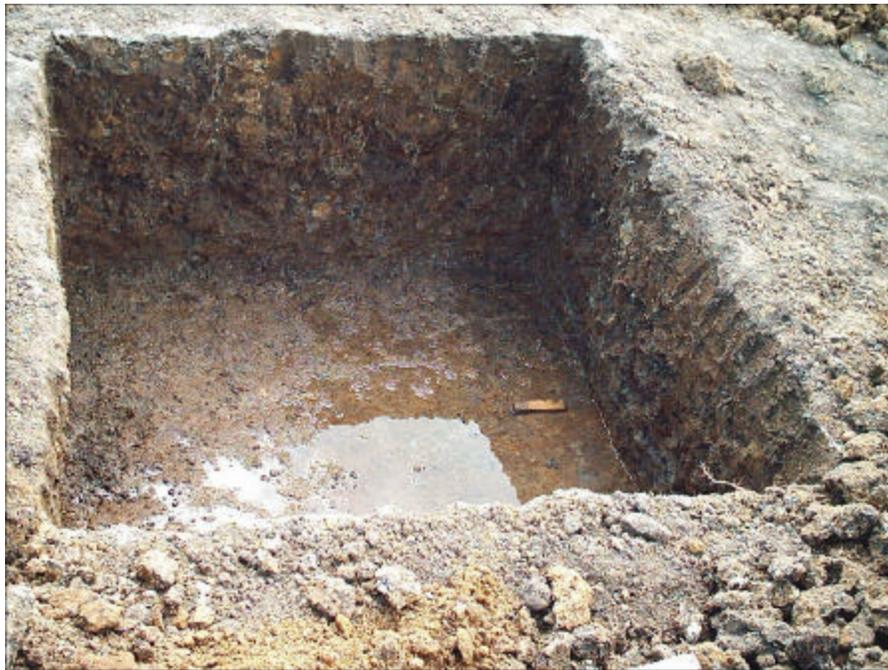
**Figura 61: Detalle de la excavación de la zapata I-2A**
