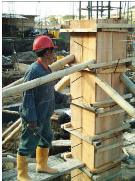
**Figura 109: Fundición de columnas en el primer piso**
