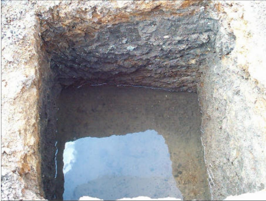
**Figura 60: Aparición de agua superficial en el Bloque 4**
