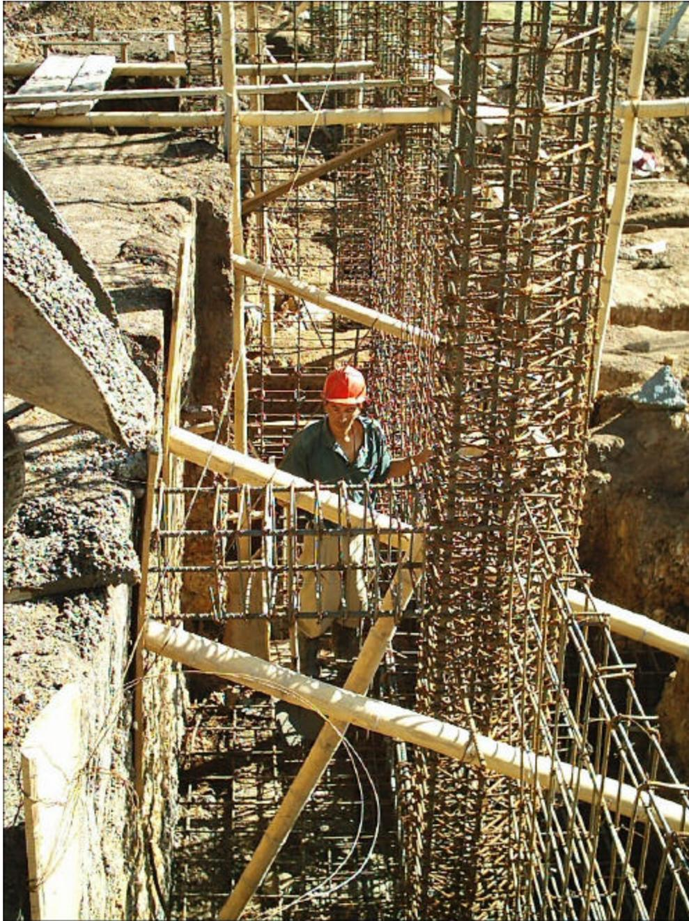
**Figura 112: Aseguramiento de la formaleta y fundición de pantallas**
