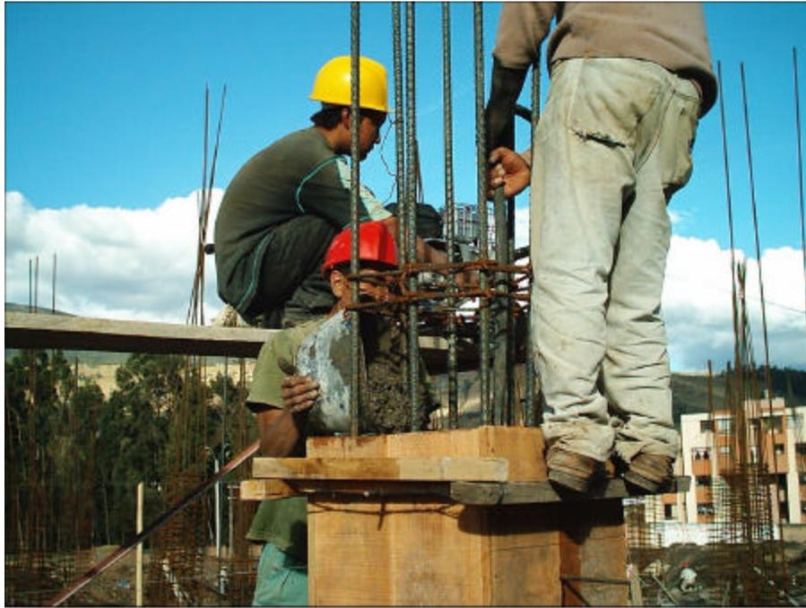
**Figura 110: Detalle del armado en pantallas**
