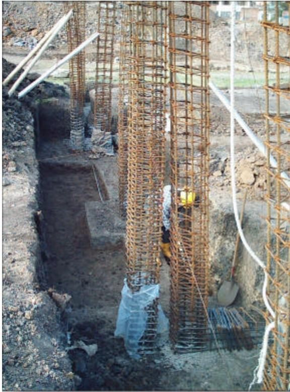
**Figura 115: Fundición del muro de contención**
