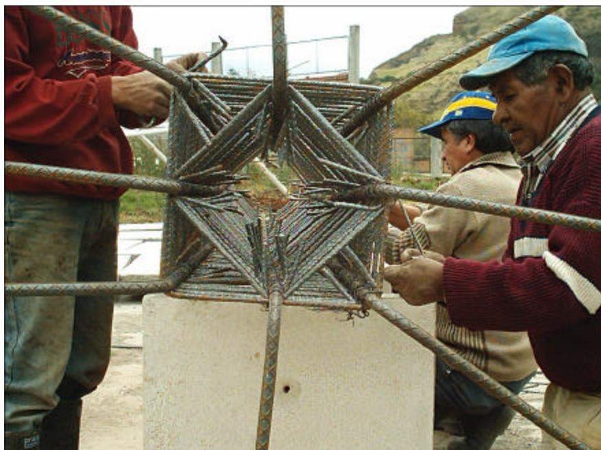
**Figura 105: Levantamiento de los castillos**
