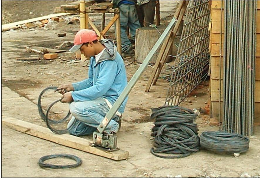
**Figura 92: Dobladora de acero modificada para cumplir con el diámetro mínimo de la norma NSR-98**
