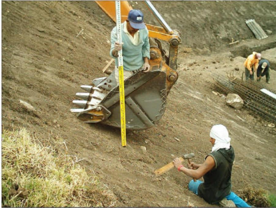
**Figura 36: Corte de la terraza sobre el talud**
