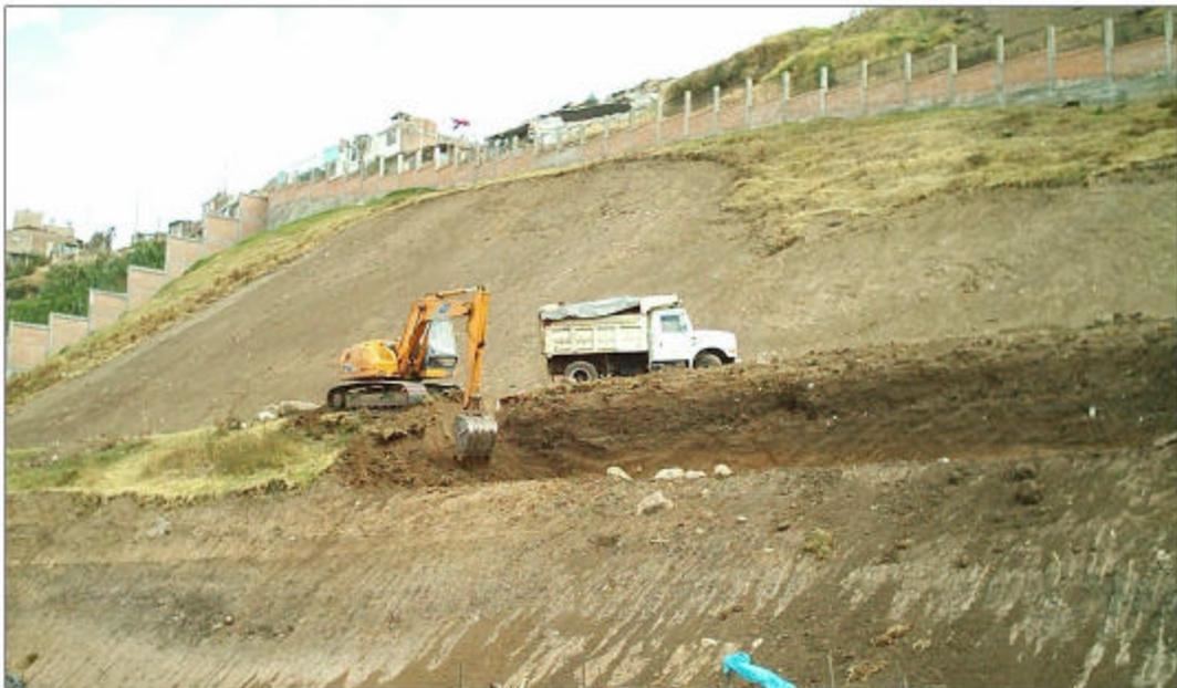
**Figura 37: Detalle del terraceo en el talud**
