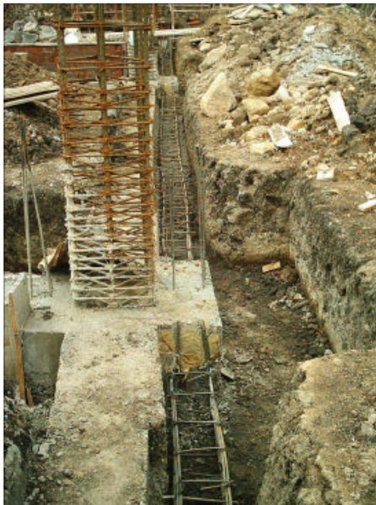
**Figura 118: Fundición de columnetas**
