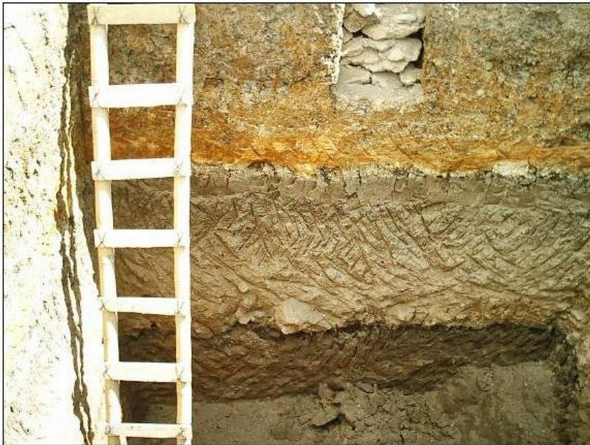
**Figura 63: Excavación de zapatas junto al muro de contención**
