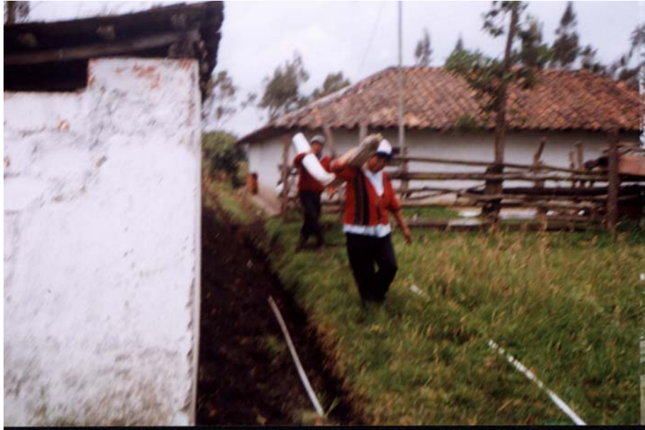
Figura 3. Transporte de material al sitio de la obra
