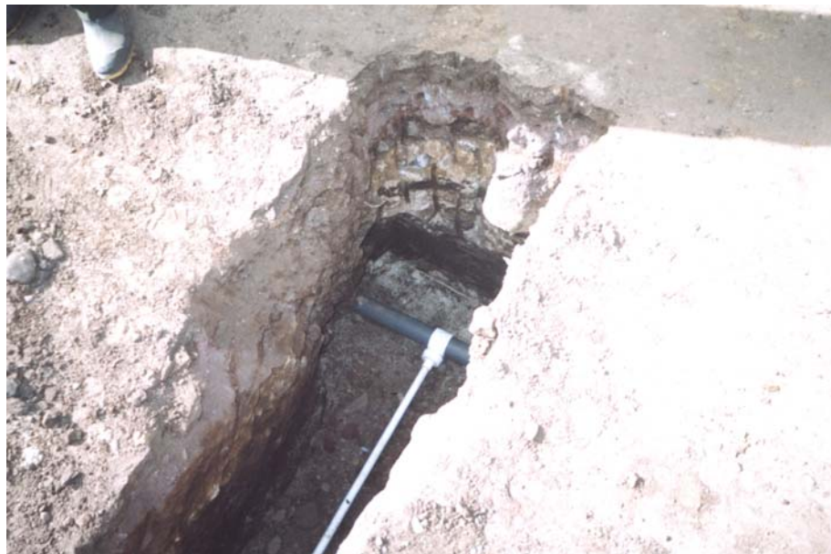
Figura 10. Acometida terminada
