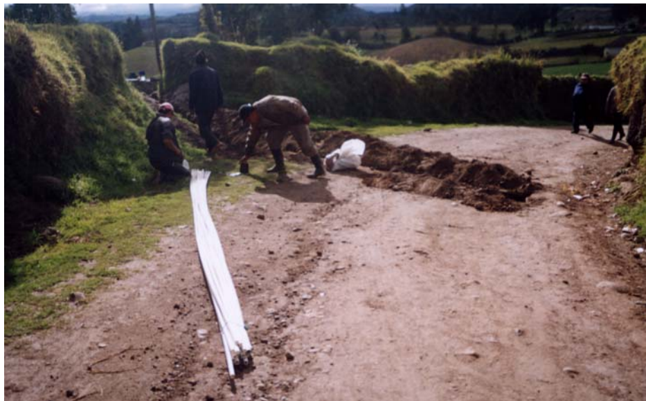
Figura 4. Material en el sitio de la obra
