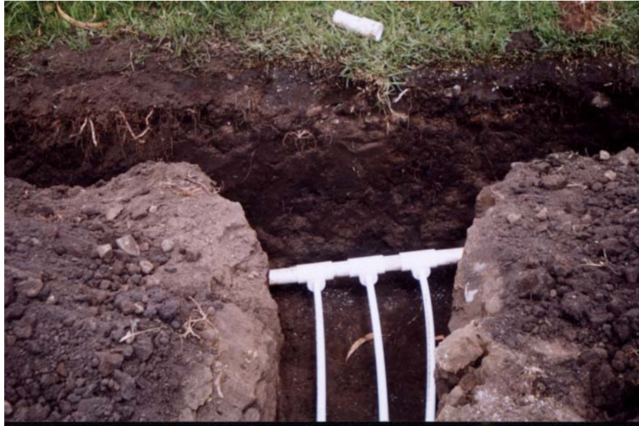
Figura 11. Derivación de acometida.
