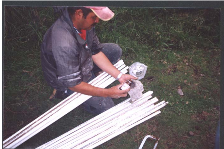
Figura 6. Conexión de la tubería
