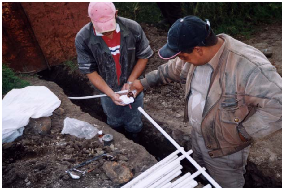
Figura 6. Conexión de la tubería
