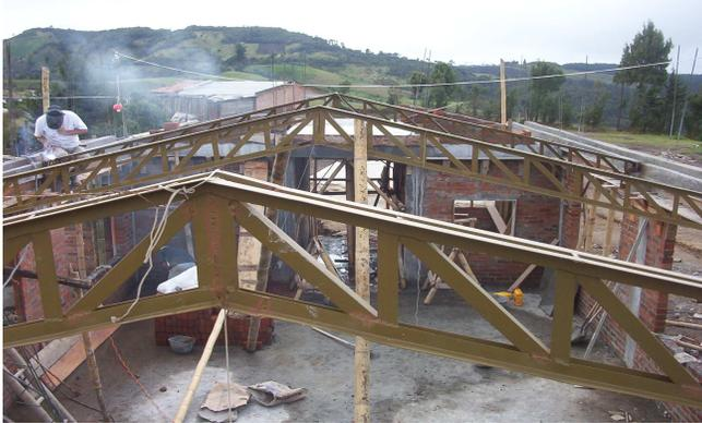
**6.1.11 Cubierta.** Fueron instalados 124 m<sup>2</sup> de cubierta en teja de Asbesto Cemento con sus respectivos accesorios y 5 m<sup>2</sup> en teja traslúcida con sus respectivos accesorios. Anterior a la colocación de las tejas, se confirmó que la pendiente que se presentaba fuera la adecuada.
