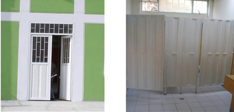
**6.2.10 Carpintería en madera.** En la parte interna del salón se instalaron 2 puertas en madera de 0.90 m x 2.10 m con luceta de 0.20 m, cada una de ellas pintadas, estas puertas incluyen chapas de seguridad.
