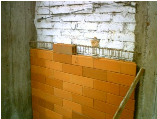
Figura 96 Viguetas de confinamiento.
