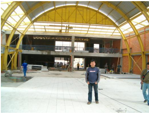
Figura 144. Montaje de cubierta en policarbonato.
