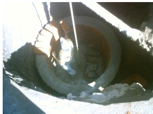
Figura 106. Compactación de alcantarillado, construcción pozo inspección.
