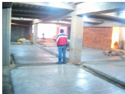
Figura 92. Terminado fundición placa pavimento parqueadero.
