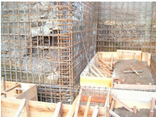
Figura 51. Formateado de zapatas centrales y excéntricas.
