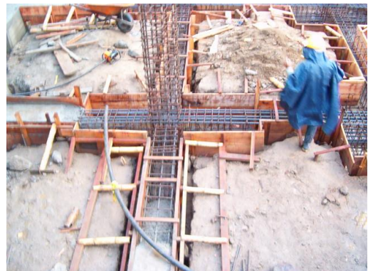
Figura 51. Formateado de zapatas centrales y excéntricas.
