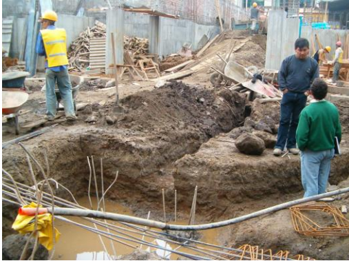
Figura 49. Excavación y armado parrillas de acero zapatas.
