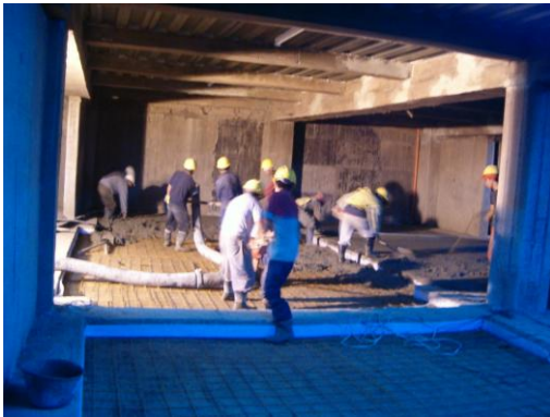
Figura 91. Fundición con bomba de concreto placa de parqueadero.
