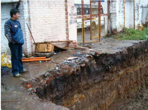
Figura 22. Terminación de excavación n-3.00 - llegada piloteadora.
