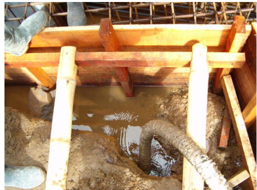
Figura 51. Formateado de zapatas centrales y excéntricas.
