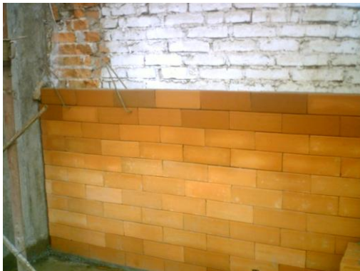
Figura 123. Levantamiento de muros en ladrillo a la vista, dilatación.
