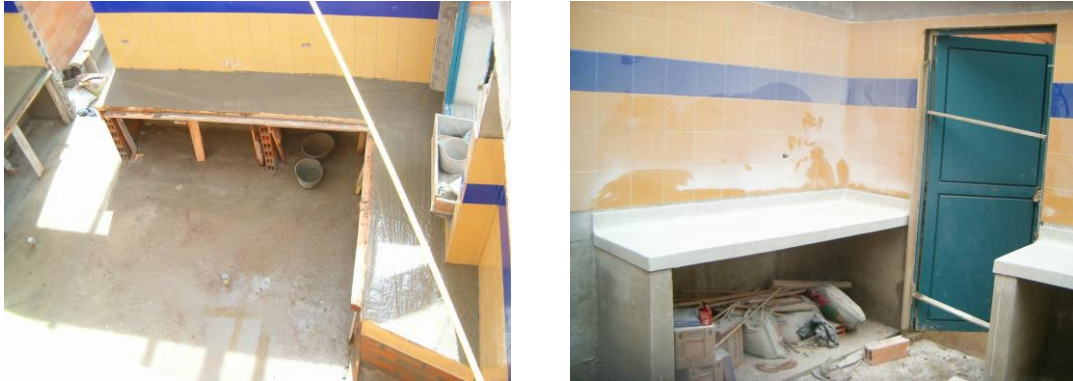
Figura 133. Fundición mesón cocina y terminado granito pulido.
