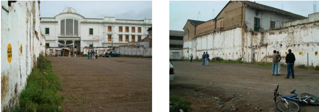
Figura 6. Reconocimiento parte externa lote carrera 22
