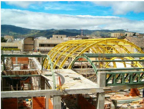
Figura 138. Aplicación pintura estructura de cubierta.
