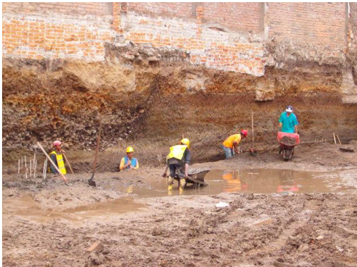
Figura 23. Excavación manual de la zarpa.
