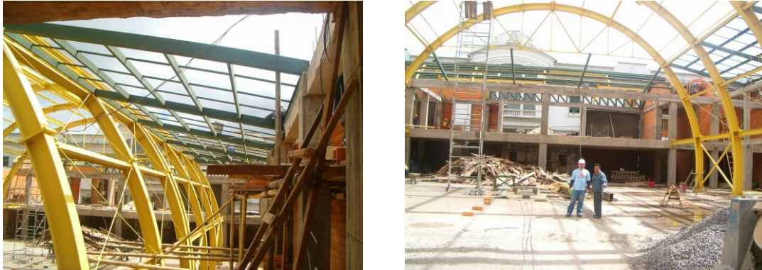
Figura 81. Estructura de cubierta para policarbonato.
