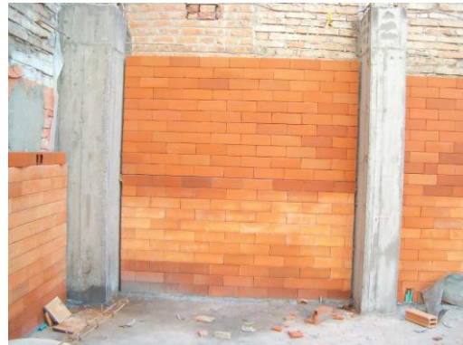
Figura 123. Levantamiento de muros en ladrillo a la vista, dilatación.
