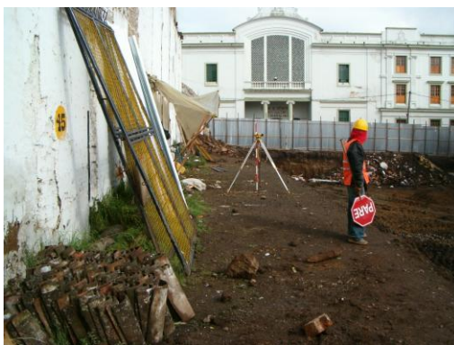
Figura 18. Verificación de cotas a través de la nivelación del terreno.
