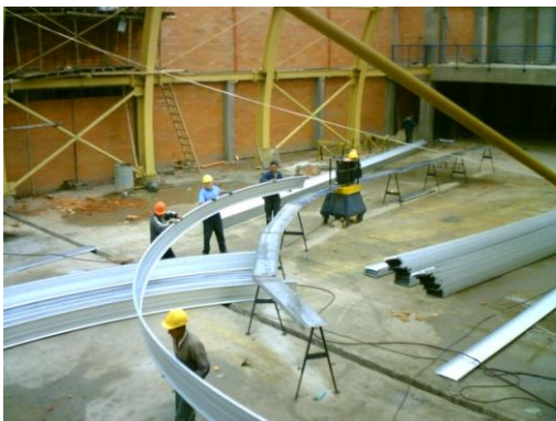
Figura 140. Máquina curvadora de tejas en aluzinc luxalon.
