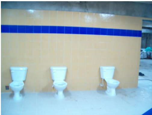
Figura 110. Instalación de sanitarios, orinales, lavaplatos.
