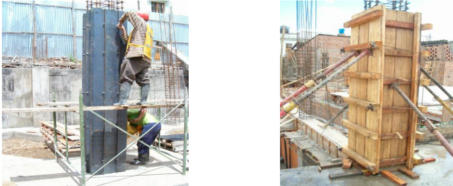
Figura 38. Formaleta metálica y de madera para columnas.
