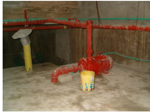
Figura 113. Motobomba instalación red contra incendios, flotador tanque.
