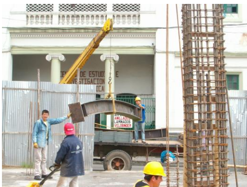
Figura 72. Descargue de elementos con grúa.
