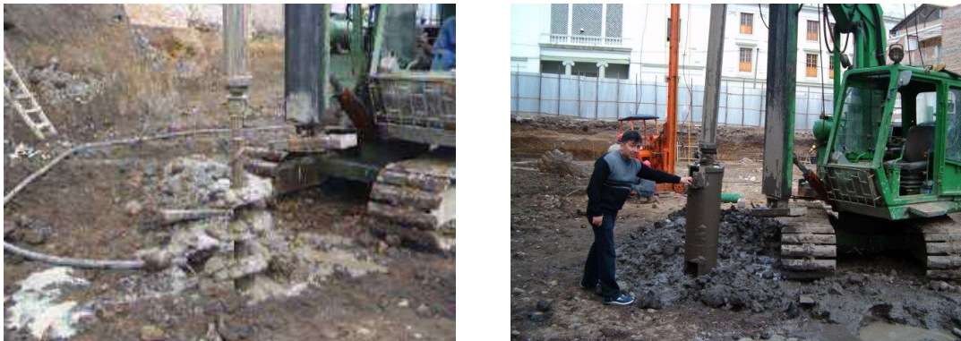
Figura 40. Lodos obtenidos de la perforación de pilotes.
