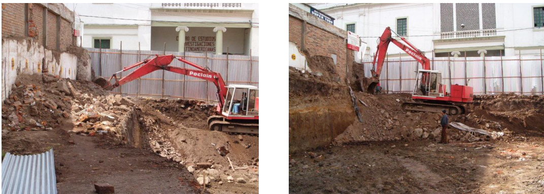
Figura 9. Perfilado y demolición de tapias con ayuda de excavadora.
