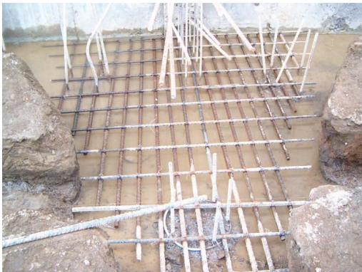
Figura 51. Formateado de zapatas centrales y excéntricas.
