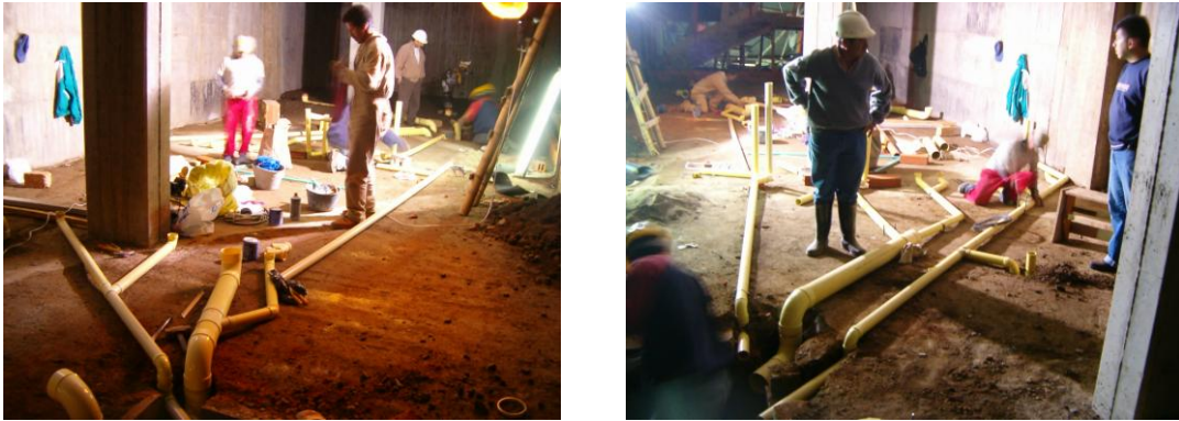
Figura 101. Para embeber la instalación sanitaria se hizo un escalón en toda el área de la batería sanitaria.
