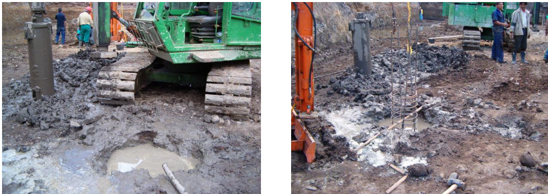
Figura 42. Excavación con lodo bentonítico y colocación refuerzo.
