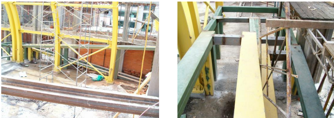
Figura 77. Construcción rampa peatonal.
