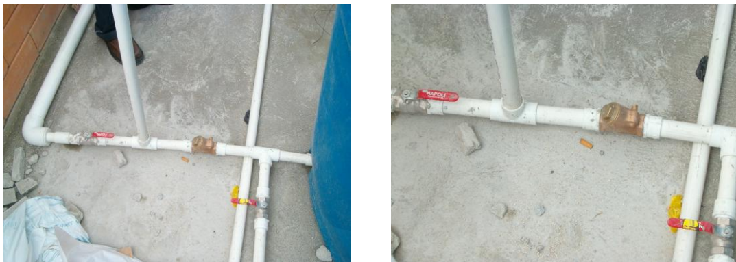
Figura 118. Válvulas de bola y cheques.
