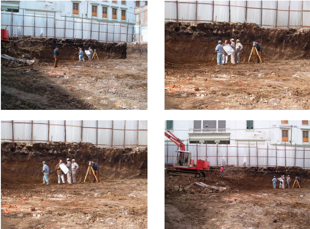
Figura 16. Localización y replanteo de eje 2
