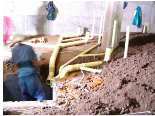
Figura 105. Excavación alcantarilla, perforación colector y construcción pozo inspección
