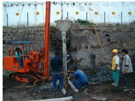
Figura 43. Máquina para izar la canastilla de acero Tolva para introducir el concreto.
