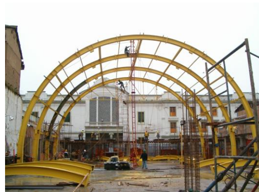
Figura 75. Vista de arcos HEA 400 y unión perfiles IPE
