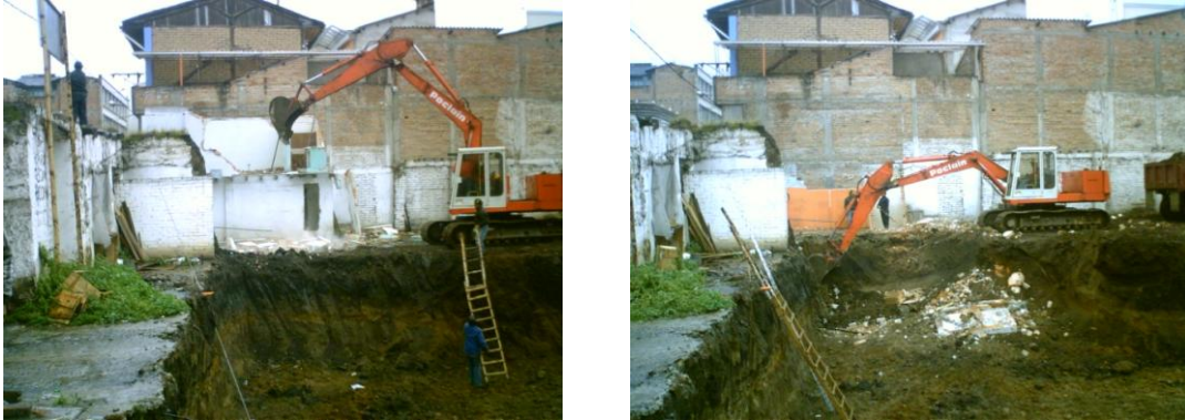
Figura 10. Demolición muros ladrillo parte interna.
