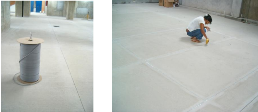
Figura 93. Cordón de respaldo y epóxico para dilatación pavimento.
