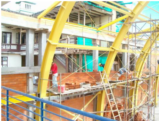
Figura 124. Pega de ladrillo y aplicación siliconite.
