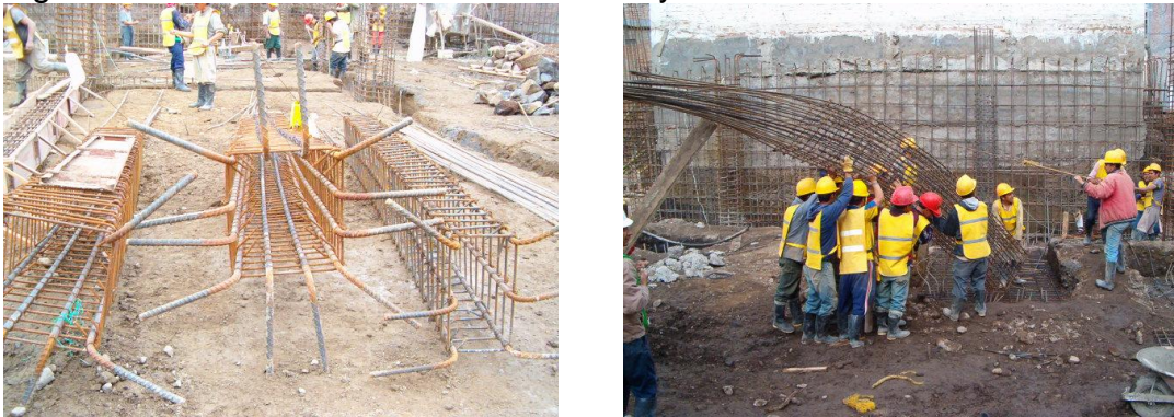
Figura 59. Alineando encofrado, fundición y terminado de columnas.
