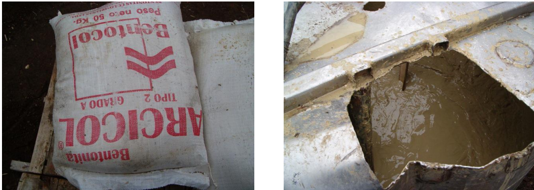
Figura 42. Excavación con lodo bentonítico y colocación refuerzo.
