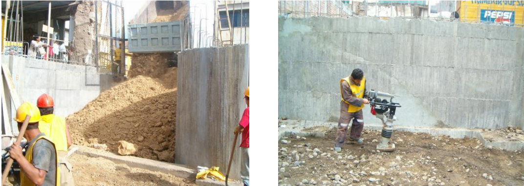
Figura 87. Toma de densidades rampa vehicular.
