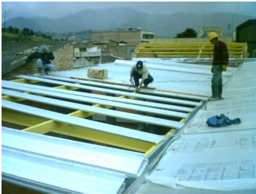
Figura 142. Instalación cubierta curva en aluzinc.
