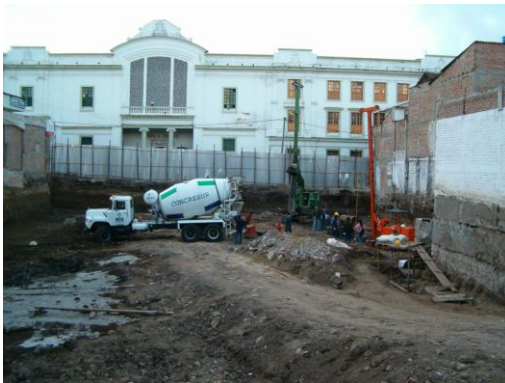
Figura 30. Transporte, mezclado, vaciado y bombeo del concreto.
