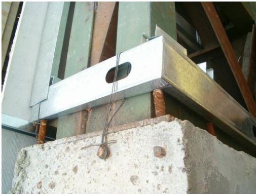
Figura 130. Fachada falsa en superboard.
