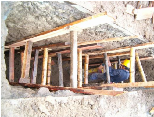
Figura 106. Compactación de alcantarillado, construcción pozo inspección.
