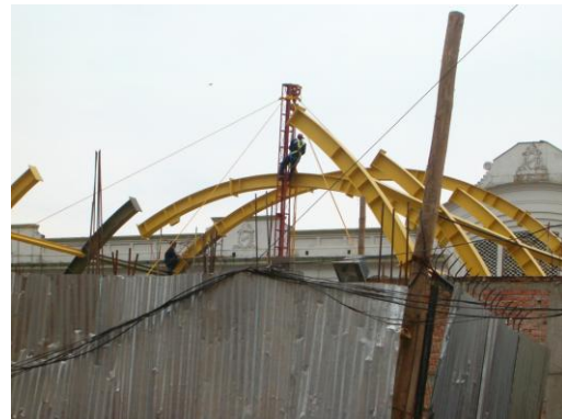
Figura 75. Vista de arcos HEA 400 y unión perfiles IPE
