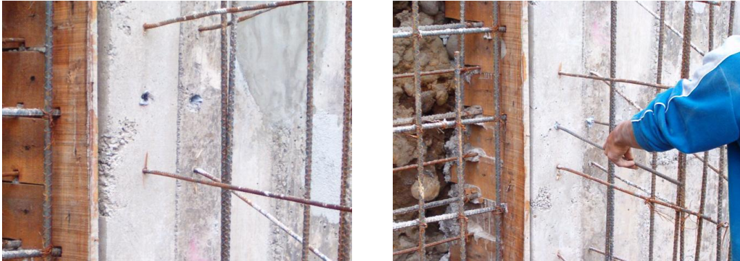
Figura 34. Anclaje final de la varilla.
