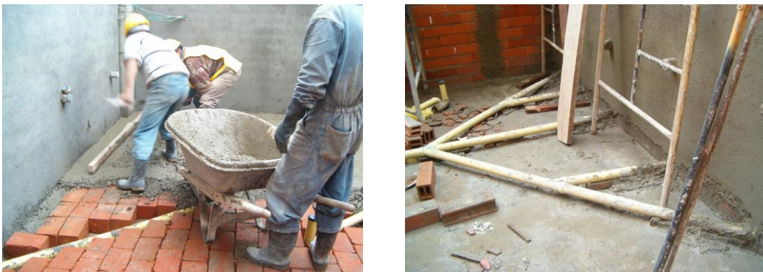
Figura 101. Para embeber la instalación sanitaria se hizo un escalón en toda el área de la batería sanitaria.
