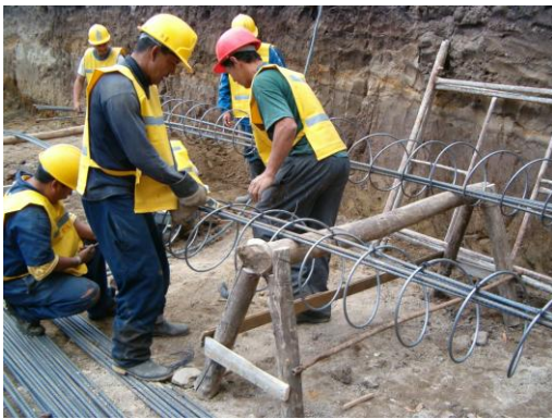
Figura 39. Armado de acero de refuerzo pilotes (canastillas).
