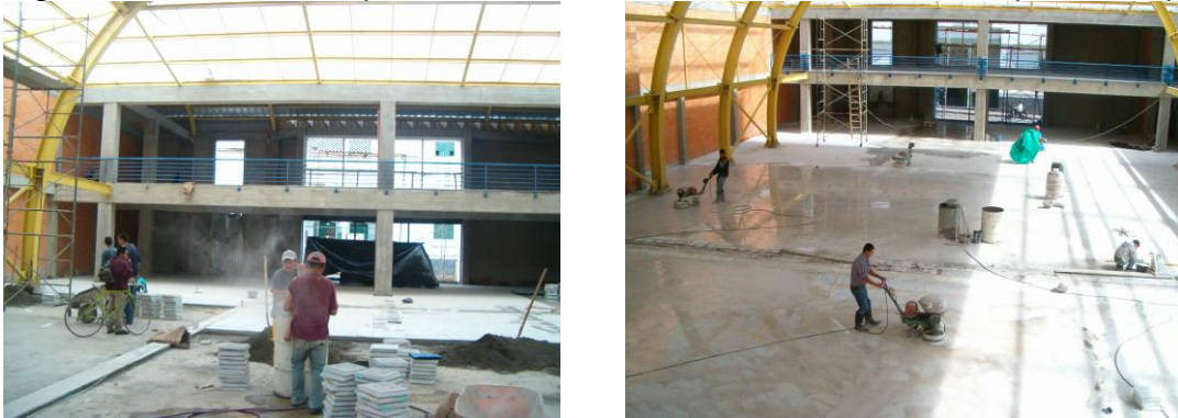
Figura 131. Nivelación piso con mortero e instalación baldosas - pulido de piso.
