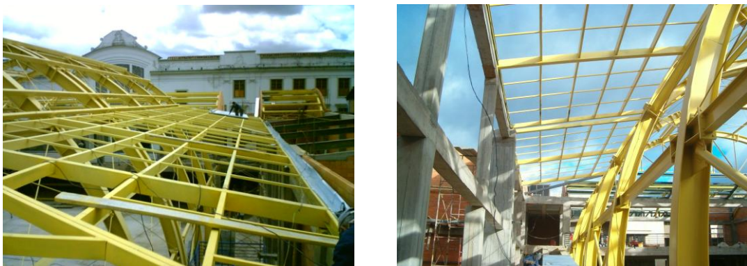
Figura 82. Estructura lateral para cubierta policarbonato.
