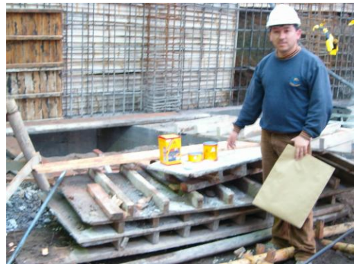
Figura 31. Aditivo para unir concreto viejo con nuevo.
