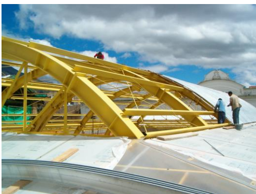
Figura 143. Diferentes pasos para el montaje de cubierta.
