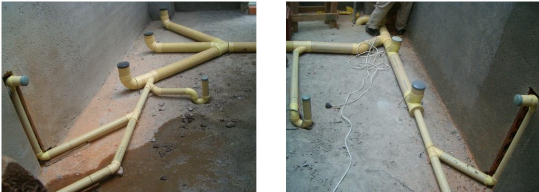
Figura 103. Bajantes de aguas lluvias.
