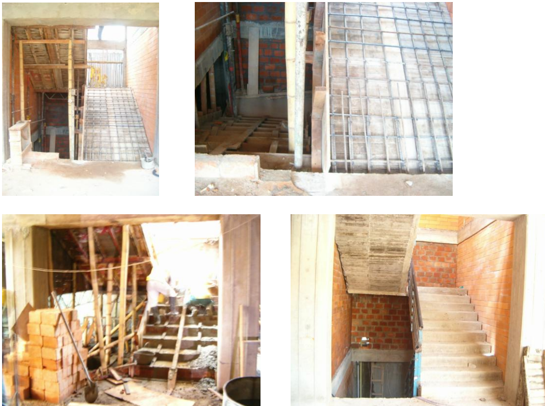
Figura 94. Armado parrilla inferior escalera y formaleteado.
