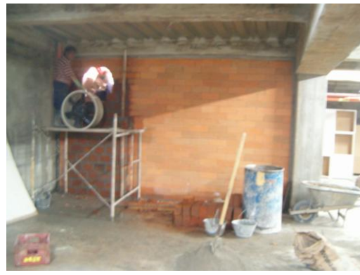
Figura 121. Iluminación parqueadero e instalación extractor de gases (CO 2 ).
