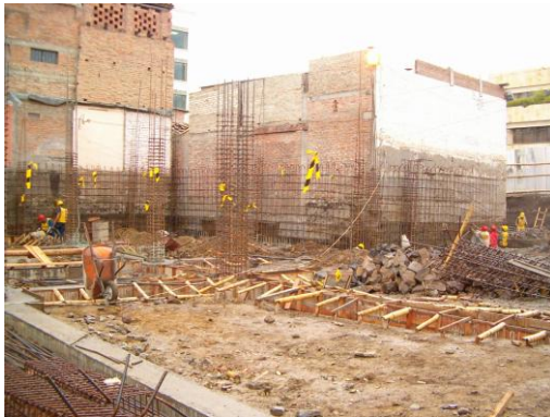
Figura 47. Formateado muros de contención.
