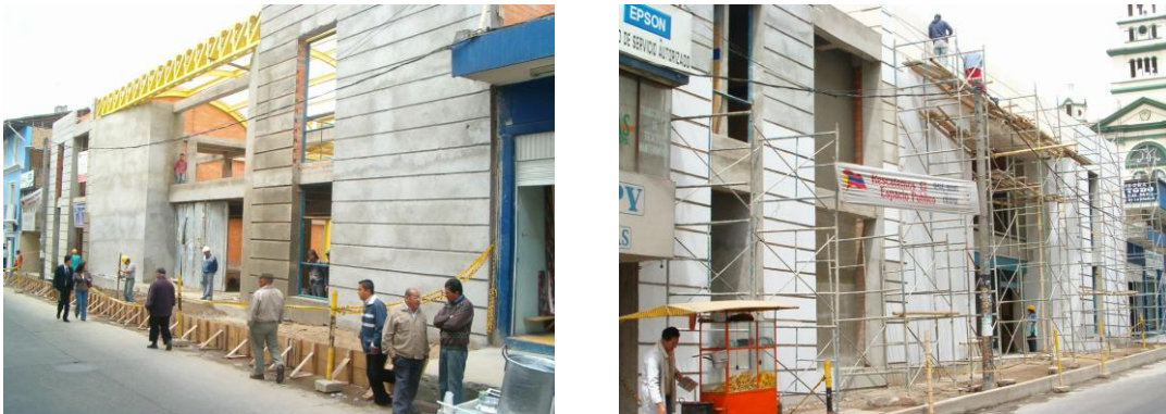
Figura 135. Estucado fachadas carrera 21B – carrera 22.
