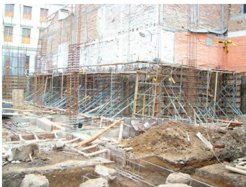
Figura 47. Formateado muros de contención.
