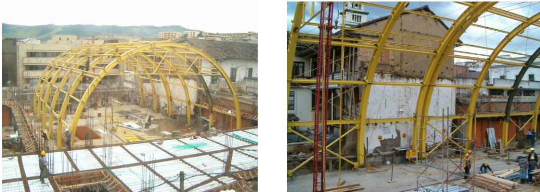
Figura 76. Arriostramiento estructura metálica.
