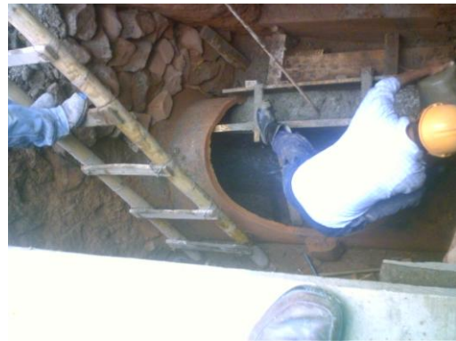
Figura 106. Compactación de alcantarillado, construcción pozo inspección.
