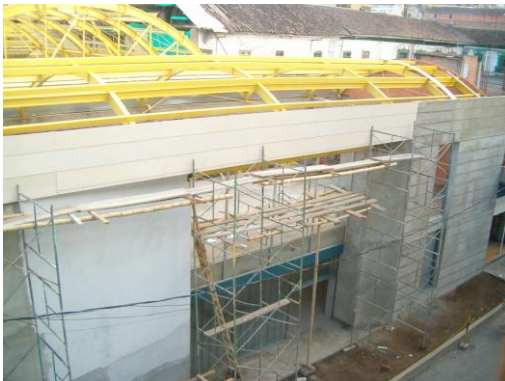
Figura 130. Fachada falsa en superboard.
