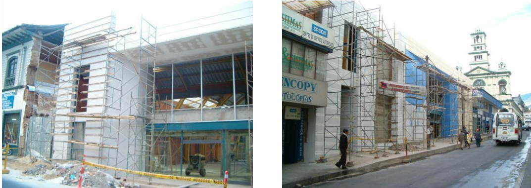
Figura 125. Dilataciones y filos de las fachadas carreras 21 B – 22.
