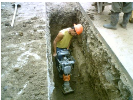
Figura 106. Compactación de alcantarillado, construcción pozo inspección.
