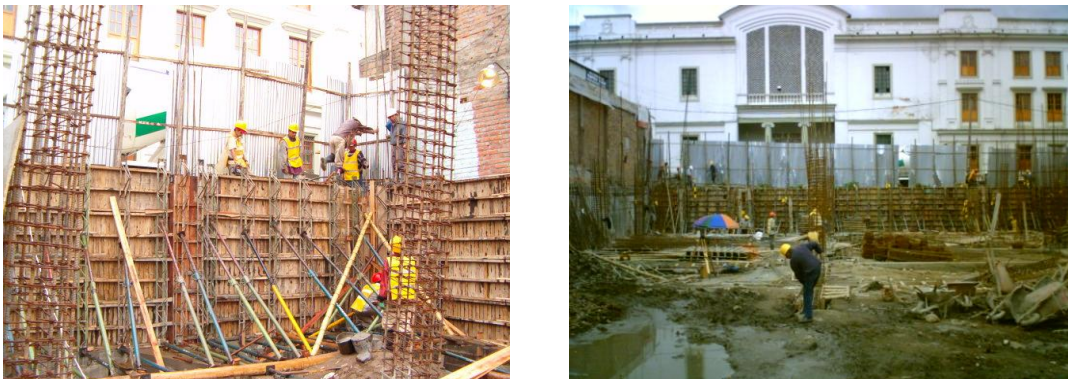
Figura 35. Encofrado muro de contención.
