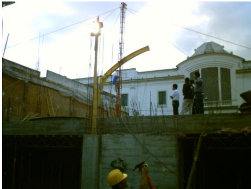
Figura74. Montaje parte central arco.
