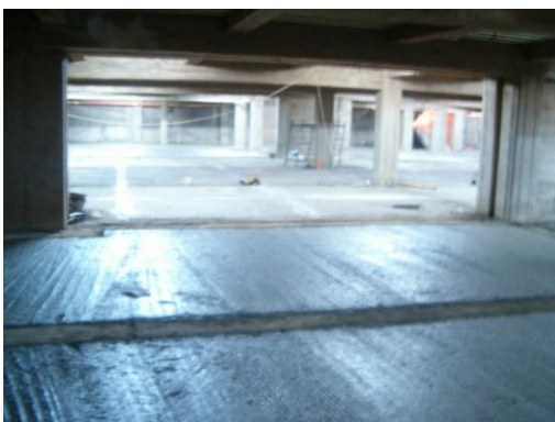
Figura 92. Terminado fundición placa pavimento parqueadero.
