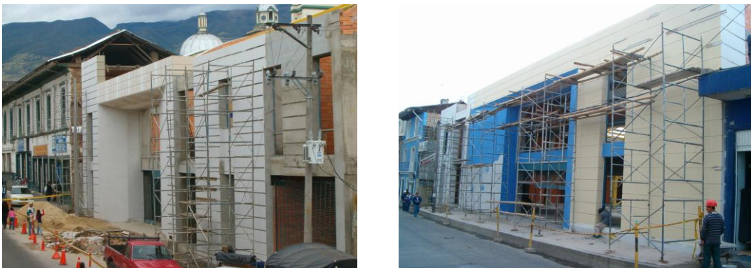
Figura 135. Estucado fachadas carrera 21B – carrera 22.
