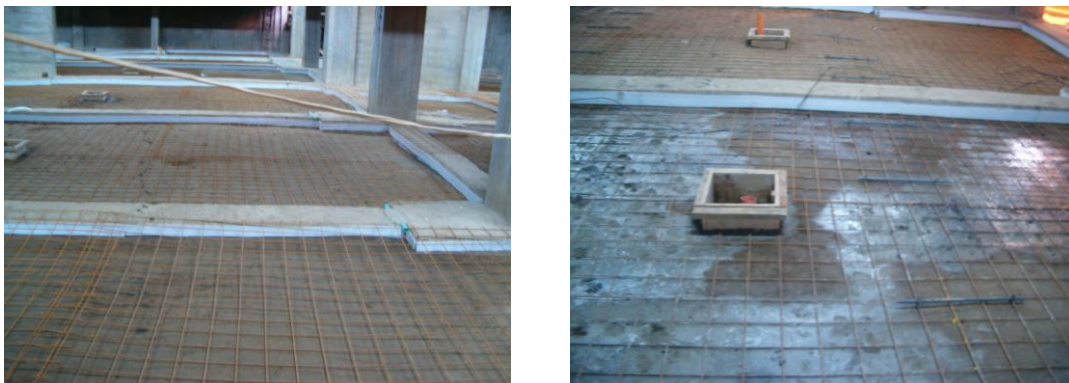
Figura 89. Tendido de malla electrosoldada y refuerzo de la placa de contrapiso.
