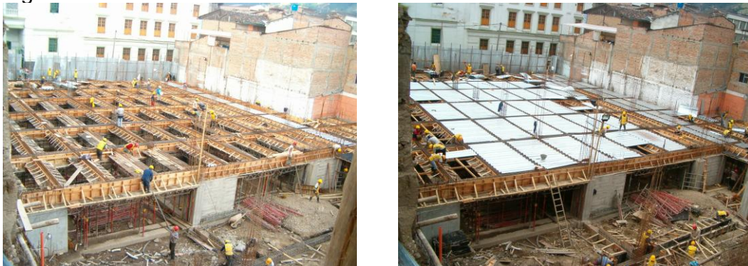
Figura 65. Instalación inicial de las láminas de metaldeck.
