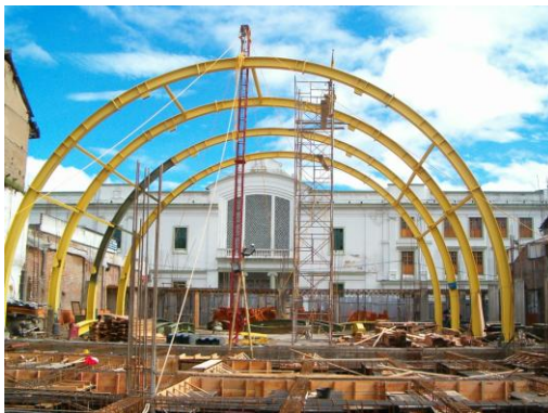
Figura 75. Vista de arcos HEA 400 y unión perfiles IPE
