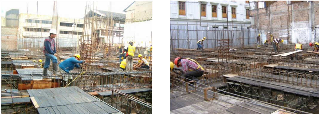
Figura 63. Formaleteando vigas aéreas.
