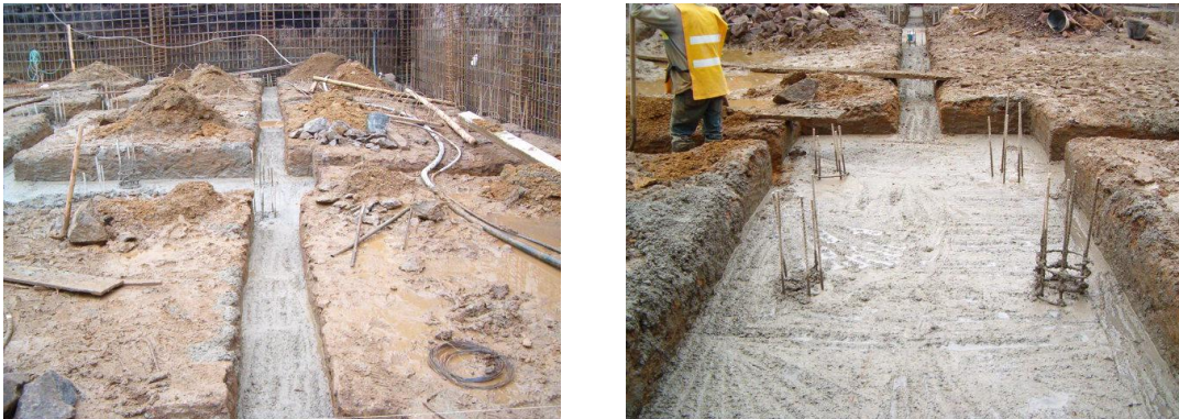
Figura 45. Solado vigas de cimentación
