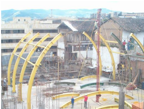
Figura74. Montaje parte central arco.
