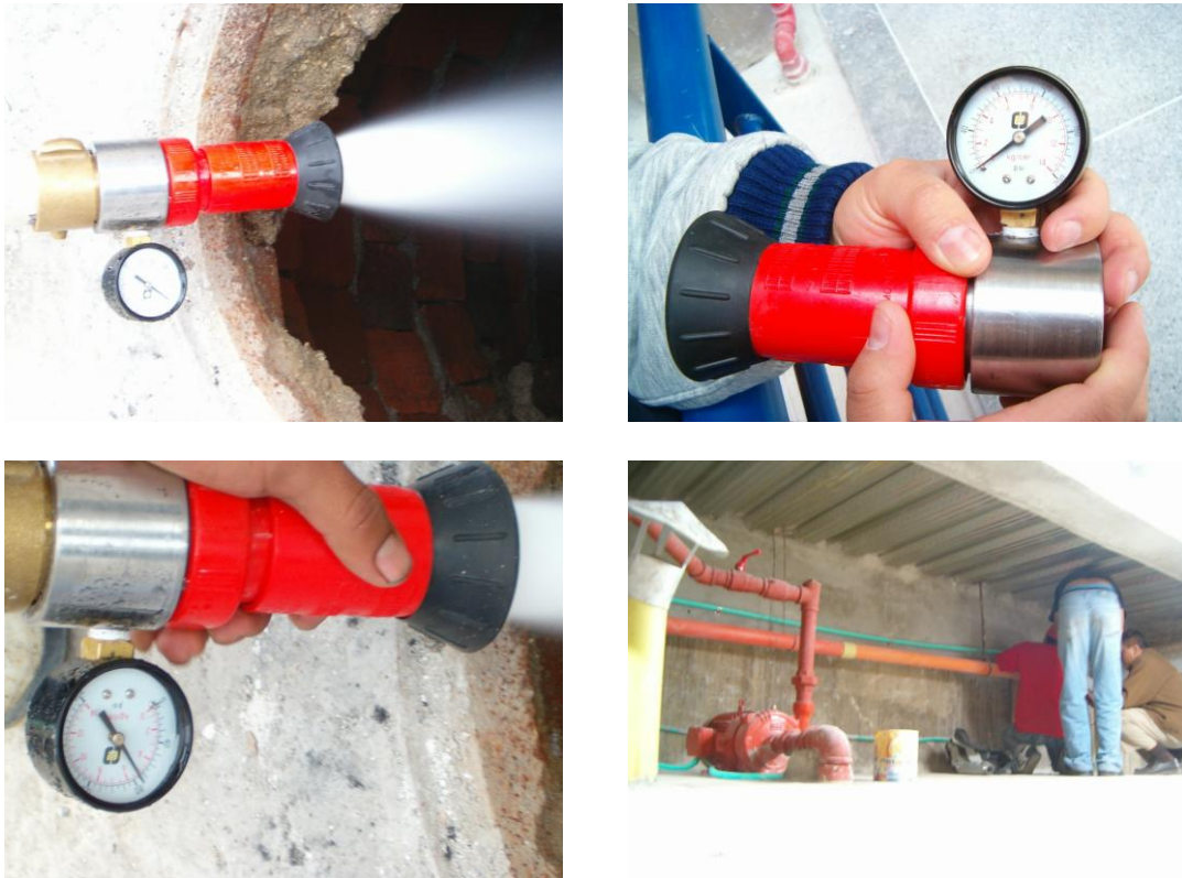
Figura 115. Verificando presión agua, prueba de encendido motobomba.
