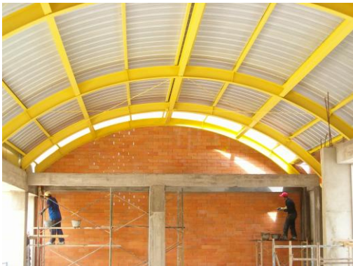
Figura 143. Diferentes pasos para el montaje de cubierta.
