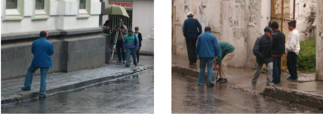
Figura 16. Localización y replanteo de eje 2
