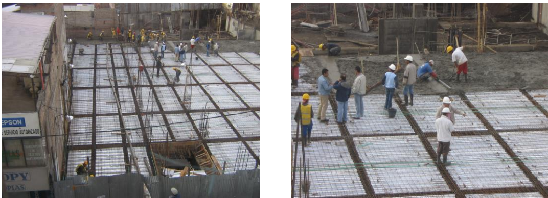
Figura 67. Inicio fundición, nivelación placa nivel +0.00
