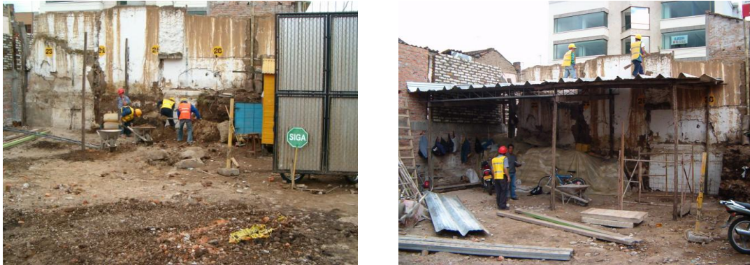
Figura 13. Construcción del campamento.
