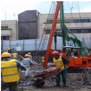
Figura 43. Máquina para izar la canastilla de acero Tolva para introducir el concreto.
