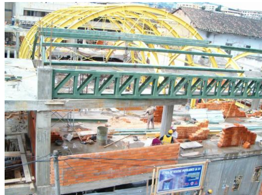
Figura 138. Aplicación pintura estructura de cubierta.
