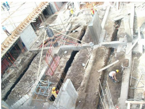
Figura 57. Instalación de geotextil y colocación grava.
