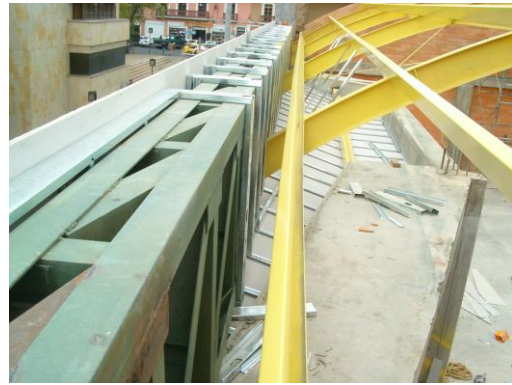
Figura 129. Instalación y accesorios de Superboard.
