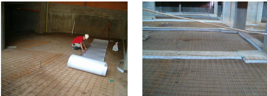
Figura 89. Tendido de malla electrosoldada y refuerzo de la placa de contrapiso.
