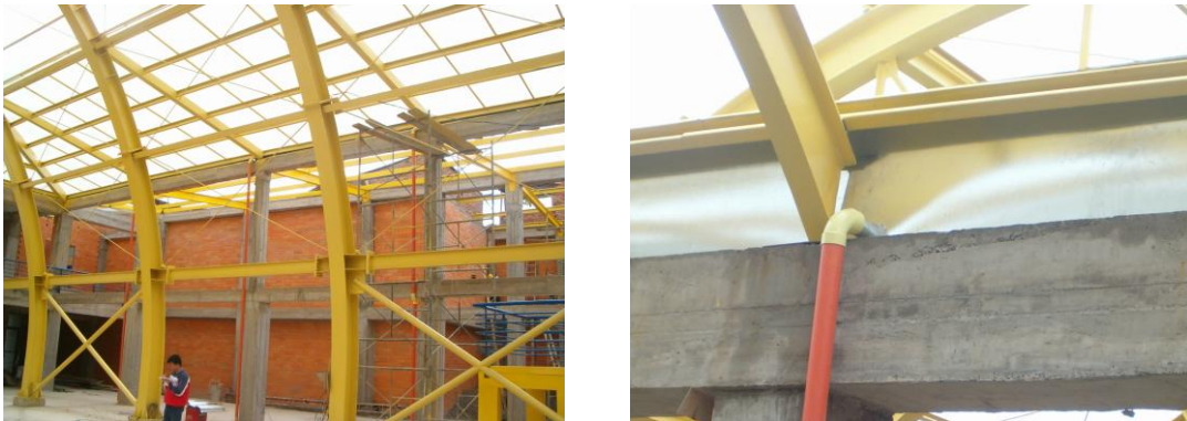
Figura 103. Bajantes de aguas lluvias.
