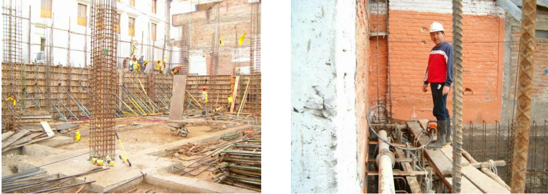
Figura 36. Verificación estado de apuntalamiento de la formaleta eje G'.
