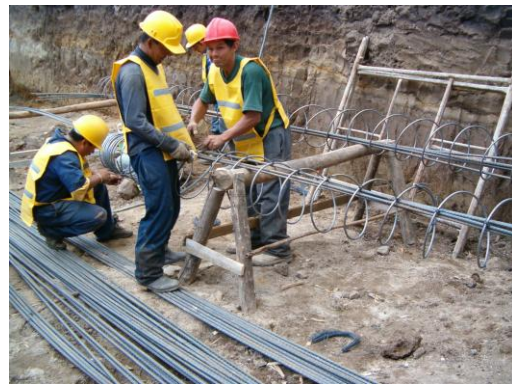
Figura 39. Armado de acero de refuerzo pilotes (canastillas).
