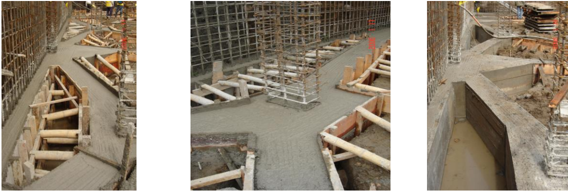
Figura 55. Fundición Vigas y desencofrado.
