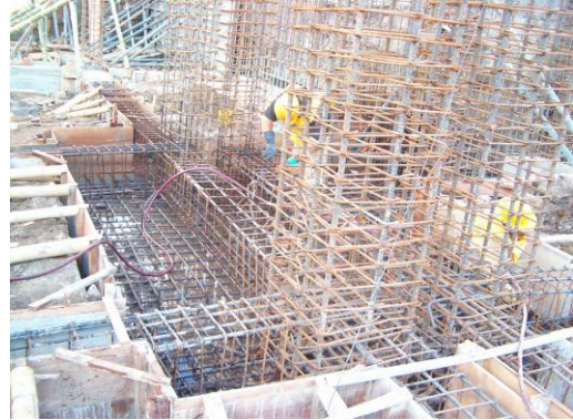
Figura 49. Excavación y armado parrillas de acero zapatas.
