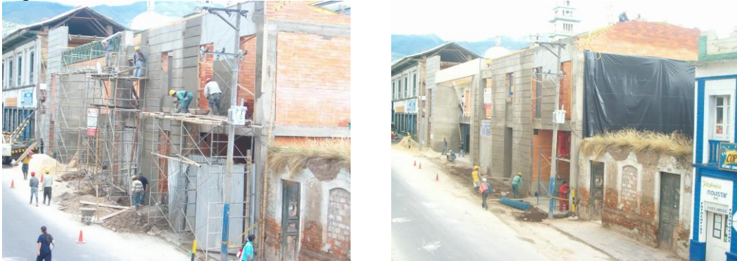
Figura 134. Pañetado de fachada carrera 21B.
