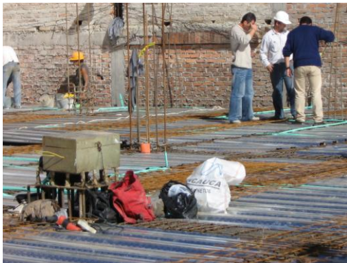
Figura 119. Instalación de ductos y cajillas.
