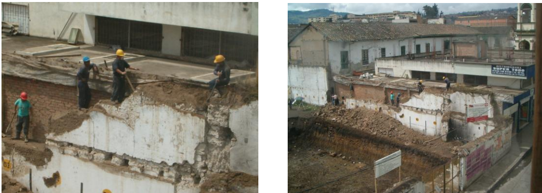
Figura 9. Perfilado y demolición de tapias con ayuda de excavadora.
