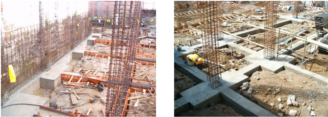
Figura 53. Zapatas terminadas.
