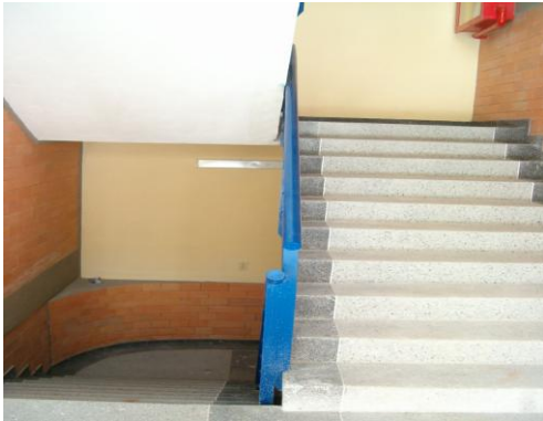
Figura 95 Acabado de escaleras en granito lavado.
