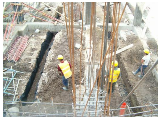
Figura 57. Instalación de geotextil y colocación grava.
