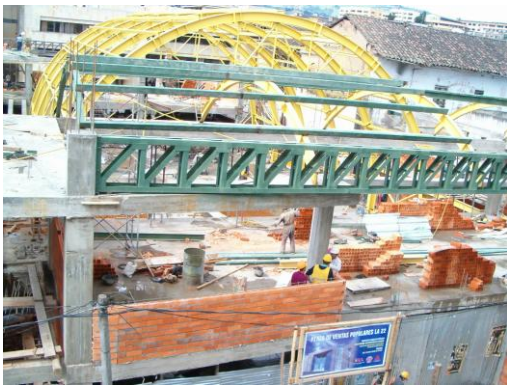
Figura 144. Montaje de cubierta en policarbonato.
