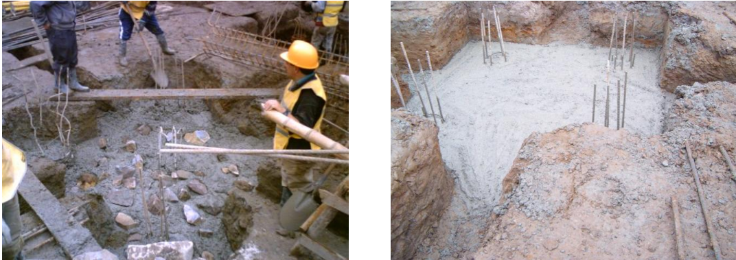
Figura 45. Solado vigas de cimentación
