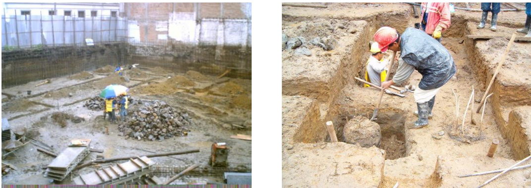
Figura 25. Verificación secciones de zapatas y zona para descabezar pilote.
