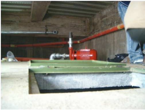
Figura 113. Motobomba instalación red contra incendios, flotador tanque.
