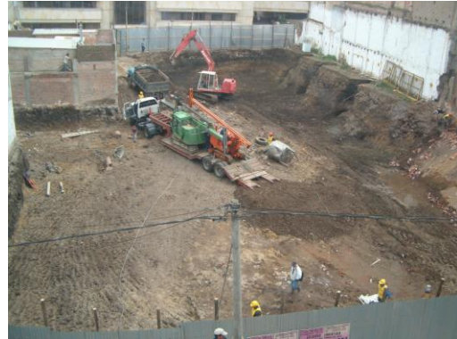
Figura 22. Terminación de excavación n-3.00 - llegada piloteadora.
