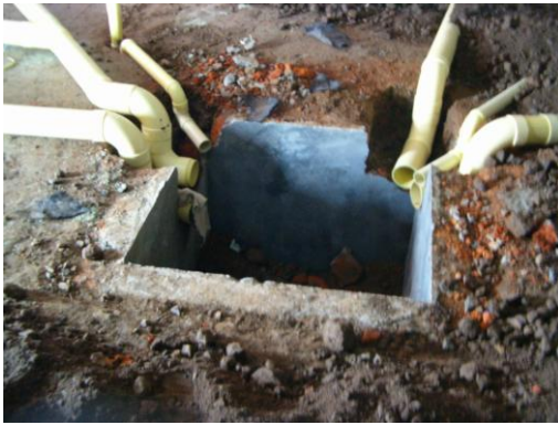
Figura 105. Excavación alcantarilla, perforación colector y construcción pozo inspección
