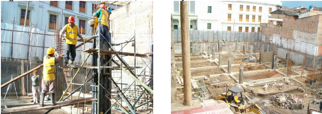
Figura 59. Alineando encofrado, fundición y terminado de columnas.
