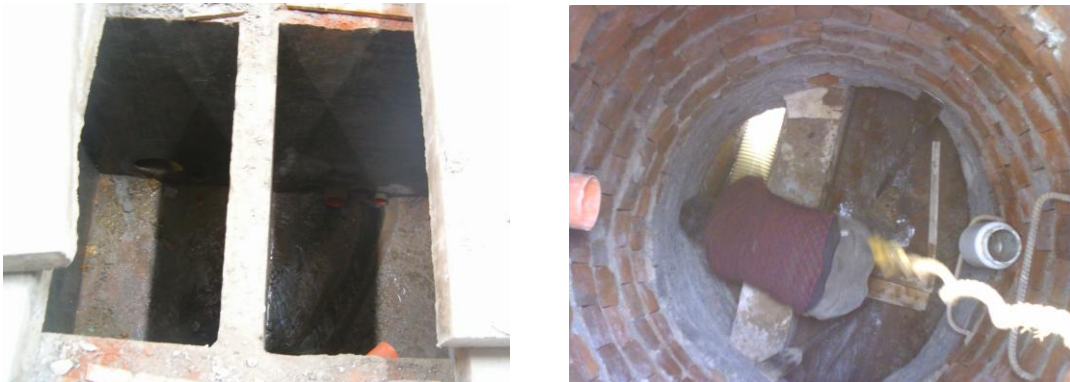
Figura 107. Desagües aguas servidas – filtro (A.LL).
