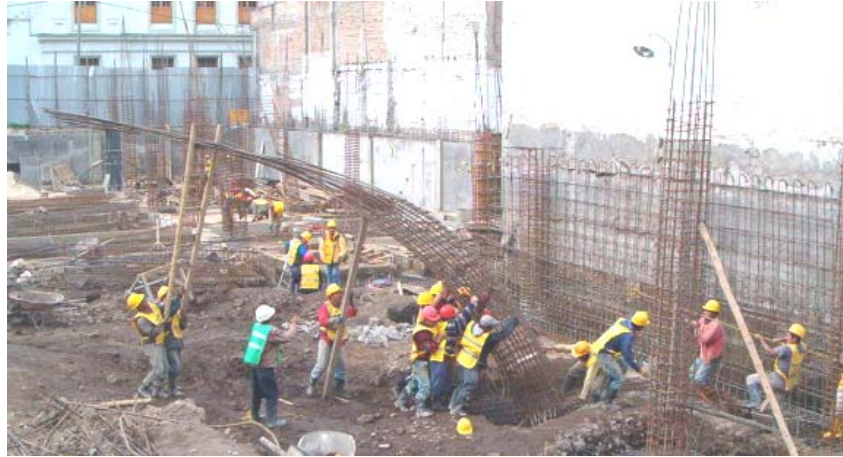
Figura 56. Hincado de armaduras de columnas.
