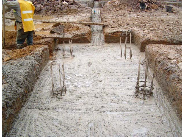
Figura 22. Fundición de concreto ciclópeo bajo la zapata.
