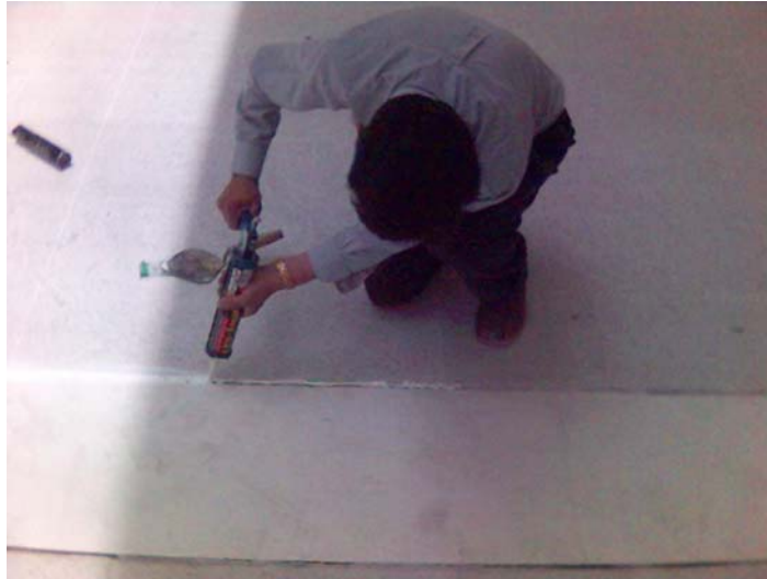
Figura 201. Instalación del Sikaflex-1a.
