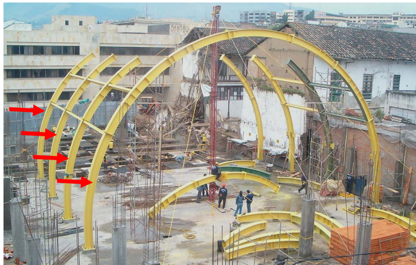
Figura 91. Armado de los arcos.
