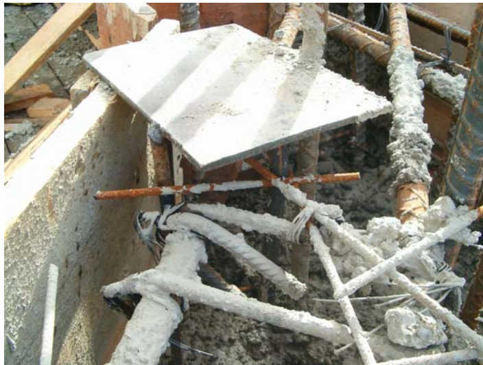
Figura 79. Platinas de soporte de los arcos IPE-240.
