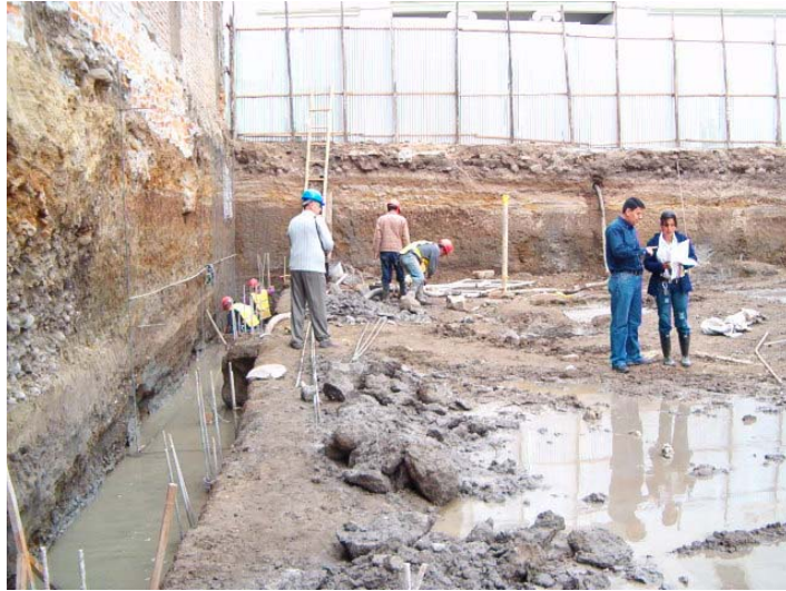
Figura 18. Excavaciones para el descabezado de pilotes.
