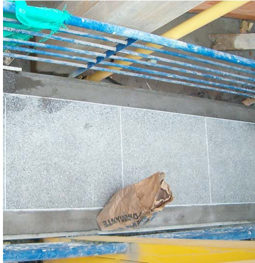
Figura 177. Pasamano instalado en la rampa.
