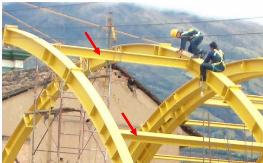
Figura 93. Instalación de las vigas IPE-240
