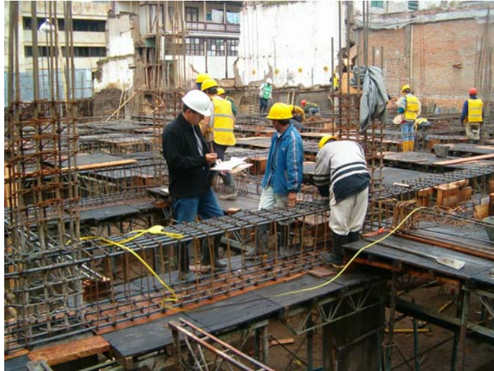
Figura 64. Revisión de las vigas con planos estructurales.
