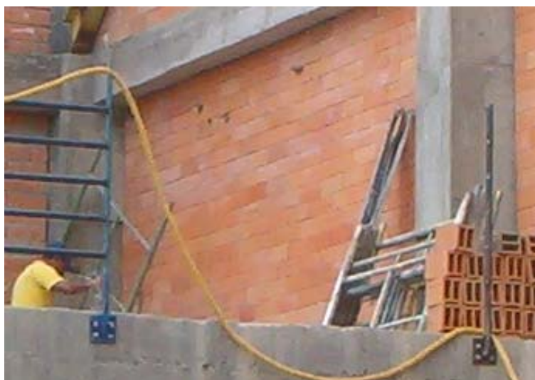
Figura 176. Pasamanos en la estructura de concreto.
