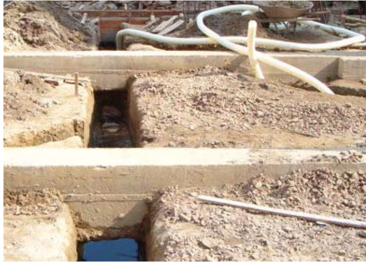
Figura 131. Excavación y tubería del filtro.
