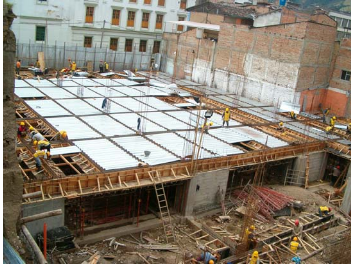
Figura 69. Panorámica de instalación las láminas de acero.
