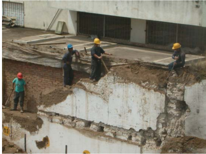
Figura 5. Demolición de tapia a mano.
