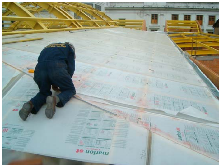
Figura 114. Instalación del policarbonato.
