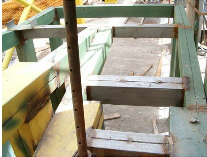
Figura 127. Perfiles unidos por medio de soldadura.
