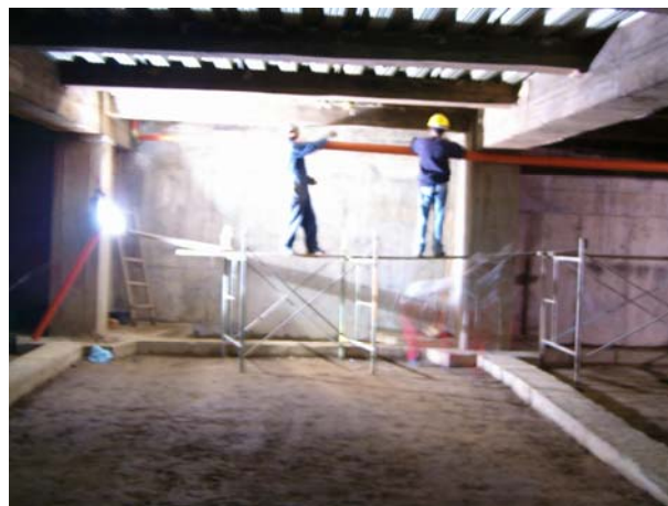
Figura 145. Instalación del sistema de aguas lluvias aéreas.
