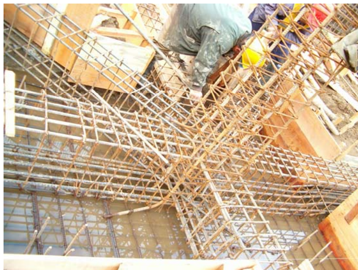
Figura 27. Formaleta para zapatas
