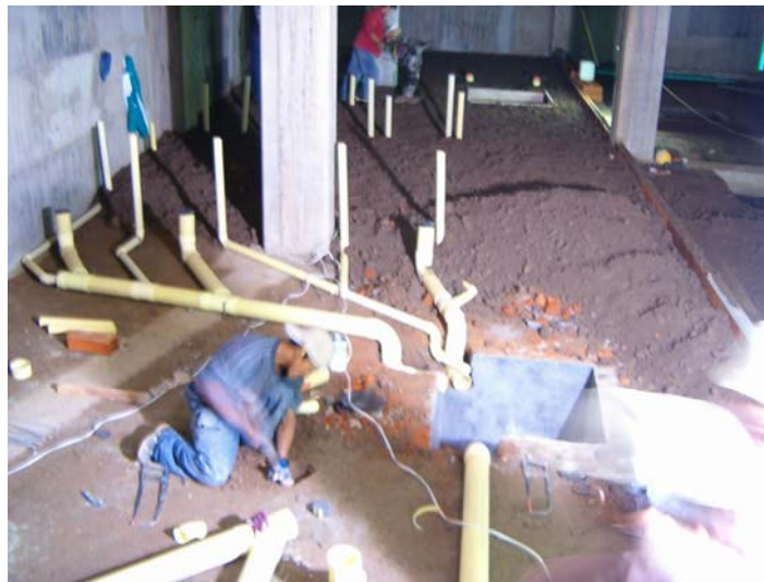
Figura 141. Instalación sanitario parqueadero.
