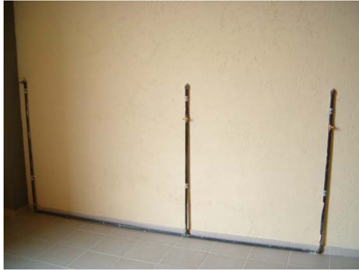
Figura 151. Instalación de gas.
