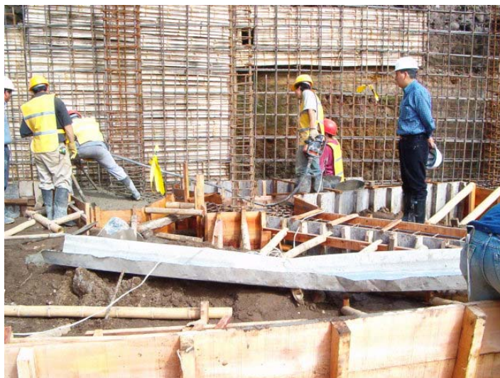
Figura 28. Supervisión de fundición de zapatas.
