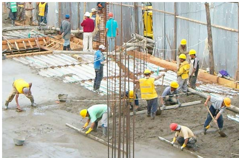
Figura 75. Nivelación con codal de madera.
