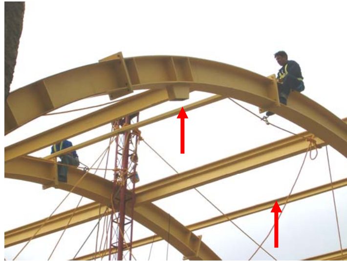
Figura 100. Instalación del perfil en C PHR 160x60-3.0mm
