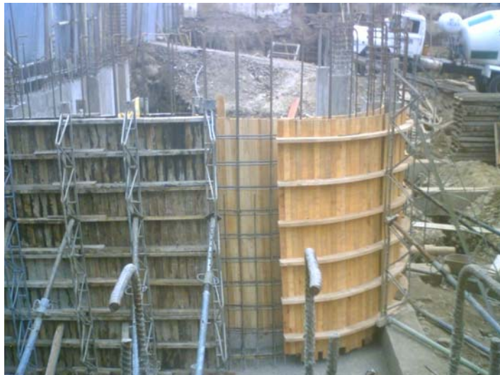
Figura 47. Encofrado del muro de contención de la rampa.
