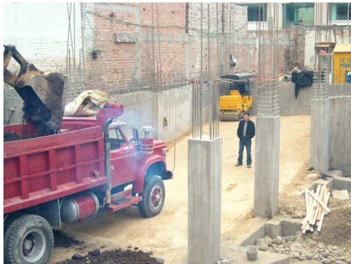
Figura 121. Compactación de la rampa.
