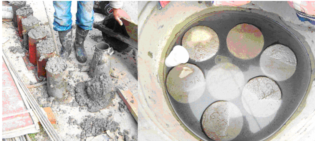
Figura 35. Prueba en obra del SLUMP y toma de cilindros.
