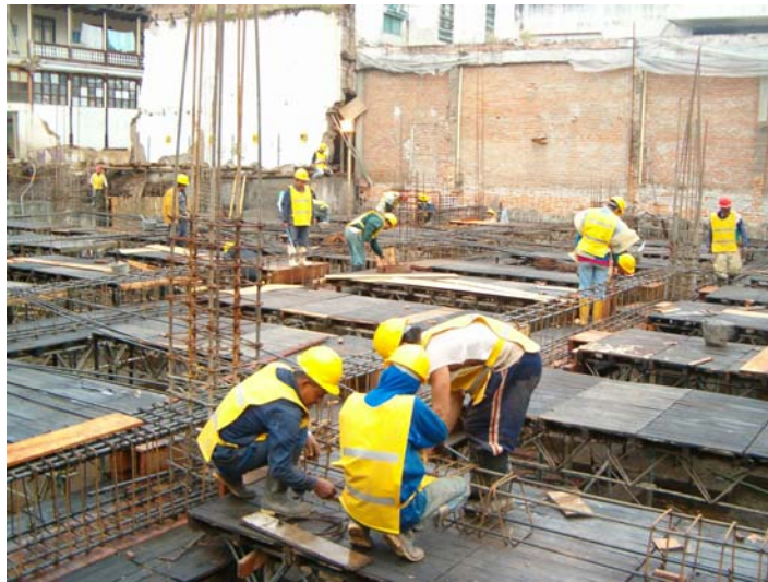
Figura 67. Armado de vigas aéreas.
