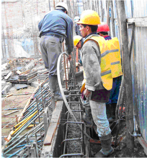
Figura 43. Fundición de un tramo del muro de contención.
