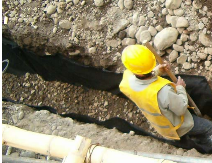
Figura 132. Armado del filtro.
