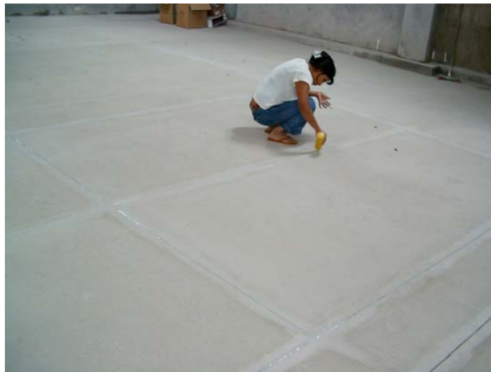
Figura 184. Instalación de la masilla.
