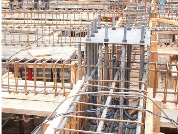
Figura 62. Pedestal con sus Anclajes y platina guía.
