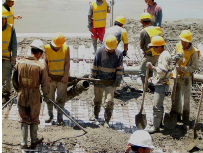
Figura 74. Colocación del concreto premezclado mediante bombeado.
