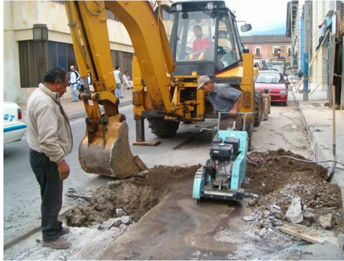
Figura 148. Corte de concreto asfáltico y retiro de tierra.
