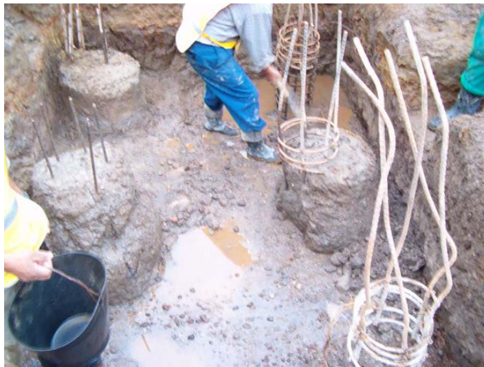
Figura 20. Pilote superior derecho contaminado.
