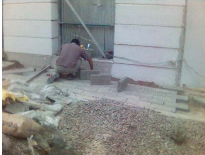
Figura 179. Instalación de las plaquetas del andén.
