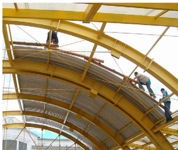
Figura 118. Instalación del aluzinc.
