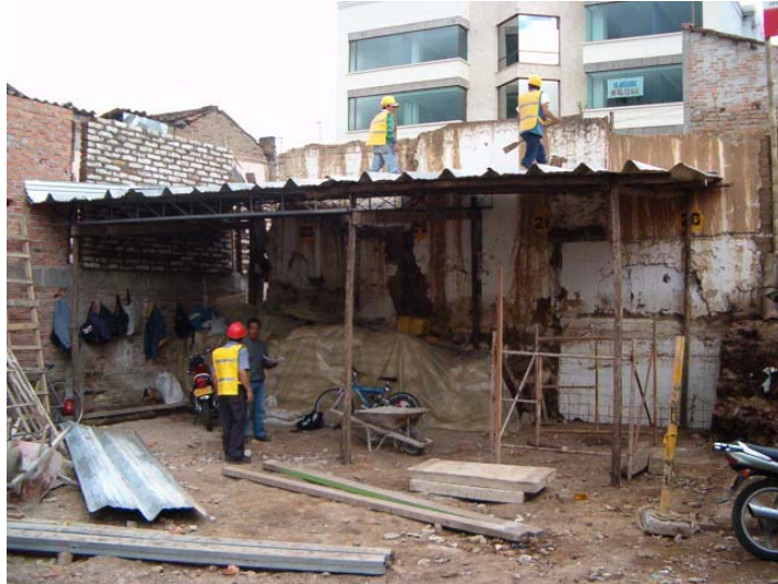
Figura 8. Construcción del campamento provisional.
