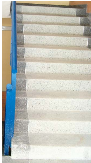
Figura 190. Escalera y rampa terminadas.
