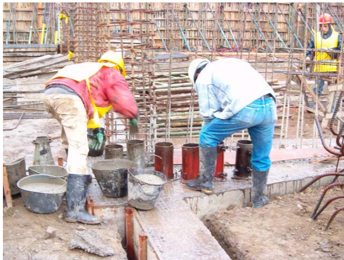
Figura 44. Toma de cilindros.
