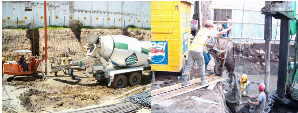
Figura 16. Fundición de pilotes con la mixer y con buggys.
