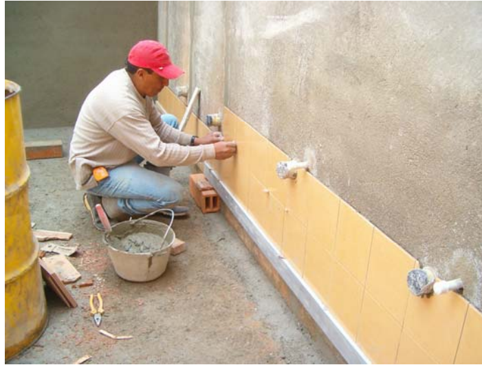
Figura 191. Enchapado de pared.
