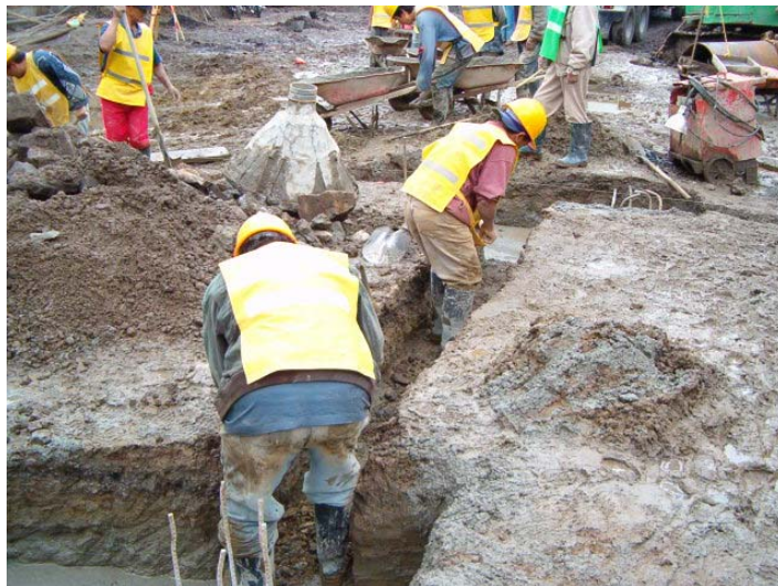
Figura 29. Excavación de vigas de cimentación.
