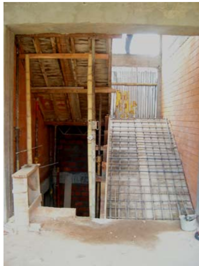
Figura 120. Encofrado y armado del refuerzo de las escaleras.
