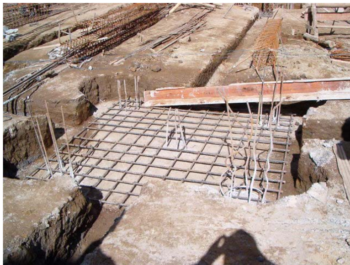
Figura 25. Refuerzo de zapatas y refuerzo de pilotes.
