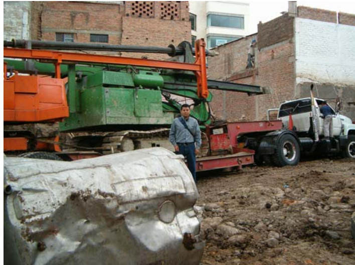
Figura 9: Equipos para pilotaje.
