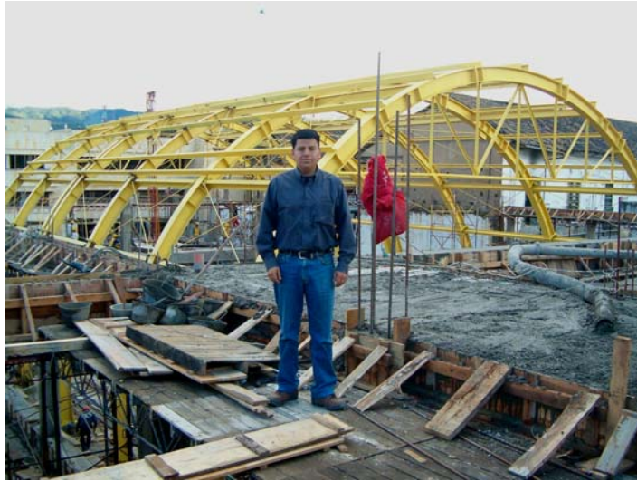
Figura 80. Fundición del nivel +7.00
