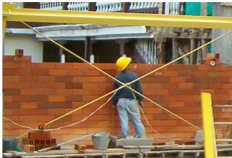
Figura 157. Pega de ladrillo farol.
