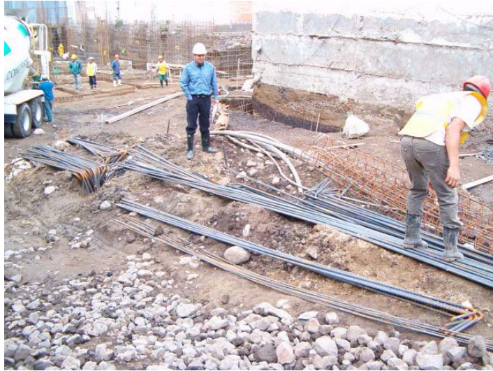
Figura 24. Supervisión de llegada a obra del figurado.
