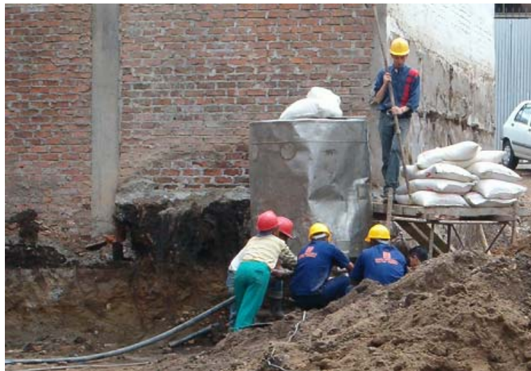
Figura 11. Máquina para la preparación de lodo bentonítico.
