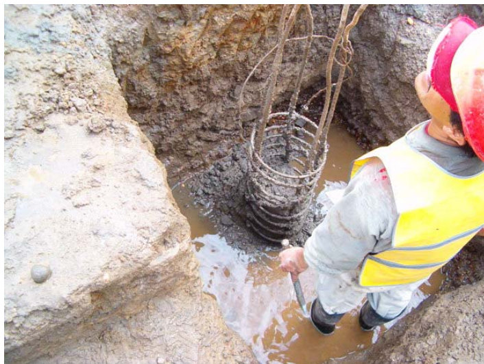
Figura 19. Descabezado de pilotes a mano.
