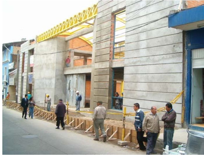
Figura 178. Encofrado de sardineles.
