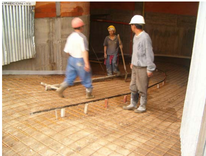
Figura 123. Rampa del parqueadero lista para la fundición.
