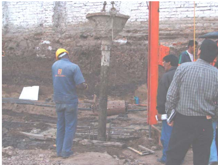
Figura 15. Embudo con los canales metálicos.
