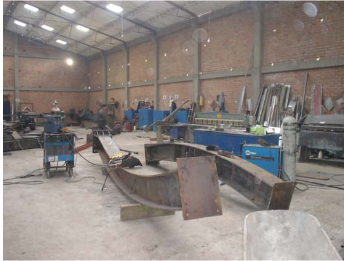
Figura 88. Armado de la estructura metálica en fábrica.
