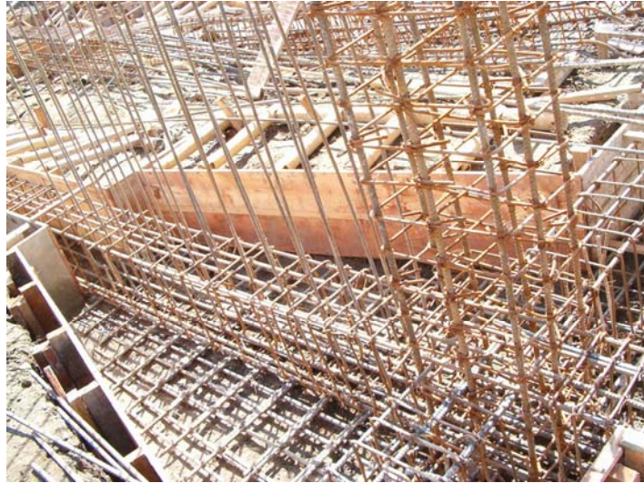
Figura 50. Armado de refuerzo de pantalla.
