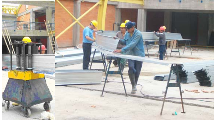
Figura 117. Máquina para dar curva al aluzinc.
