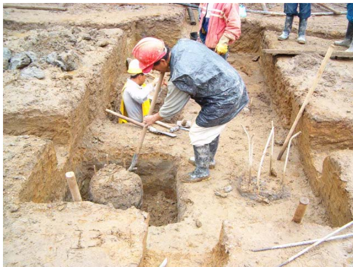
Figura 21. Excavación de zapatas.
