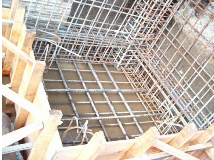
Figura 40. Armado de zapatas y vigas de cimentación del lindero
