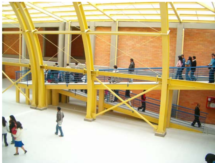
Figura 125. Rampa peatonal totalmente terminada.
