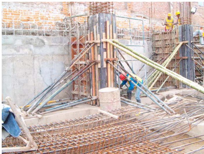
Figura 52. Encofrado de pantalla.
