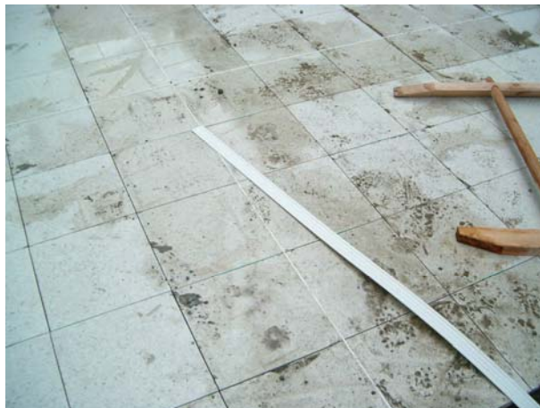
Figura 187. Láminas de dilatación plástica para baldosa.
