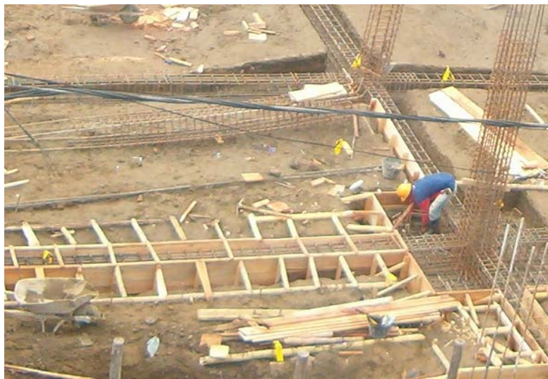
Figura 32. Formaletas para vigas de cimentación.
