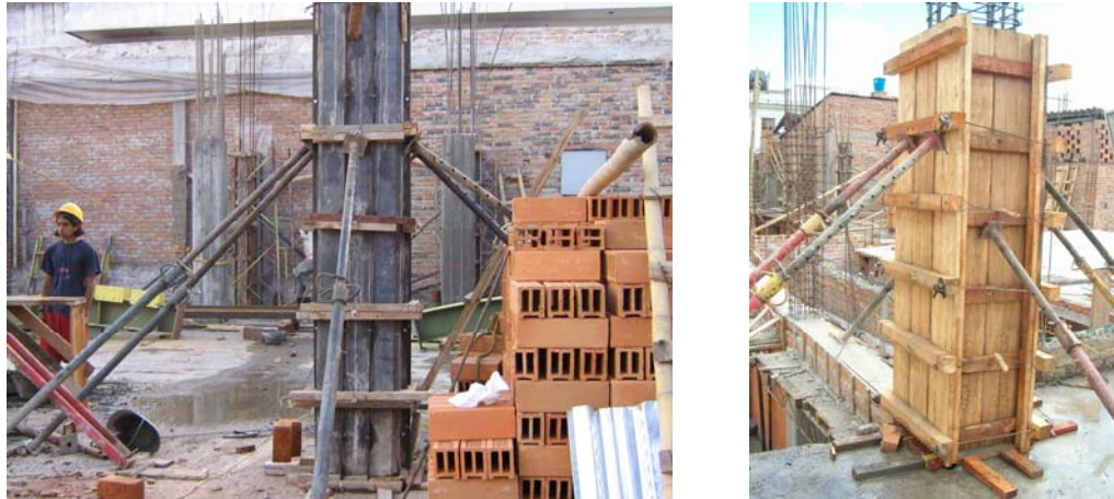
Figura 58. Formaleta metálica y de madera.
