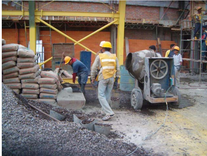
Figura 61. Concreto hecho en obra.
