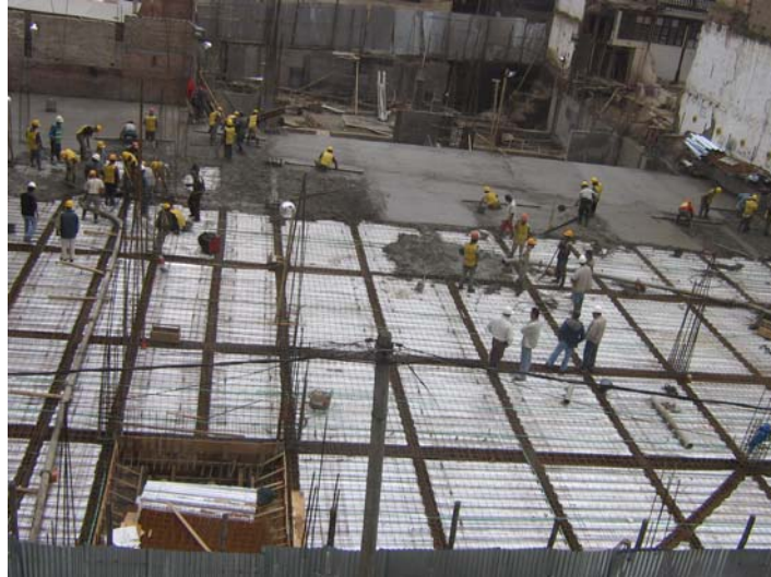
Figura 73. Panorámica de fundición de losa.
