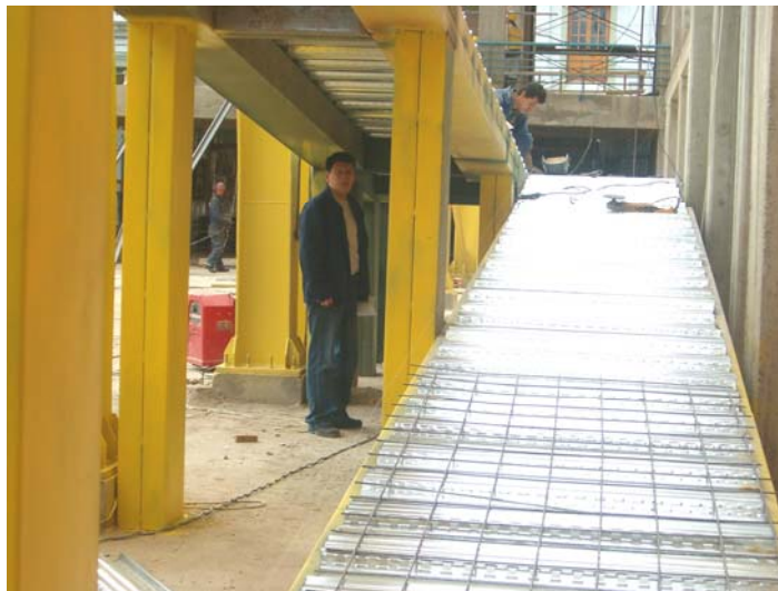
Figura 128. Preparación de la placa de la rampa.
