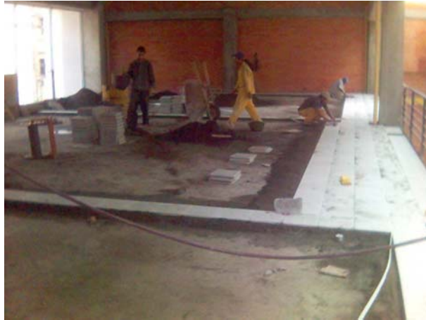
Figura 186. Instalación de baldosas en mezanine.
