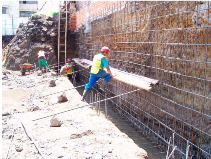
Figura 38. Armado de refuerzo de muro de contención.
