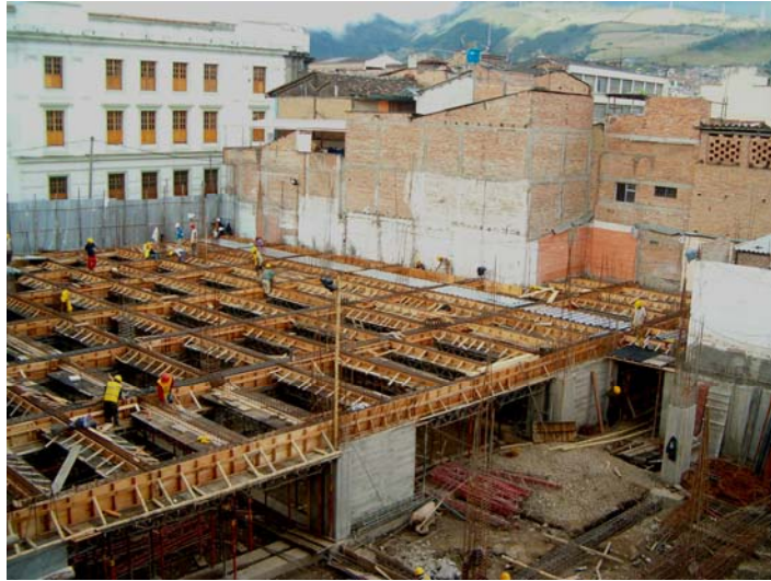
Figura 68. Panorámica del encofrado de vigas.
