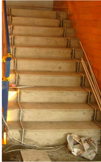
Figura 189. Dilataciones para granito.
