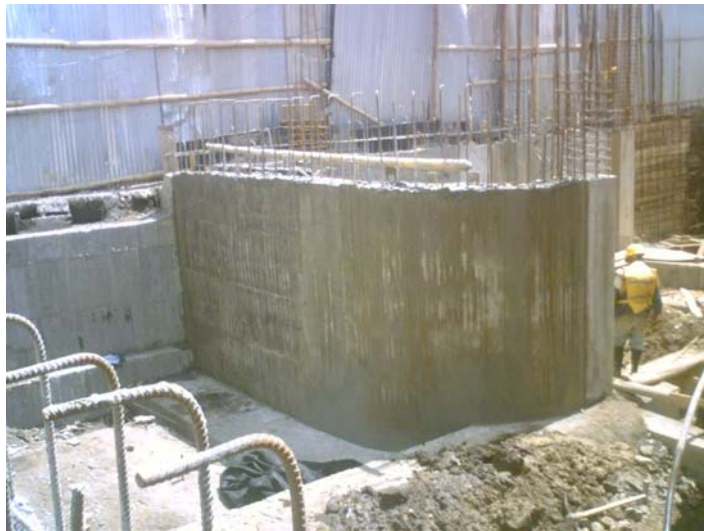
Figura 48. Muro de contención de la rampa terminado.
