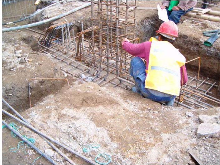
Figura 31. Armado de las vigas de cimentación.
