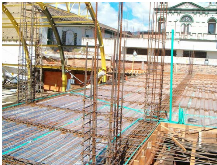
Figura 153. Instalación de la tubería conduit.
