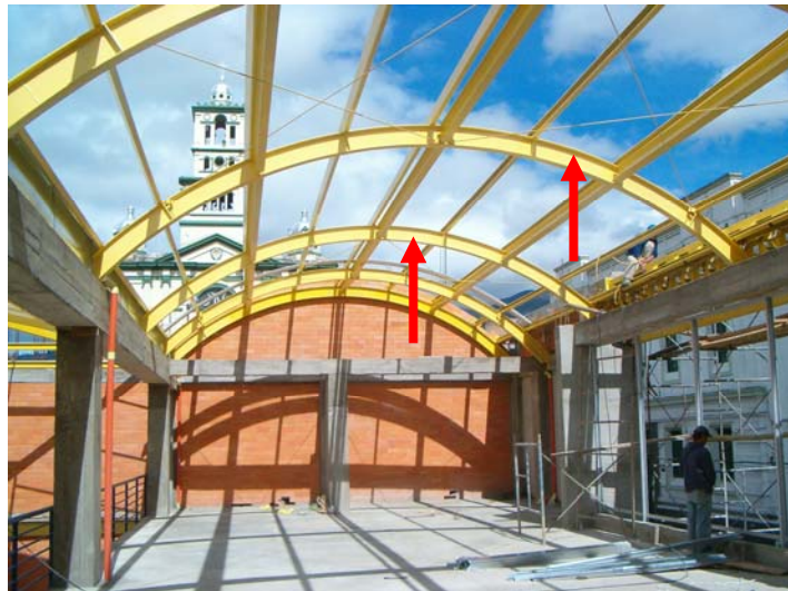
Figura 106. Arcos IPE-270 instalados.
