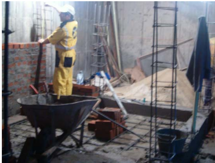
Figura 135. Construcción del tanque de red contra incendios.
