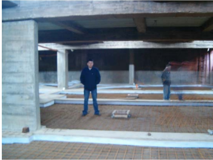
Figura 86. Refuerzo y dilatación.
