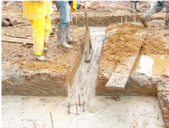
Figura 30. Solado de limpieza.
