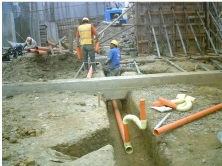
Figura 139. Zanjas para la instalación de la tubería sanitaria.
