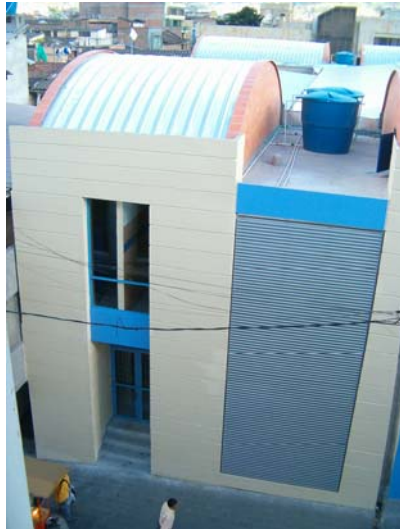
Figura 171. Persiana de la fachada.
