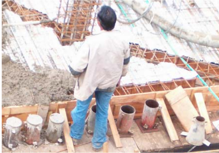
Figura 77. Toma de cilindros.
