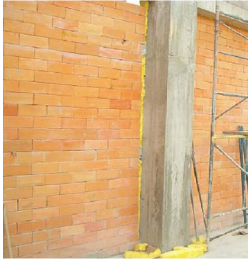
Figura 163. Instalación de lana mineral.
