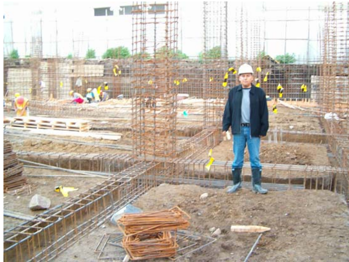
Figura 26. Armado de refuerzo.
