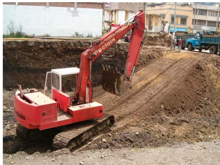
Figura 7. Rampa provisional.
