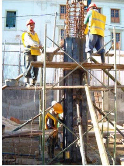
Figura 60. Vaciado a mano y vibrado del concreto.
