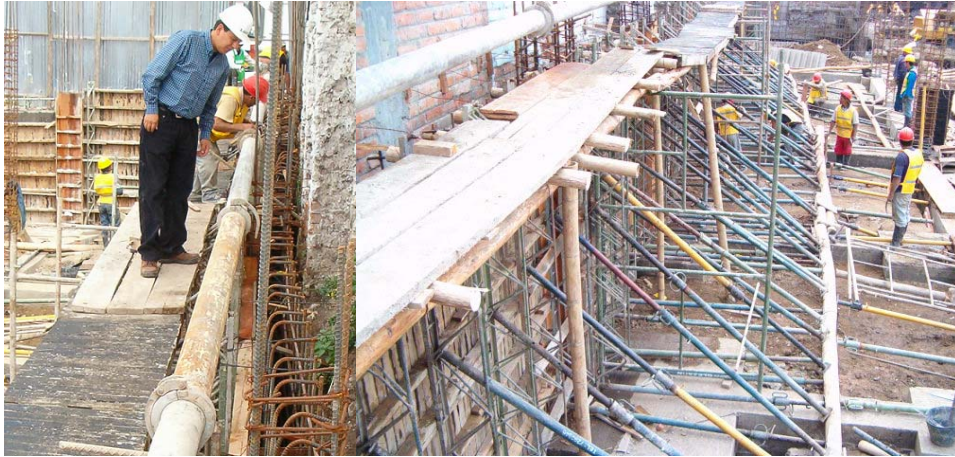
Figura 42. Formaleta del muro de contención.
