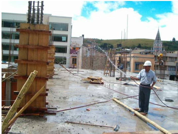
Figura 78. Curado de las losas.
