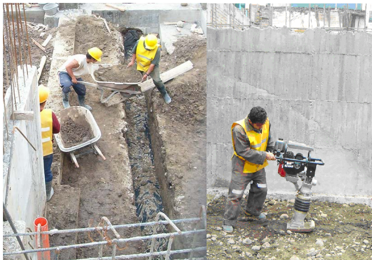
Figura 133. Relleno y compactación de zanjas para el filtro.
