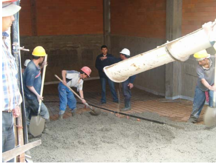
Figura 124. Fundición de la rampa del parqueadero.
