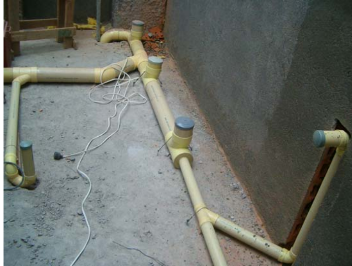
Figura 142. Instalación sanitaria.
