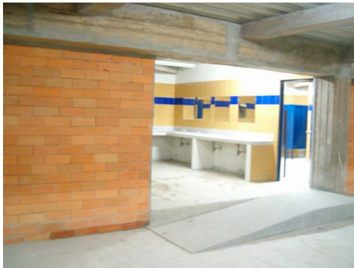
Figura 181. Rampa para los baños del sótano.
