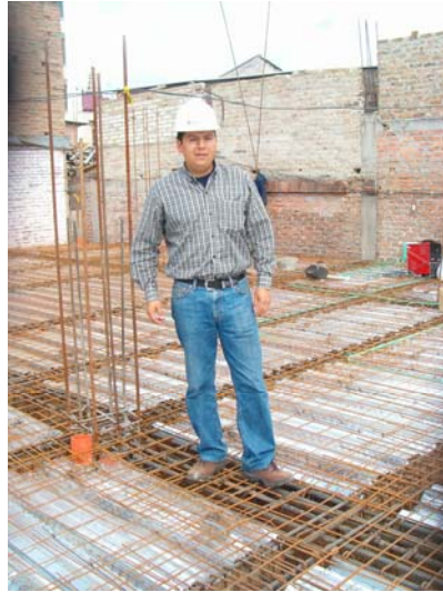
Figura 72. Mallas por momento negativo y por temperatura.
