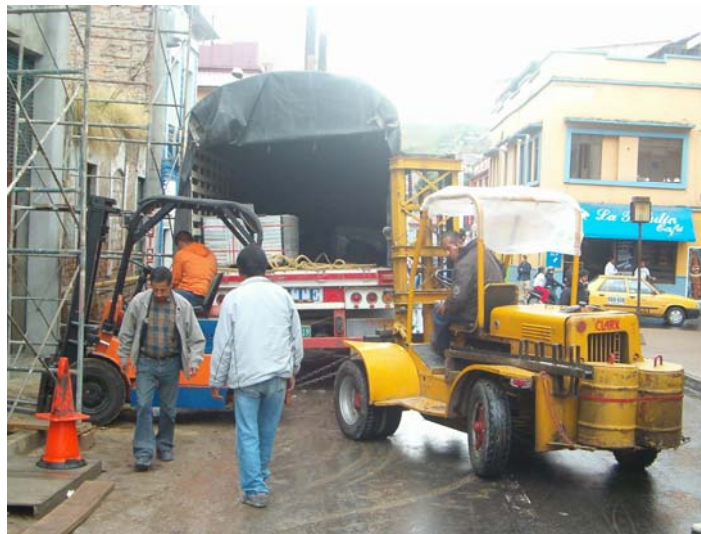
Figura 185. Descargue de las baldosas.
