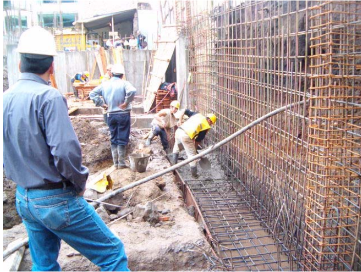
Figura 39. Fundición de zarpa.
