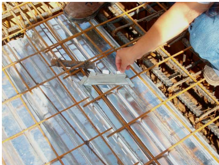
Figura 70. Tapas laterales para el metaldeck.
