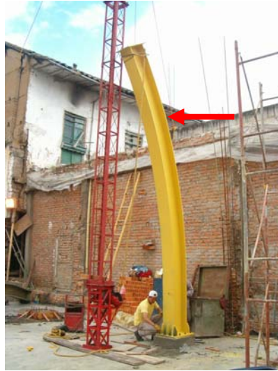
Figura 90. Primera sección que se instaló del arco HEA-400.
