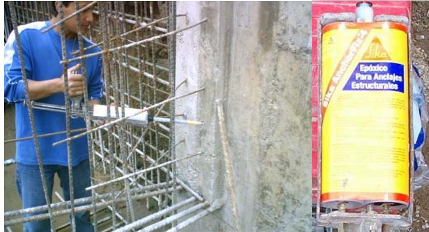
Figura 51. Instalación de anclajes estructurales.
