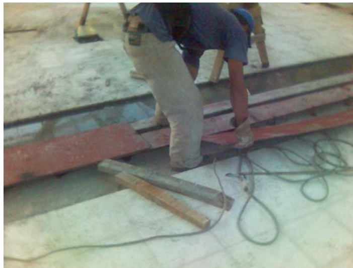
Figura 200. Instalación de platinas de soporte.
