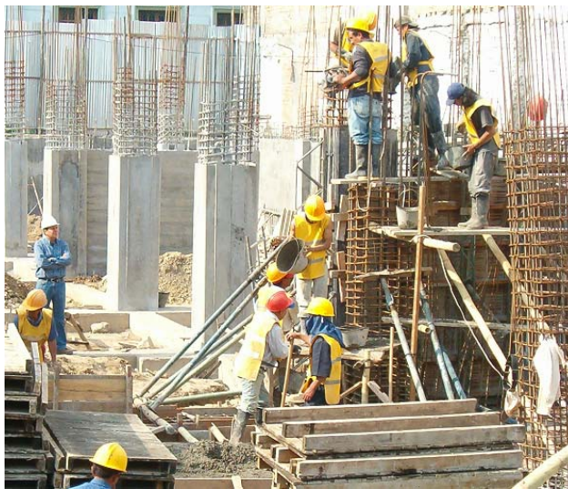
Figura 53. Fundición de pantallas.
