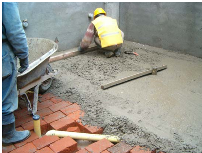
Figura 143. Fundición de losa de baños.
