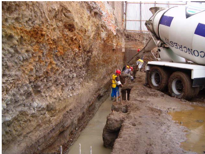
Figura 36. Perfilado, excavación y fundición de concreto ciclópeo.
