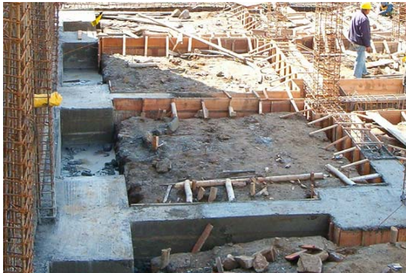
Figura 33. Fundición de vigas de cimentación.
