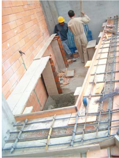
Figura 192. Armado de mesones de concreto reforzado.
