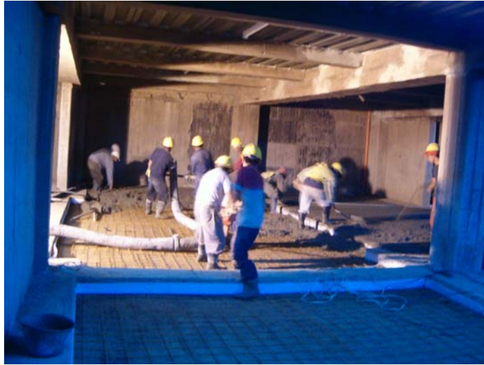
Figura 87. Fundición de la losa de piso.
