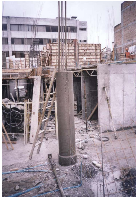
Figura 50. Desencofrado de formaleta de columna circular.
