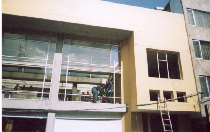
Figura 75. Acabado fachada principal.
