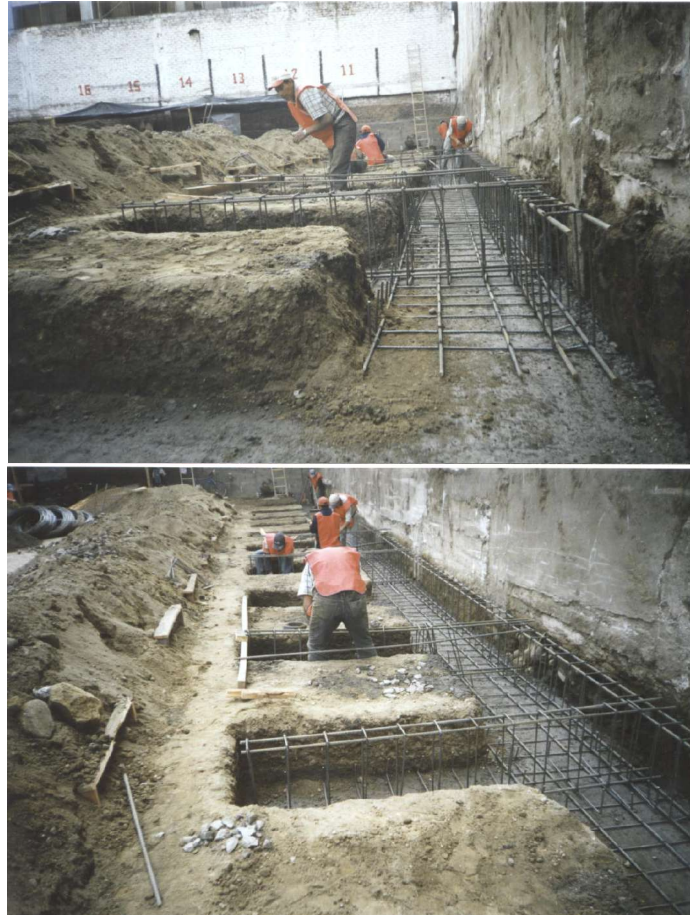
Figura 35. Armado de hierros en vigas de cimentación.
