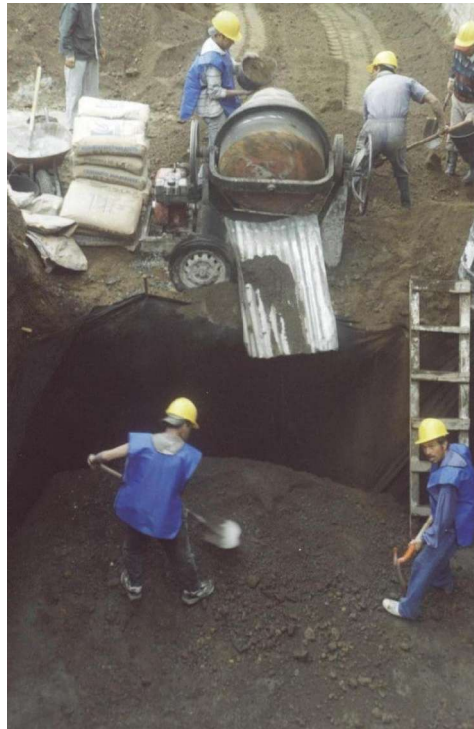
Figura 22. Vaciado de la mezcla suelo – cemento.
