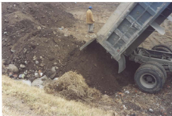
Figura 17. Desalojo de Escombros. Botadero El Chambú.
