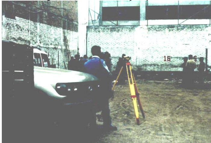
Figura 18. Localización y Replanteo.
