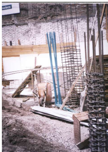
Figura 47. Armado de hierros. Columna circular.
