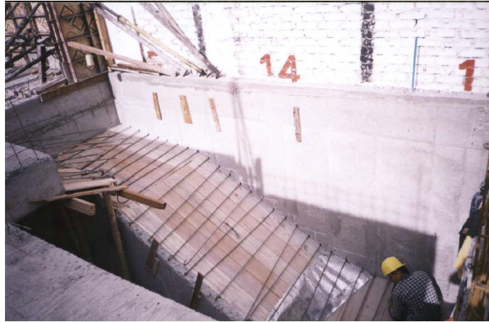
Figura 64. Vaciado del concreto en escaleras.
