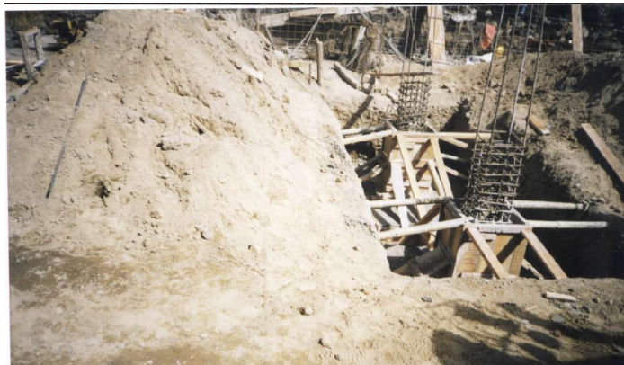
Figura 42. Formateado y colocación de hierros en el pedestal de la zapata.
