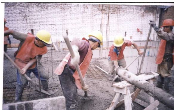
Figura 61. Vaciado del concreto en losa de entrepiso.
