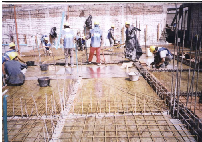
Figura 59. Colocación de malla electro soldada en placa de contrapiso.
