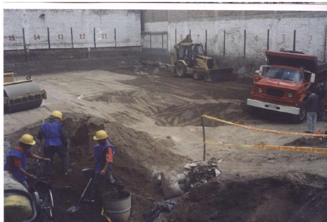
Figura 28. Transporte de relleno para compactar por volquetas.
