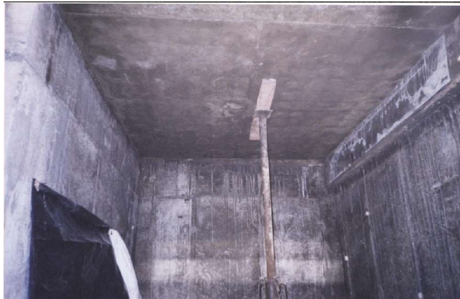
Figura 62. Desencofrado de formaleta de losa de entrepiso.
