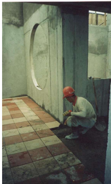
Figura 72. Colocación del piso en cerámica.
