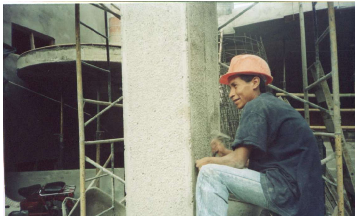
Figura 76. Abuzardado de Columnas.
