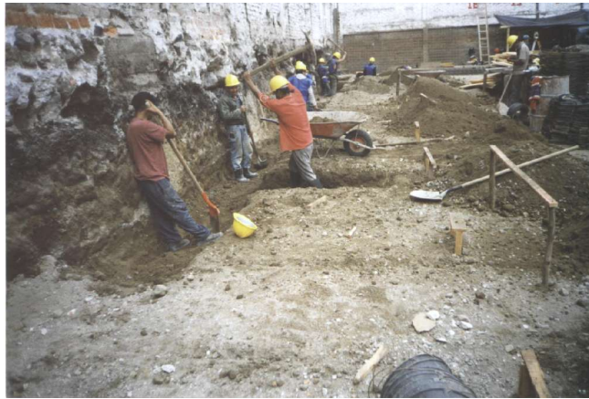
Figura 31. Puentes de referencia en excavación de vigas de cimentación.
