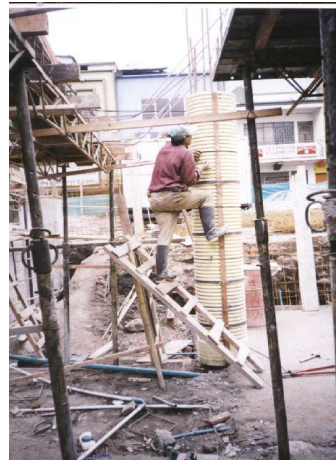
Figura 49. Colocación de formaleta (Tubo Novafort) para columna circular.
