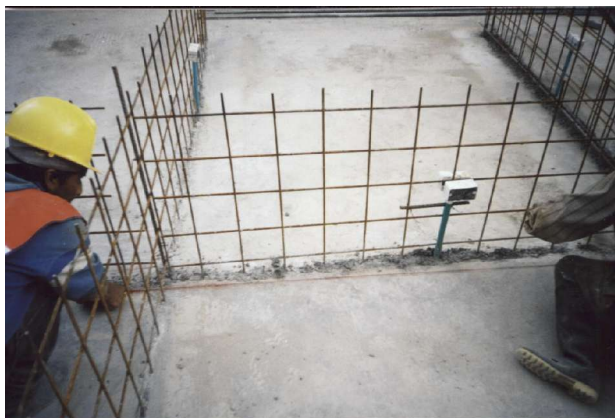
Figura 51. Cimbrado en el área donde se ubicara el muro estructural.
