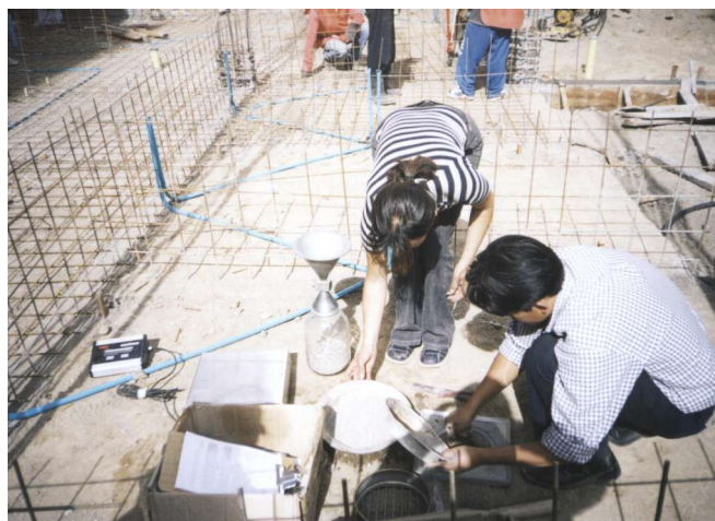
Figura 81. Ensayo de toma de densidades.
