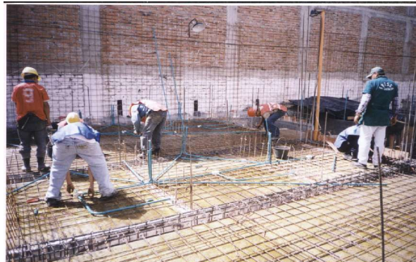
Figura 60. Instalación de tubería eléctrica, telefónica, sanitaria e hidráulica.
