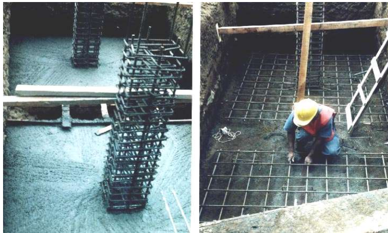
Figura 42. Formateado y colocación de hierros en el pedestal de la zapata.
