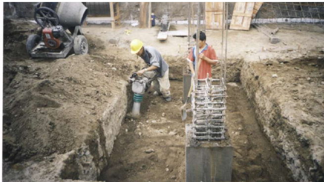
Figura 44. Esquema donde se rellena y se compacta con saltarín la zapata.
