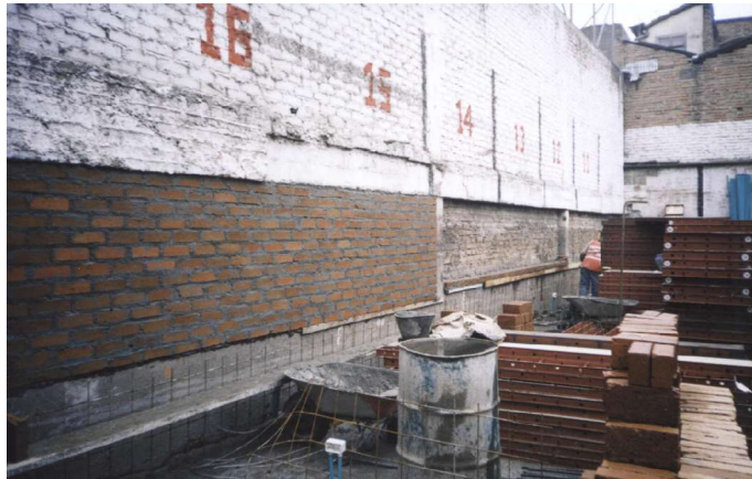
Figura 71. Mampostería en ladrillo tolete común.
