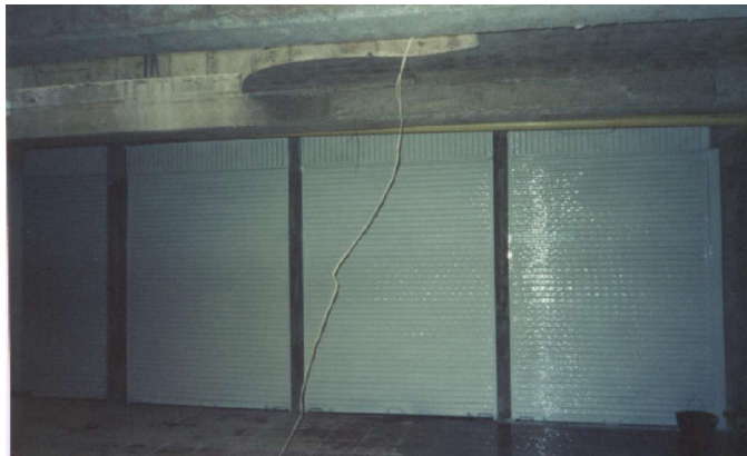
Figura 69. Instalación de puertas.
