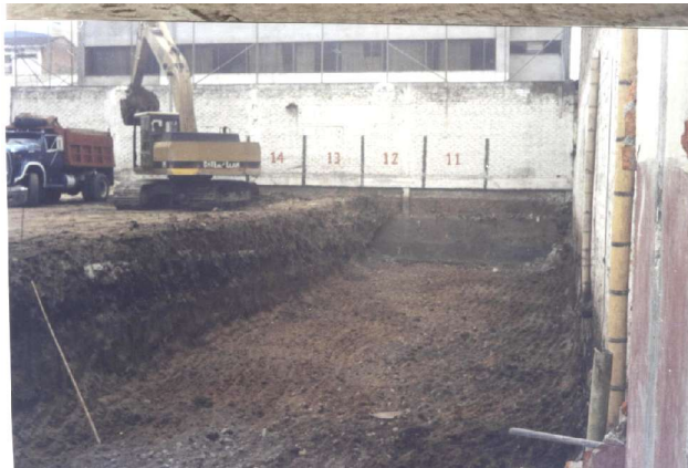
Figura 19. Excavación con Retroexcavadora a – 2.44 m de Profundidad.
