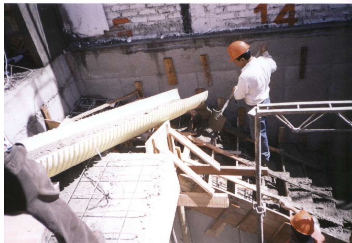
Figura 64. Vaciado del concreto en escaleras.
