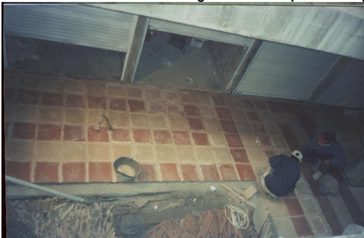
Figura 74. Emboquillado del piso.
