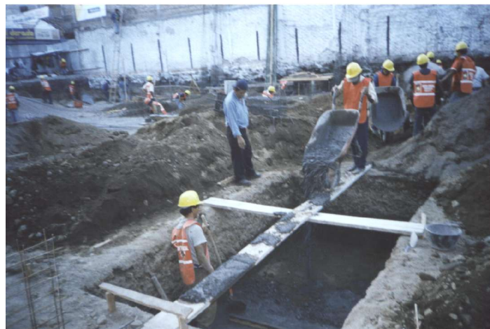
Figura 40. Vaciado de Solado de limpieza en zapatas.
