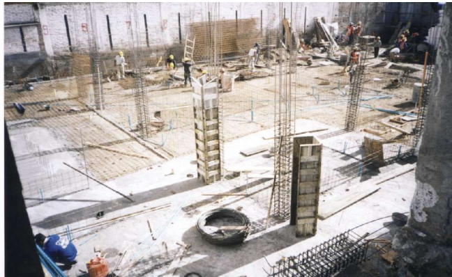
Figura 47. Armado de hierros. Columna circular.
