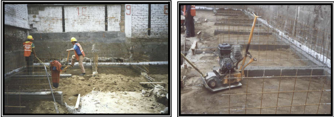
Figura 38. Relleno y compactación de vigas de cimentación.
