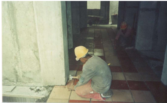
Figura 73. Utilización del chipote en la colocación del piso.
