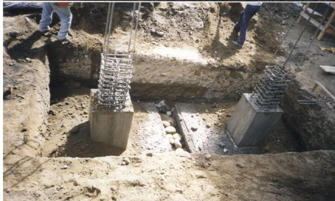
Figura 44. Esquema donde se rellena y se compacta con saltarín la zapata.
