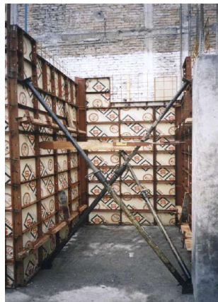
Figura 53. Instalación de Formaleta (Symons) para muros estructurales.
