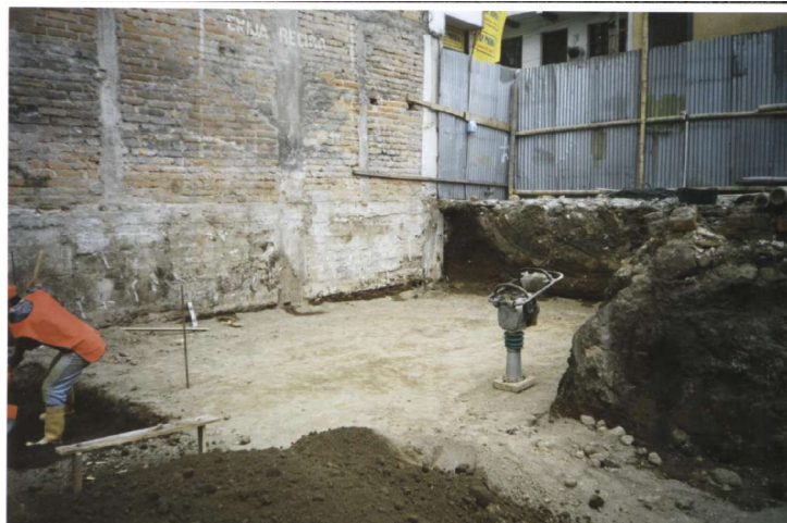
Figura 26. Compactación del plinto con recebo.
