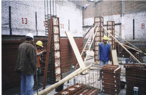
Figura 49. Colocación de formaleta (Tubo Novafort) para columna circular.
