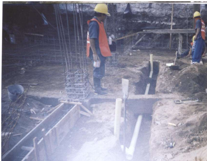
Figura 78. Instalación de tubería sanitaria antes de fundir placa de piso.
