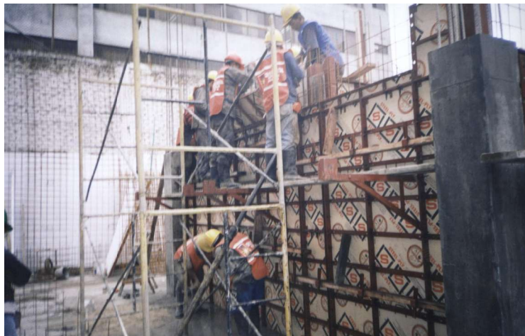
Figura 55. Vibrado, obreros con chipote pegándole en el muro estructural.
