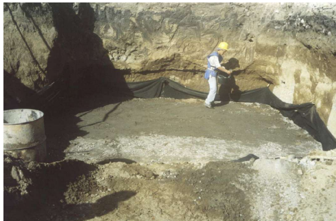
Figura 24. Parte superior del plinto.
