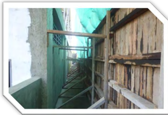
Formaleta para muro
