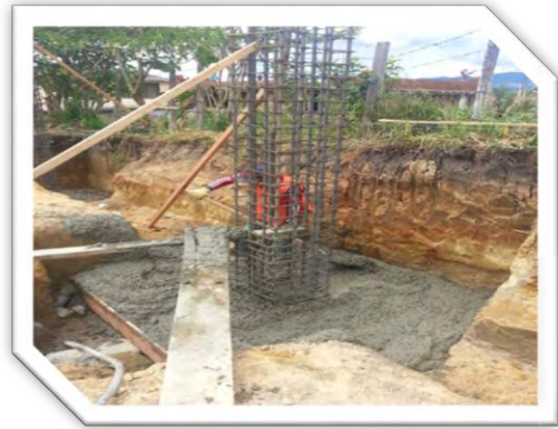
Fundición de zapatas con concreto 3000 PSI
