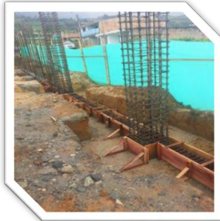
Figura 23. Formaleta en madera amarillo para vigas de cimentación
