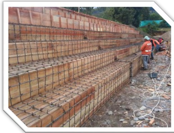
Figura 20. Acero de refuerzo vigas aéreas longitudinales gradería
