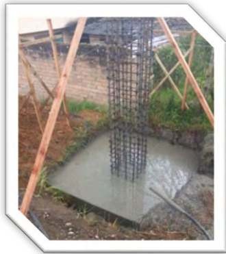
Fundición de zapatas utilizando vibrador de aguja
