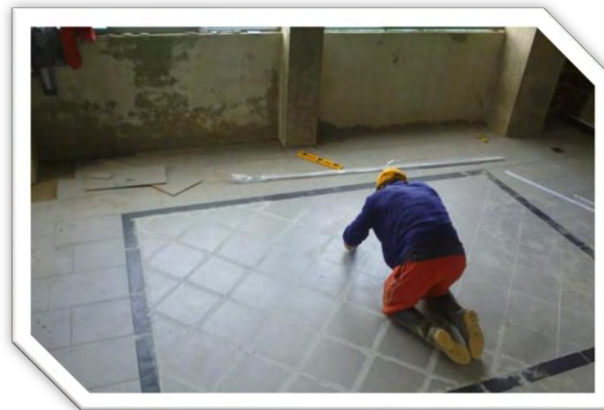
Figura 62. Enchape para pisos oficina
