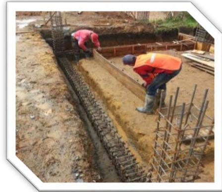
Acero de refuerzo para columnas de 30 x 30 cm
