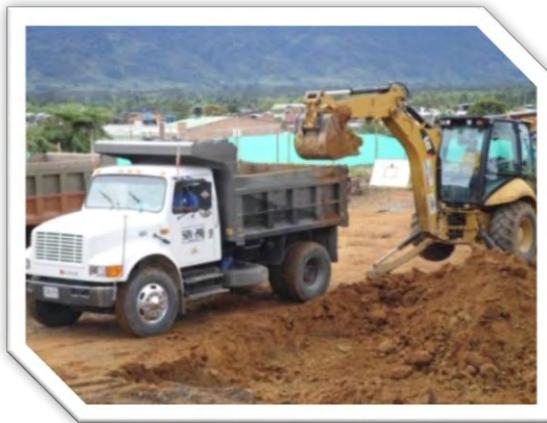
Figura 9. Desalojo de materia excavado
