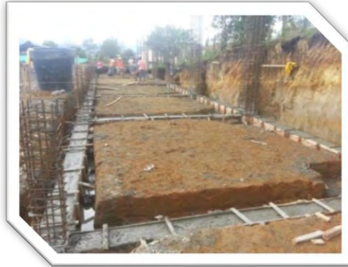
Figura 24. Fundición de vigas de cimentación eje 1 y 2
