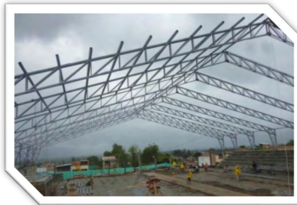
Figura 49. Instalación de perfiles cajón
