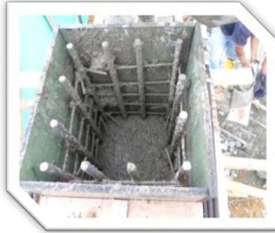
Figura 30. Fundición de columnas 30 x 30 m ejes 2 y 4
