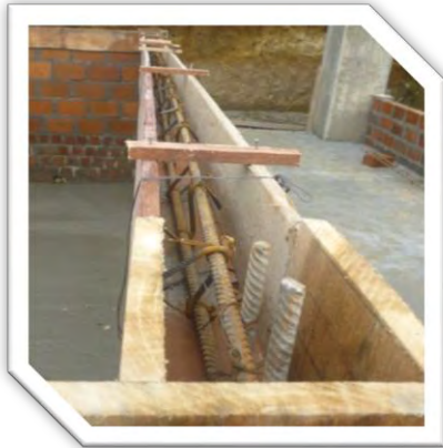
Acero de refuerzo viguetas muros
