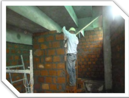
Muros en soega duchas
