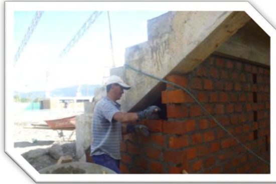
Figura 37. Muro en saga accesos
