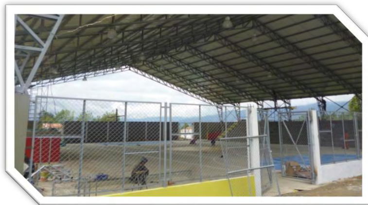
Cerramiento fachada posterior
