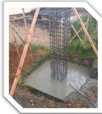
Figura 22. Fundición de zapatas utilizando vibrador de aguja
