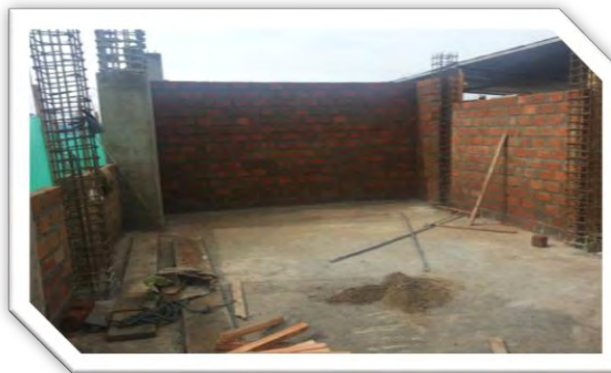
Figura 36. Muros en soga oficina
