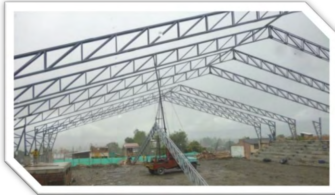
Figura 43. Cerchas instaladas en pedestales
