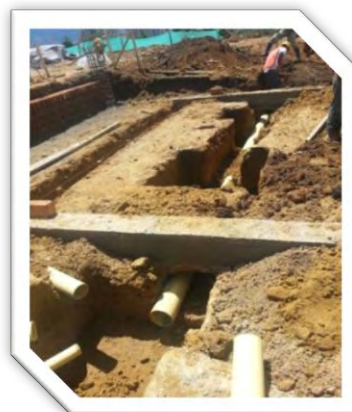
Figura 25. Instalación de tubería sanitaria
