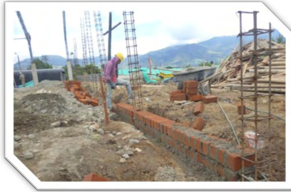
Figura 21. Acero de refuerzo columnetas muros
