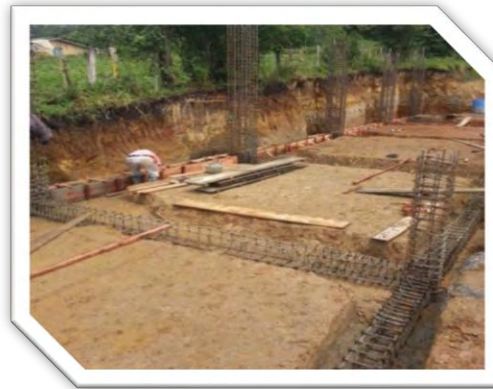
Figura 14. Acero de refuerzo para vigas de cimentación ejes 1 y 5
