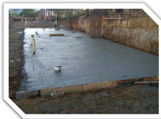
Figura 26. Losa piso camerinos + malla electrosoldada
