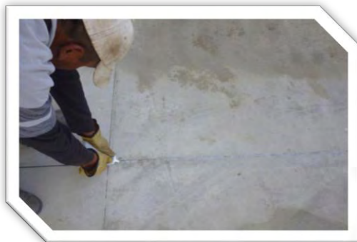
Figura 59. Sellado de juntas utilizando sikaflex 2C SL
