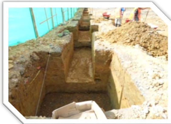
Figura 7: Excavación para vigas de cimentación eje 5
