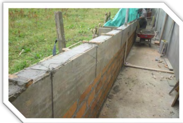
Muro en mampostería
