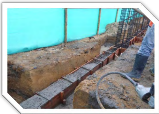
Vigas de cimentación eje 5 y 4
