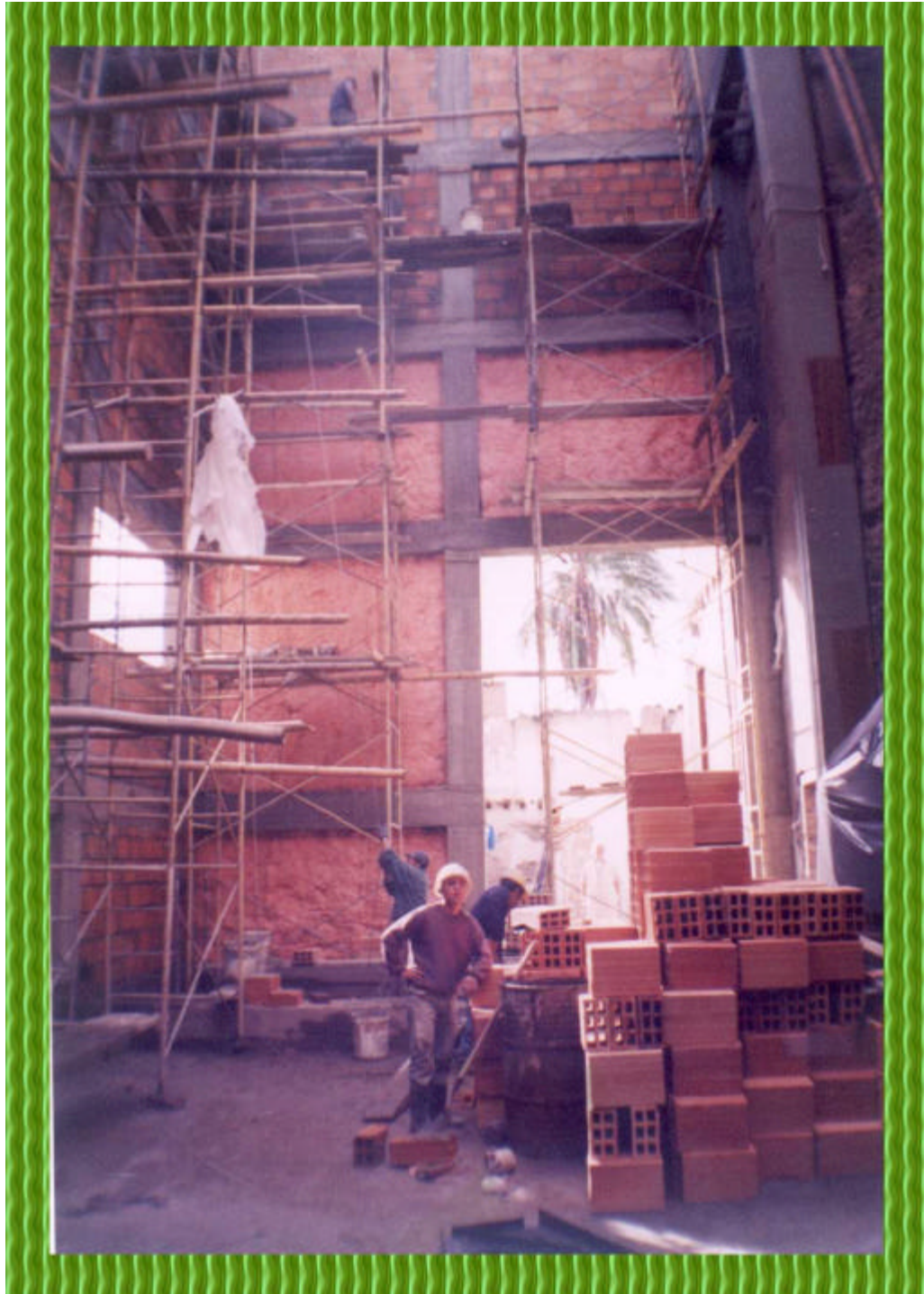
Foto 128. Colocación de frescasas en los muros sencillos de los pórticos No. 1
