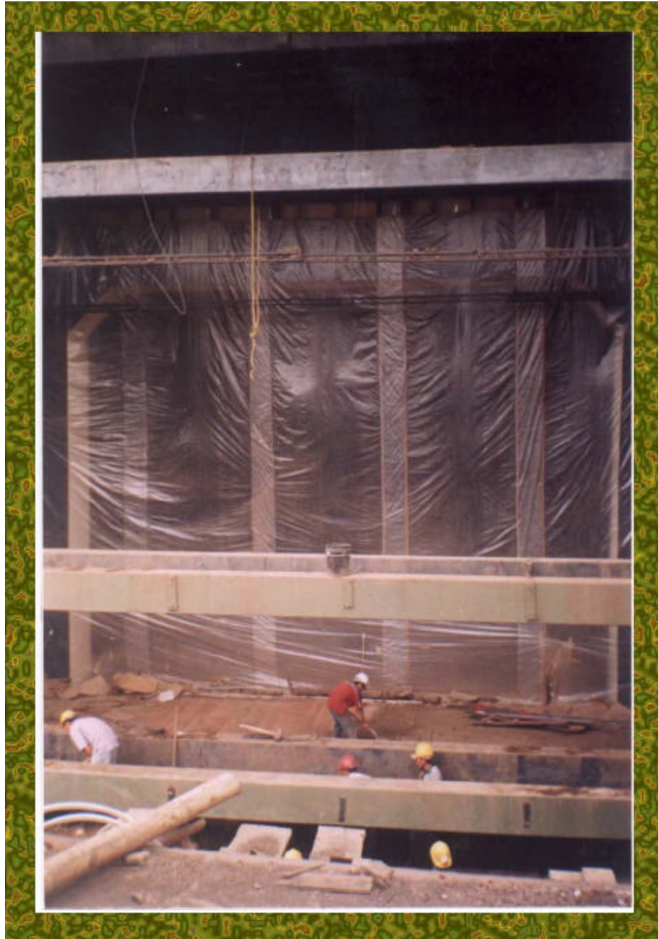
Foto 3. Demolición casi total de la tapia pisada, donde claramente se aprecia la Boca del Escenario
