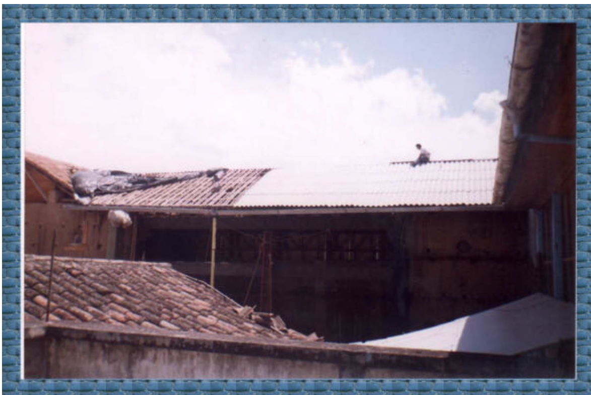
Foto 168. Desmonte de tejas de barro y montaje provisional de tejas de Asbesto-Cemento y poder utilizar el teatro en eventos durante los Juegos Nacionales Universitarios
