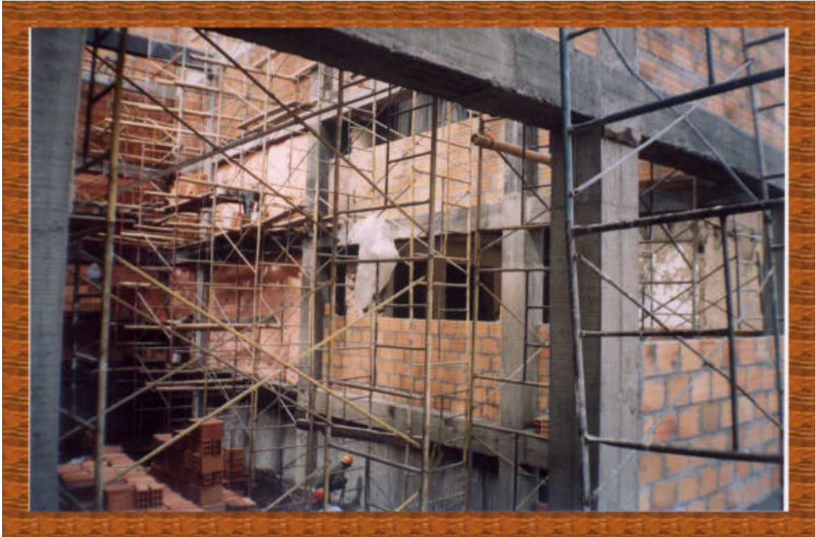
Foto 124. Muro sencillo, construido luego de haber colocado la frescaca
