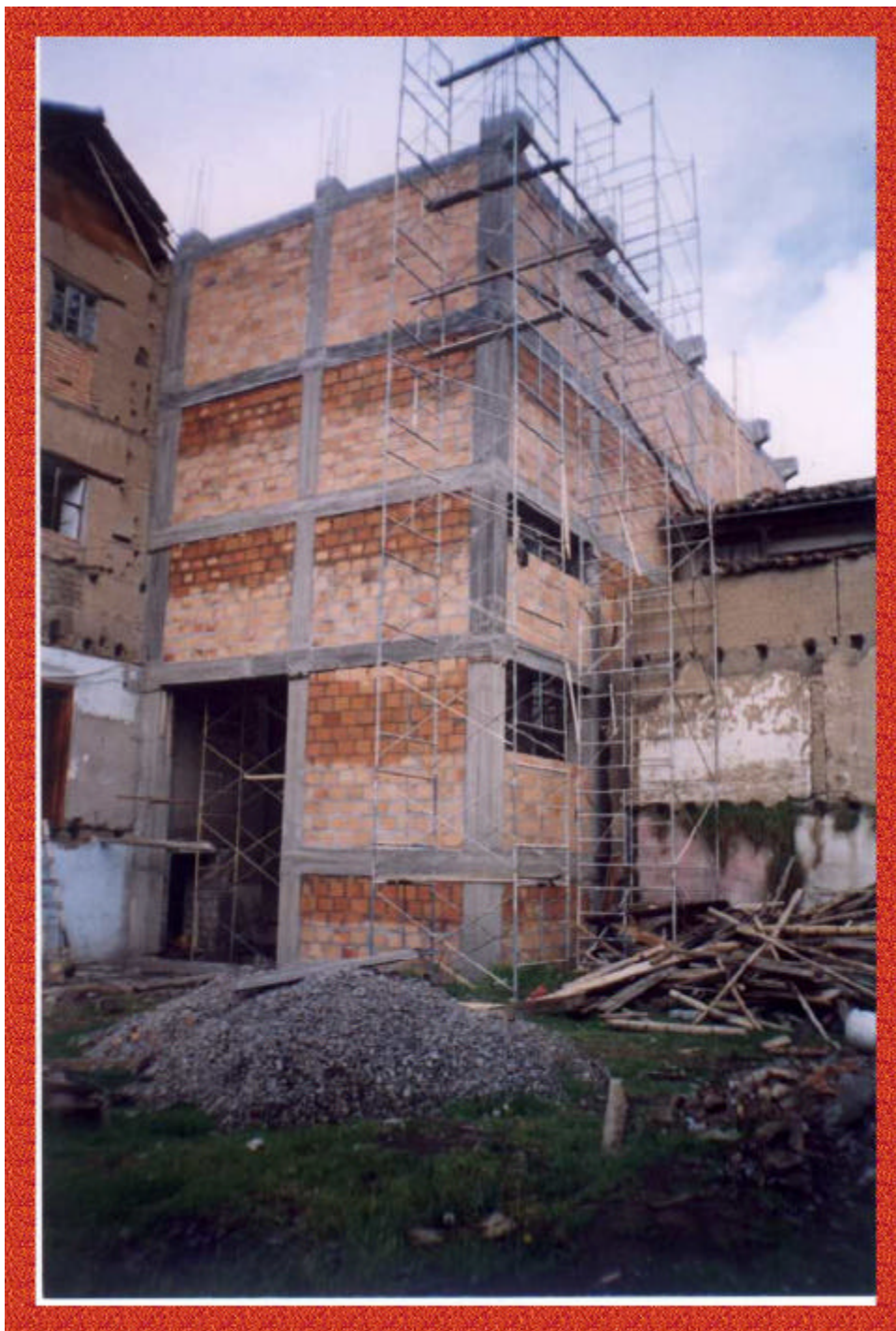
Foto 111. Los pórticos de la estructura han sido trabajados con ladrillo o farol o bloque No. 5
