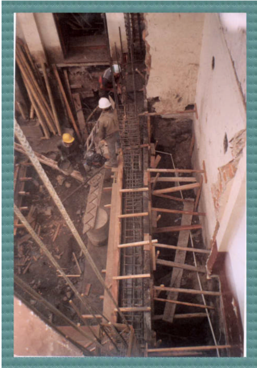
Foto 52. Fundición primera viga
