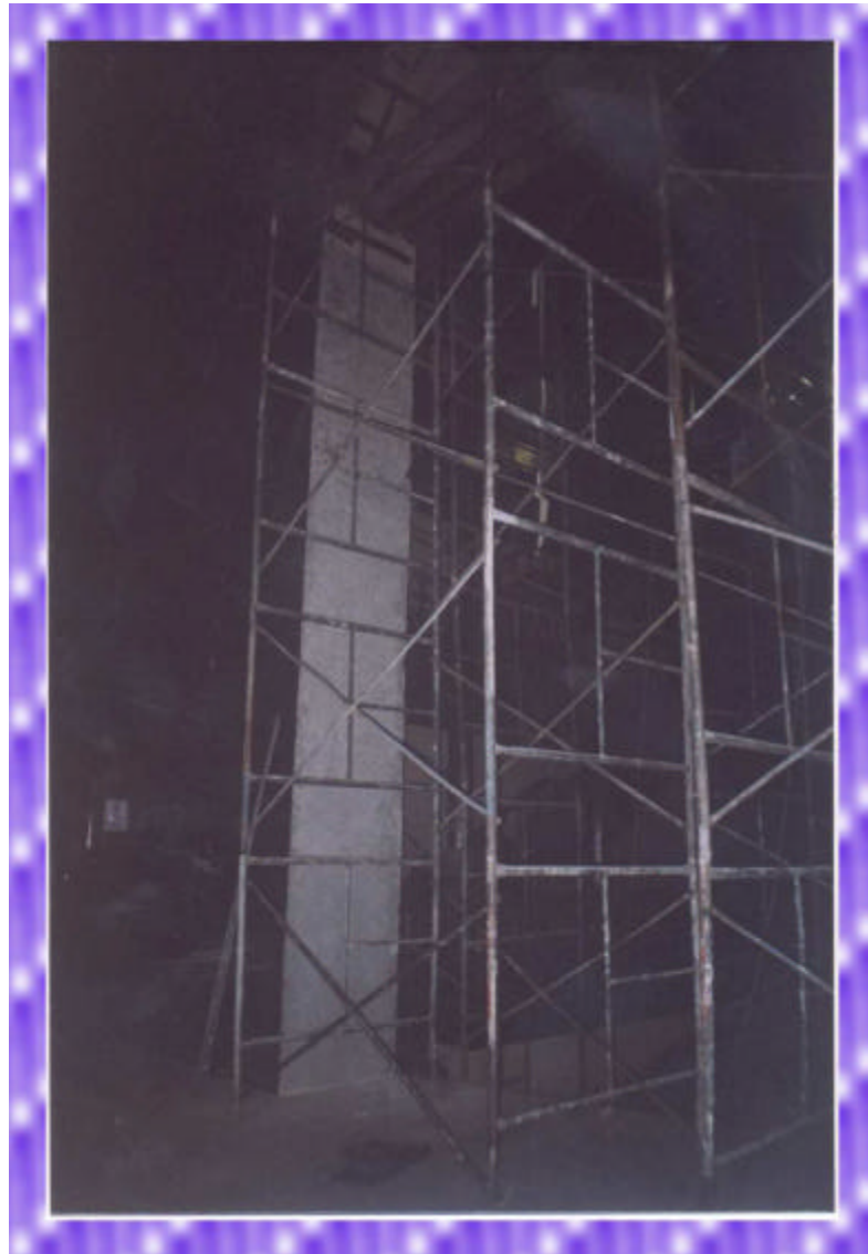
Foto 151. Retiro del estuco de las columnas ubicadas en la boca del escenario
