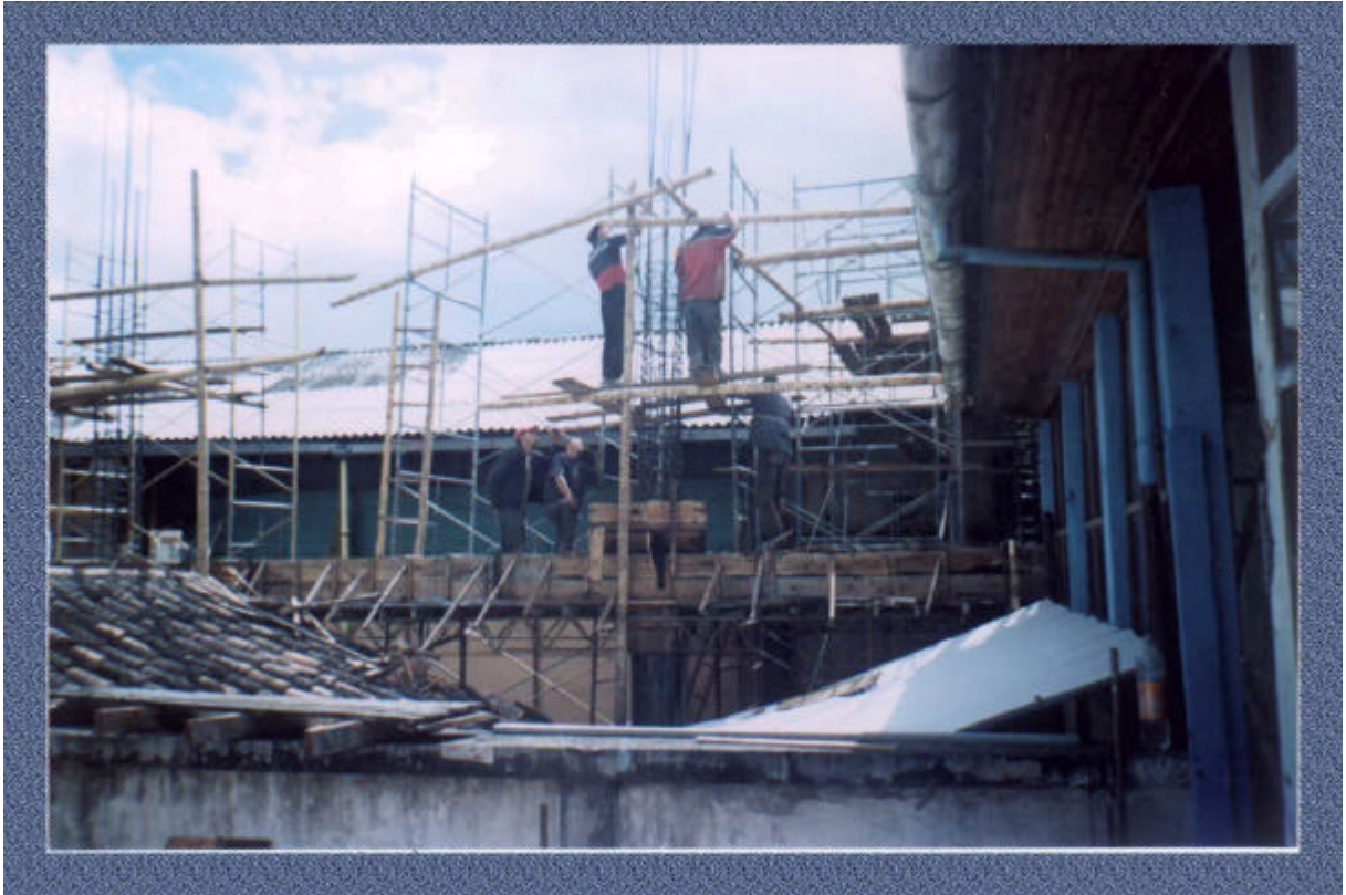
Foto 67. Armado y figurado del hierro de las ménsulas, las cuales se encuentran a 14.82m de alto
