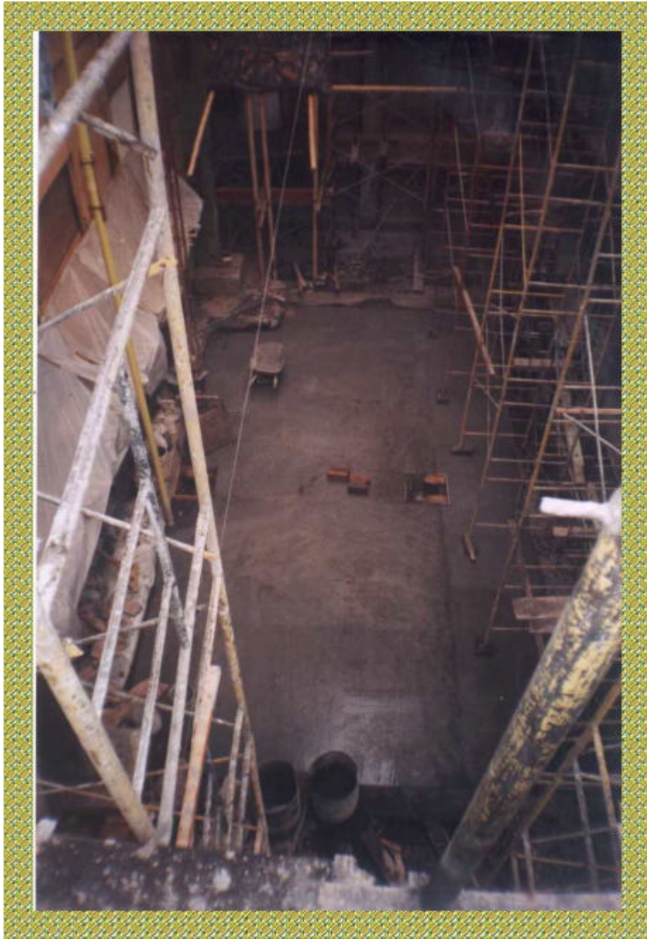
Foto 149. Fundición de la placa de piso de la ampliación del escenario
