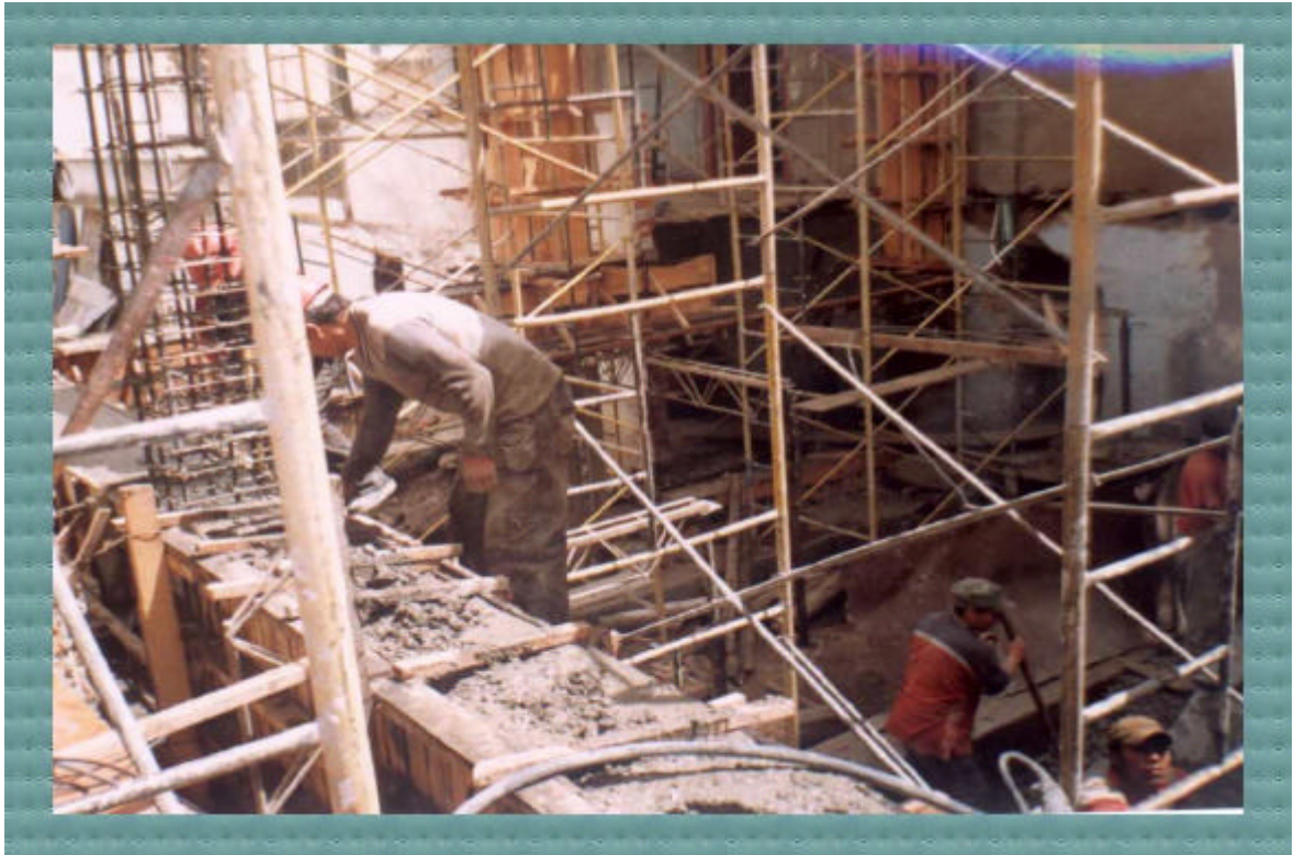
Foto 53 y 54. Fundición primera viga VD con vibrador para el concreto
