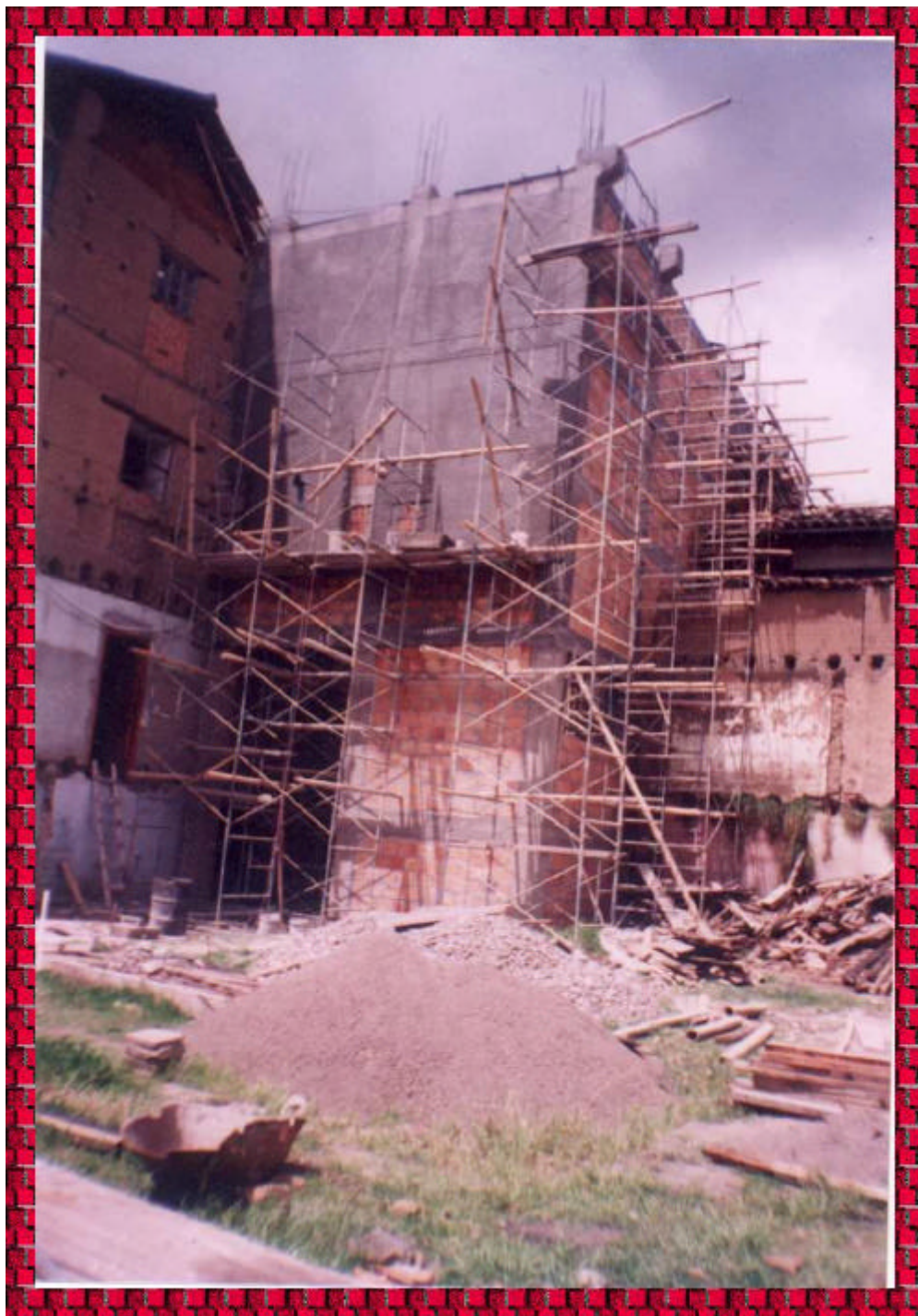
Foto 112. Estructura aporticada con ladrillo farol o bloque No. 5
