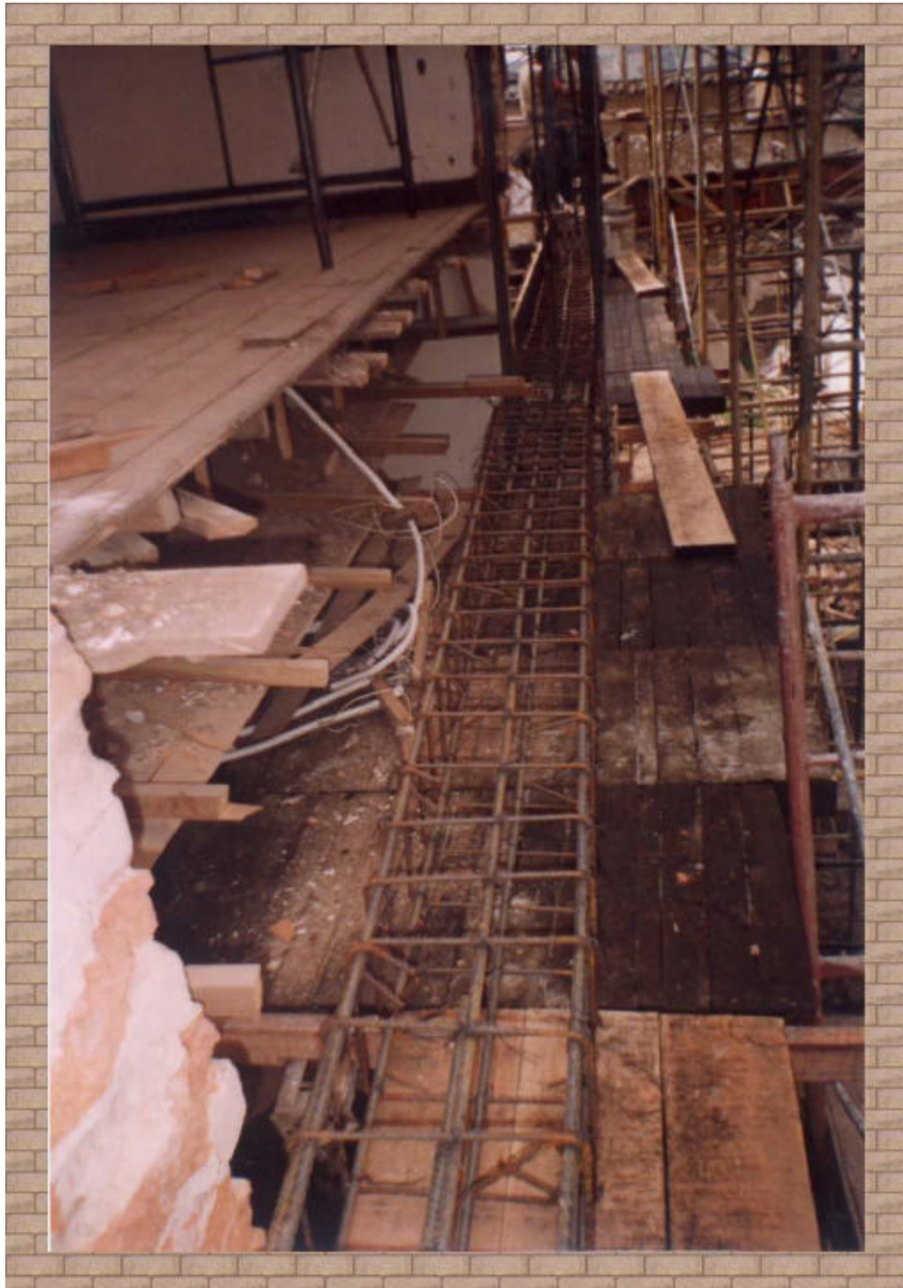
Foto 58. Se Comienza a encofrar viga VD del segundo nivel
