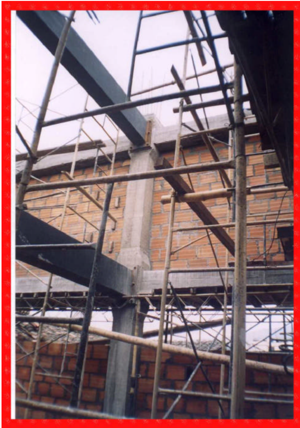
Foto 108. Vigas metálicas soldadas, pernadas, aseguradas a platina doble, en la estructura de concreto
