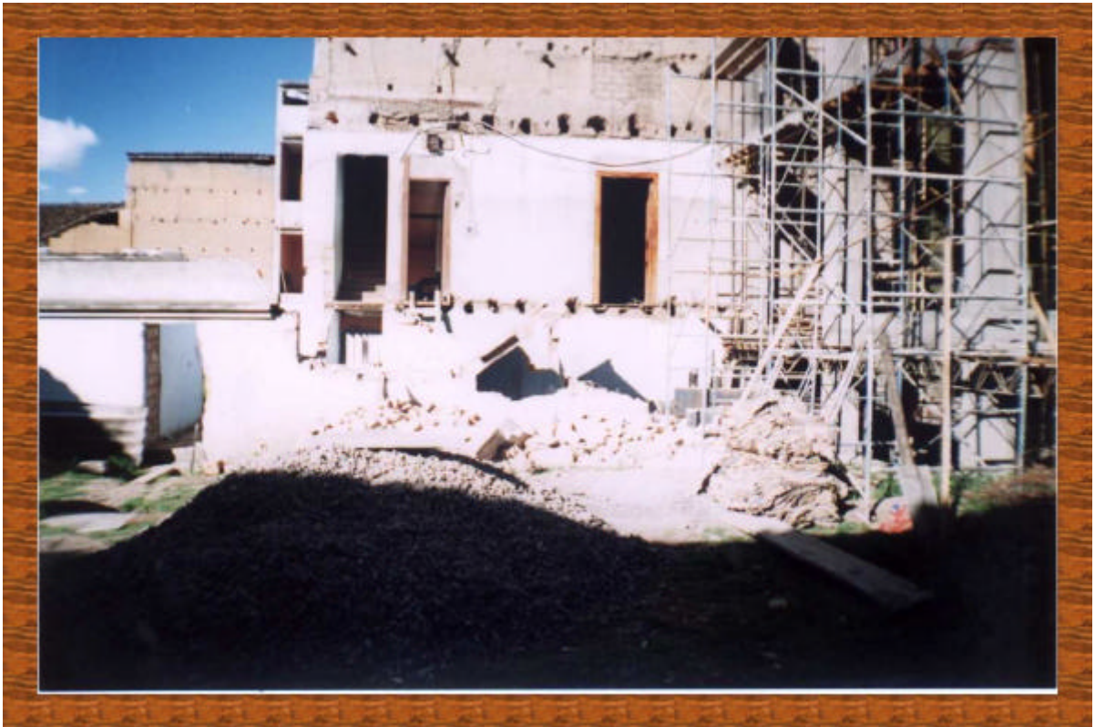
Foto 171. Desmonte de gradas de madera, demolición gradería de ladrillo o adobón
