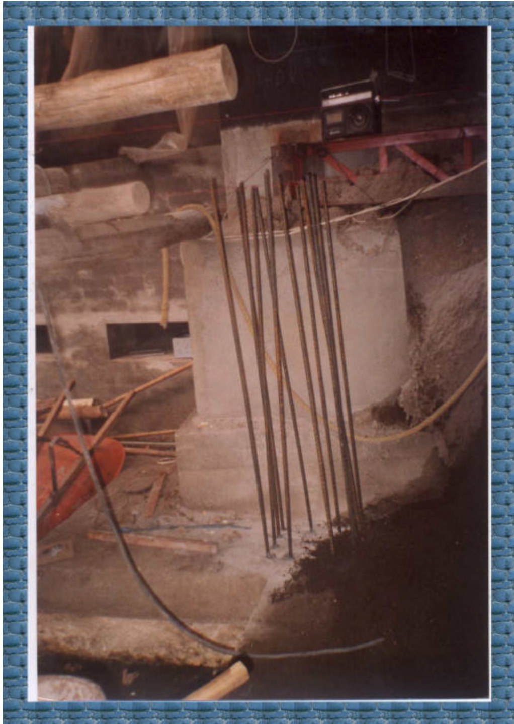
Foto 141. Realización de anclajes de 30cm en las vigas de cimentación existentes
