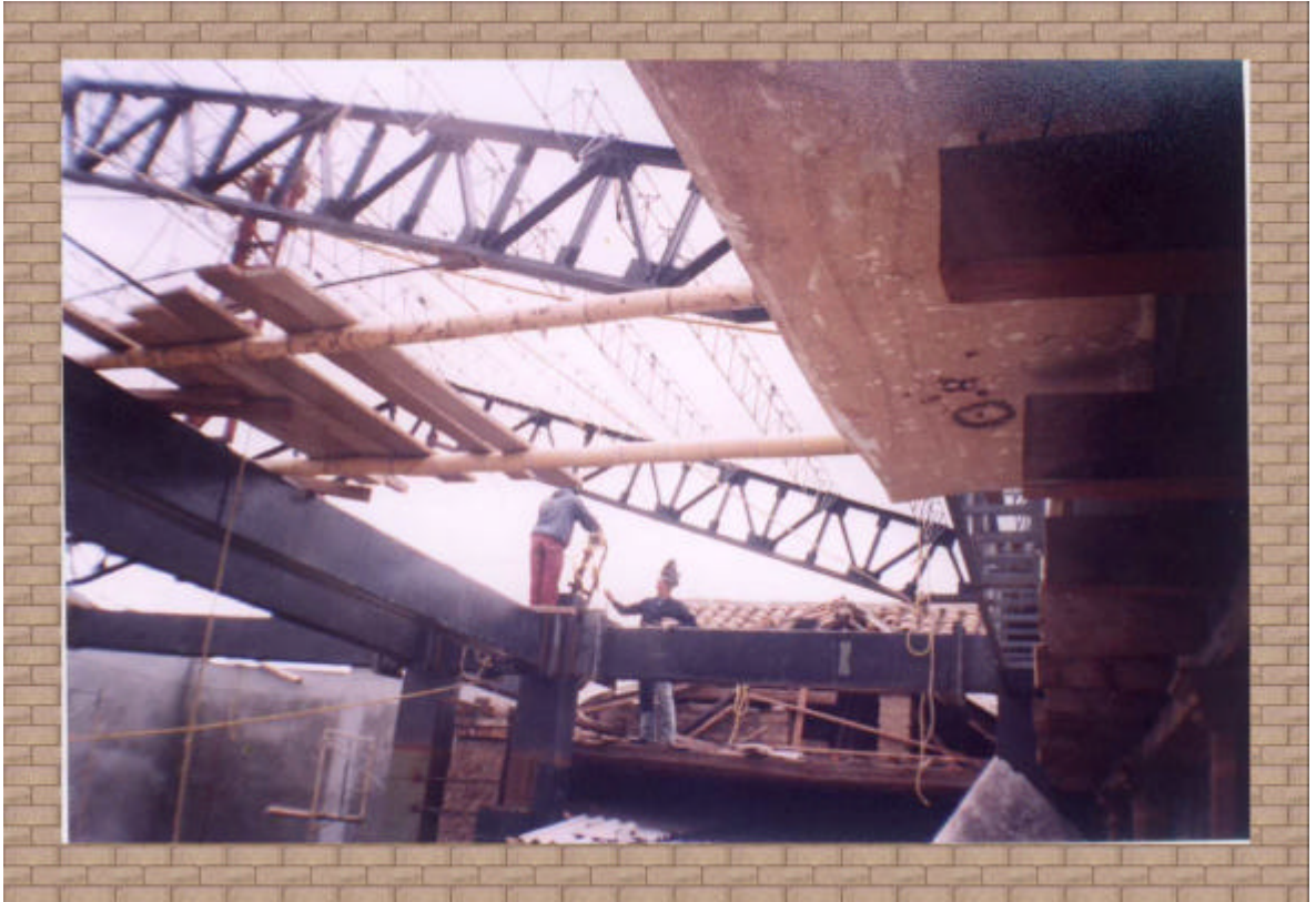
Foto 138. Soldadura de otras correas metálicas para instalar la teja ondulada
