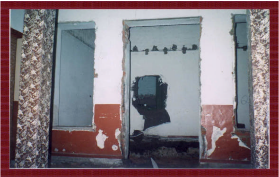
Foto 6 y 7 . Los muros de la casa al edaña al teatro, para facilitar sus entradas y salidas de el la
