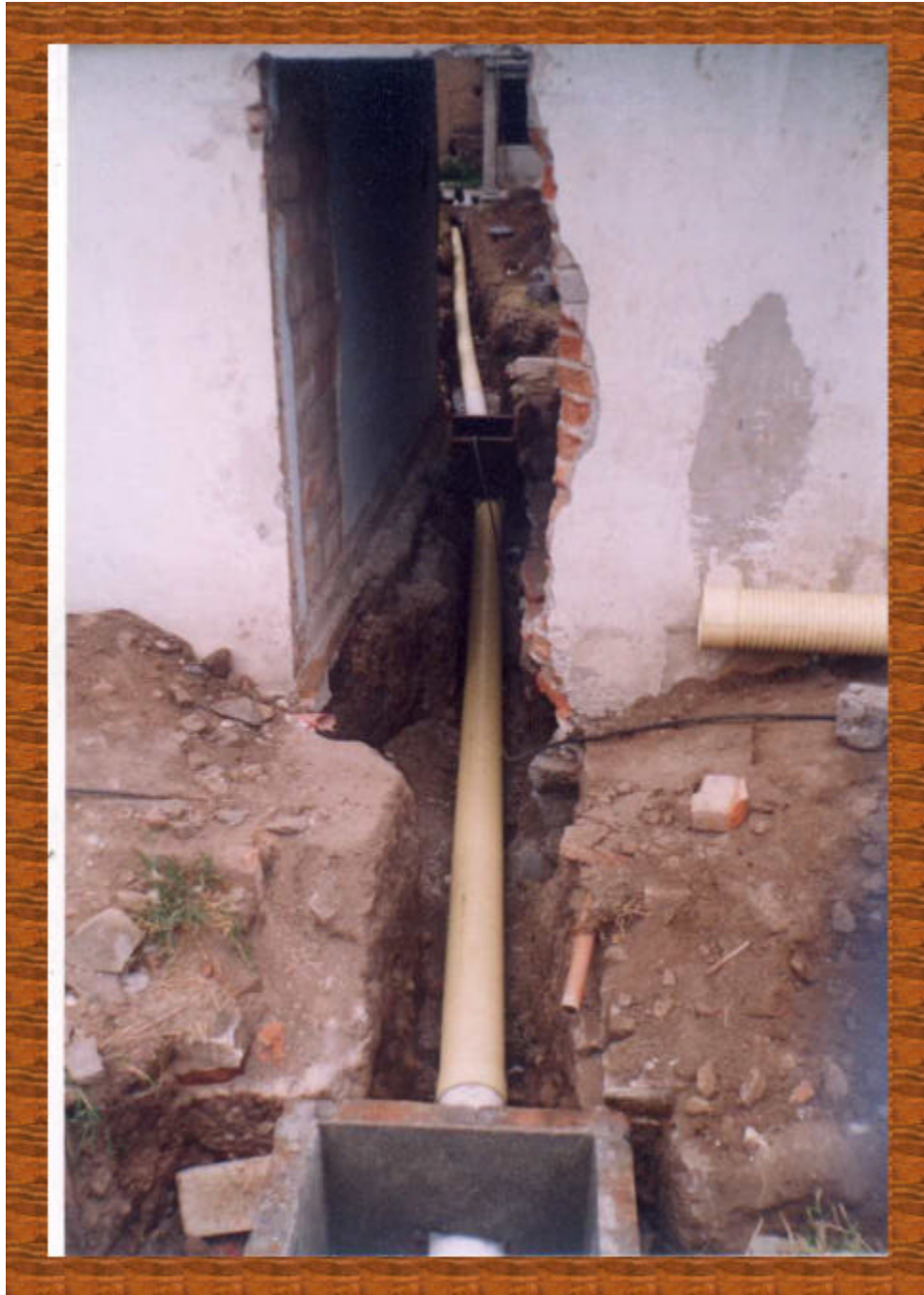
Foto 157. Instalación de tubería de al cantaril lado PAVCO en PVC, diámetro de 6", cuya longitud de al cantaril lado es de 48m
