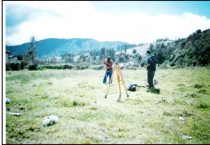
Figura 54. Nivelación del Equipo en uno de los Vértices
