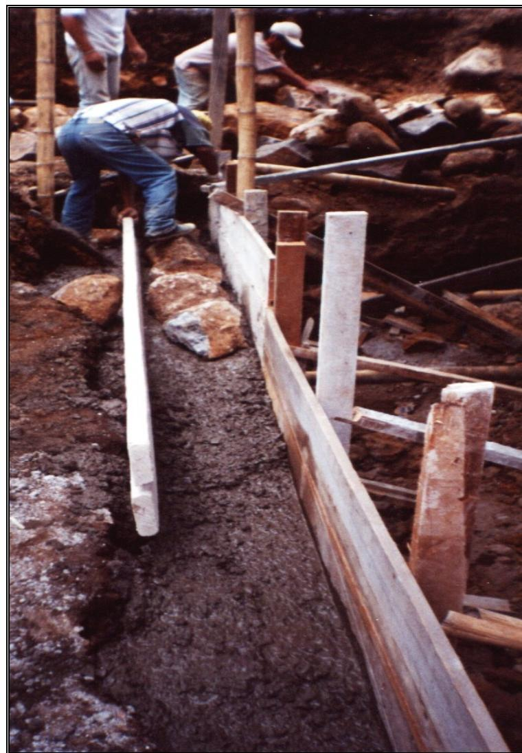
Encofrado y fundición muro de contención
