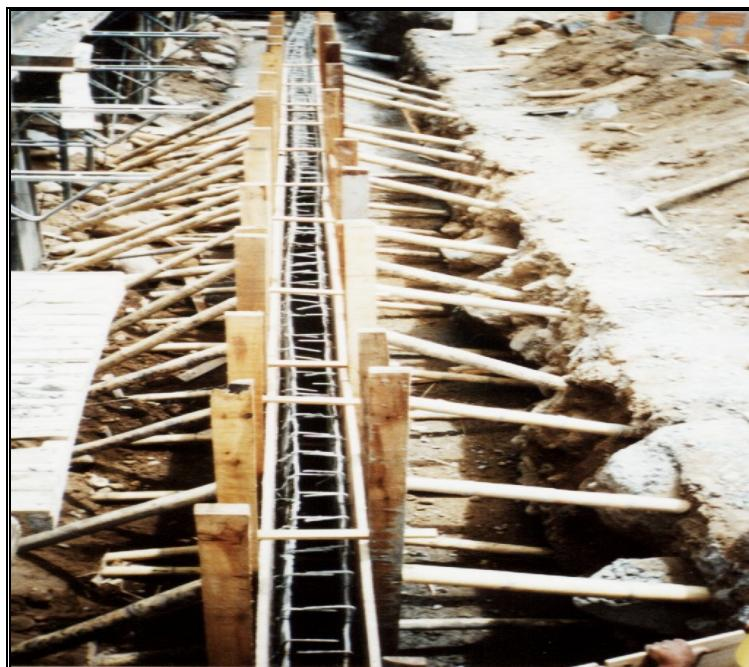
Encofrado - cuerpo muro de contención
