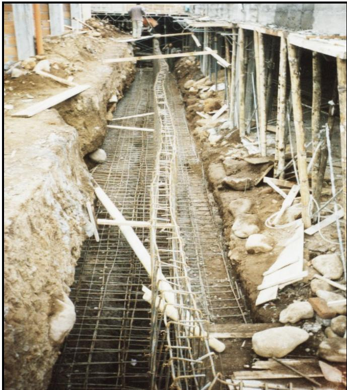
Detalle refuerzo muro de contención
