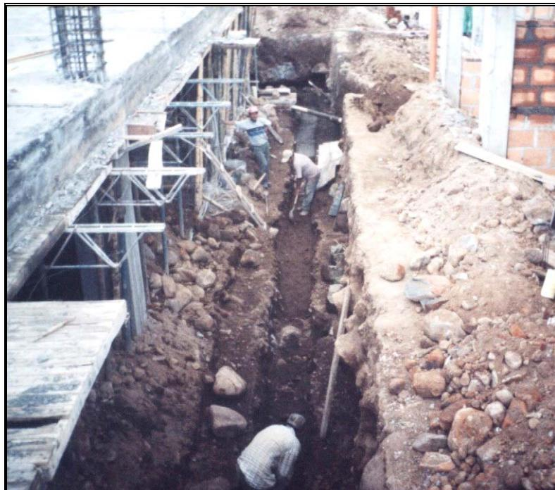
Ubicación y excavación del muro de contención
