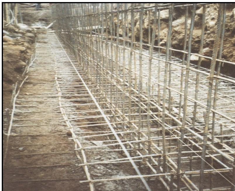
Armado del refuerzo del talón, zarpa y cuerpo del muro
