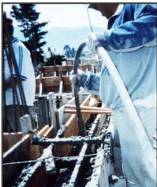
Fundición y Vibrado del concreto
