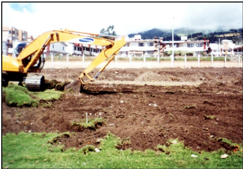
Descapote y Extracción del material de relleno
