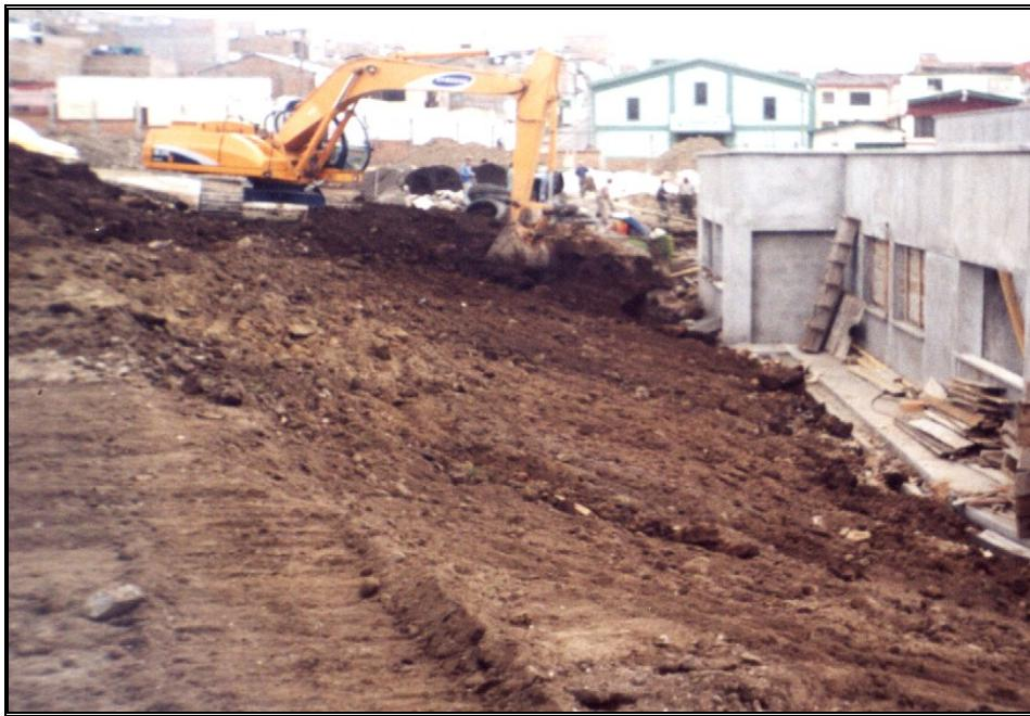
Adecuación del talud en forma de rampa
