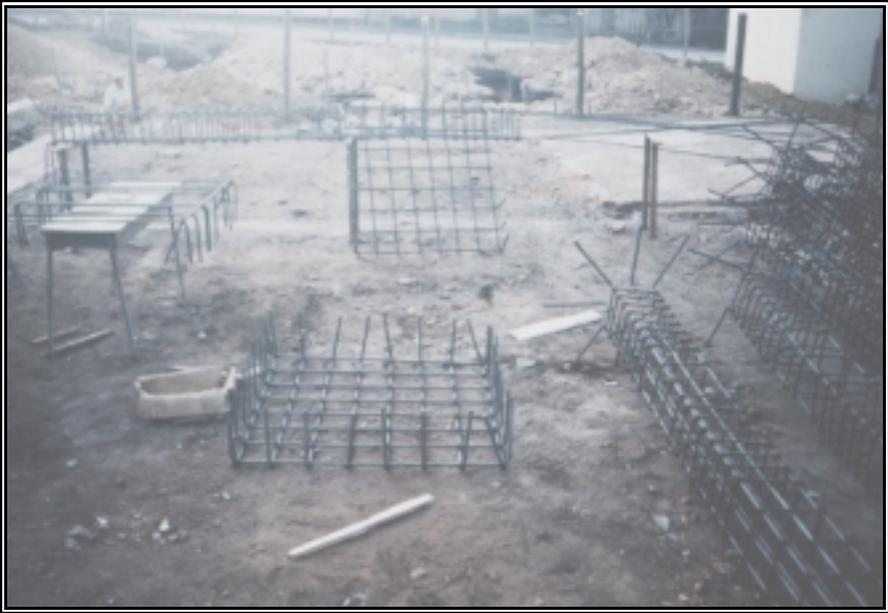
**Figura 70. *Figurado de Flejes para Columnas y Viga de Cimentación***
