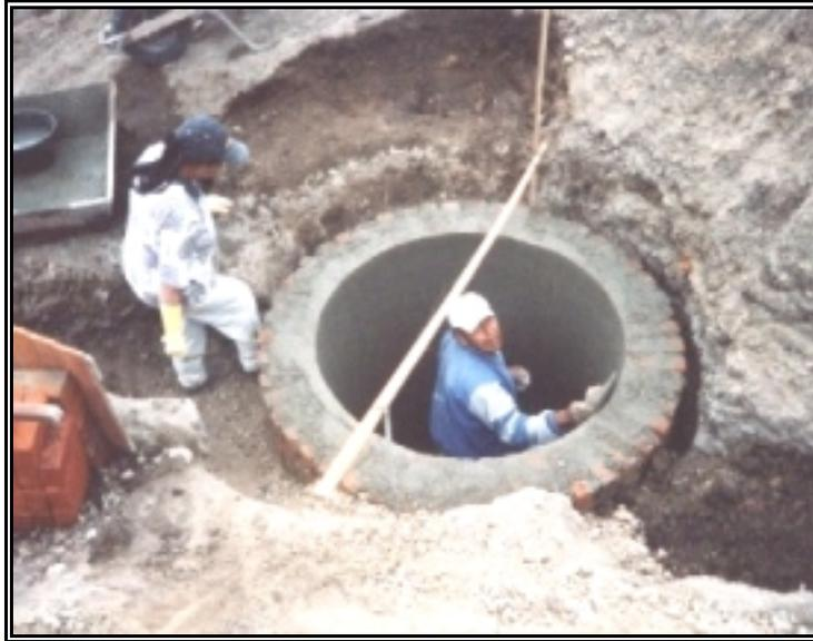
**Figura 190. Fundición Concreto Ciclópeo**
