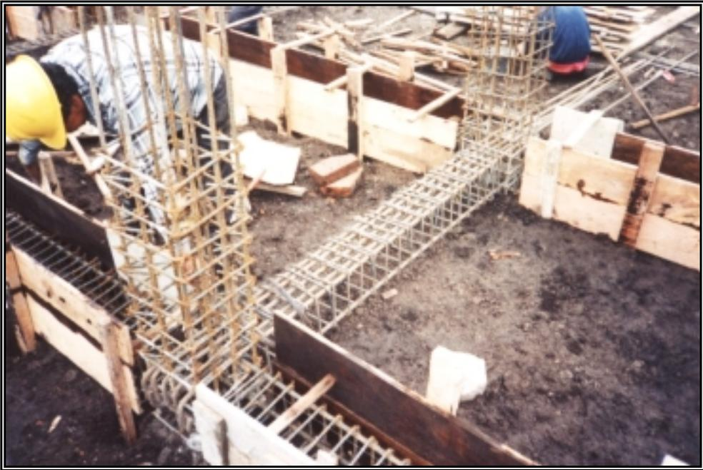
**Figura 136. *Encofrado y Fundición Viga de Cimentación***
