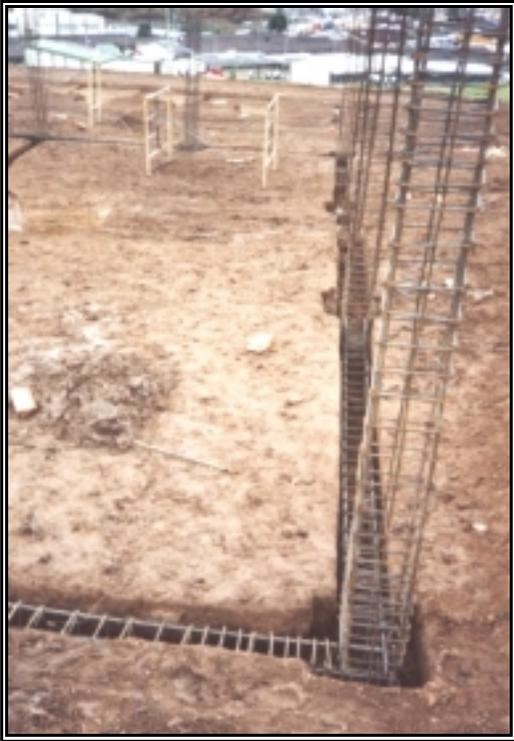
**Figura 31. *Fundición de Vigas de Cimentación***
