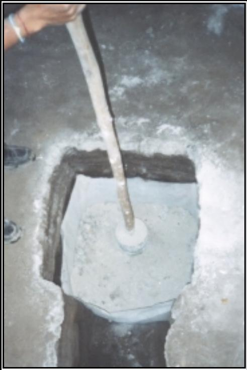
**Figura 177. Solado y Encofrado para Dado**
