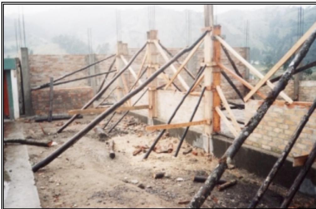
**Figura 47. Columnas Fundidas**
