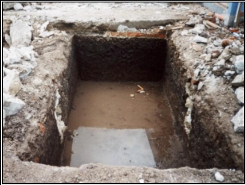
**Figura 130. *Solado de Zapata***
