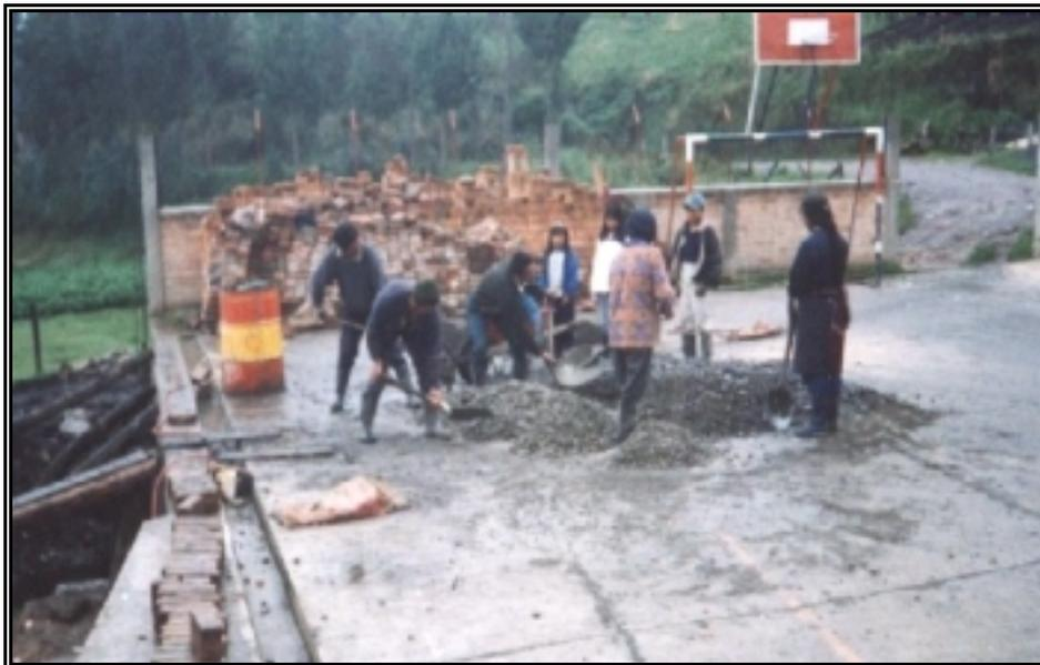
**Figura 51. *Fundición de Viga Corona y Viga Canal***
