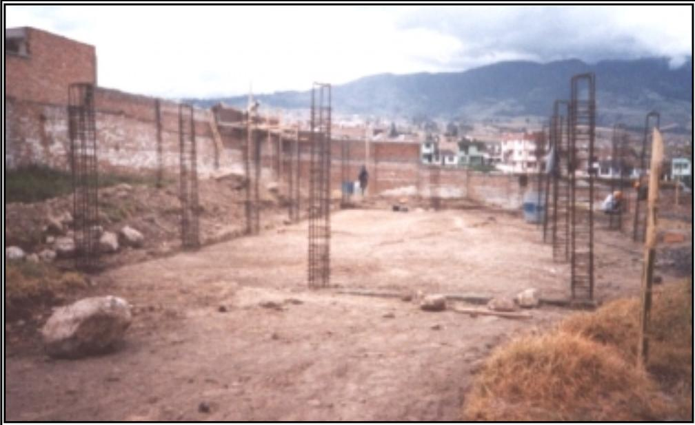
**Figura 20. Castillos de Columnas**
