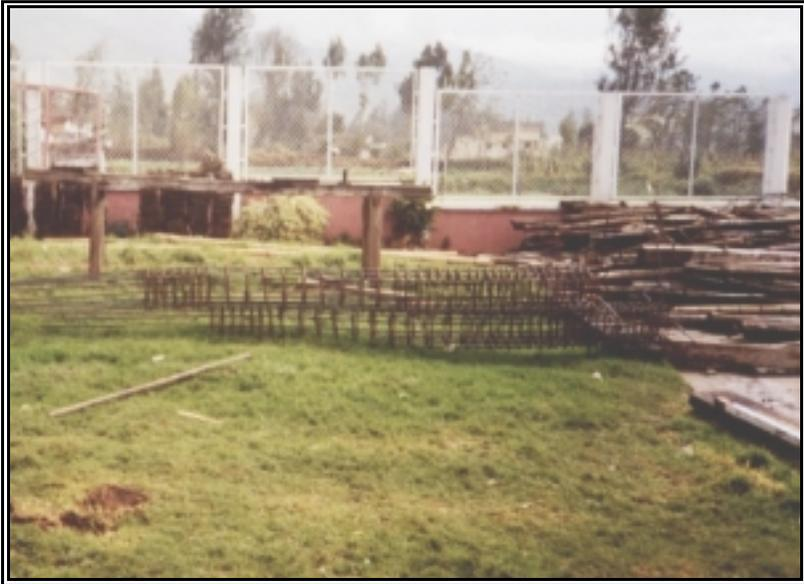
**Figura 144. Solado de Zapata y Detalle Parrilla Zapata - Columna**
