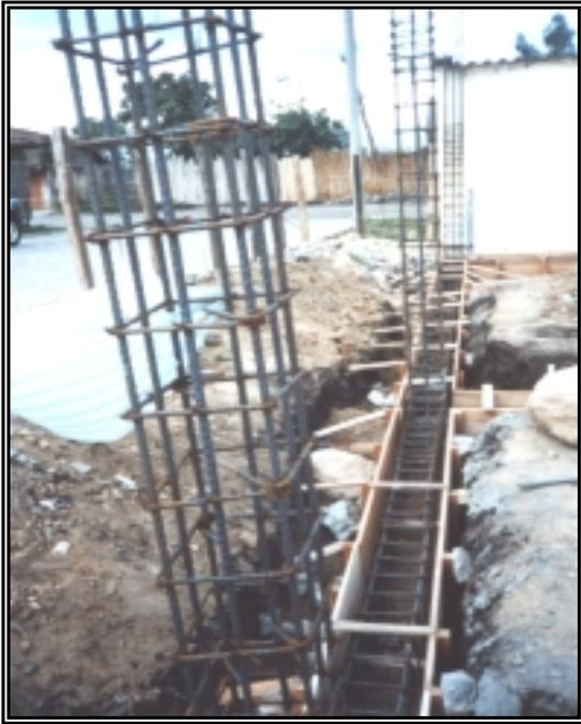
**Figura 76. *Fundición Viga de Cimentación***
