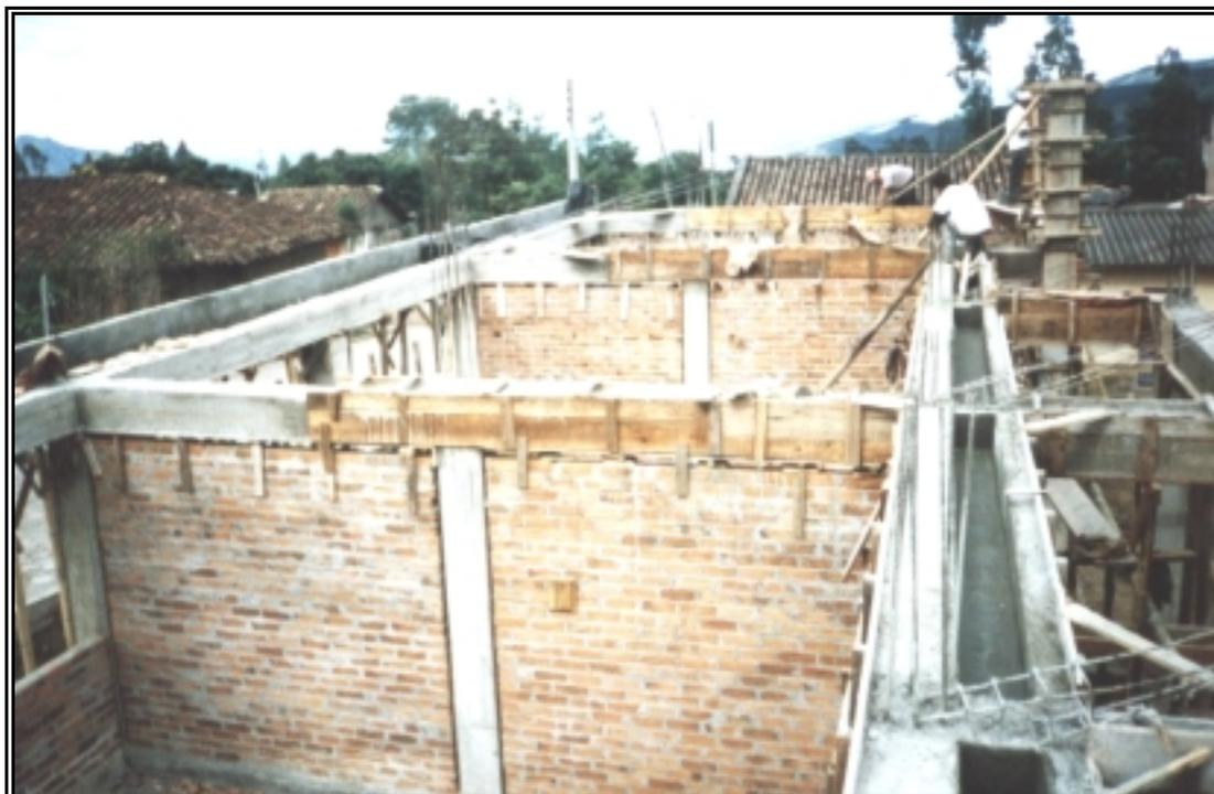
**Figura 82. Armado y Encofrado Viga Canal**
