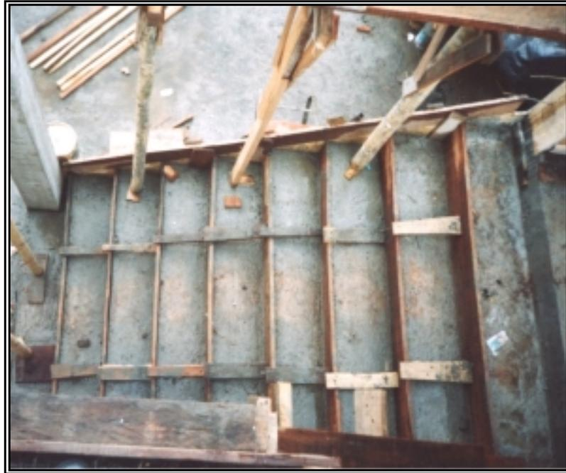
**Figura 109. Fundición Solado Inferior de Losa y Detalle Instalación Eléctrica**
