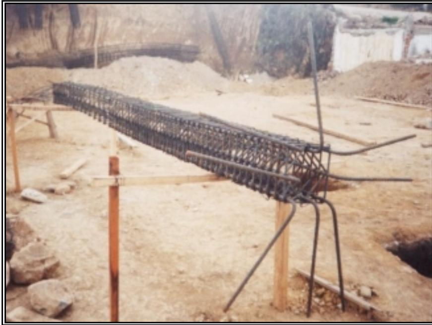
**Figura 66. Armado de Pantalla**
