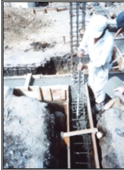
**Figura 77. *Encofrado de Columna***
