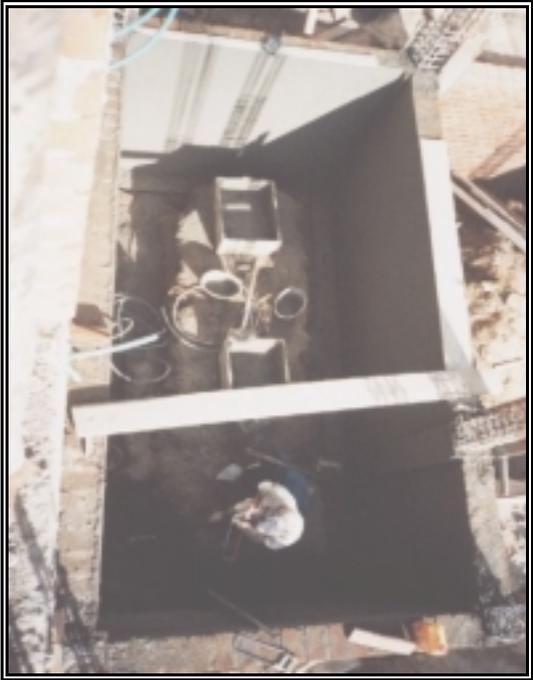
**Figura 250. Armado, Encofrado y Fundición Viga Doble - Nivel Escenario**
