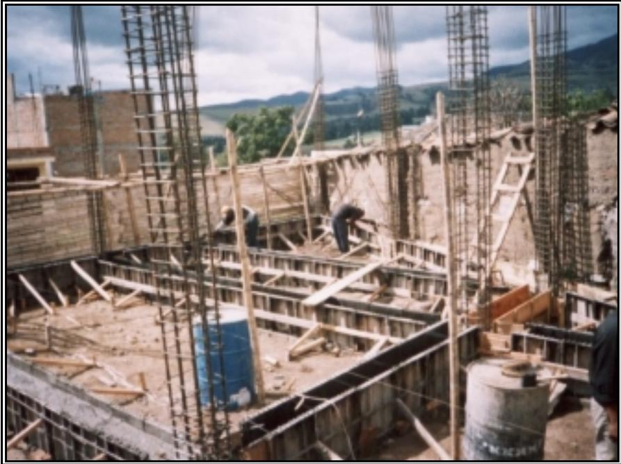
**Figura 13. Detalle de Intersección Nudo Vigas X**
