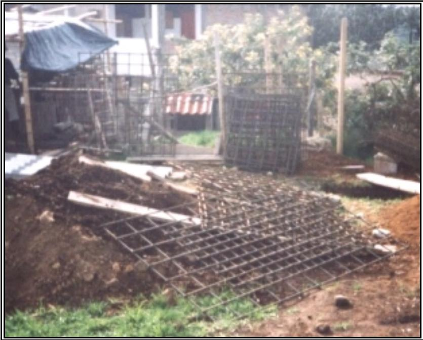
**Figura 65. Castillos de Columnas**
