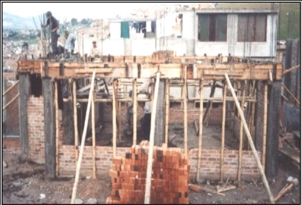
**Figura 219. *Viga Canal en U, Fundida***
