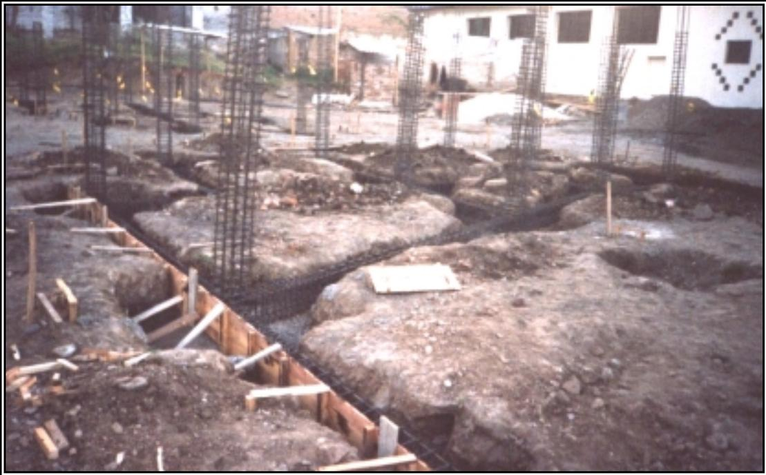
**Figura 169. Encofrado Viga de Cimentación – Salón de Ensayos**
