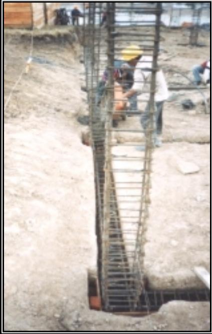
**Figura 32. *Detalle Castillos de Columnas***
