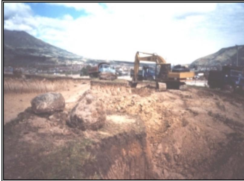
**Figura 25. *Excavación para Zapatas y Viga de Cimentación.***
