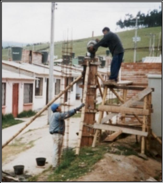
**Figura 125. Levantamiento de Muro en Soga**
