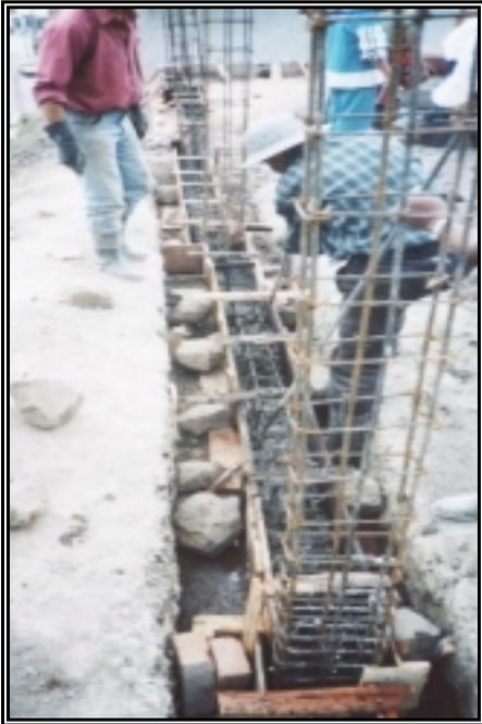
**Figura 192. Encofrado de Columnas**
