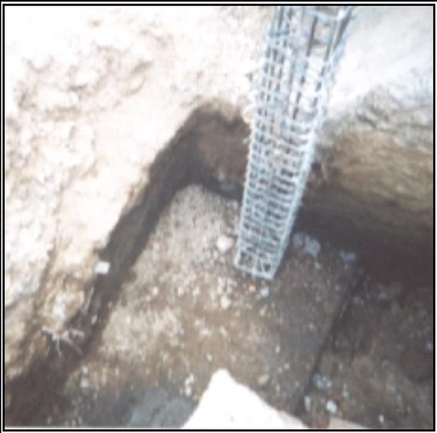
**Figura 228. Concreto Ciclópeo para Viga de Cimentación**
