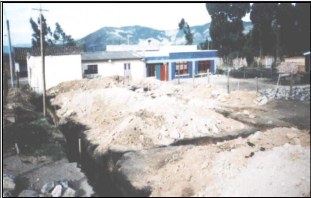
**Figura 68. *Excavación de Zapatas y Viga de Cimentación***
