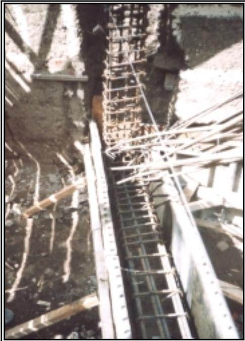
**Figura 14. *Fundición de Vigas de Cimentación***
