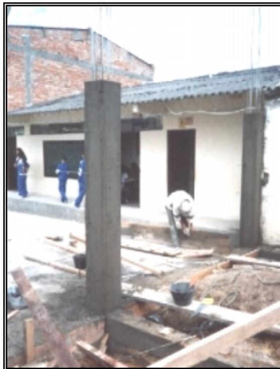
**Figura 233. *Instalación de Tubería de Aguas Lluvias PVC 4"***
