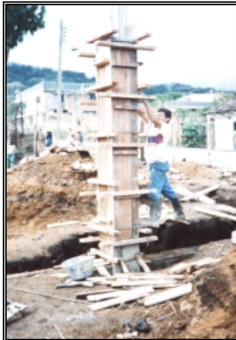
**Figura 78. Columna Fundida con su respectivo Anclaje**
