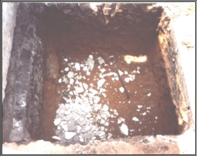
**Figura 173. Excavación para Mejoramiento de Suelo**
