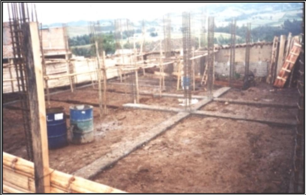
**Figura 11. *Armado de Vigas de Cimentación***
