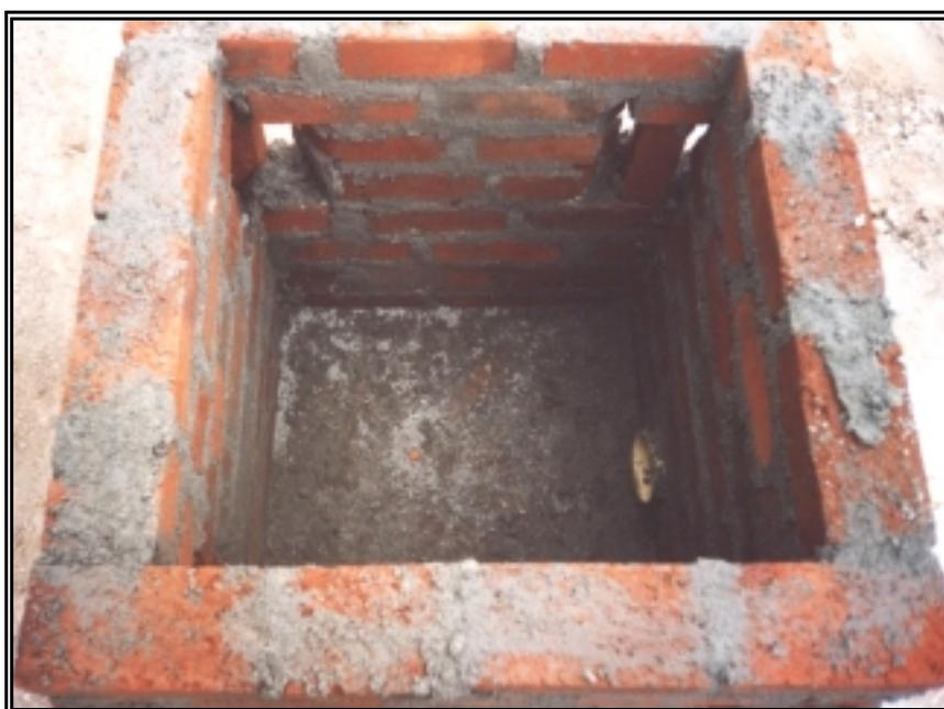
**Figura 153. Detalle Tubería Sanitaria y Pedestales Fundidos**
