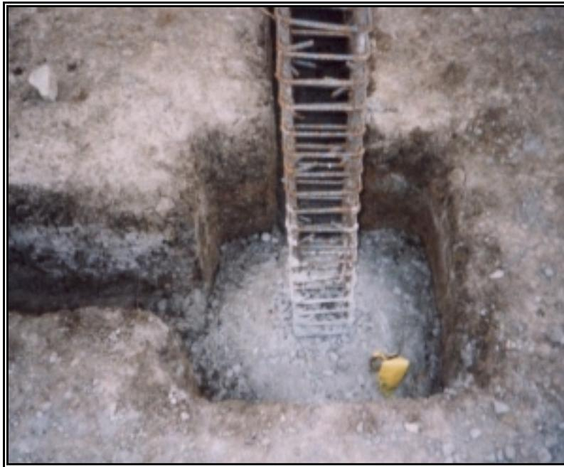
**Figura 18. Armado de Vigas de Cimentación**
