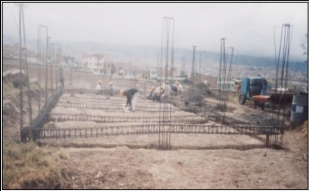
**Figura 19. Fundición de Vigas de Cimentación**
