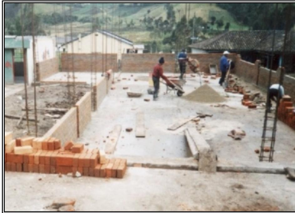
**Figura 44. Muro en Soga Altura 0.92 m y Repello Esmaltado Sobrecimiento**
