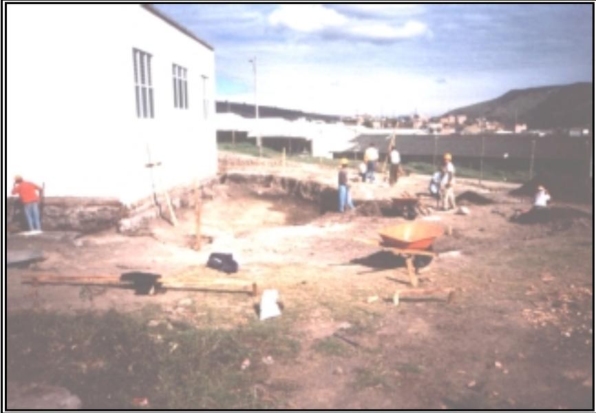
**Figura 147. *Excavación de Zapata***
