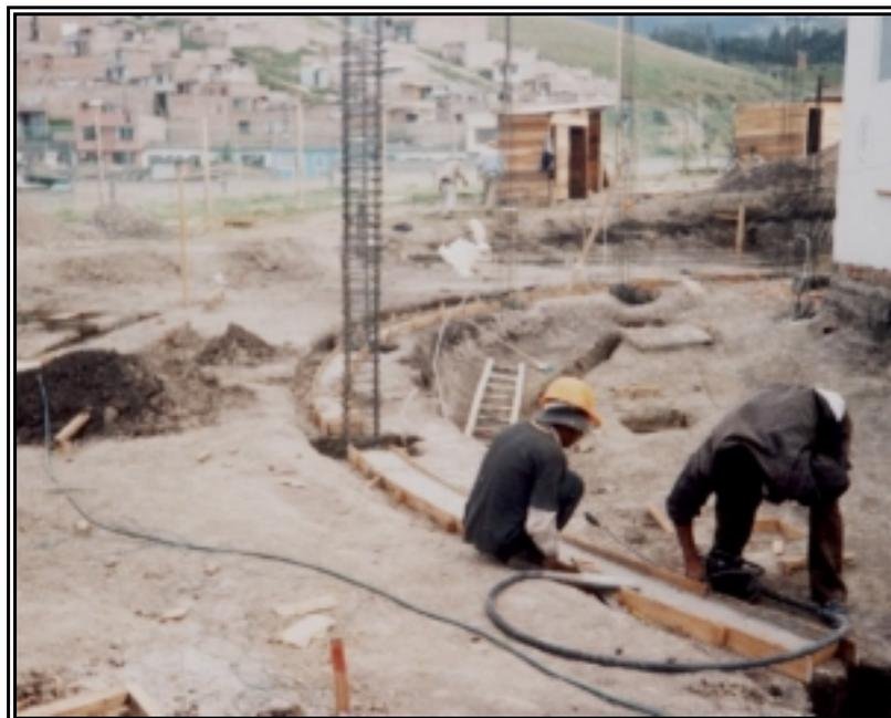
**Figura 152. Caja de Inspección**
