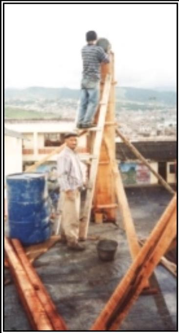
**Figura 243. *Levantamiento de Muro en Soga***
