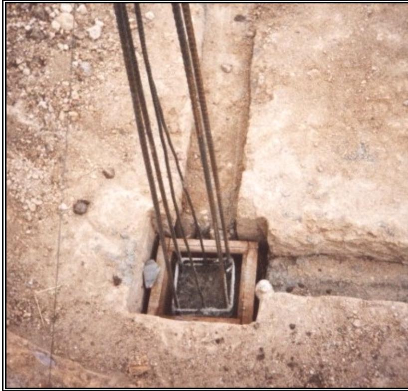
**Figura 28. Zapata Fundida**
