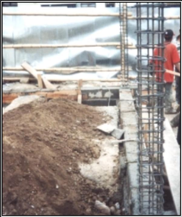
**Figura 231. *Encofrado de Columna***
