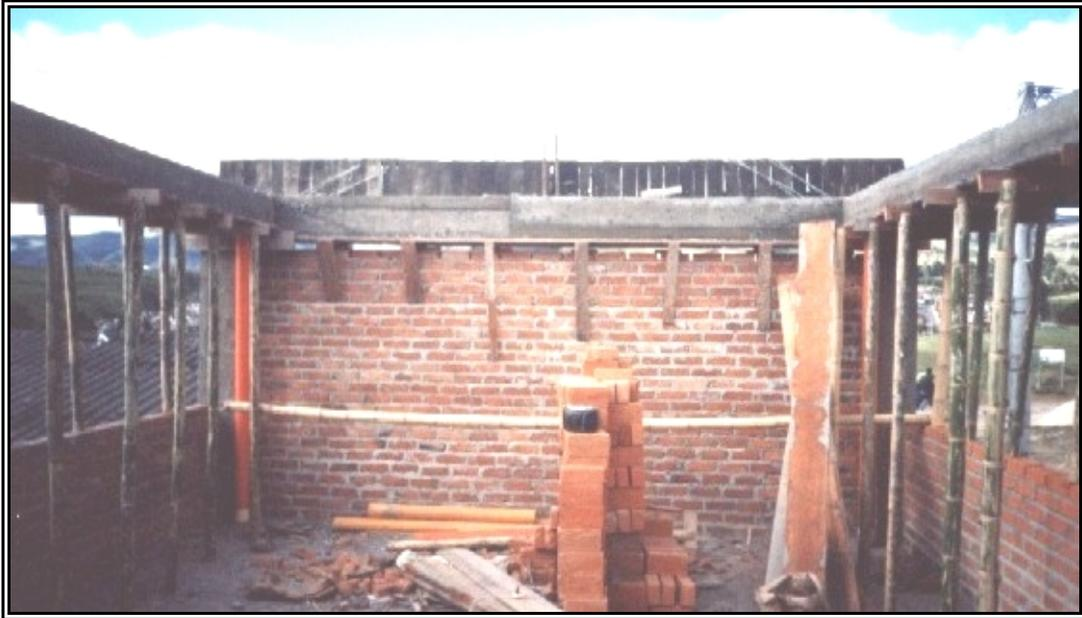
**Figura 245. Armado y Encofrado Cinta de Culata**
