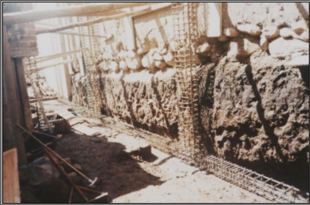
**Figura 102. Repello de Muro**
