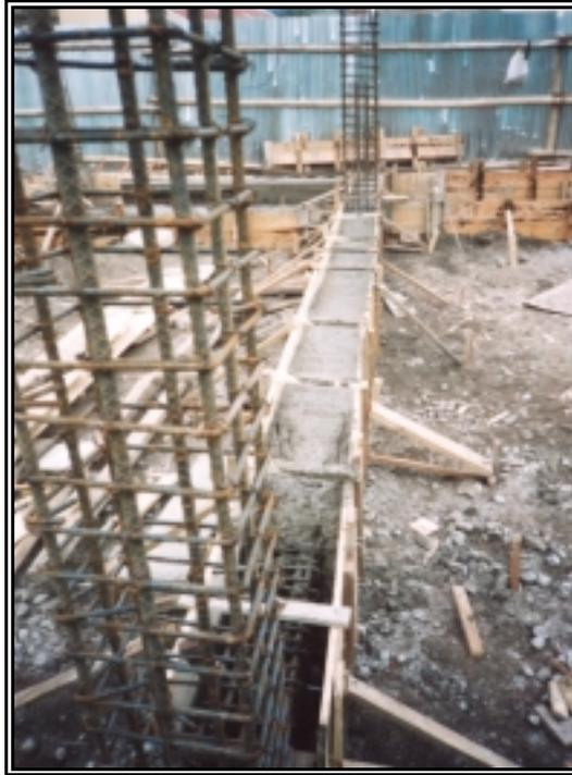
**Figura 137. *Encofrado de Columnas***
