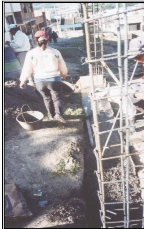
**Figura 191. Armado, Encofrado y Fundición Viga de Cimentación**
