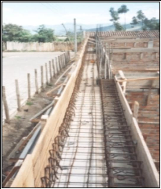
**Figura 83. Armado Vigas Corona**
