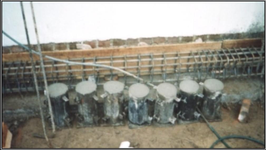
**Figura 9. Fundición de Pedestales**
