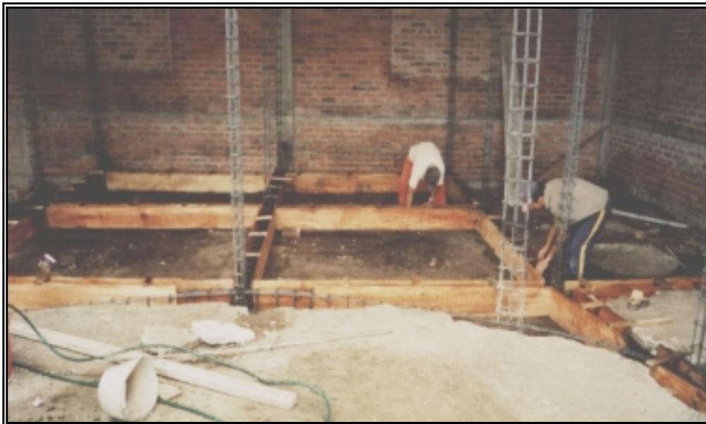
**Figura 182. *Fundición Viga de Cimentación***
