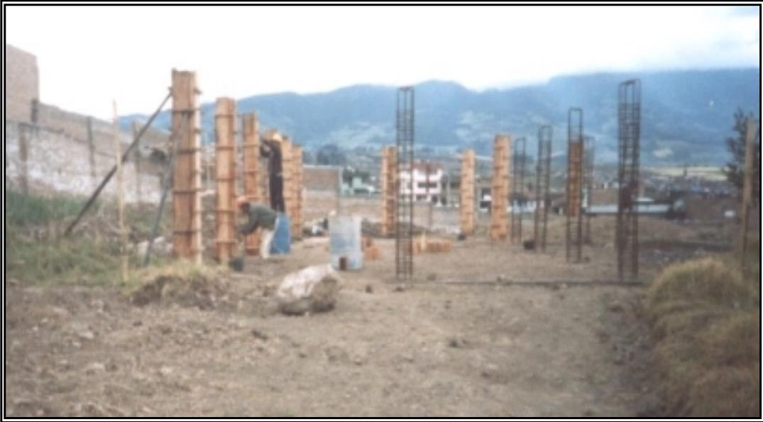
**Figura 23. Columnas Fundidas**
