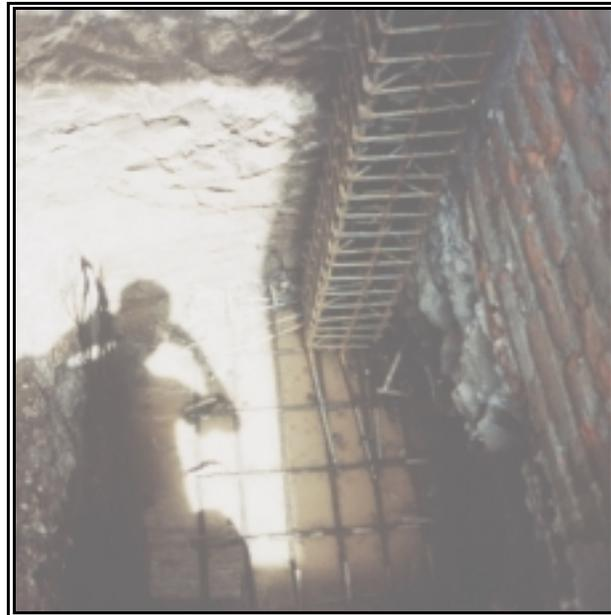
**Figura 99. Zapata Fundida y Encofrado de Pedestal**
