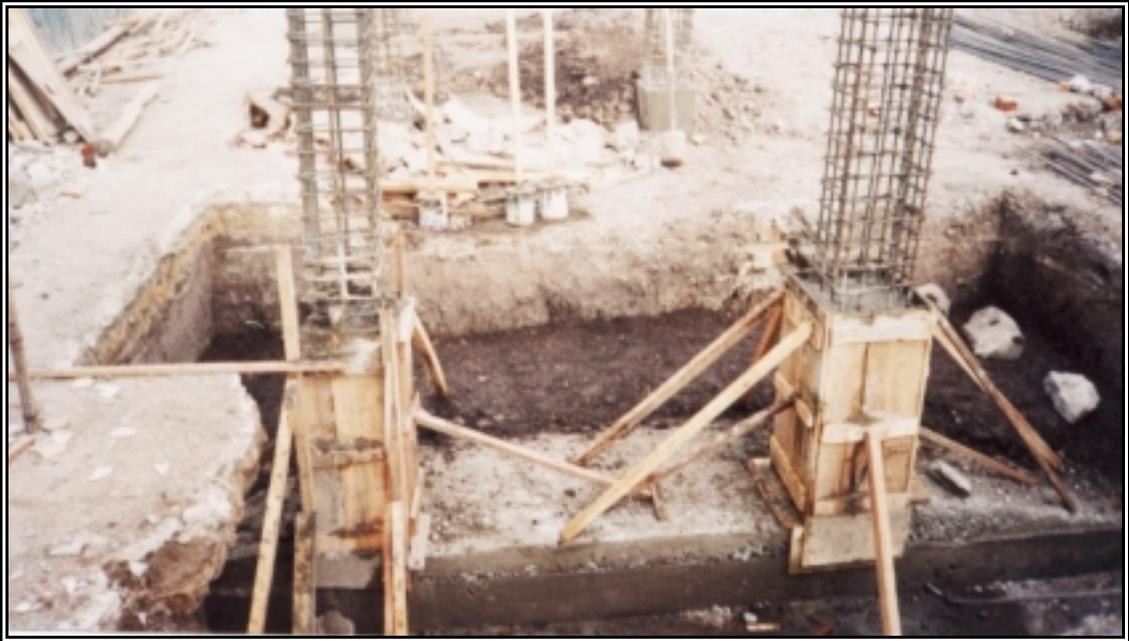
**Figura 134. Relleno Compacto en Zapata y Detalle Castillo Columna**
