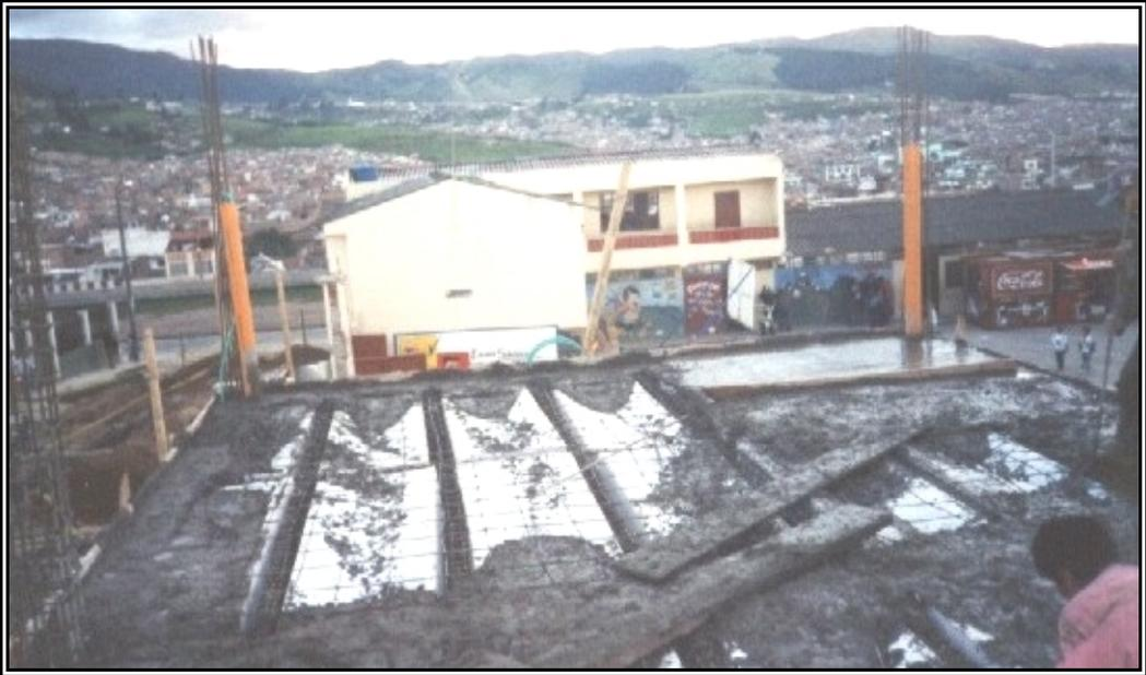
**Figura 241. *Fundición Viga Canal***
