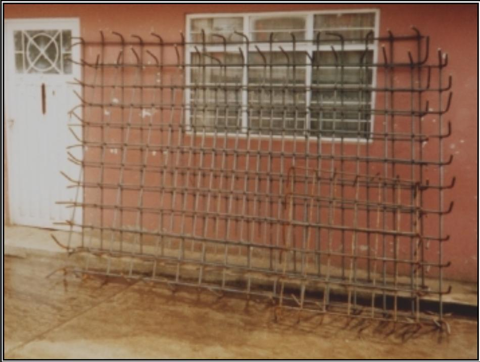
**Figura 143. Castillos de Columnas**
