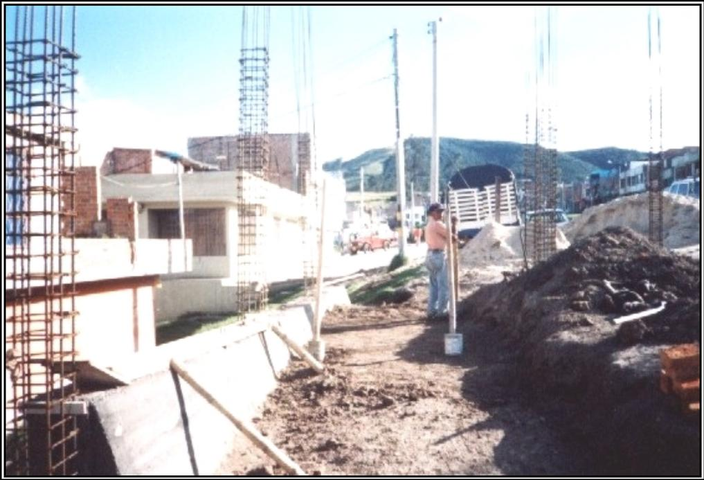
**Figura 204. Excavación para Zapatas**
