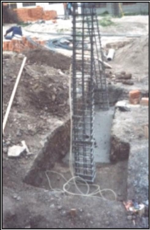
**Figura 208. Armado Viga de Cimentación y Castillos de Columnas**
