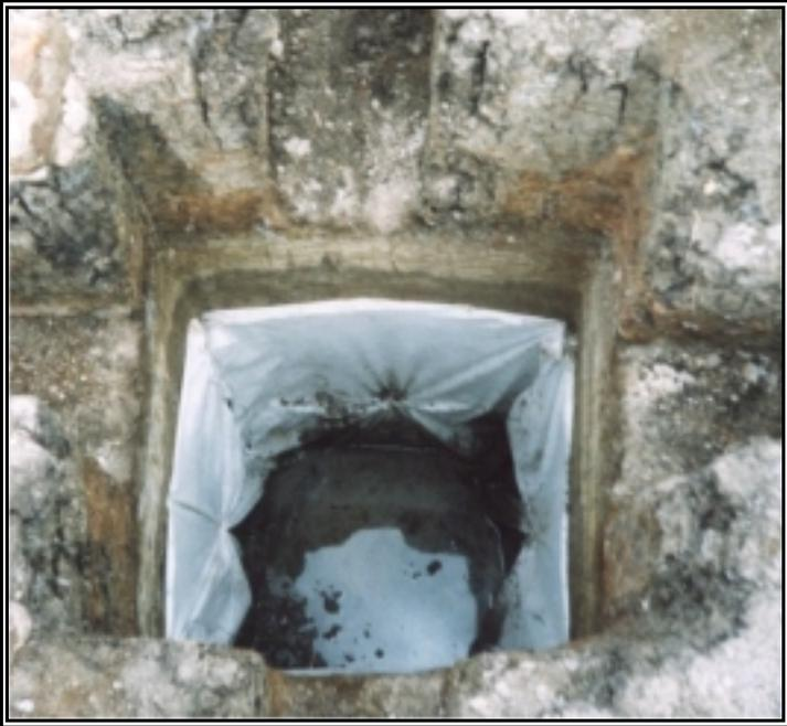
**Figura 165. Fundición Mejoramiento de Suelo**
