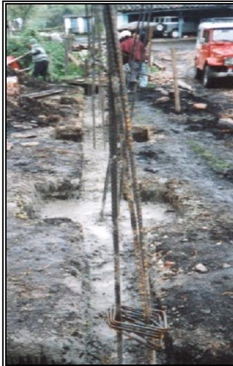
**Figura 39. *Función de Concreto Ciclópeo bajo Viga de Cimentación***
