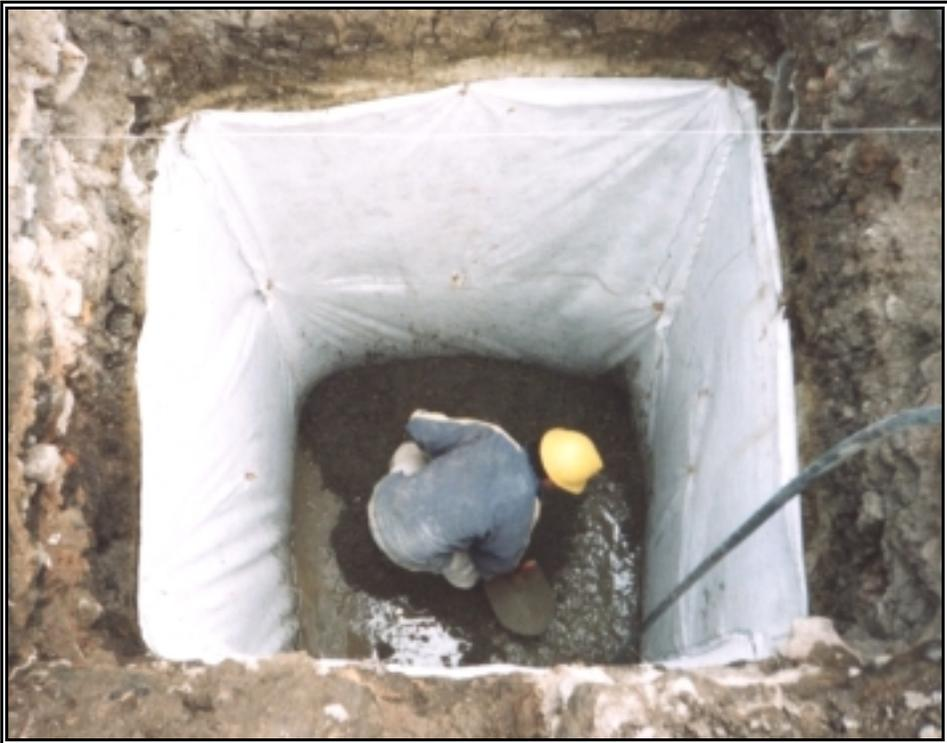
**Figura 166. Vibrado – Mejoramiento de Suelo**
