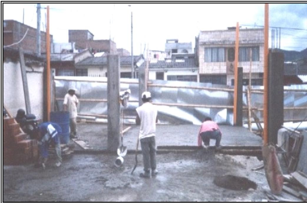
**Figura 237. Armado Losa de Entrepiso Aligerada**
