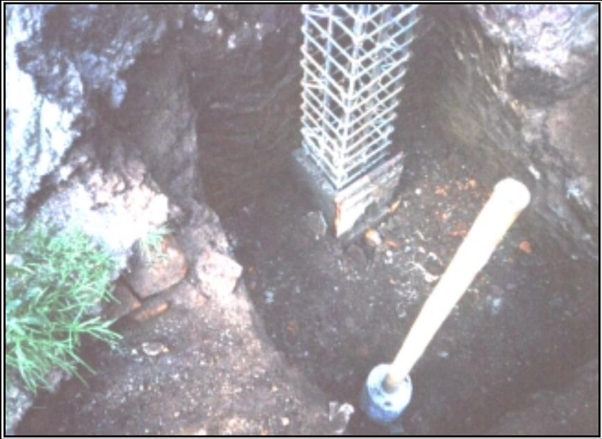
**Figura 101. Armado Viga de Cimentación**
