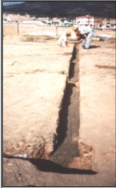
**Figura 17. *Fundición de Zapatas***
