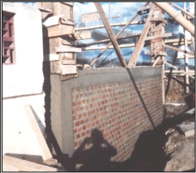
**Figura 235. *Repello Esmaltado e Impermeabilizado Muro Tizón***
