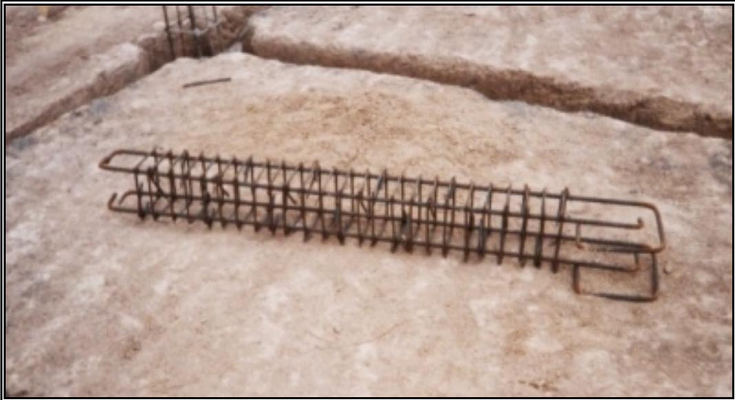
**Figura 30. *Armado de Vigas de Cimentación.***
