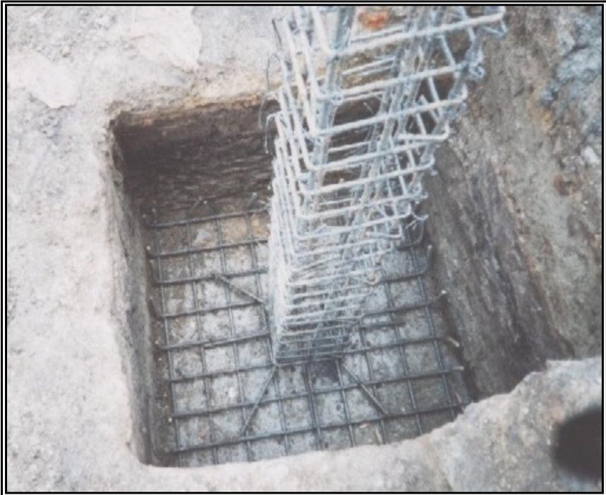
**Figura 207. Zapatas Fundidas**
