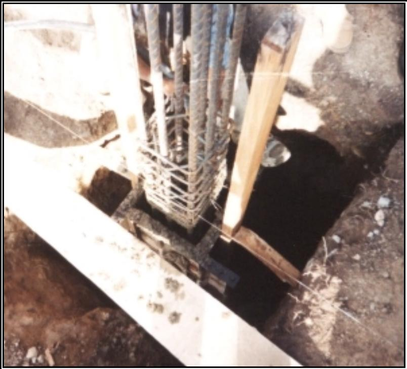
**Figura 10. *Fundición de Solado de Vigas de Cimentación***
