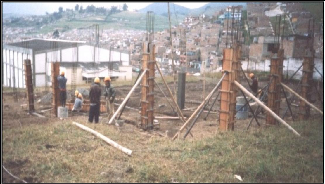
**Figura 34. Columnas Fundidas**
