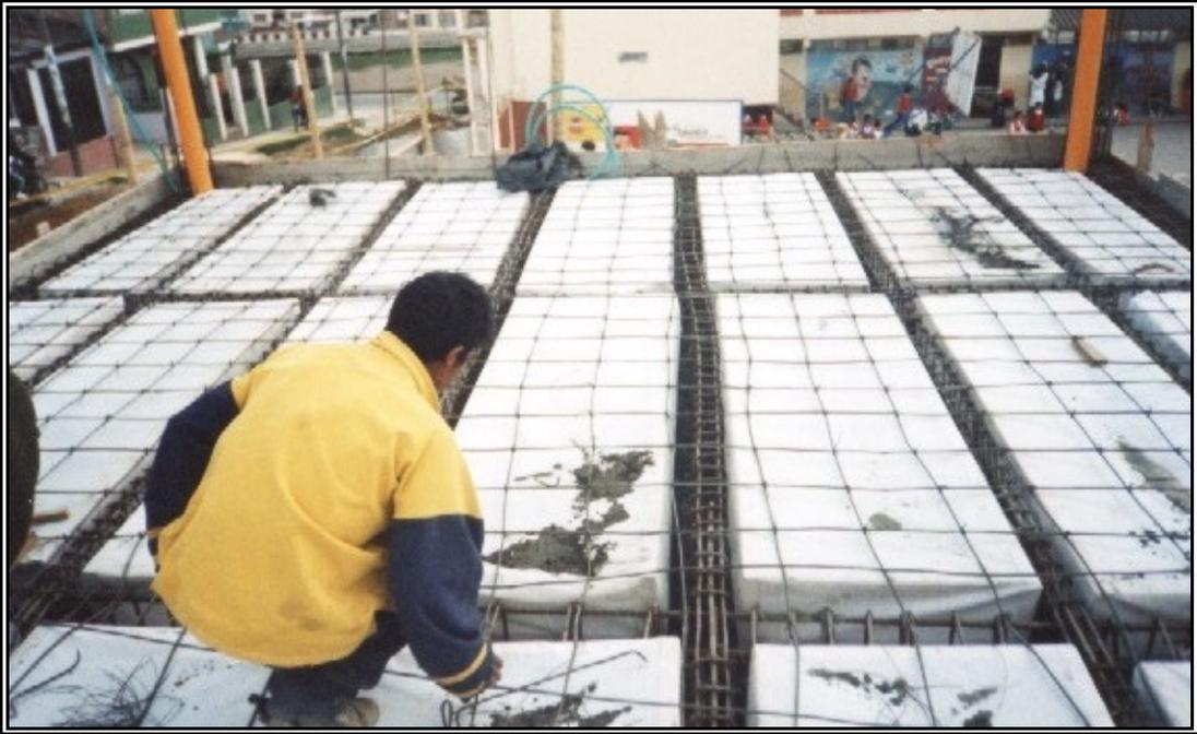
**Figura 239. Detalle Armado Viga Canal ( Ubicación hacia Baños existentes )**
