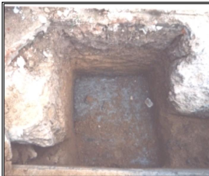
**Figura 227. Zapata Fundida y Detalle Castillo columna**
