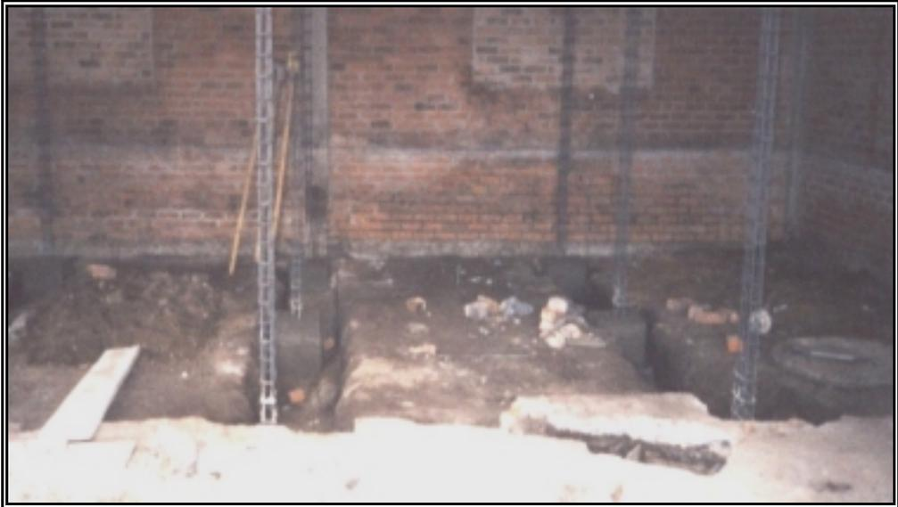
**Figura 179. *Detalle Columneta de Confinamiento***
