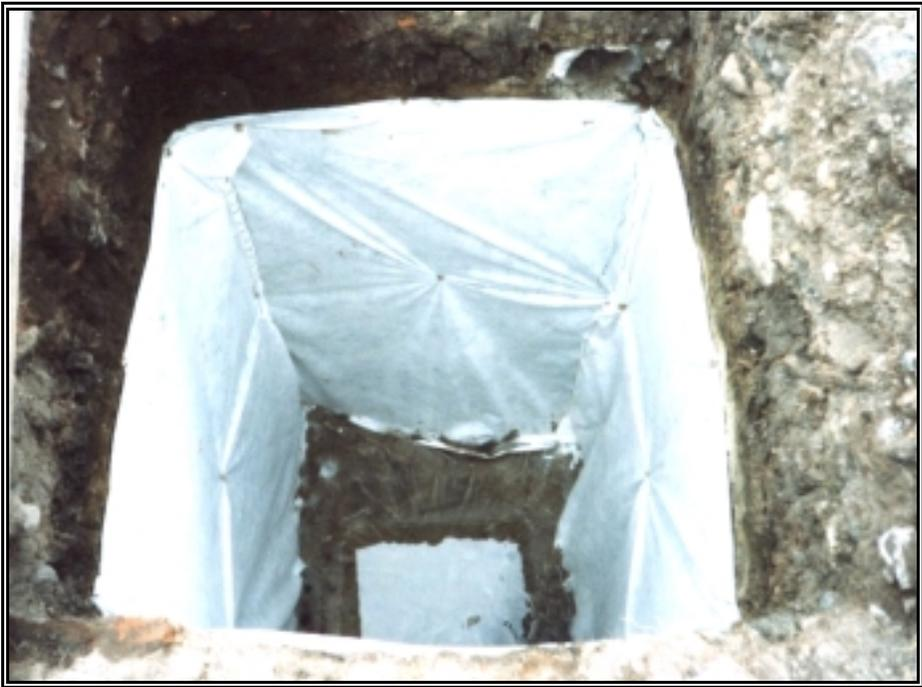
**Figura 164. Ubicación de Geotextil No Tejido 1600 – Salón de Clases**
