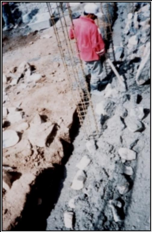
**Figura 123. Muro de Contención de Gravedad**
