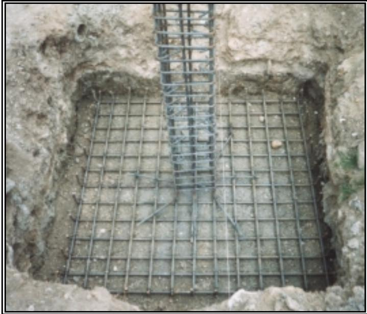
**Figura 168. Armado Viga de Cimentación – Salón de Ensayos**
