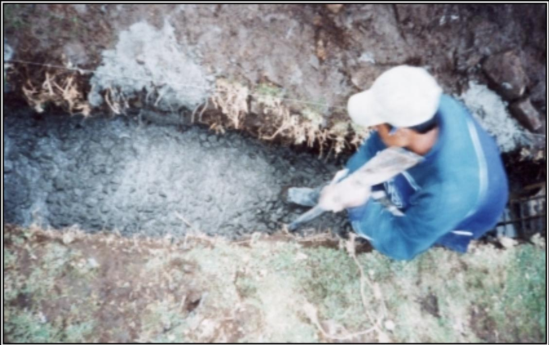
**Figura 119. *Detalle Nudo Viga de Cimentación – Columna***
