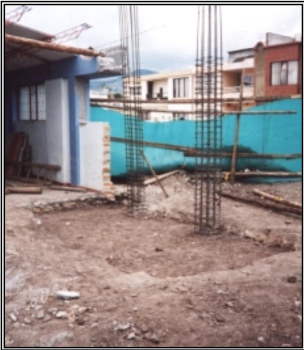
**Figura 135. Armado Viga de Cimentación**
