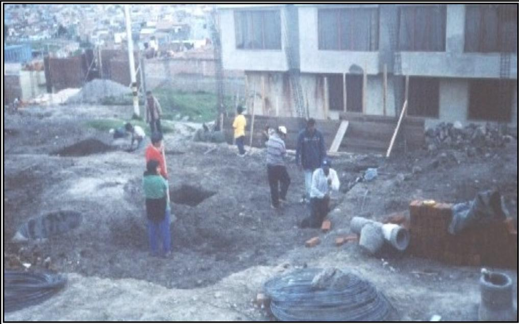
**Figura 205. Solado para Zapatas**
