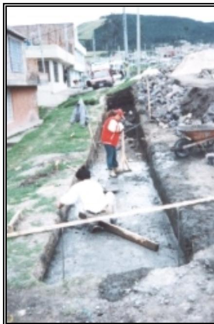
**Figura 201. *Encofrado Muro de Contención***
