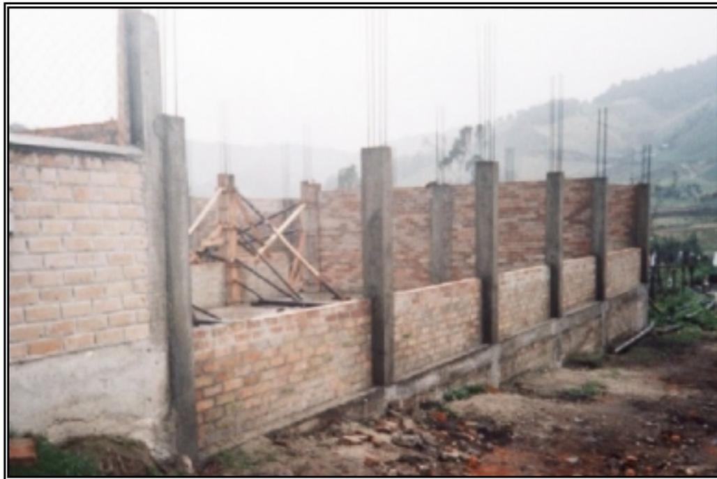
**Figura 48. Armado de Viga Corona**
