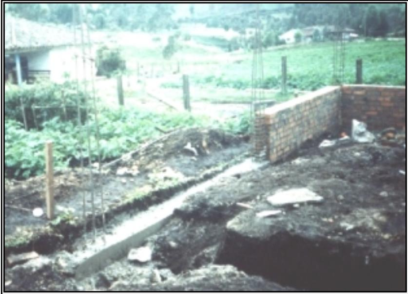
**Figura 41. Muro Tizón para Nivelación**
