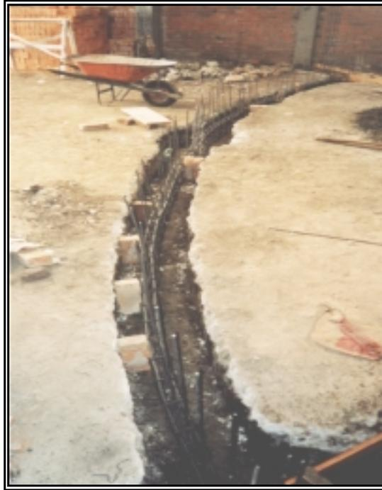
**Figura 181. Encofrado Viga de Cimentación**
