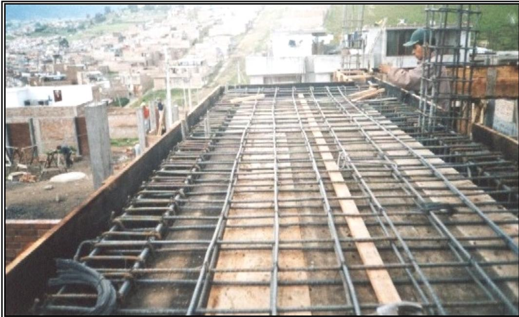
**Figura 218. *Fundición de Viga Corona, Viga Canal y Losa Maciza***
