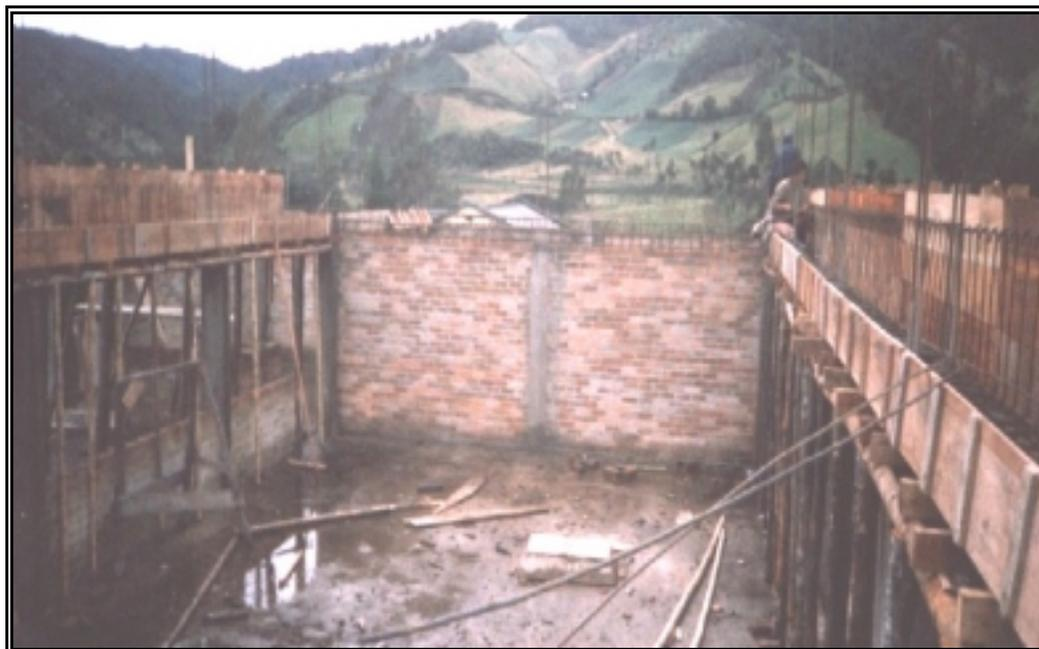
**Figura 49. Armado de Viga Canal y Encofrado**
