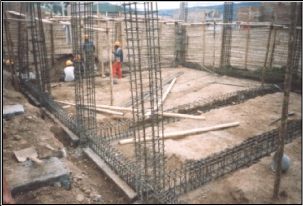
**Figura 12. Encofrado de Vigas de Cimentación**
