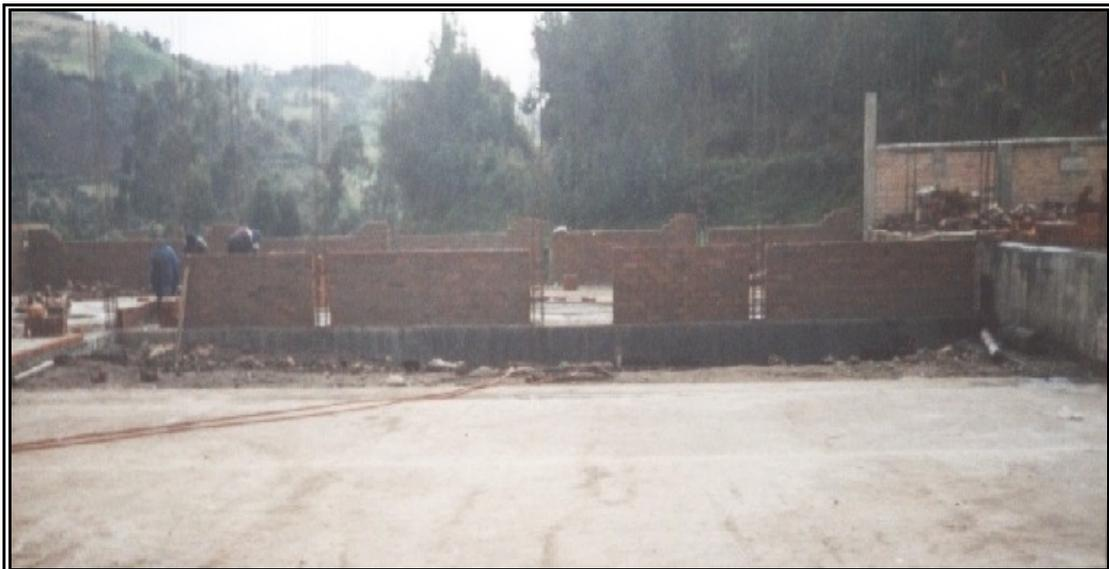
**Figura 45. Levantamiento de Muro en Ladrillo Común, Soga**
