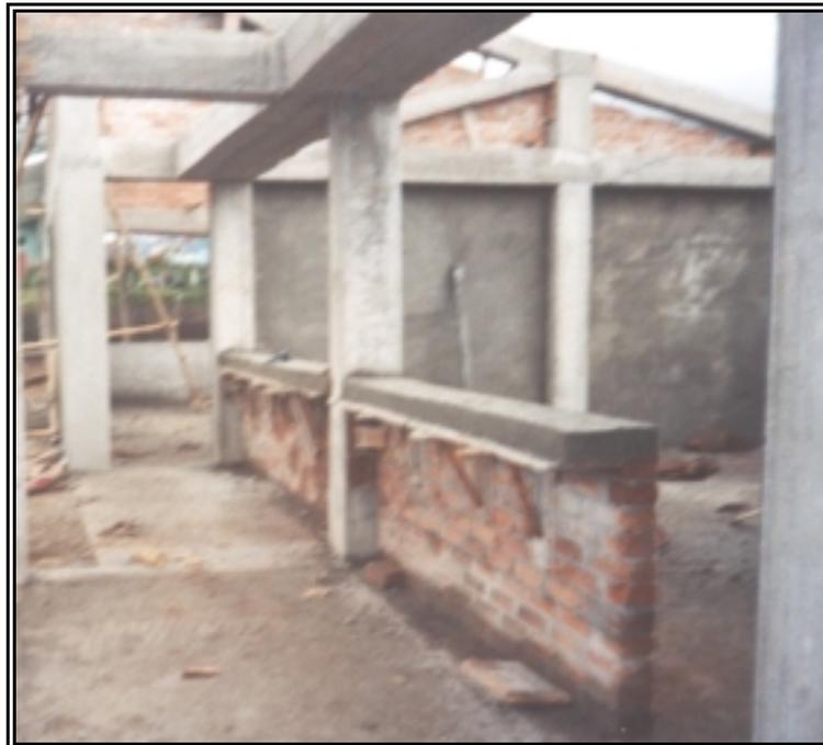
Figura 92. *Repello de Muros*
