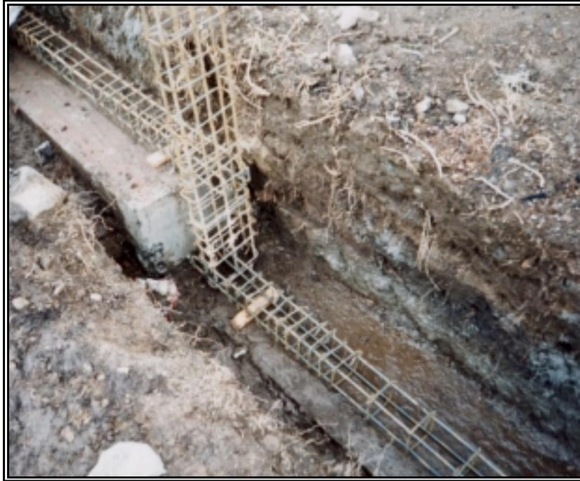
**Figura 120. *Viga de Cimentación***
