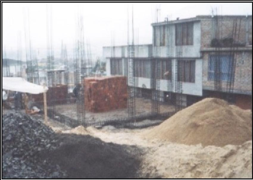
**Figura 209. Encofrado y Fundición de Viga de Cimentación**
