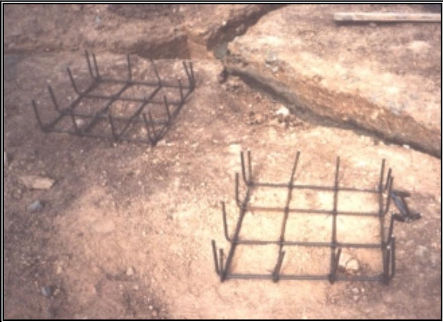
**Figura 149. *Detalle Parrilla Zapata y Castillo Columna***
