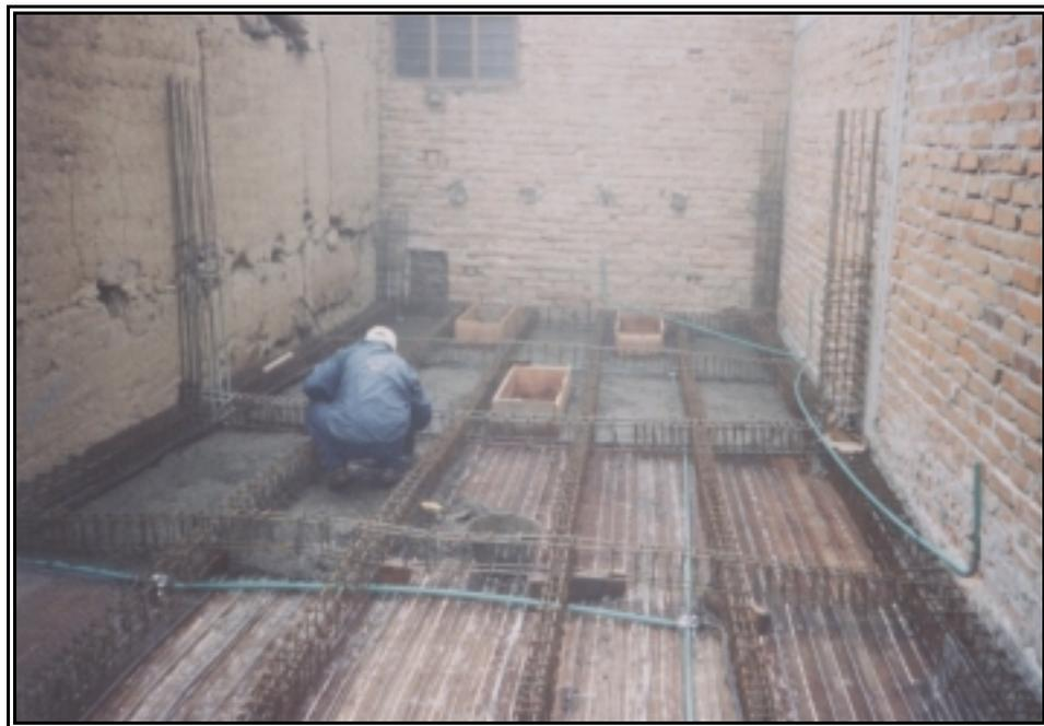
**Figura 110. *Fundición de Losa***
