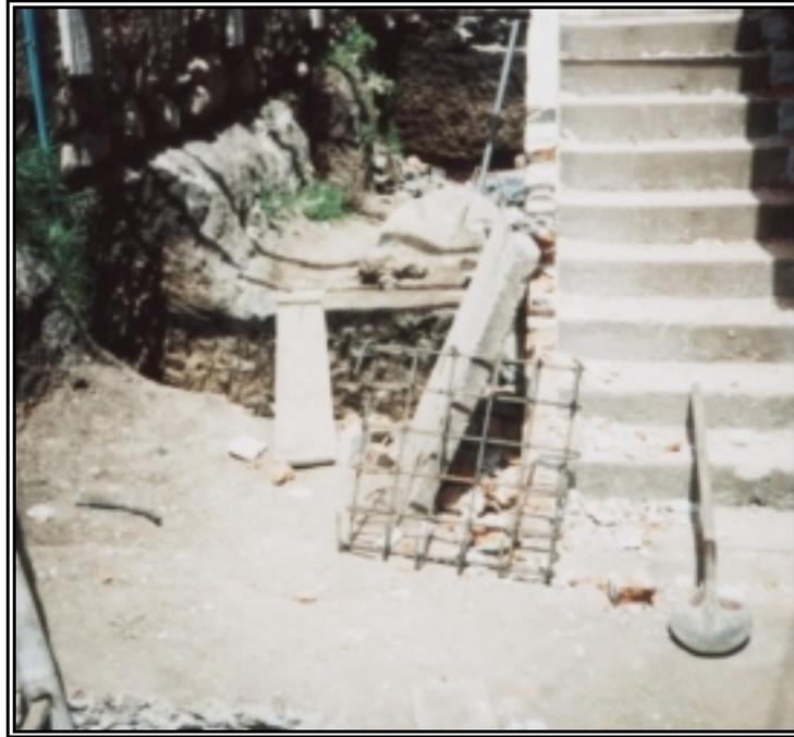
**Figura 96. Armado Castillos de Columnas**
