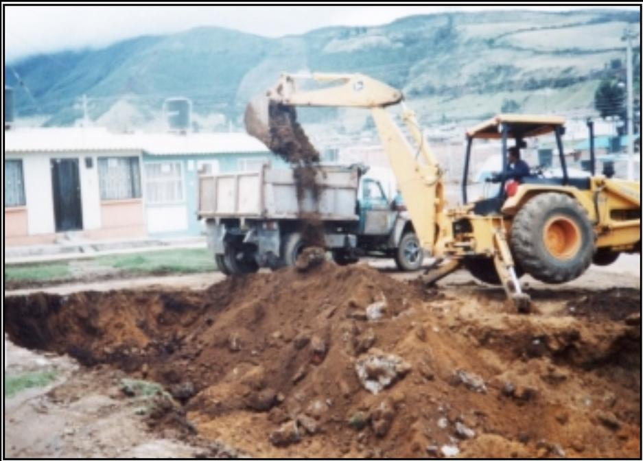
**Figura 115. *Excavación para Cimiento***
