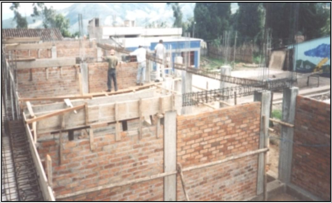
**Figura 84. Vigas Corona Fundidas y Repello Esmaltado e Impermeabilizado**
