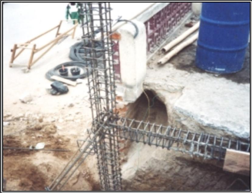
**Figura 230. Viga de Cimentación Fundida**
