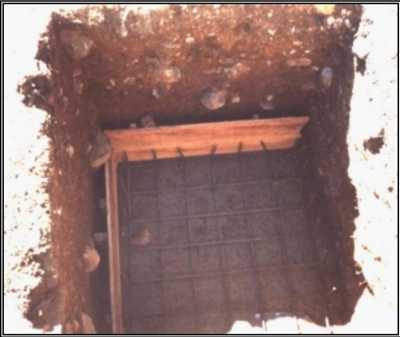
**Figura 6. Castillos de Columnas**
