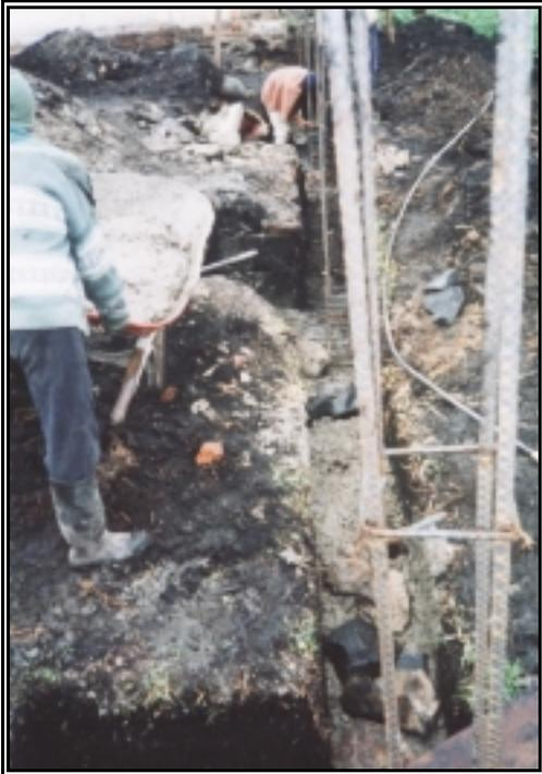
**Figura 40. *Viga de Cimentación Fundida***
