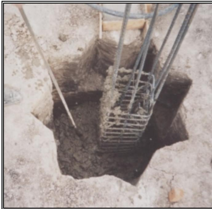
**Figura 151. Solado para Viga de Cimentación**
