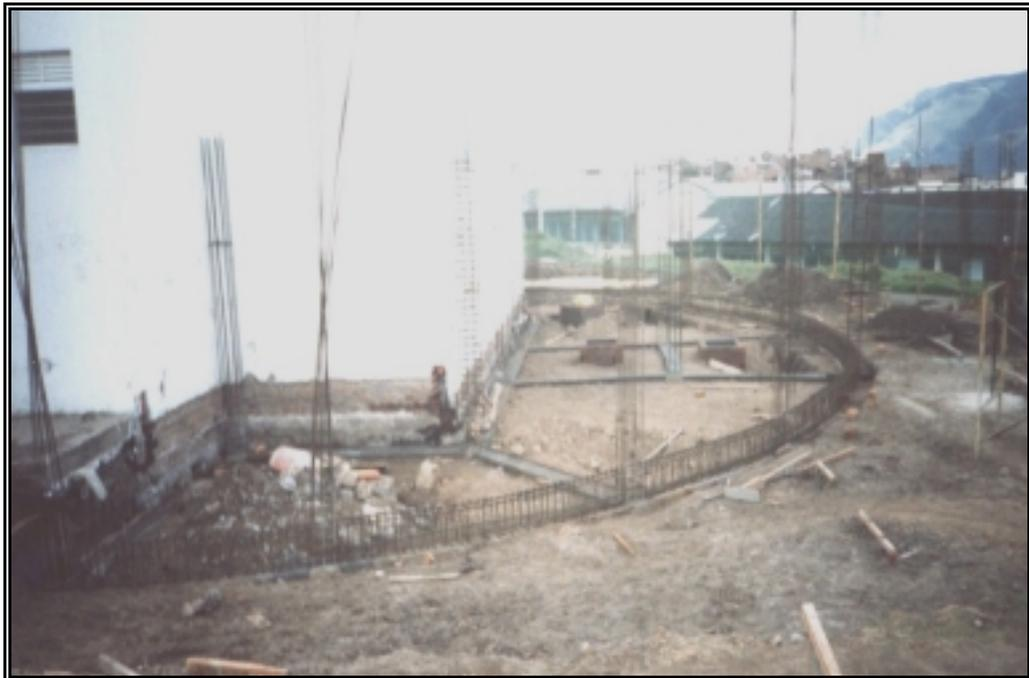
**Figura 155. Vigas de Cimentación Fundidas**
