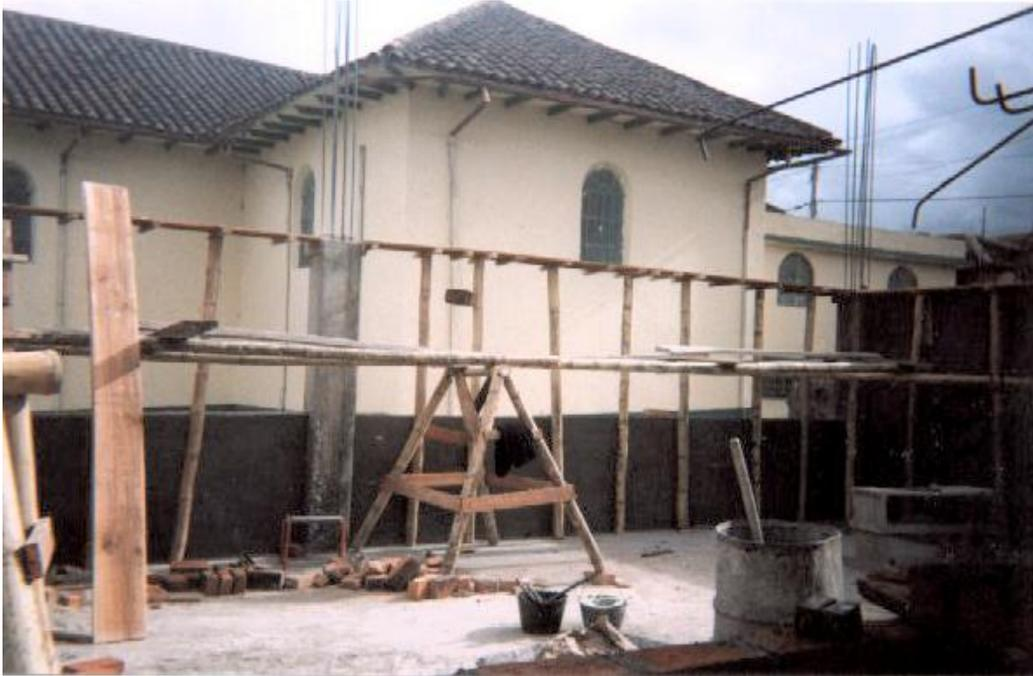
**Figura 78. Columnas N+5.30 a N+7.90 y mampostería repellada**
