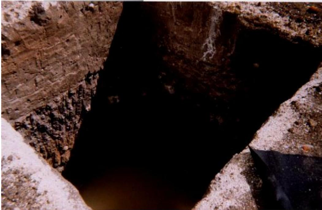
**Figura 7. Colocación de geotextil para trinchera.**
