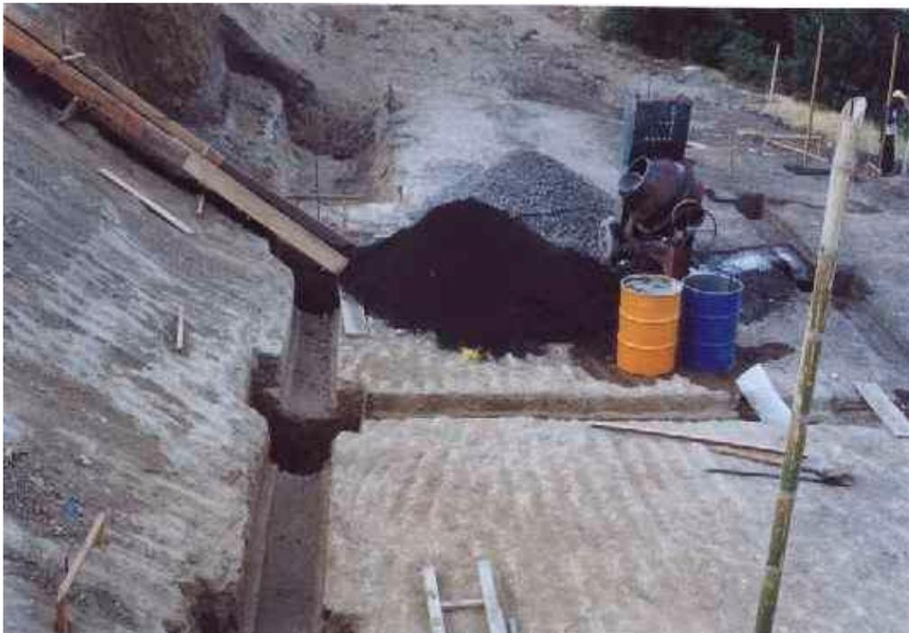
**Figura 105. Perfilación de terreno con retroexcavadora bloque de 2 pisos**
