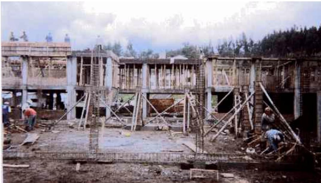
**Figura 132. Fundición de vigas de cimentación**
