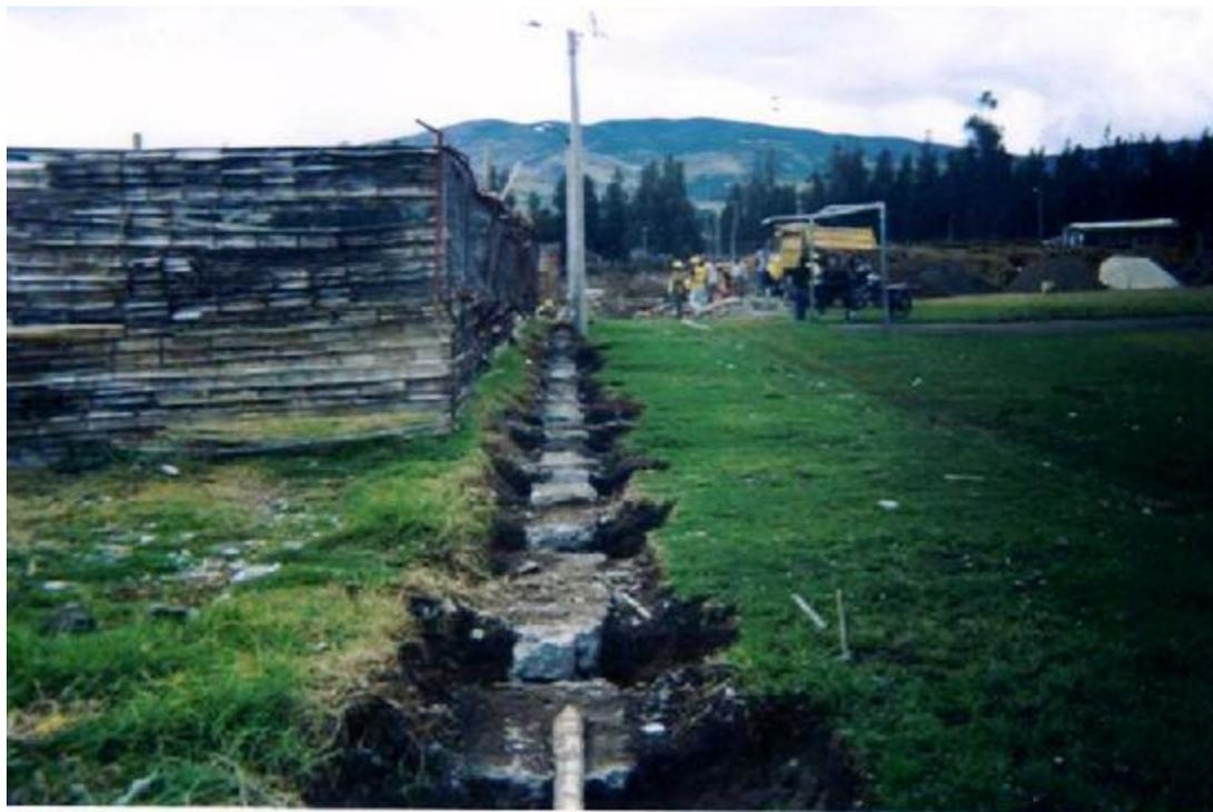
**Figura 38. Armado de refuerzo de zapata de muro de cierre**
