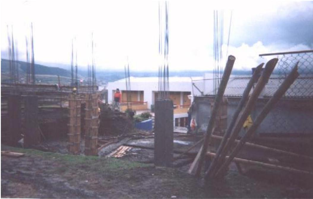
**Figura 31. Fundición de placa de piso**
