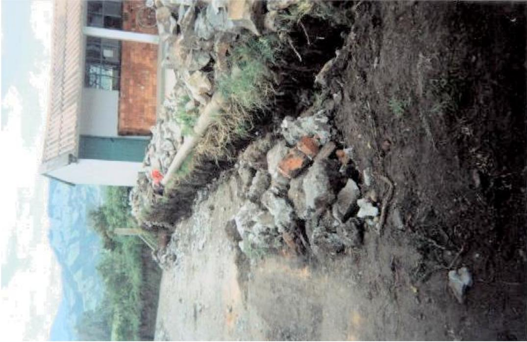
**Figura 91. Fundición de cimiento y contención en ciclópeo**
