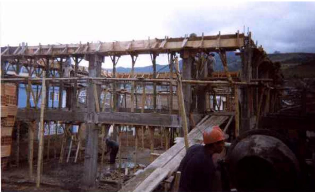
**Figura 125. Módulos de Ensayo, fundición de columnas**
