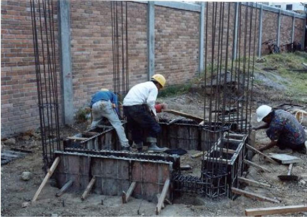
**Figura 118. Vigas y columnas fundidas batería sanitaria preescolar**
