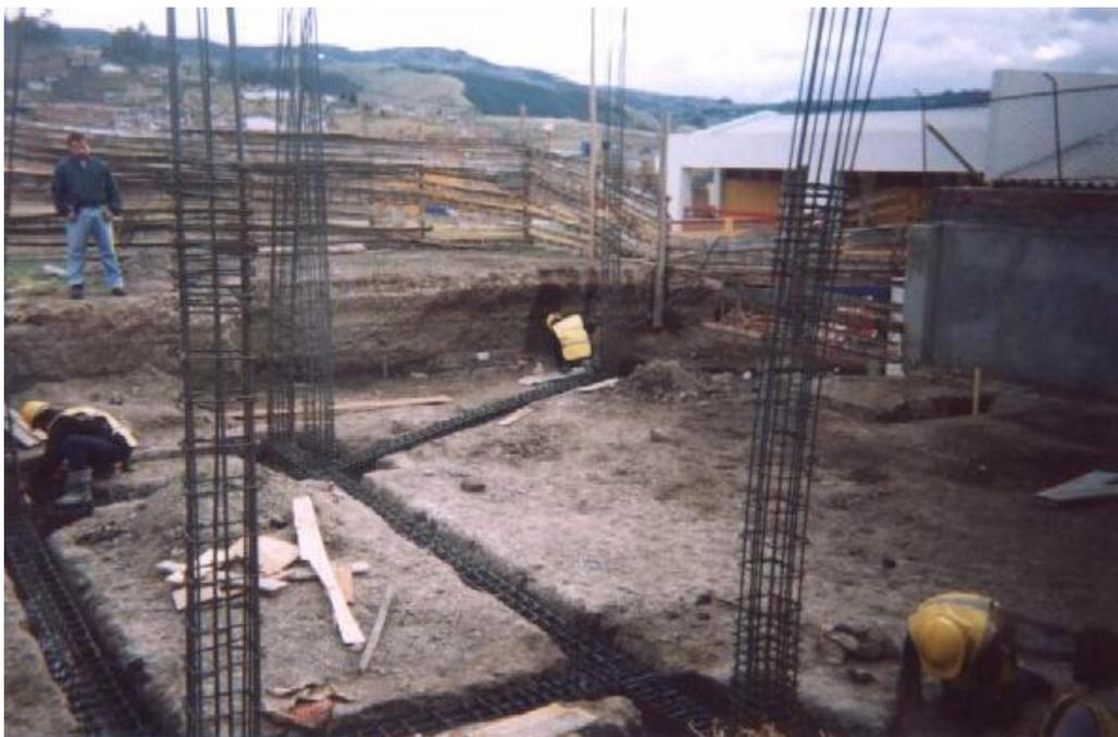
**Figura 30. Fundición de columnas**
