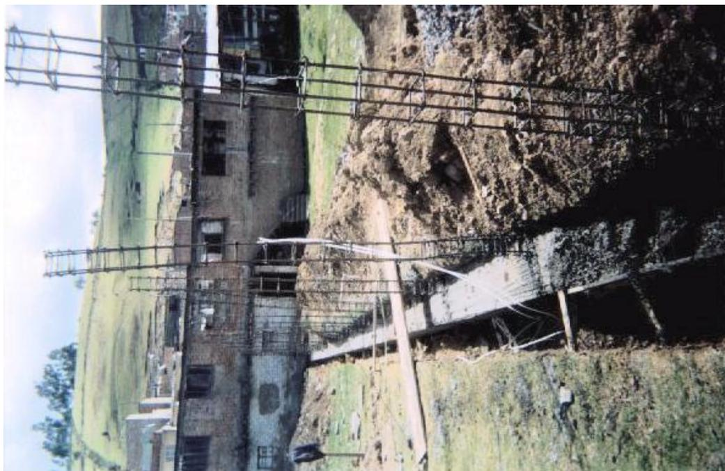
**Figura 22. Viga de cimentación muro de cierre**
