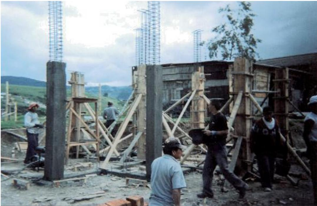
**Figura 126. Módulos de Ensayo, Armado de vigas corona**
