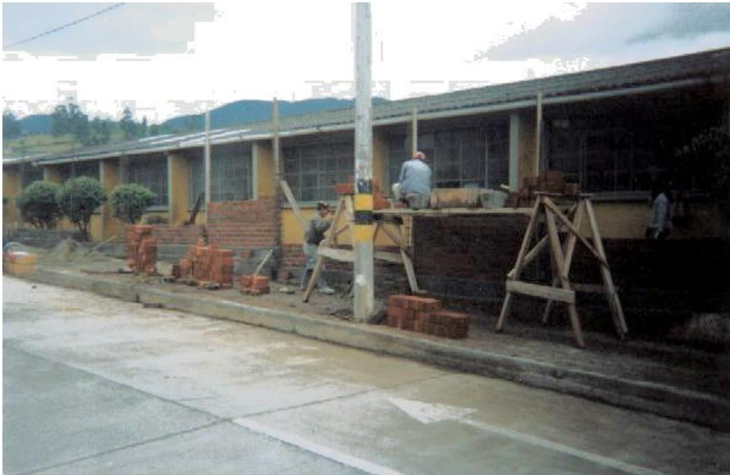
**Figura 49. Muro de cierre finalizado**
