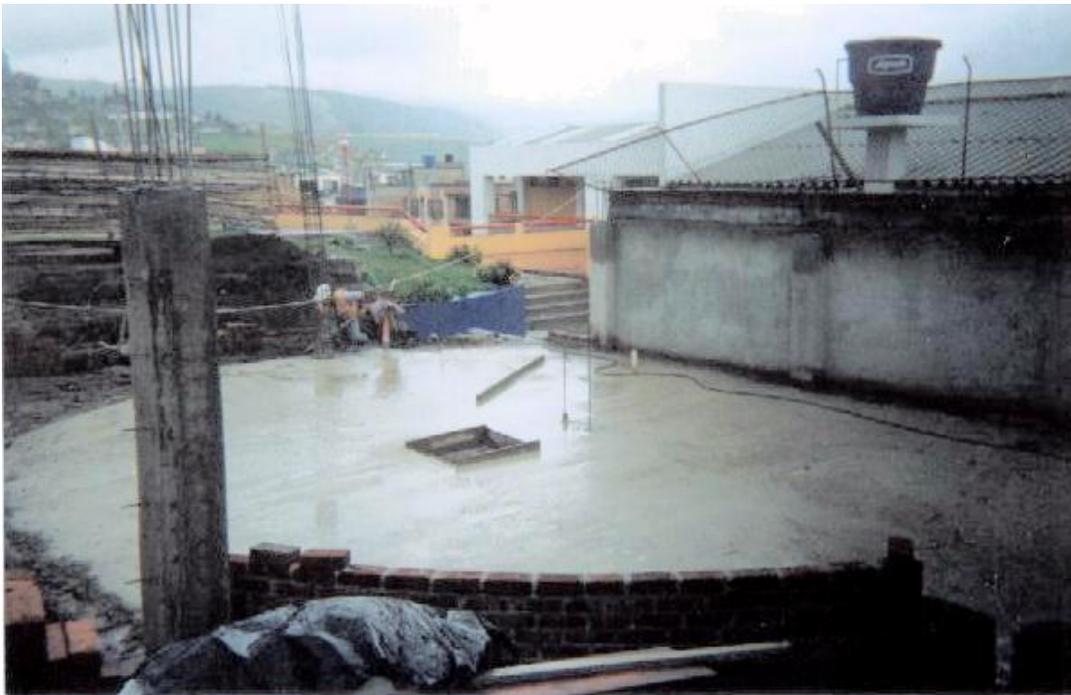
**Figura 34. Placa y losa canal fundida**
