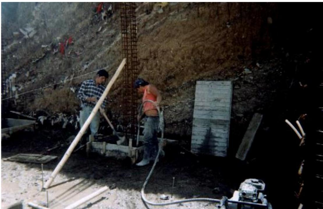
**Figura 10. Armado de refuerzo vigas de cimentación y columnas.**
