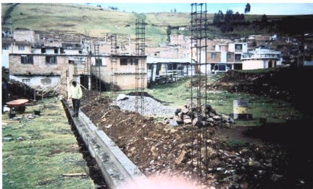
**Figura 23. Fundición de columnas muro de cierre.**
