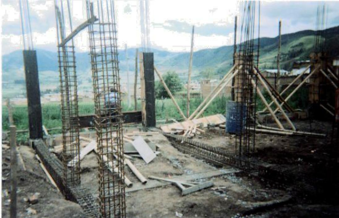
**Figura 59. Armado de vigas aéreas y pega de mampostería primer piso**
