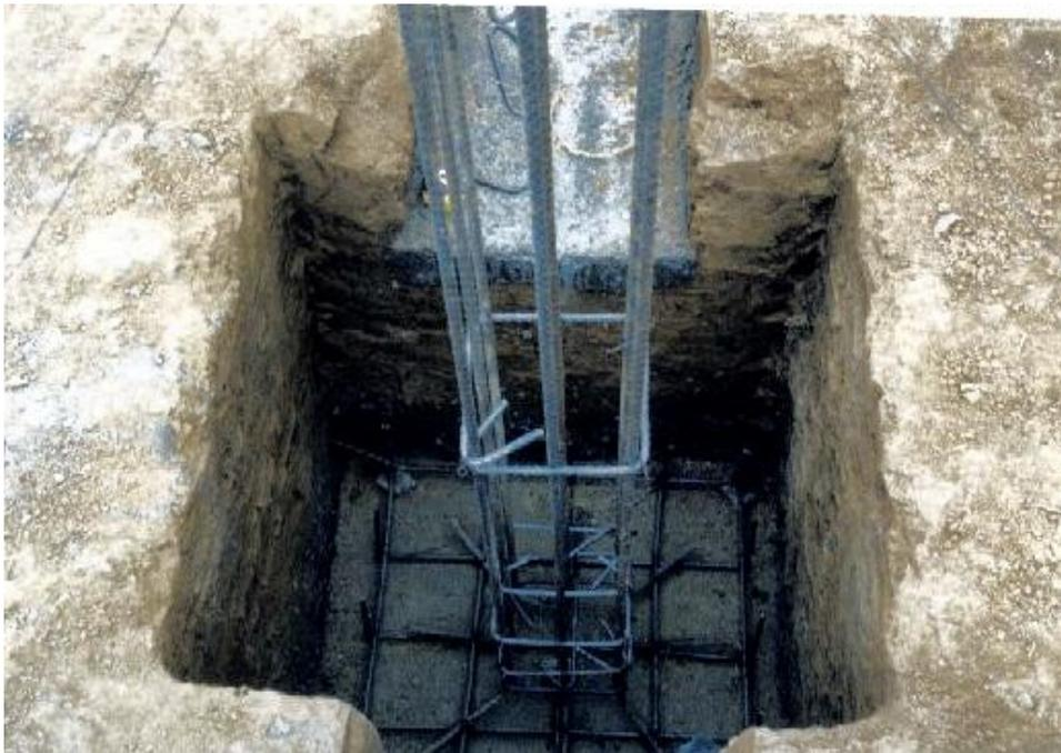
**Figura 115. Columnas y vigas de cimentación fundidas batería sanitaria de adultos**
