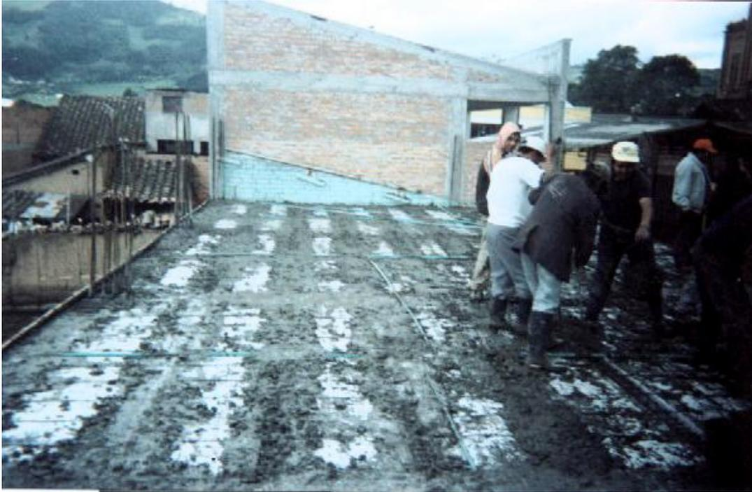
**Figura 63. Fundición de losa aligerada 2**
