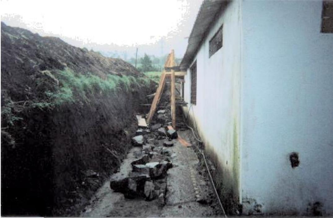
**Figura 89. Fundición muro de contención posterior de la escuela**
