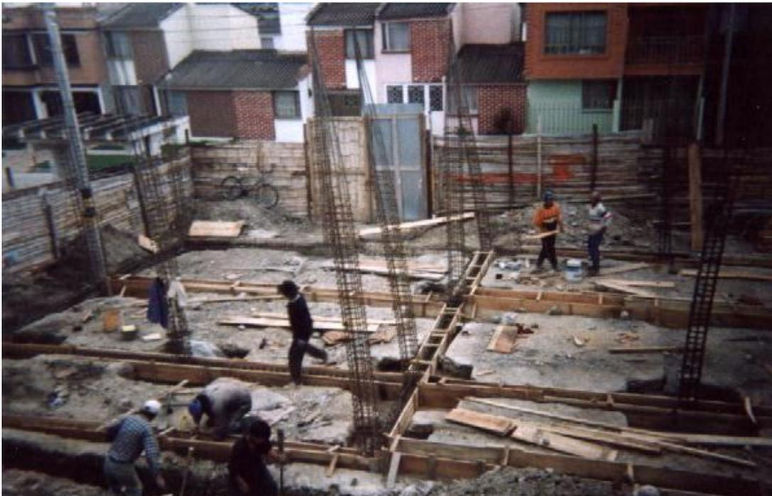
**Figura 72. Fundición de vigas de cimentación con premezclado**
