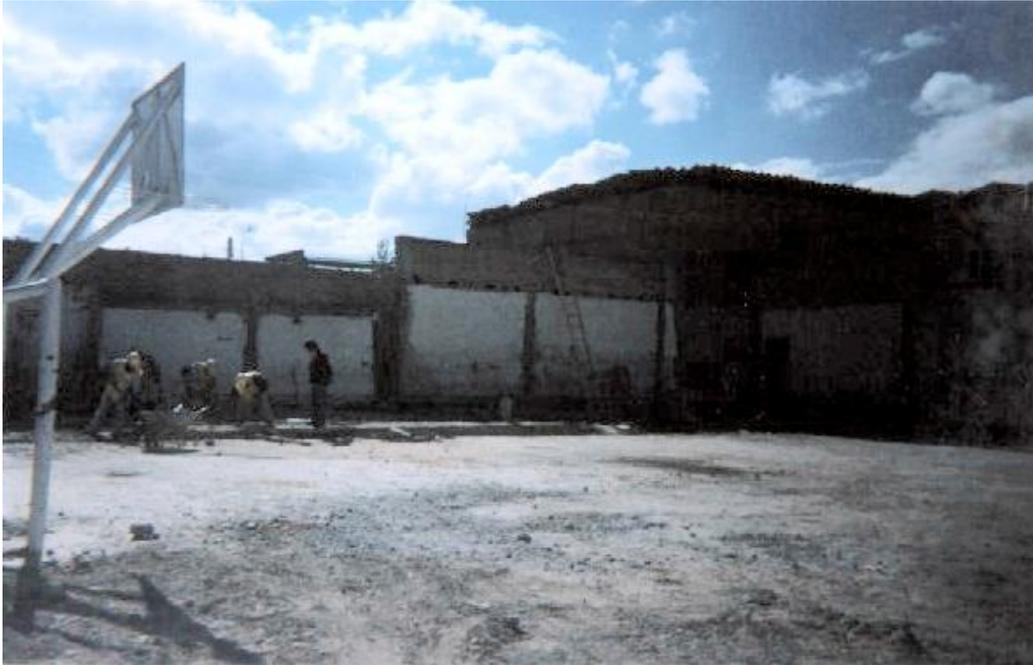
**Figura 97. Excavaciones para zapatas del bloque 1**
