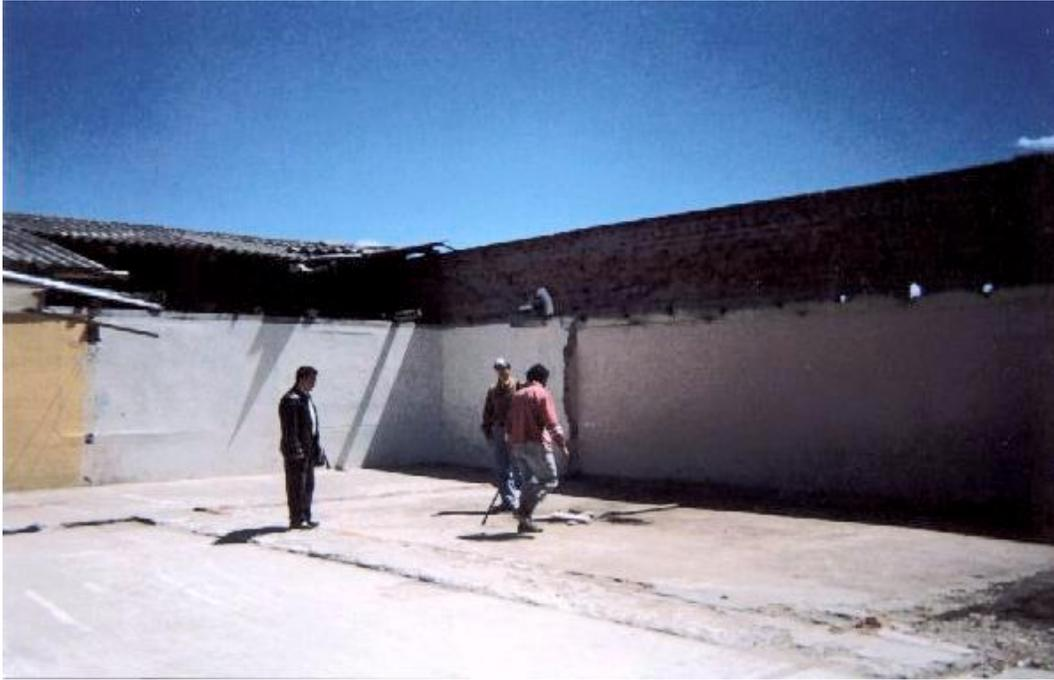
**Figura 57. Demolición de piso y excavaciones para cimientos**
