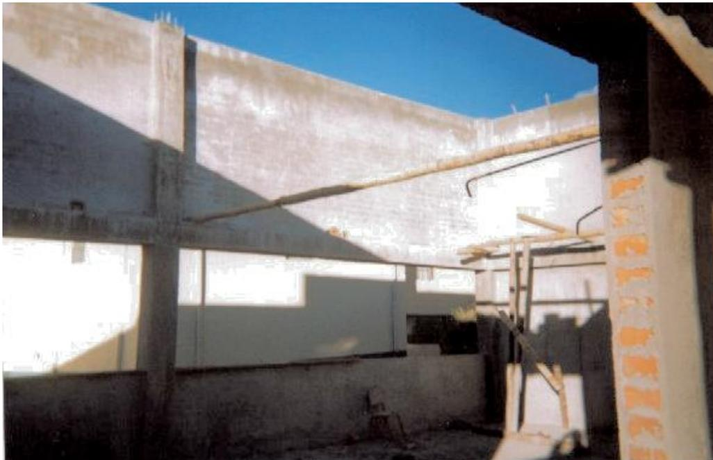
**Figura 81. Pega de mampostería culata de cierre y estructura en concreto**
