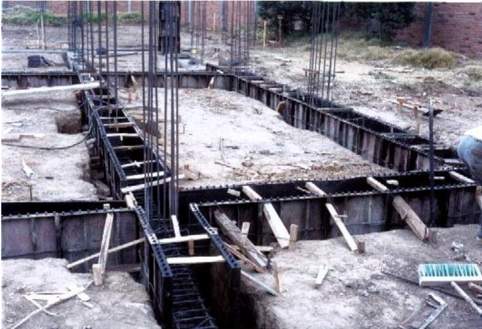
**Figura 111. Columnas y vigas de cimentación fundidas bloque de 1 piso**
