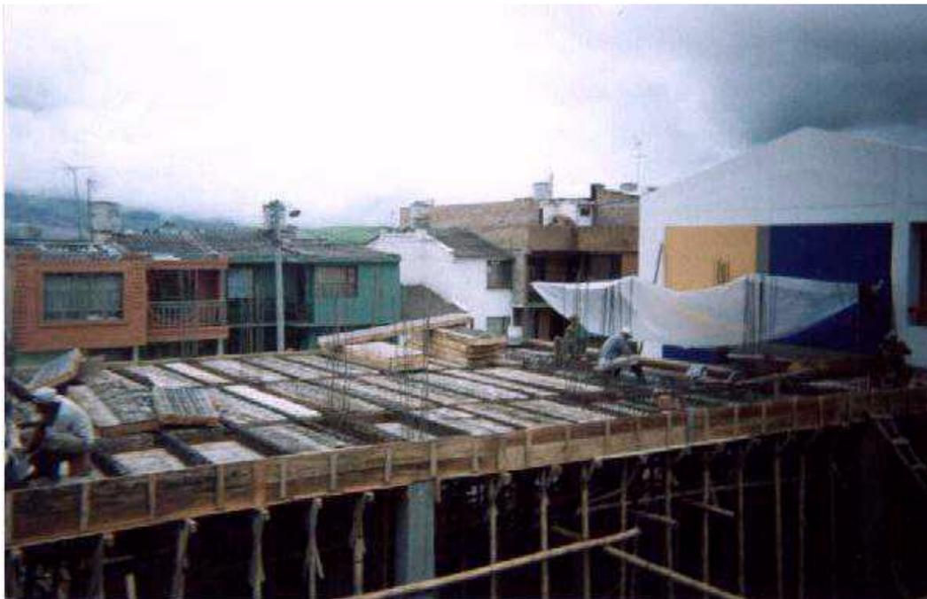
**Figura 76. Detalle de losa aligera**
