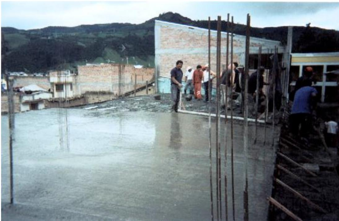
**Figura 64. Losa aligerada fundida.**
