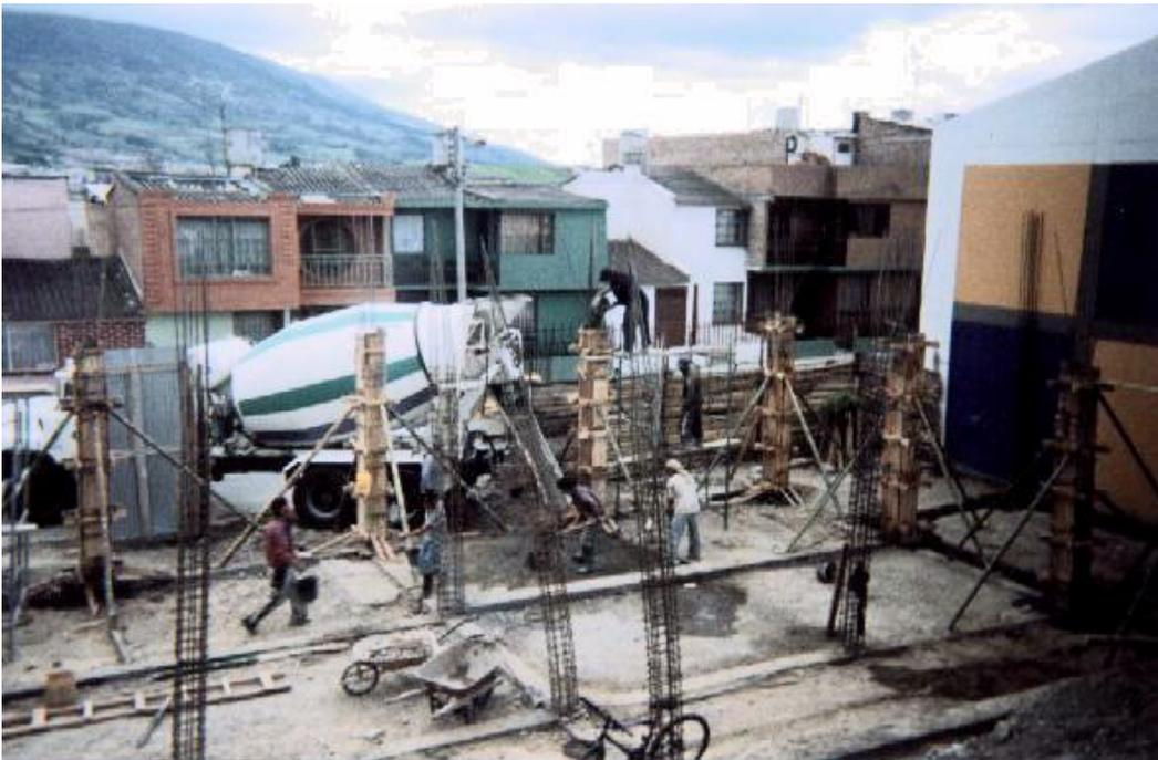
**Figura 74. Armado del refuerzo de vigas aéreas**
