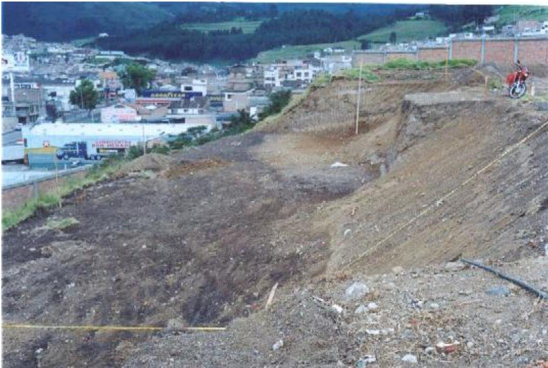
**Figura 103. Excavación de zapatas y vigas de cimentación bloque 2 pisos**
