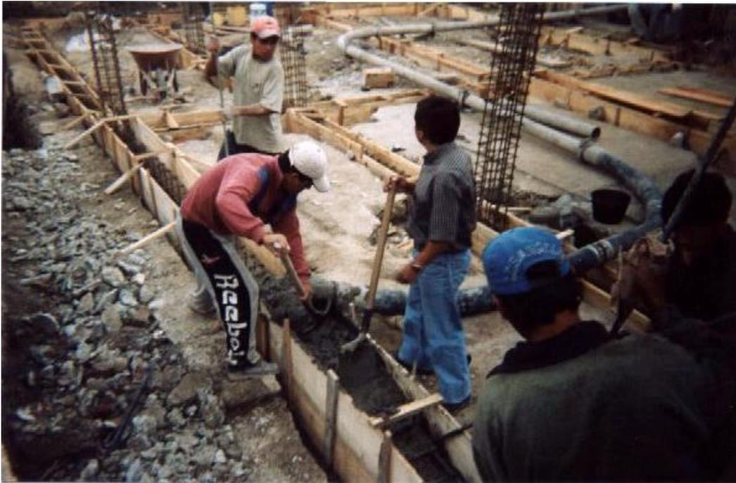
**Figura 73. Fundición de columnas con concreto premezclado**
