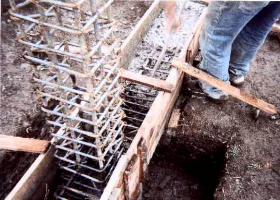
**Figura 133. Columnas fundidas**
