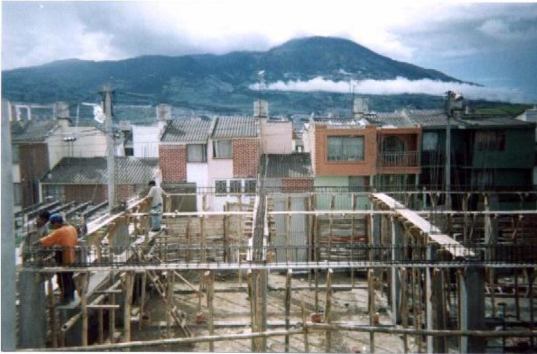
**Figura 75. Armado casetones y nervios de losa aligerada**
