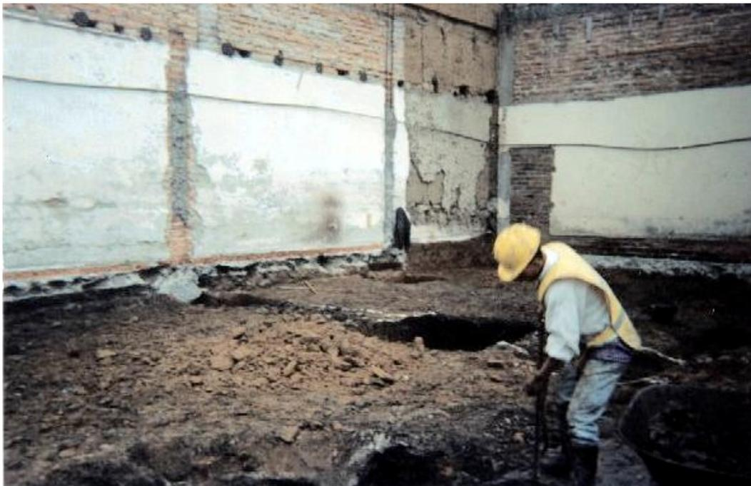
**Figura 98. Ensayo de densidad “in situ” para plintos**
