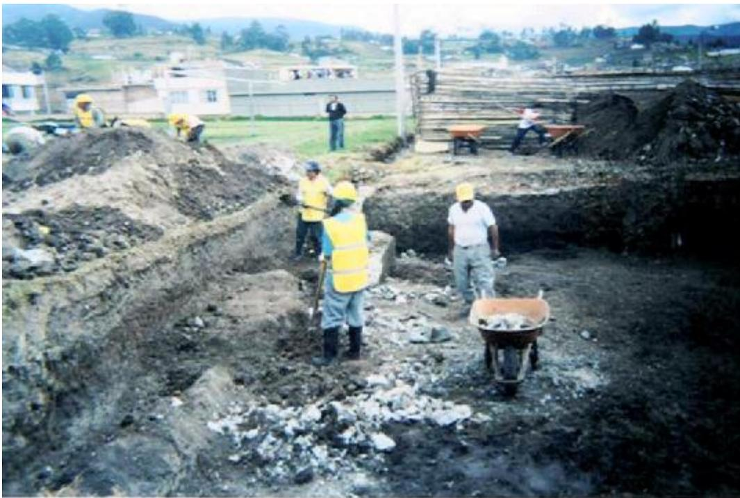
**Figura 26. Excavación de zapatas y cimientos**
