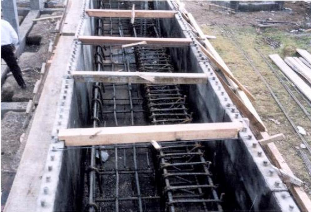
**Figura 114. Detalle armado zapata batería sanitaria de adultos**
