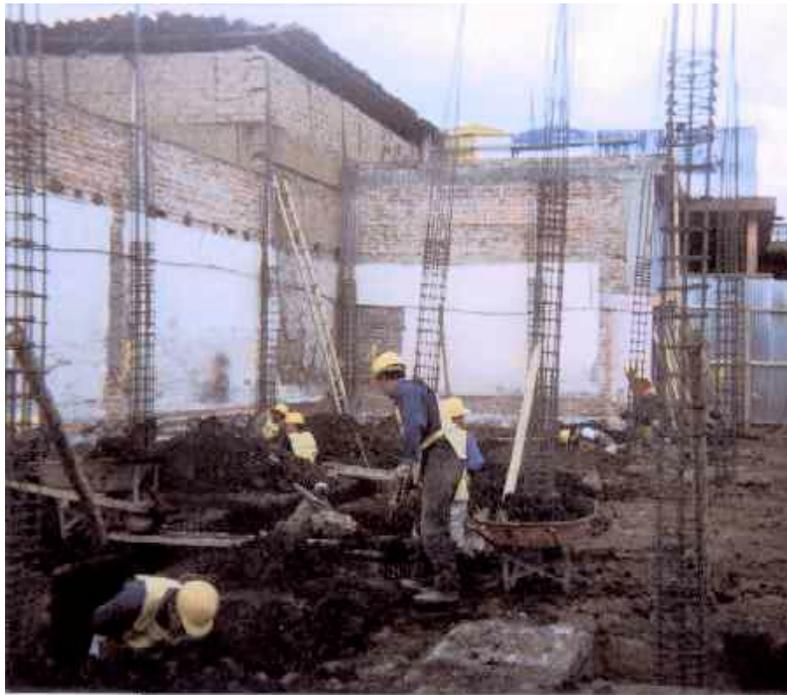
**Figura 100. Armado de vigas de cimentación bloque 1**
