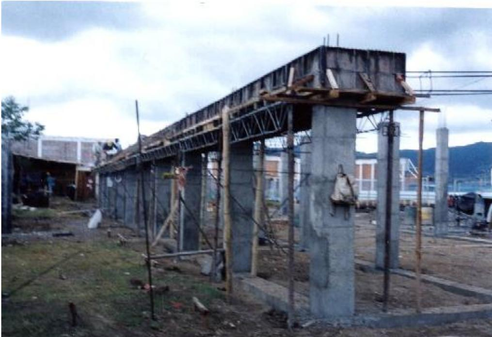
**Figura 113. Detalle refuerzo viga canal eje A**
