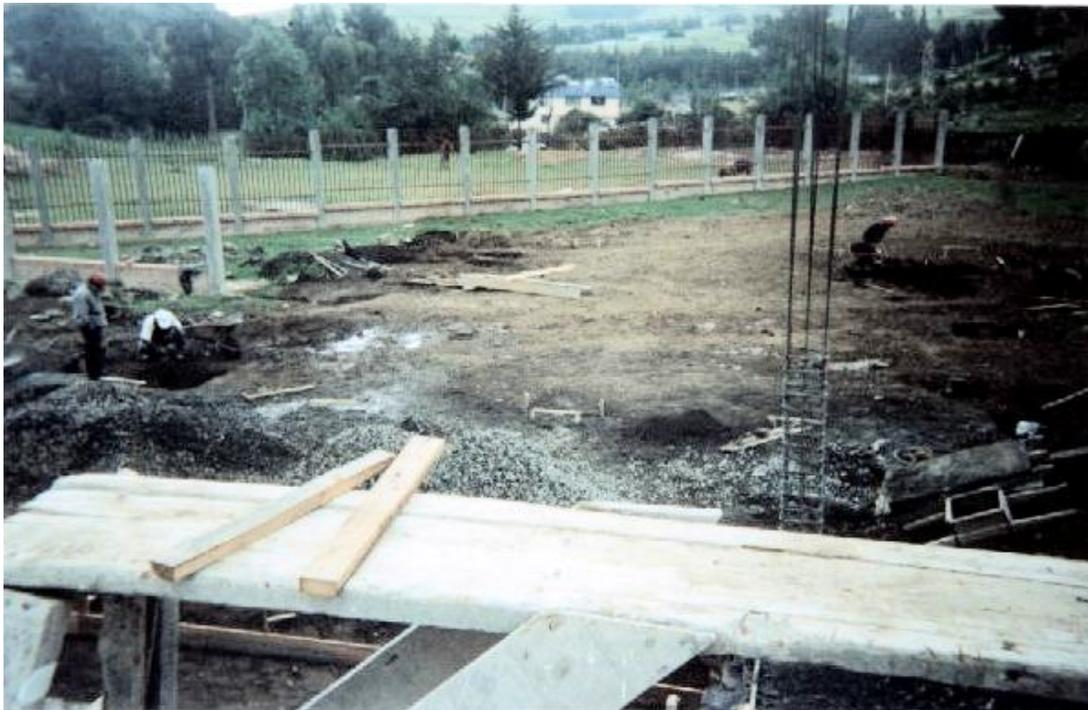
**Figura 130. Solado fundido para zapata**
