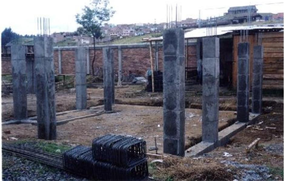
**Figura 116. Excavación zapatas batería sanitaria preescolar**
