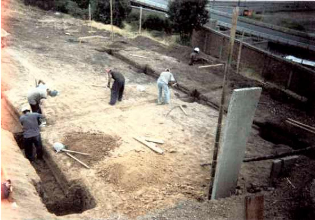
**Figura 104. Fundición de solados de zapatas y vigas bloque 2 pisos**
