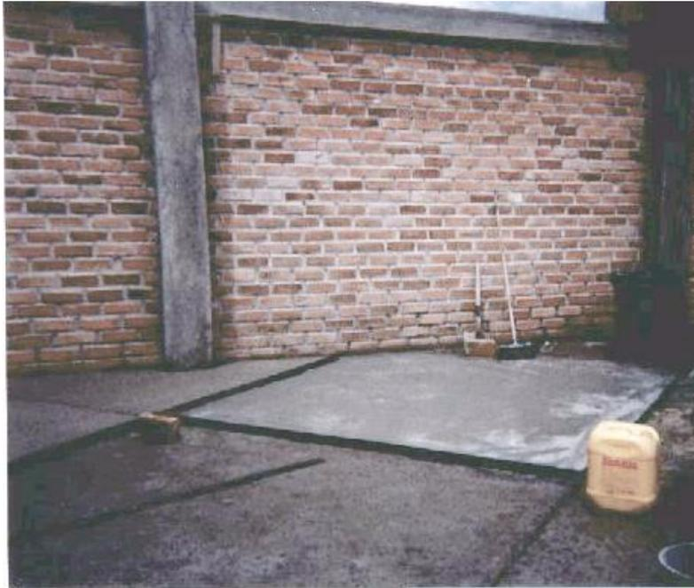
**Figura 86. Aspecto final del pavimento recuperado**
