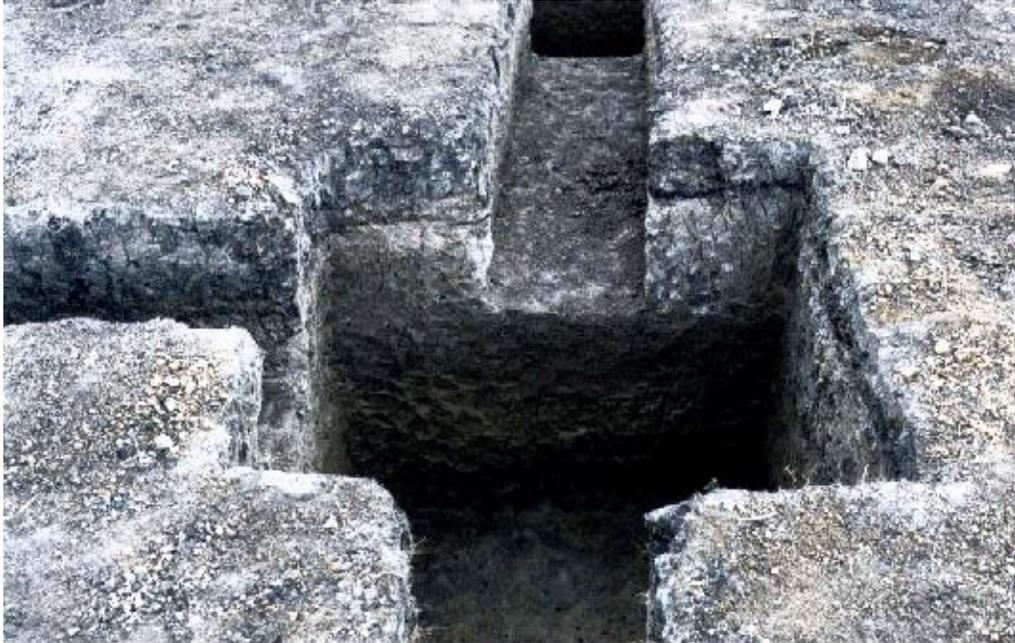
**Figura 108. Excavación de zapatas y vigas bloque de 1 piso**
