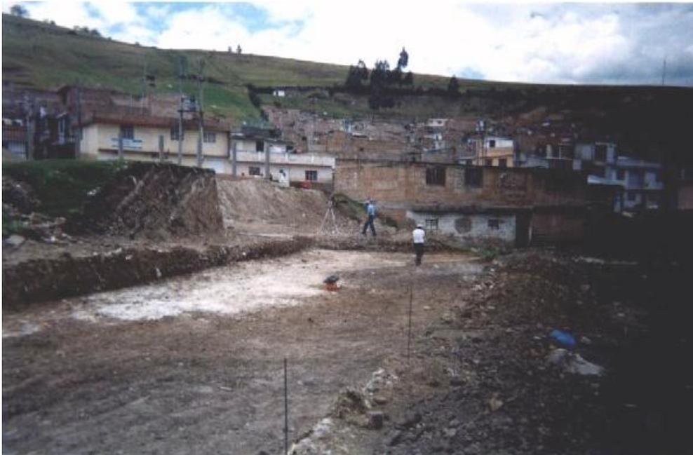
**Figura 4. Excavaciones para zapatas**
