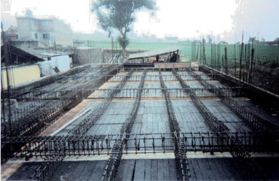
**Figura 61. Nudo crítico, intersección vigas ejes 2 y B**
