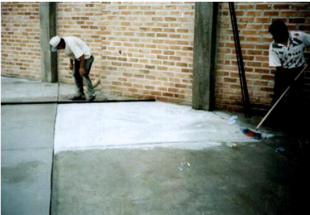
**Figura 85. Fundición de paños y mezcla de aditivo**
