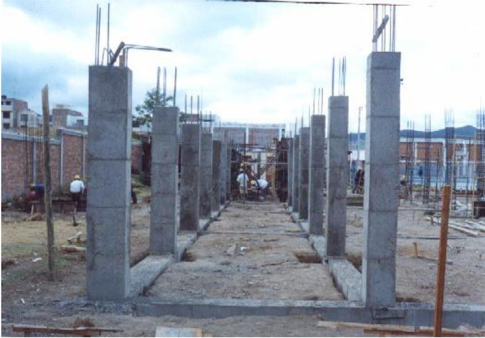
**Figura 112. Armado de viga canal eje A**
