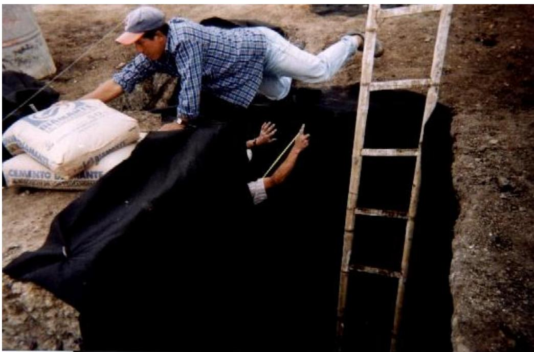
**Figura 8. Compactación suelo-cemento para trinchera.**
