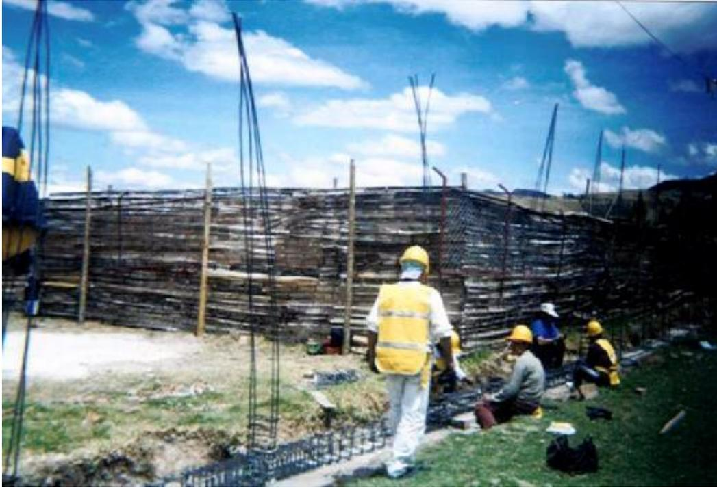
**Figura 41. Fundición de viga de piso de muro de cierre**
