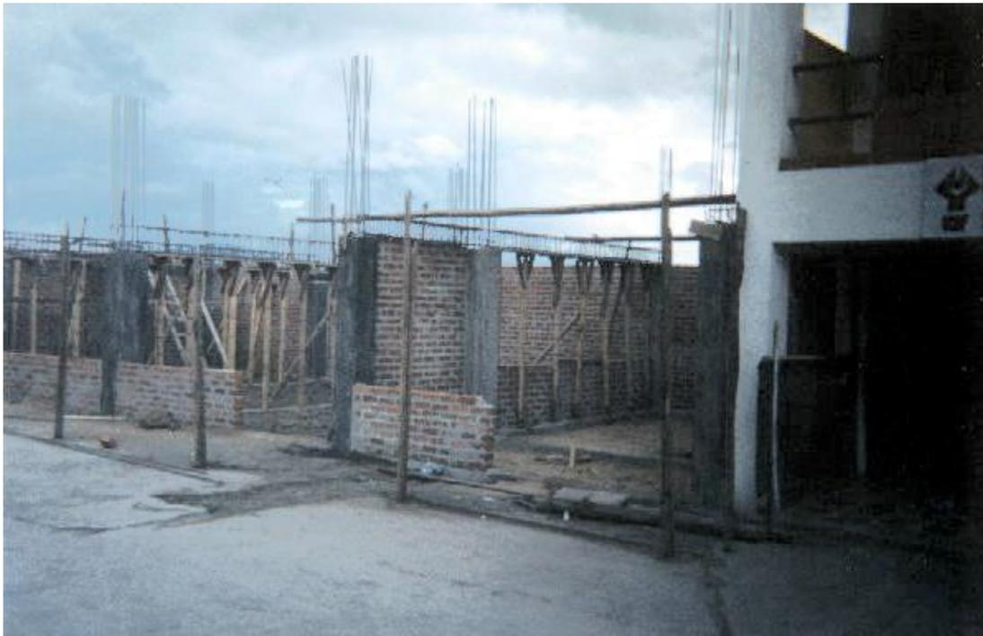
**Figura 60. Armado de losa aligerada**
