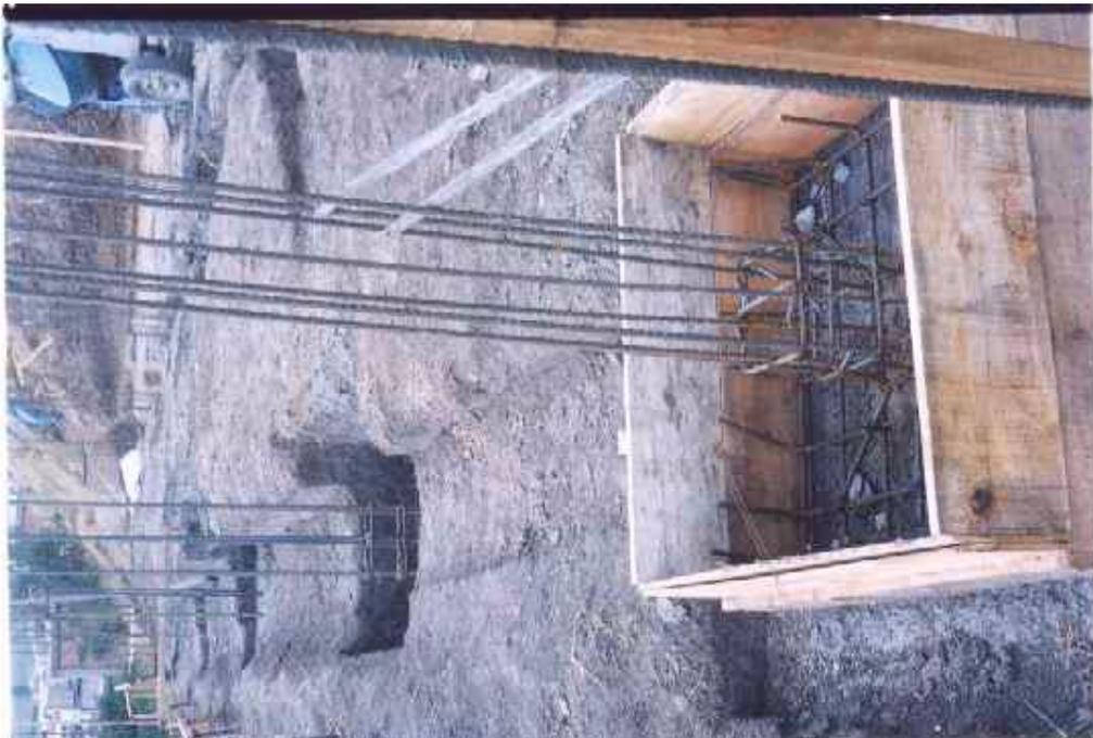
**Figura 107. Excavaciones de zapatas y vigas de cimentación bloque de 1 piso**
