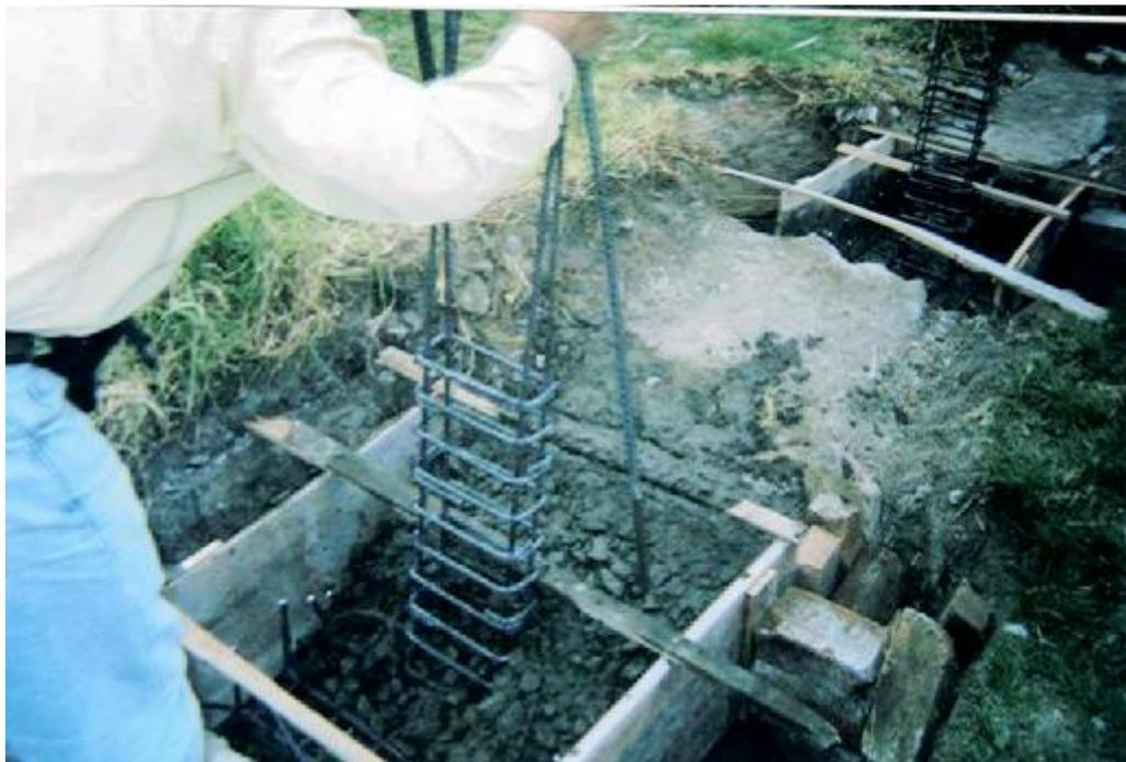
**Figura 40. Armado de viga de piso del muro de cierre**
