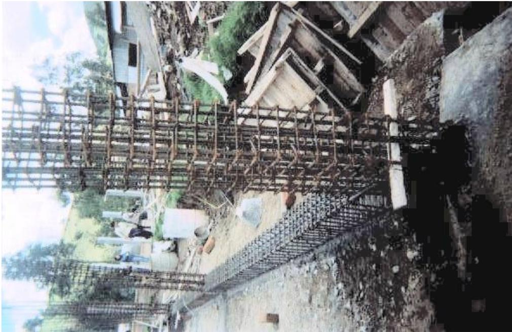
**Figura 11. Vigas de cimentación ya fundidas.**
