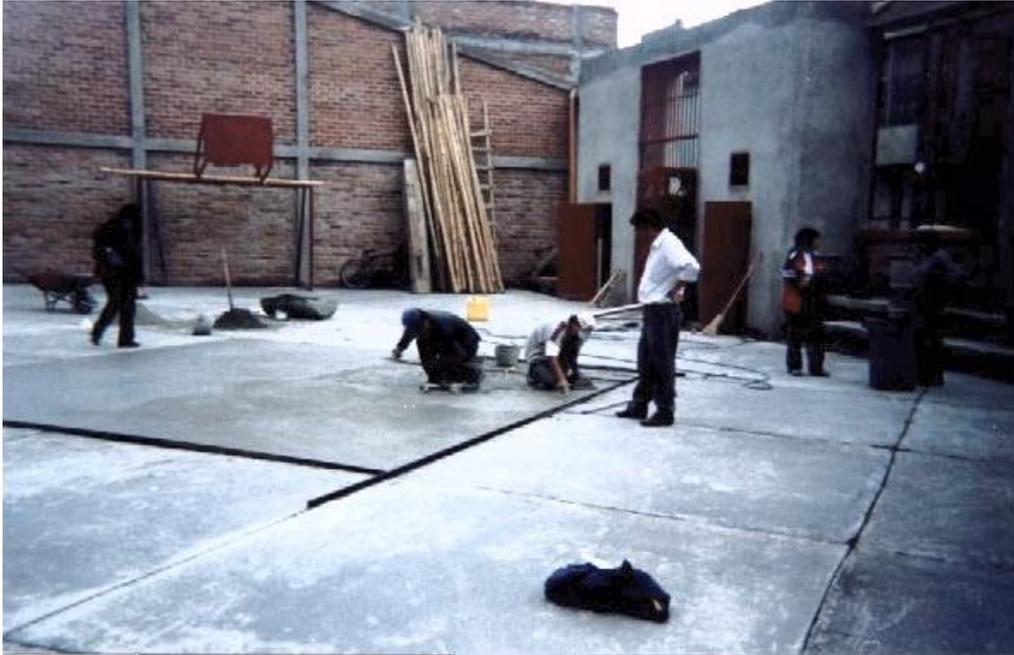
**Figura 84. Mezcla inicial de aditivo sobre el pavimento**
