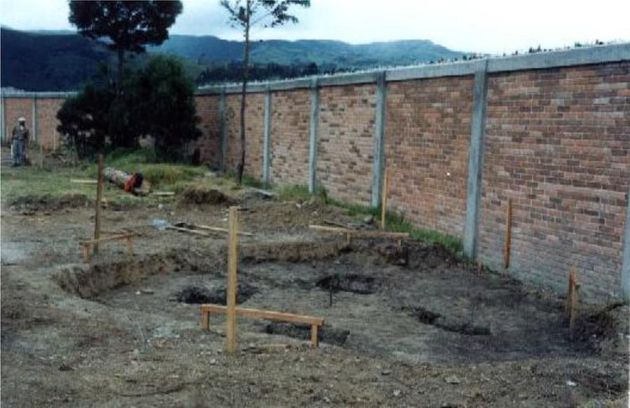
**Figura 117. Armado vigas de cimentación batería sanitaria preescolar**
