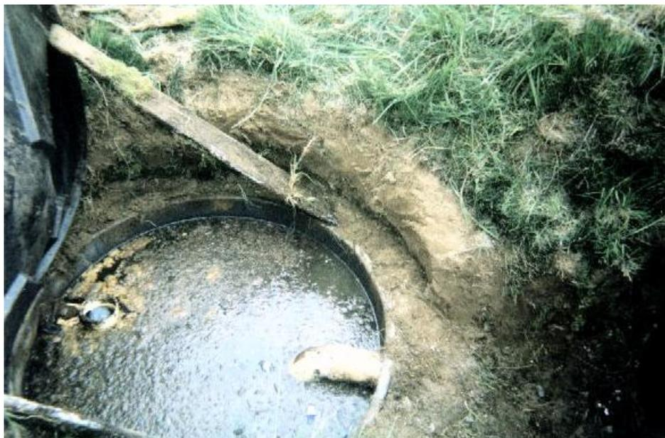
**Figura 139. Compartimento No. 2 Tanque séptico existente**
