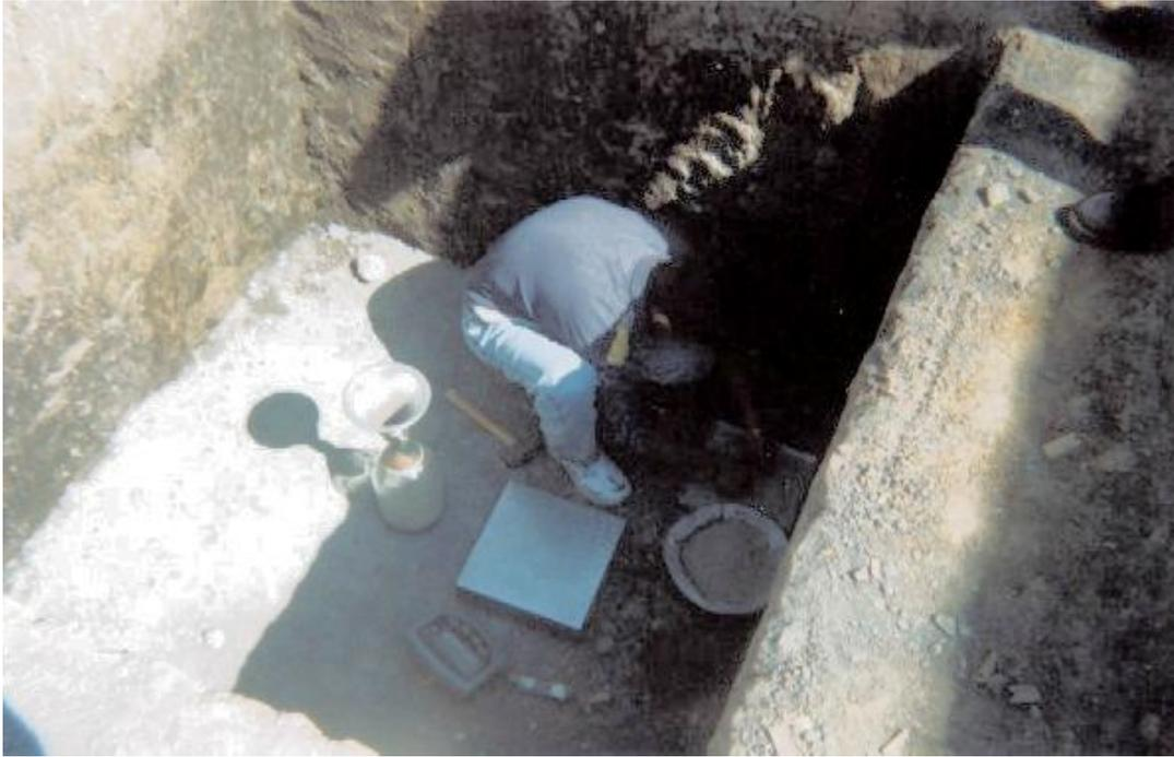
**Figura 99. Excavación para vigas de cimentación bloque 1**
