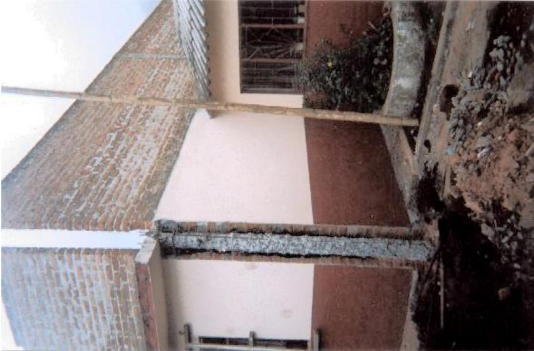
**Figura 52. Columna con el refuerzo para recalce**
