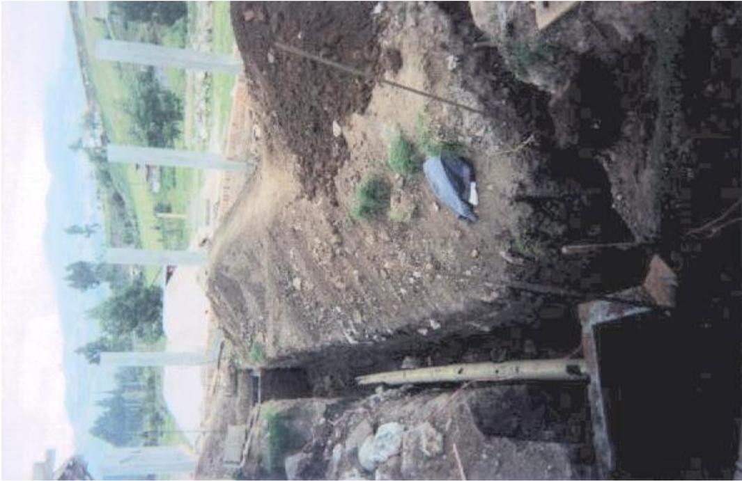
**Figura 17. Excavación para tubería de aguas lluvias.**
