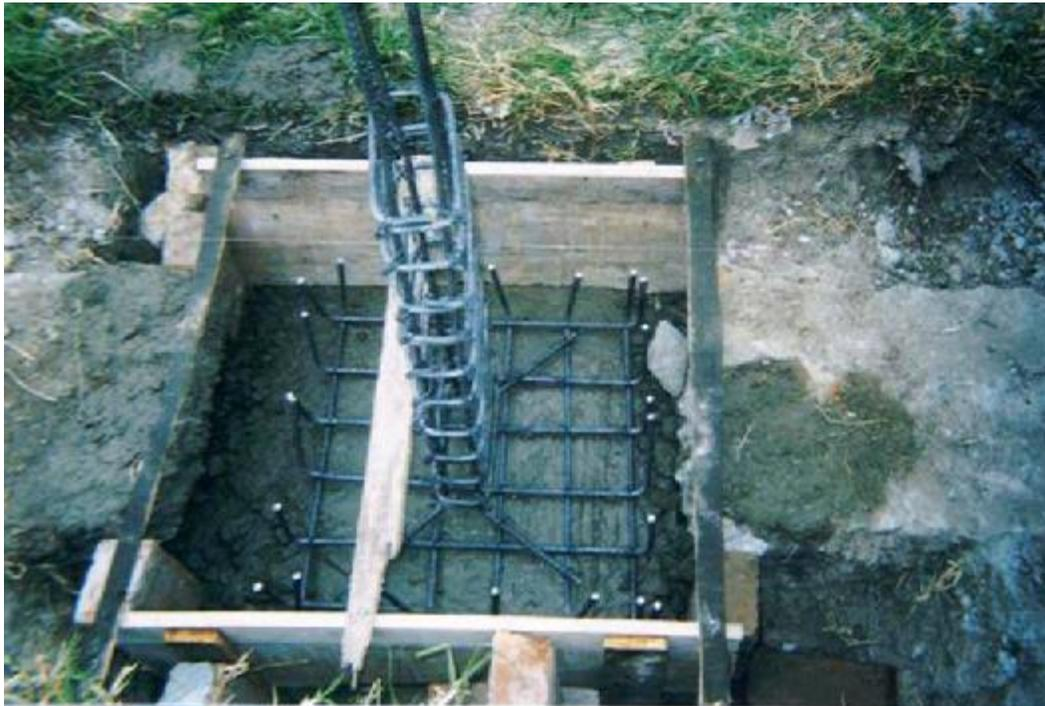
**Figura 39. Fundición de zapatas del muro de cierre**
