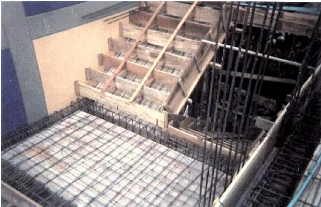
**Figura 78. Armado de formaleta y refuerzo de viga canal eje D**
