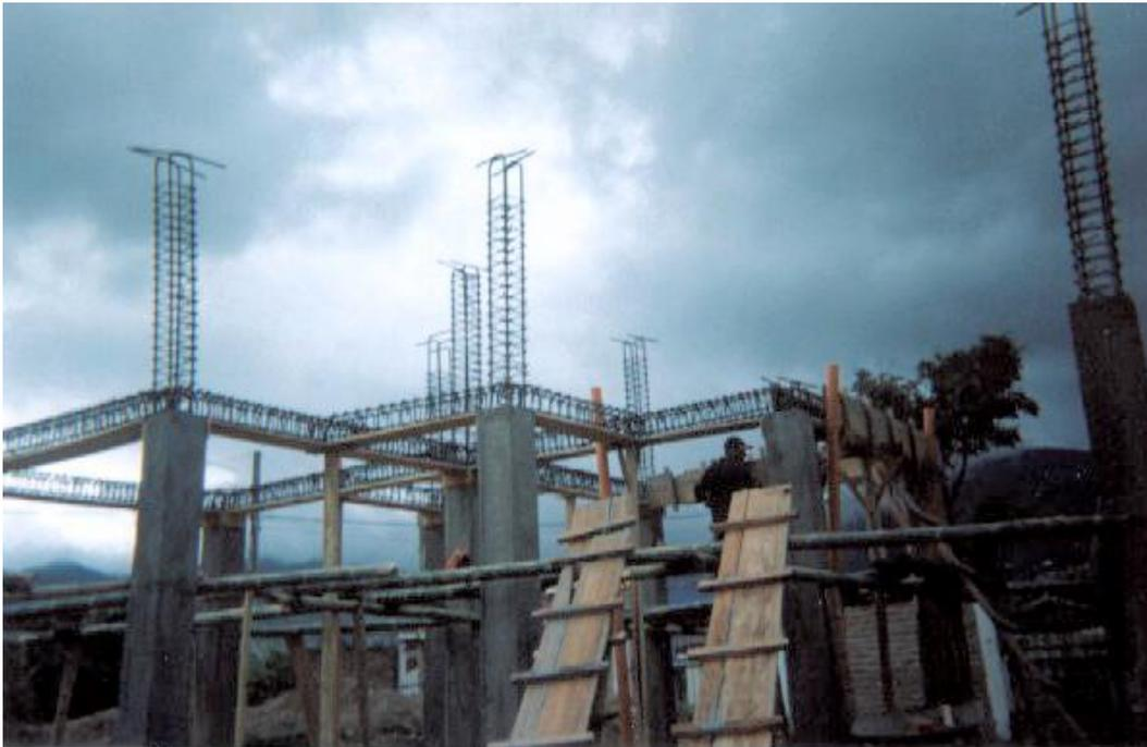
**Figura 127. Módulos de Ensayo, fundición de vigas canal y corona**
