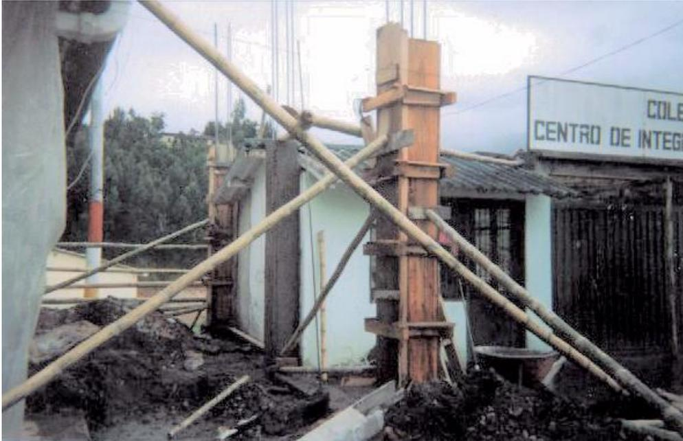
**Figura 67. Fundición de vigas corona aula ampliada**
