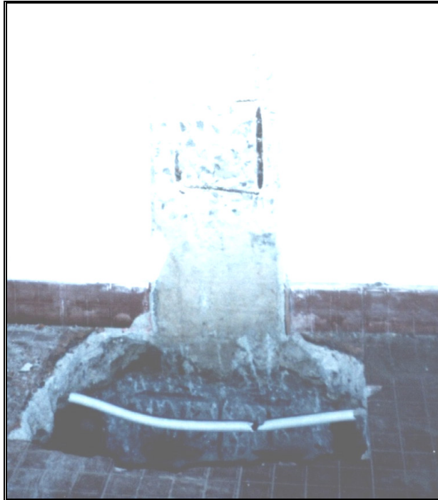
Figura 168. Losa escarificada
