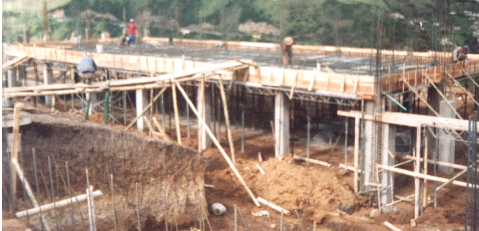
Figura 22. Armado de la losa de entrepiso (terraza 2 primaria)
