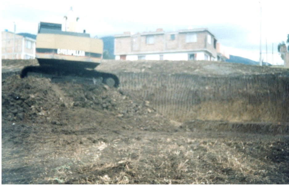
Figura 9. Excavación de zapatas
