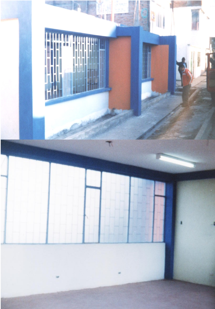
Figura 60. Instalaciones eléctricas y piso
