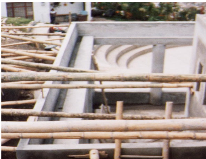
Figura 145. Viga C-13 y placa de contrapiso
