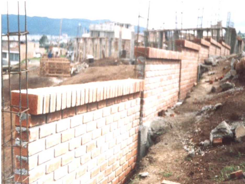
Figura 26. Mampostería muro de cerramiento
