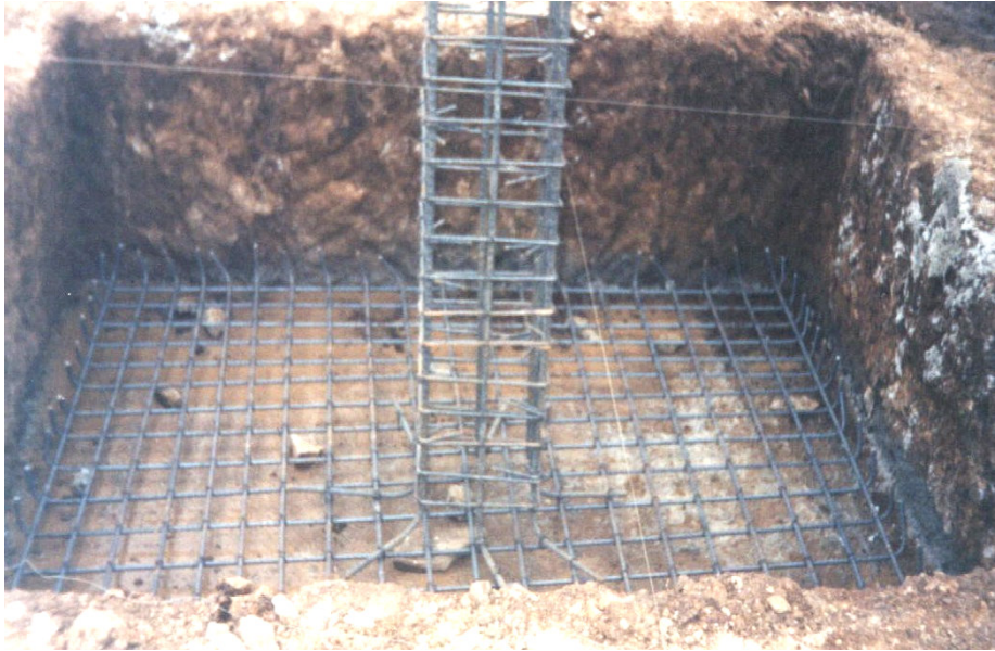
Figura 13. Fundición de zapatas
