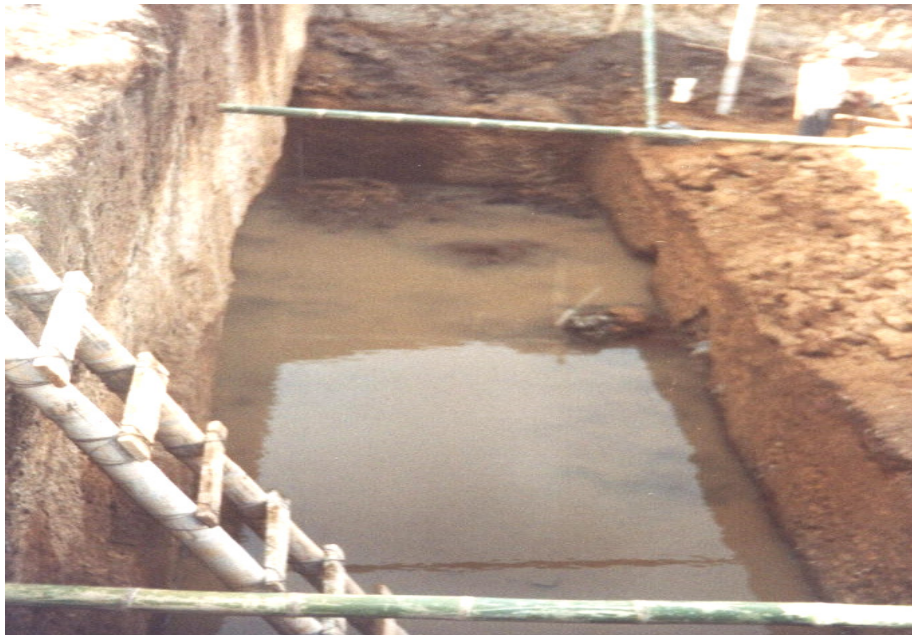
Figura 40. Excavación muro de contención (unidad sanitaria)
