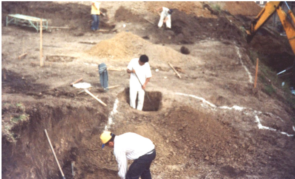
Figura 38. Excavación de zapatas
