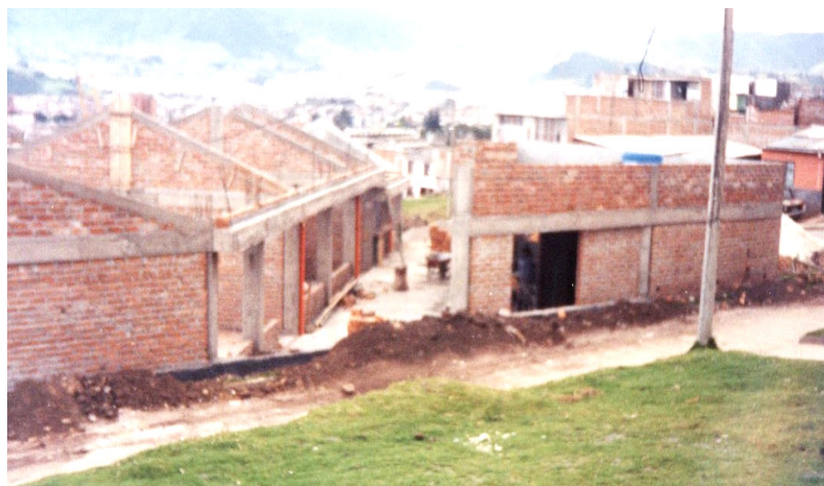
Figura 28. Mampostería bloque de preescolar y unidad sanitaria
