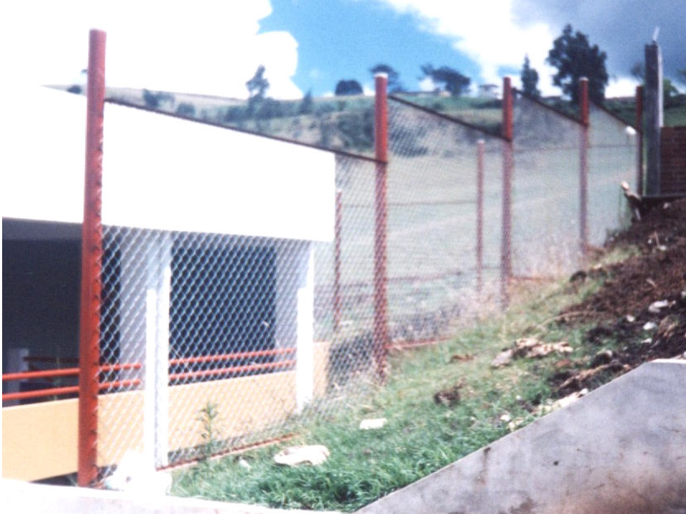
Figura 154. Talud para muro de contención lateral
