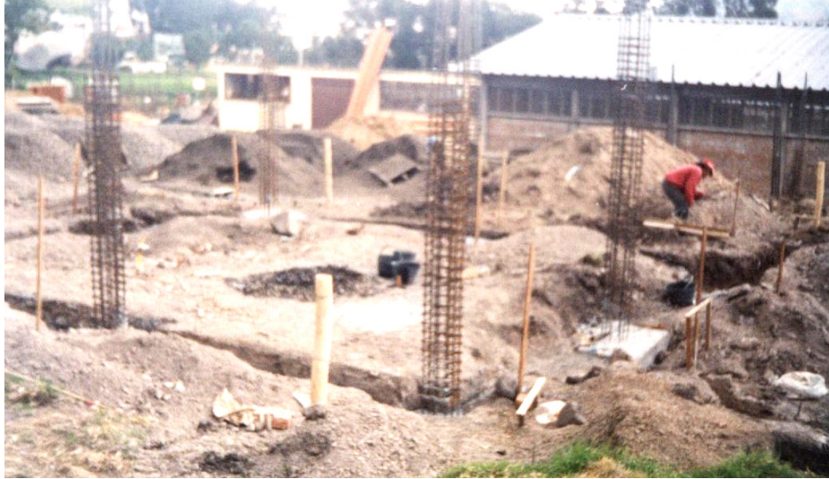
Figura 45. concreto ciclópeo vigas de cimentación (bloque 4)
