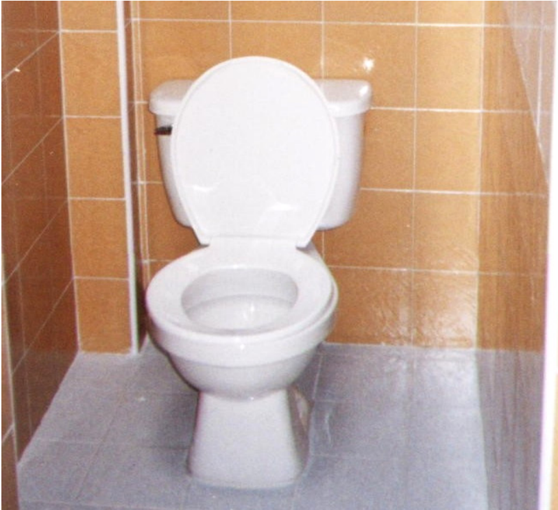
Figura 99. Enchape cerámico pared altura 1.8 m
