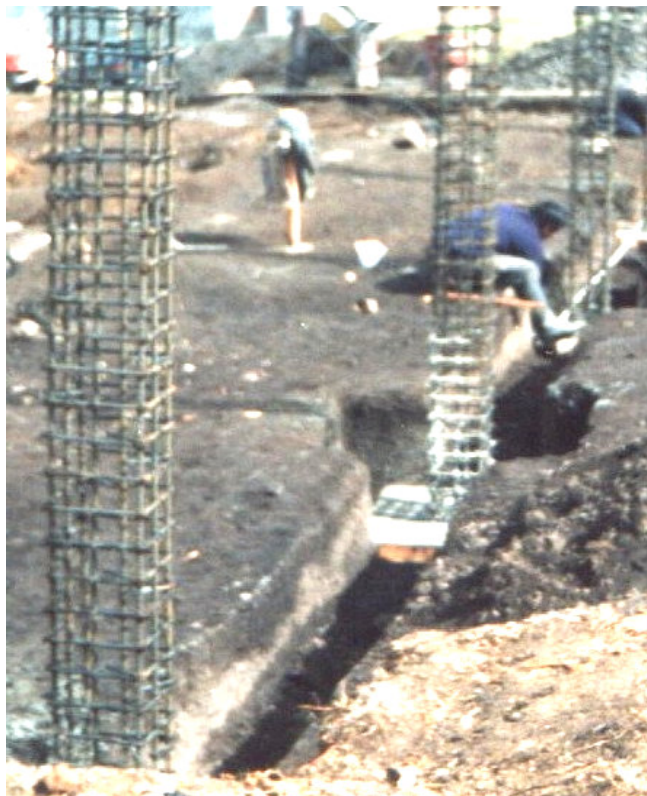
Figura 23. Armado de columnas y fundición de zapatas (muro de cerramiento)
