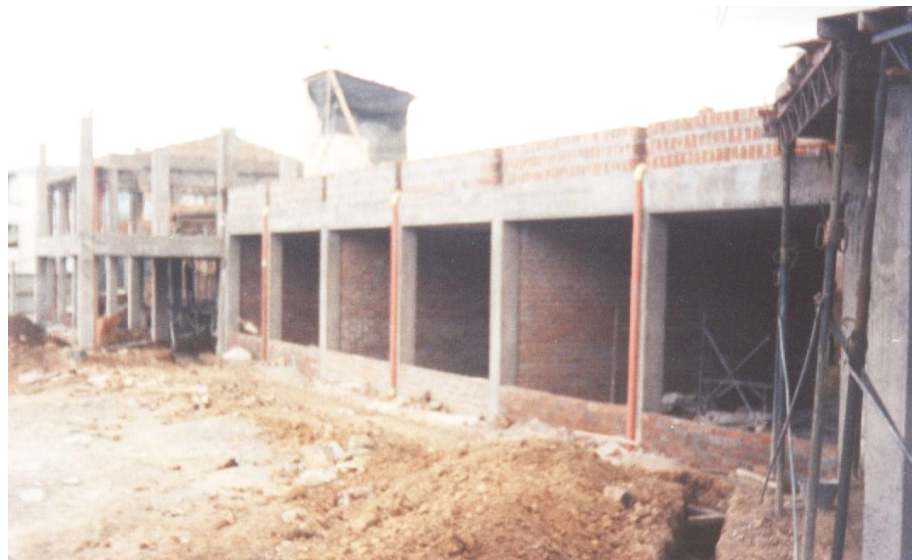
Figura 27. Mampostería bloque de primaria
