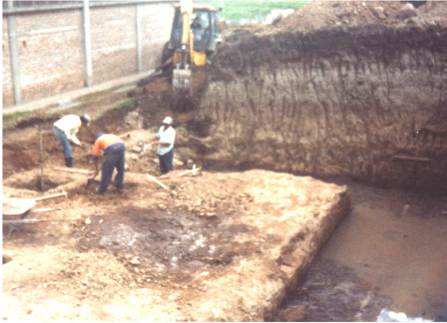
Figura 40. Excavación muro de contención (unidad sanitaria)
