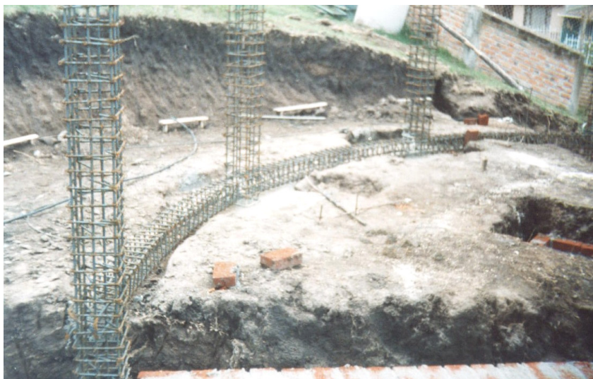
Figura 107. Armado de vigas de cimentación.
