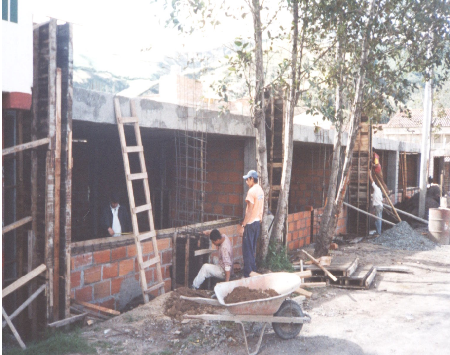
Figura 79. Armado y fundición parasoles fachada
