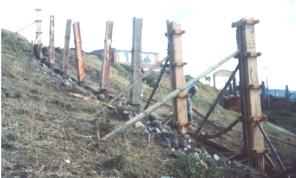
Figura 165. Columnas y mampostería (cerramiento)
