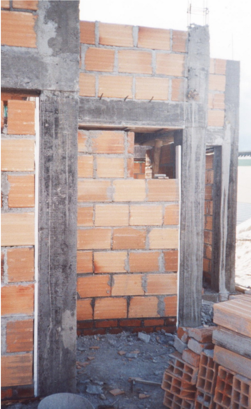
Figura 132. Anclaje de muros y sello para dilatación de muros
