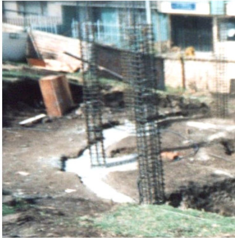
Figura 107. Armado de vigas de cimentación.
