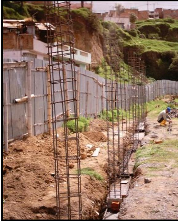
**Figura 65. Detalle columnetas**
