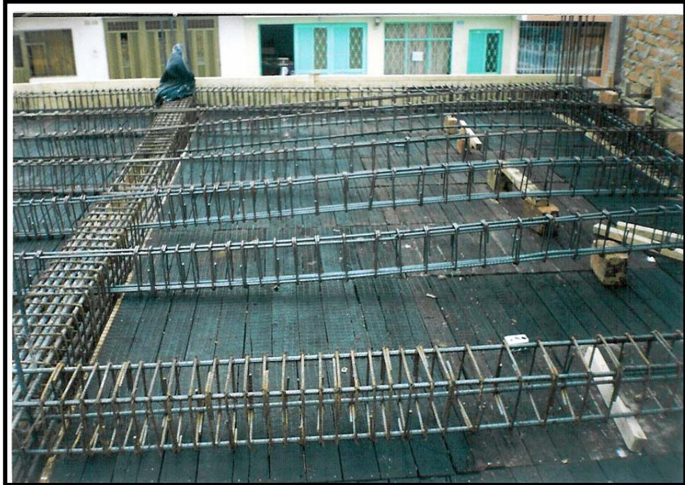
**Figura 30. Colocación de casetones**
