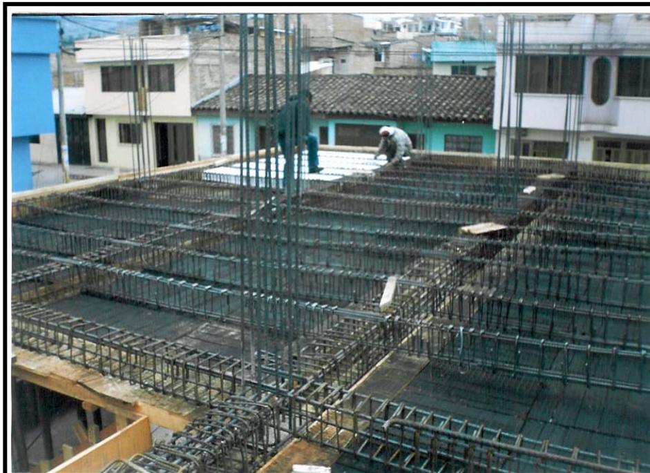
**Figura 29. Detalle del refuerzo de nervios y vigas**
