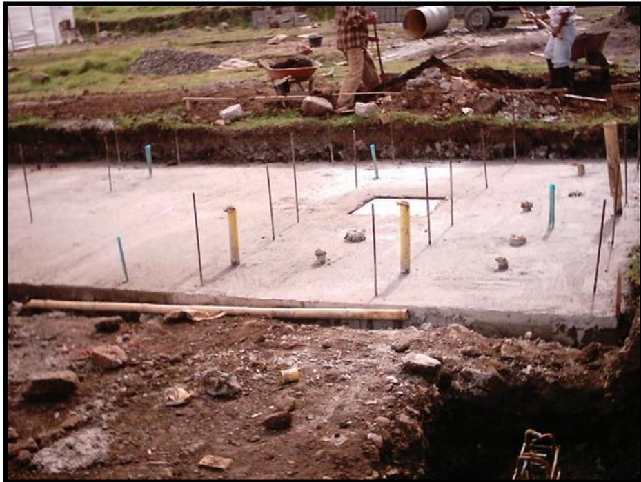
**Figura 90** Columnas de la serviteca
