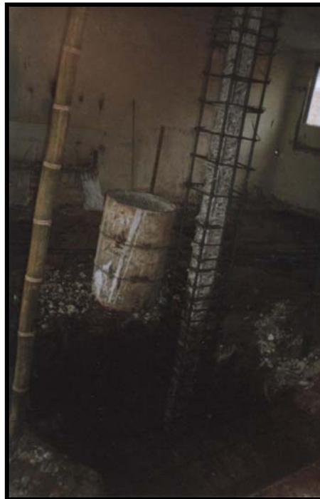
**Figura 25. Refuerzo de la cimentación de la columna central**
