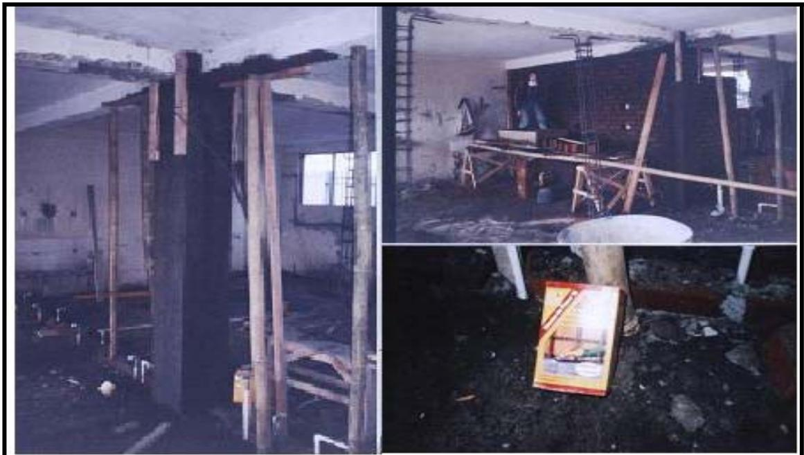
**Figura 27.** Fundición de placa de piso y columnas
