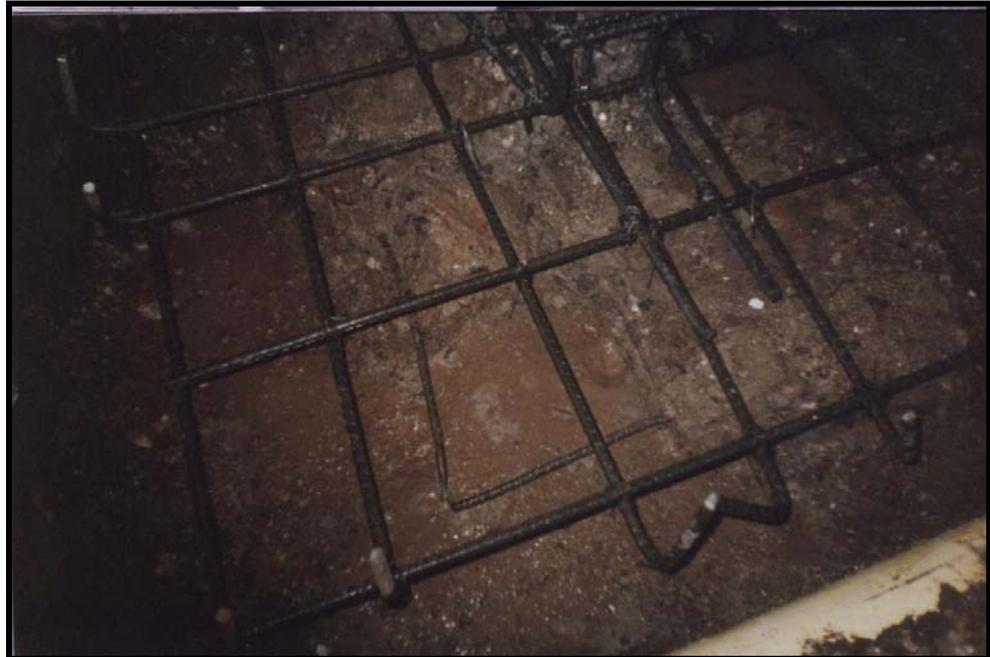
**Figura 26.** Reforzamiento de la estructura en la unidad sanitaria, recalce de la columna central aplicando anclaje epoxico, elaboración vigas de piso y columnetas de confinamiento para muros
