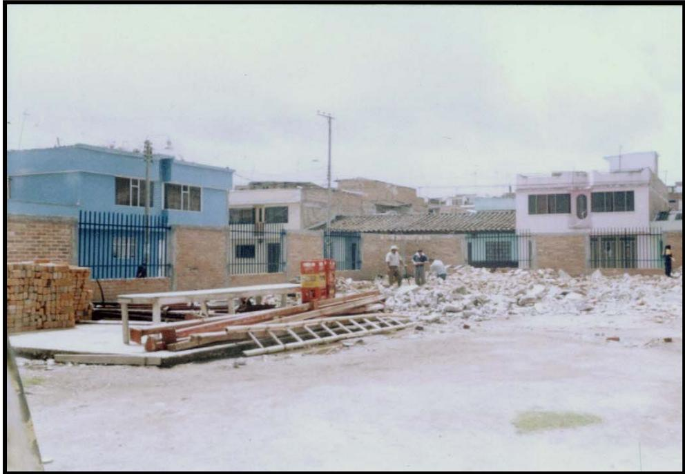
**Figura 10.** Unidad sanitaria una vez demolidos los muros, se puede apreciar la excesiva esbeltez de la columna central
