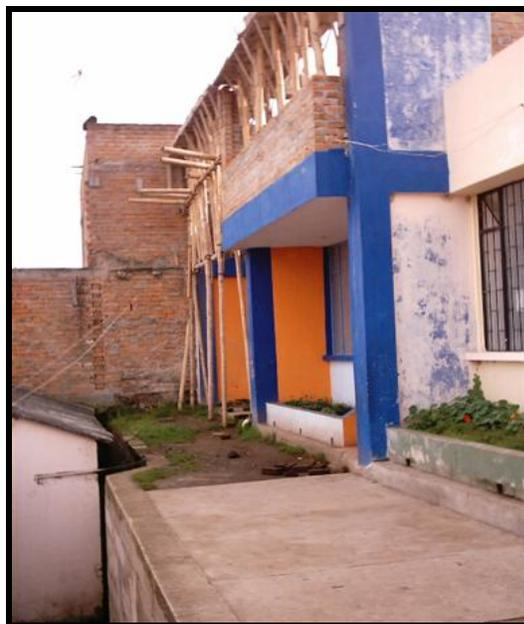
**Figura 110. Viga canal sin apoyo en el centro de la luz**
