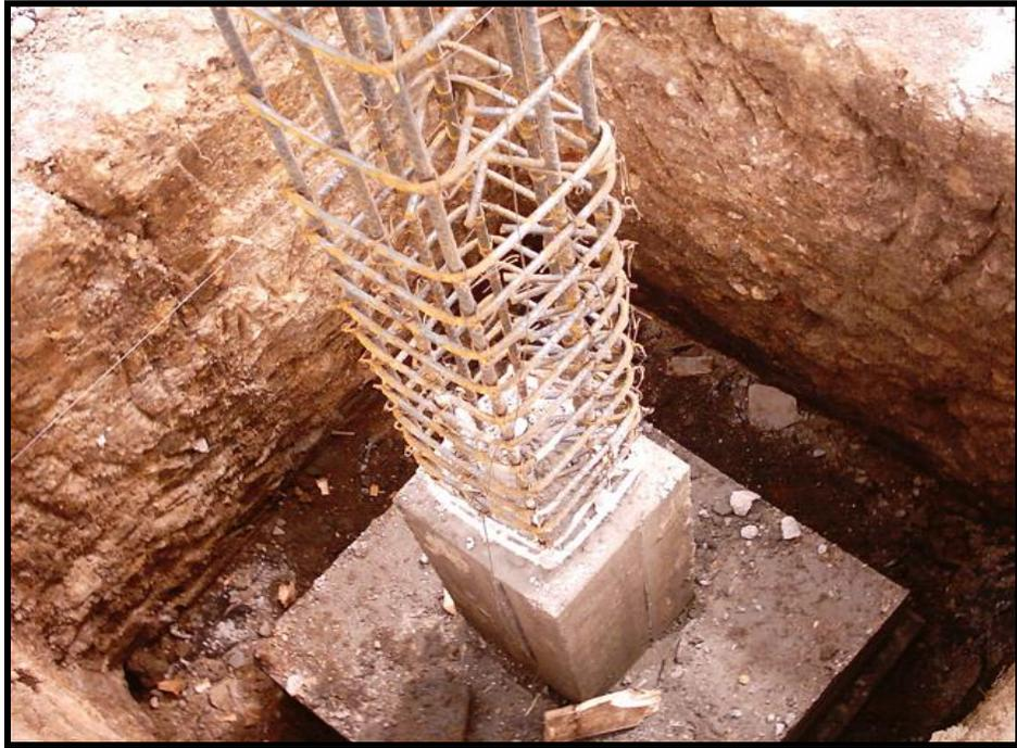
**Figura 61. Castillos de columnas**
