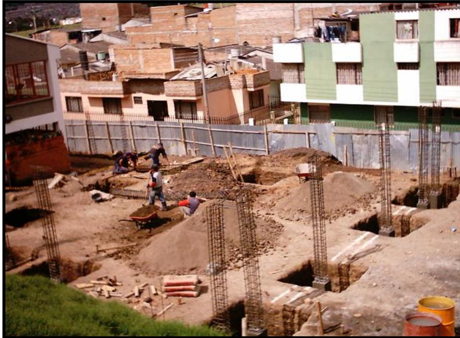
**Figura 63. Cimentación del muro de cierre**
