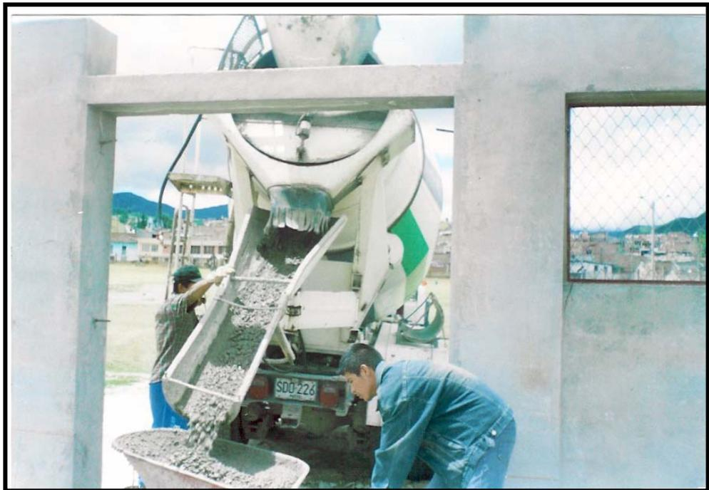
**Figura 71. Vaciado y fundición del pavimento, elaboración de juntas**
