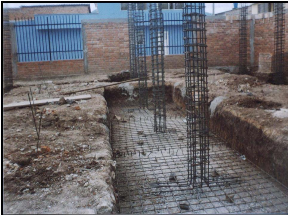
**Figura 21. Fundición de vigas de cimentación**
