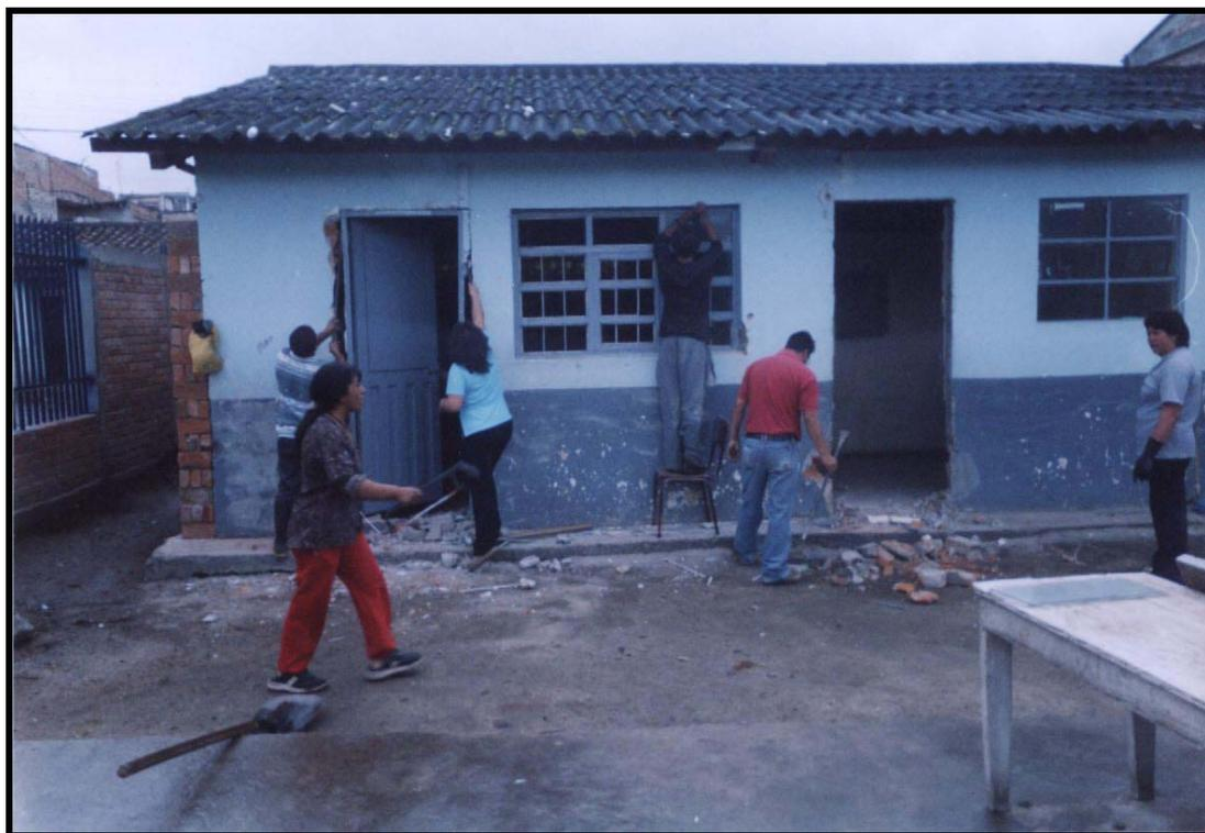
**Figura 7. Desmonte de cubierta, puertas y ventanas**
