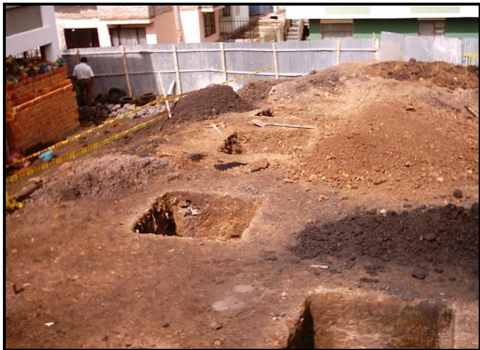
**Figura 52. Presencia de nivel freático**
