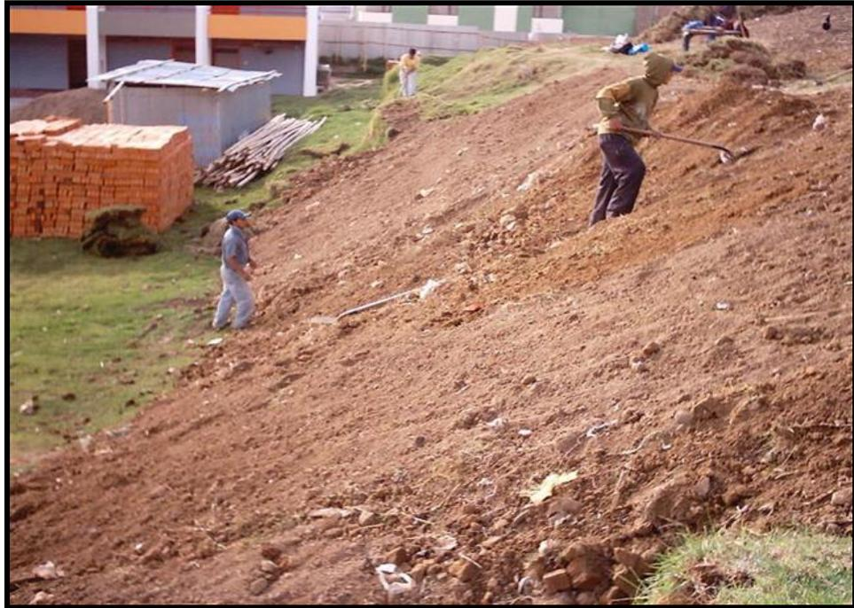
**Figura 51.** Excavación de las trincheras para cimentación
