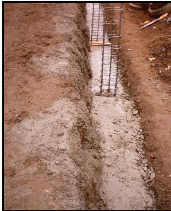
**Figura 64. Armado de columnetas**
