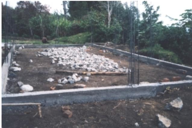
**Figura 14. Hormigoneras en vigas, producto de una mala fundición**
