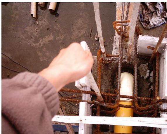
**Figura 115. Insuficiente refuerzo longitudinal en la columna, excesiva separación entre estribos en el refuerzo a cortante**
