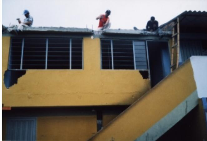
**Figura 45. Demolición escaleras antiguas**
