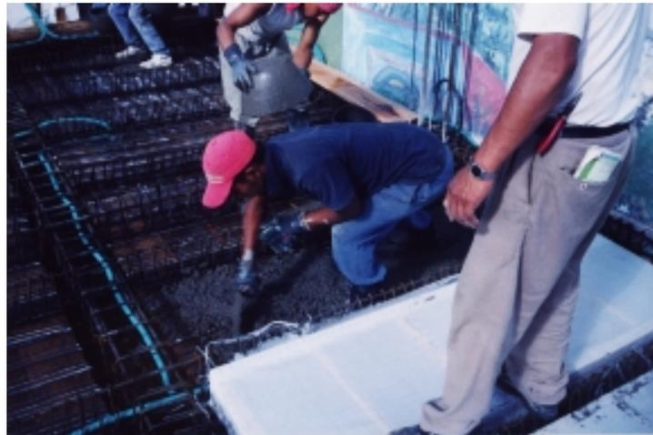
**Figura 52. Colación de refuerzo de retracción por temperatura (1/4")**
