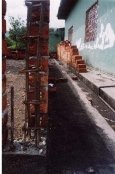
**Figura 17. Excavación de Zapatas y armado de pedestales**
