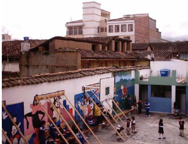
**Figura 39. Muro en Tapia, vista longitudinal**
