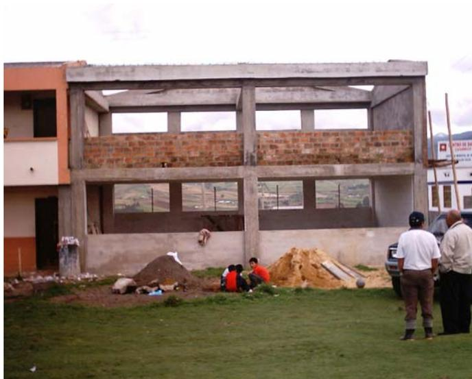
**Figura 68. Armado de vigas y tímpanos**
