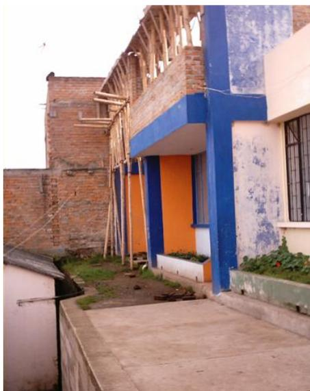
**Figura 113. Viga canal sin apoyo en el centro de la luz**
