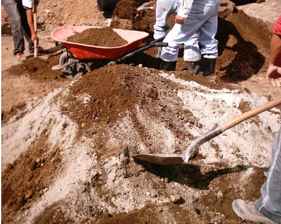
Figura 58. Mezcla de recebo 94% – cemento 6%
