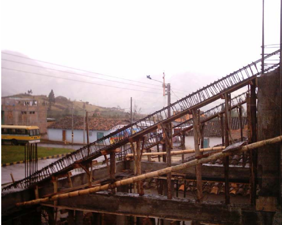
Figura 119. Refuerzo vigas inclinadas de cubierta
