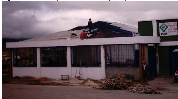
Figura 73. Trabajos en cubierta y carpintería metánica
