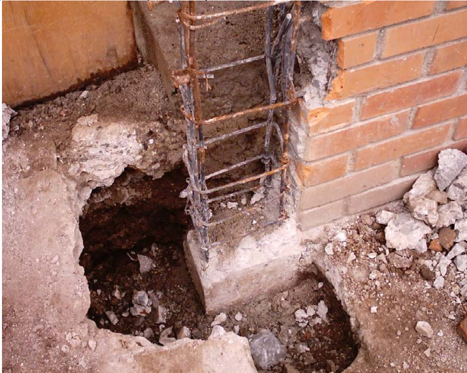
Figura 105. Demolición para emplazamiento de columnas muro de cierre
