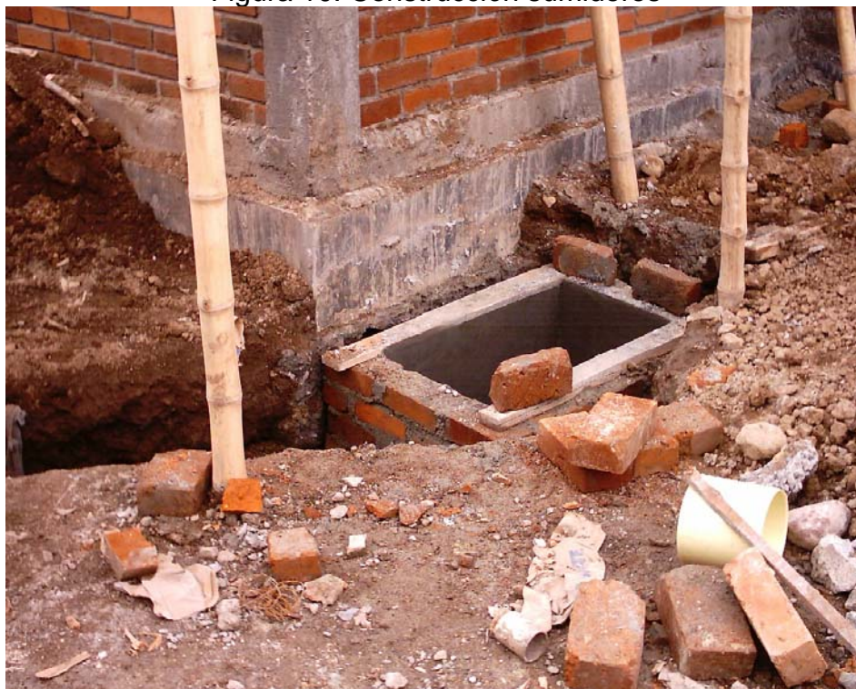
Figura 10. Construcción sumideros
