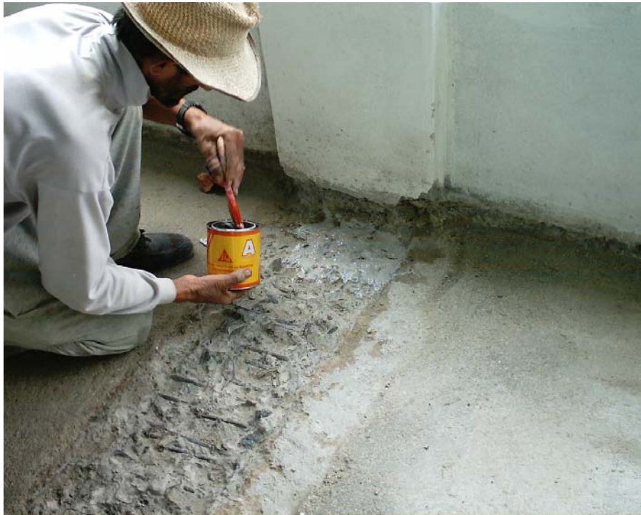
Figura 128. Corrección en la demolición
