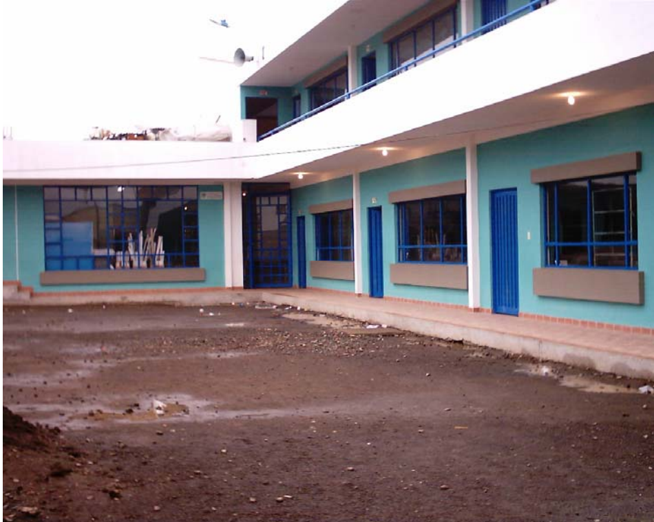
Figura 104. Bloque de aulas construido
