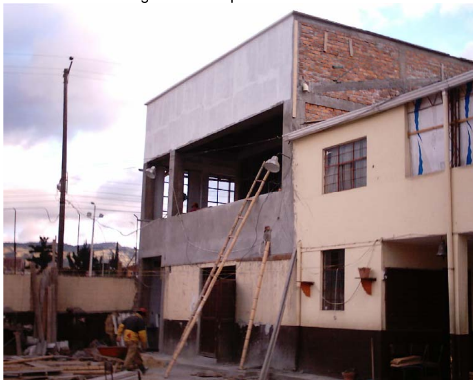
Figura 146. Repellos terminados
