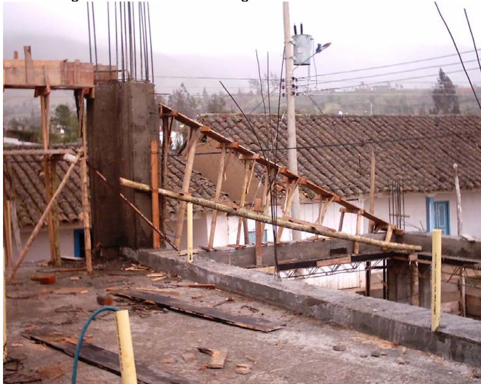
Figura 118. Formaletas vigas inclinadas de cubierta
