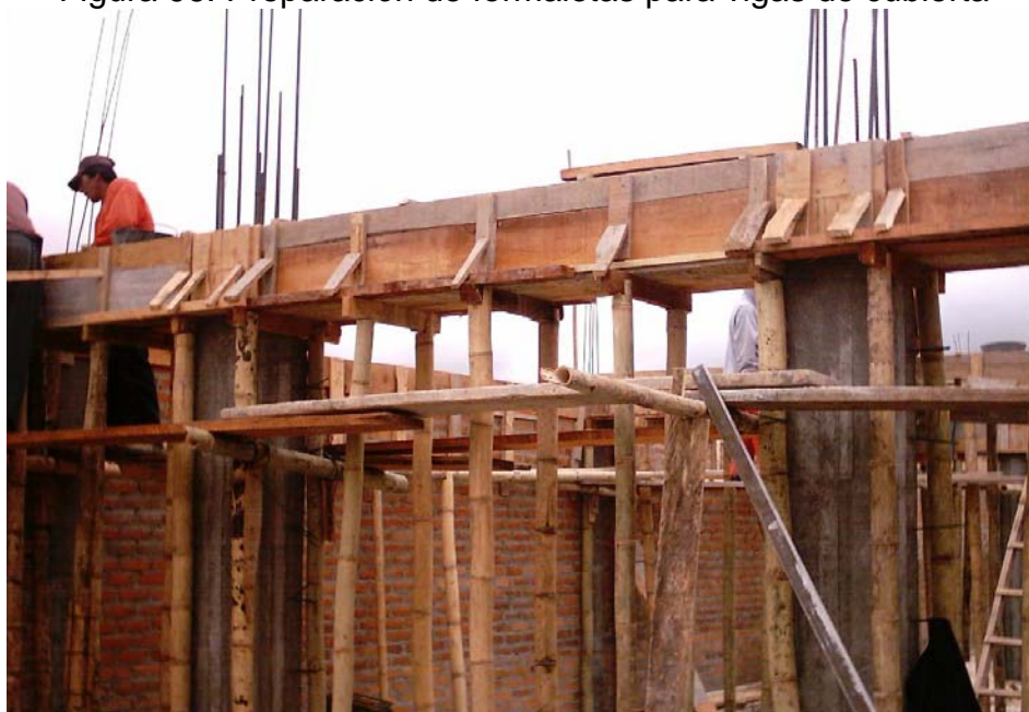
Figura 97. Armado de vigas de cubierta
