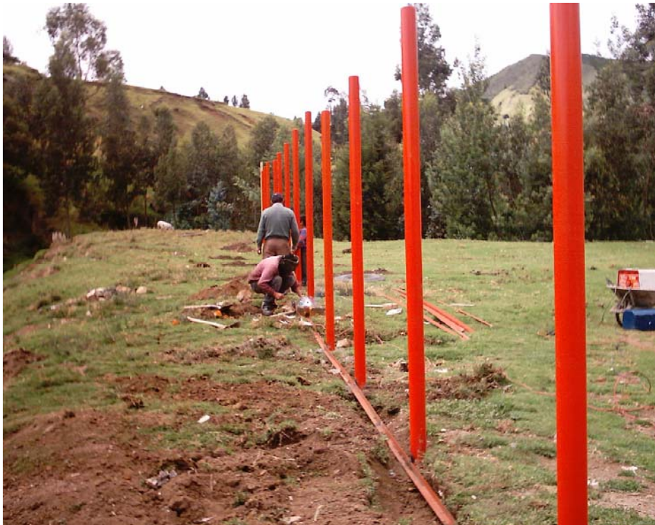
Figura 80. Construcción cerramiento en malla
