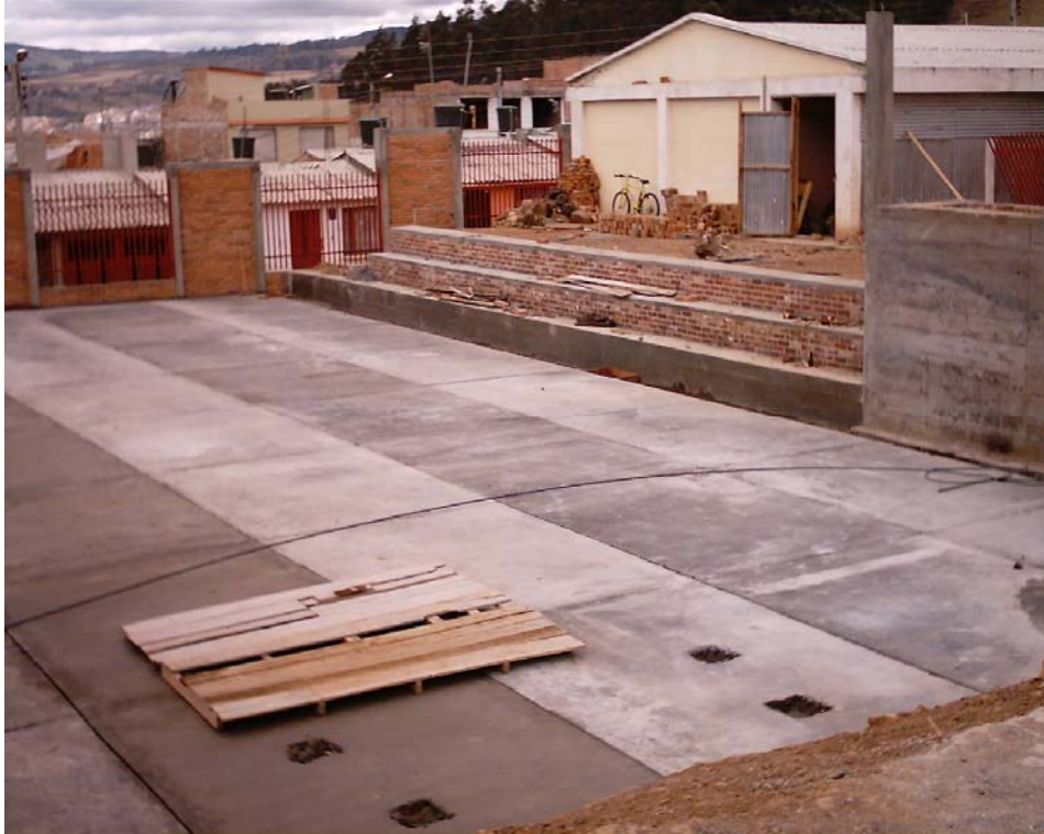
Figura 25. Pavimento y graderías terminadas
