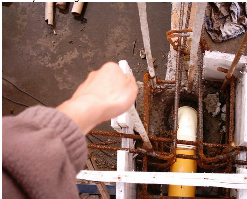
Figura 210. Bajante de aguas lluvias incrustado en el centro de la columna
