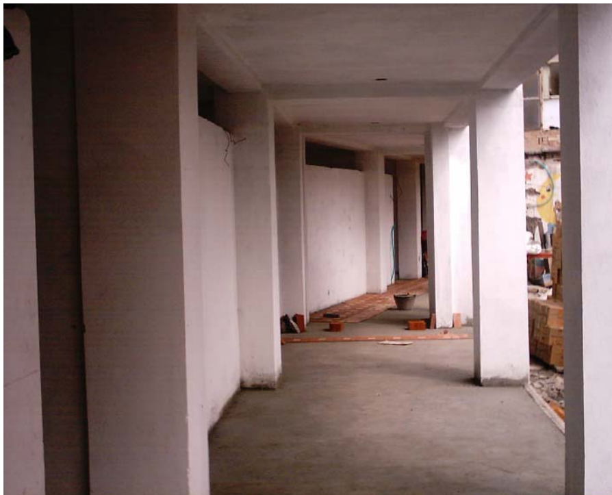
Figura 132. Instalación piso en tableta de gress pasillos
