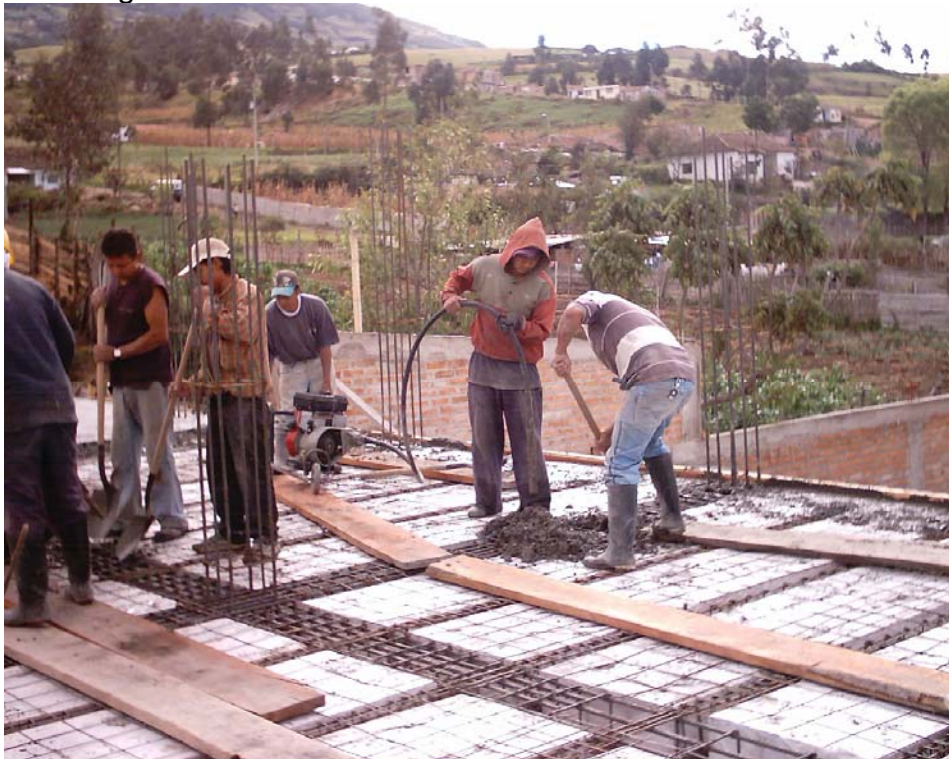
Figura 95. Vibrado mecánico de la mezcla de concreto
