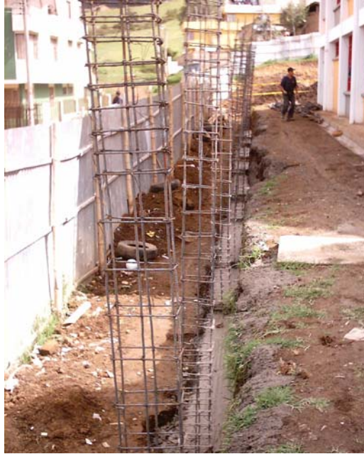
Figura 48. Castillos de columnas muro de cierre
