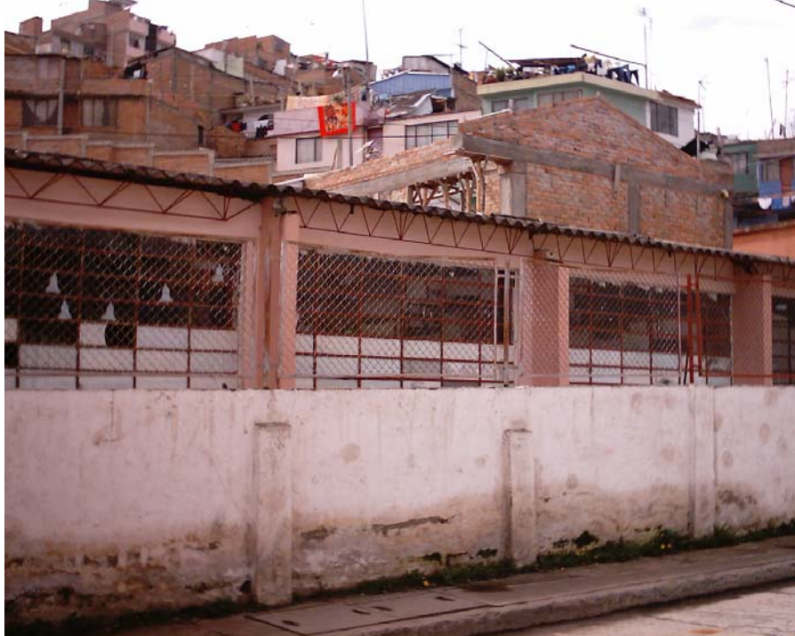
Figura 153. Muro en ladrillo h=1.5m y cierre en malla h=1.1m
