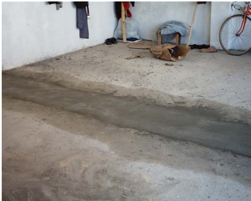
Figura 129. Peralte recuperado en la viga de cimentación
