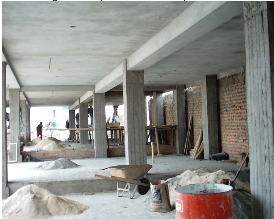
Figura 99. Repellos de estructura primer nivel
