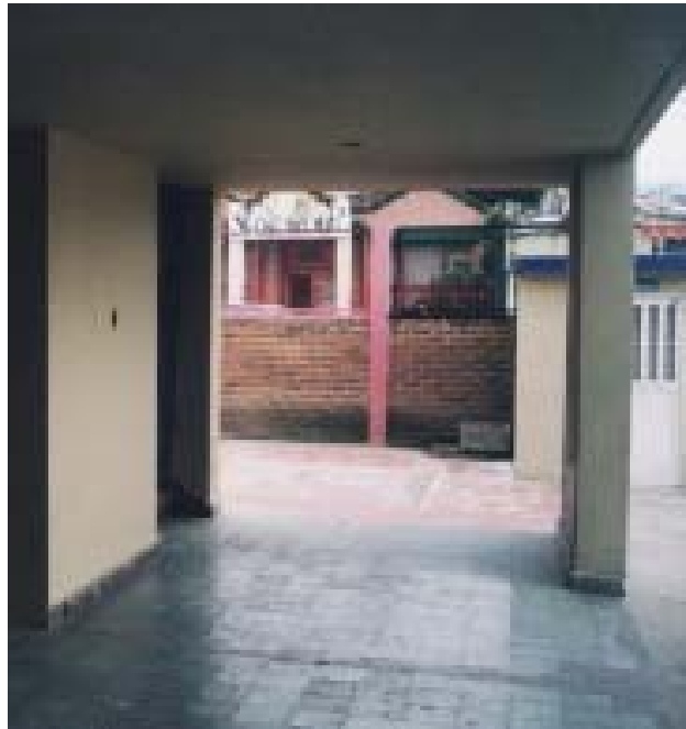
Figura 199. Accesos al bloque en riesgo
