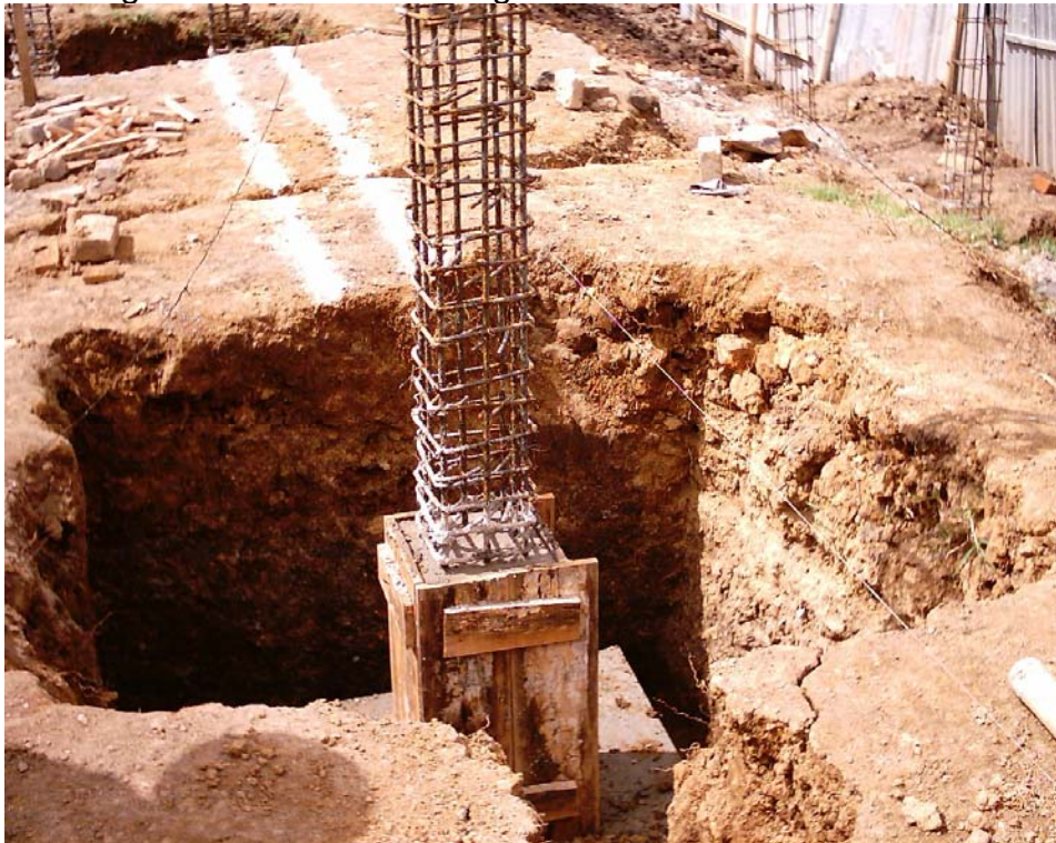
Figura 65. Localización viga de cimentación restaurante
