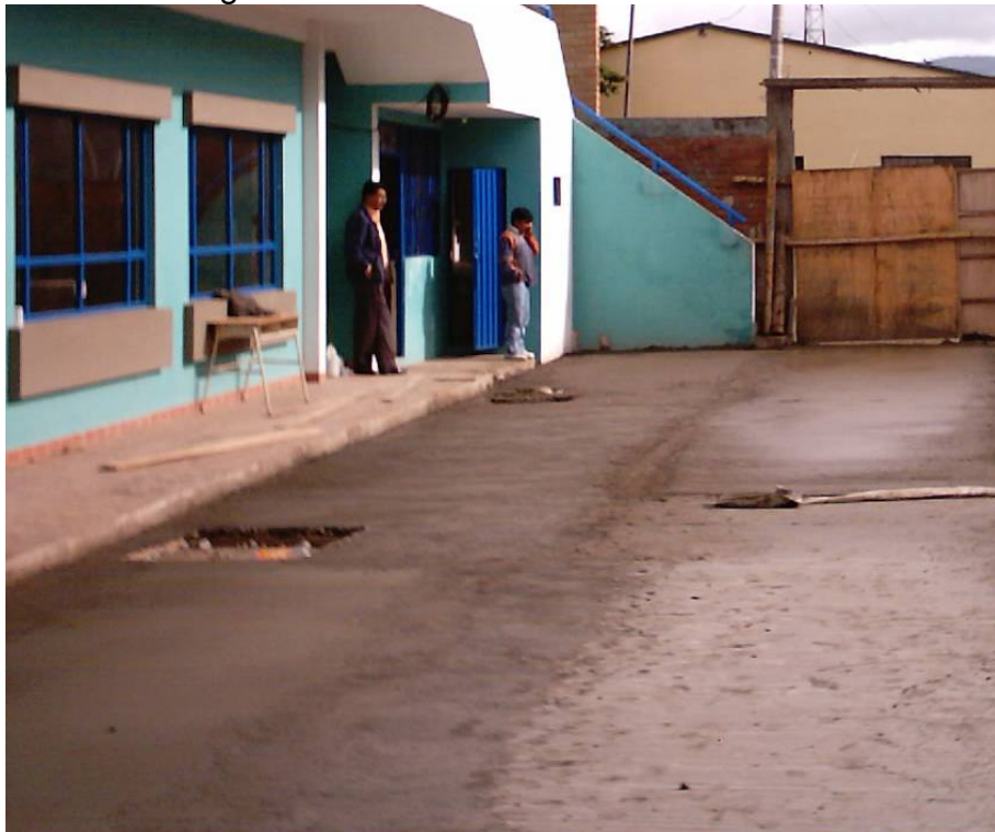
Figura 109. Fundición de losa terminada
