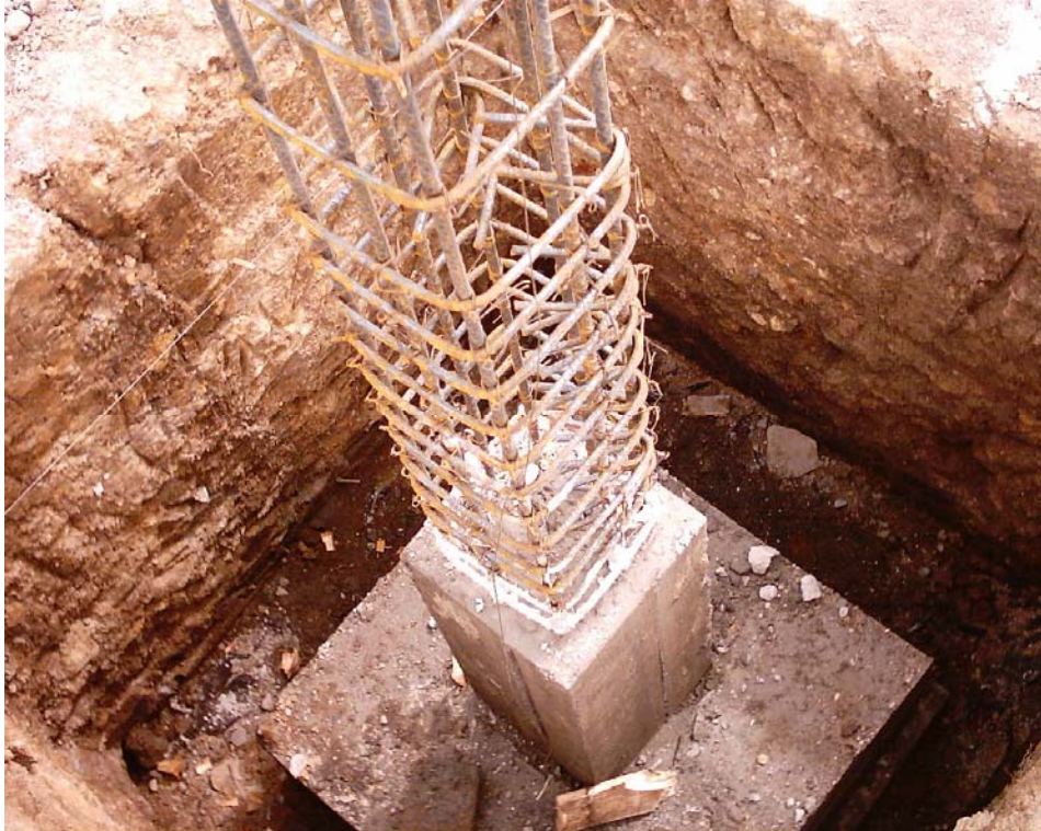
Figura 64. Zapata fundida y castillo de columna
