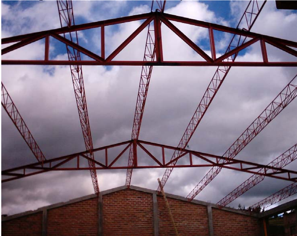
Figura 30. Instalación de cerchas y correas terminada
