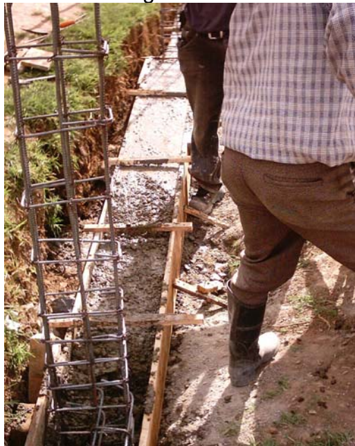
Figura 47. Fundición de vigas de cimentación muro de cierre
