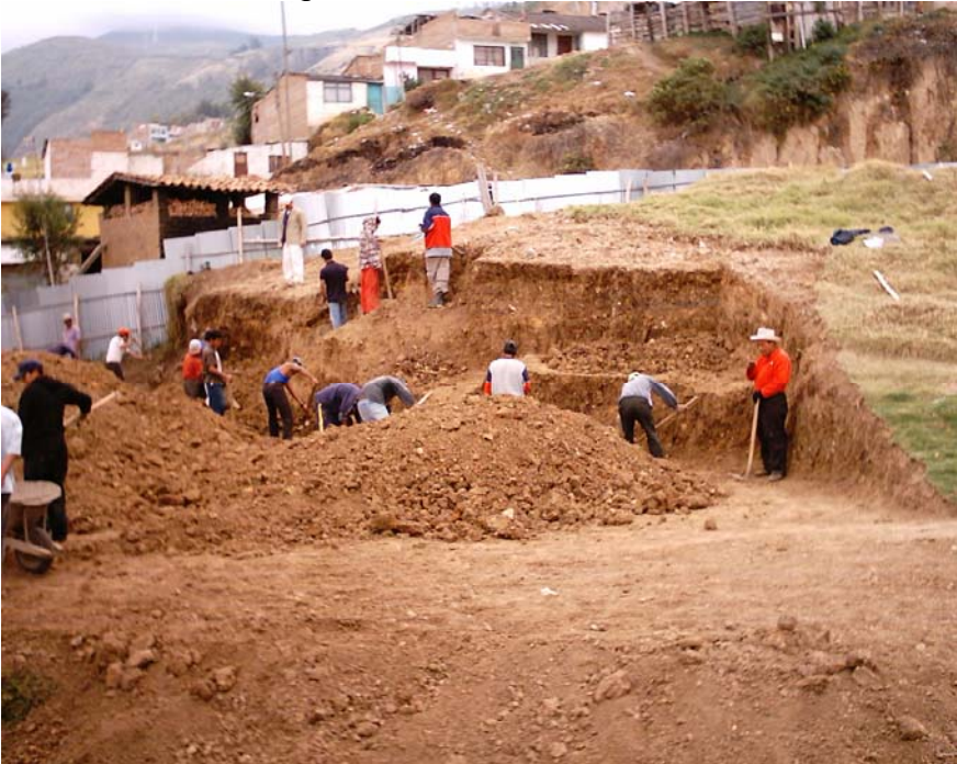
Figura 51. Corte de terreno
