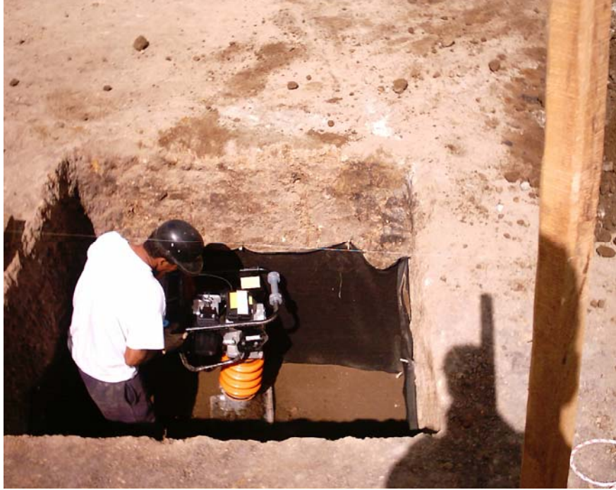
Figura 60. Compactación por capas con rana del suelo mejorado
