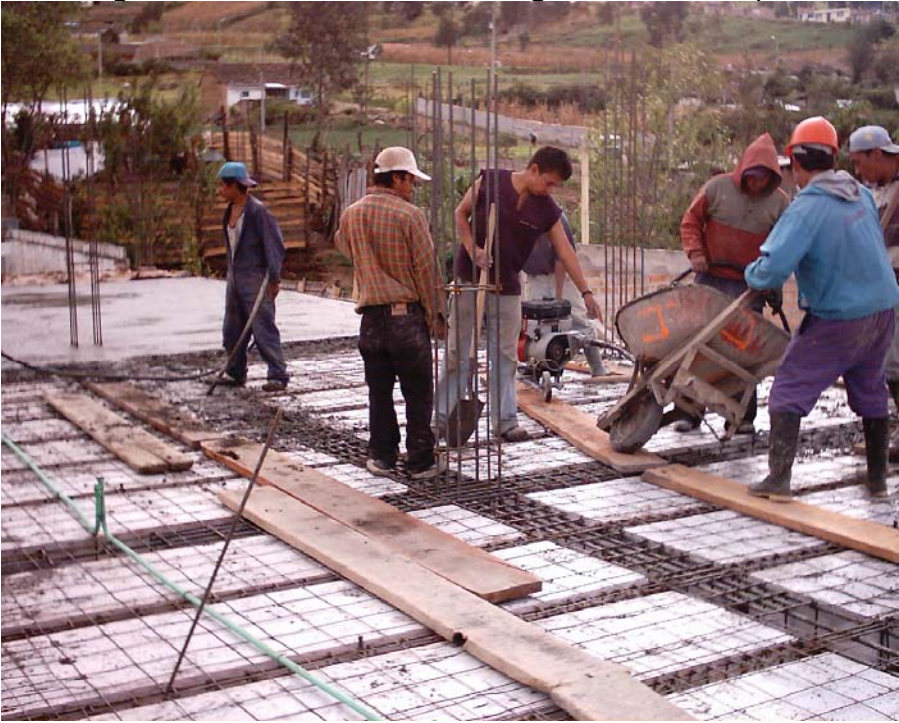
Figura 93. Fundición de losa aligerada de entrepiso
