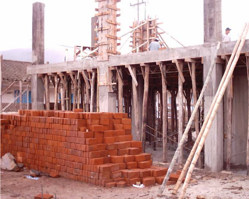
Figura 115. Fundición de columnas segundo nivel
