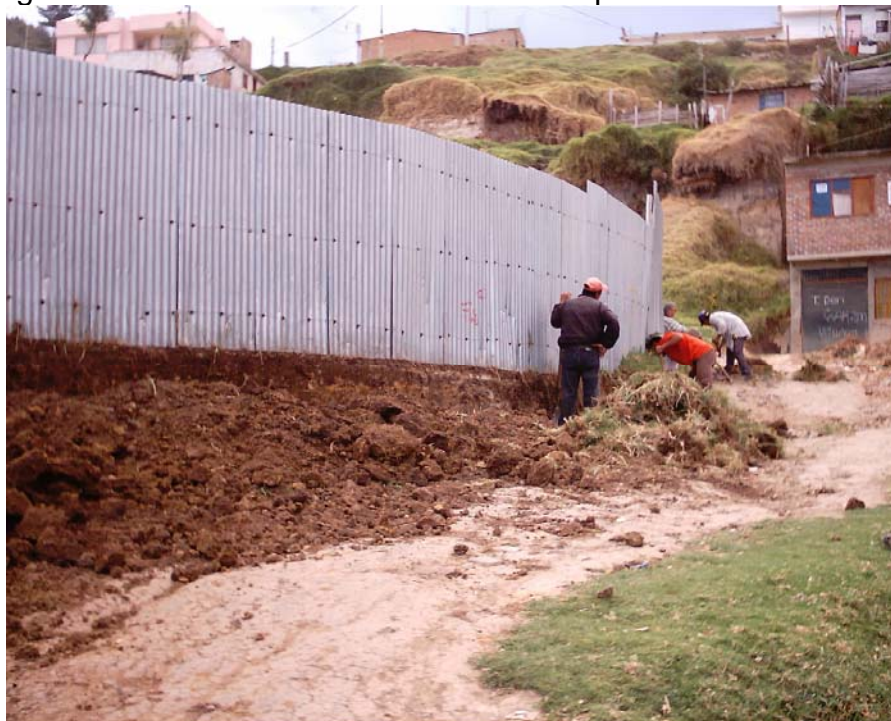
Figura 39. Nivelación de terreno en la vía que circunda la escuela
