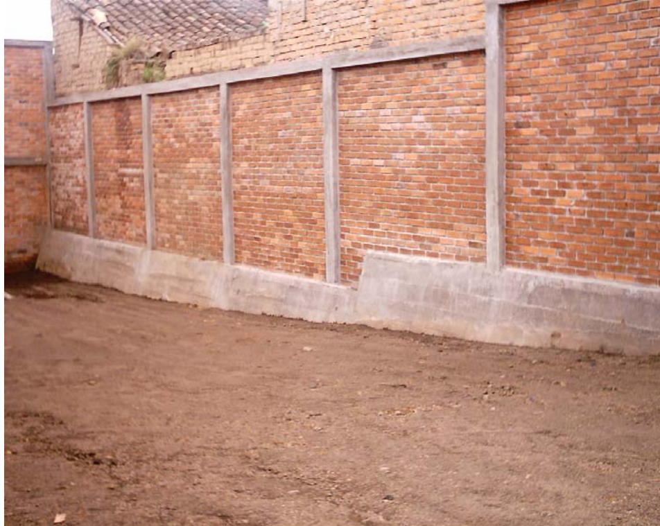
Figura 11. Zona muro de contención terminada
