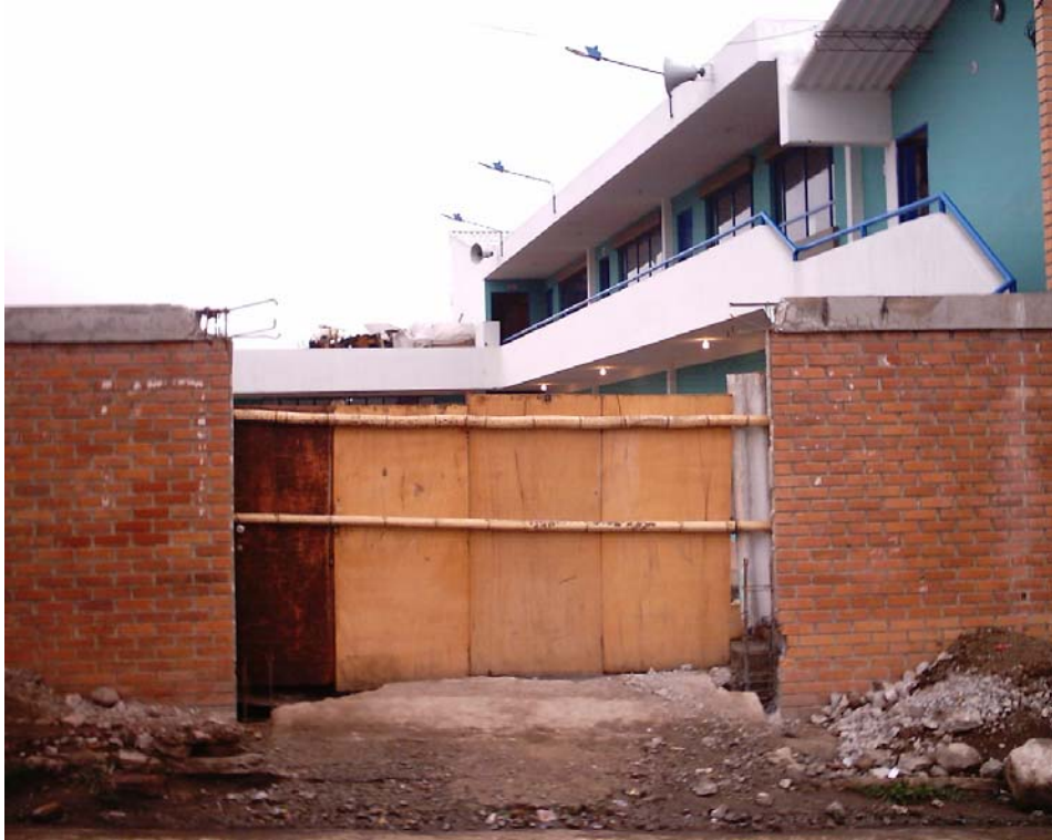
Figura 106. Zona de construcción acceso
