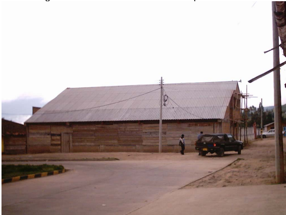
Figura 122. Fachada externa del bloque construido
