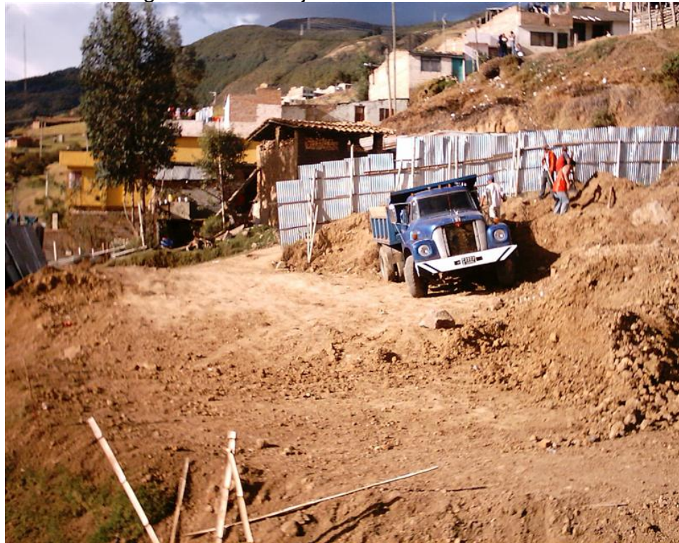
Figura 53. Desalojo de sobrantes nivelación
