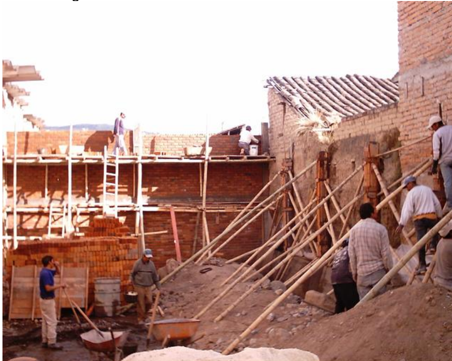
Figura 8. Terminación muro de cierre lindero sur
