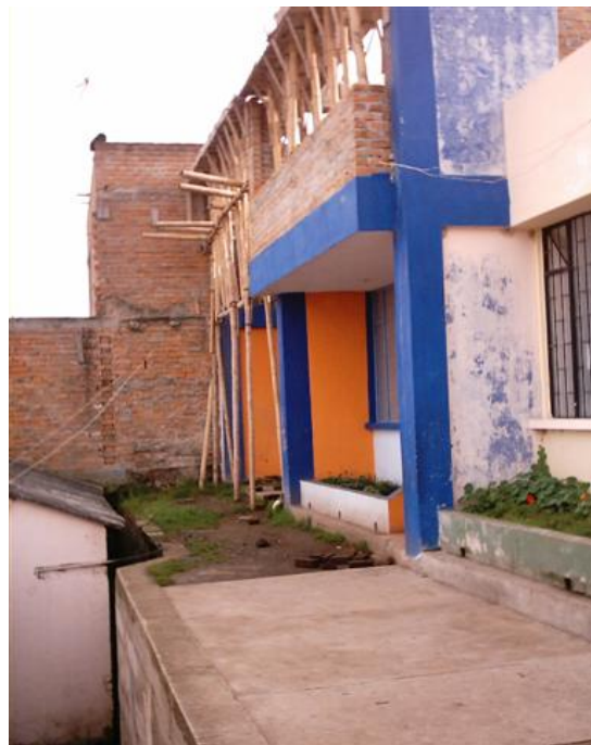
Figura 208. Zona en construcción
