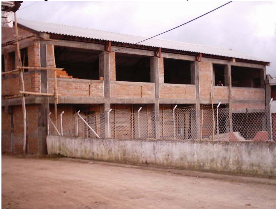
Figura 121. Fachada interna del bloque construido
