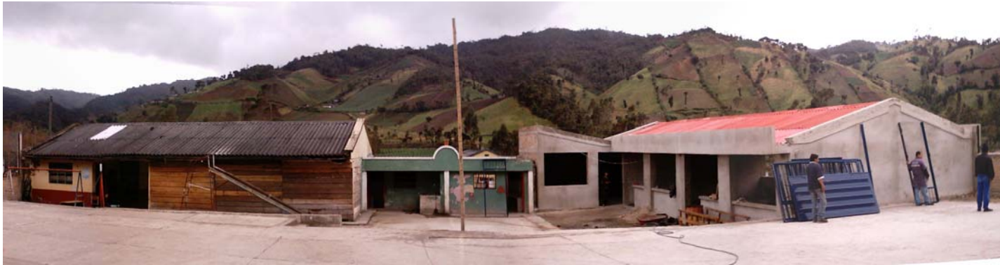
Figura 85. Vista de la obra en la Escuela Rural Mixta San Gabriel
