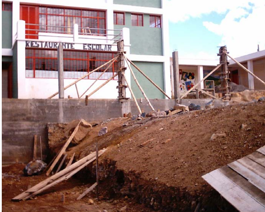
Figura 15. Construcción de columnas muro de protección
