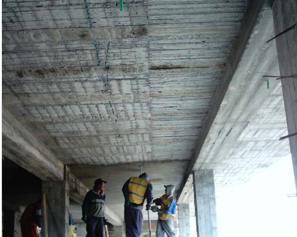
Figura 98. Repello inferior de losa de entpiso
