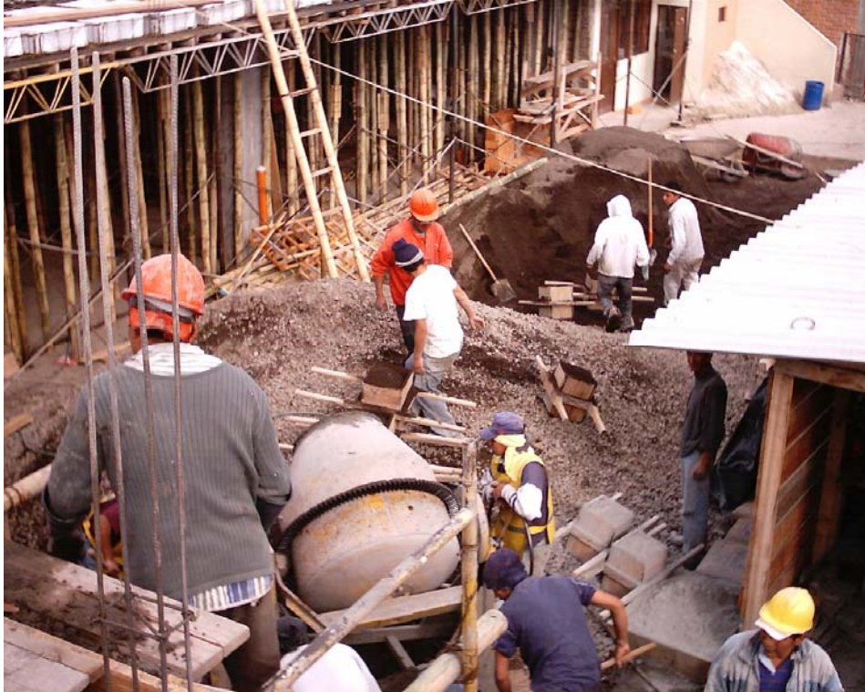
Figura 94. Preparación mezcla de concreto
