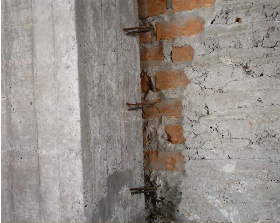
Figura 100. Anclaje de muros a estructura
