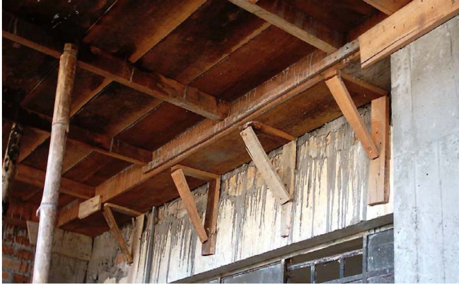
Figura 144. Formaleta viga y losa maciza
