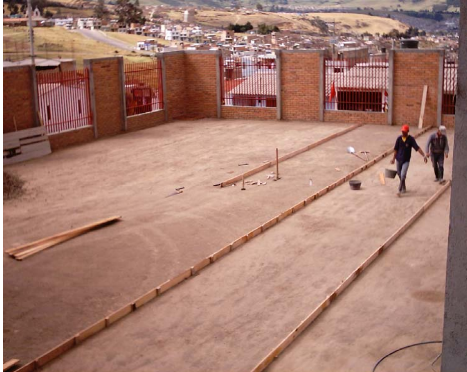
Figura 19. Carriles de fundición y capa compactada
