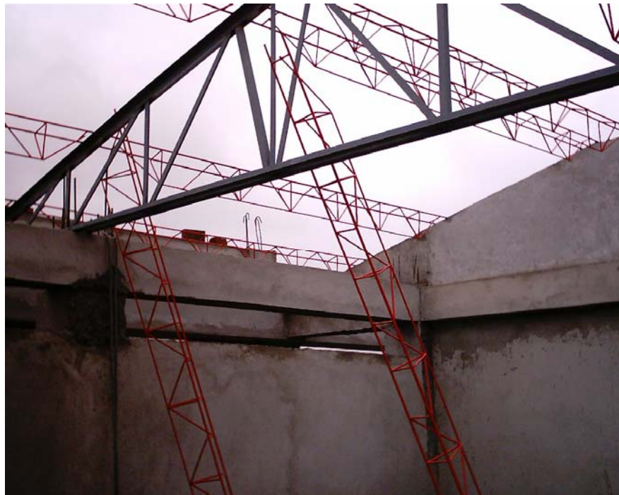
Figura 131. Instalación cerchas y correas para cubierta
