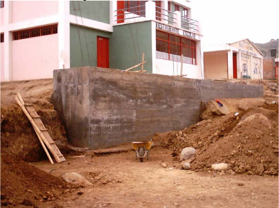
Figura 14. Muro de contención
