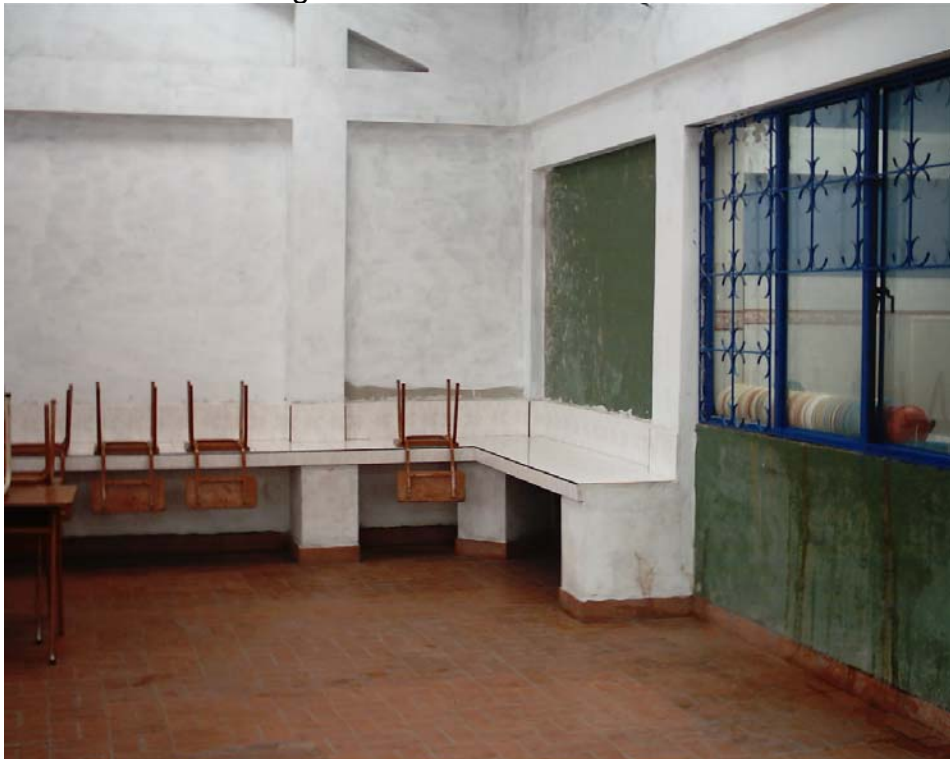
Figura 76. Mesón en concreto
