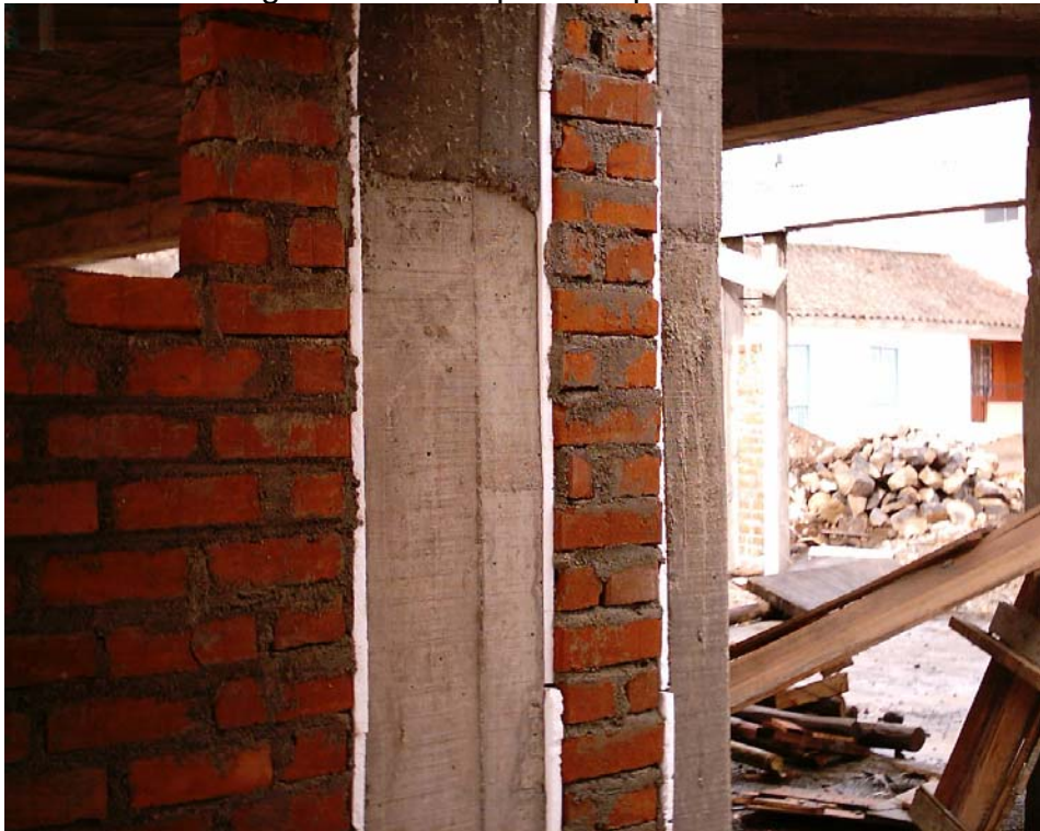
Figura 120. Mampostería primer nivel
