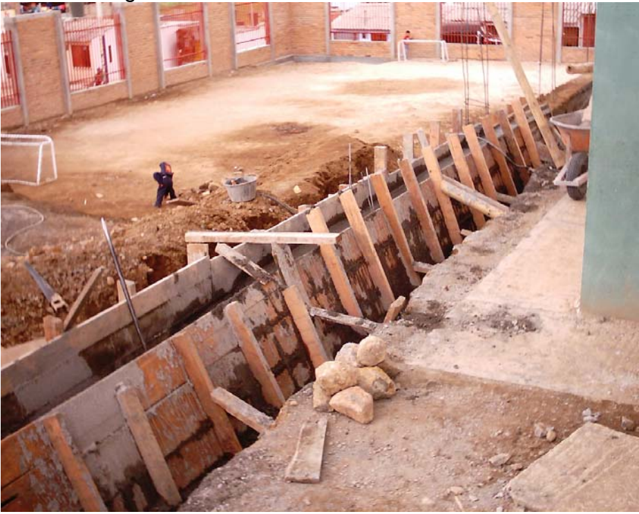
Figura 13. Terminación muro de contención
