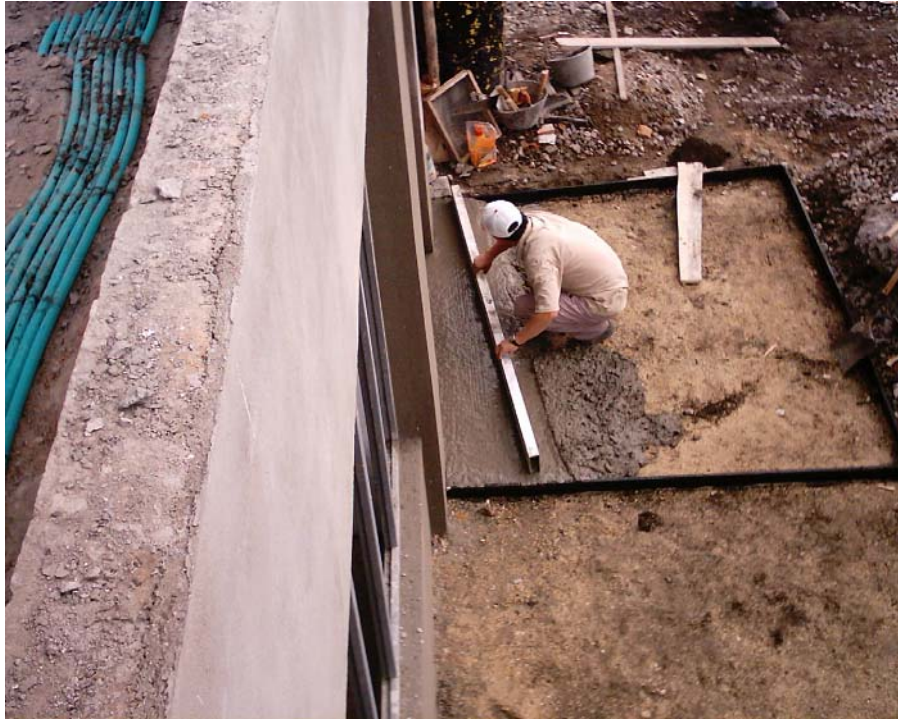
Figura 130. Construcción andenes fachada de la escuela
