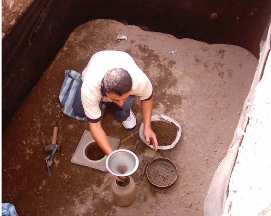
Figura 61. Ensayo de densidad con cono y arena zapata 5b
