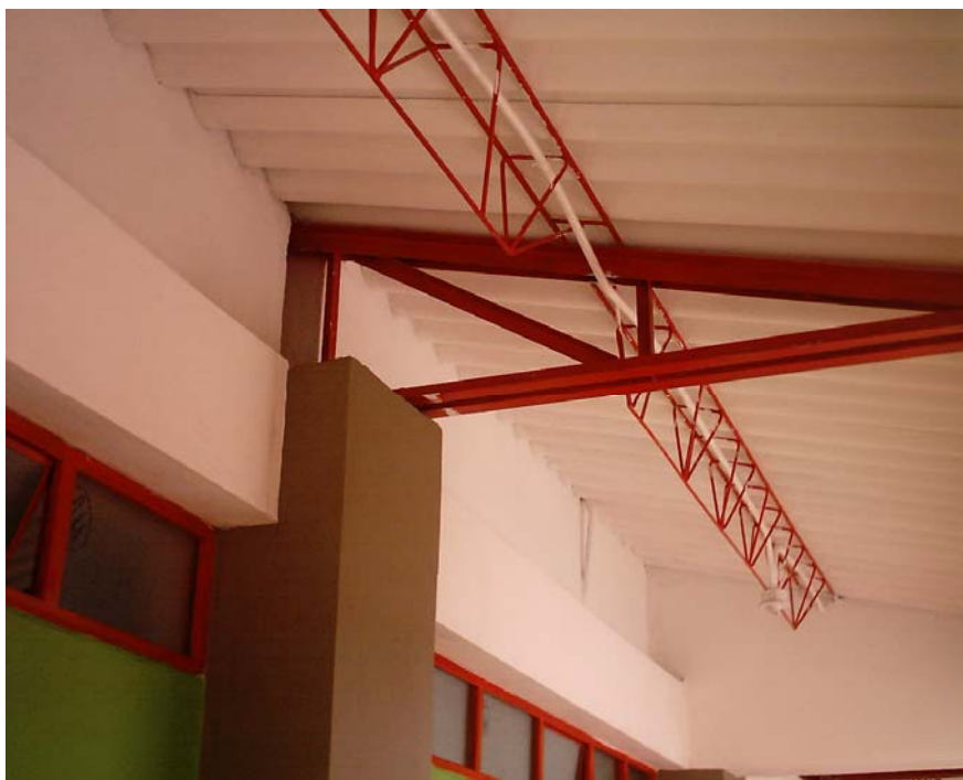
Figura 134. Detalle cubierta terminada
