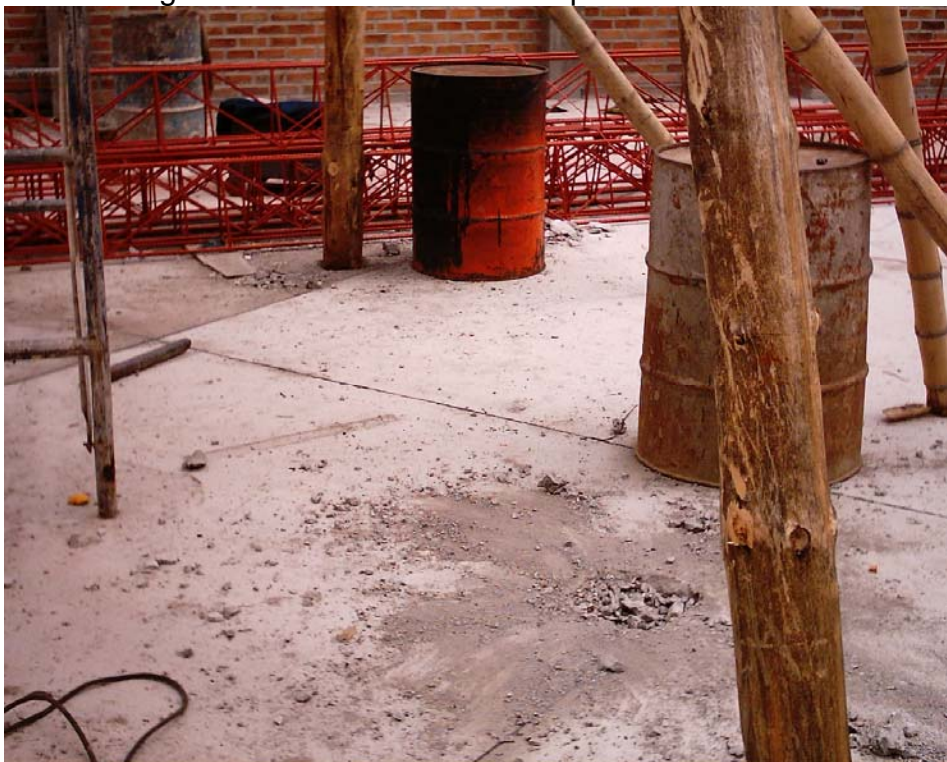
Figura 32. Perforaciones en la placa de concreto
