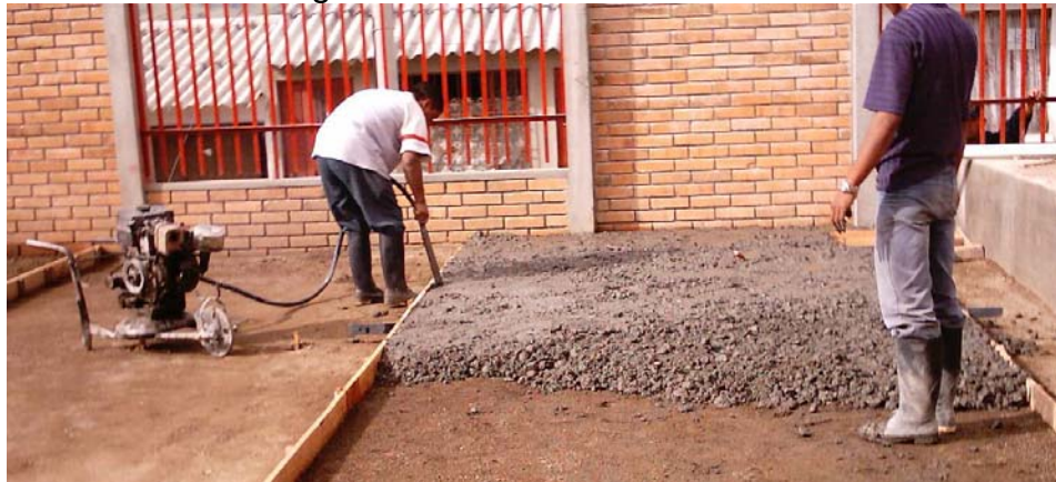
Figura 20. Vibrado de la mezcla
