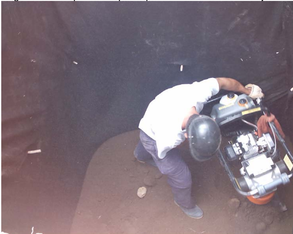
Figura 59. Compactación por capas con rana del suelo mejorado
