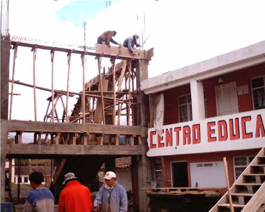
Figura 116. Armado de vigas de cubierta
