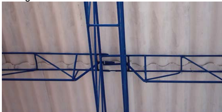
Figura 74. Estructura metánica de la cubierta
