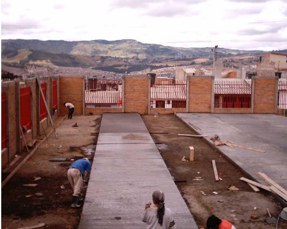
Figura 23. Fundición por carriles
