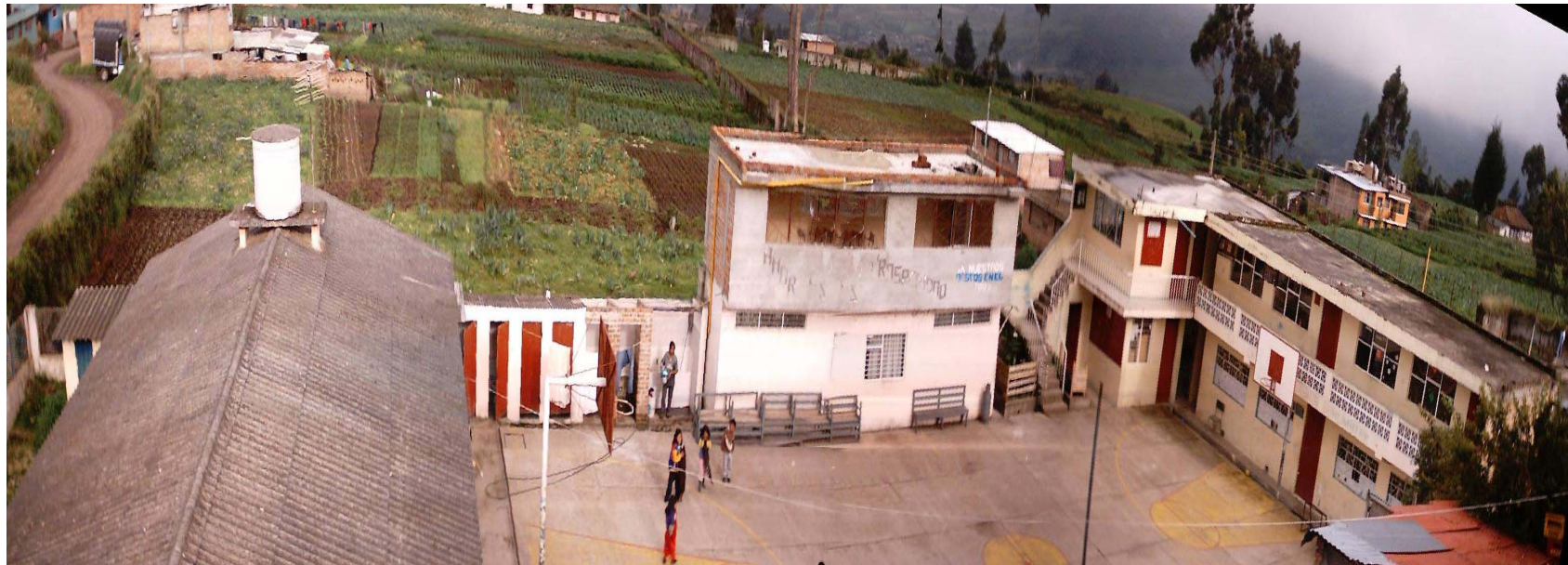
Figura 206. Instalaciones antiguas de la escuela, aulas y unidad sanitaria
