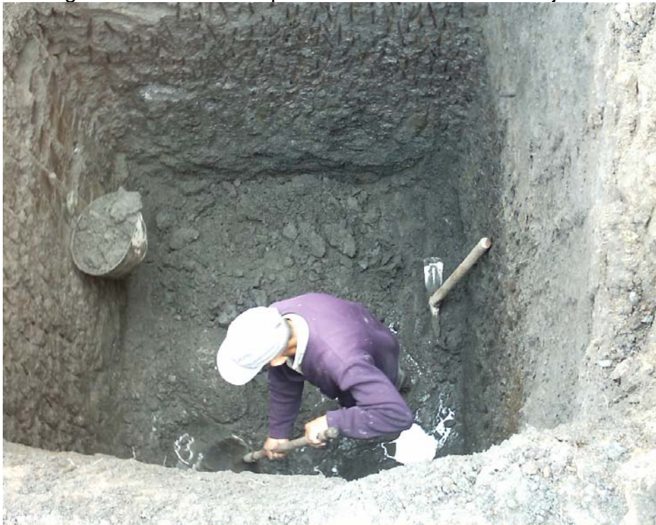
Figura 55. Excavación para cimientos con suelo mejorado
