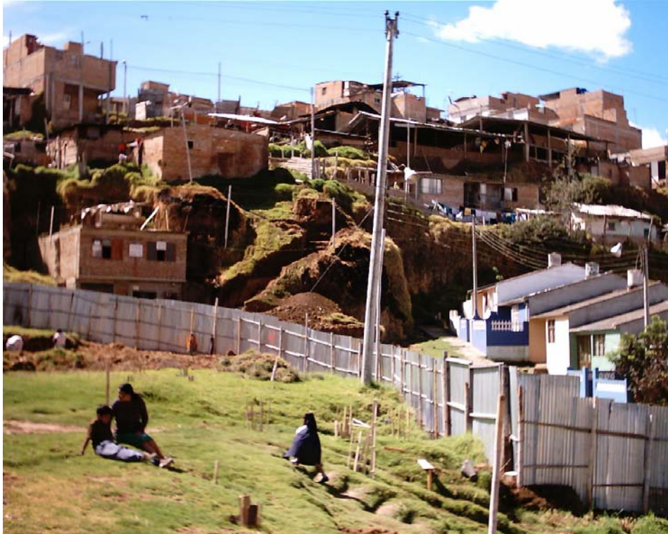
Figura 40. Poste de alta tensión que requiere de su traslado
