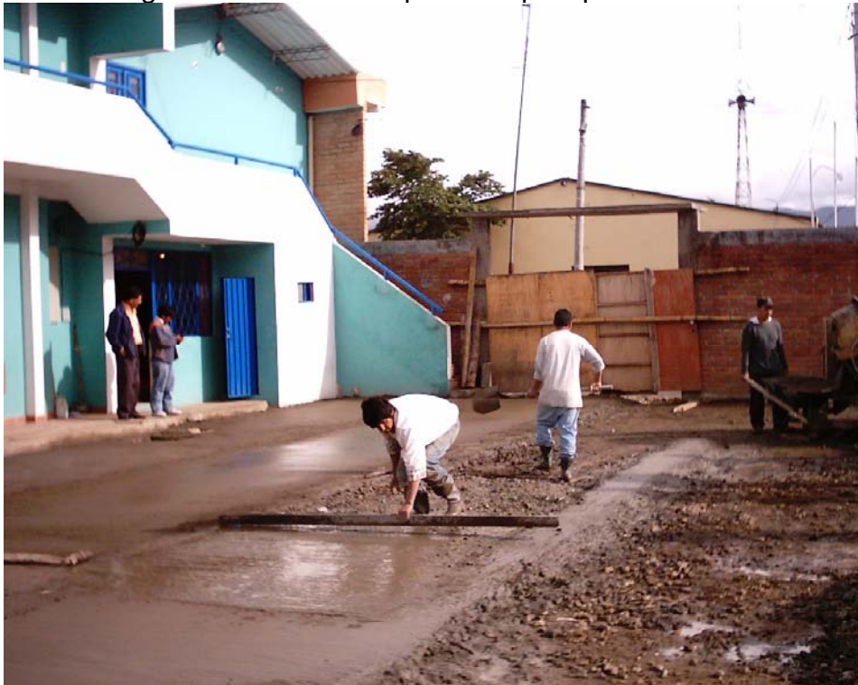
Figura 107. Fundición placa de piso patio escolar
