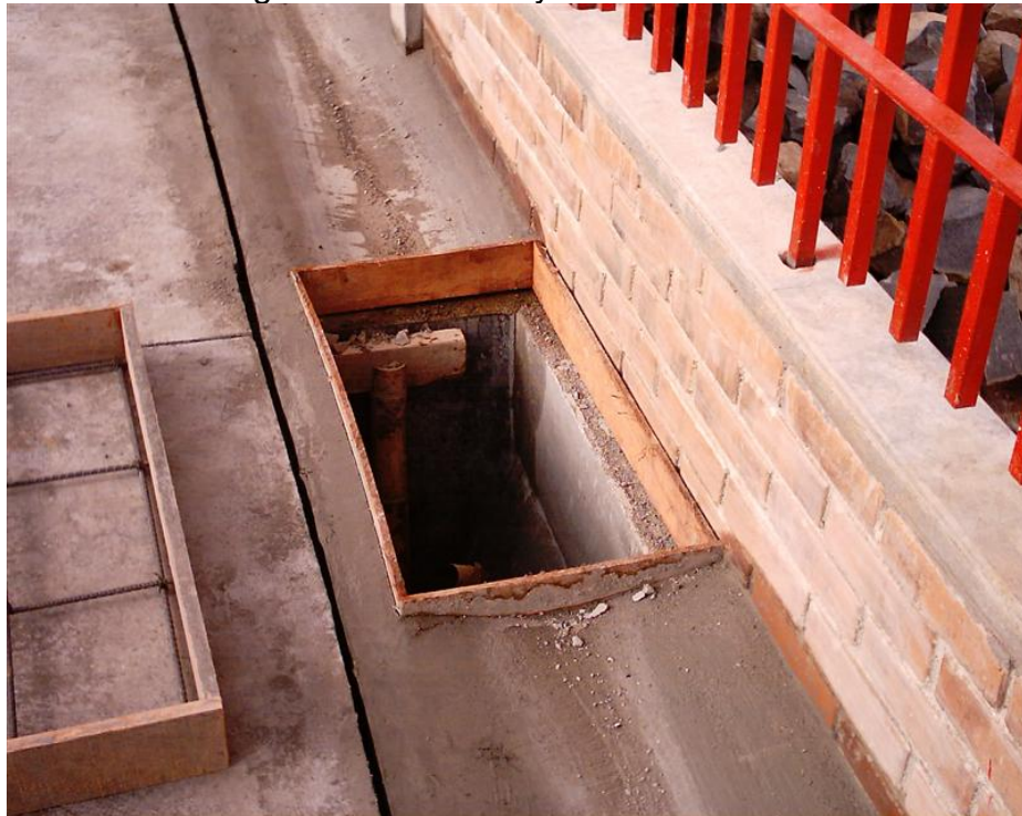
Figura 24. Cunetas y obras sanitarias
