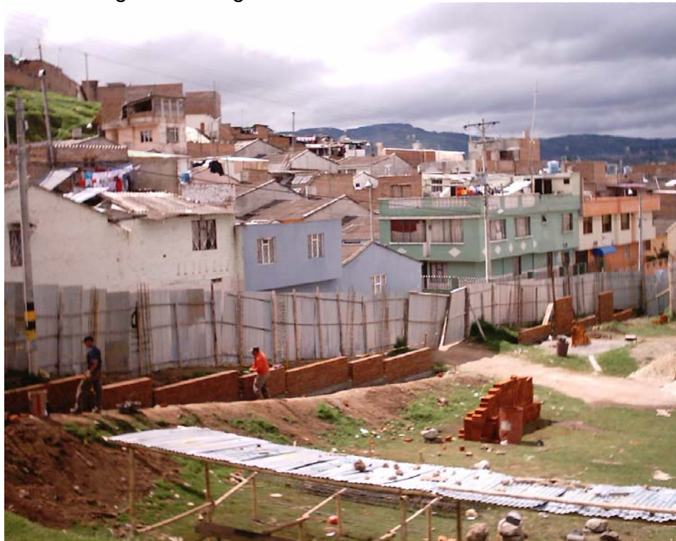
Figura 49. Pega de muro en tizón muro de cierre
