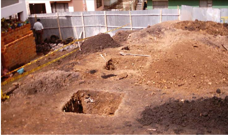
Figura 56. Excavaciones cimientos
