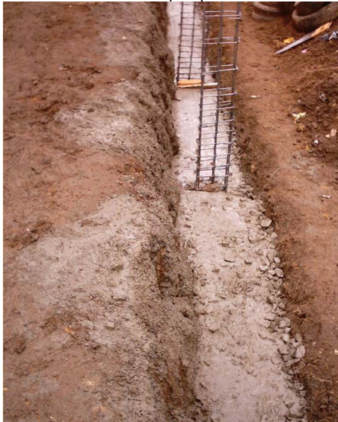
Figura 45. Fundición de ccto ciclópeo para cimientos muro de cierre
