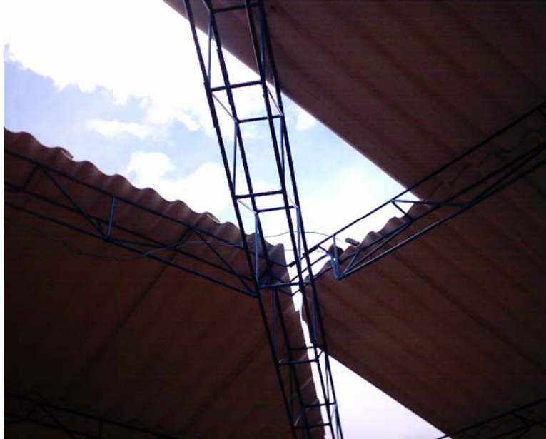
Figura 72. Empalmes cubierta cuatro aguas
