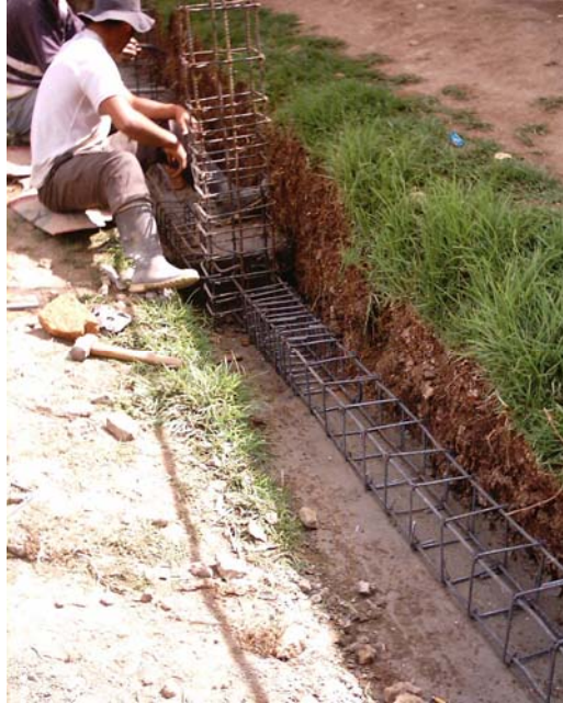
Figura 46. Armado de vigas de cimentación para muro de cierre
