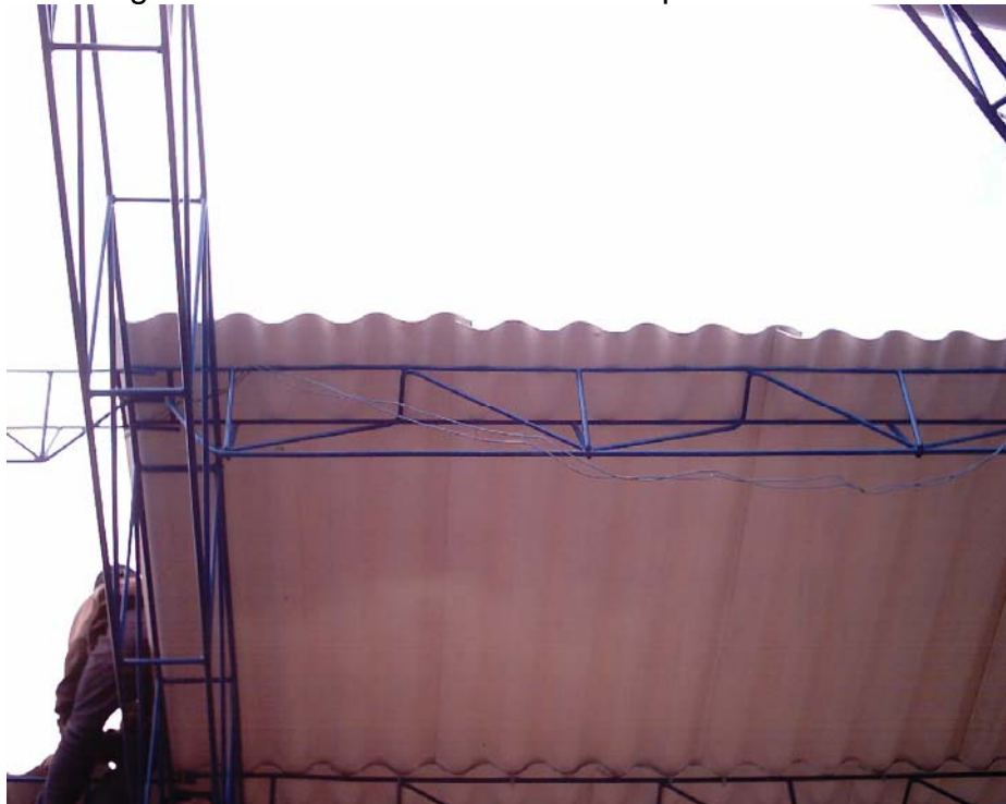
Figura 71. Construcción de cubierta para restaurante
