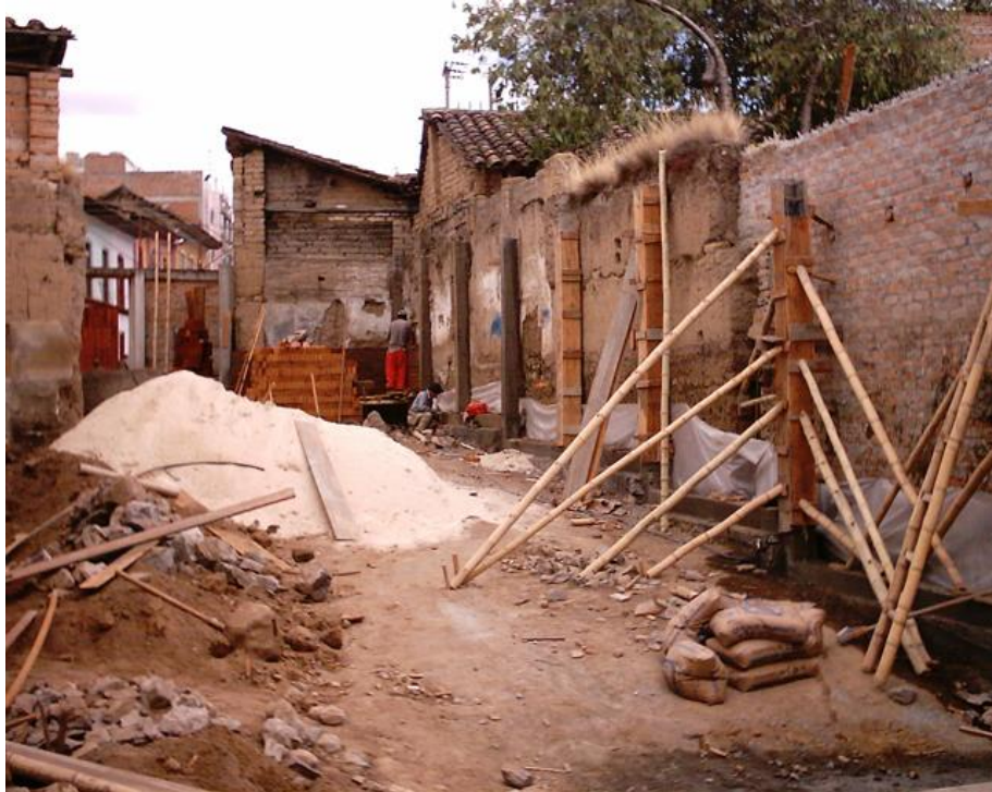
Figura 7. Columnas muro de cierre
