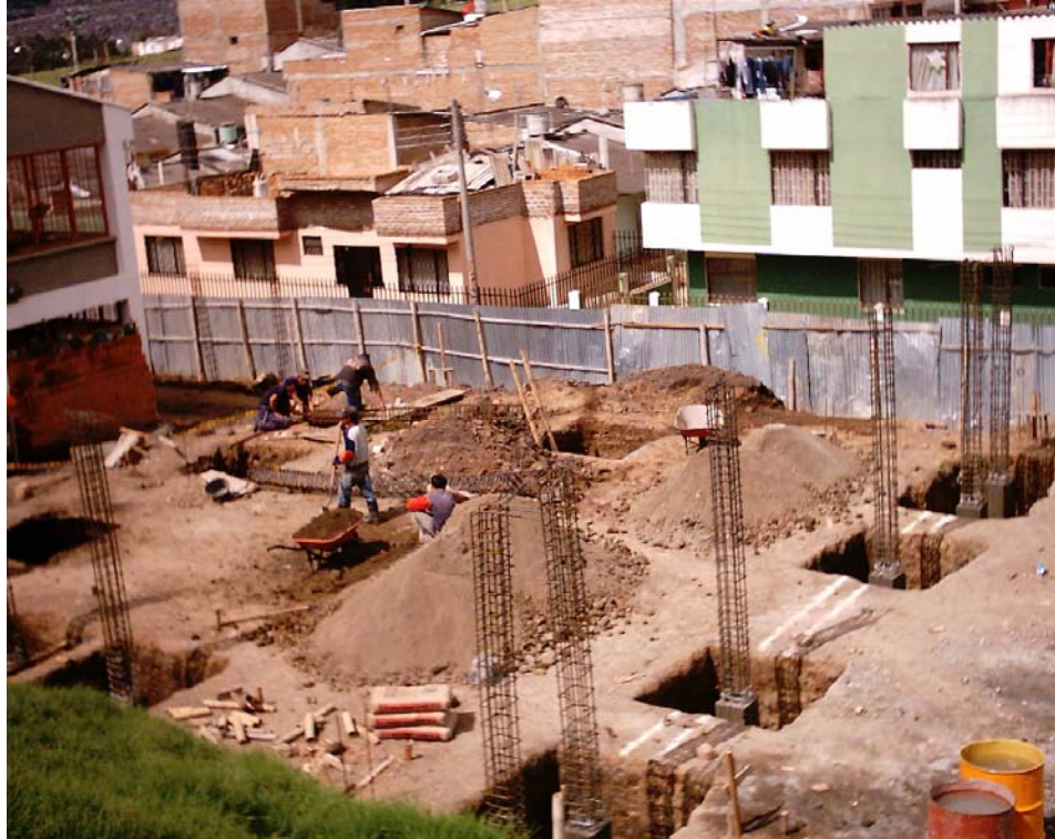
Figura 66. Cimientos fundidos en el restaurante
