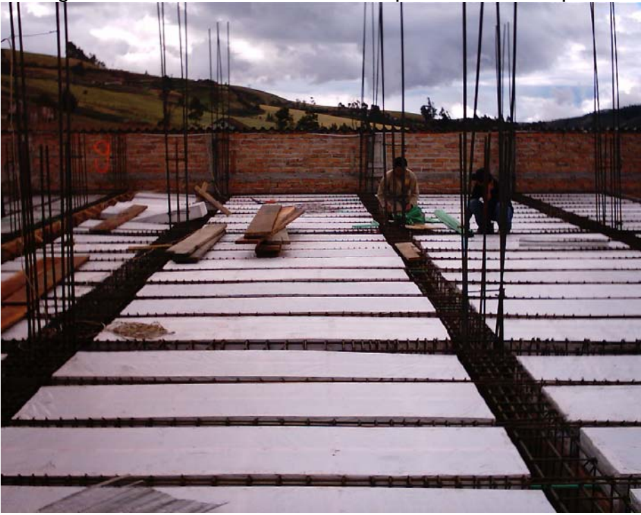
Figura 92. Instalación de casetones par losa de entrepiso
