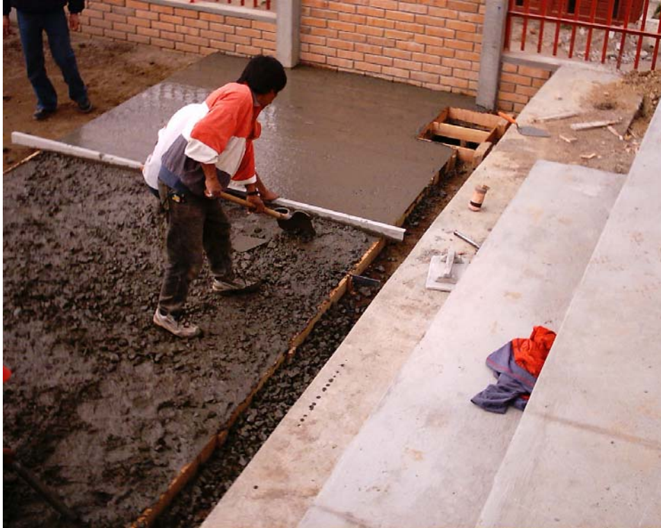
Figura 21. Fundición de placa de pavimento
