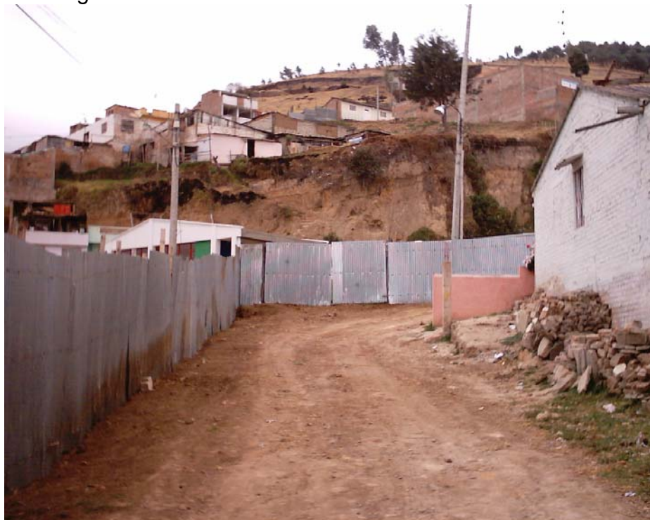
Figura 41. Vía nivelada en el sector del muro de cierre
