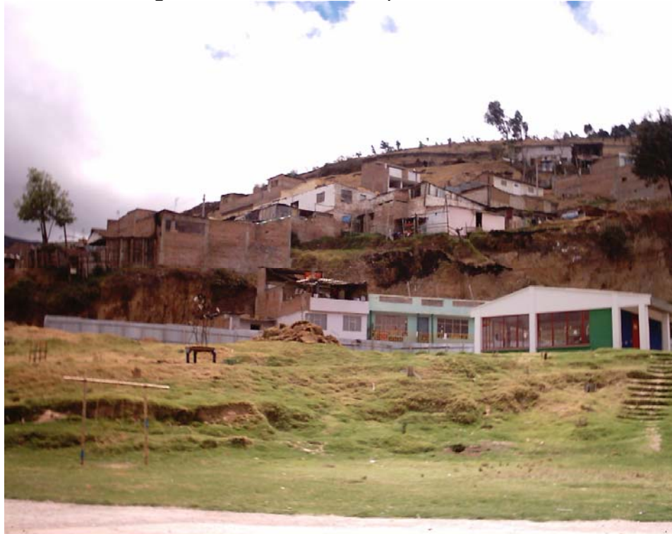
Figura 67. Zona de talud previa a la obra
