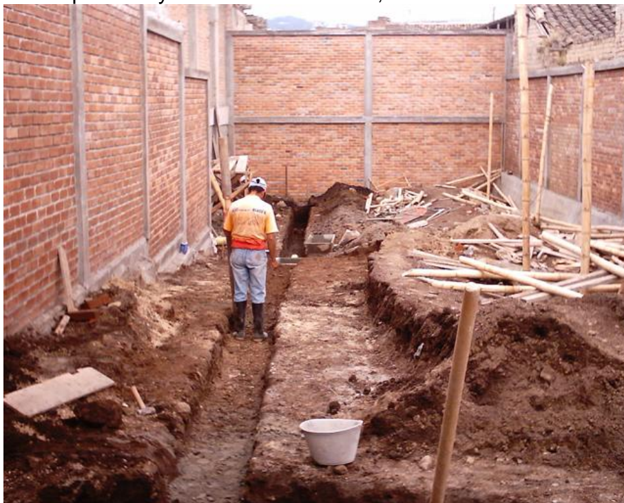
Figura 9. Mampostería y estructura terminada, se inicia instalaciones sanitarias
