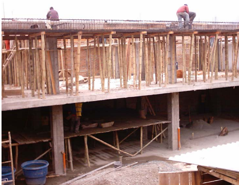
Figura 97. Armado de vigas de cubierta
