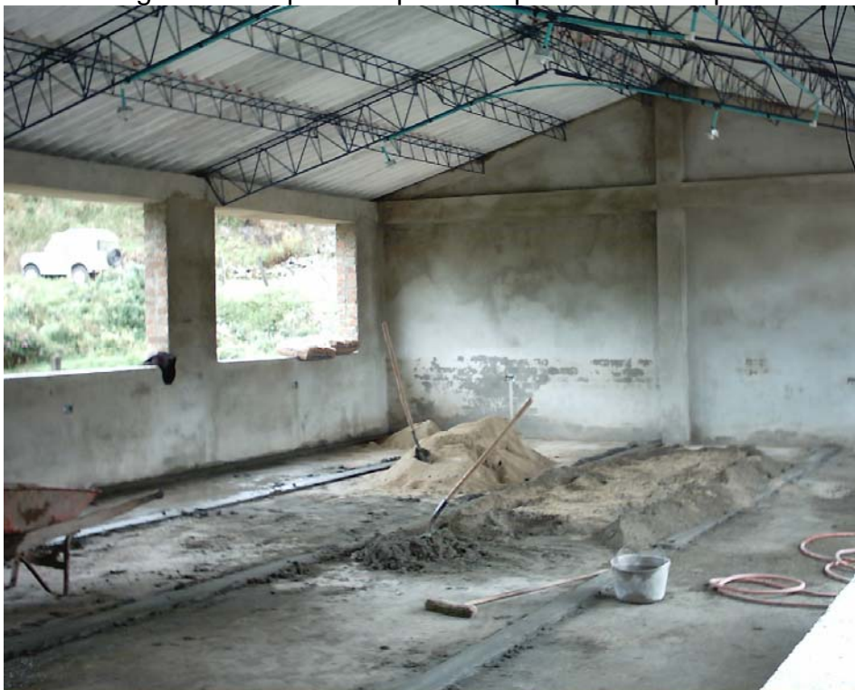
Figura 87. Repello de placa de piso salón múltiple
