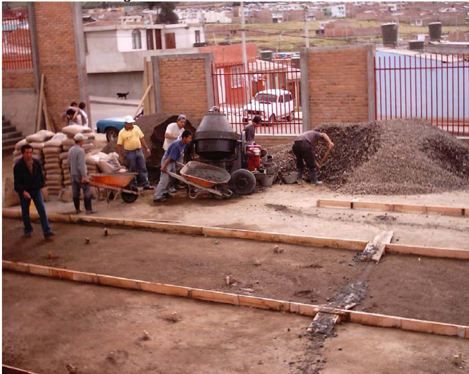
Figura 22. Elaboración de la mezcla
