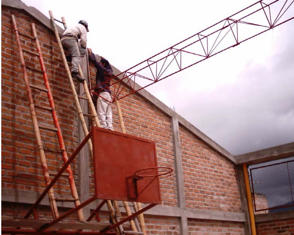
Figura 29. Instalación de correas
