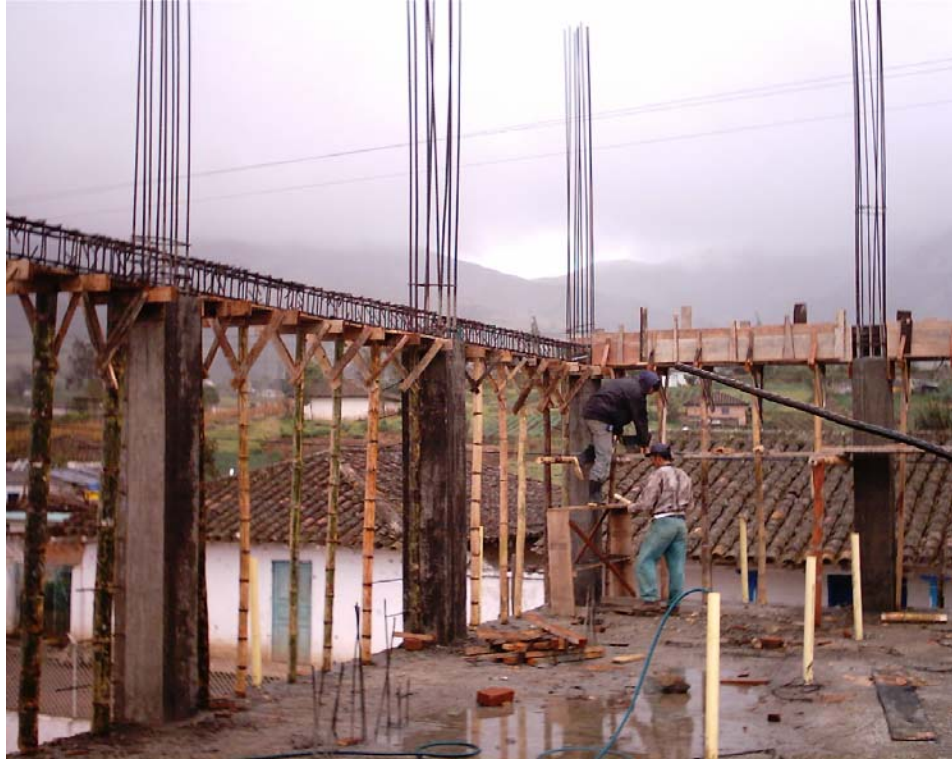
Figura 117. Vigas de segundo nivel
