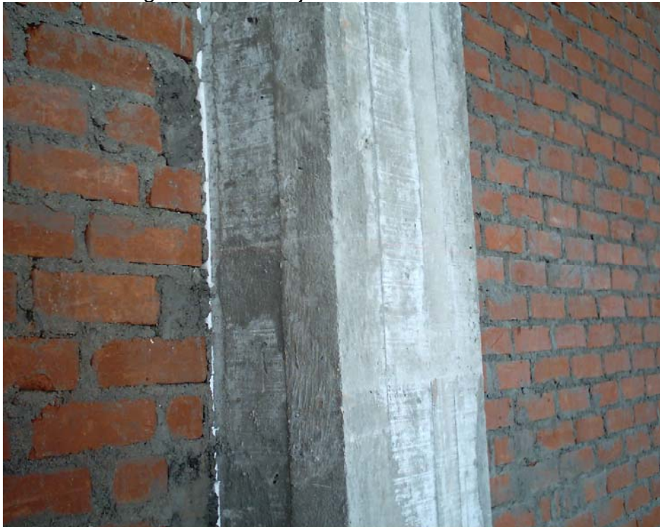
Figura 101. Anclaje de muros a estructura
