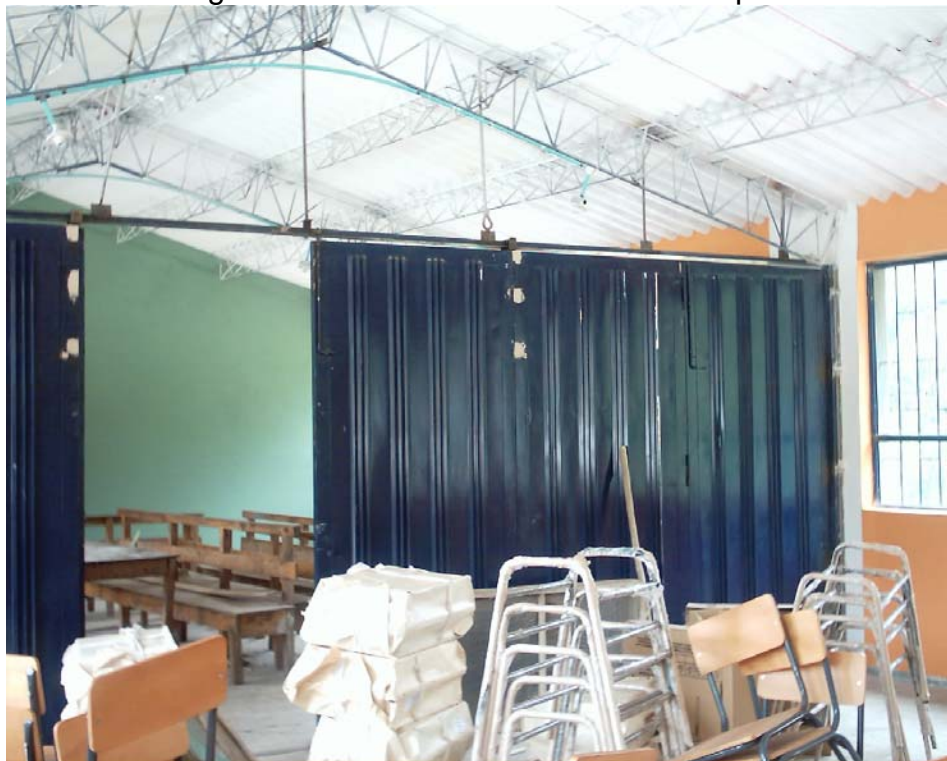
Figura 90. División metálica salón múltiple
