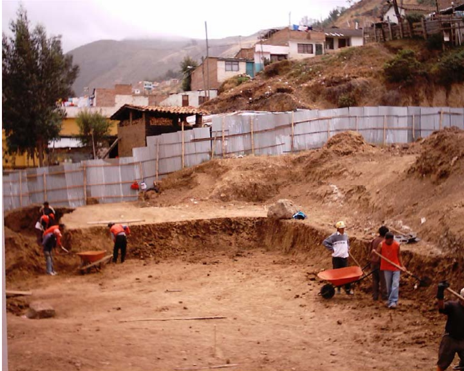
Figura 54. Nivelación de piso
