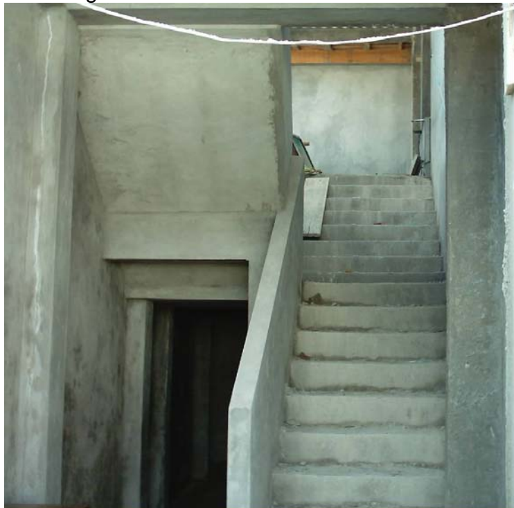
Figura 145. Zona de acceso a las aulas
