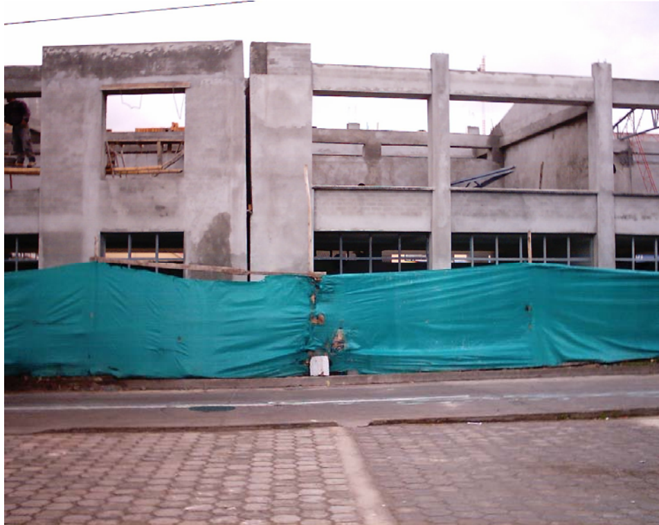
Figura 126. Dilatación entre bloques 1 y 2
