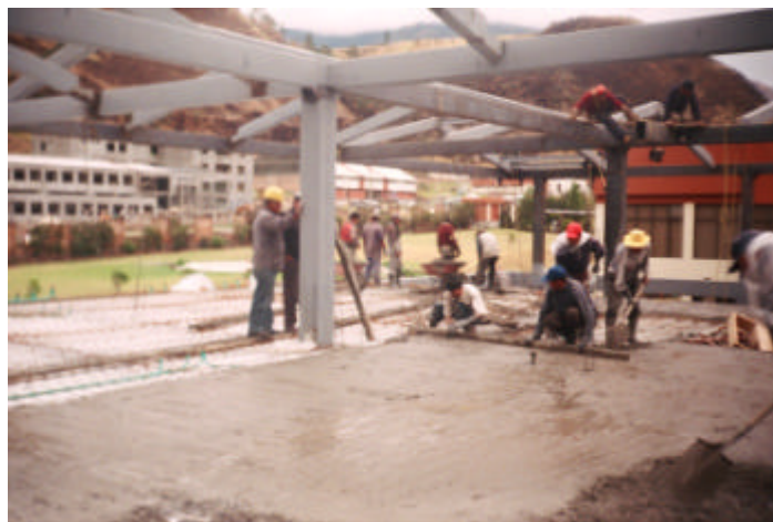
Figura 26. Fundición de la placa de entrepiso
