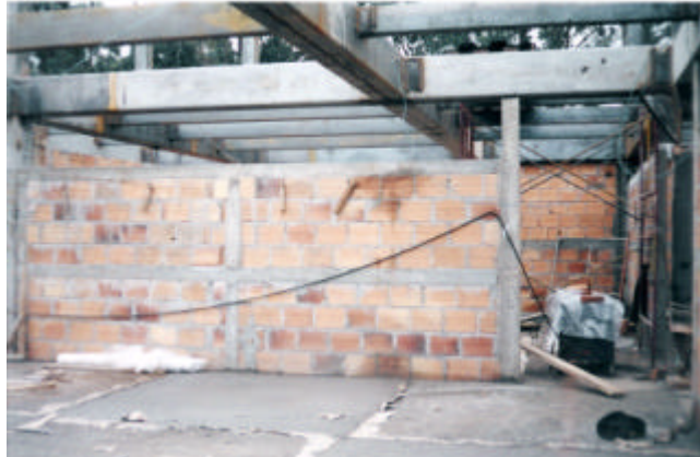
Figura 28. Mampostería y elementos de confinamiento
