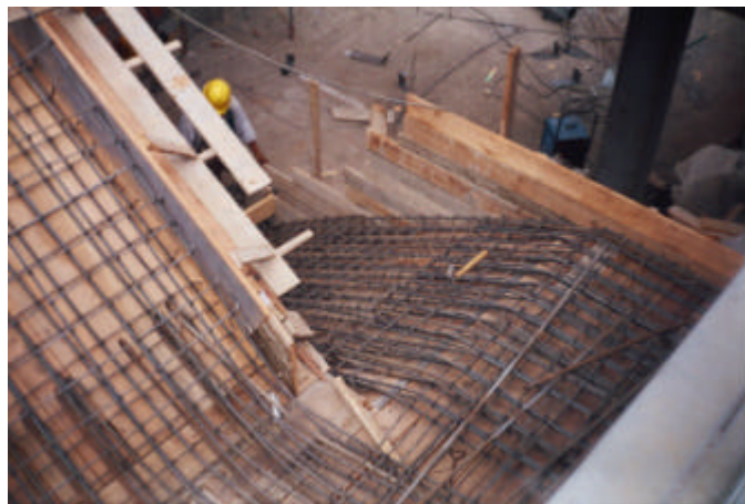
Figura 30. Armado y encofrado escalera autoportante
