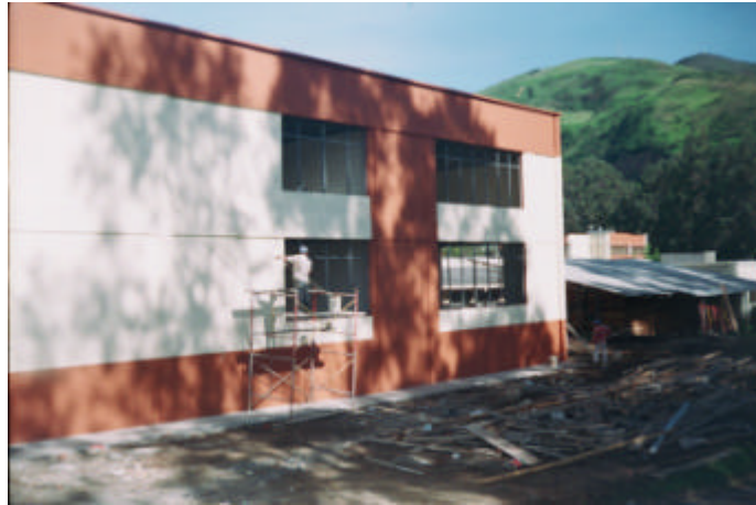
Figura 40. Pintura de Fachada
