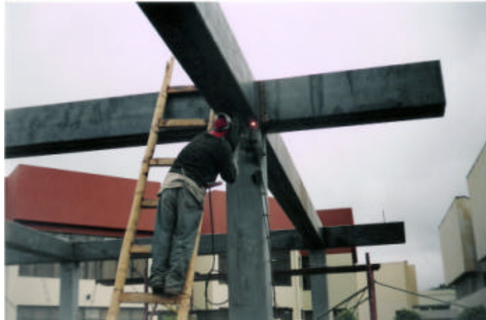
Figura 18. Montaje de vigas metálicas principales
