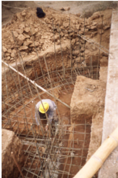
Figura 36. Armado muro de contención reforzado
