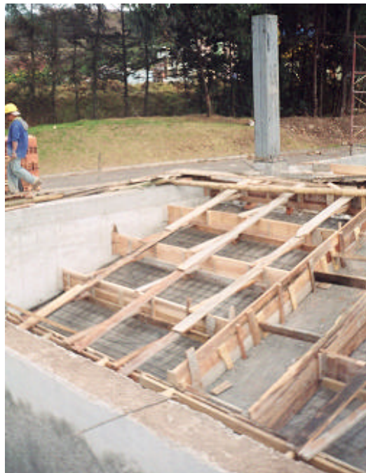
Figura 13. Armado y encofrado de Torreones
