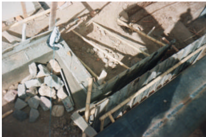
Figura 34. Encofrado muro de contención de gravedad
