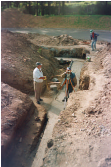
Figura 1. Localización y replanteo de la cimentación
