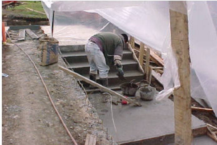
Figura 15. Fundición de escaleras
