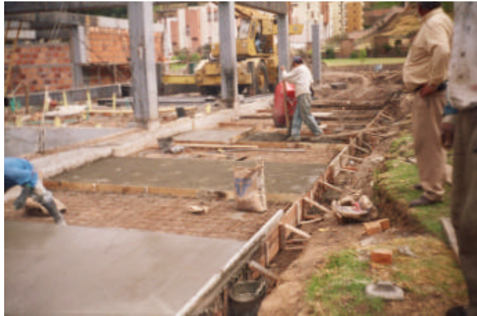
Figura 14. Armado y fundición de andenes
