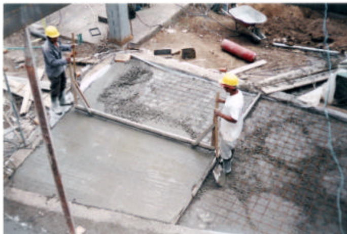
Figura 12. Fundición placa de piso
