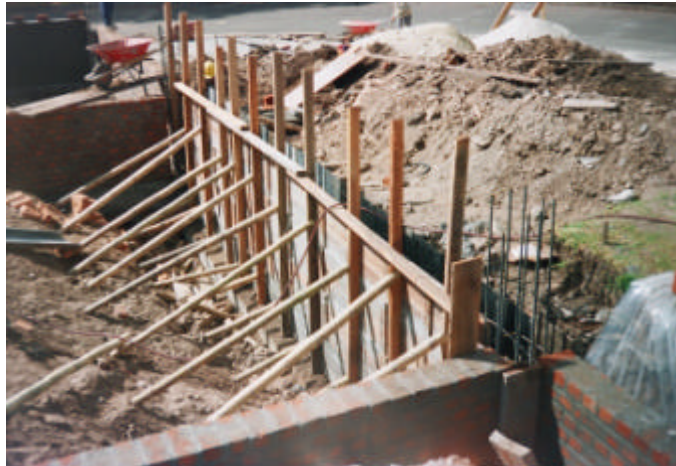
Figura 6. Armado y encofrado de la pantalla
