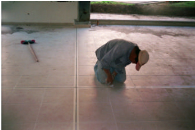
Figura 39. Sellado de junta de dilatación
