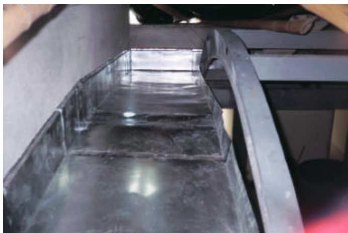
Figura 23. Instalación lámina en el domo
