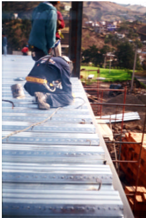
Figura 24. Instalación de la lámina colaborante
