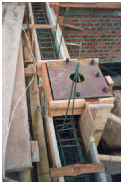
Figura 11. Anclaje y encofrado de platina
