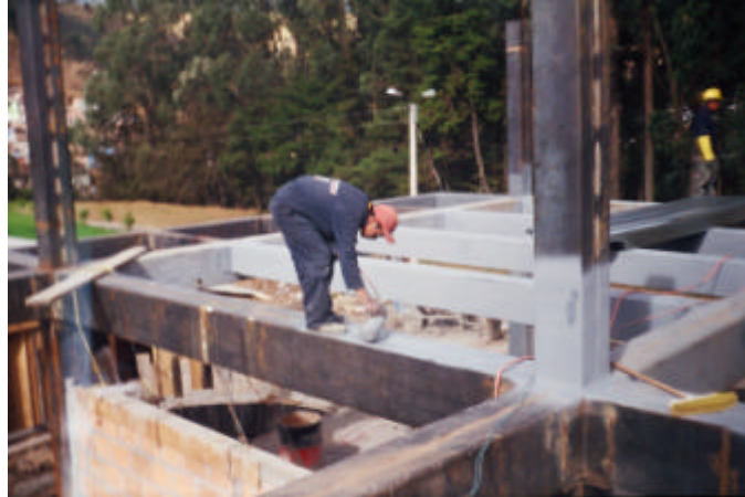
Figura 22. Aplicación de pintura anticorrosiva
