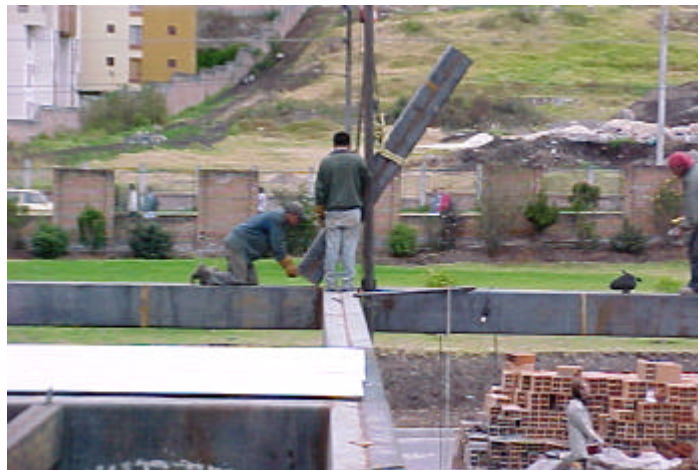
Figura 17. Montaje columna metálica segundo piso
