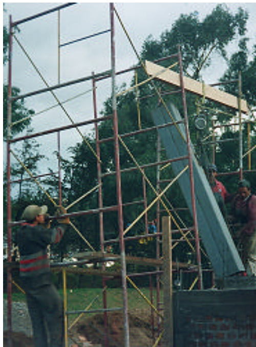
Figura 16. Montaje columna metálica primer piso
