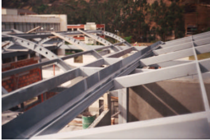
Figura 20. Cubierta y domo metálico
