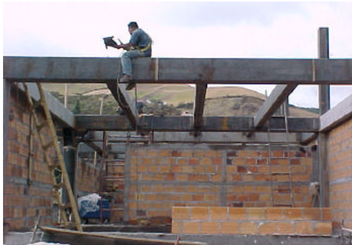
Figura 19. Montaje viguetas metálicas
