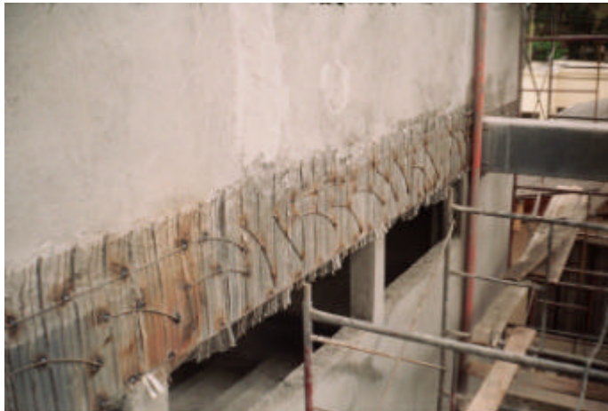
Figura 37. Pañete viga metálica
