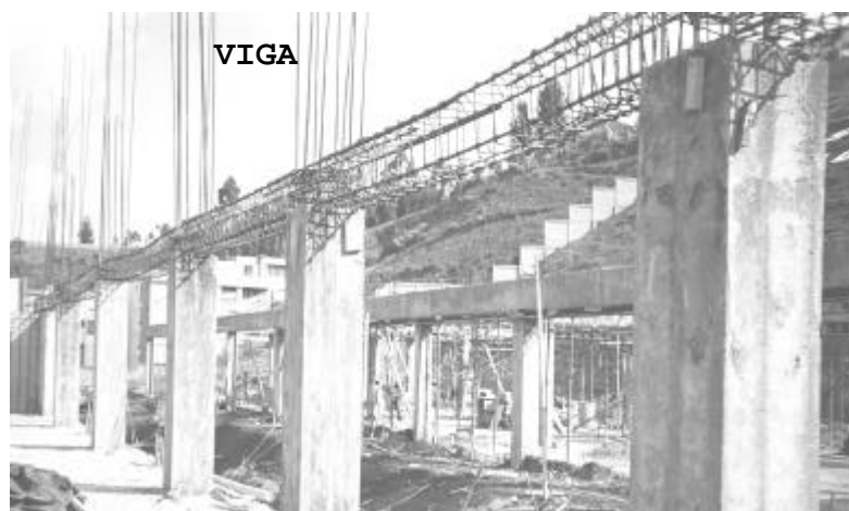
Figura 10. Detalle de traslapos
