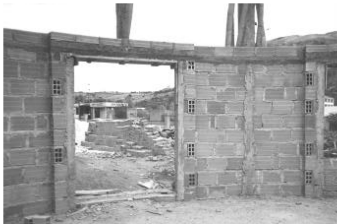
Figura 32. Detalle de muros en bloque
