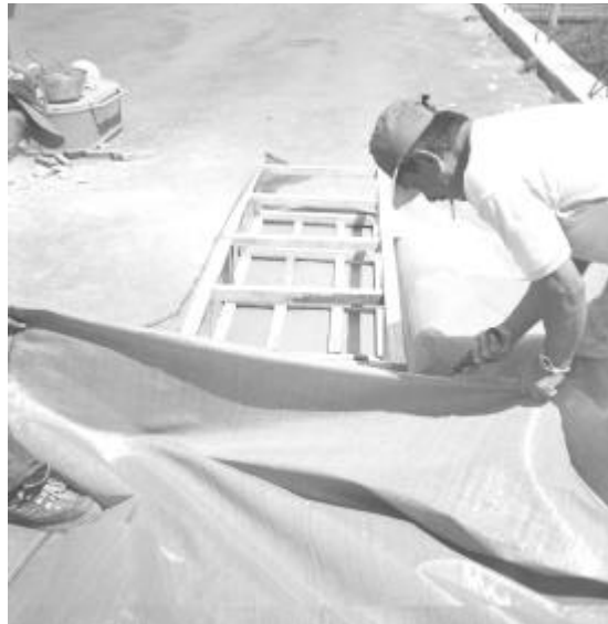
Figura 19. Armado de casetones
