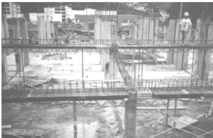
Figura 5. Detalle de viga aérea
