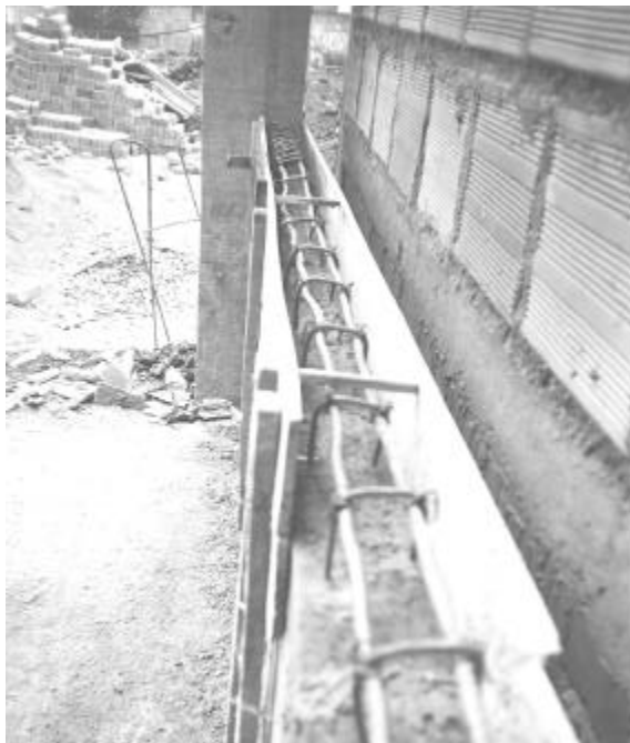
Figura 33. Detalle de viguetas de confinamiento para muros
