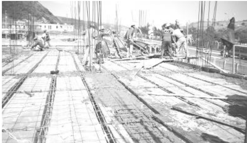
Figura 24. Fundición de losas aligeradas
