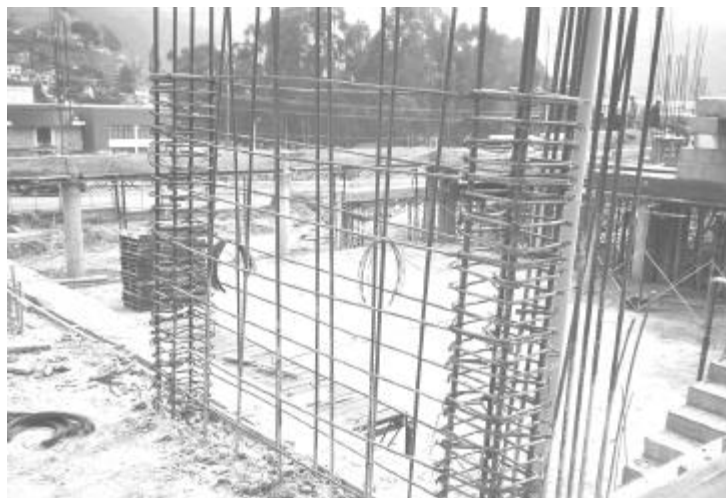
Figura 29. Refuerzo de pantallas
