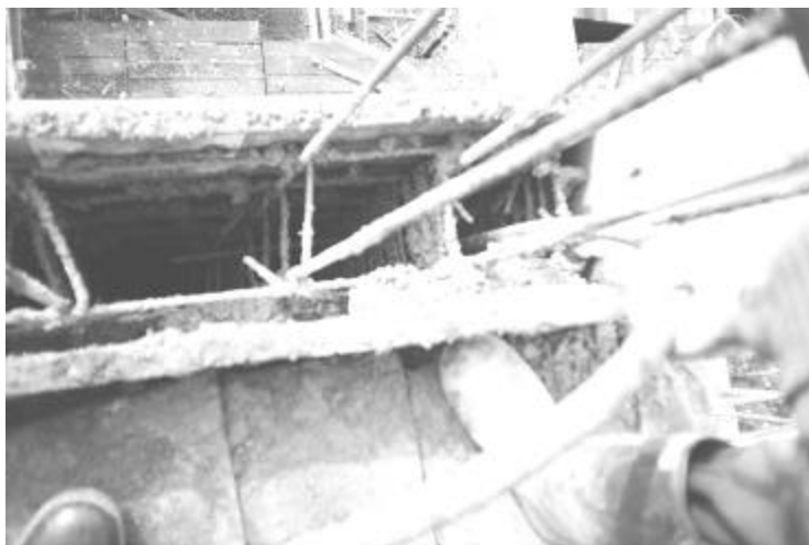
Figura 30. Fundición y Vibrado - Pantallas
