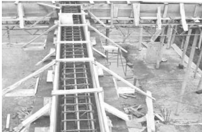
Figura 7. Armado del refuerzo
