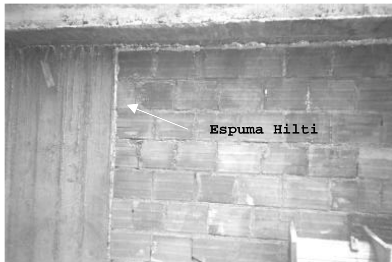
Figura 35. Sello de juntas entre muros y estructura
