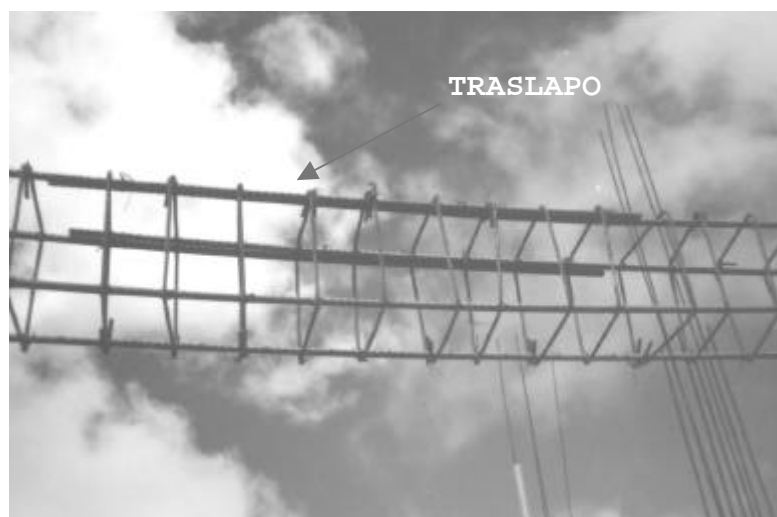
Figura 10. Detalle de traslapos
