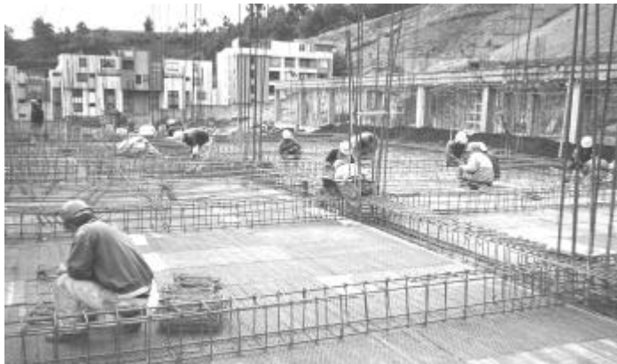
Figura 21. Armado de nervios de losa
