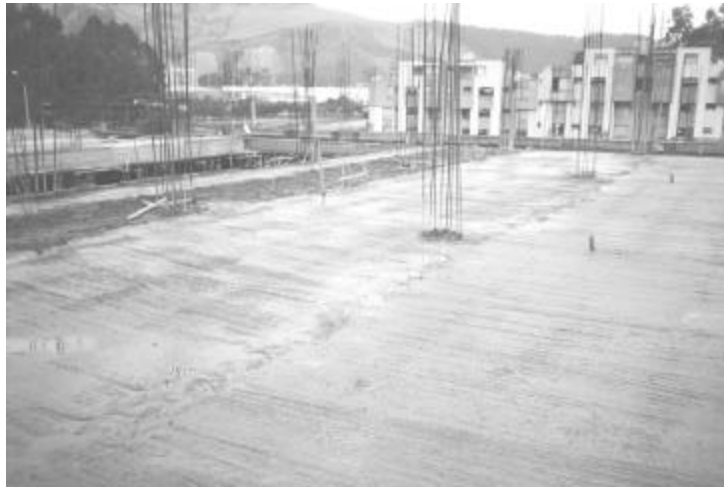
Figura 25. Detalle de losa terminada
