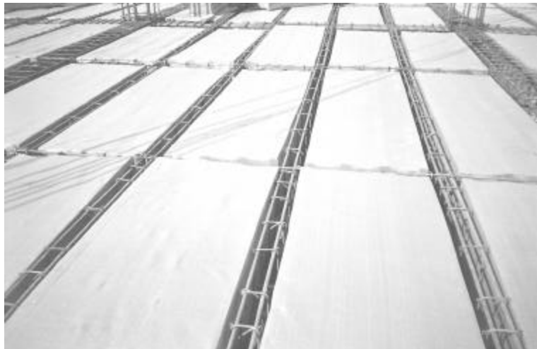
Figura 23. Colocación de los casetones
