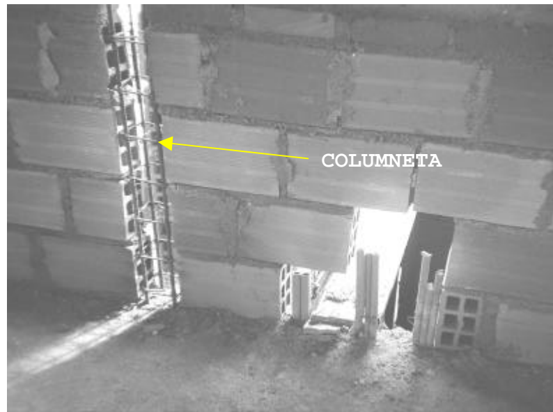
Figura 34. Detalle de columnetas de confinamiento para muros
