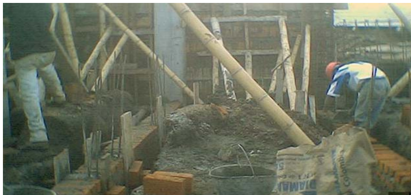
Figura 101. Muros de sobrecimiento
