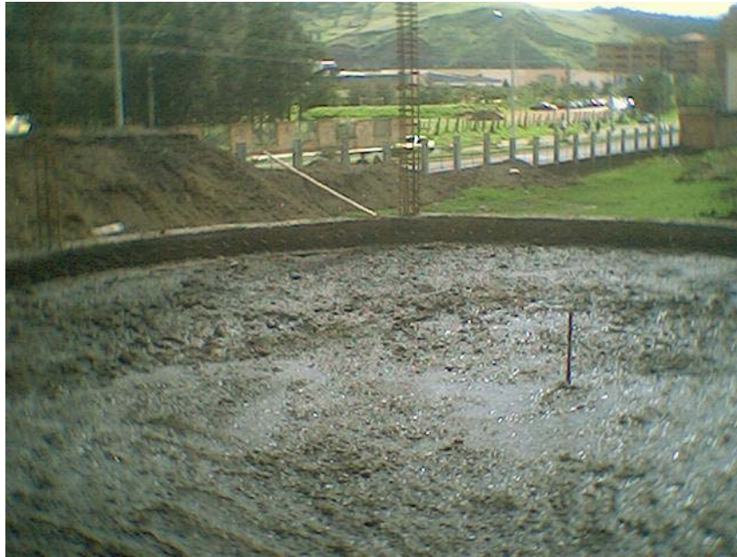
Figura 69. Eje de construcción en la viga circular
