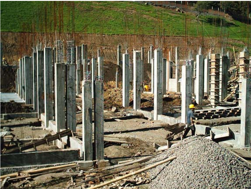
Figura 79. Dilatación entre bloques 1 y 3
