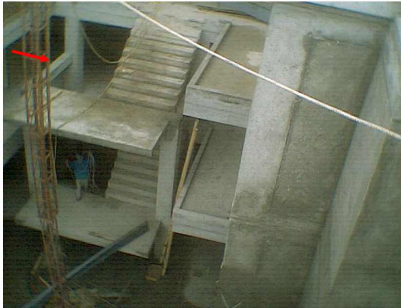
Figura 1. Vigas entre escaleras y columnas
