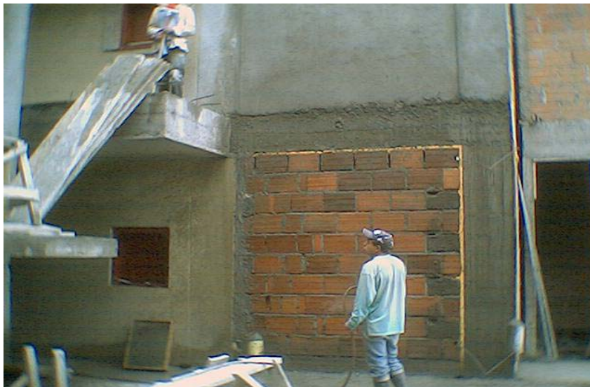
Figura 25. Mojando la superficie a repellar
