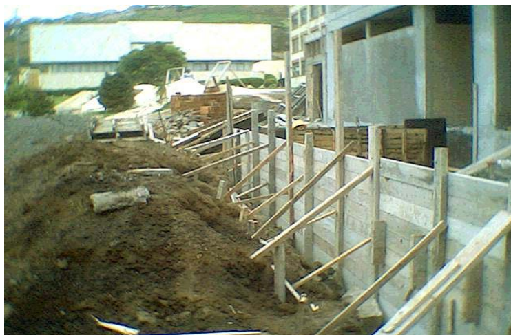
Figura 8. Apuntalamiento de la formaleta
