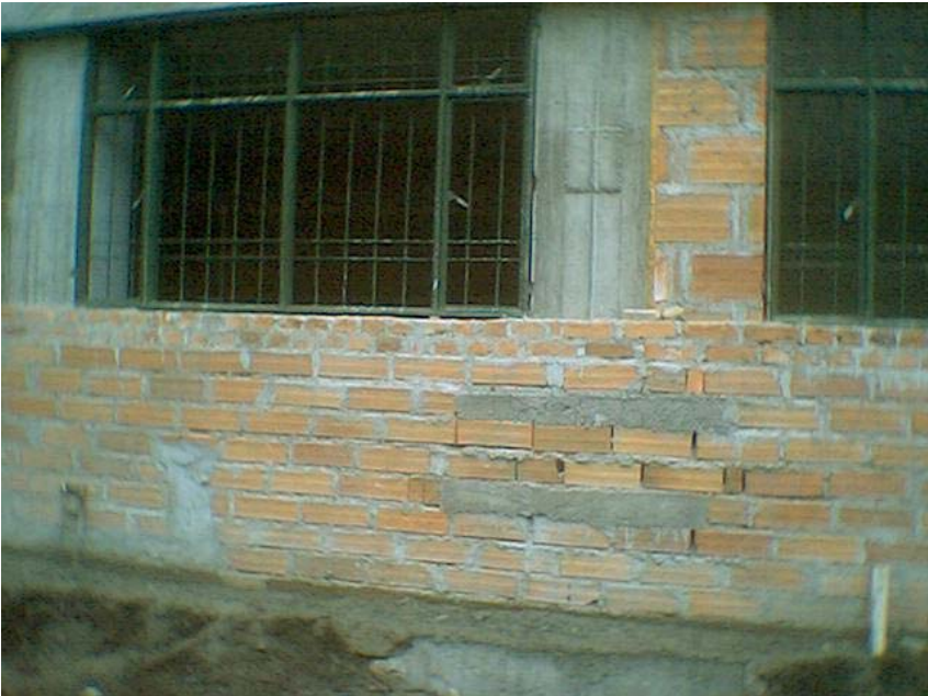
Figura 40. Instalación de ventanas
