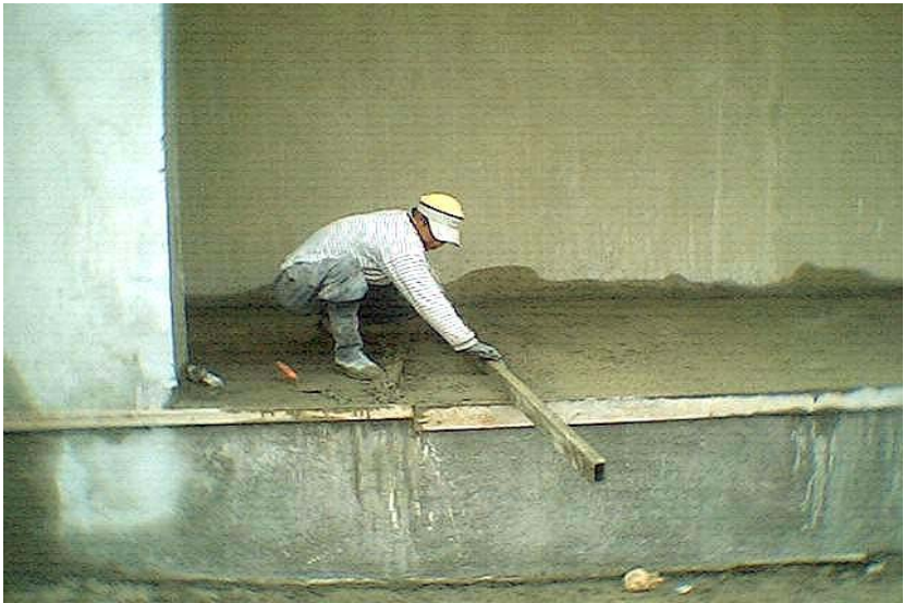
Figura 28. Espesor del repello de piso
