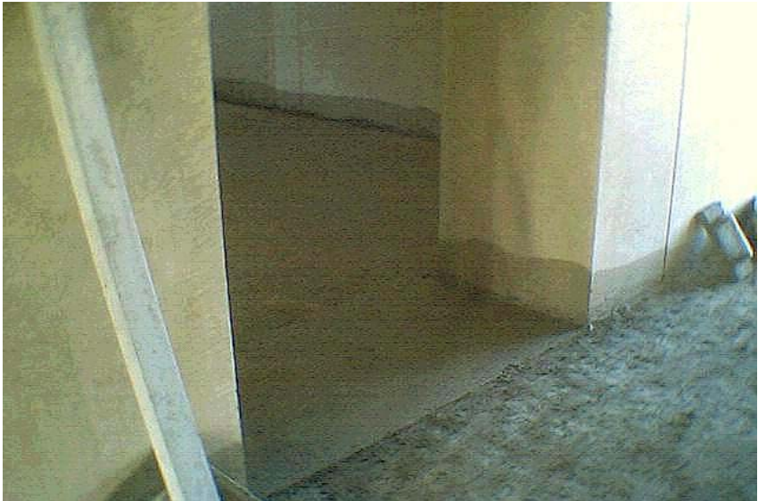
Figura 28. Espesor del repello de piso
