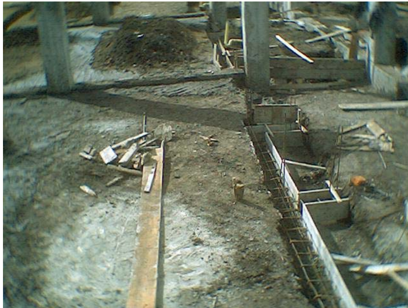
Figura 84. Formaleta para viguetas y armado de hierro
