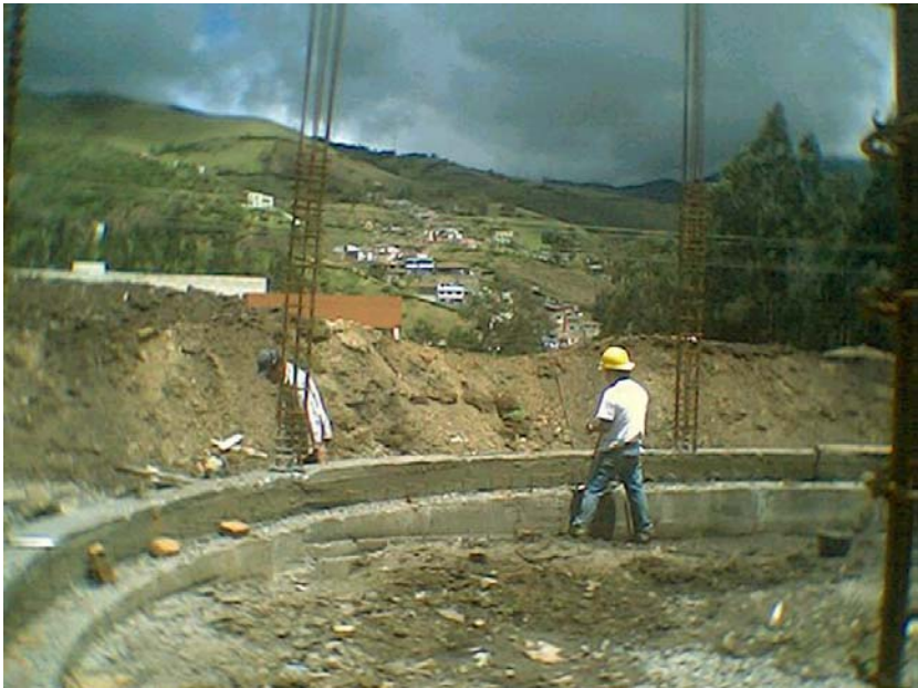
Figura 93. Concreto ciclópeo para muros de corla longitud
