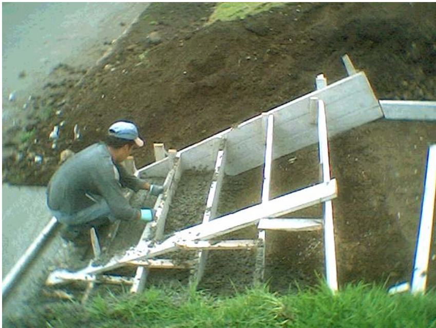
Figura 23. Fundición de escalones
