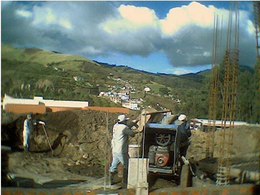
Figura 104. Parihuela vertiendo material en la mezcladora
