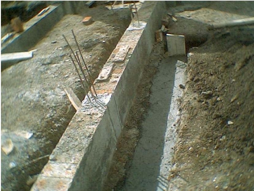
Figura 85. Fundición de viguetas
