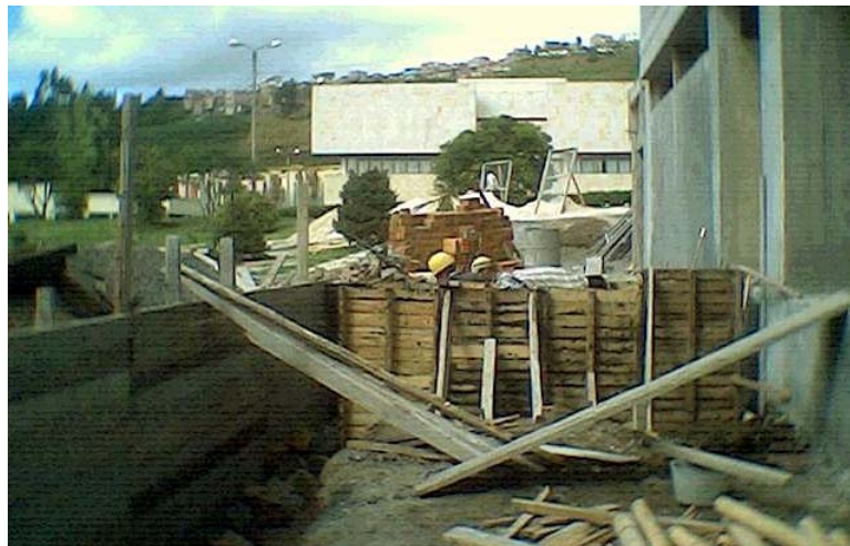
Figura 7. Espacio por donde pasa la vía
