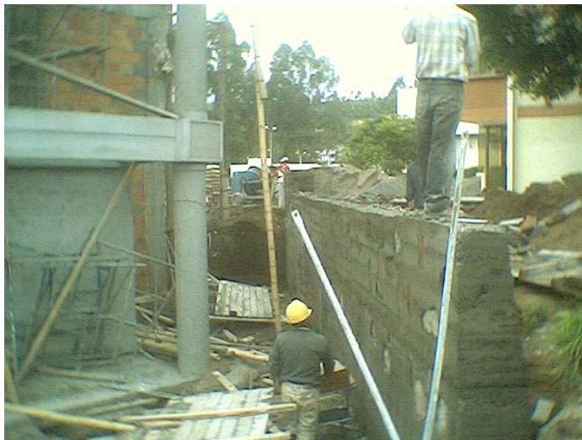
Figura 11. Muro lateral terminado
