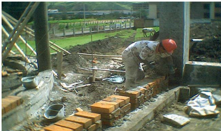
Figura 100. Pega de muro de sobrecimiento
