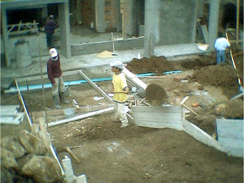
Figura 19. Armado de formaleta de peldaños
