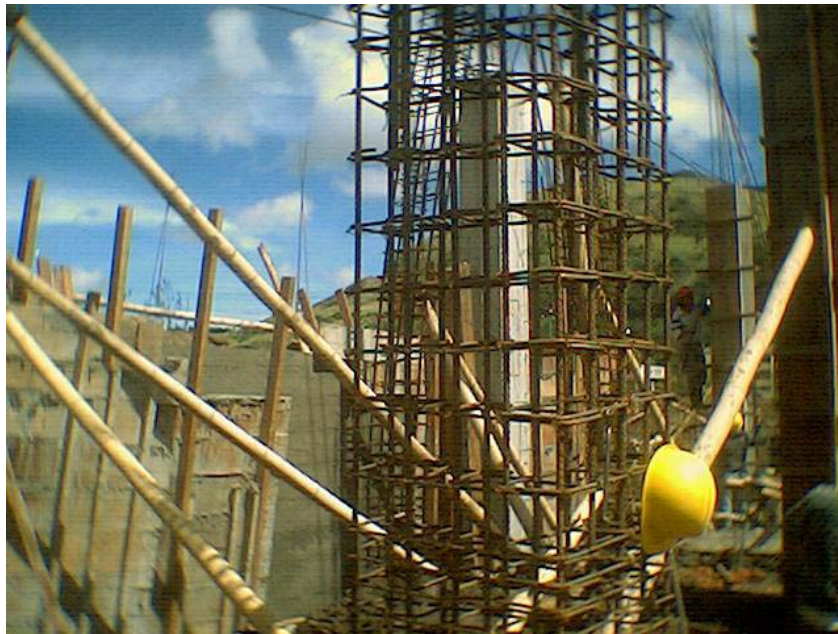
Figura 71. Armado de hierro en columnas circulares
