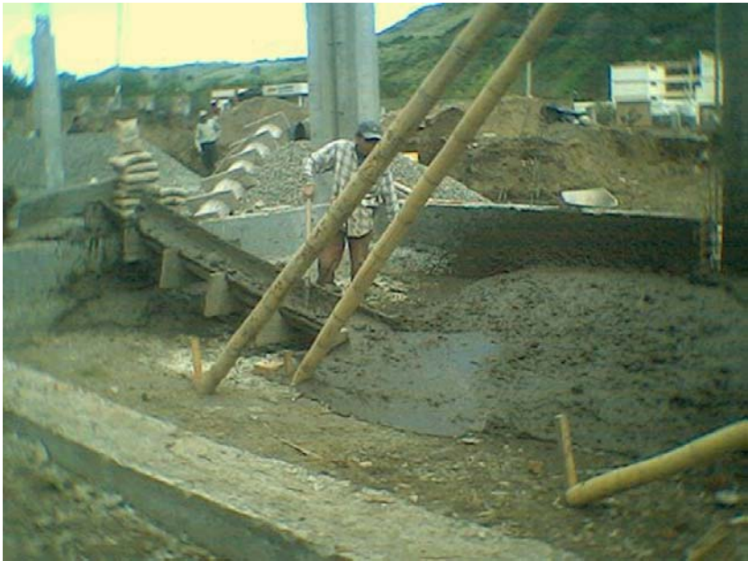
Figura 94. Altura del muro de concreto ciclópeo
