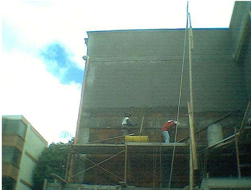
Figura 24. Repello afinado en exteriores
