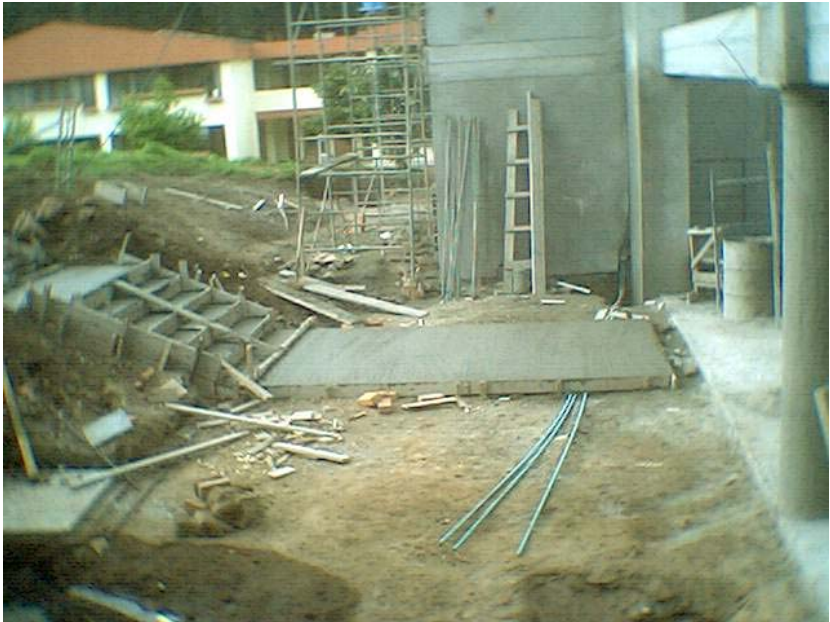
Figura 21. Vista lateral de escaleras de acceso principal
