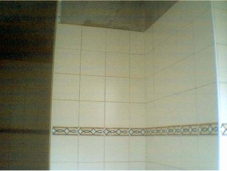
Figura 32. Esquinas con bocel piragua
