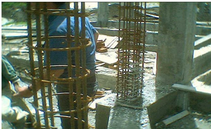
Figura 71. Armado de hierro en columnas circulares
