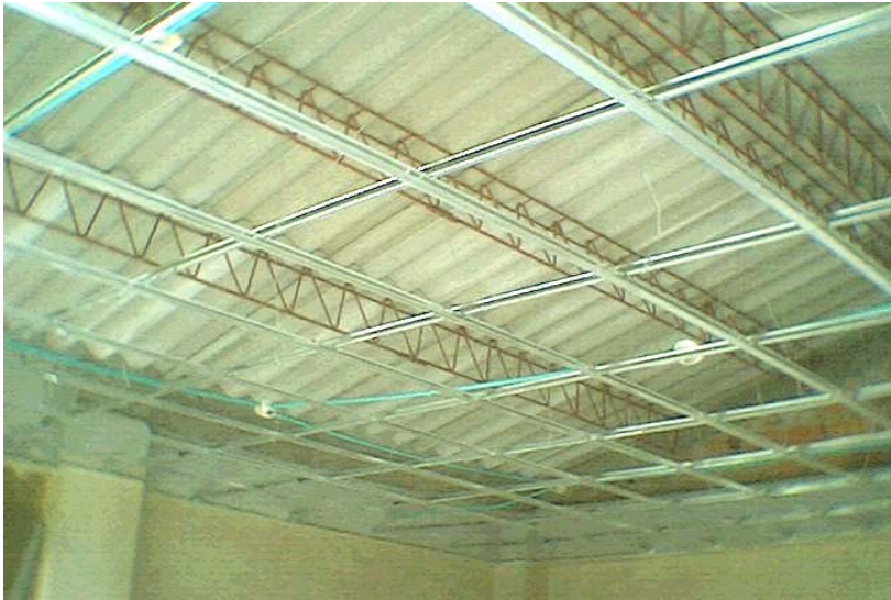
Figura 67. Vista general de la estructura
