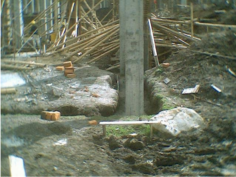
Figura 75. Introduciendo la guaya del vibrador en la columna
