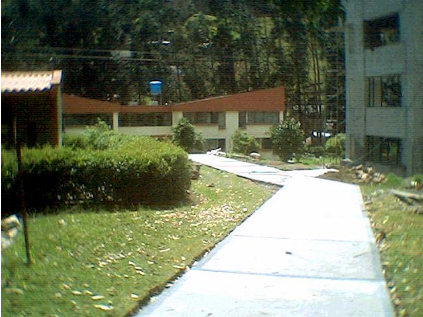
Figura 16. Acceso peatonal terminado
