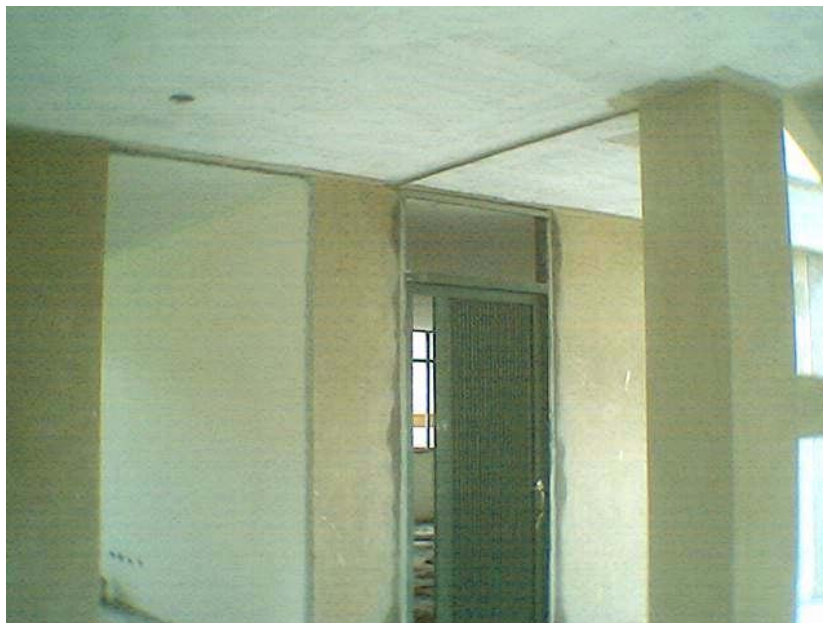
Figura 42. Instalación de puertas
