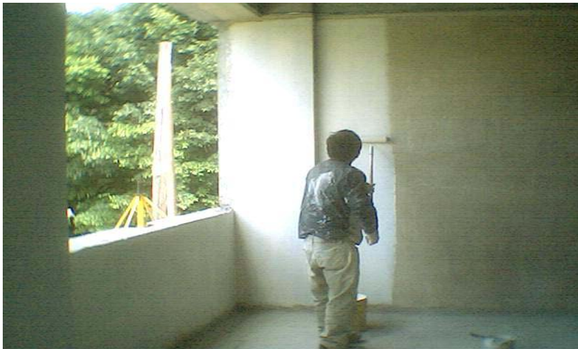
Figura 61. Aplicación de pintura con rodillo
