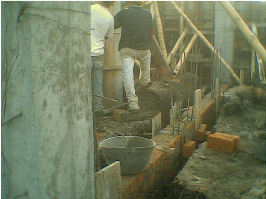
Figura 82. Formaleta de columnetas en muros internos
