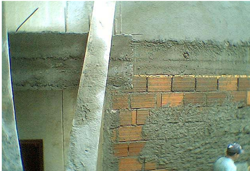
Figura 26. Repellando interiores
