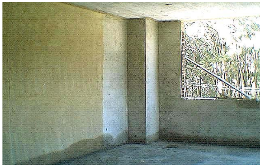
Figura 60. Aplicación de estuco
