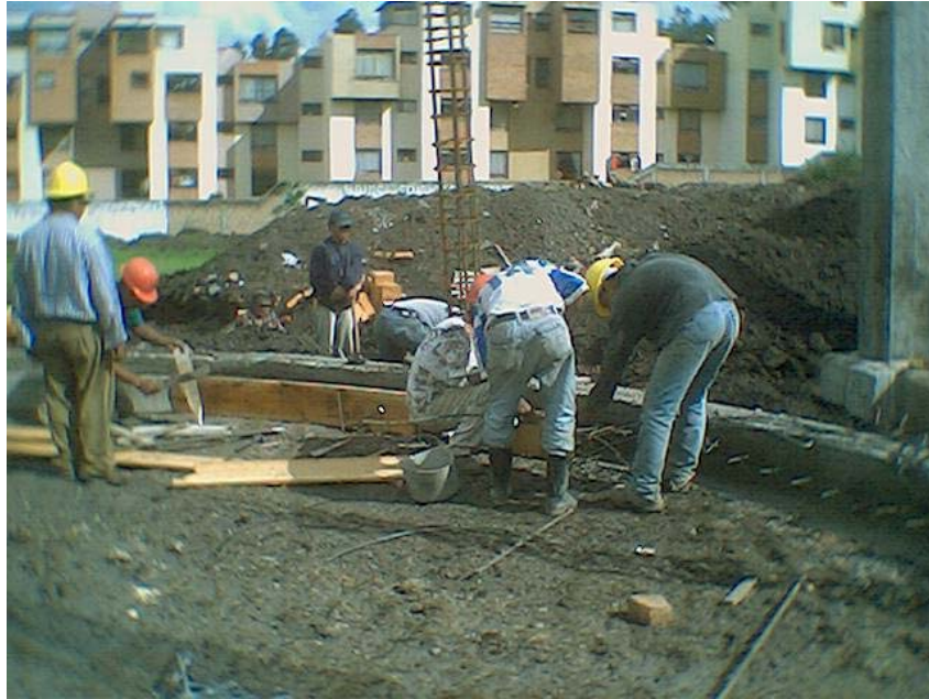
Figura 87. Formaleta de vigueta circular
