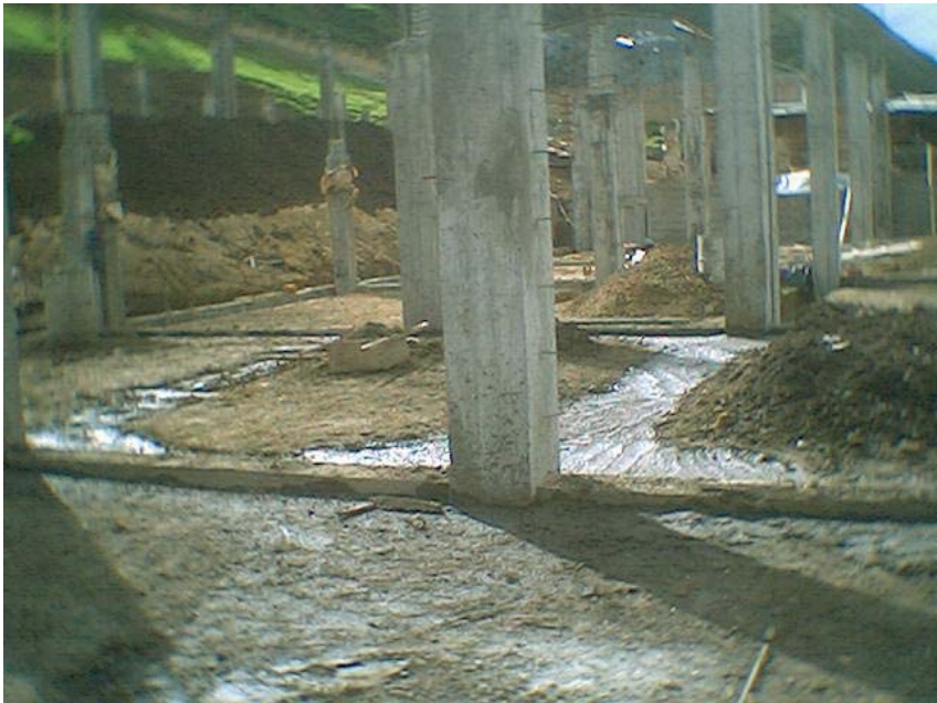
Figura 108. Relleno con suelo cemento en los espacios de excavación de las vigas
