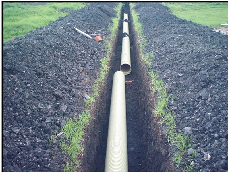
**Figura 71. ENSAMBLE DE TUBERÍA PARA ALCANTARILLADO NOVAFORT – PVC**
