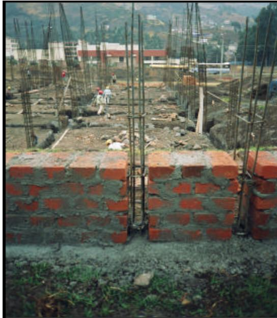
El mortero para repello y esmaltado de los muros es impermeabilizado con sika 1, proporción 1:8 en volumen de agua, con el objeto de evitar el paso de la humedad del suelo a la placa de piso y a la mampostería de la edificación.
