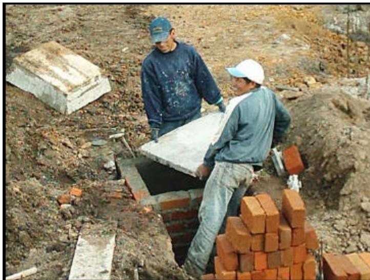
**2.2.6.2 Tubería sanitaria de aguas lluvias.** Las aguas lluvias que son recogida por las vigas canal deben ser evacuadas del mismo, esto se hace a través de la instalación de bajantes los cuales llevan sus agua a su correspondiente caja de inspección.
