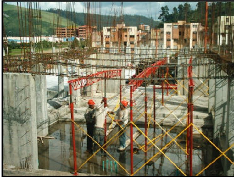
**Figura 94. FORMALETA BASE INSTALADA TOTALMENTE**
