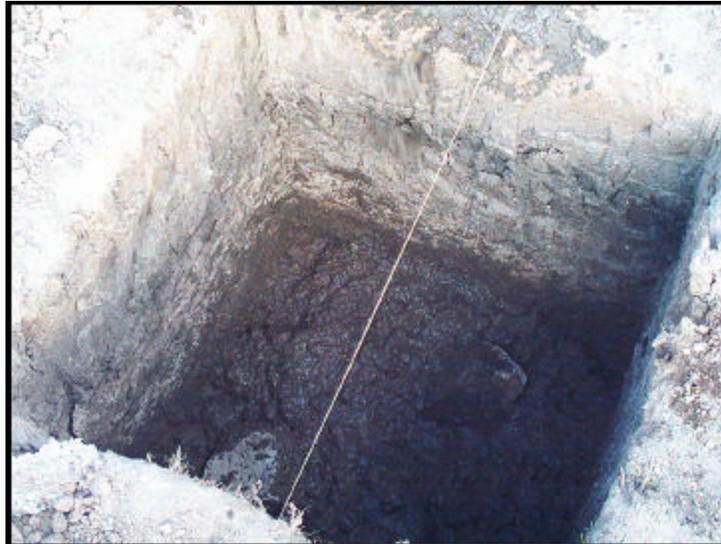
Las zapatas adyacentes al bloque 3 están a nivel de la cimentación de estos bloques y el suelo de cimentación fue mejorado con material de sitio, mezclado con arena negra y triturado de 3", compactado al 95% del proctor modificado.
