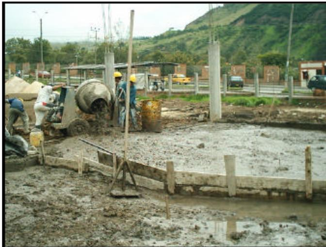
**2.2.7.2 Instalación de polisecc.** Conformada la base de la placa, se procede a instalar polisecc, que es un plástico impermeable utilizado con el objeto de evitar el paso de la humedad del suelo por la placa del piso a la mampostería del primer piso. Este material tiene una presentación en rollos de 1.60 mt de ancho, por que se dejaba un traslape de 0.30 mt entre cada tira.
