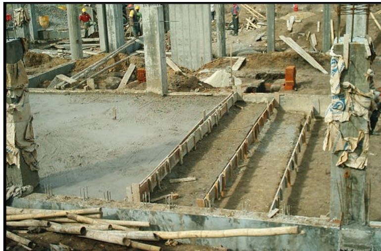
El relleno más significativo con suelos cemento que se realizó, fue en el bloque 5 para alcanzar el nivel de piso igual al del bloque 4, con este propósito se proyectó el muro de contención en concreto reforzado hasta este bloque. Esperados 7 días después de fundido el muro de contención y que el concreto alcanzara un 80% de su resistencia, se empezó con el relleno que en algunos sectores tenía alturas hasta de 2.20 mt que iban disminuyendo a medida que se acercaba al bloque 4
