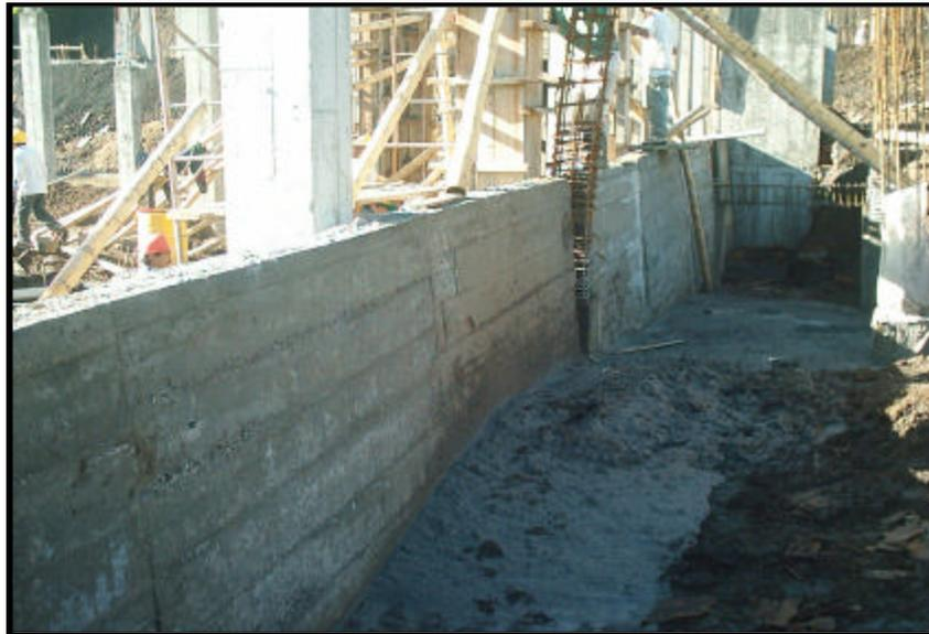
Para dar rendimiento al trabajo del relleno, se ubicaba la máquina lo más cerca posible al hueco, para evitar el transporte de la mezcla en buguis, así a medida que se producía en la mezcladora fuera vaciada directamente. En este sector se rellenaron aproximadamente 300 m<sup>3</sup> con suelo cemento fluido.
