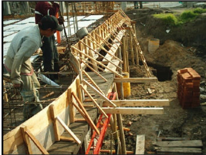
➤ **Construcción de Casetones.** A medida que se instalaba la formaleta base, se estaban construyendo los casetones de la losa. Los marcos principales se elaboraron en varenga de sección 4 \* 4 cm y las varengas de unión de sección 2 \* 4 cm. Para la conformación de un casetón se colocaban marcos cada 0.50mt, y sus dimensiones de largo y ancho variaban de acuerdo al espaciamiento de vigas y nervios.
