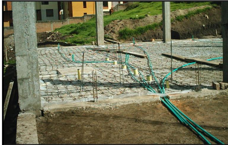
**2.2.7.5 Fundición de placa de piso.** Revisado en conjunto con la interventoría, la instalación eléctrica, hidráulica y sanitaria en sectores donde así lo requería, se da orden de fundida. La mezcla de concreto utilizada fue con dosificación 1 : 2 : 3, con arena negra lavada y triturado fino como agregados. A medida que se vaciaba el concreto se chequeaba la colocación del emparrillado a 1/3 del espesor de la placa que para este caso fue de 0.10 mt, así como el peralte de la placa.
