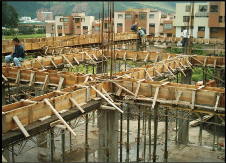
**Figura 85. CHEQUEO DE VERTICALIAD DE TABLEROS LATERALES**
