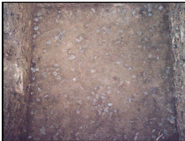
Las zapatas sobre el eje 9, acceso principal a la facultad, tenían una diferencia de nivel de aproximadamente 1.0 mt, con respecto a las anteriormente descritas, para alcanzar la profundidad de desplante requerida es necesario rellenar con suelo cemento y rajón, se amplía la sección de la excavación 0.30 cm por cada lado para aumentar el área de presión ejercida por la zapata.
