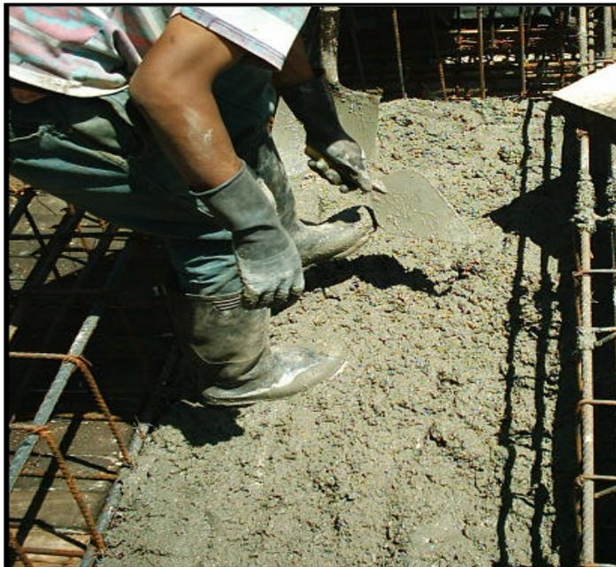
Es importante tener en cuenta que a la hora de fundir el solado de mortero, evitar que penetre a la sección propia de las vigas o nervios, puesto que se debe garantizar que su recubrimiento inferior sea todo en concreto.
