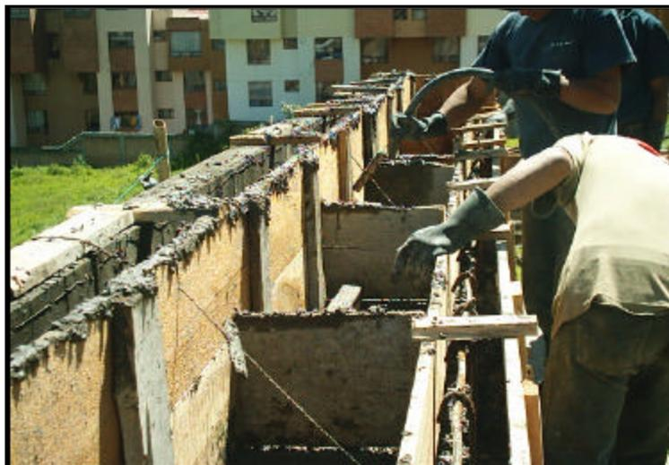
Cuando la fundición llegaba al nudo, intercepción viga columna, se chequeaba que la mezcla se distribuya muy bien a lo largo y ancho del mismo, en ocasiones cuando el vibrador no alcanzaba a penetrar al nudo por la cantidad de refuerzo, se chuzaba el concreto garantizando que se llene de manera adecuada en toda su sección.
