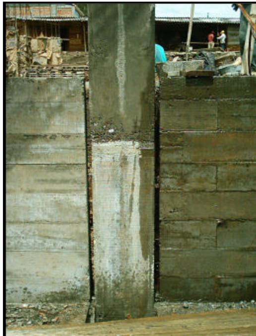
**2.2.5 Relleno con suelo cemento fluido.** Se programa relleno de sobre excavaciones realizadas para la construcción del muro sobrecimiento, así como también rellenos para alcanzar el nivel de la placa de piso internos al muro sobrecimiento.
