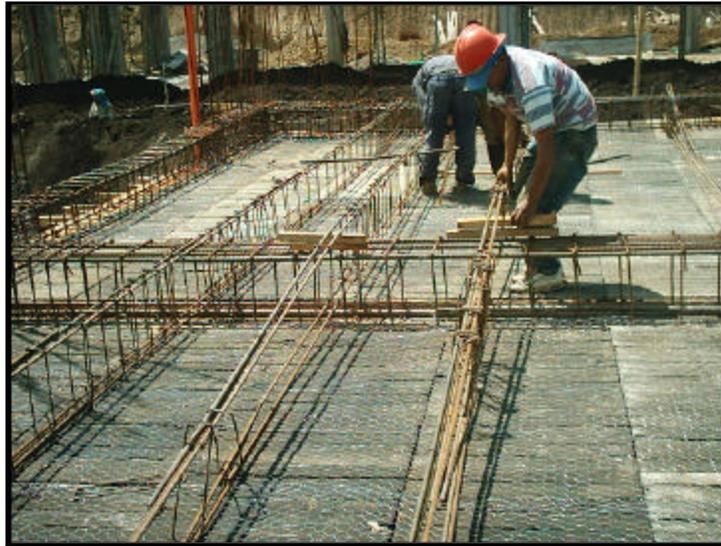
FIG 100. ARMADO COMPLETO DE LOSA ALIGERADA N + 3.85
