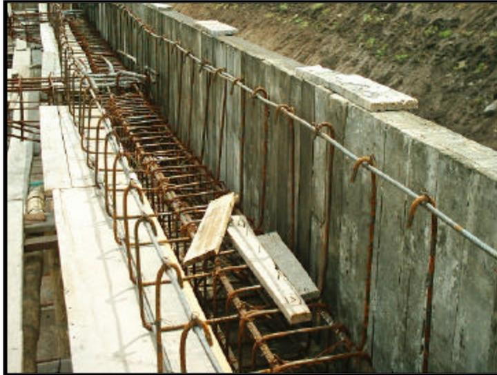
Las ménsulas, elementos estructurales proyectados para apoyar la armadura metálica de la cubierta, tienen un refuerzo independiente al de la columna, el cual se ancla 30 cm dentro de ésta para garantizar un elemento estable.
