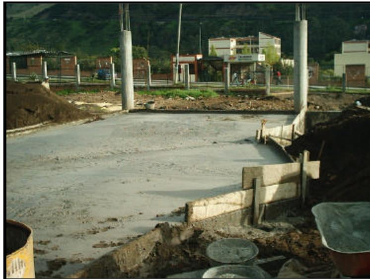
El relleno con suelo cemento también fue utilizado cuando las excavaciones para la instalación de tubería de alcantarillado eran grandes en cuanto a sección y profundidad, así se daba una mayor estabilidad al relleno de allí en adelante hasta alcanzar el nivel de piso determinado, esto debido a que el suelo estaba húmedo y se dificultaba el relleno de las chambas para ser compactadas con pizón .
