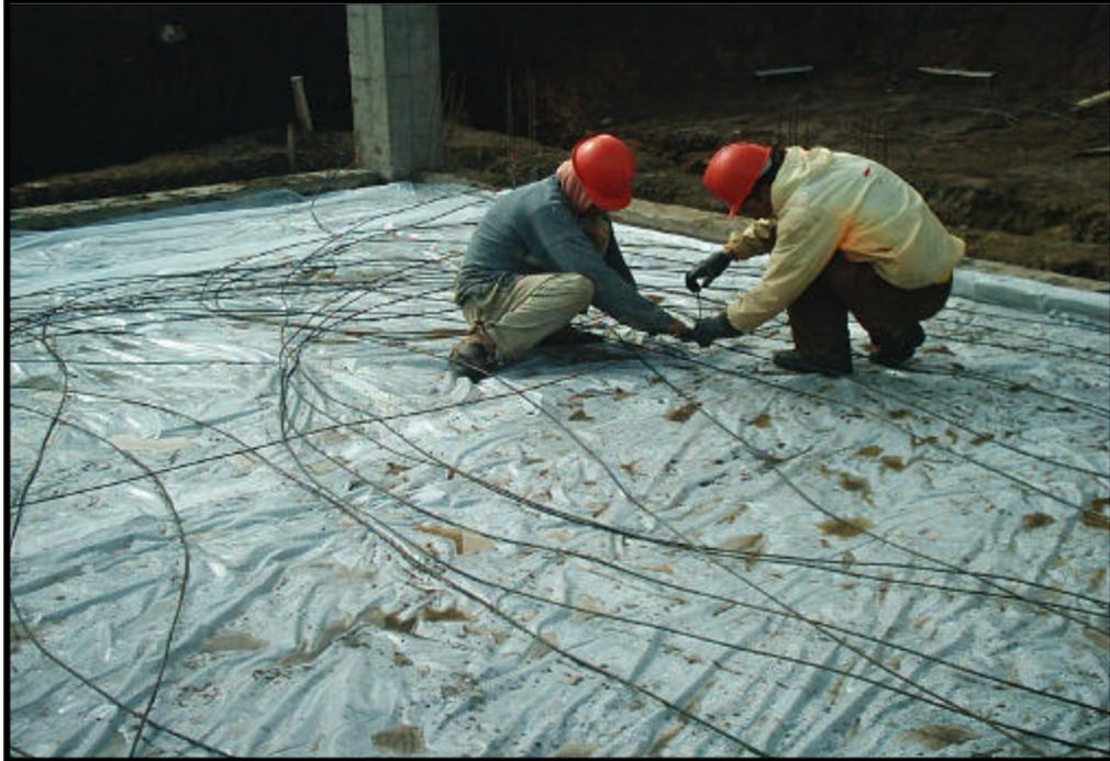
**2.2.7.4 Instalación eléctrica.** Inmediatamente después del finalizar el amarre del emparrillado de la losa, se empieza a instalar los doctos de los puntos eléctricos, voz, datos e imagen , que en su mayoría son de  $\phi$   $\frac{1}{2}$  " y  $\frac{3}{4}$ ". La instalación se realiza siguiendo estrictamente la ubicación de los circuitos especificados en los planos eléctricos para cada punto.
