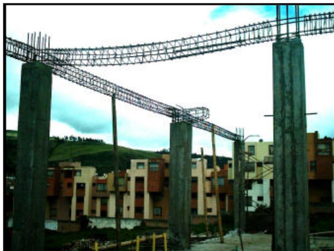
**Figura 81. REFUERZO ADICIONAL PARA VIGA CANAL**
