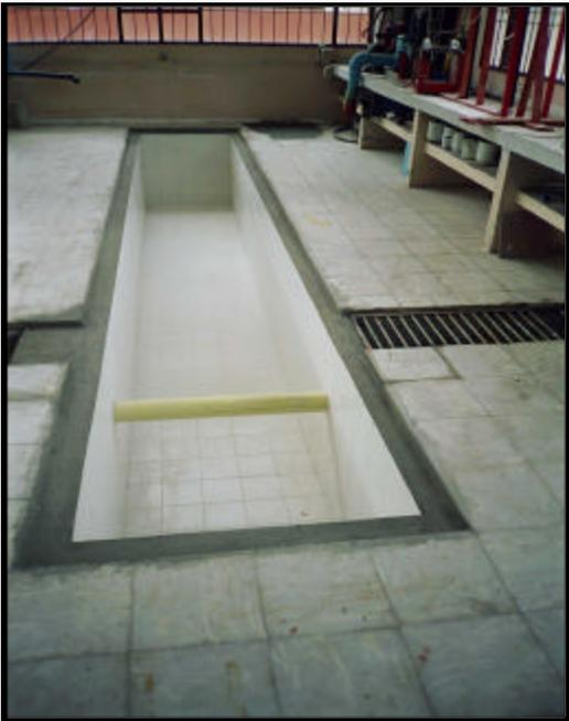
**FIG 6. TANQUE RESERVORIO SUBTERRÁNEO EN FUNCIONAMIENTO**
