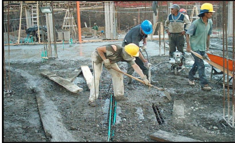
**Figura 108 . FUNDICION DE PLACA SUPERIOR E = 0.05 MT**
