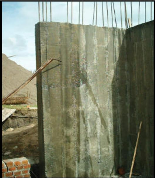
**Figura 51. CURADO DEL CONCRETO FORRADO CON PAPEL MOJADO**
