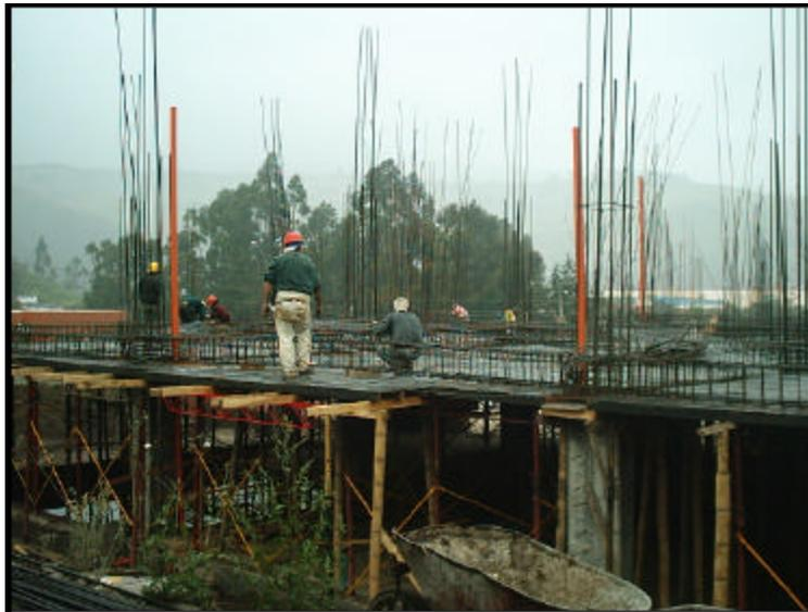
**Etapa II.** Consiste en la colocación de los tableros laterales a las vigas del contorno de la losa. Se realiza cuando está armado y chequeado la totalidad del refuerzo tanto de vigas como de nervios. Con esta formaleta se da la sección y forma definitiva a las vigas, para este proyecto se trabajaron vigas de sección  $0.40 * 0.40$  mt y la más grande de sobre el eje 2<sup>a</sup> de  $0.45 * 0.48$  mt.
