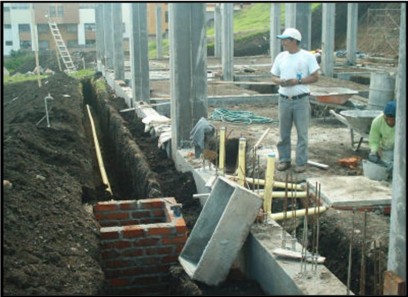
Cada caja se repelló internamente con mortero 1:4 y se le dio el acabado con cañuela, esmaltado y tapa en concreto reforzado con espesor de 0.08 m , la cual quedaba a nivel de la placa de piso.
