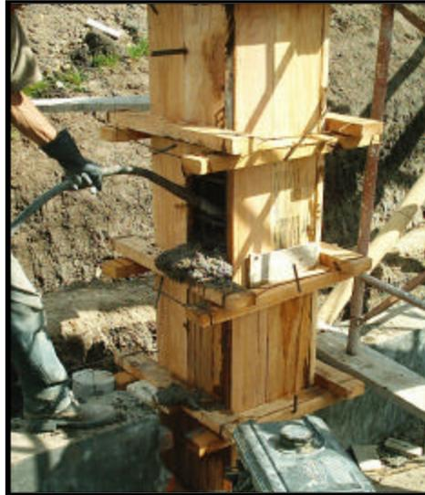
**2.2.3.3 Curado del concreto.** A las 24 horas de haber fundido las columnas, 48 en el caso de las pantallas, se retiraba la formaleta y se iniciaba el proceso de curado del concreto, para que el cemento se acabe de hidratar y vaya adquiriendo dureza a medida que pasan los días. El curado se realizaba hasta que el concreto cumpliera los 28 días, edad a la cual alcanza el 100 % de su resistencia.
