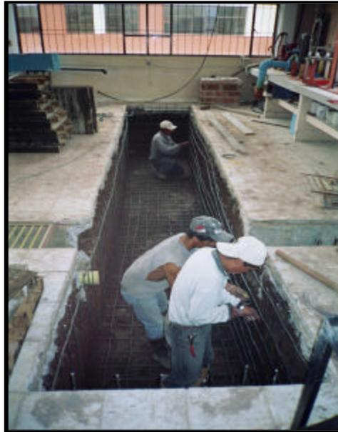
Así se da inicio a la colocación de la formaleta, para lo cual se alquilan tableros o camillas dando rendimiento al proceso, se chequea la verticalidad de la misma y el recubrimiento del refuerzo; de esta manera se procede a fundir las paredes del tanque con concreto en proporción 1 : 2 : 3, a medida que se vacía concreto se vibra con el objetivo de tratar de eliminar la mayor cantidad de aire atrapado y dar un mejor acomodo de los agregados dentro de la mezcla.
