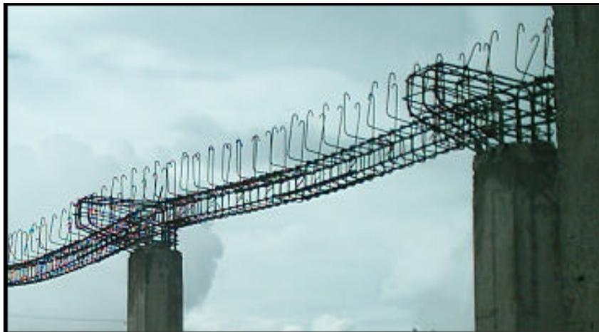
➤ **Encofrado.** Armadas las vigas aéreas, se alquila la formaleta que consiste en gatos, tijeras, cerchas y tableros. Se la empieza a armar en el bloque A que es por donde se va a arrancar la fundición.
