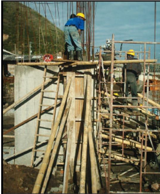
Para poder fundir , junto con la interventoría se chequeaba la verticalidad o plomo de la formaleta, lo cual se hacia por dos métodos diferentes: con la plomada y con las pesas, para lo cual se tomaban 2 medidas sobre un hilo vertical templado por las pesas, una medida arriba y otra abajo las cuales tenían que coincidir.
