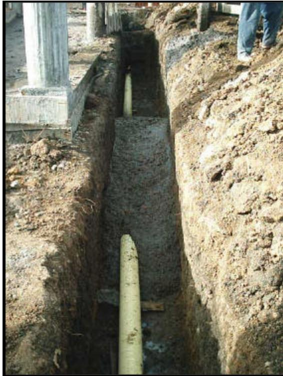
**2.2.6 Instalación hidrosanitaria.** En el diseño hidrosanitario se separan completamente el alcantarillado de aguas negras o sanitarias y el alcantarillado de aguas lluvias, cada uno con sus respectivas cajas de inspección, que al final llevan sus aguas a una cámara de inspección principal que está ubicada en el andén externo del lote, la cual corresponde al plan maestro de acueducto y alcantarillado de la ciudad
