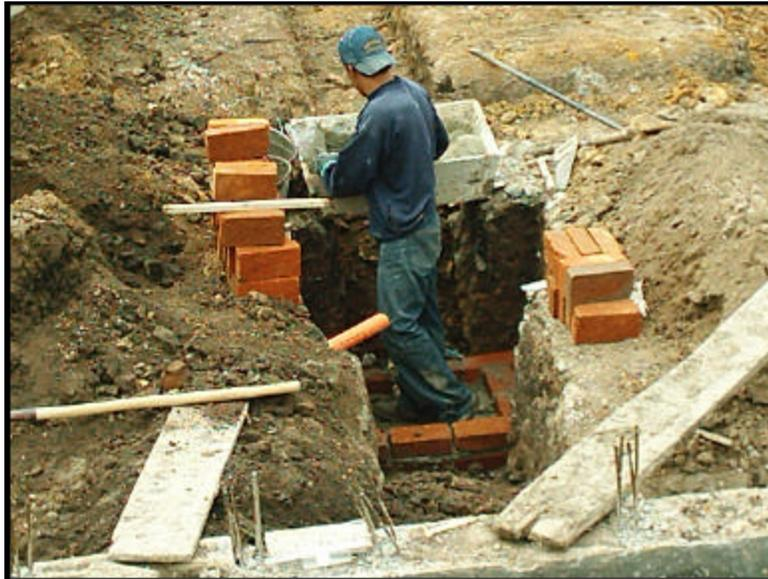
**Figura 66. INSTALACIÓN PUNTOS SANITARIOS - TALLERES**
