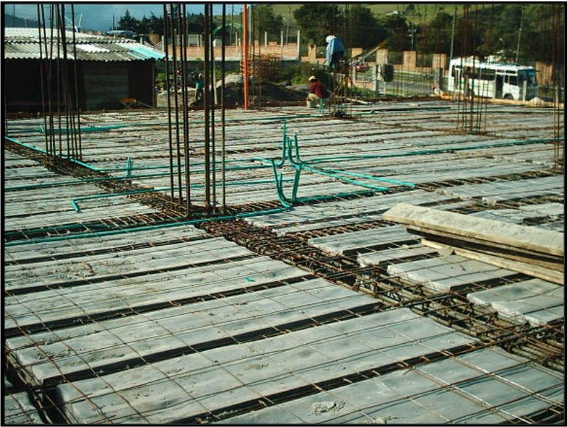
El concreto utilizado para la fundición de las vigas, nervios y placa superior, tiene dosificación 1 : 3 : 2.25, además del Plastiment TM – 10 a, contiene acelerante Plastocrete HE al 2.2 % del peso del cemento, que se decidió utilizar debido a un mejor resultado en la relación de costos con el alquiler de la formaleta que tiene que estar hasta los 22 días después de la fundición.
