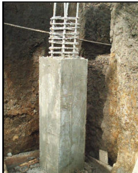
Una vez determinado el nivel de las vigas y los apoyos sobre los pedestales, se funde un solado de limpieza de 5 cm de espesor. La viga 9A, quedó sin suelo de apoyo, por lo que fue necesario armar y fundir un muro en concreto ciclópeo de 40 cm de espesor y altura promedio de 0.80 m, la cual iba decreciendo a medida que se alejaba del eje G y finalizaba en el eje I.
