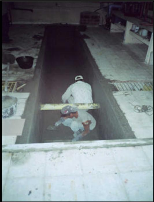
**Figura 5. ENCHAPE DE PAREDES INTERNAS TANQUE**
