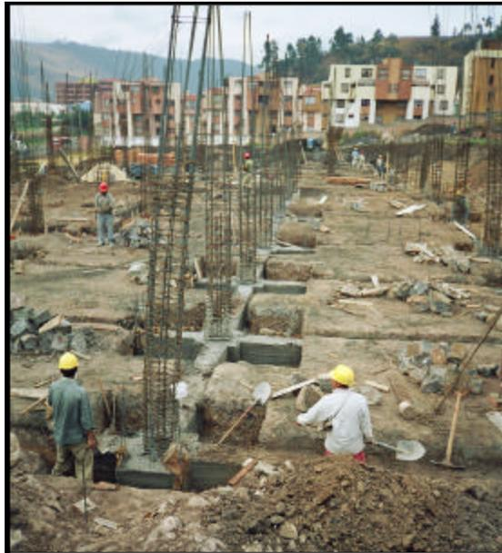
**Figura 43. DETALLE DE FLEJES DE COLUMNAS Y PANTALLAS**
