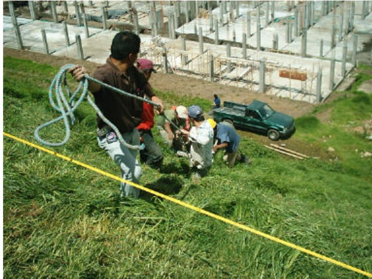
La alineación de los renglones superior e inferior del letrero, se realizó con nivel de precisión y mira, de igual manera se ubicó módulo por módulo con la misma inclinación, tratando de seguir al máximo la pendiente del talud, para que al final toda la letra quedara con igual pendiente.
