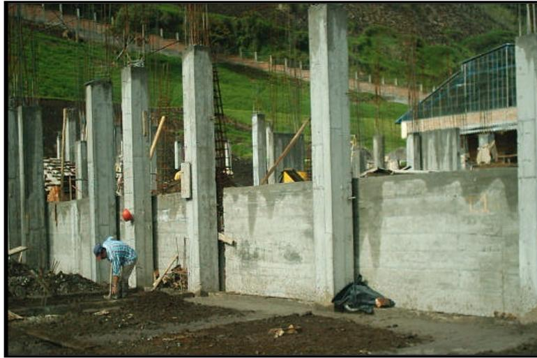
Cuando el muro de contención llega a una columna se corta su fundición, dejando una dilatación entre ellos de 0.04 mt, anclados entre sí por varillas de 5/8 " de 0.30 mt la cual está recubierta por un tubo liso. Esto con el fin de que tengan libertad de movimiento en caso de un sismo.
