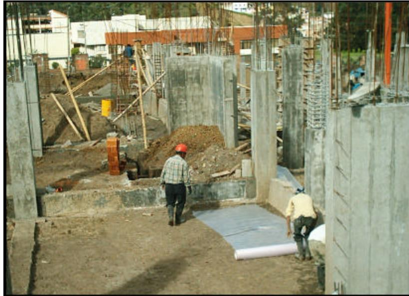
En el momento en que se acaba el polisecc existente en la obra, se hizo el pedido necesario para acabar el tendido en el resto del suelo nivelado, pero hubo escasez del material en la región por lo que se decidió continuar el tendido con casetex de color verde, por ser un material que tiene sus fibras muy seguidas y traslapadas entre sí que lo convierten en un elemento impermeable.
