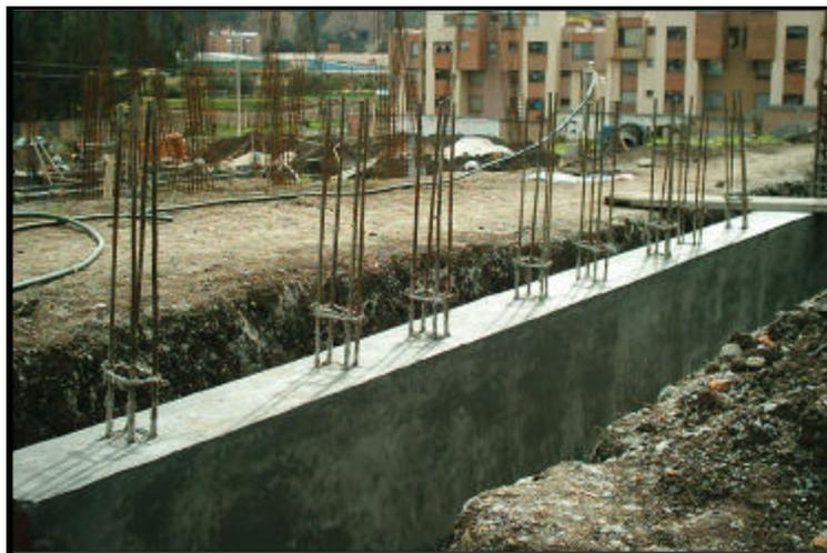
**2.2.3 Columnas.** En el momento en que llego a la obra, se encuentran levantados todos los castillos y armado el refuerzo de pantallas en el bloque 4 así como en Talleres, con todo el refuerzo longitudinal como transversal propios de cada una. Pero para poder empezar a encofrar era necesario revisar si el armado del refuerzo tanto longitudinal como transversal coincidía con el que estaba descrito en los planos estructurales.
