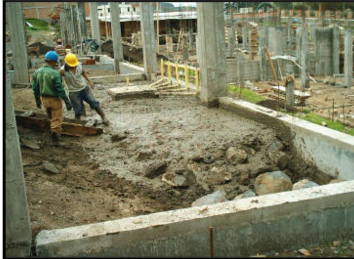
En bloque 4 se utilizó suelo cemento para rellenar las excavaciones de sobrecimiento, y para la conformación de las escaleras de las aulas de audiovisuales que arquitectónicamente están diseñadas con un nivel más bajo que el piso fino sobre la placa de piso.
