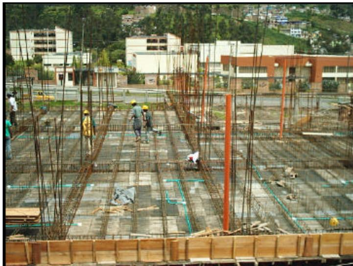
➤ **Instalación Eléctrica.** A medida que se completa el armado de nervios, se empieza a realizar la instalación de ductos para la instalación eléctrica. En primer lugar se instalan las cajas para las lámparas de del alumbrado del primer piso, siguiendo el orden de los circuitos y la posición de las mismas, especificado en el plano correspondiente.
