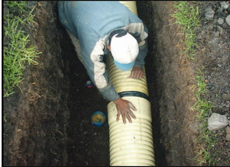
Una vez instalada la tubería, el paso a seguir es colocar en su sitio toda la tierra que se extrajo para tal objetivo , para esto es necesario ir compactando por capas de espesores pequeños con el compactador manual también llamado pizón, repitiendo el proceso hasta alcanzar el nivel original del terreno.
