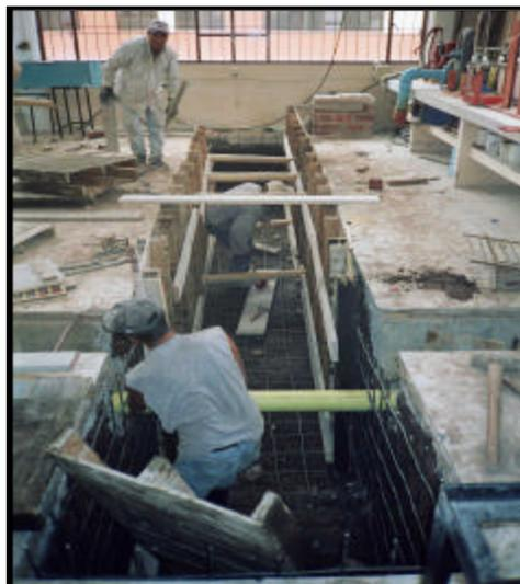
**Figura 3. LOSA DE PISO Y PAREDES FUNDIDAS**
