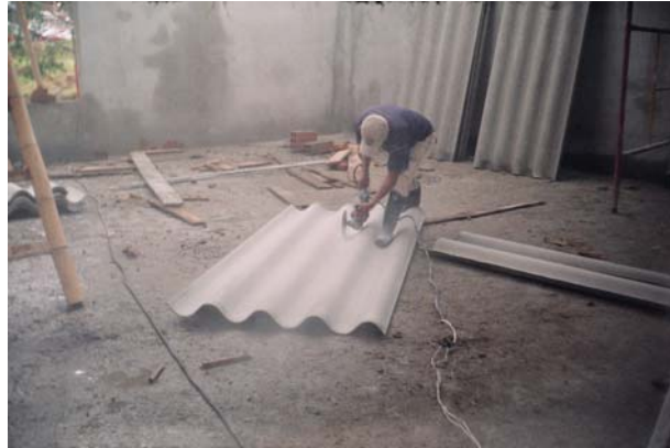
Figura 101. Corte de Teja con Disco
