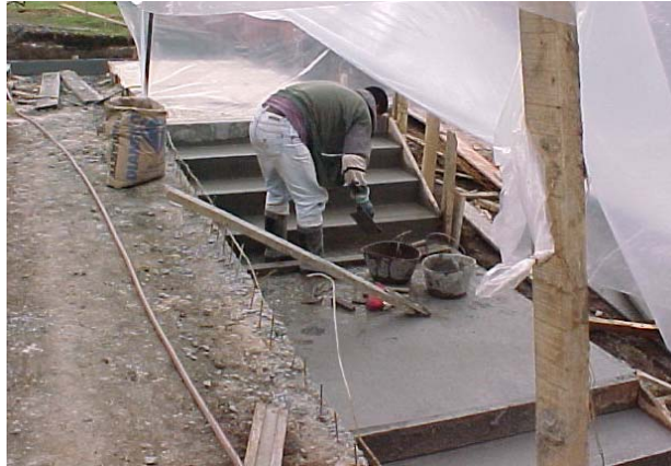
Figura 150. Escaleras sobre tierra
