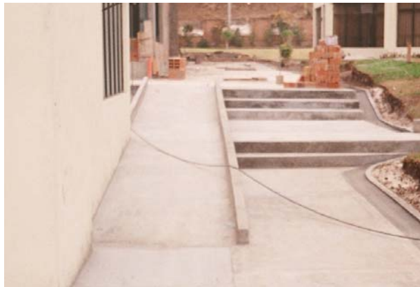
Figura 149. Rampa que comunica Derecho con la Unidad Médica
