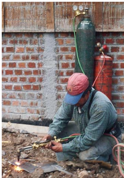
Figura 46. Realización de ganchos con Oxicorte
