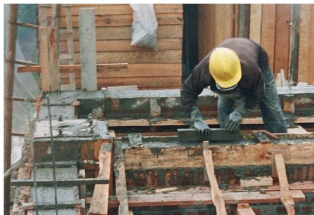
Figura 31. Fundición viga de amarre y dados de platina
