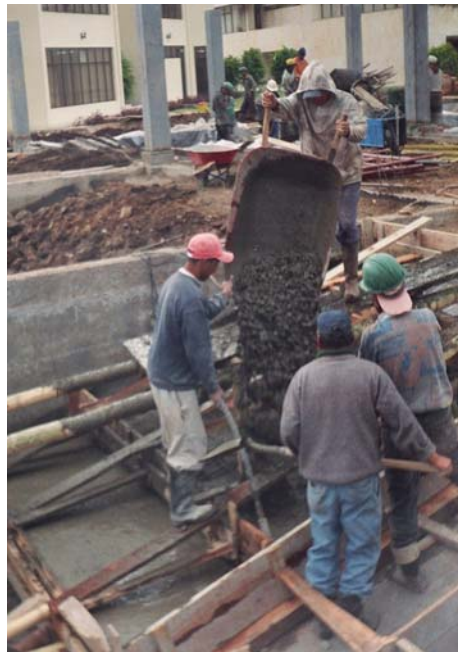
Figura 39. Fundición de escalones en torreones
