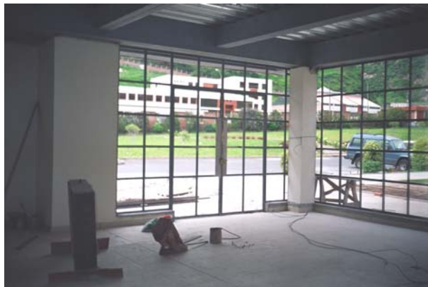
Figura 130. Puerta ventana totalmente instalada
