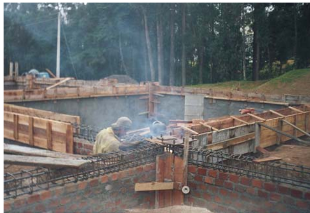
Figura 29. Soldadura definitiva de platinas
