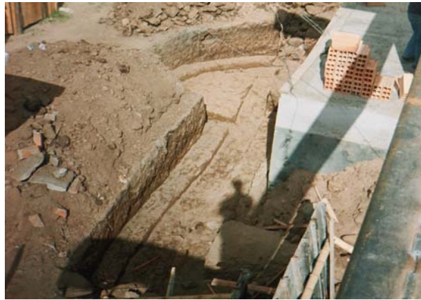
Figura 144. Excavación para base de muro de contención
