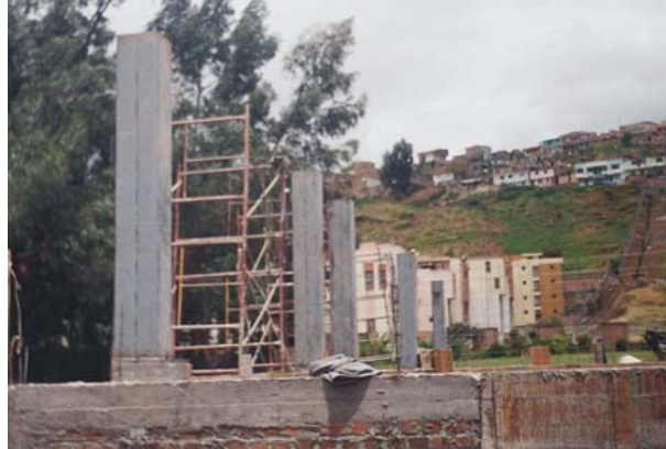
Figura 53. Alineamiento de Columnas metálicas
