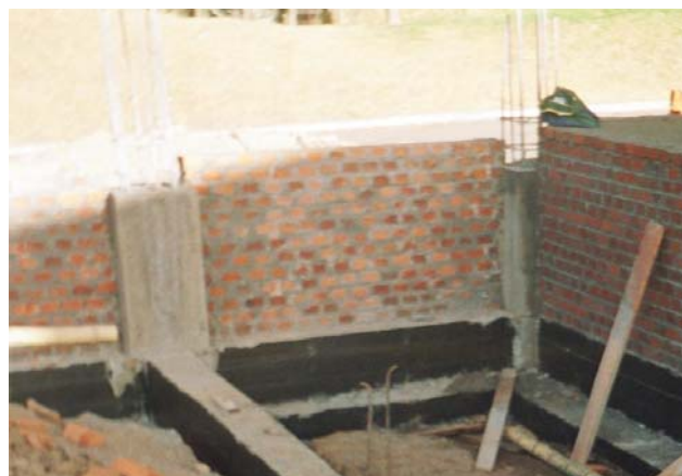
Figura 24. Pedestales y muro en tizón
