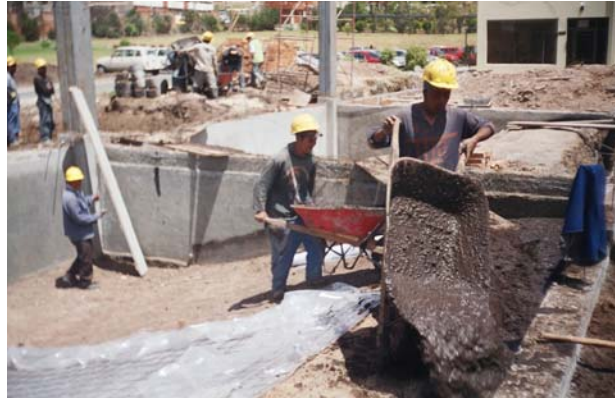
Figura 34. Relleno con suelo cemento
