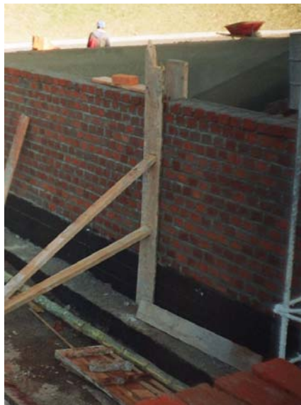
Figura 20. Encofrado para fundición de cintas de amarre
