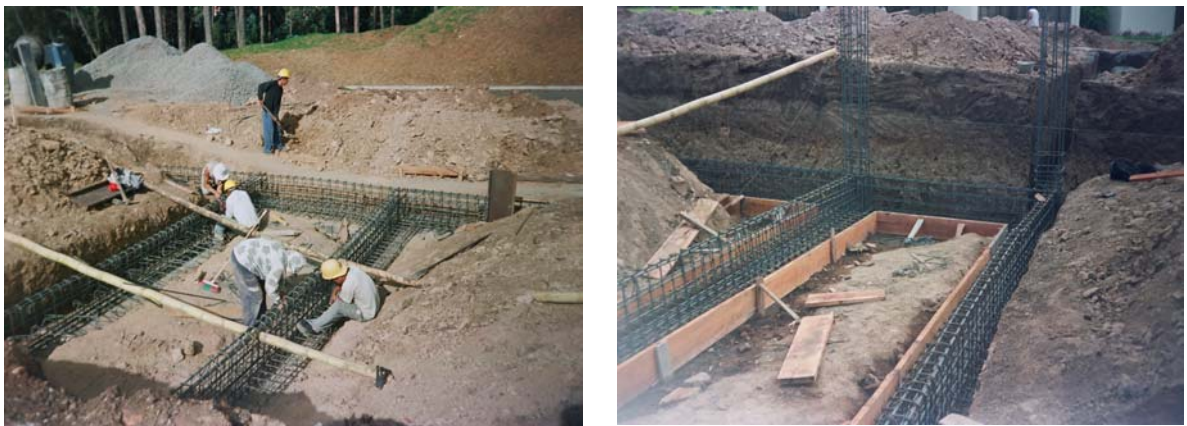
Figura 13. Armado y encofrado de viga tee invertida
