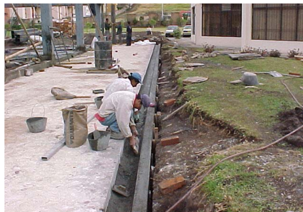
Figura 137. Fundición y esmalte de cañuela
