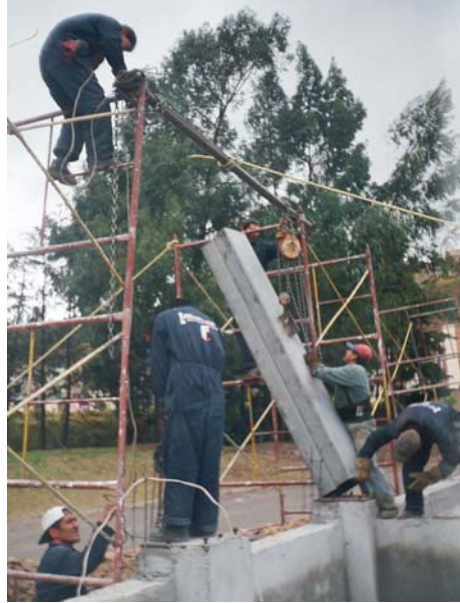
Figura 51. Instalación columna metálica primer piso
