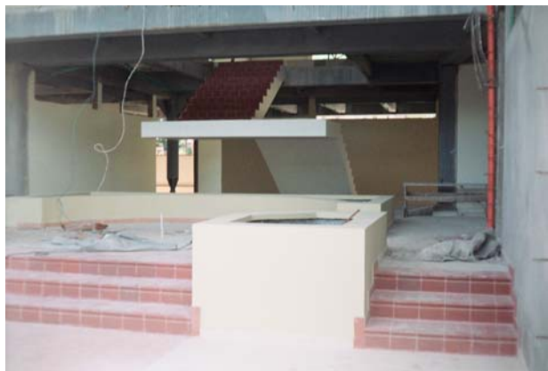
Figura 162. Enchape de escaleras internas sobre tierra
