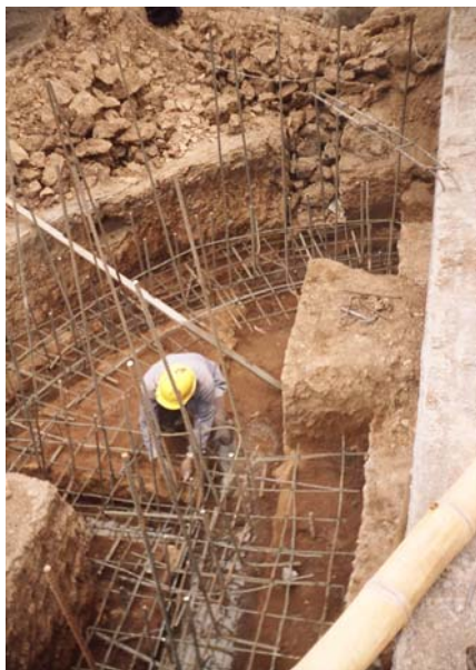
Figura 146. Armado de muro de contención
