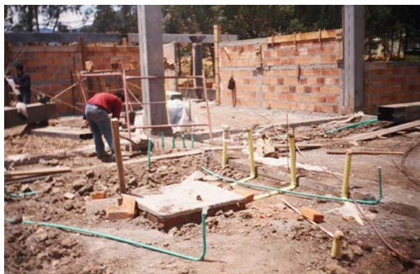
Figura 108. Instalaciones sanitarias primer piso
