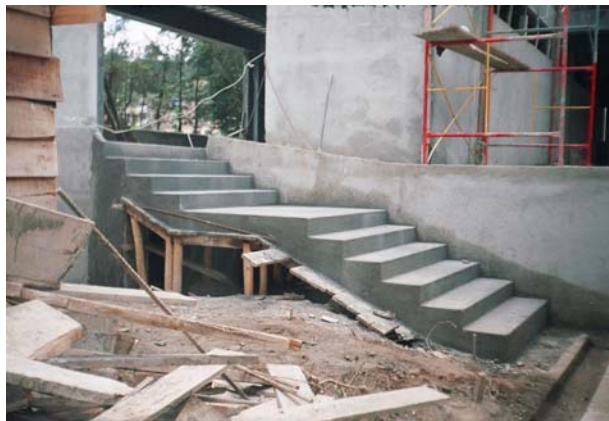
Figura 153. Terminado de escaleras de acceso a auditorio
