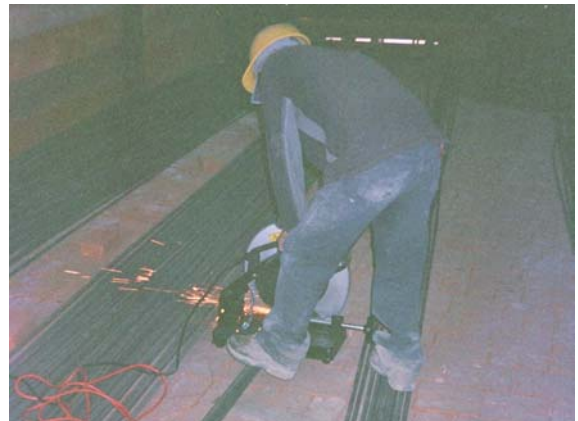
Figura 12. Corte de hierro con cizalla y cortadora eléctrica
