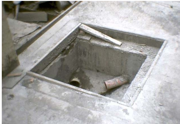
Figura 112. Caja de inspección con cañuela y esmaltada interiormente
