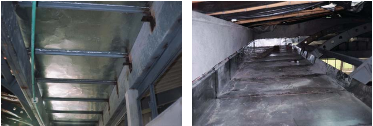
Figura 92. Lámina canal del Domo
