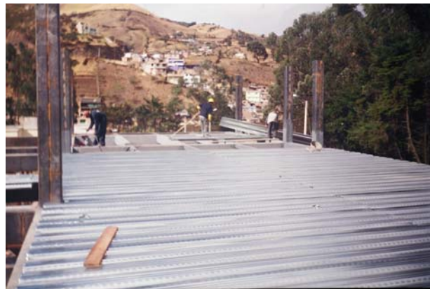
Figura 64. Distribución de lámina metálica Metaldeck
