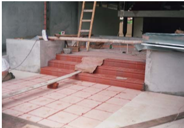
Figura 158. Emboquillado de cerámica
