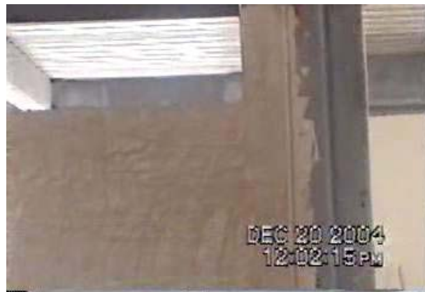
Figura 154. Estuco de muros internos
