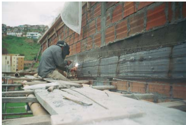
Figura 120. Instalación de malla con vena
