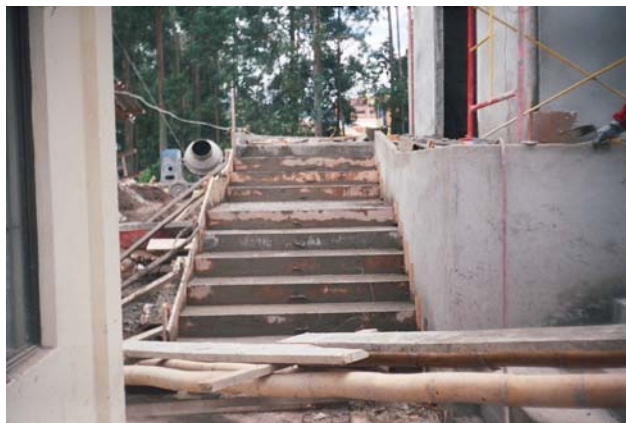
Figura 152. Encofrado y fundición de escaleras reforzadas
