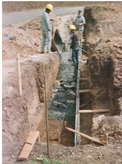
Figura 10. Concreto ciclópeo y solado de limpieza (formaleta metálica)
