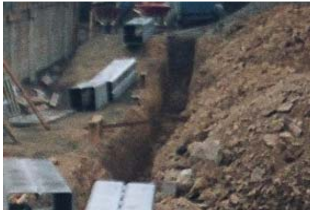
Figura 107. Excavación para instalación de tubería de desagüe
