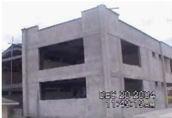
Figura 119. Repello externo de muros
