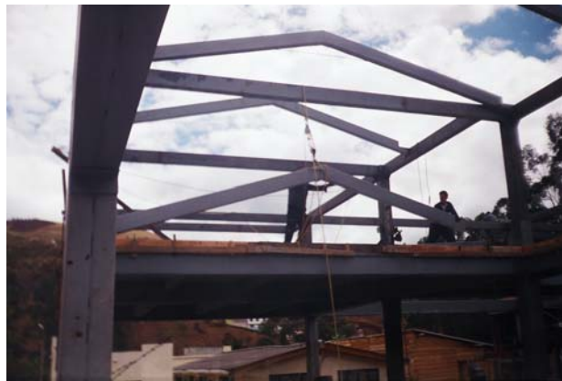
Figura 83. Proceso de izaje de vigas cerchas
