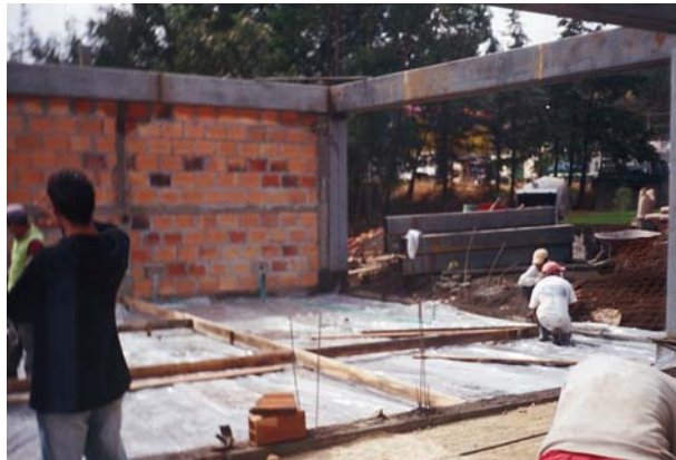
Figura 40. Polisecc y separadores de paños para fundición de piso
