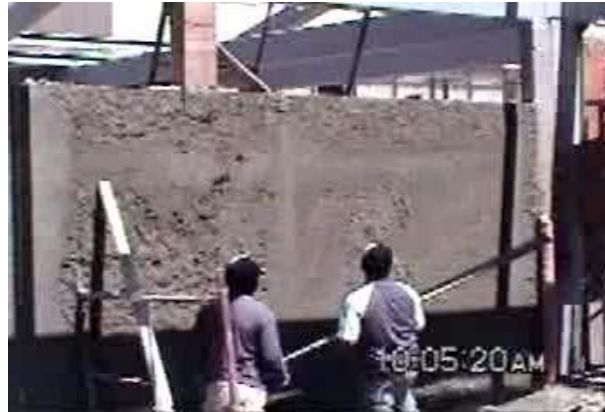
Figura 123. Pañete interno de muros. Definición de maestras
