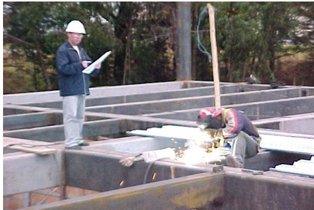
Figura 60. Soldadura de viguetas de entrepiso
