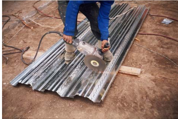
Figura 63. Corte de Lámina Metaldeck
