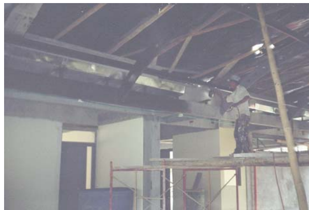
Figura 165. Pintura de cerchas de Domo
