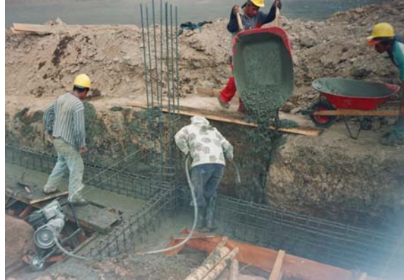
Figura 14. Fundición aletas viga tee invertida
