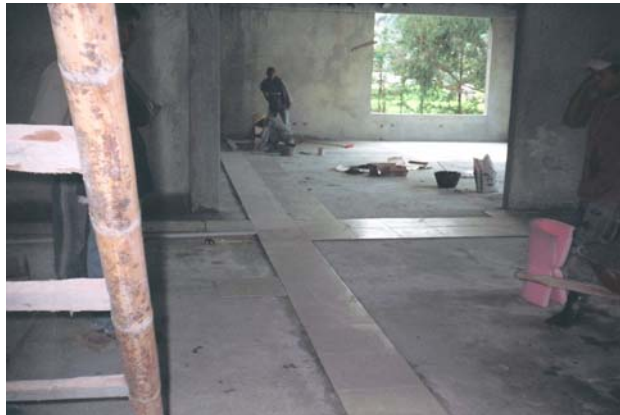
Figura 156. Iniciación de enchape de piso
