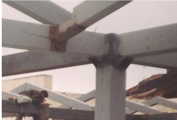
Figura 84. Fijación vigas cerchas
