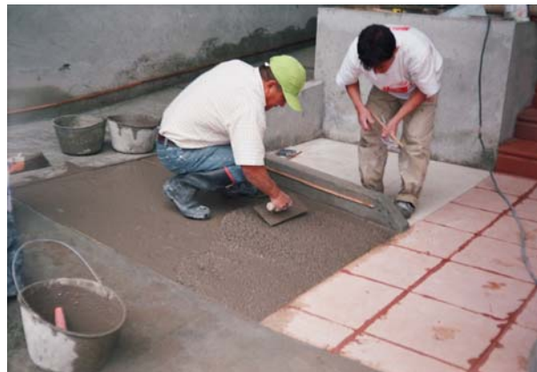
Figura 166. Instalación gravilla lavada en rampa interna
