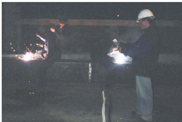
Figura 79. Soldadura de vigas metálicas. Trabajo nocturno
