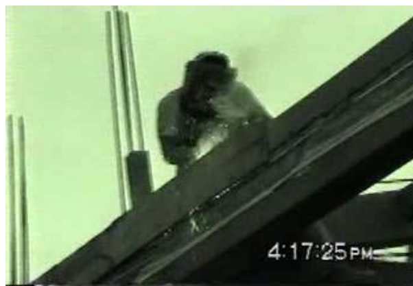
Figura 96. Soldadura de refuerzo de vigueta y columnetas para parapetos
