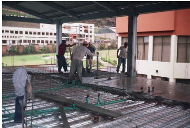
Figura 71. Fundición de losa con Metaldeck en ampliación
