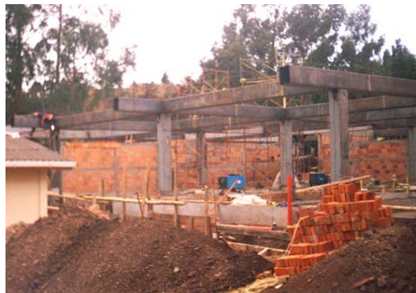
Figura 59. Vigas y columnas metálicas del primer piso
