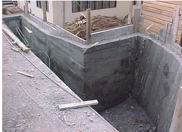
Figura 147. Muro en voladizo
