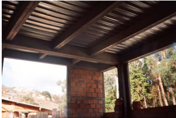
Figura 62. Instalación Lámina Metaldeck sin apuntalamiento
