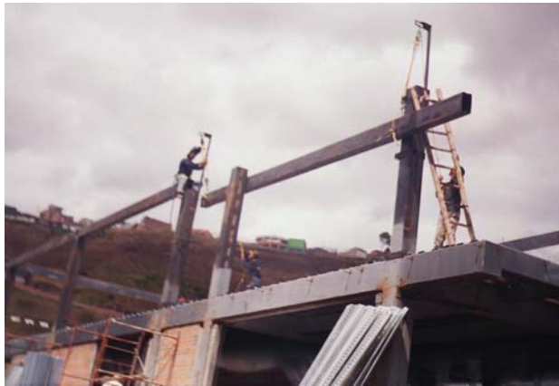
Figura 80. Instalación de vigas metálicas de coronamiento
