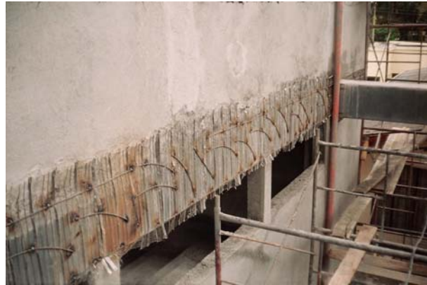
Figura 125. Instalación malla con vena sobre viga metálica interna
