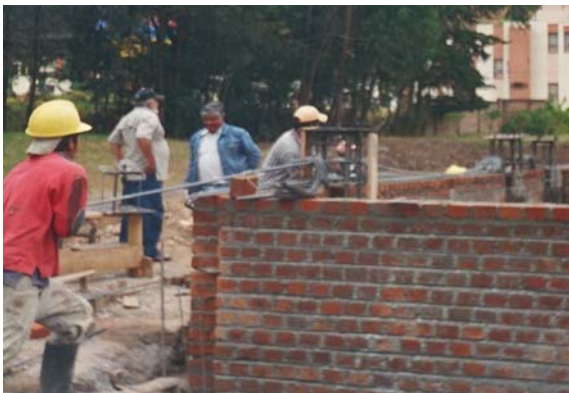
Figura 25. Armado de la viga de amarre
