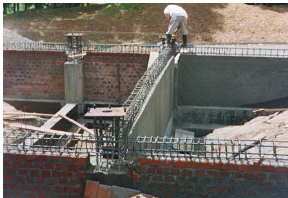
Figura 28. Instalación preliminar de platinas
