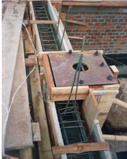
Figura 30. Encofrado de platinas metálicas
