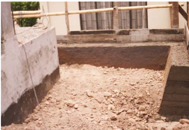
Figura 143. Muro de gravedad
