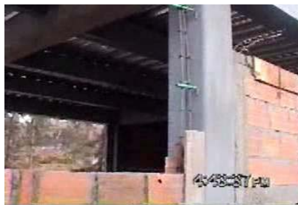
Figura 95. Sistema combinado en juntas de dilatación
