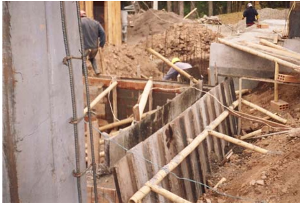
Figura 142. Encofrado con formaleta metálica
