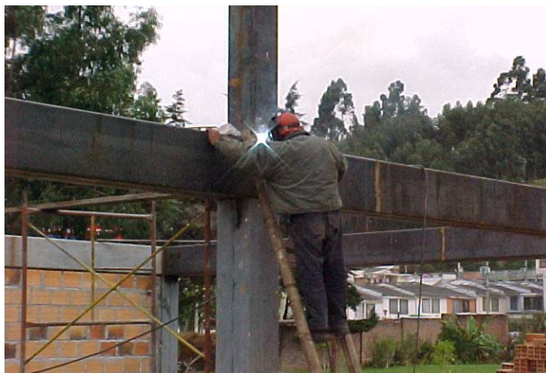
Figura 78. Soldadura de columnas metálicas
