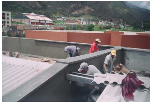
Figura 122. Repello interno de parapetos y tímpanos
