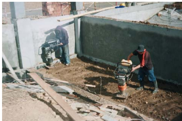
Figura 33. Relleno compactado con saltarín
