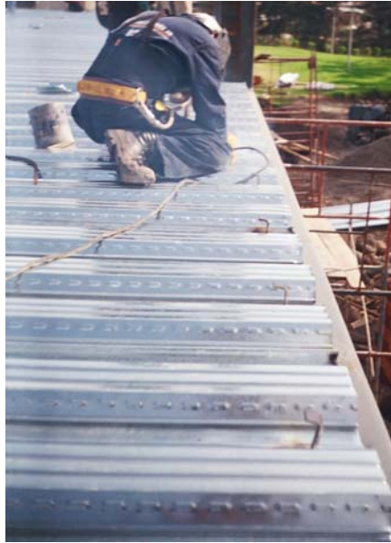
Figura 65. Instalación conectores de cortante
