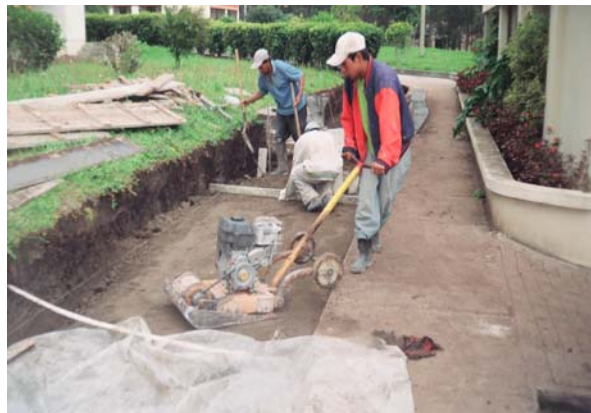
Figura 135. Mejoramiento con suelo-cemento seco y uso de saltarín
