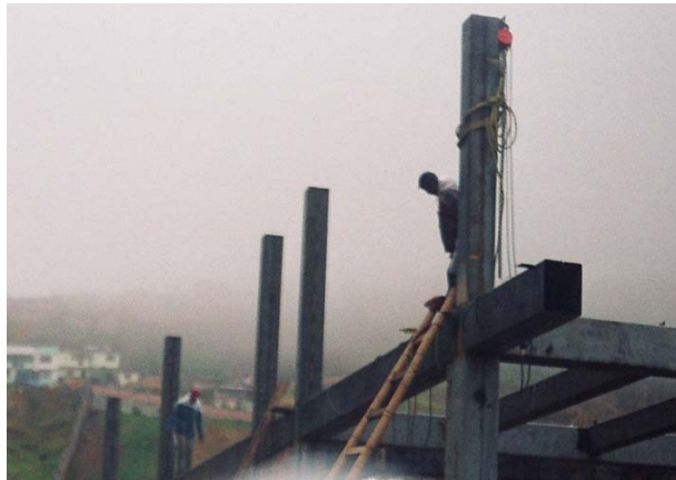
Figura 77. Alineación de columnas
