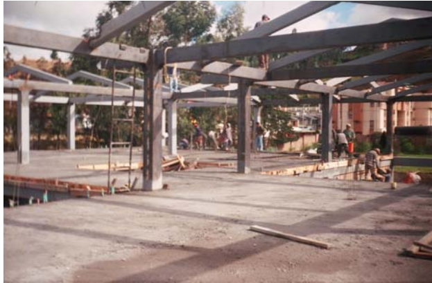
Figura 69. Losa de entrepiso fundida completamente
