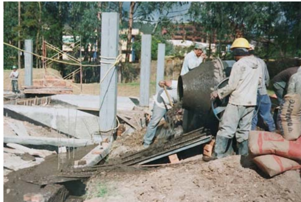
Figura 35. Relleno con suelo cemento canalizado
