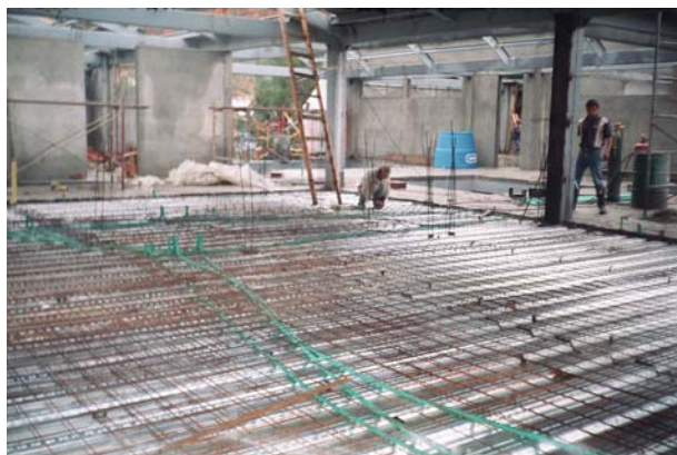
Figura 70. Instalación Lámina Metaldeck en ampliación
