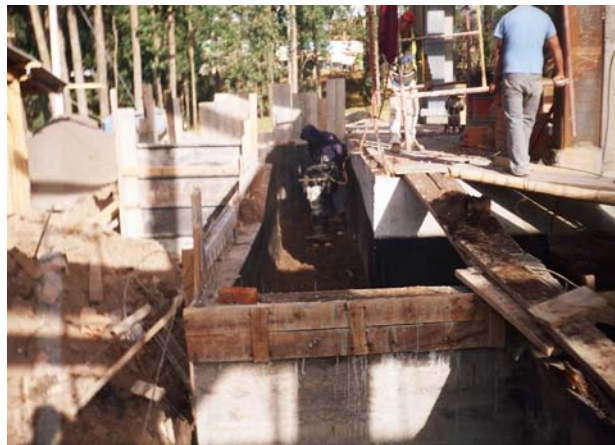
Figura 148. Relleno compactado con saltarín
