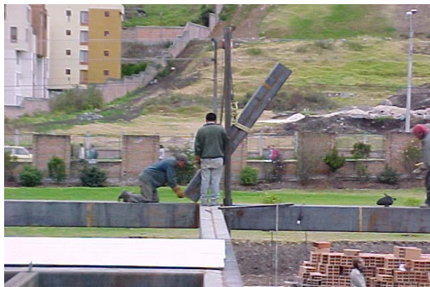
Figura 76. Columnas del Segundo Piso
