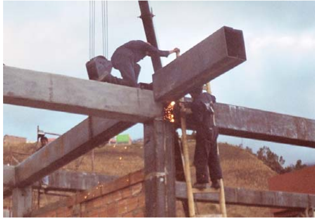
Figura 58. Utilización de oxicorte para la ubicación de una viga metálica
