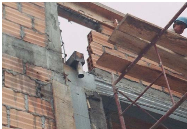
Figura 89. Prolongación de la canaleta con sección reducida
