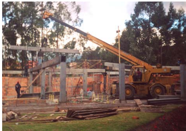
Figura 57. Grúa GROVE transportando una viga metálica
