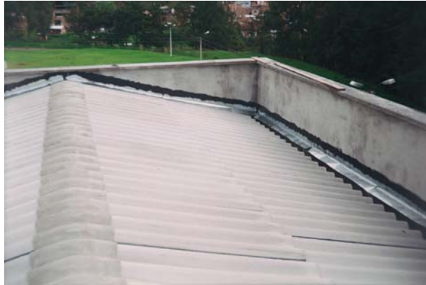
Figura 103 Lámina zinc y aplicación de Igasol Cubierta
