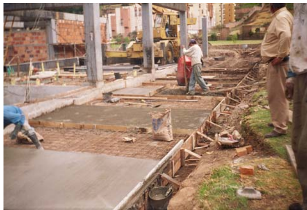
Figura 136. Fundición y acabados de andén
