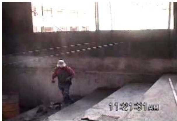
Figura 126. Hilos de nivel guía para pisos
