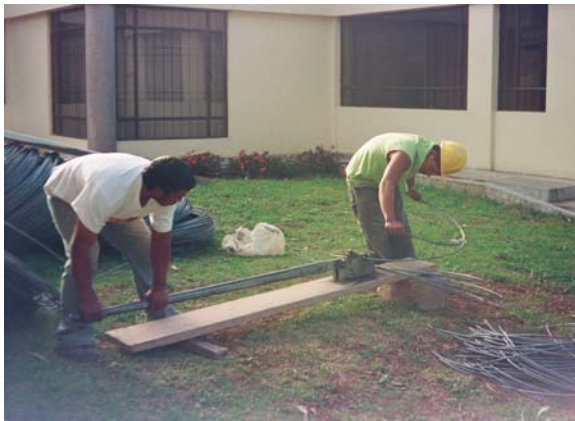
Figura 12. Corte de hierro con cizalla y cortadora eléctrica
