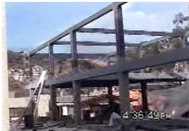
Figura 81. Vigas metálicas de coronamiento
