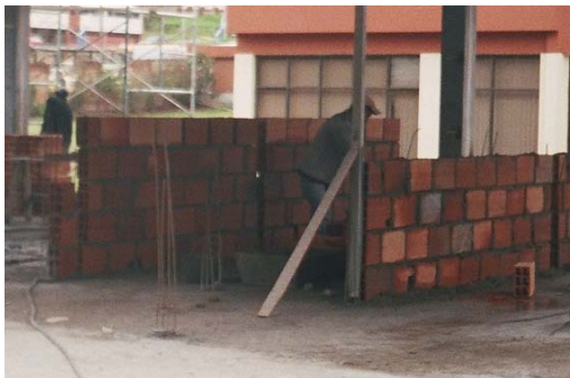
Figura 93. Pega de muros en Sala de Audiencias
