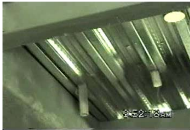
Figura 109. Instalación puntos sanitarios segundo piso
