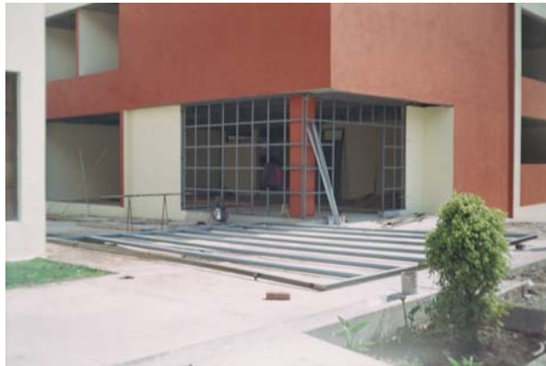
Figura 129. Armado de puerta ventana y ventanal en obra
