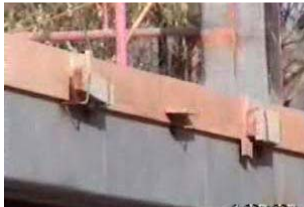
Figura 67. Encofrado lateral
