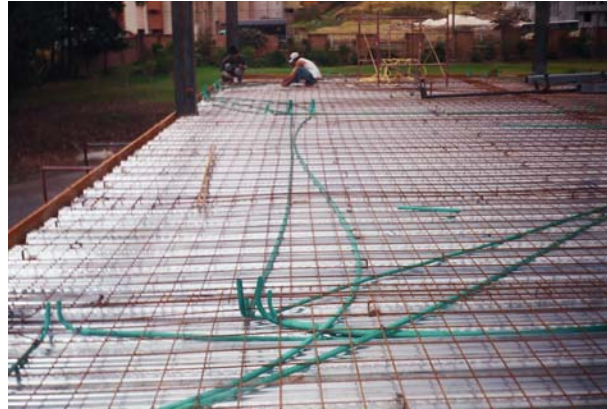
Figura 116. Ductería eléctrica en losa de entrepiso
