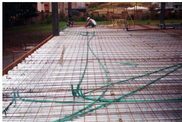
Figura 66. Instalación malla electro-soldada y tubería eléctrica
