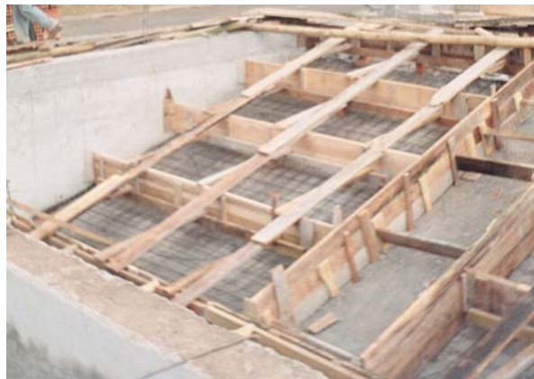
Figura 38. Instalación malla electro-soldada y formaleta en torreones
