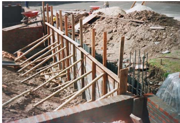
Figura 21. Encofrado de pantalla y pedestales en tramo G-2-5
