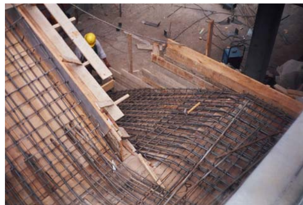
Figura 73. Armado de Escalera Autoportante
