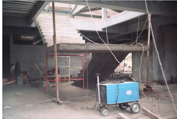
Figura 75. Escaleras Autoportantes. Chequeo de flecha
