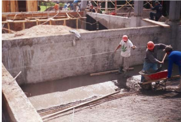
Figura 37. Fundición descanso inferior torreón
