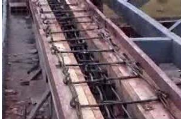
Figura 98. Armado y encofrado de viga de amarre y alfajía doble
