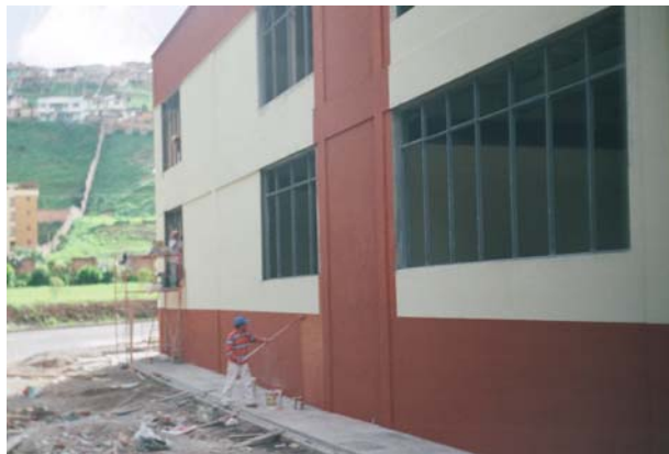
Figura 131. Instalación de ventanas y pintura externa
