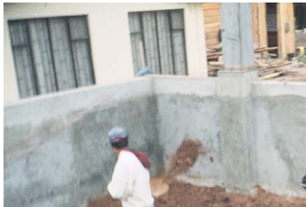
Figura 32. Muro esmaltado hasta nivel de relleno
