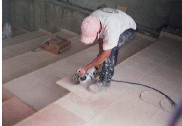
Figura 159. Corte de cerámica con pulidora
