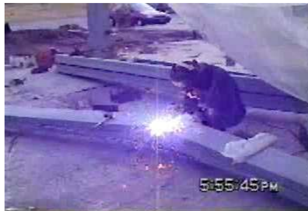
Figura 82. Producción de vigas cerchas en Obra
