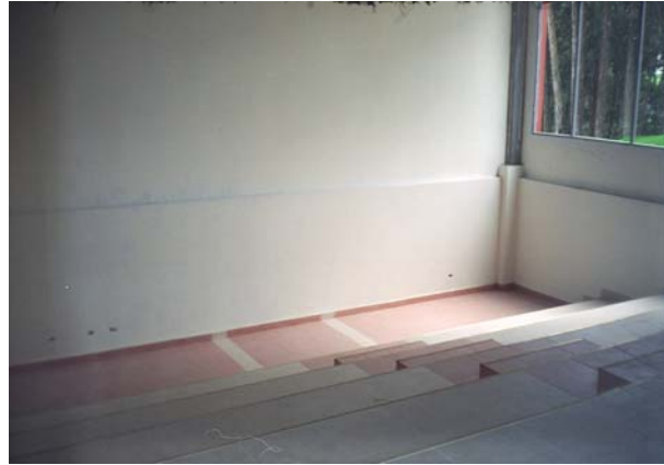
Figura 163. Pintura interna de muros en torreones
