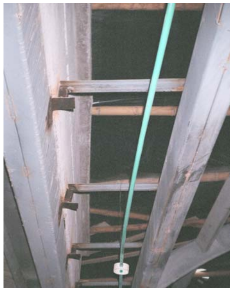
Figura 91. Estructura para lámina canal del domo
