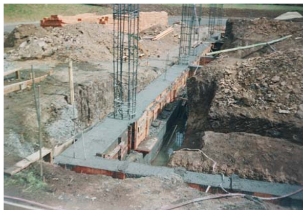
Figura 15. Fundición vástago de viga tee Invertida
