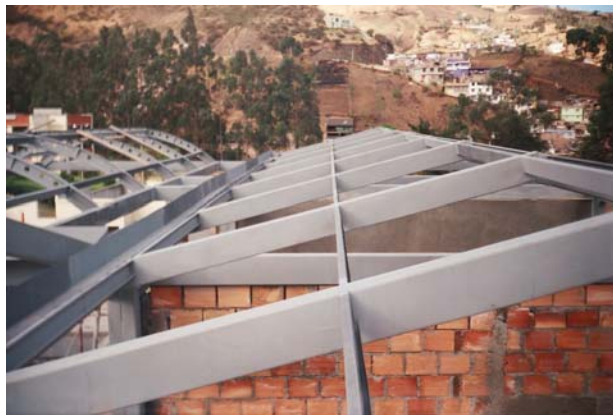
Figura 85. Instalación correas metálicas
