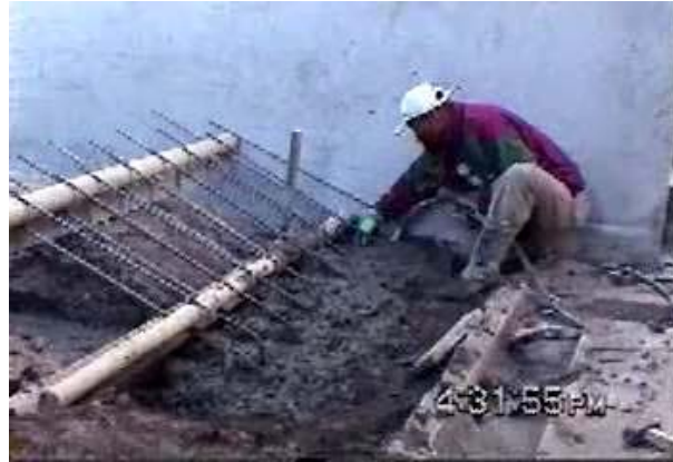
Figura 151. Fundición viga de piso
