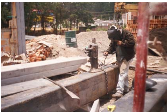
Figura 56. Soldadora con electrodo y la utilización de un gato mecánico
