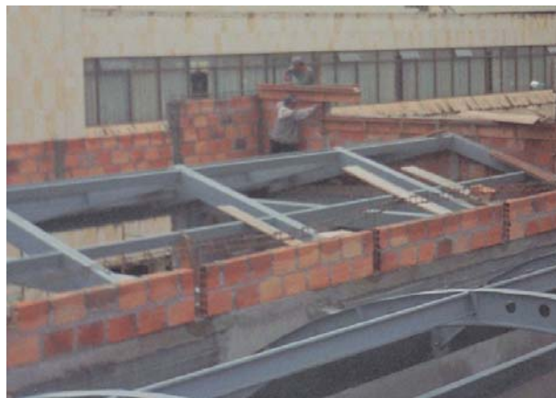
Figura 97. Pega de muro farol en parapetos
