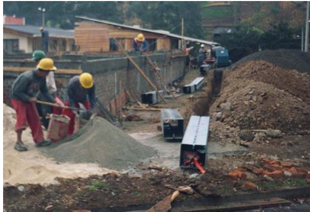
Figura 49. Ubicación de las columnas en obra
