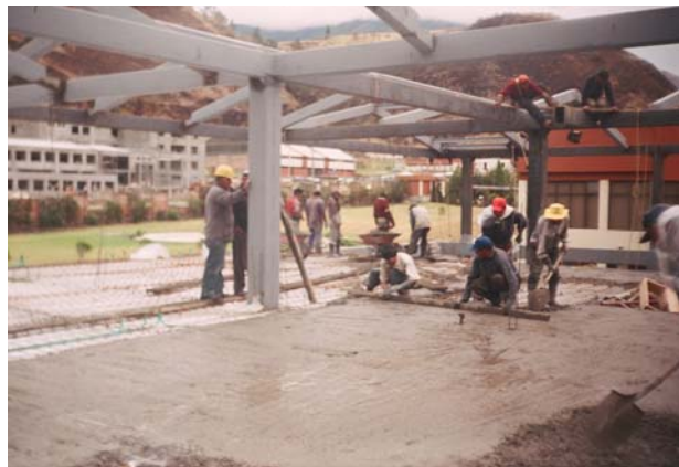
Figura 68. Fundición losa de entrepiso
