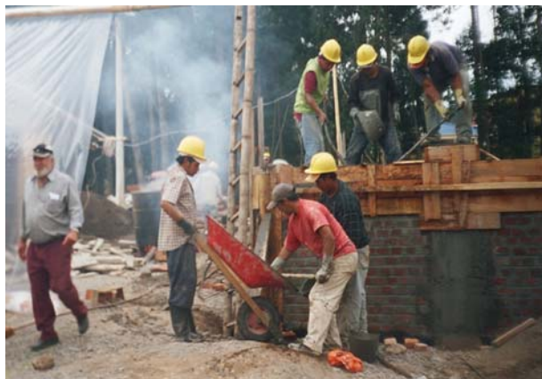
Figura 27. Fundición Viga de Amarre.
