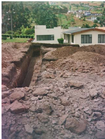
Figura 9. Excavación a mano para cimentaciones
