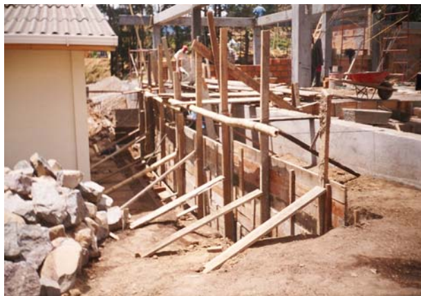
Figura 141. Formaleta de muro a gravedad
