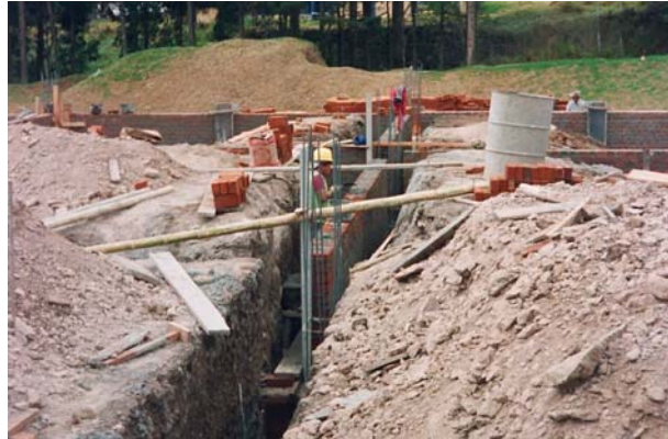
Figura 19. Pega de muro en tizón
