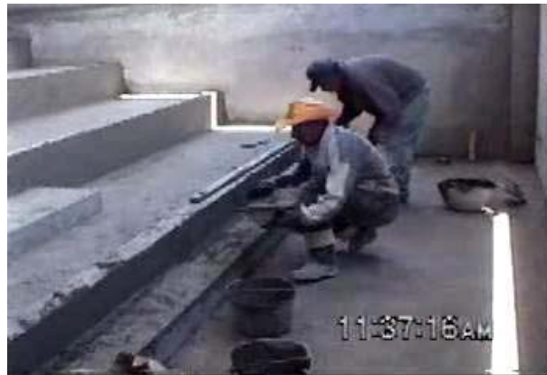
Figura 127. Pañete de escalones en torreón
