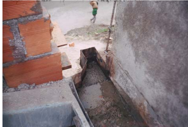
Figura 90. Sosco metálico soldado a la canaleta
