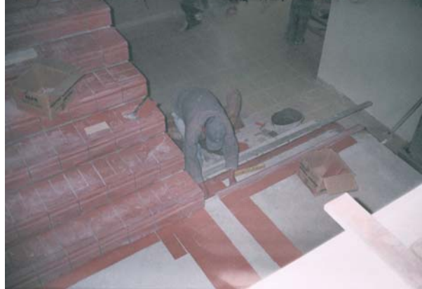
Figura 161. Enchape de escaleras autoportantes
