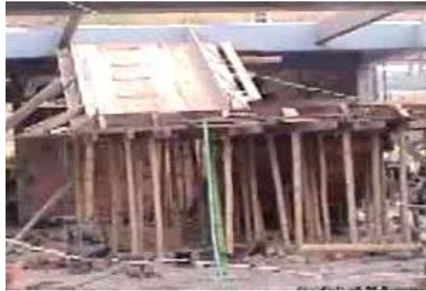
Figura 72. Formaleta de escaleras autoportantes
