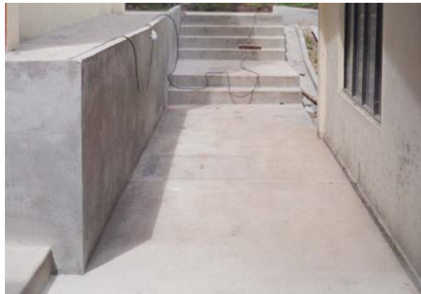
Figura 138. Anden Sin cañuela Terminado
