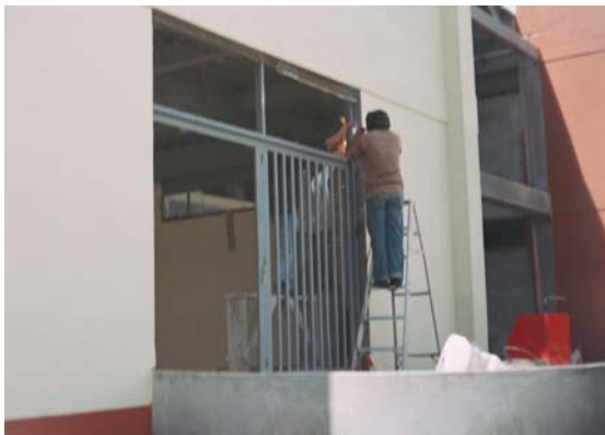
Figura 132. Instalación de puertas articuladas en Biblioteca y Auditorio
