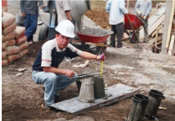
Figura 16. Prueba de Slump
