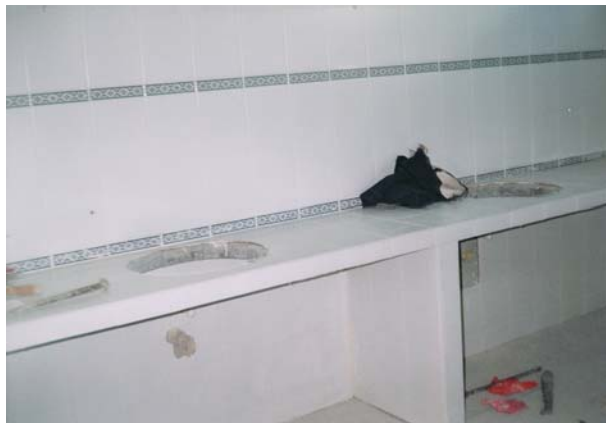
Figura 160. Enchape de muros en baños
