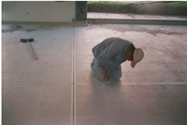
Figura 157. Sellado de juntas de dilatación de cerámica
