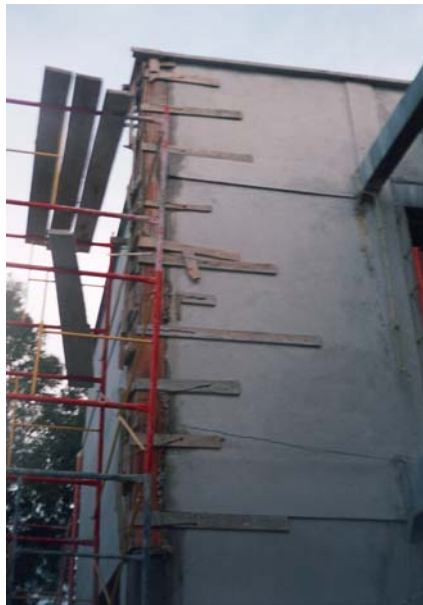
Figura 114. Fundición de bajante de aguas lluvias
