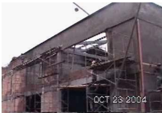
Figura 121. Pañete externo de muros y estructura metálica
