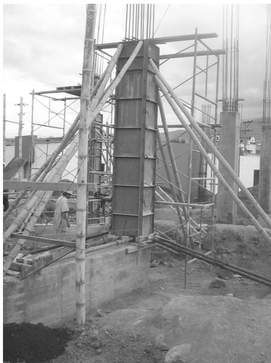
Figura 29. Encofrado de Columnas, Pantallas y Elementos de Borde
