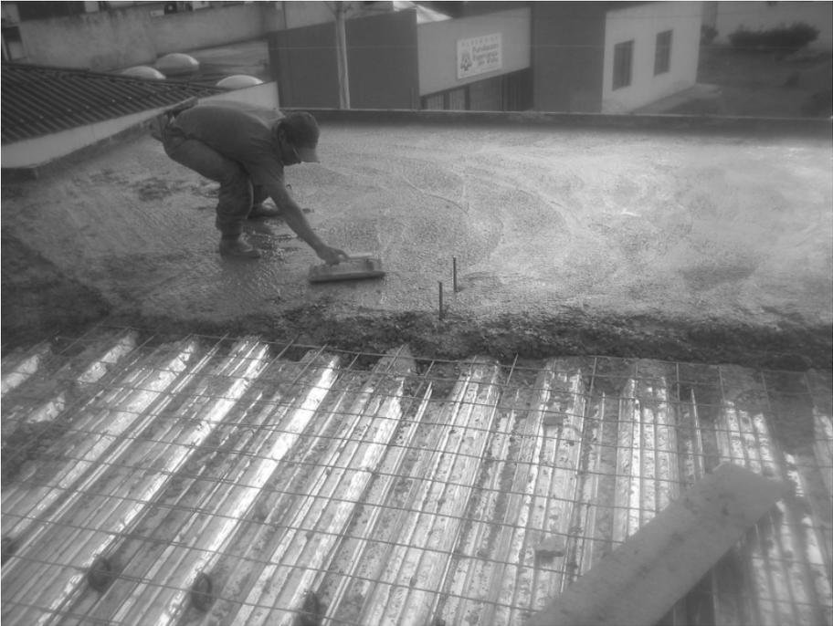
En este punto se podría decir que termina el primer ciclo de construcción de la estructura de una edificación; ya fundida la losa de entrepiso se prosigue nuevamente con el armado de refuerzos de columnas y de ahí en adelante, teniendo presente ciertas variaciones debidas al incremento de la altura de trabajo, el proyecto y su configuración.
