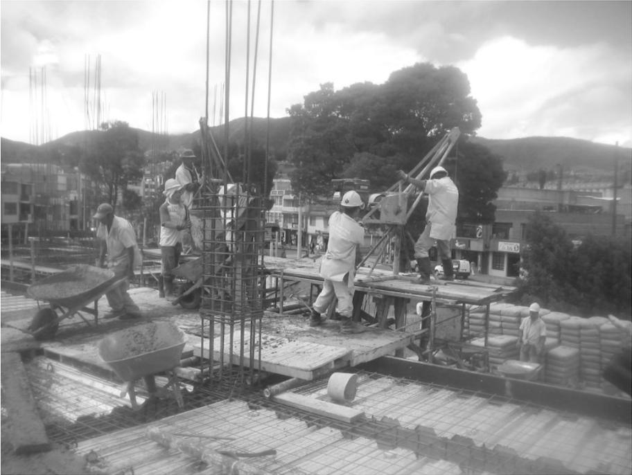
Figura 45. Losa de Entrepiso, en Proceso de Terminación
