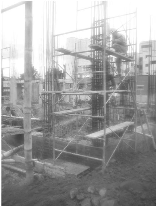
Figura 28. Encofrado de Columnas
