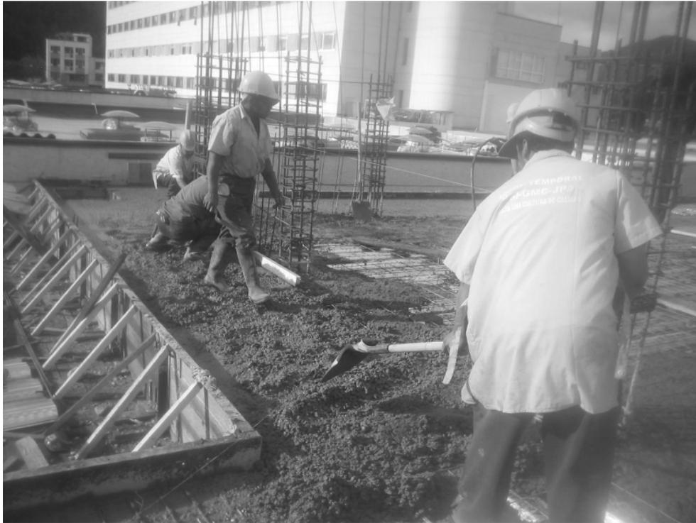
Figura 44. Fundición de Losa de Entrepiso, Colocación del concreto
