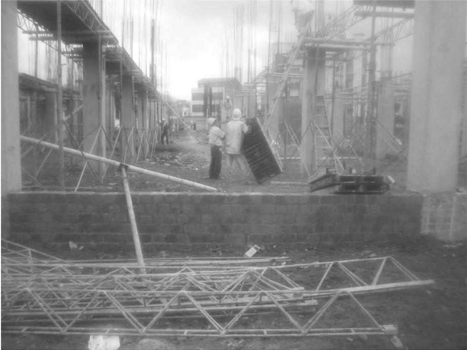
Figura 37. Tableros de piso y refuerzo de vigas N+3.52 Zona C
