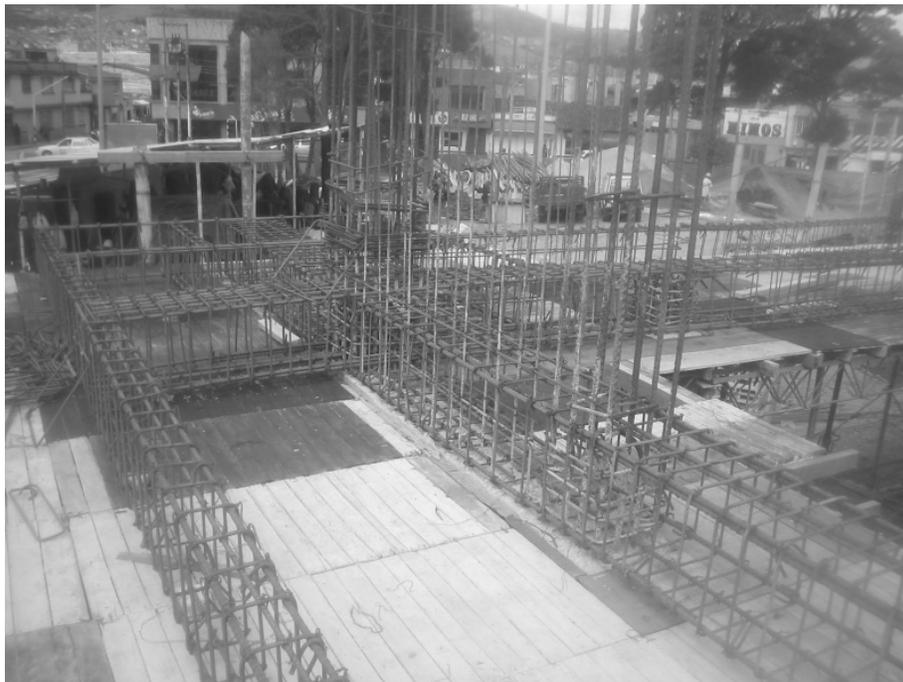
Figura 39. Encofrado y Refuerzo de Vigas N+ 3.52 Zona A
