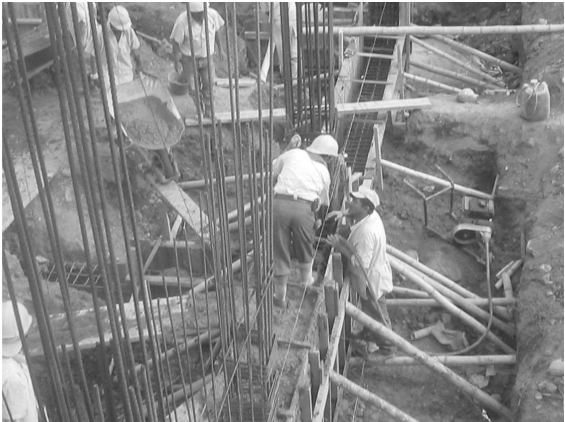
Figura 26. (2) Fundición de Vigas de Piso
