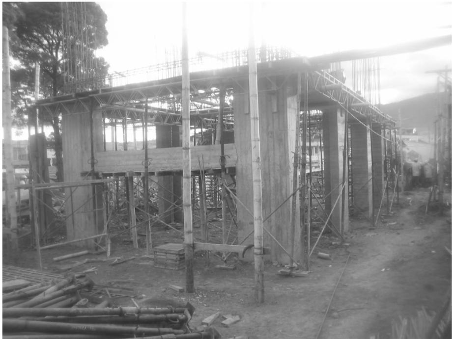
Figura 38. Refuerzo de Vigas N+3.52 Zona A
