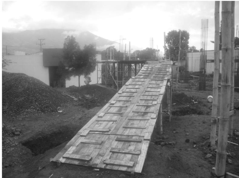
Fig. 48 Rampa para producción de concreto, abastecimiento de materiales
