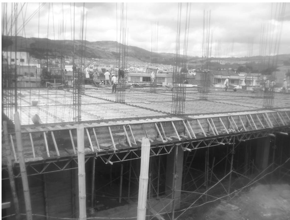
Figura 40. Lámina Colaborante Instalada
