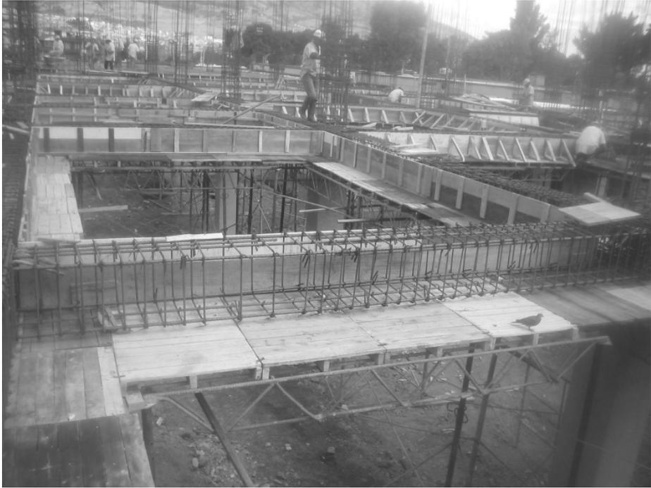
Figura 41. Conectores de Cortante y Malla Electro-Soldada
