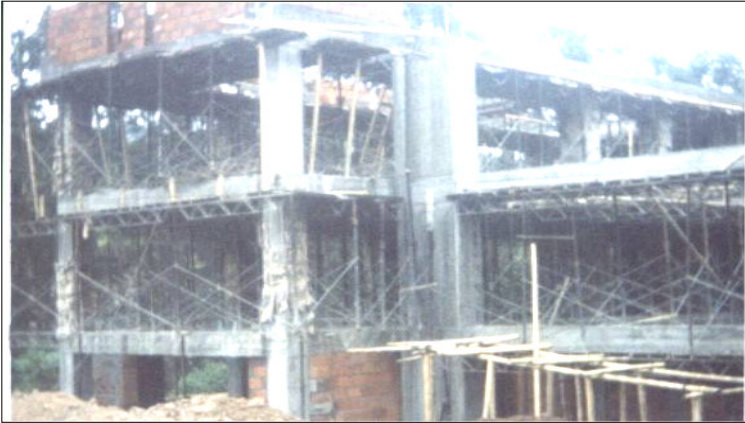
Figura 98. Conformación de vigas canal y formaleta n+6.32.
