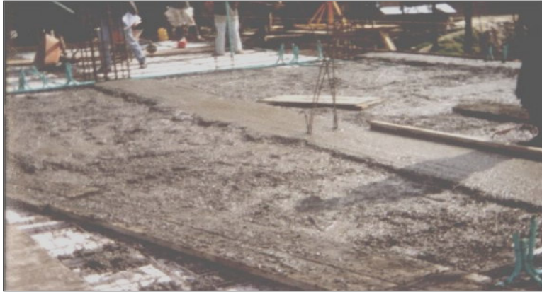
Figura 90. Toma de niveles para espesores de solados.
