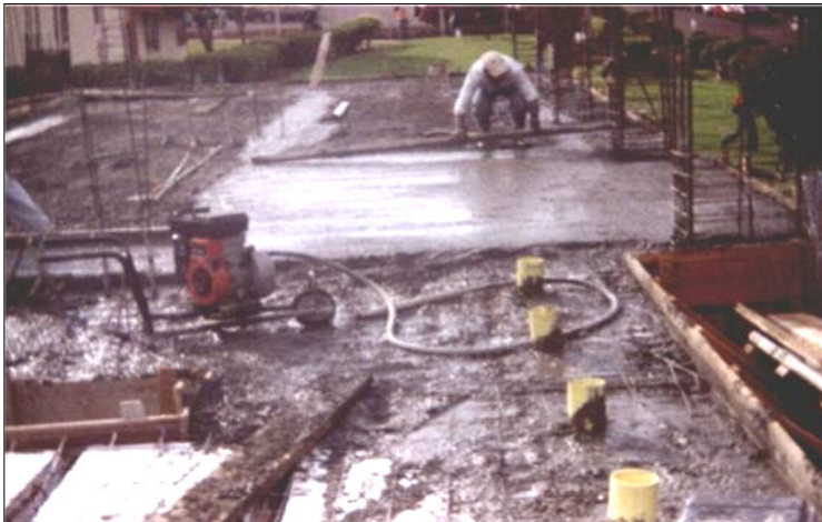
Figura 84. Fundición nervios, instalaciones sanitarias.
