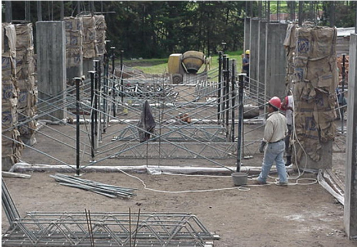
Figura 67. Inicio colocación de tacos, diagonales y nivelación.
