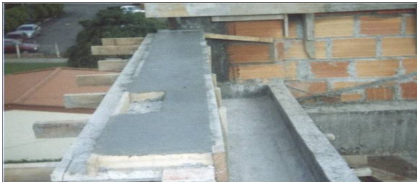
Figura 121. Alfajías terminadas y esmaltadas.
