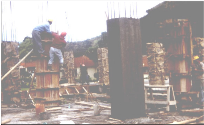
Figura 43. Apuntalamiento, chequeo de plomos y realización de ventana.
