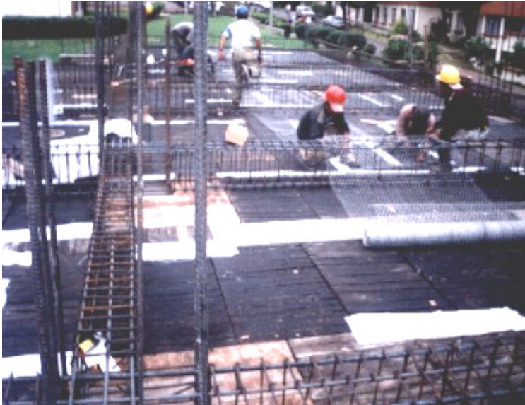
Figura 74. Traslapo malla hexagonal.
