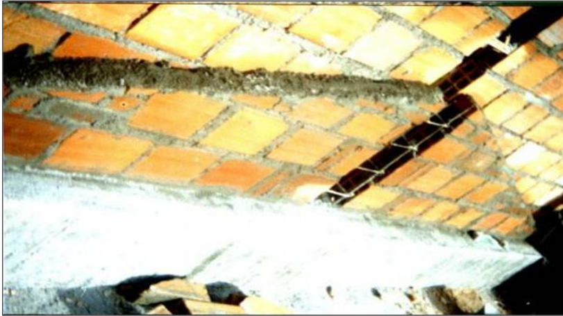
Figura 117. Armado el 60% de tímpanos. indica esmalte de vigas canal.
