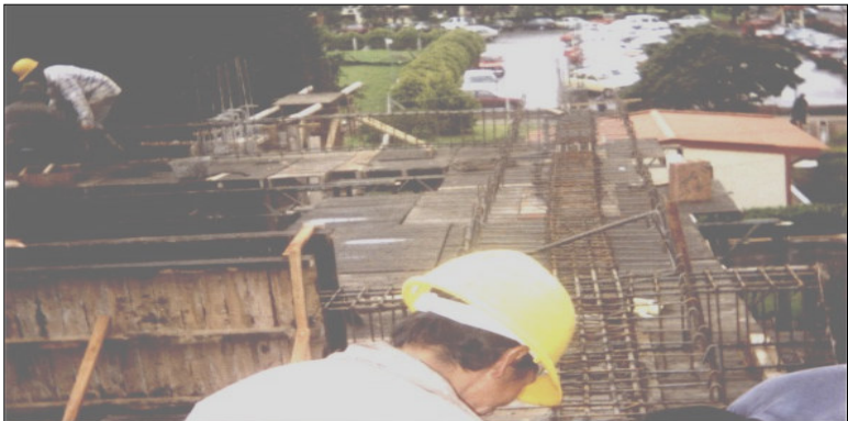
Figura 106. Armado de corniza sobre viga aérea.
