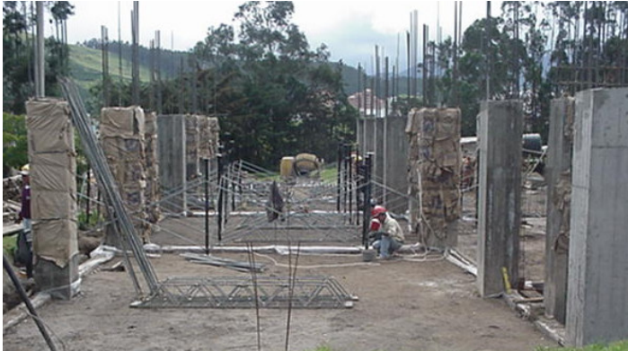
Figura 69. Nivelación de la formaleta n+3.16m en inicio.
