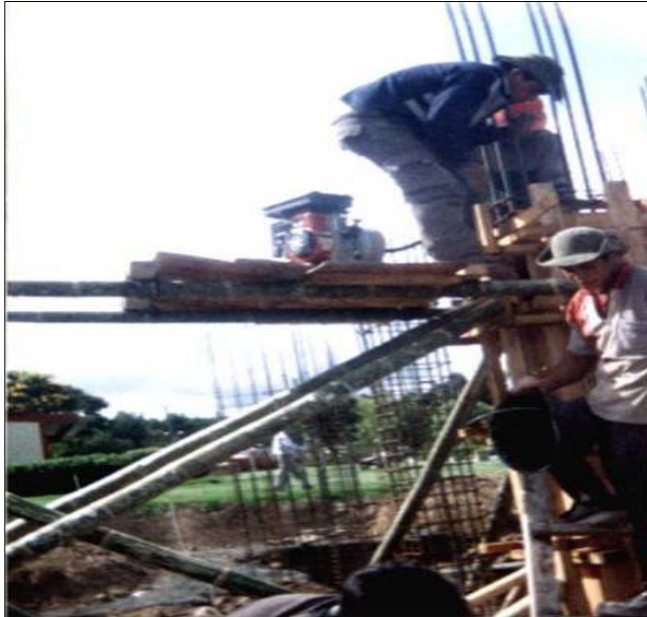
Figura 48. Aplicación del gran método de vibración.
