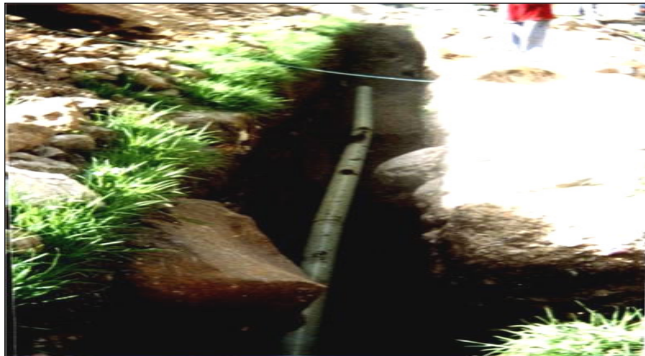
Figura 78. Instalación tubería de 8" aguas lluvias.
