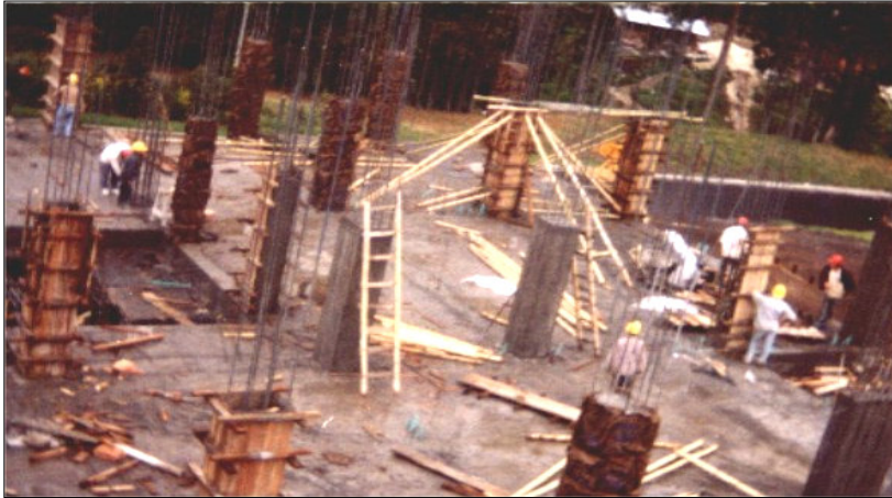
Figura 101. Formaleteado, fundida y curado de columnas.
