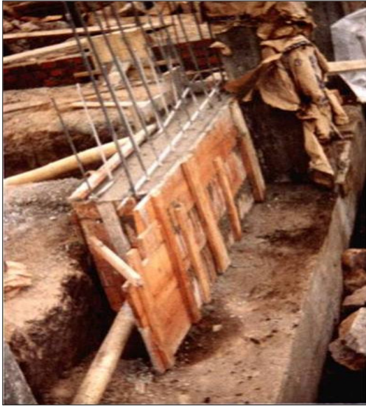
Figura 127. Formaleteado y vaciado de escaleras.
