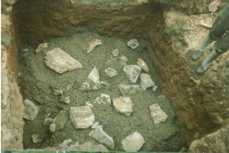
Figura 27. Colocación del concreto y rajón en formación del ciclópeo.
