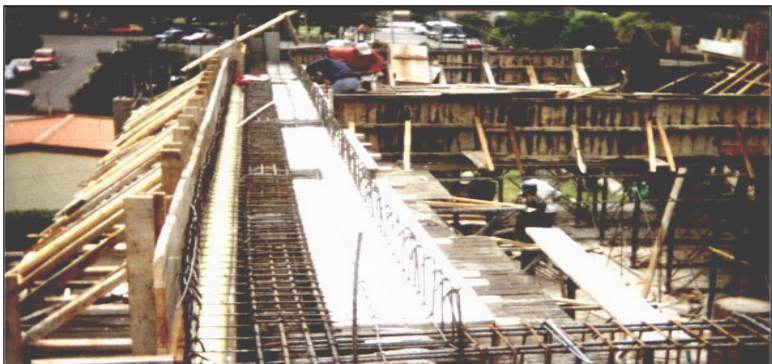
Figura 106. Armado de corniza sobre viga aérea.
