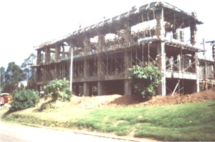
Figura 98. Conformación de vigas canal y formaleta n+6.32.
