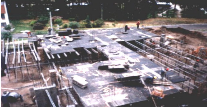
Figura 69. Nivelación de la formaleta n+3.16m en inicio.
