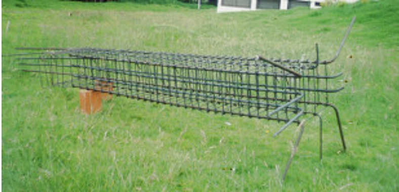
Figura 39. Armaduras de columnas
