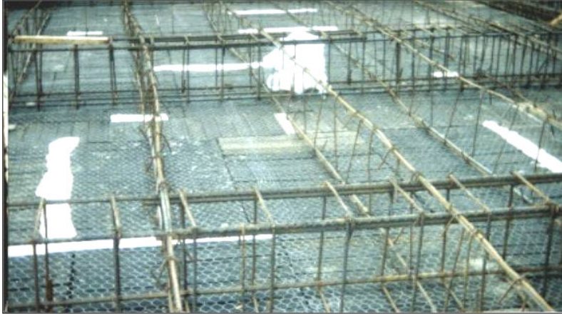
Figura 72. Detalles de vigas y nervios.
