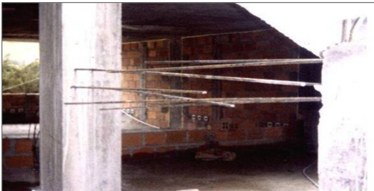
Figura 125. Colocación de anclajes.
