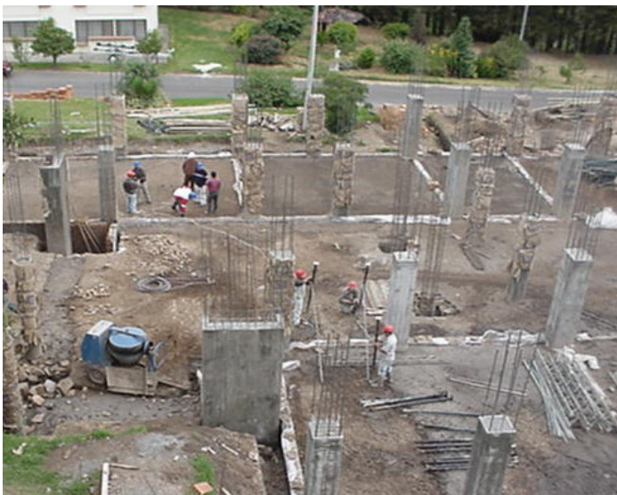
Figura 54. Fundición total de columnas y pantallas del N+ 3.16m.
