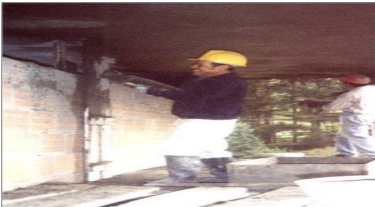
Figura 133. Repellos bajo placas.
