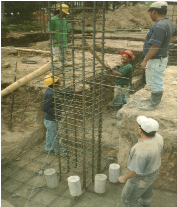
Figura 32. Apuntalamiento y verticalidad de columnas.
