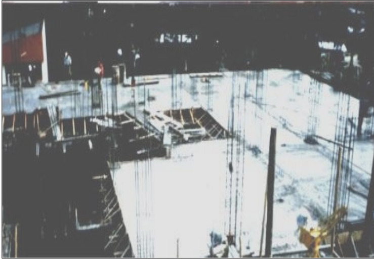
Figura 91. Proceso curado de placa (día siguiente 21 febrero 2003).
