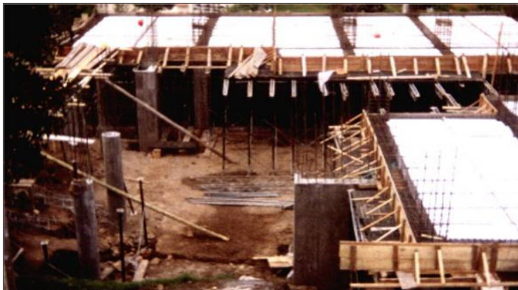
Figura 83. Colocación del aligeramiento.
