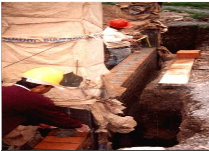
Figura 55. Sobrecimiento en muro tizón.
