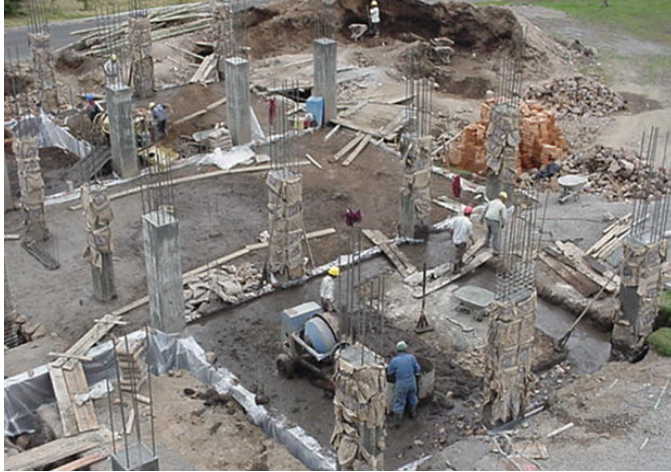
Figura 47. Ventana para fundición y mojar formaleta.
