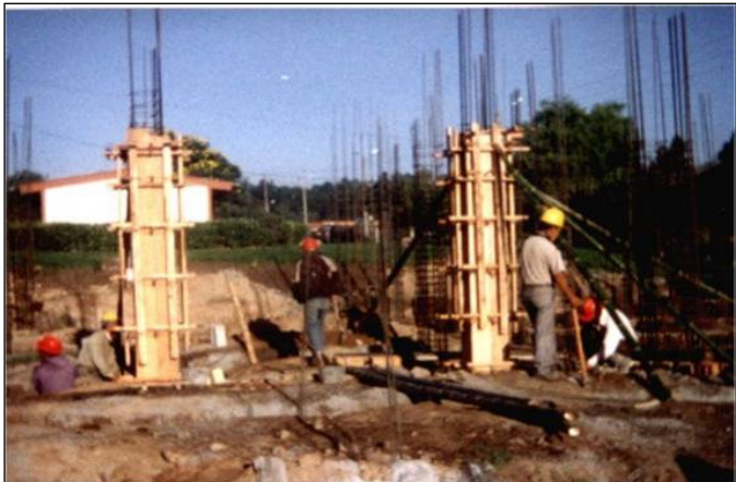
Figura 44. Verificación verticalidad de columna.
