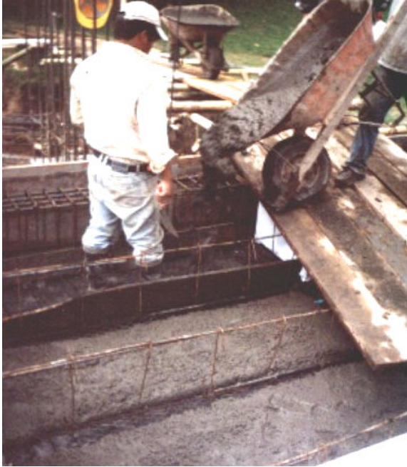
Figura 80. Colocación de mortero bajo casetón.
