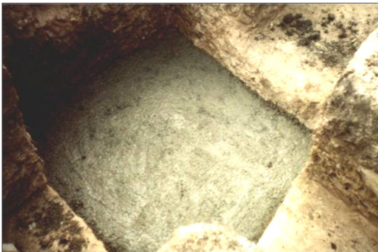
Figura 28. Terminado de concreto ciclópeo y fundida del solado
