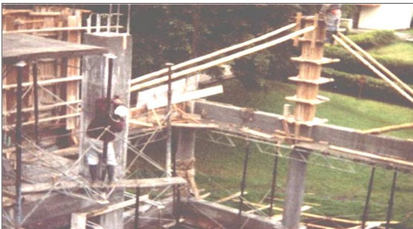
Figura 92. Formaleteado de columnas circulares.
