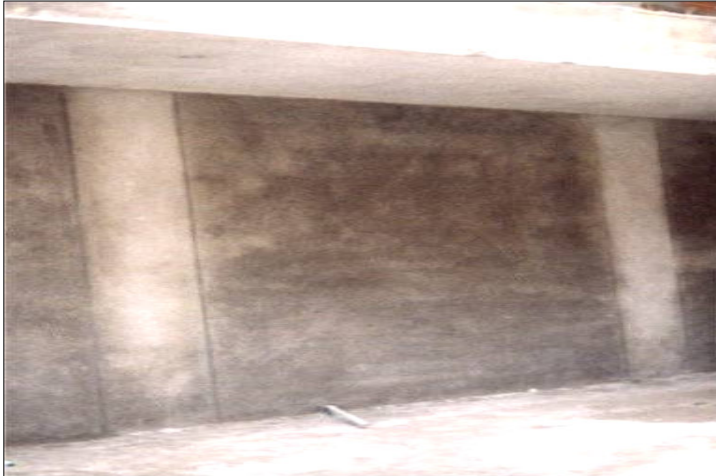
Figura 133. Repellos bajo placas.
