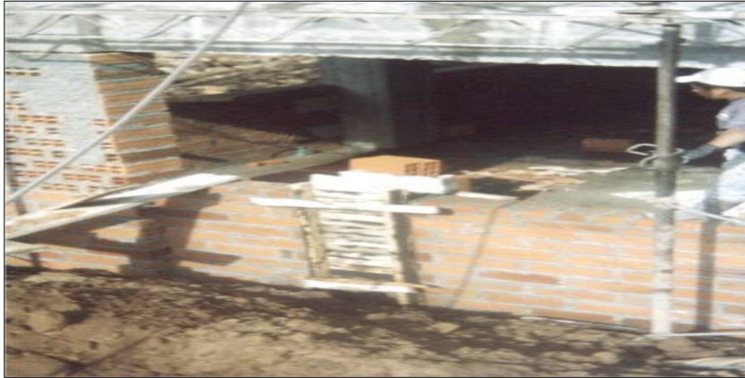
Figura 129. Fundición de columnetas.
