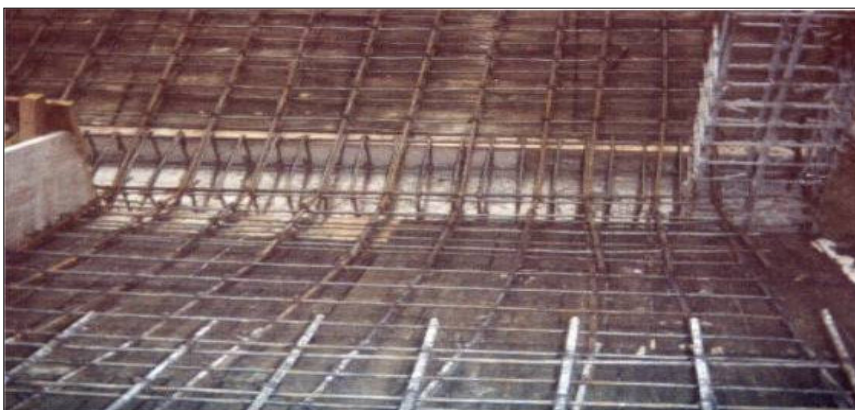
Figura 123. Refuerzo a compresión y tracción.
