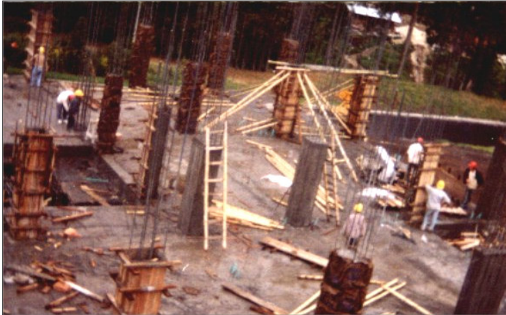
Figura 45. Encofre y decencofre de columnas.
