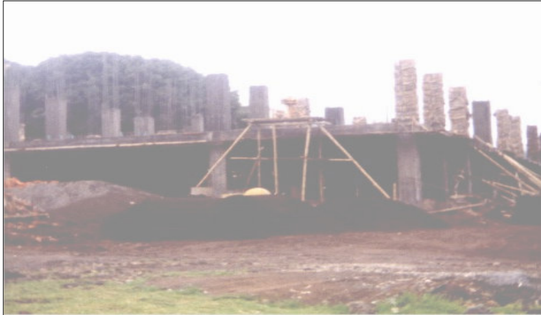
Figura 93. Armado y fundición de columnas N + 6.32.
