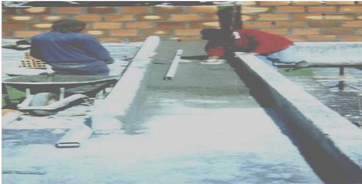
Figura 111. Repello de vigas canal.
