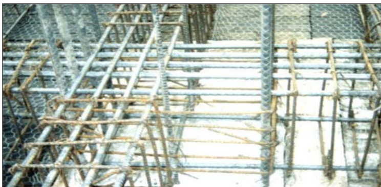
Figura 71. Disposición del refuerzo en los nudos.
