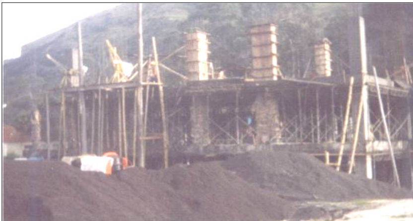
Figura 100. Armado y fundicion de columnas n + 9.48m.
