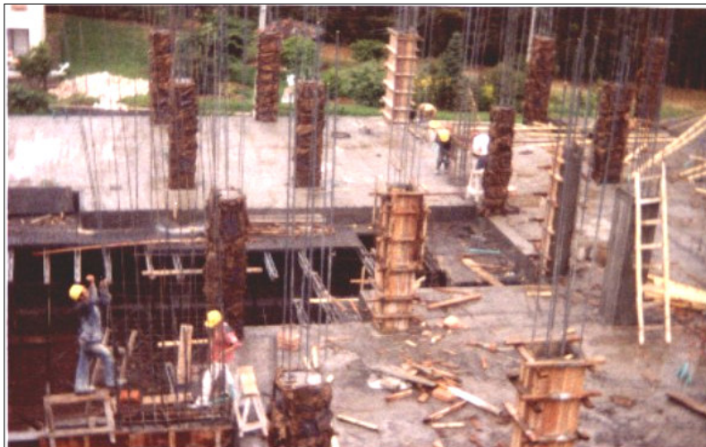
Figura 94. Formaleteado, curado y armado de pantallas.
