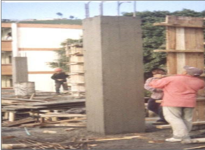
Figura 52. Proceso de curado.
