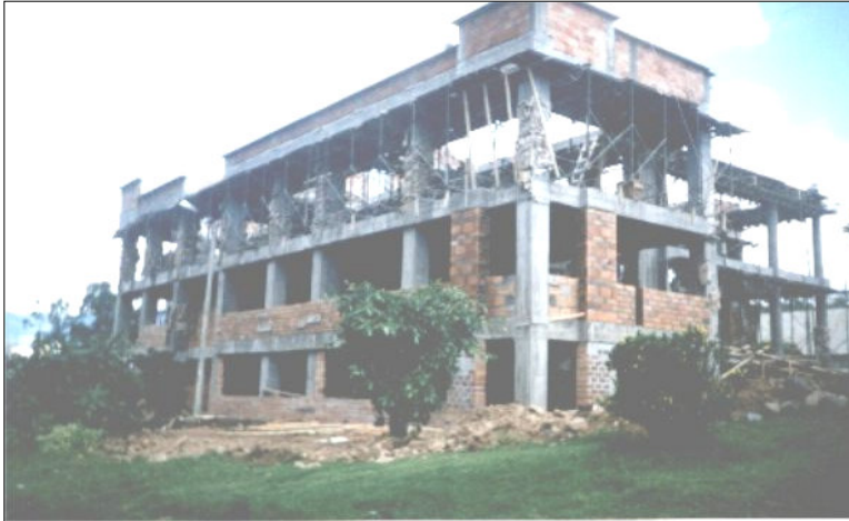
Figura 99. Pega ladrillo en realización de mochetas (para fachada )
