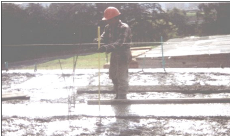
Figura 90. Toma de niveles para espesores de solados.
