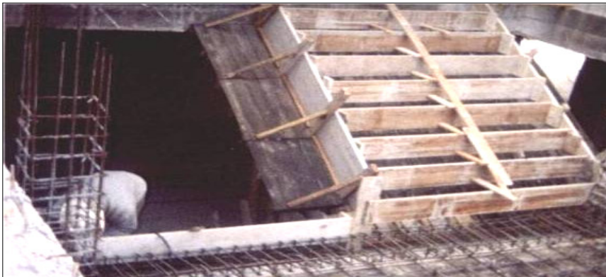
Figura 127. Formaleteado y vaciado de escaleras.
