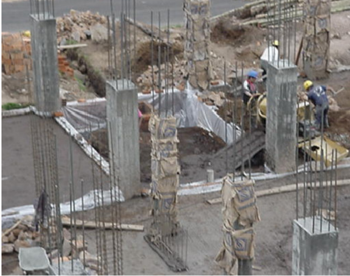
Figura 54. Fundición total de columnas y pantallas del N+ 3.16m.
