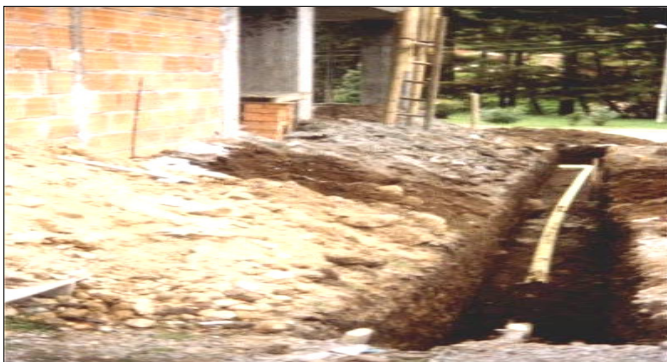
Figura 114. Excavación para tubería de aguas lluvias.
