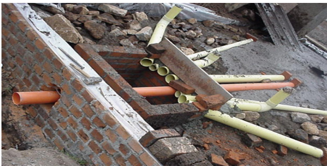
Figura 77. Instalación de sifones d = 2'' y baños de d = 4''.
