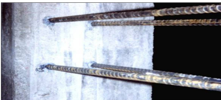
Figura 125. Colocación de anclajes.
