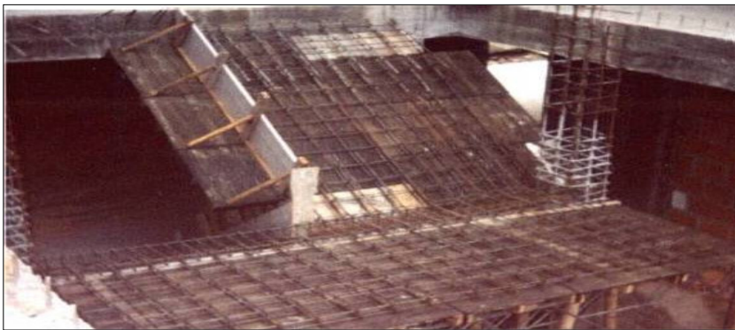
Figura 123. Refuerzo a compresión y tracción.
