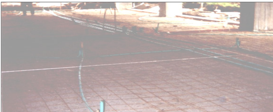
Figura 102. Colocación de malla, inst. eléctricas, hidrosanitarias.
