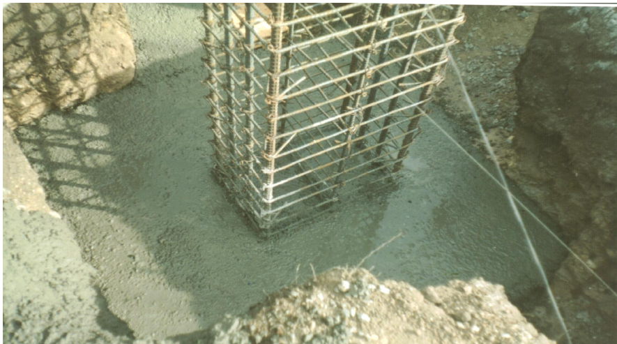
Figura 34. Zapata fundida y nivelada.
