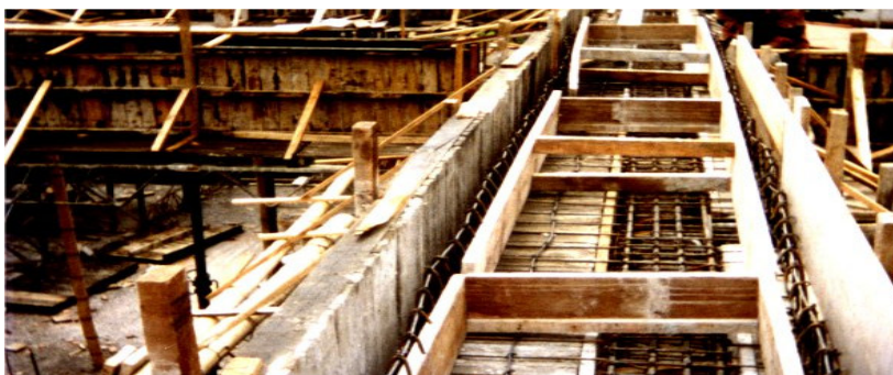
Figura 110. Formaleteo de vigas canal.
