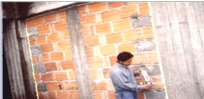
Figura 128. Relleno con espuma hilty.
