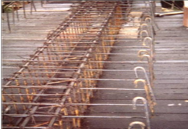
Figura 109. Armado de vigas canal.
