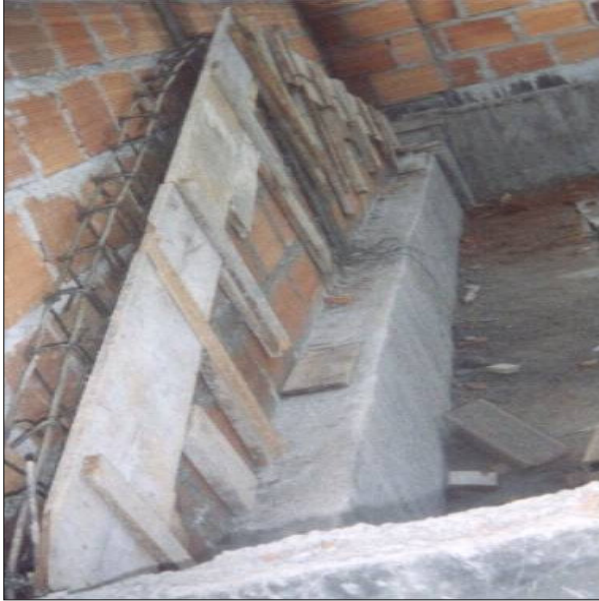
Figura 118. Armado y formateado de vigas de encinte.
