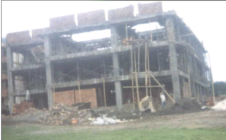
Figura 120. Iniciación en la realización de Parapetos.
