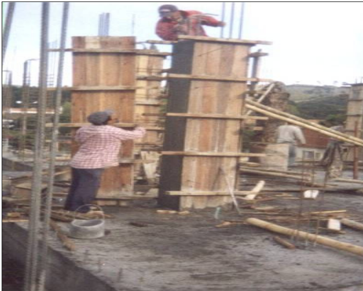
Figura 50. Proceso de decencofre 2.
