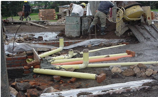
Figura 77. Instalación de sifones d = 2'' y baños de d = 4''.
