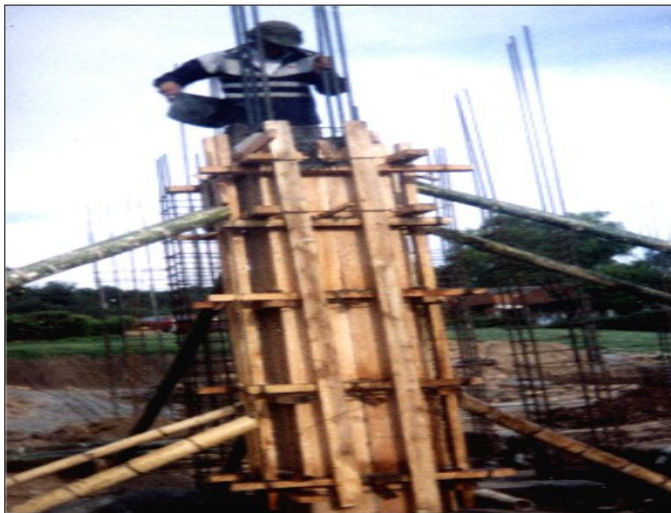
Figura 47. Ventana para fundición y mojar formaleta.
