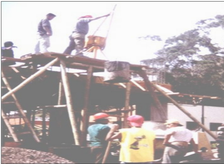
Figura 96. Vaciado de concreto en el n +6.32m
