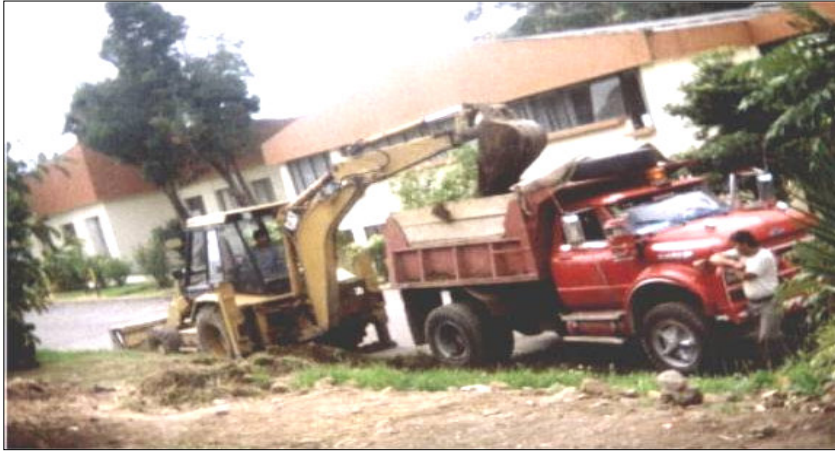
Figura 136. Cargue de material en conformación de taludes.
