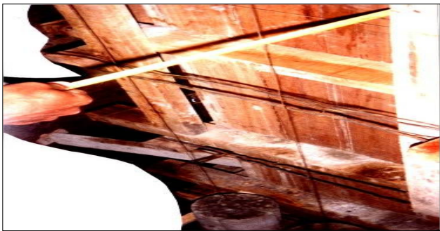
Figura 44. Verificación verticalidad de columna.
