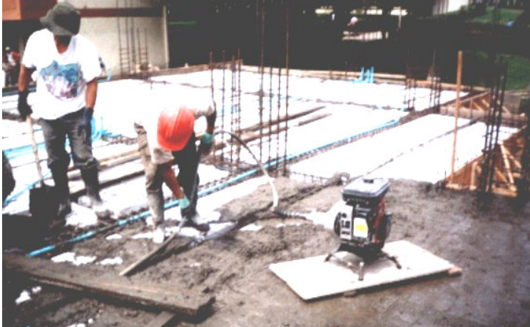
Figura 86. Armado de equipo y transporte de concreto.
