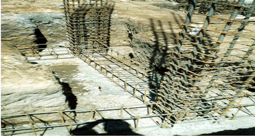
Figura 36. Supervisión de armaduras.
