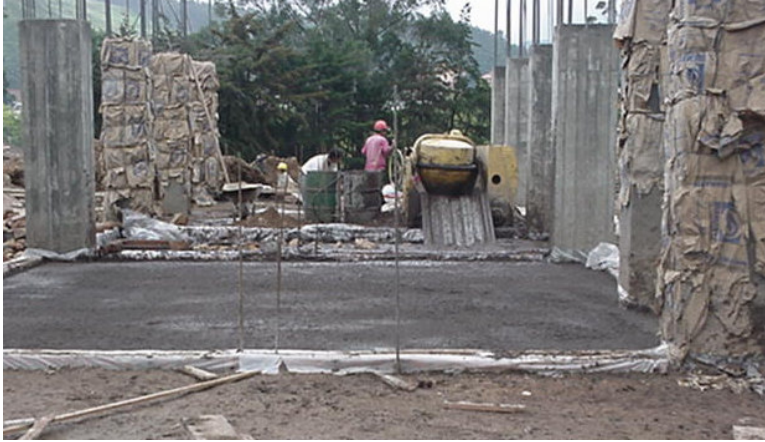
Figura 62. Nivelación obtenida mediante el relleno
