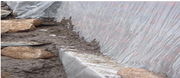
Figura 56. Impermeabilización con polisecc en caras de muros.
