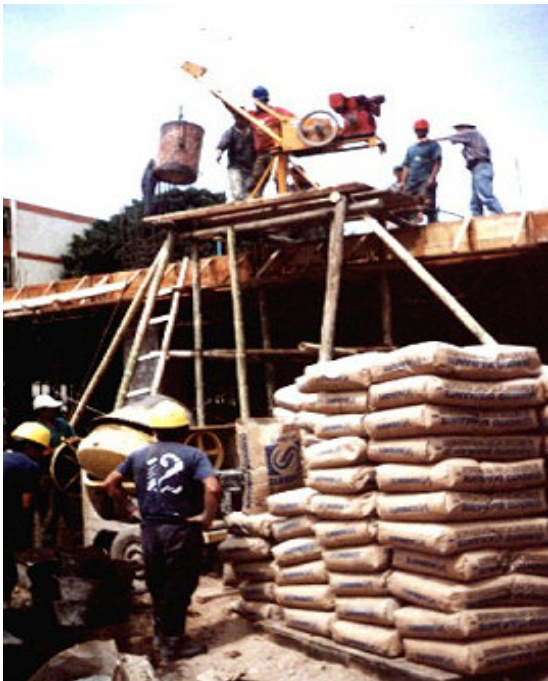
Figura 86. Armado de equipo y transporte de concreto.
