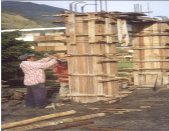
Figura 50. Proceso de decencofre 2.
