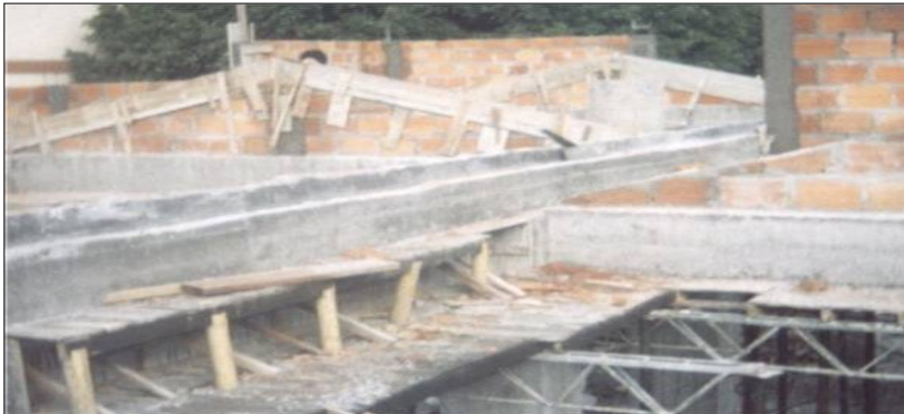
Figura 117. Armado el 60% de tímpanos. indica esmalte de vigas canal.
