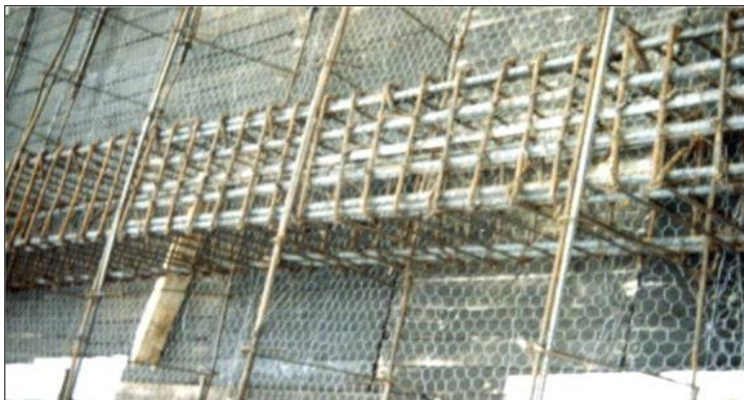
Figura 71. Disposición del refuerzo en los nudos.
