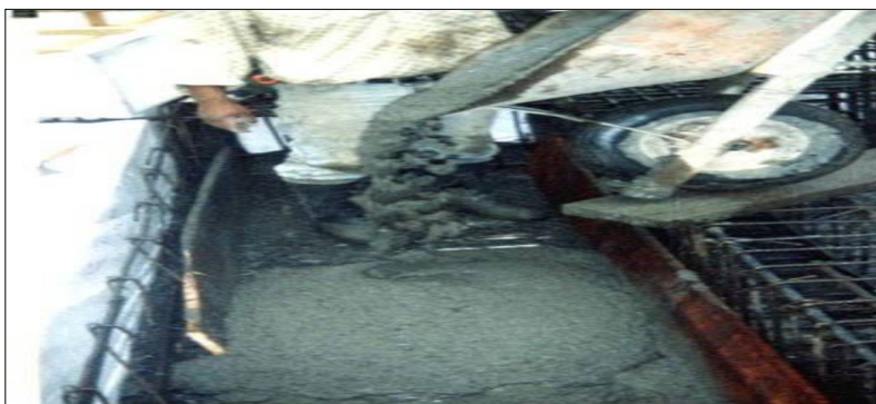
Figura 79. Colocación de mortero en solado inferior.
