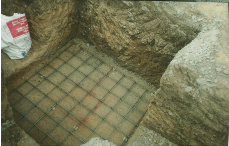
Figura 30. Armado, centrado y verticalidad de pantallas.
