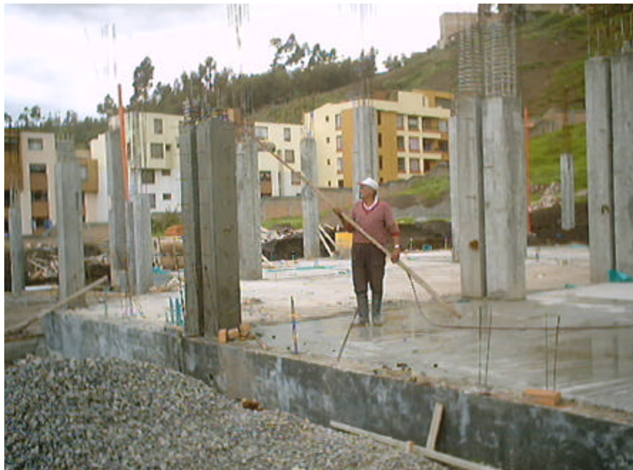
Figura 33. Curado del concreto columnas
