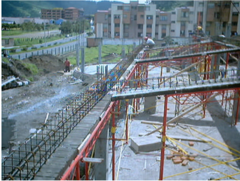
Figura 13. Viga v 10 y vigas inclinadas bloque 1 y 3
