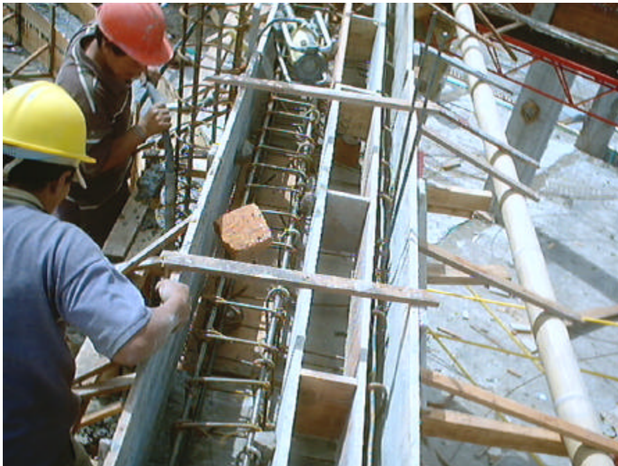
Figura 21. Detalle formaleta vigas canal
