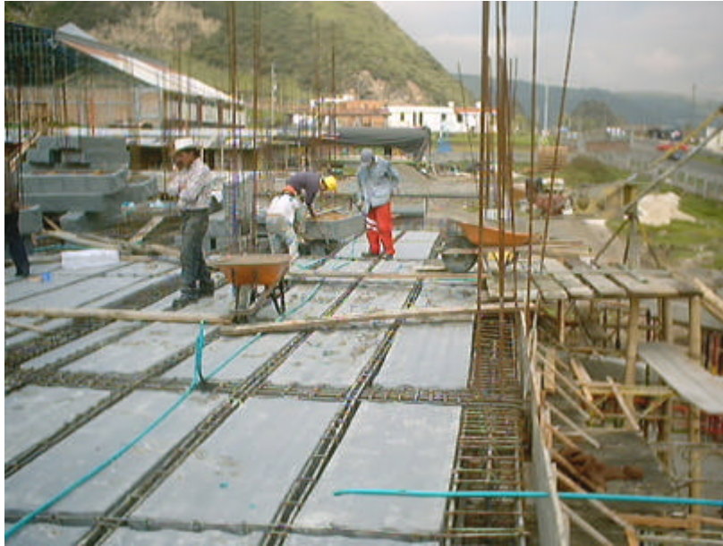
Figura 49. Fundición solado
