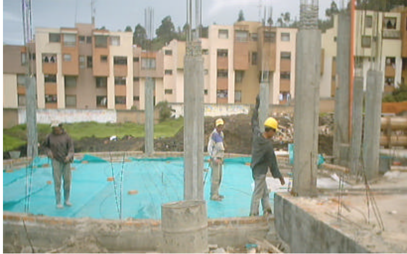
Figura 3. Colocación de casetex
