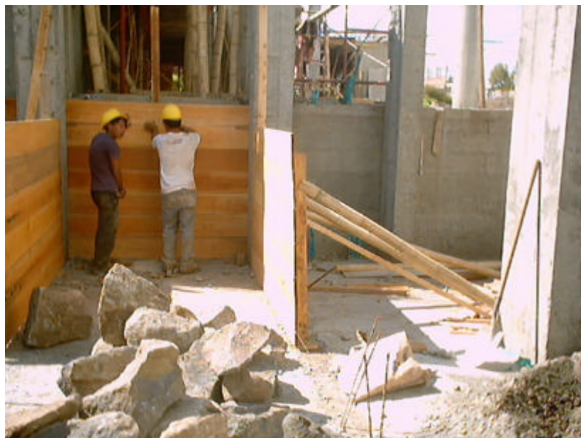
Figura 63. Encofrado escaleras en concreto ciclópeo
