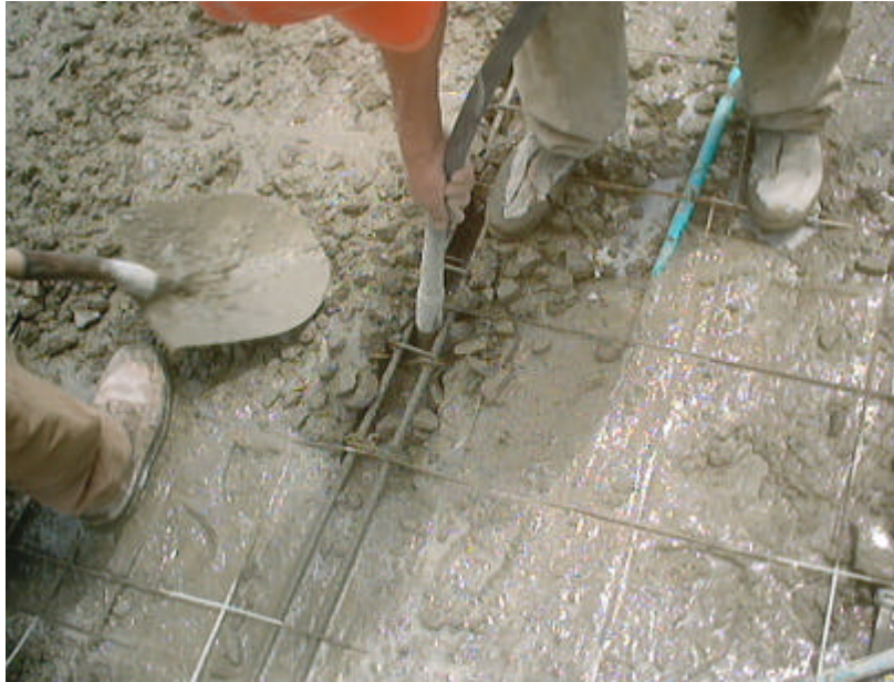
Figura 52. Vibrado de nervios
