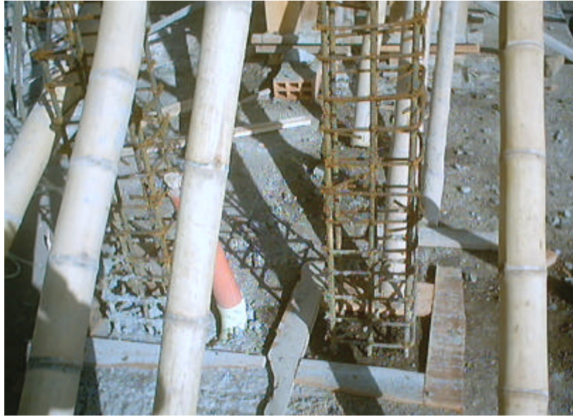
Figura 38. Refuerzo columnas estructura de acceso hall exposiciones
