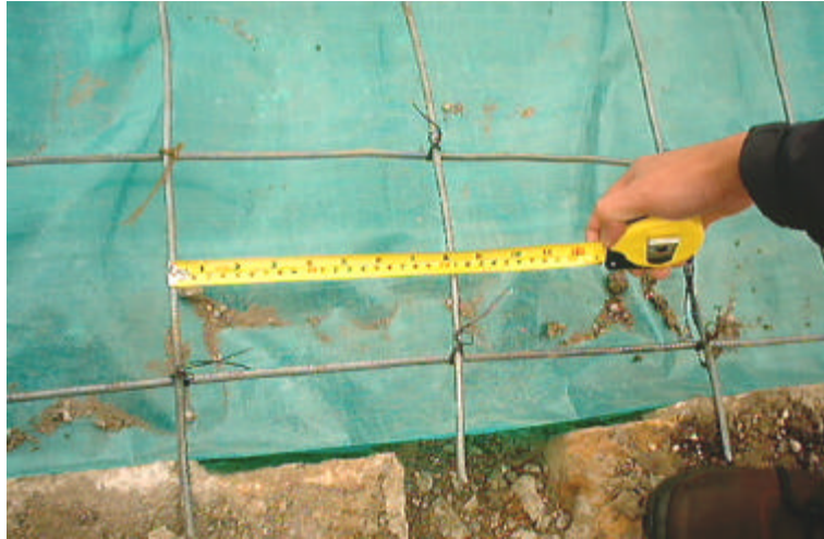
Figura 5. Revisión de amarre y espaciamiento refuerzo placa de piso
