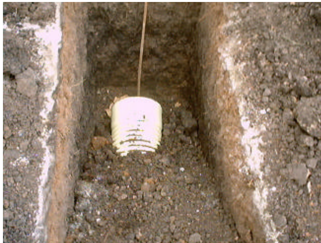
Figura 10. Instalación tubería novafort
