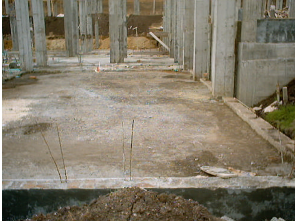
Figura 2. Nivelación del terreno con suelo – cemento fluido
