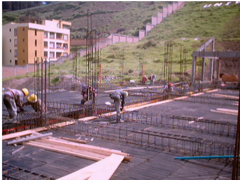
Figura 41. Armado de refuerzo bloque 1
