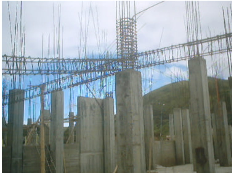
Figura 12. Refuerzo de vigas n + 3.20 m bloque 2
