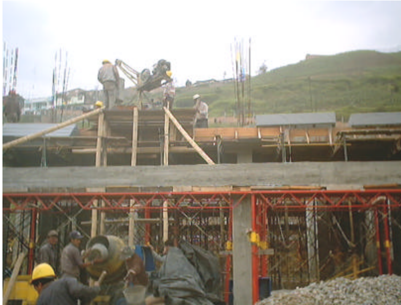
Figura 53. Ubicación pluma fundición losa bloque 3
