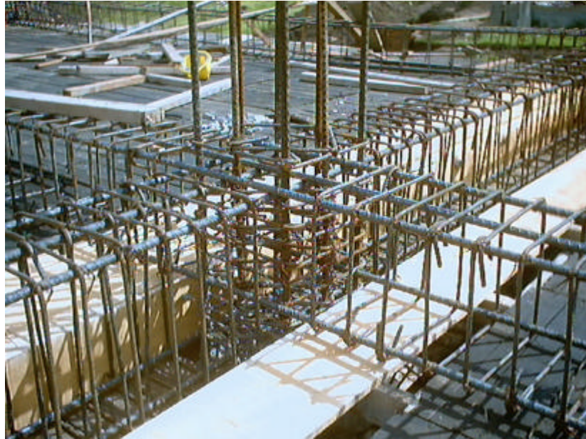
Figura 40. Refuerzo principal vigas bloque 1
