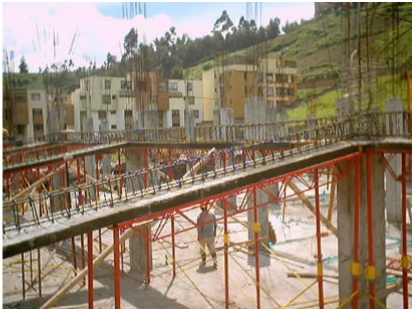
Figura 14. Viga v9 y vigas inclinadas bloque 3
