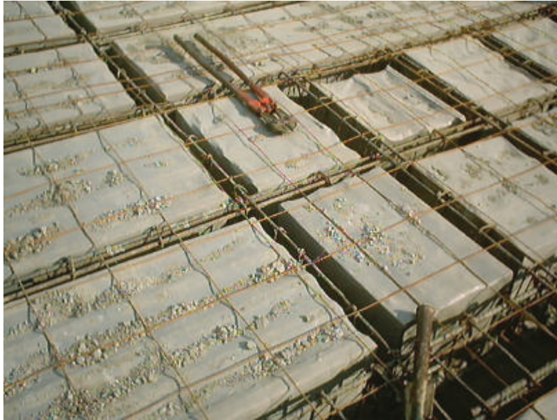
Figura 50. Colocación malla electro soldada
