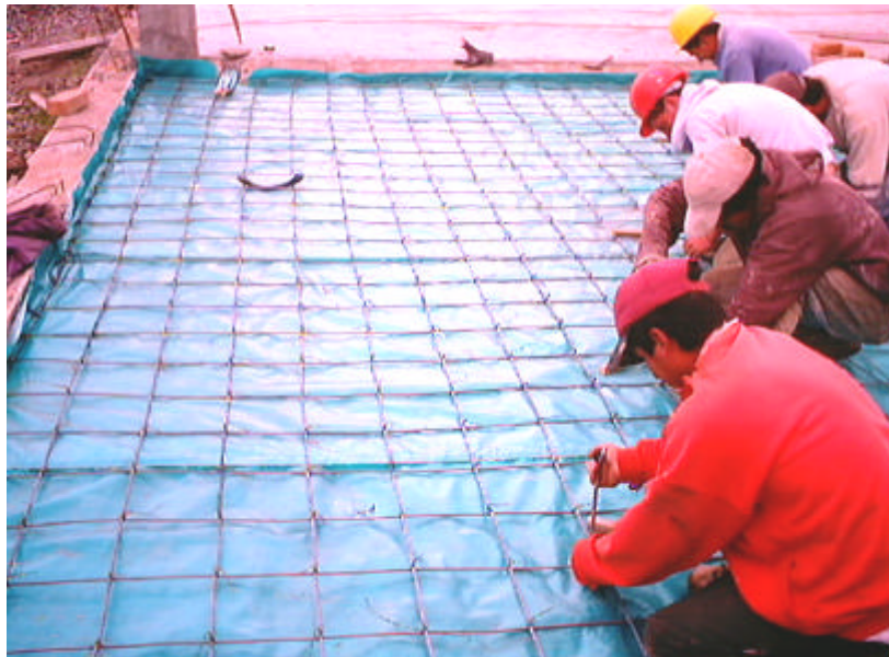
Figura 4. Armado de refuerzo placa de piso
