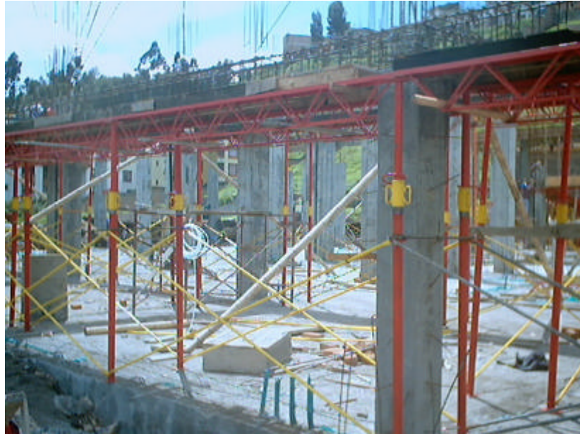
Figura 18. Formaleta metálica
