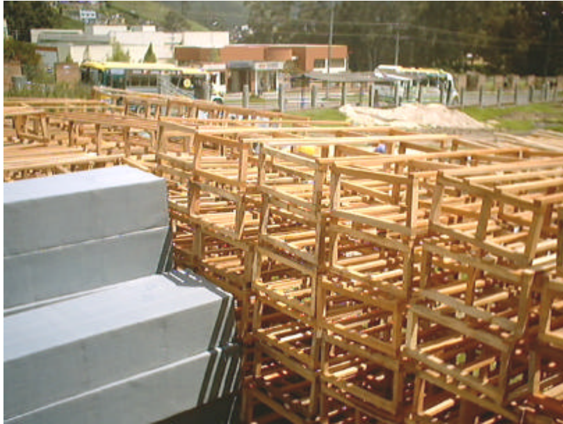
Figura 43. Almacenamiento de casetones
