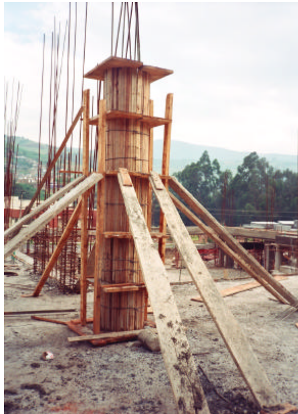
Figura 32. Apuntalado de formaleta para columnas
