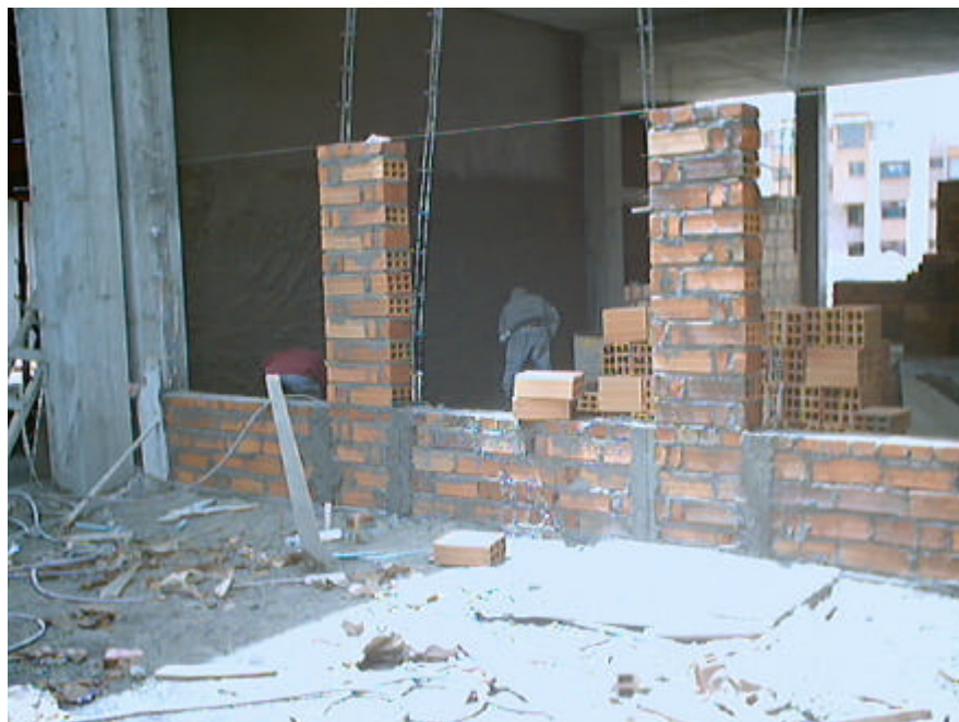
Figura 69. Pega de muros bloque 1
