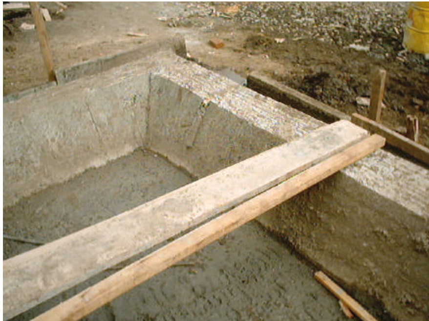
Figura 66. Muro de contención
