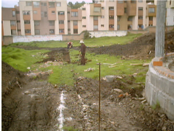
Figura 9. Excavación para tubería sanitaria
