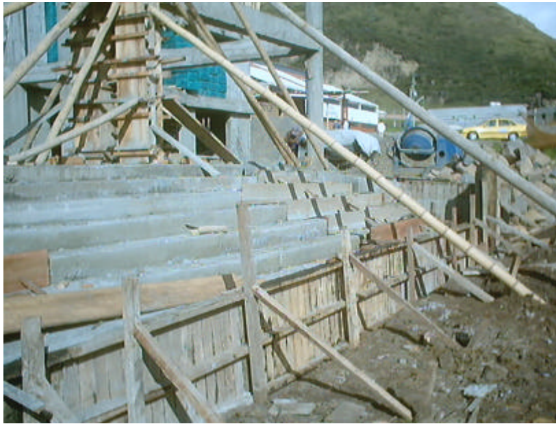
Figura 68. Escaleras acceso hall exposiciones
