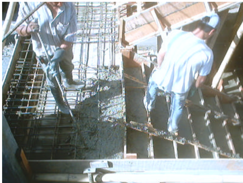
Figura 65. Fundición escaleras
