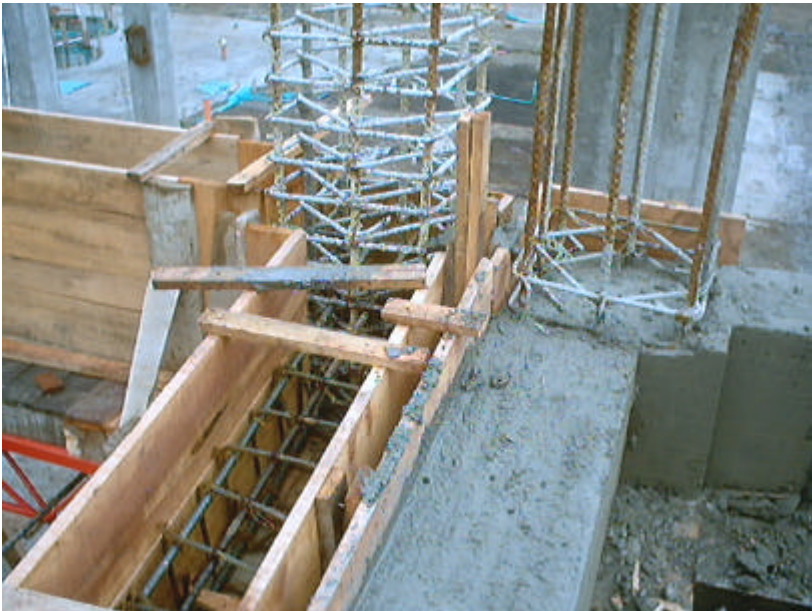
Figura 23. Detalle intersección viga columna
