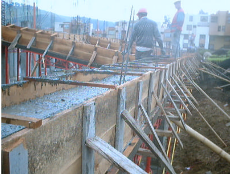
Figura 27. Fundición vigas canal bloque 2
