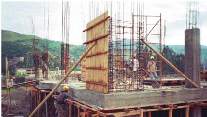
Figura 36. Encofrado de pantallas
