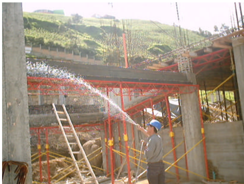
Figura 29. Proceso de curado de vigas
