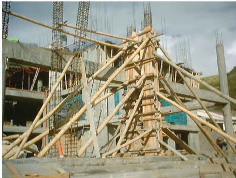
Figura 39. Encofrado columnas acceso principal
