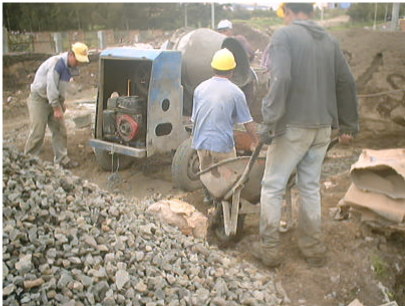
Figura 24. Producción del concreto en obra
