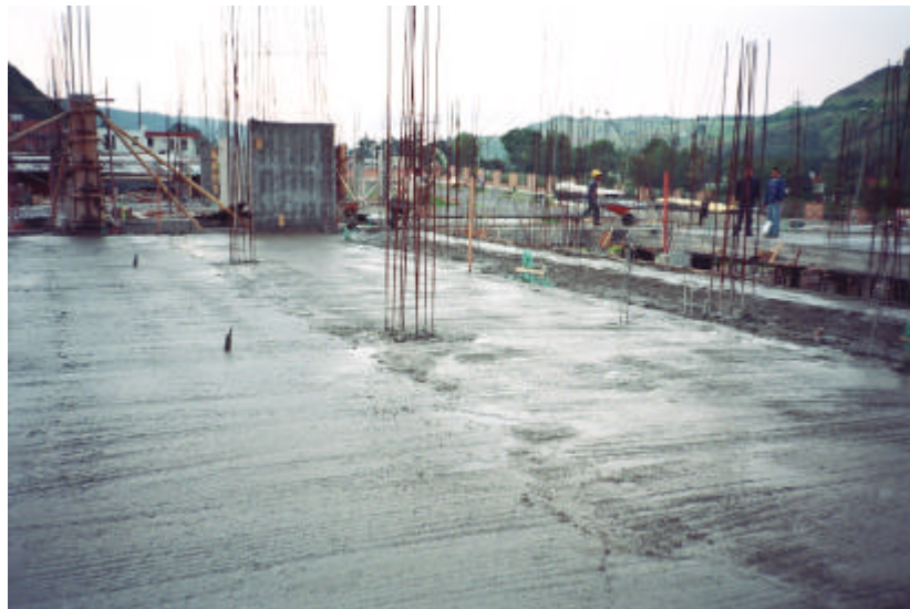
Figura 56. Losa terminada
