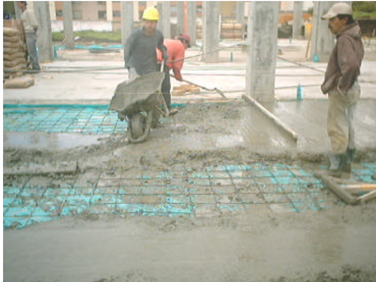
Figura 7. Fundición de la placa de piso bloque 3
