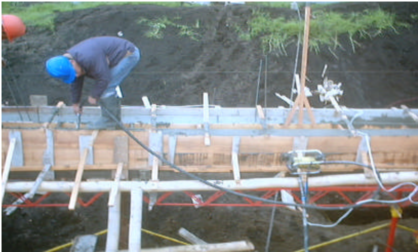
Figura 25. Fundición vigas canal bloque 1
