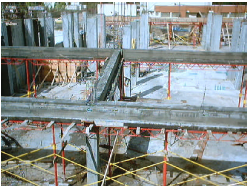
Figura 26. Vigas terminadas bloque 2
