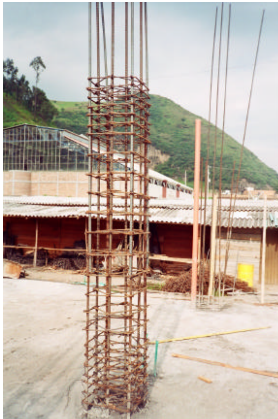
Figura 30. Detalle refuerzo columnas
