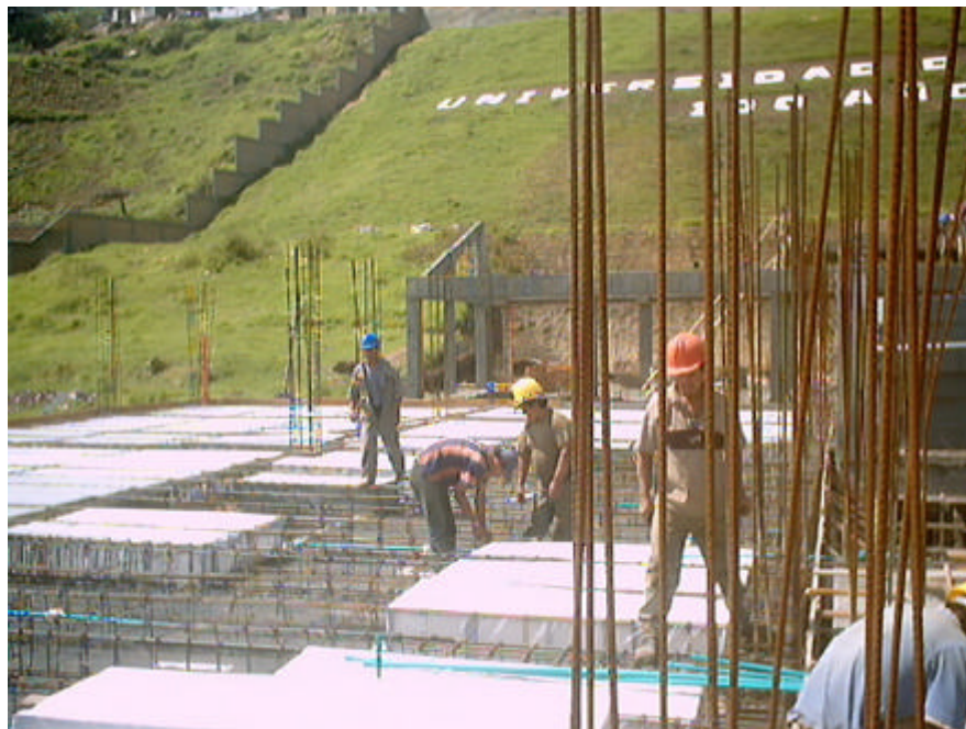
Figura 48. Colocación casetones
