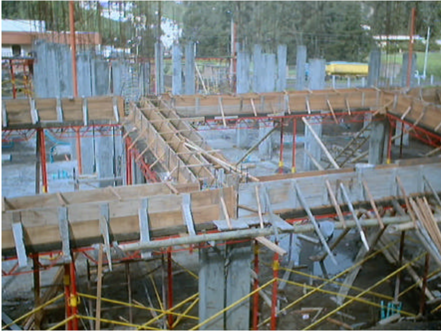
Figura 22. Formaleta vigas inclinadas
