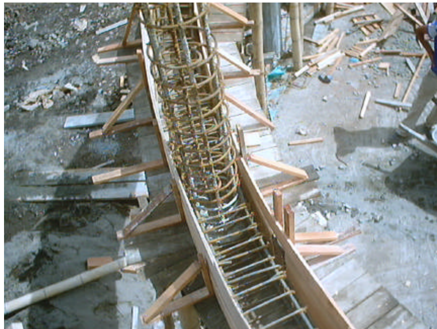
Figura 19. Formaleta bloque cilindro
