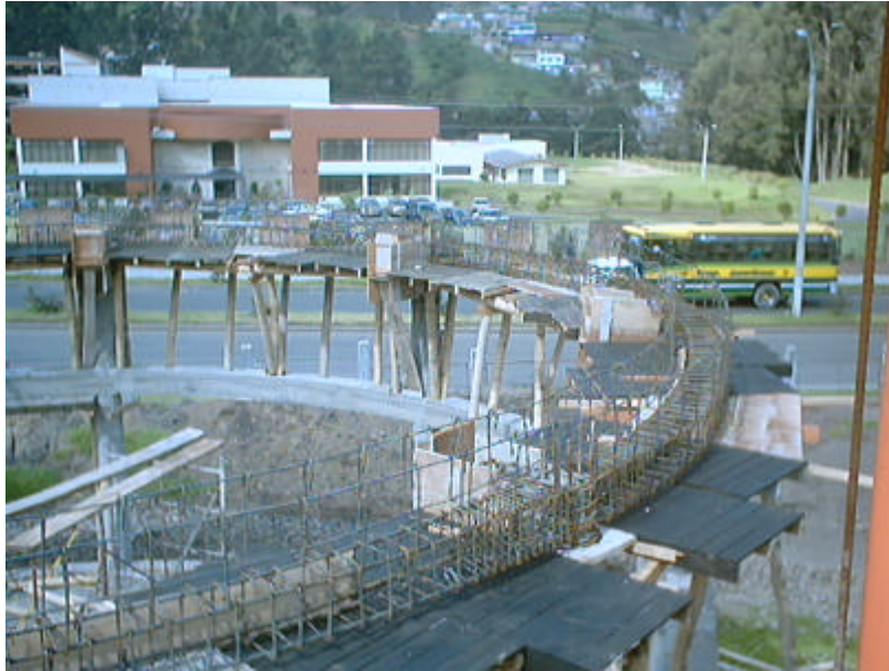
Figura 17. Viga canal y mensulas cilindro
