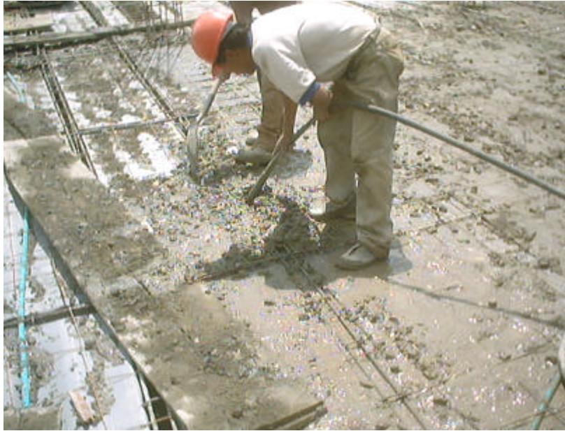
Figura 51. Fundición losa aligerada bloque 3
