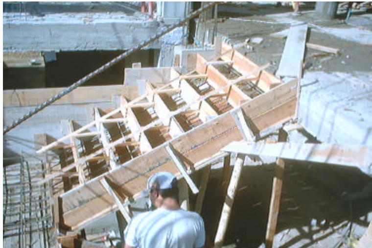
Figura 65. Fundición escaleras
