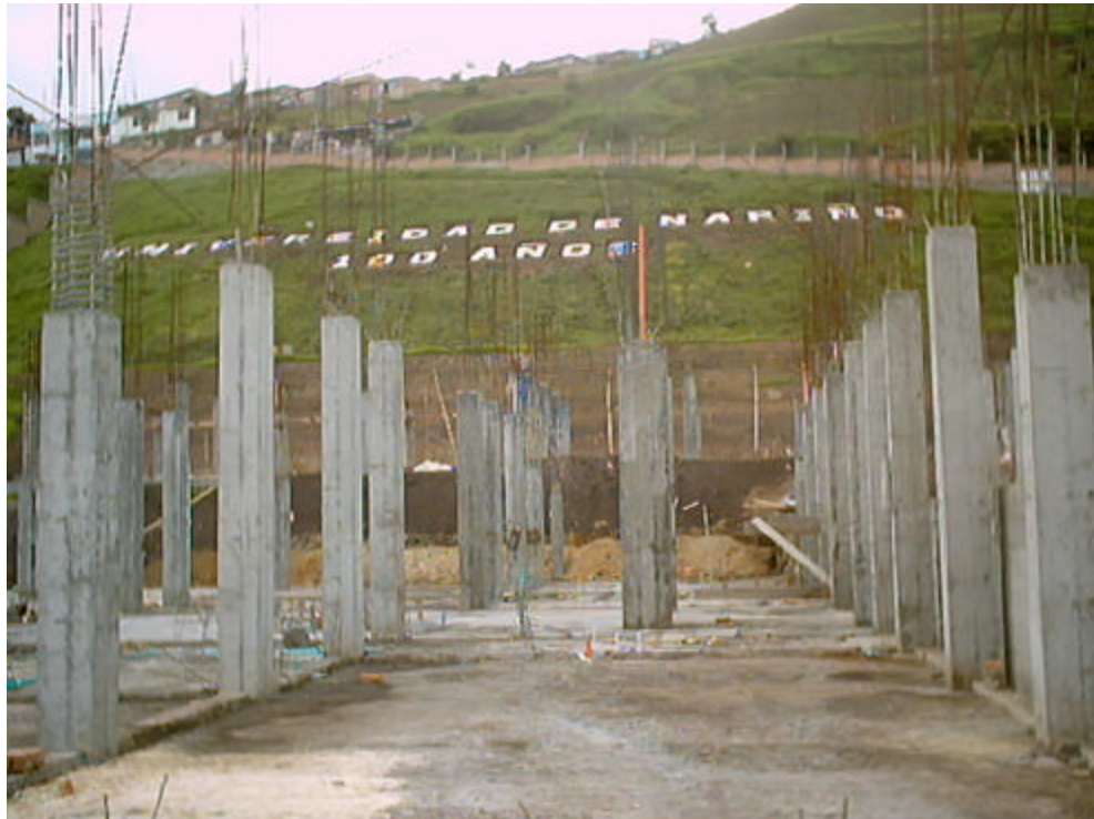
Figura 1. Vista general de la obra al inicio de la pasantía
