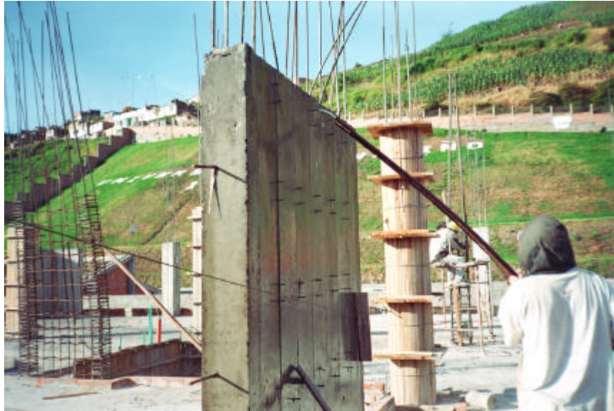
Figura 37. Curado de pantallas
