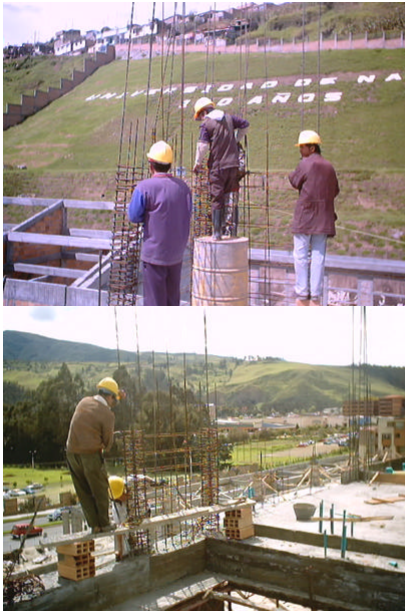
Figura 34. Armado de refuerzo pantallas
