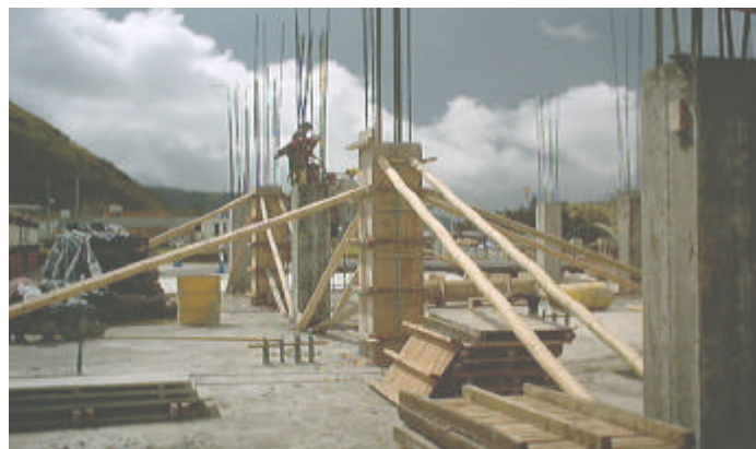
Figura 32. Apuntalado de formaleta para columnas
