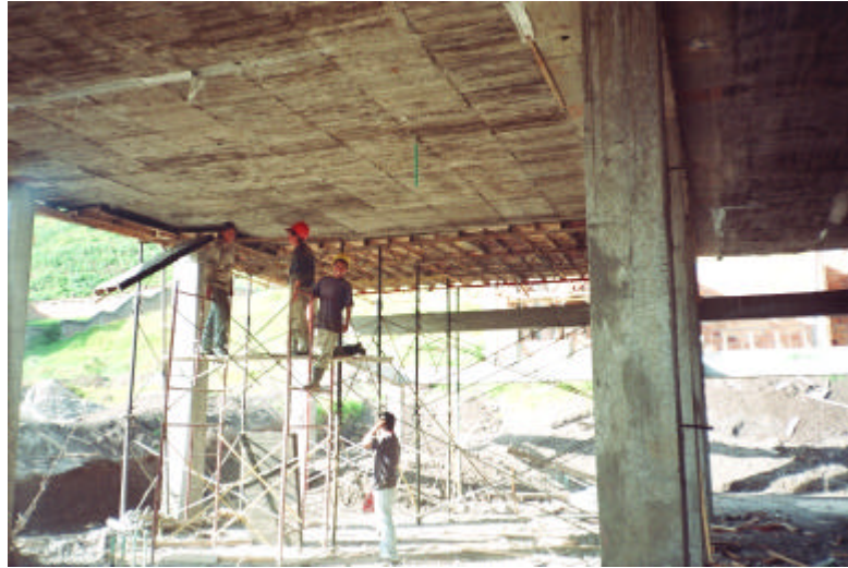
Figura 57. Desencofrado losa bloque 1
