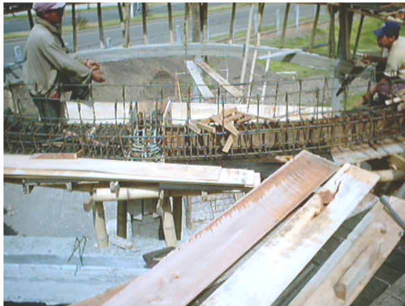
Figura 16. Armado de refuerzo viga canal cilindro
