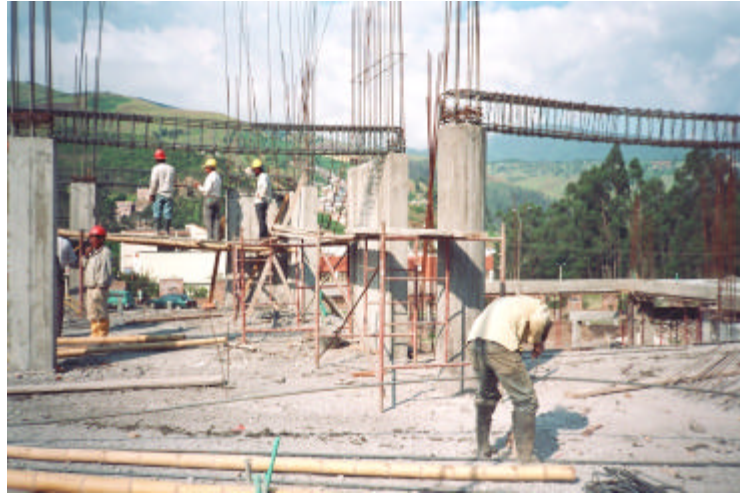
Figura 15. Armado de refuerzo vigas bloque 4
