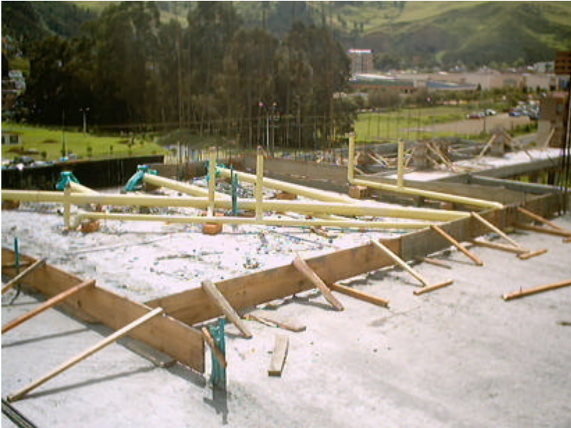
Figura 58. Tubería sanitaria losa aligerada
