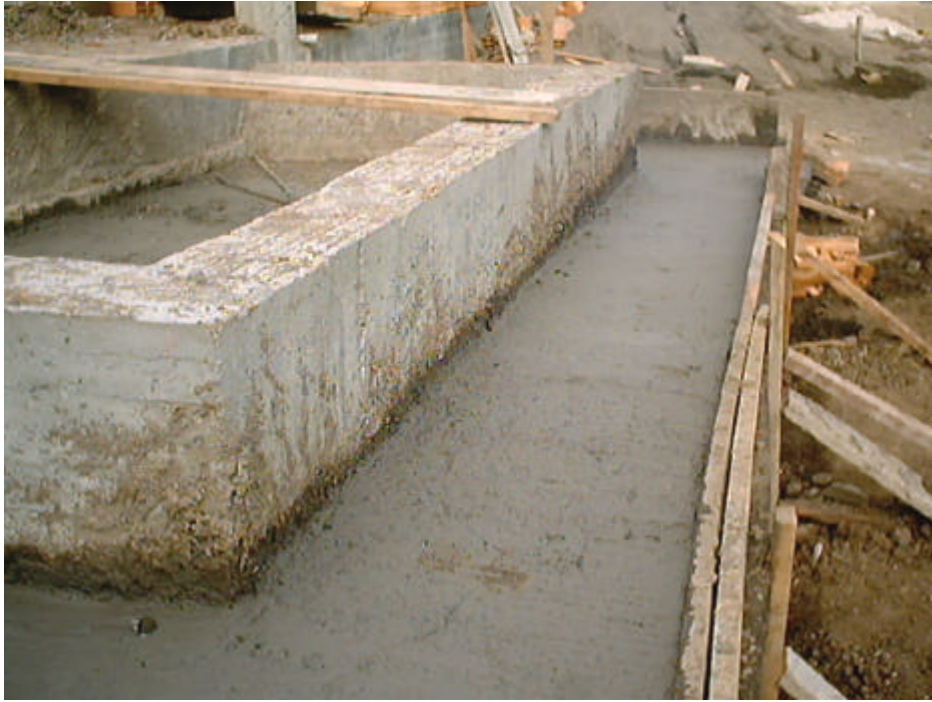
Figura 67. Relleno suelo cemento para conformación de escaleras
