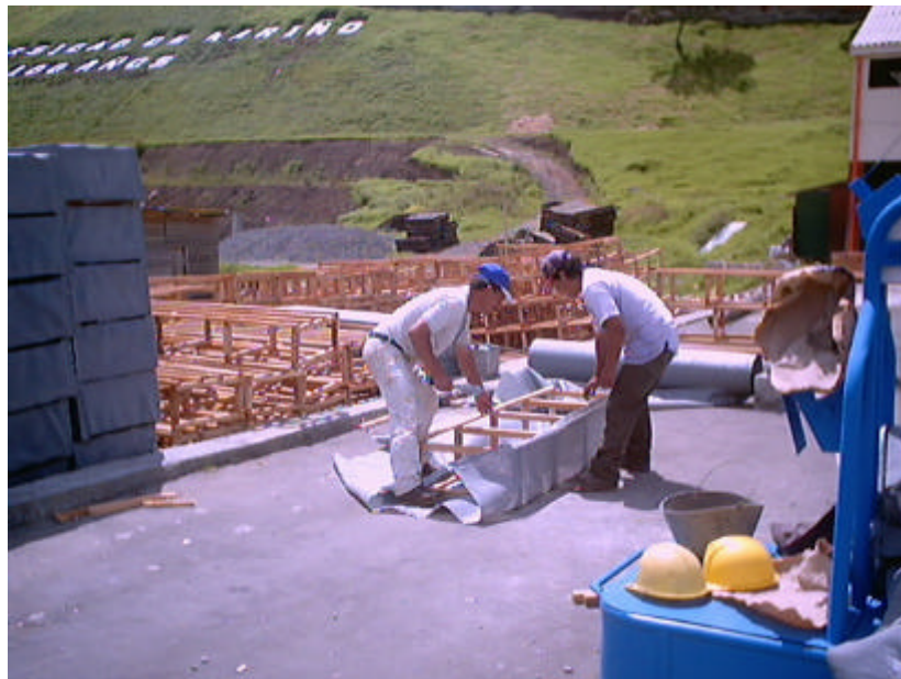
Figura 42. Fabricación de casetones
