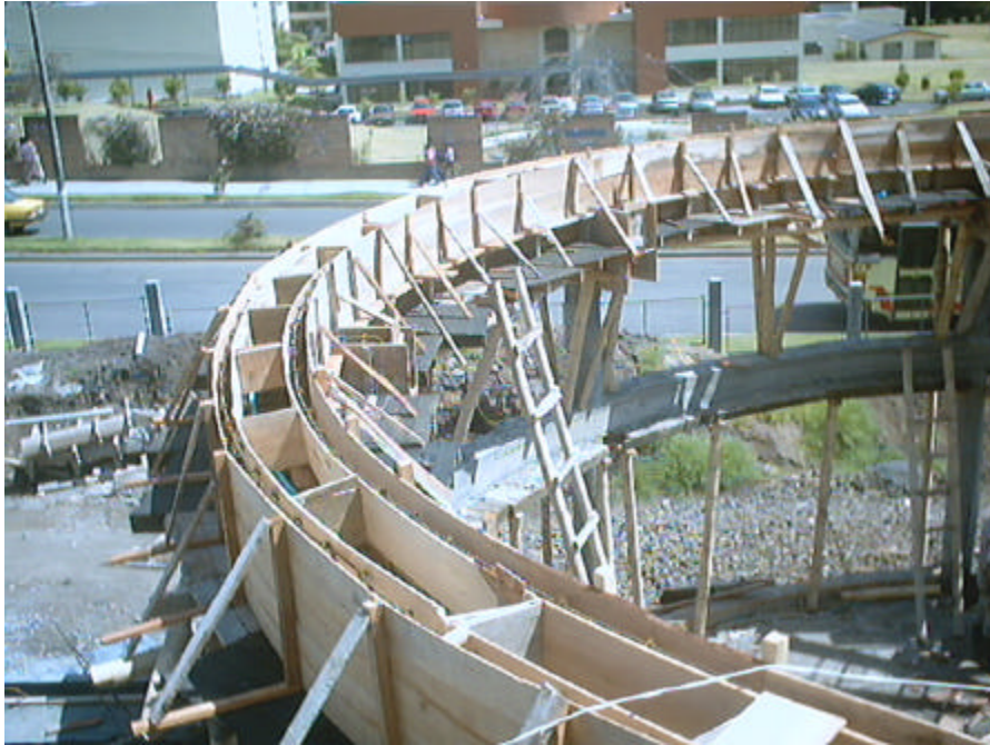
Figura 20. Formaleta viga canal bloque cilindro
