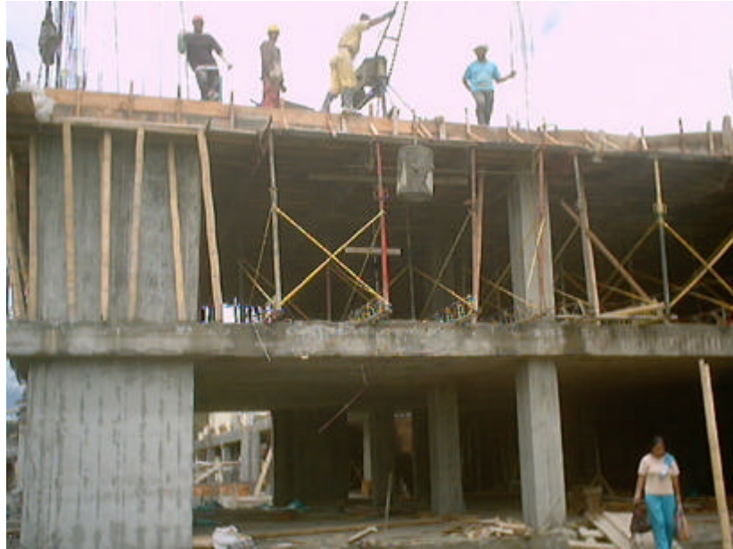
Figura 55. Ubicación pluma 1 fundición losa aligerada bloque 4
