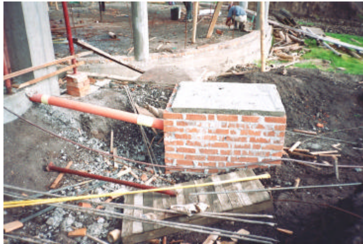
Figura 8. Caja de inspección
