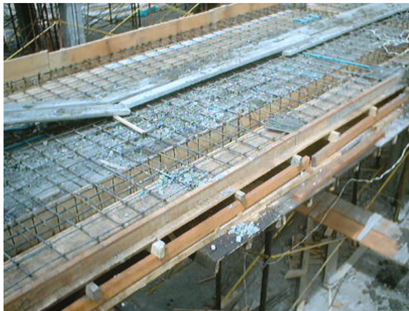
Figura 61. Refuerzo losa maciza bloque 2
