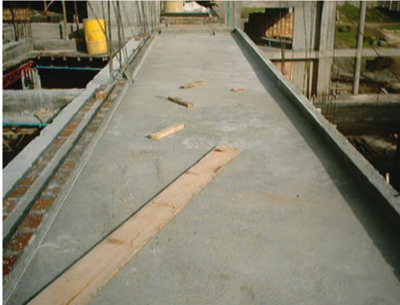
Figura 62. Losa maciza terminada
