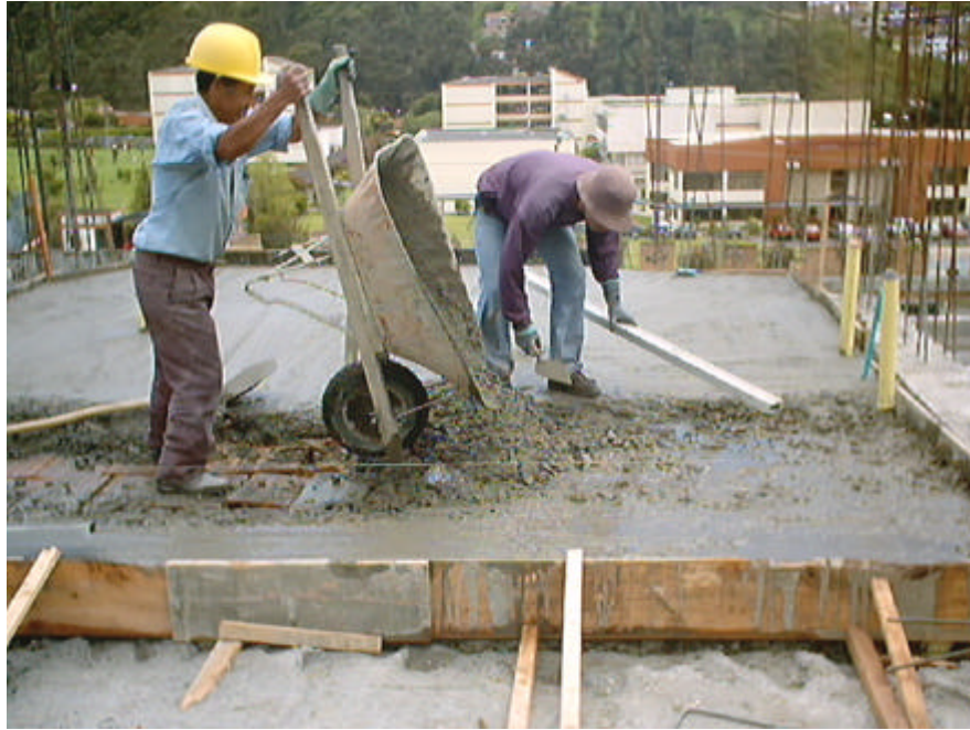
Figura 59. Fundición losa aligerada para baños cuarto piso
