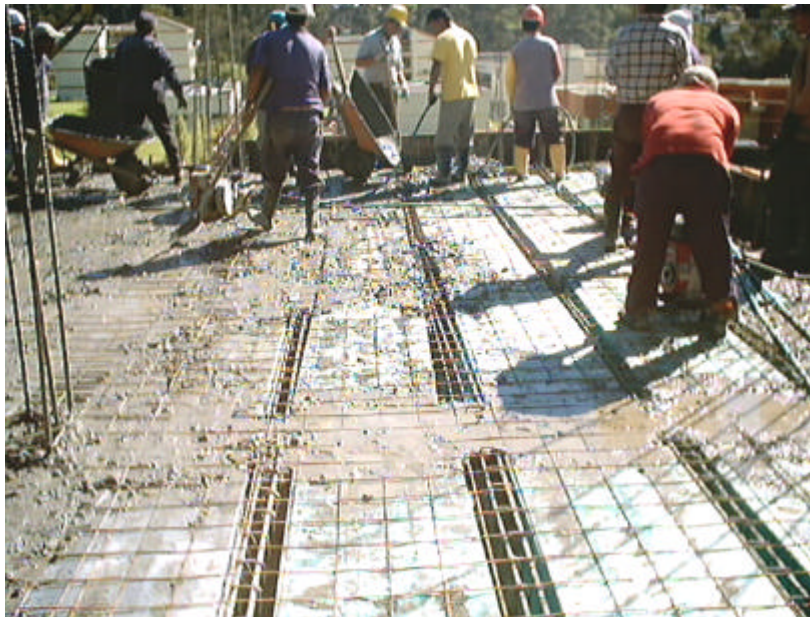
Figura 54. Fundición losa aligerada bloque 4 cuarto piso
