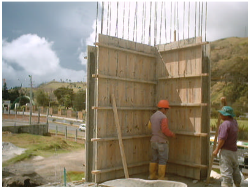
Figura 36. Encofrado de pantallas
