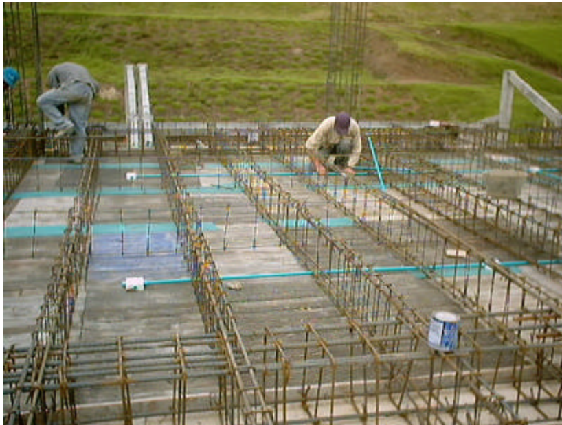
Figura 47. Ductos para instalación eléctrica nivel superior
