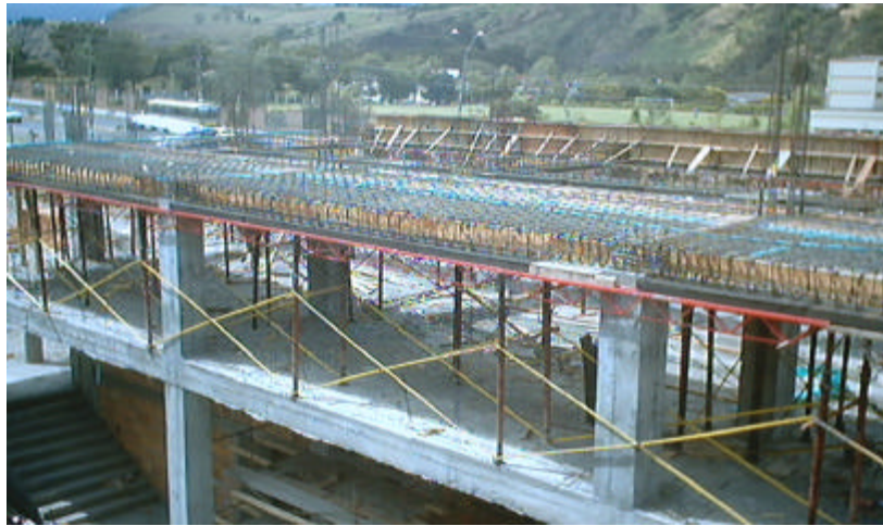
Figura 60. Refuerzo losa maciza bloque 3
