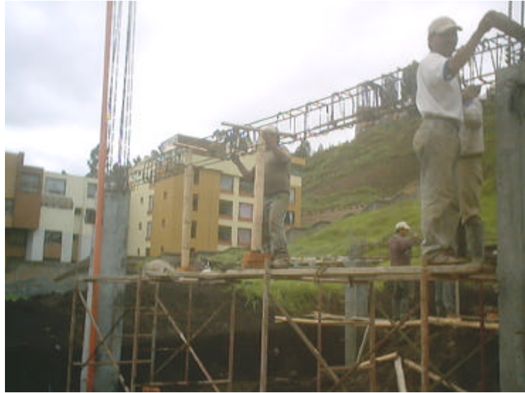
Figura 11. Armado de refuerzo de vigas bloque 1
