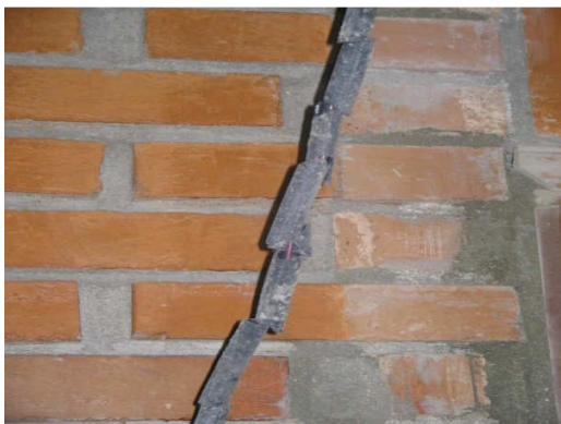
Figura 6. d. Regatas en el piso para salida de los tomas. i. Pésima calidad de los ductos eléctricos antiguos.
