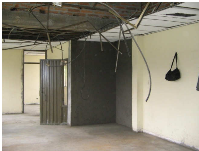
Figura 23. Demolición de cielo raso.
