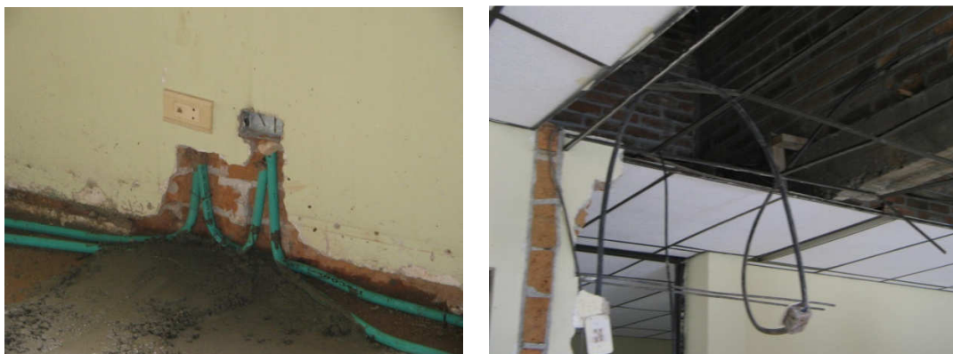
Figura 24. d. Muestra los ductos antiguos para iluminación hechos con manguera I. Red de ductos conduit en el piso, para puntos eléctricos.
