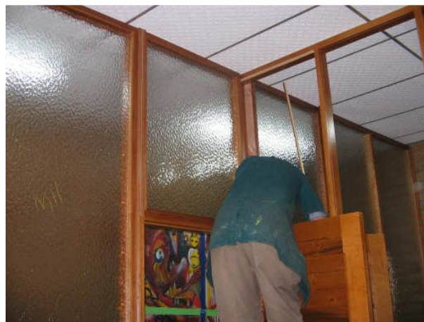
Figura 12. Desmonte de ventana en madera.
