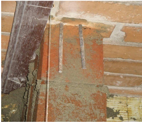
Figura 13. d. Construcción de la nueva distribución de espacios. i. Detalle anclaje para trabe con varilla incrustada.
