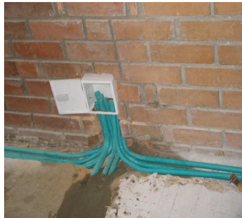
Figura 11. d. Caja de paso con gran cantidad de llegadas. i. Red de ductos conduit para iluminación.
