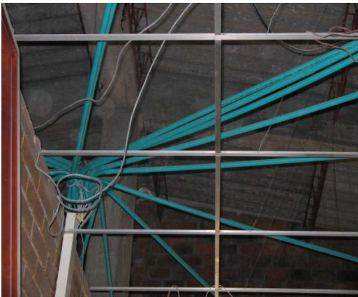
Figura 11. d. Caja de paso con gran cantidad de llegadas. i. Red de ductos conduit para iluminación.
