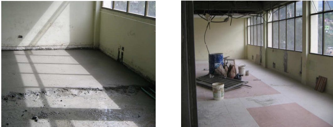
Figura 19. Fundición y enchape de piso.
