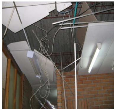
Figura 1. Demolición de muros y retiro de cielo raso.
