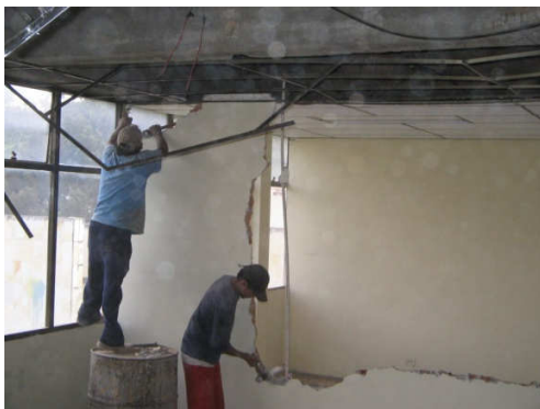
Figura 18. Demolición de muros.
