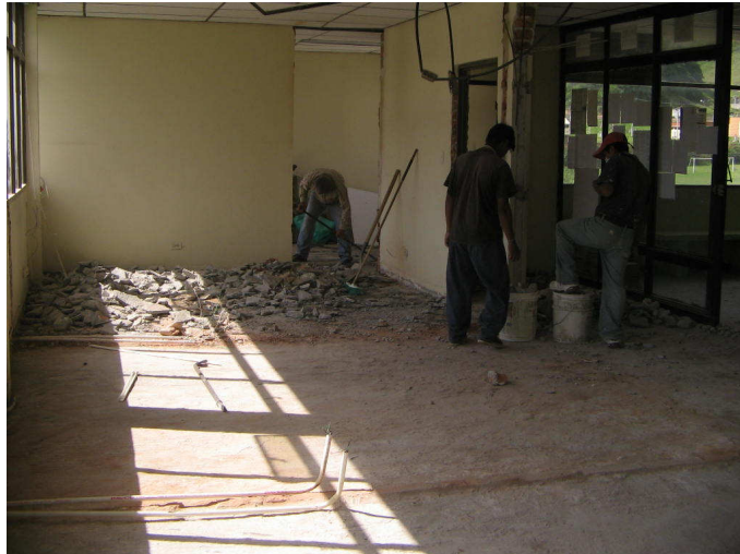
Figura 21. Desalojo de escombros con herramientas manuales.
