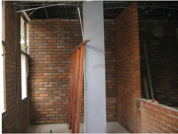
Figura 9. Desmonte de ventana en madera
