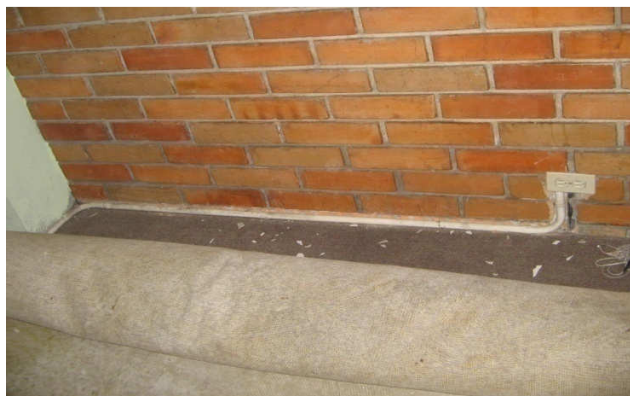
Figura 16. Reinstalación del tapete.
