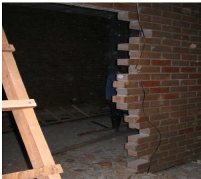
Figura 1. Demolición de muros y retiro de cielo raso.
