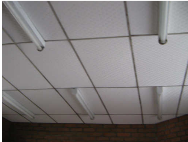
Figura 17. Nuevo cielo raso instalado.
