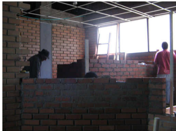
Figura 2. Formación de la nueva distribución de espacios.
