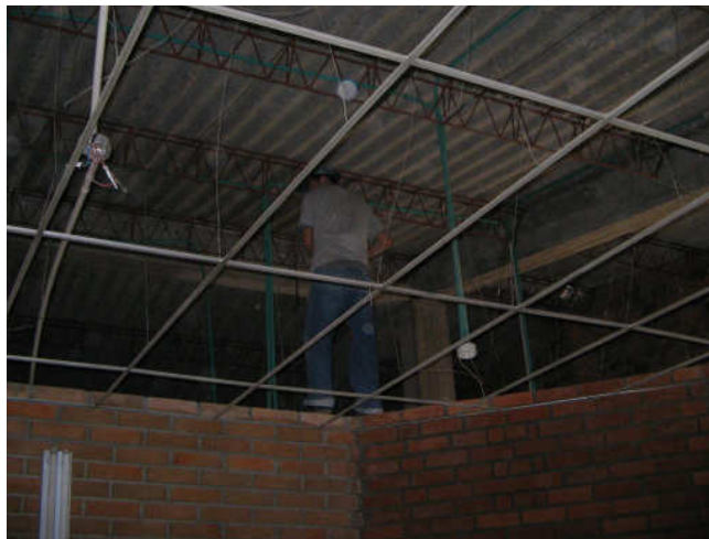
Figura 15. Red de bajantes conduit para la instalación de lámparas.
