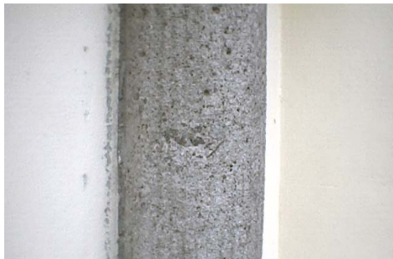
Figura 90. Columna abusardada
