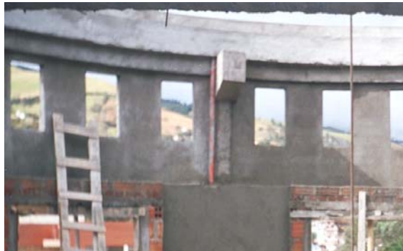
Figura 52. Bajante de aguas lluvias de la viga canal del Bloque 4
