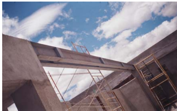
Figura 39. Montaje de doble cercha Bloque 4
