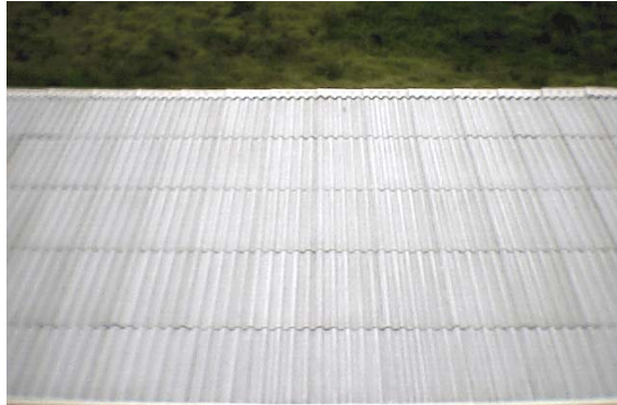
Figura 47. Instalación completa de terminal sobre muro en cubierta
