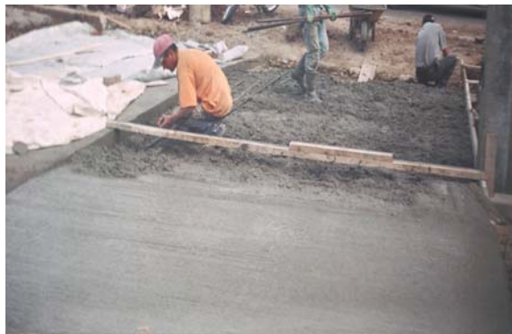
Figura 124. Fundición del pavimento segunda franja
