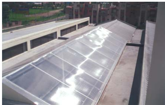
Figura 50. Policarbonato instalado
