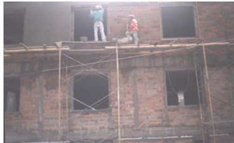
Figura 70. Revoque de fachada Bloque 4
