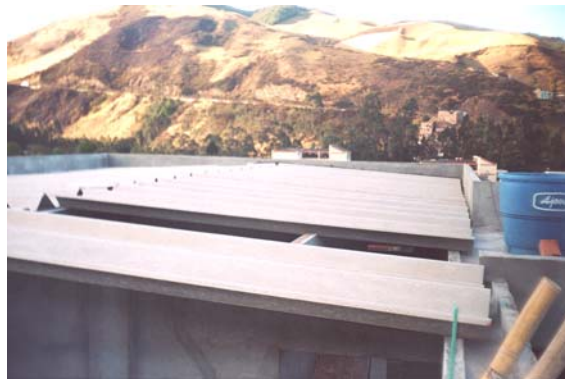
Figura 41. Instalación de canaleta 90 en el Bloque 4
