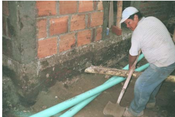
Figura 62. Instalación de acometida general, mejoramiento y compactación terreno
