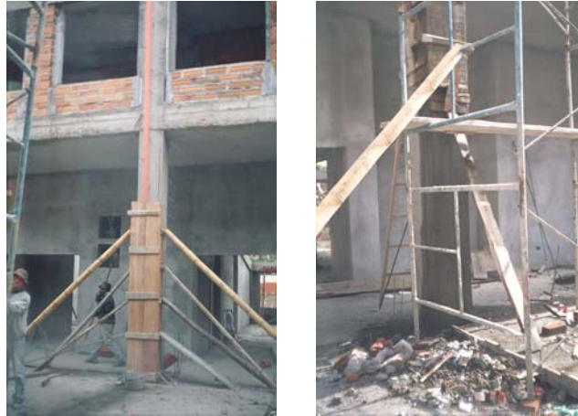
Figura 53. Encofrado y fundición del buitrón para la tubería de aguas lluvias
