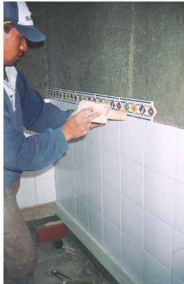
Figura 148. Enchape de muros de baños
