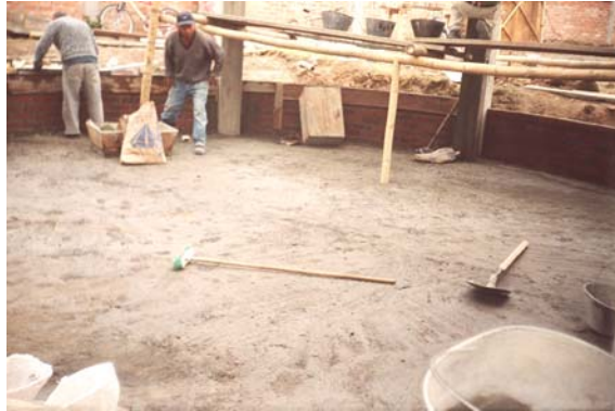
Figura 141. Placa de piso fundida
