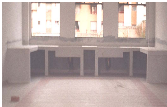
Figura 86. Granito pulido en mesones y pocetas de Taller del Bloque 1
