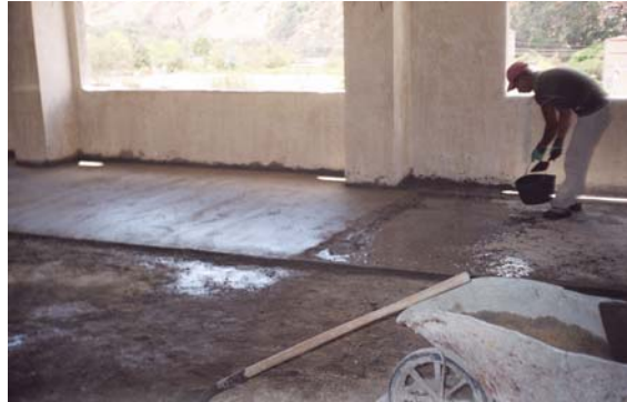
Figura 78. Pañete de pisos por franjas Bloque 4
