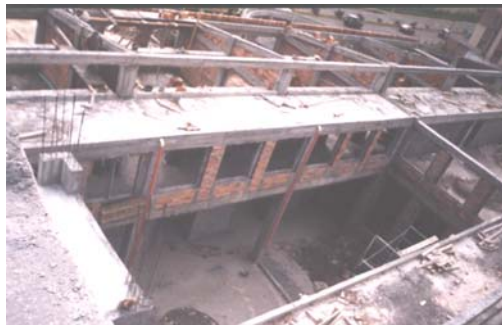
Figura 54. Tuberías de aguas lluvias en jardineras y cortes en losa
