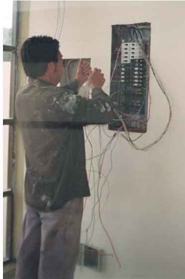
Figura 68. Montaje de Tableros eléctricos con breakers (Bloque 5)
