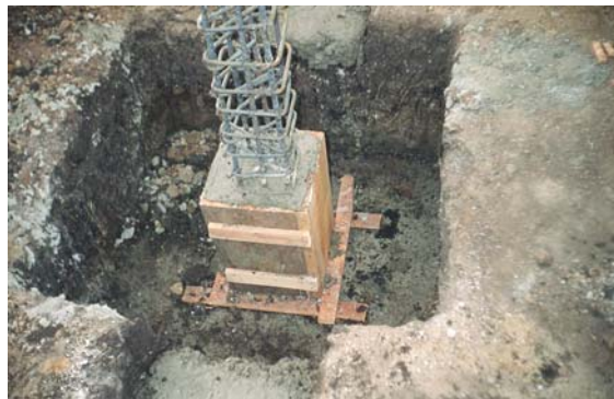
Figura 130. Fundición de zapatas y pedestales
