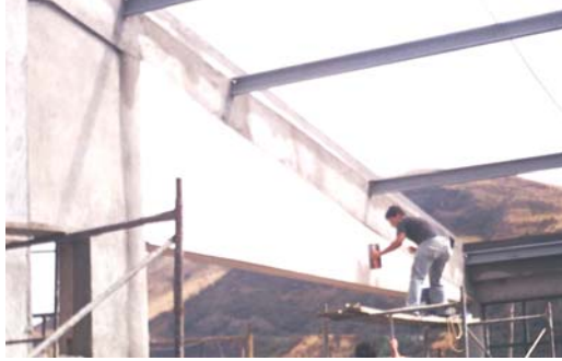
Figura 91. Placa de superboard terminada en viga flotante
