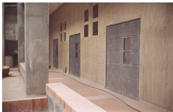
Figura 79. Estuco de muros en corredores
