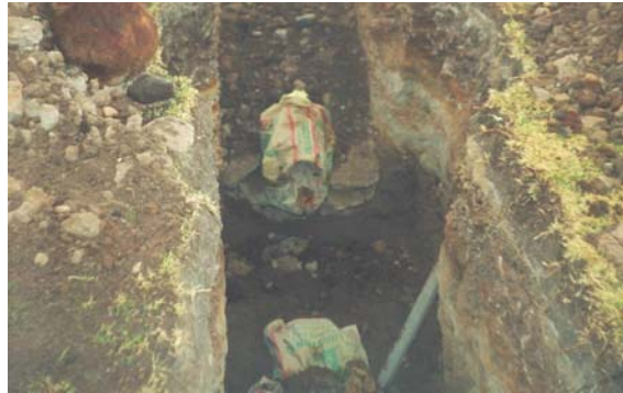
Figura 139. Tubos para empate en cajas de inspección
