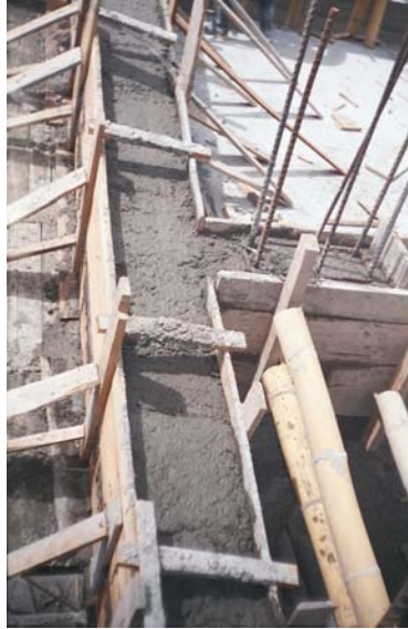
Figura 17. Presentación final de la fundición en las vigas de coronamiento y nudos
