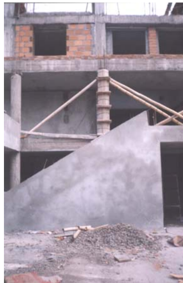
Figura 7. Detalle encofrado de Columnas
