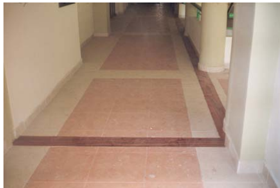
Figura 84. Dilataciones en granadillo terminadas
