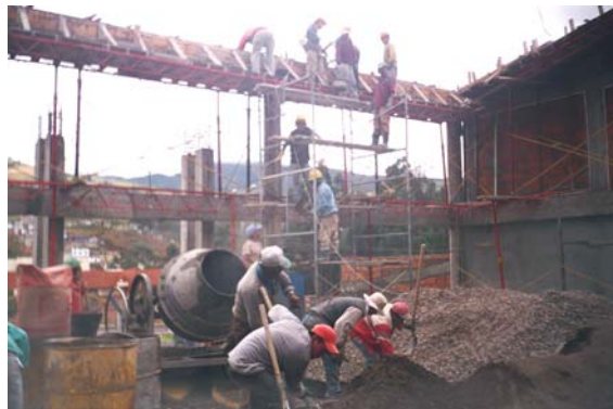
Figura 14. Vaciado y vibrado del concreto en las vigas canal
