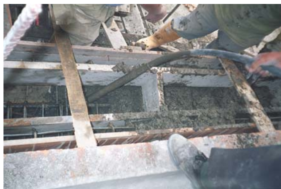
Figura 14. Vaciado y vibrado del concreto en las vigas canal
