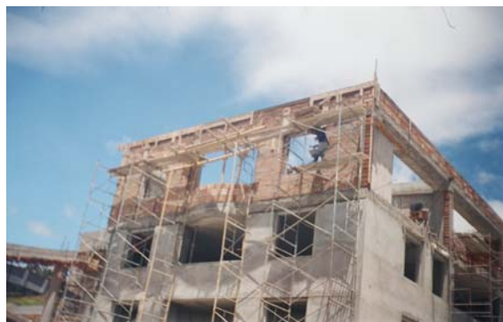
Figura 24. Muros en soga doble anclados a las pantallas (Bloque 4)
