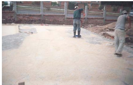
Figura 119. Llenado de las juntas entre los adoquines con arena fina
