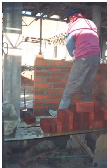
Figura 142. Pega de muros en baños
