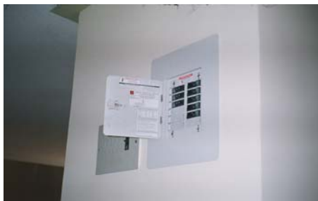
Figura 67. Montaje de Tableros eléctricos y regulados con breakers (Bloque 4 cuarto piso)
