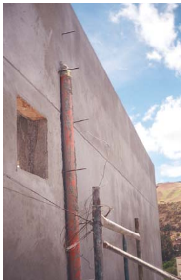
Figura 52. Bajante de aguas lluvias de la viga canal del Bloque 4
