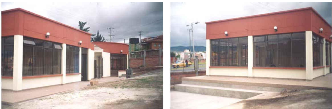
Figura 150. Pintura de fachadas
