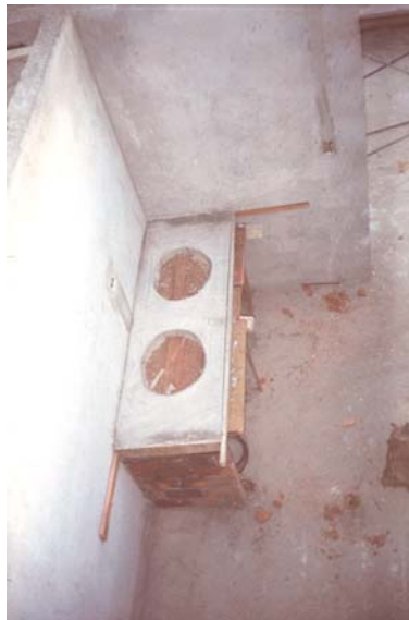
Figura 61. Elaboración de mesón en baño del Bloque 4 cuarto piso
