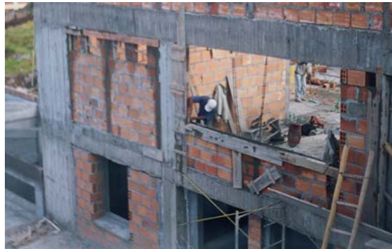
Figura 25. Fundición de columnetas y viguetas en la fachada del Bloque 4
