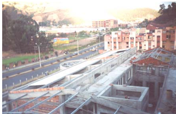
Figura 43. Instalación de cubierta en los Bloques 1 y 3
