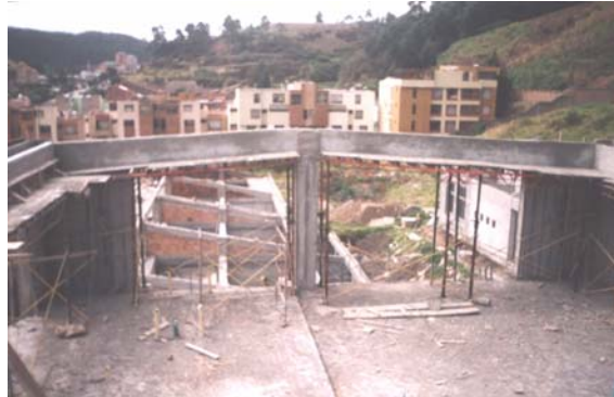
Figura 4. Vigas de coronamiento inclinadas, encofradas en la parte inferior
