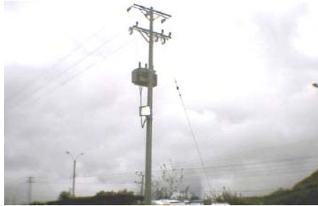
Figura 65. Montaje de poste y transformador
