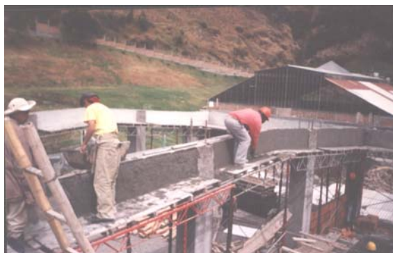
Figura 74. Revoque de vigas de coronamiento Bloque 4
