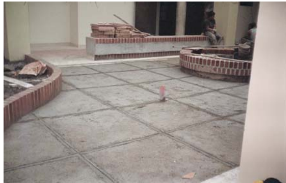
Figura 87. Preparación para la instalación de gravilla con las juntas en vidrio
