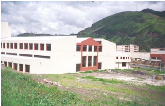
Figura 98. Pintura de fachadas Bloques 1 y 2
