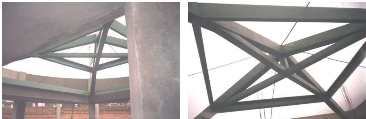
Figura 143. Estructura metálica de cubierta
