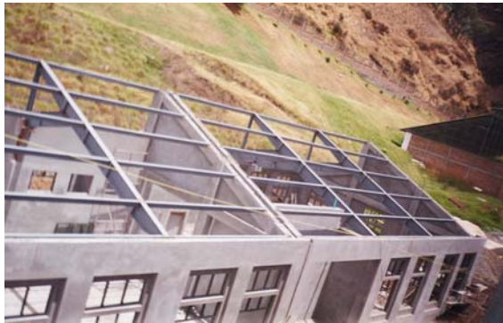
Figura 34. Correas instaladas completamente
