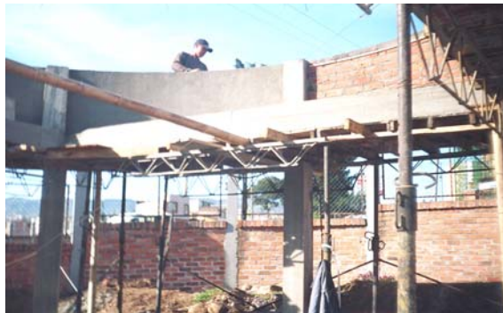
Figura 134. Columnas fundidas y desformaletadas. Formaleta y losa fundida, aula circular
