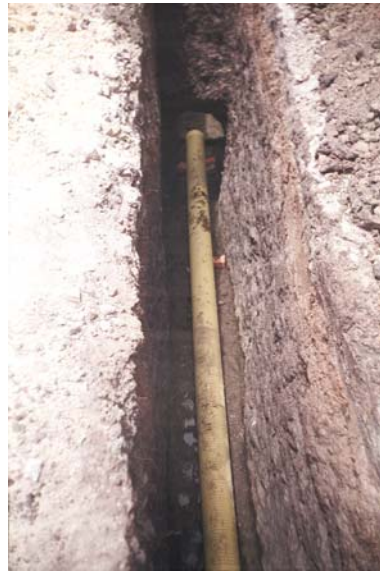
Figura 111. Instalación de tubería Novafort
