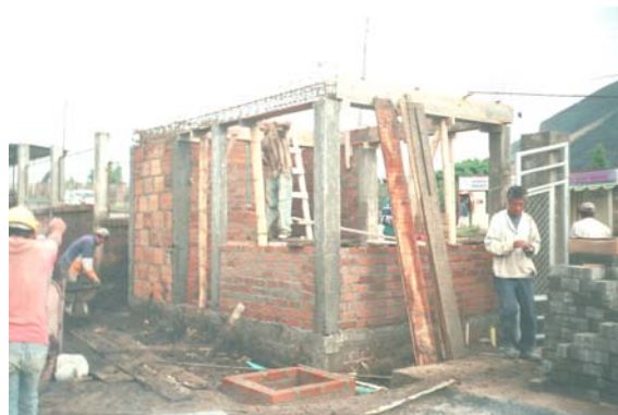
Figura 116. Construcción caseta del celador
