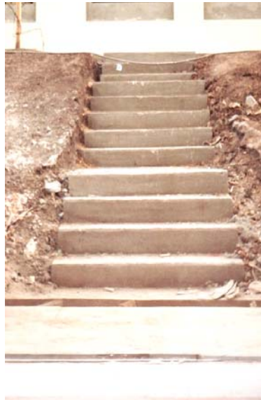
Figura 106. Escalera 2 que comunica a Talleres con el Bloque 4
