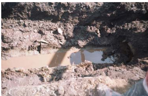
Figura 60. Terreno y canal por el cual pasa la tubería de alcantarillado general
