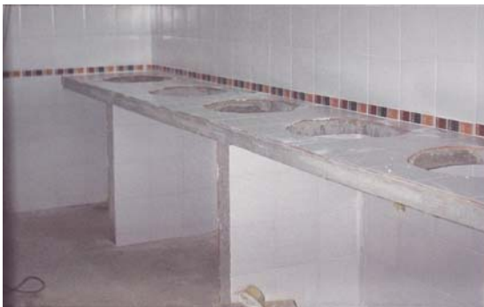
Figura 81. Enchape de mesones y muros de soporte en baños
