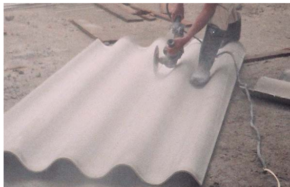
Figura 44. Corte de cubierta en obra
