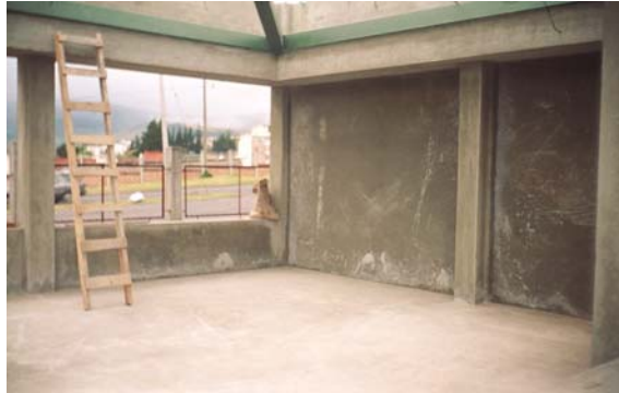
Figura 147. Repello de vigas, columnas y muros de aula cuadrada
