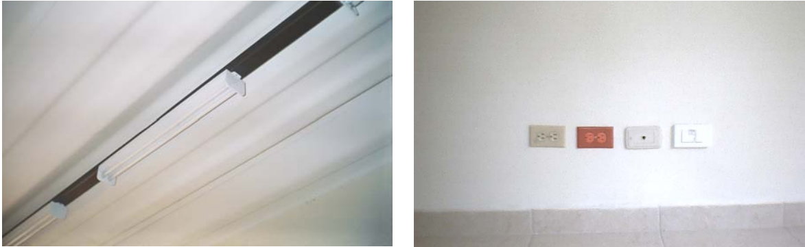
Figura 95. Instalación de lámparas y tomas N – R – S – T.
