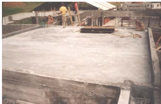
Figura 5. Losa de Tanques esmaltada y desencofrada en los laterales
