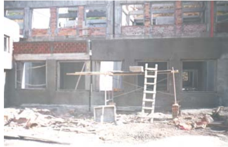
Figura 69. Revoque de fachadas Bloques 1 y 3
