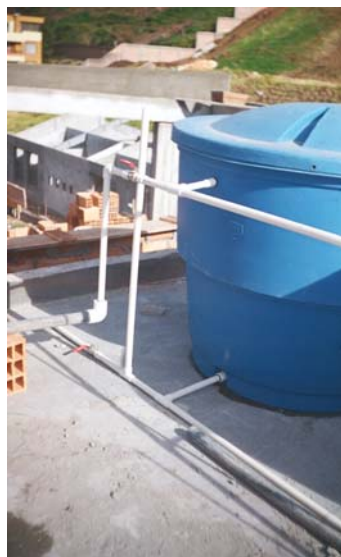
Figura 56. Tubería de agua que llega y sale de los Tanques de Almacenamiento
