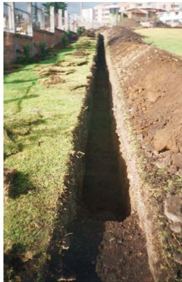
Figura 137. Excavación para alcantarillado
