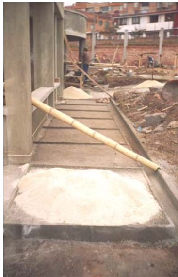
Figura 154. Preparación del andén para instalar gravilla lavada
