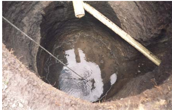
Figura 114. Excavación para cámara circular
