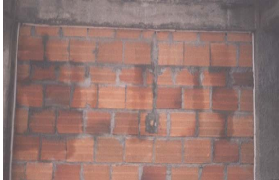
Figura 27. Instalación de icopor en juntas
