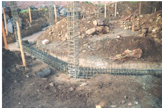
Figura 132. Armado de vigas de cimentación
