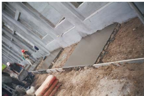
Figura 104. Fundición de andenes
