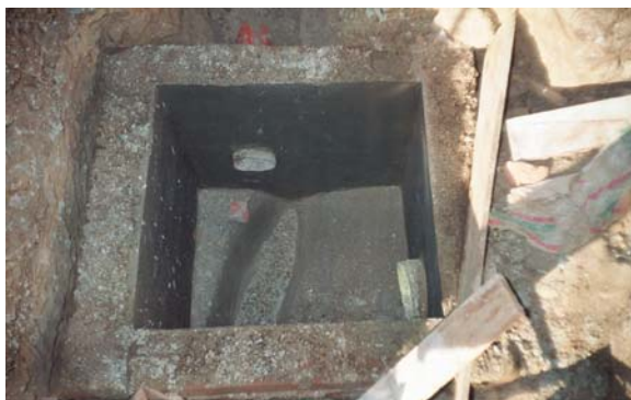
Figura 140. Cajas de inspección
