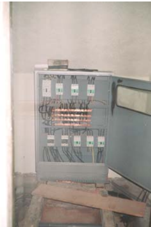
Figura 66. Montaje de gabinete metálico con barrajes y soportes
