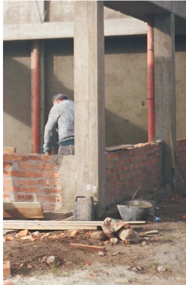
Figura 135. Instalación de tubería de aguas lluvias
