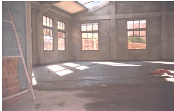
Figura 76. Pañete de pisos Talleres
