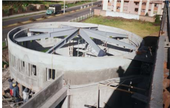
Figura 38. Montaje completo de las cerchas en el Bloque Circular
