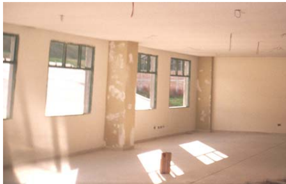
Figura 96. Pintura de muros y posteriores resanes
