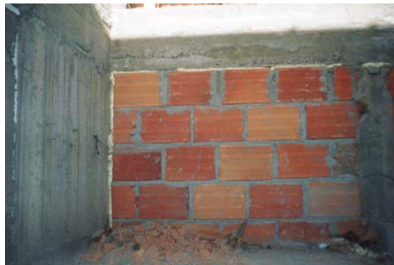
Figura 26. Instalación de Espuma Hilti en juntas
