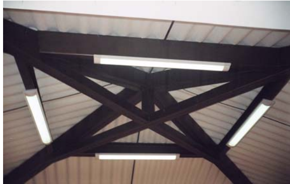
Figura 149. Instalación de lámparas
