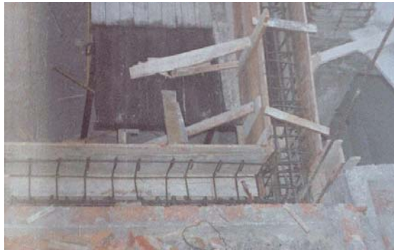
Figura 10. Encofrado en la unión entre la viga canal y de coronamiento
