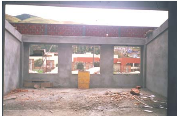
Figura 30. Pega de parapetos con fundición de columnetas y viguetas
