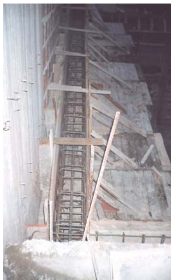
Figura 11. Disposición del hierro en los nudos de las vigas de coronamiento
