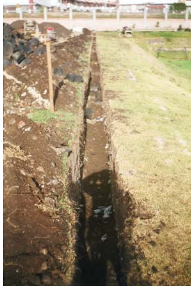
Figura 156. Excavación para reja de cierre
