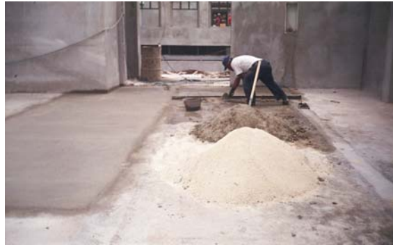
Figura 75. Preparación de mortero y pañete de pisos Talleres
