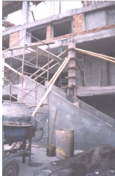
Figura 8. Preparación de materiales y equipos para la fundición
