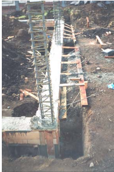
Figura 133. Fundición de vigas de cimentación
