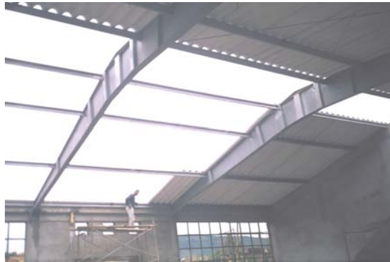
Figura 40. Instalación de cubierta en Talleres por filas
