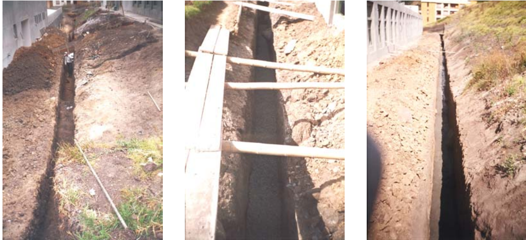
Figura 108. Excavaciones alrededor de los bloques
