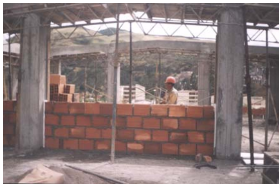
Figura 20. Pega de muros divisorios en el cuarto piso del Bloque 4
