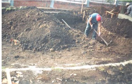
Figura 127. Descapote, replanteo e instalación de puentes
