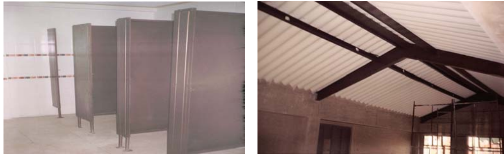
Figura 100. Pintura de divisiones de baño, cerchas y correas metálicas
