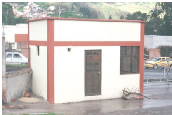
Figura 117. Caseta del celador terminada
