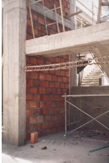
Figura 21. Pega de muros fotocopiadora
