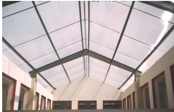
Figura 49. Instalación completa de cerchas, correas y láminas para el policarbonato en Jardineras
