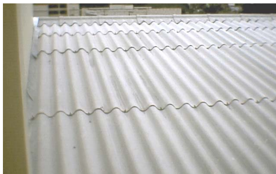
Figura 46. Instalación de caballetes al final de la pendiente en cubierta a dos aguas (Bloque 5)
