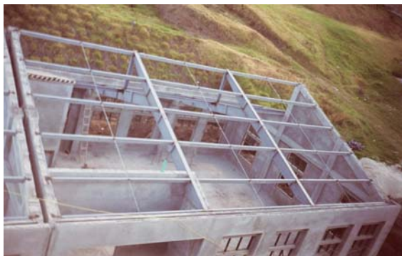
Figura 35. Instalación de riostras
