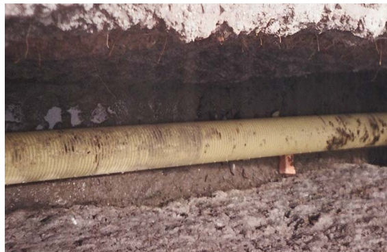
Figura 138. Instalación de tubería Novafort
