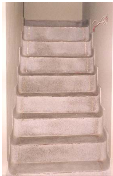
Figura 85. Gradas en granito y dilatación y protector en bronce
