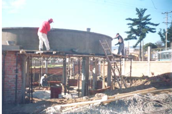
Figura 145. Elaboración de alfajías y repello de parapetos
