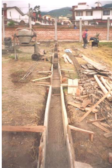
Figura 157. Fundición en concreto ciclópeo para reja de cierre
