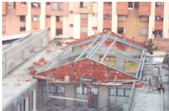
Figura 28. Pega de tímpanos Bloque 1
