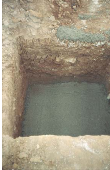
Figura 129. Fundición de solado para zapatas
