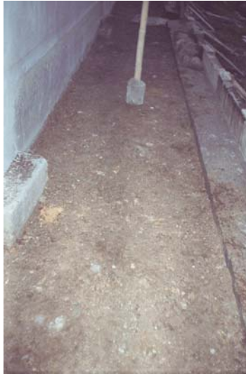
Figura 103. Compactación con pisón de mano
