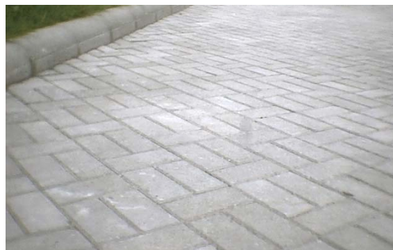
Figura 121. Forma de instalación del adoquín
