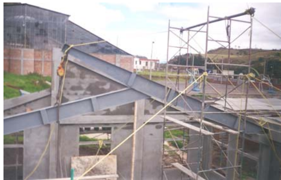
Figura 32. Armada de andamios y montaje de poleas
