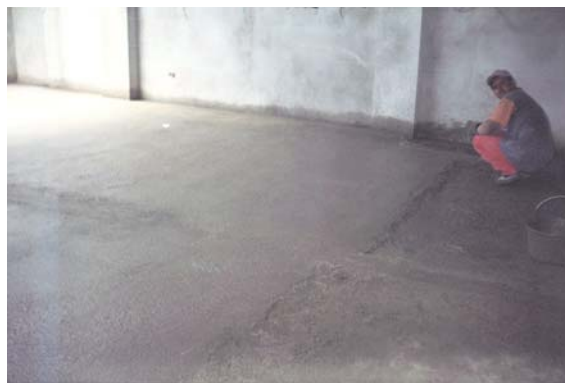
Figura 77. Pañete de pisos Bloque 2
