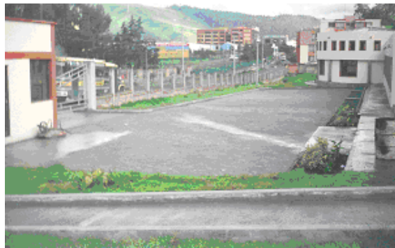
Figura 107. Rampa de entrada al Bloque 5
