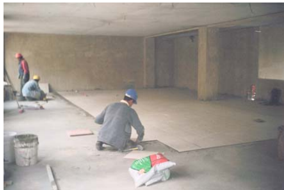
Figura 82. Proceso de enchapado de pisos
