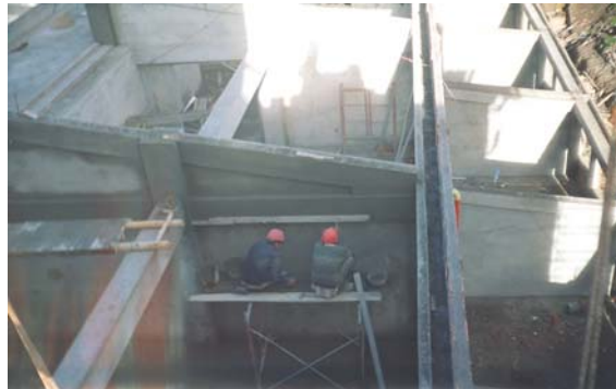
Figura 73. Revoque de vigas y tímpanos muros internos Bloque 2
