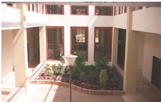
Figura 99. Pintura de fachadas Internas Bloques 1, 2 y 3
