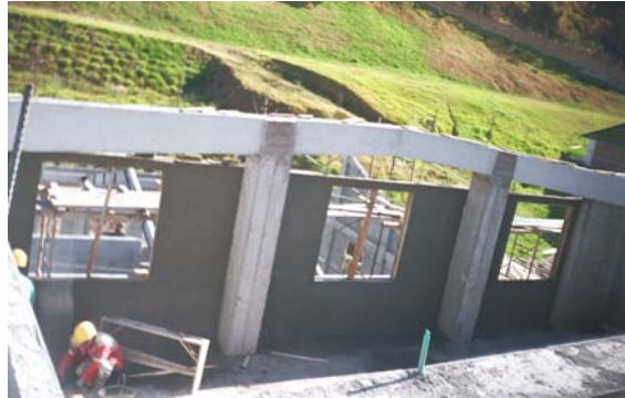
Figura 72. Revoque de muros internos Bloque 4 cuarto piso
