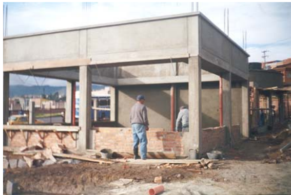
Figura 146. Repello de parapetos y elaboración de estrías
