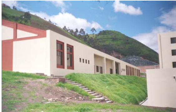
Figura 97. Pintura de fachadas Talleres
