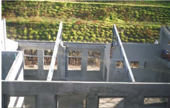
Figura 33. Estructura de cerchas instaladas
