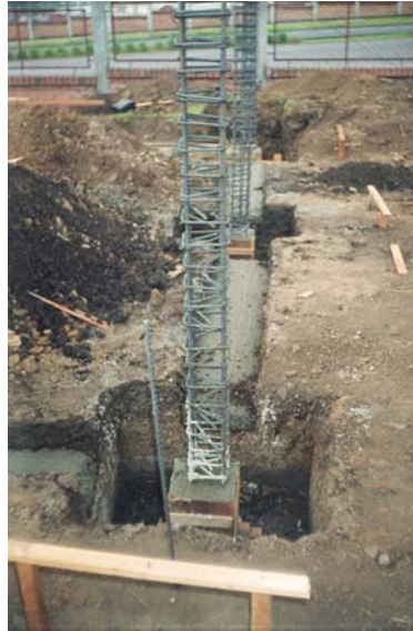
Figura 131. Fundición de solado para vigas de cimentación
