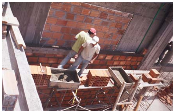
Figura 22. Pega de muros Bloque 5
