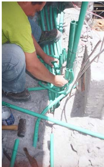
Figura 63. Instalación de ductería del Bloque 4
