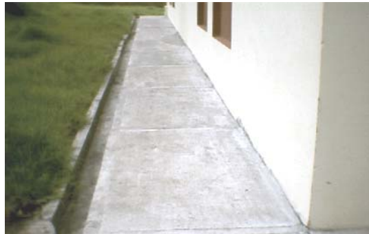
Figura 105. Anden terminado con cañuela
