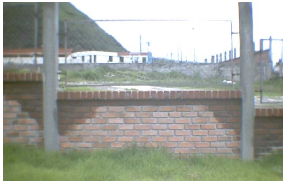
Figura 115. Tramo del muro de cierre
