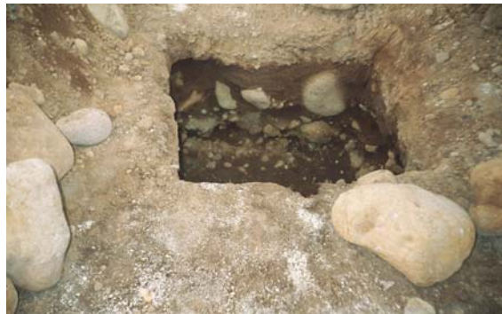
Figura 128. Excavación para zapatas, rocas
