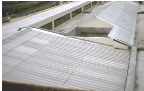
Figura 48. Lámina de zinc en cubierta Bloque 5
