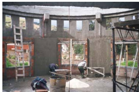
Figura 71. Revoque de muros internos Bloque Circular
