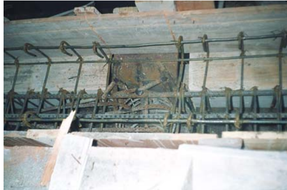
Figura 12. Disposición del hierro en la unión de las columnas circulares con las vigas canal
