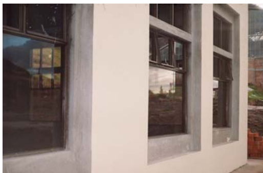
Figura 92. Vidrios instalados en el sector de Talleres
