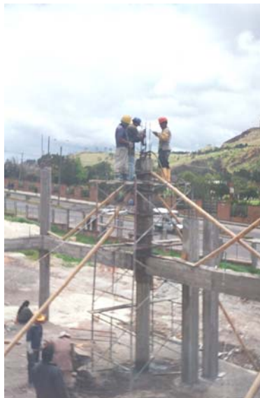
Figura 9. Vaciado y vibrado del concreto
