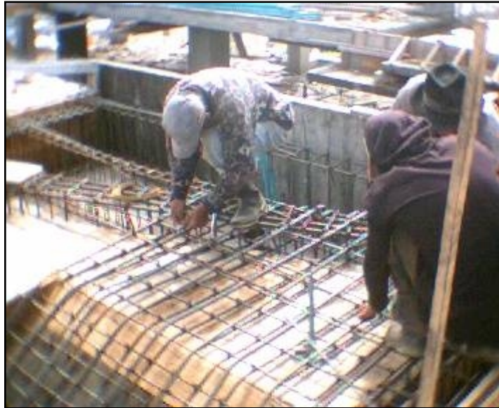
Figura 22. Armado de acero de refuerzo de descanso de escalera
