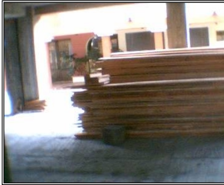
Figura 4. Almacenamiento de madera bajo techo
