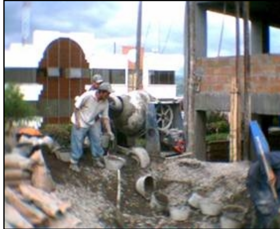
Figura 13. Elaboración de concreto.
