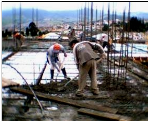
Figura 14. Vibrado de concreto
