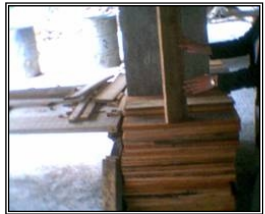
Figura 6. Reposición de madera de casetón.
