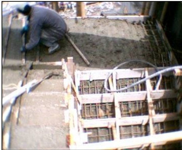
Figura 23. Fundición de escalera
