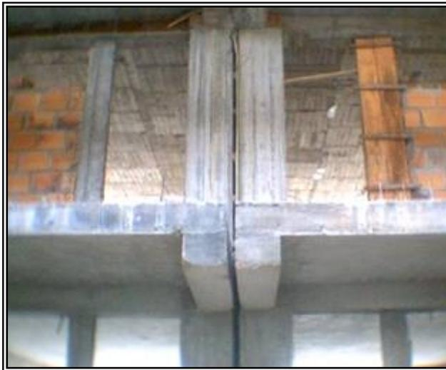
Figura 40. Vigas cargueras descolgadas ubicadas en la dilatación de los bloques 1 y 2 en el 3º piso.
