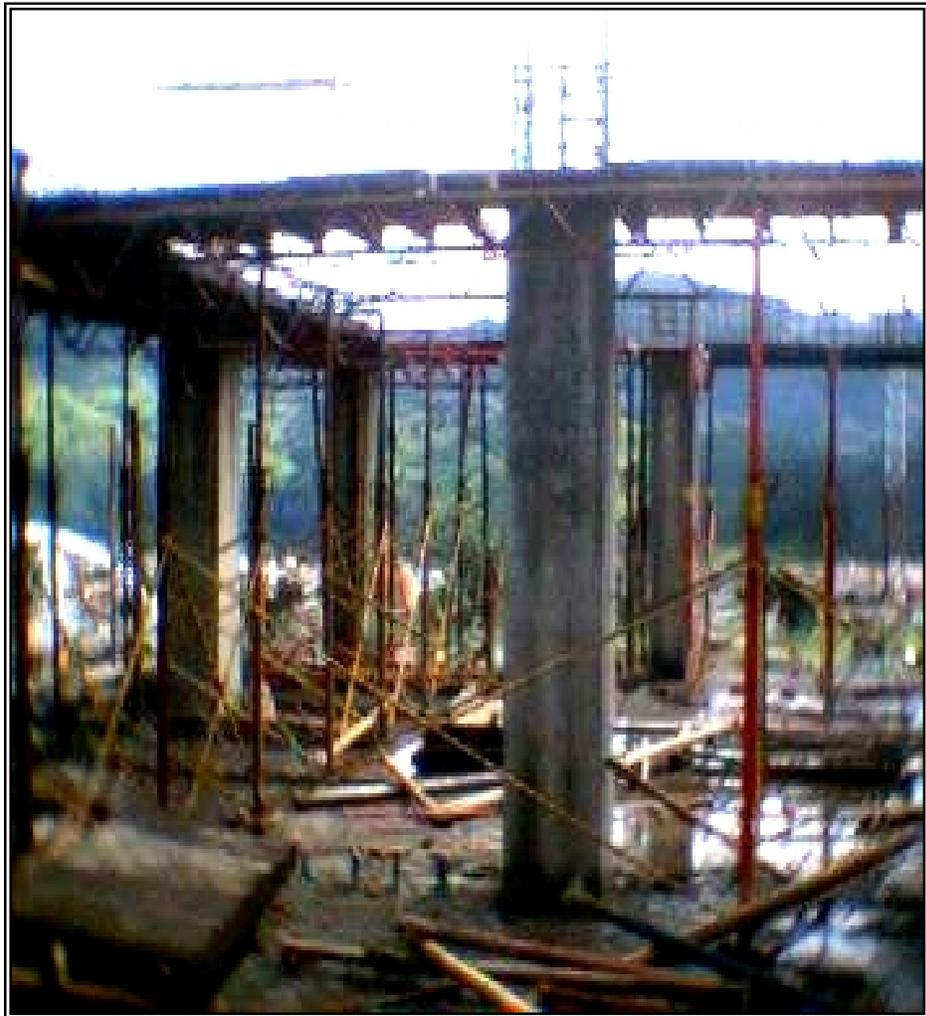
**Figura 48. Formaleta metálica para vigas B1 piso 5**
