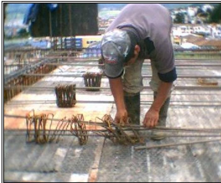
**Figura 72. Colocación de estribos del nervio 6 B2 piso 4**
