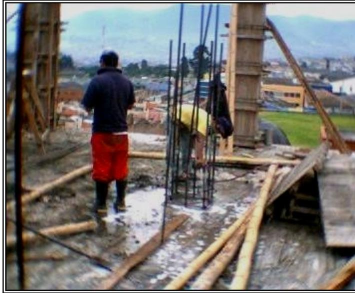
**Figura 9. Refuerzo longitudinal de columna antes del traslapo**
