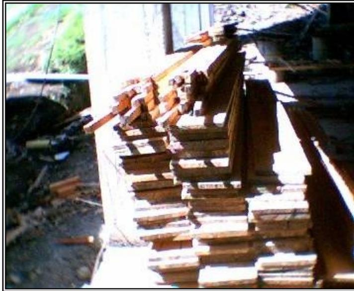
**Figura 13. Madera de achapo para formaleta de columnas.**
