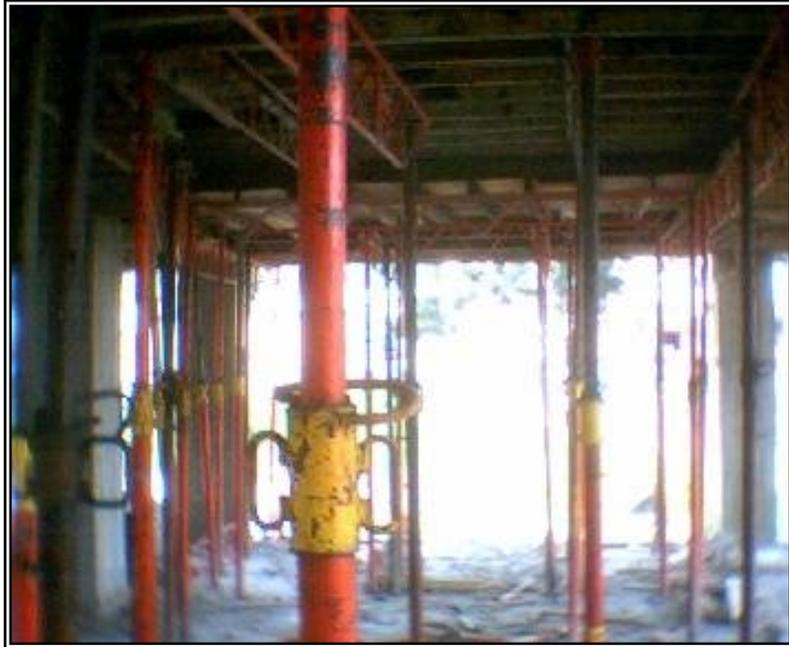
**Figura 69. Formaleta completamente armada.**
