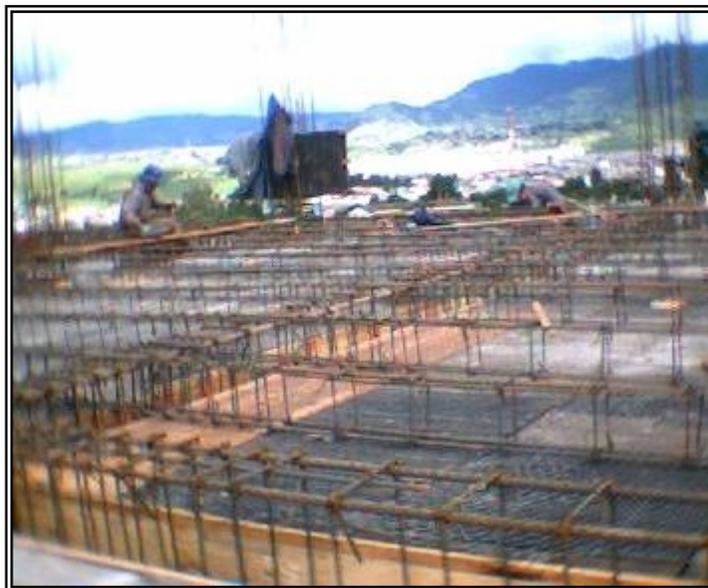
**Figura 74. Vista panorámica armado de refuerzo vigas de entrepiso y nervaduras**
