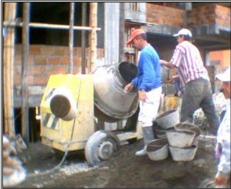
**Figura 21. Mezclado de concreto**
