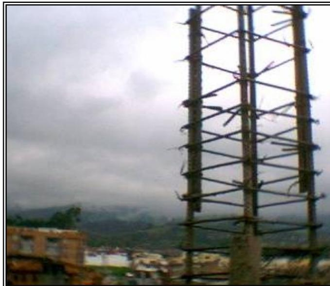
**Figura 10. Traslado de refuerzo longitudinal de Columna N12 B3 piso 4**
