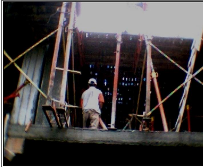
Figura 67. Colocación de tacos para armado de formaleta.
