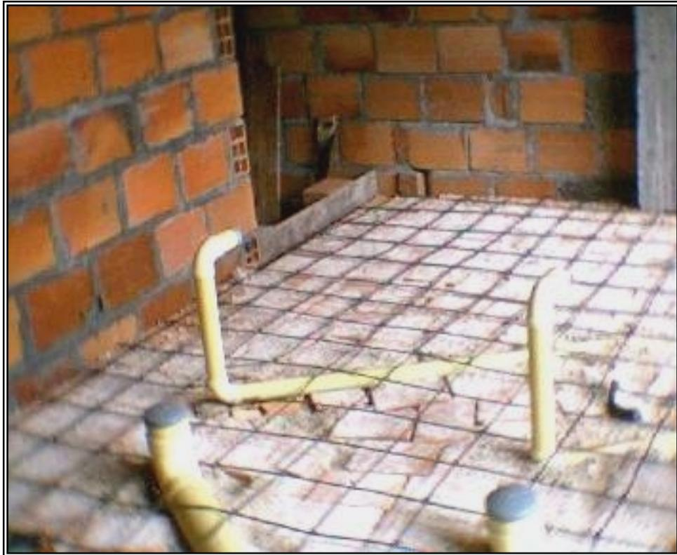
**Figura 118. Punto sanitario y armado de sobrelosa**
