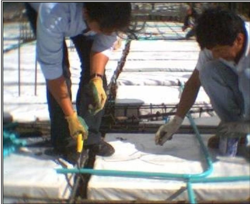
Figura 120. Instalación de ductos eléctricos
