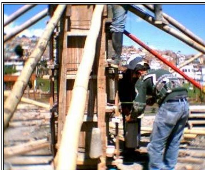
**Figura 27. Rectificación de alineamientos y verticalidad de la columna fundida.**
