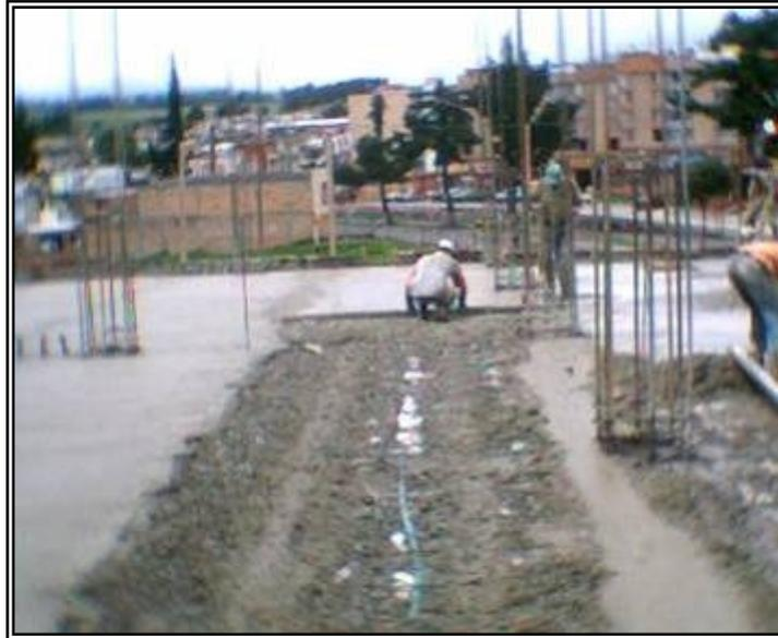
**Figura 90. Guías de tallado de loseta superior.**
