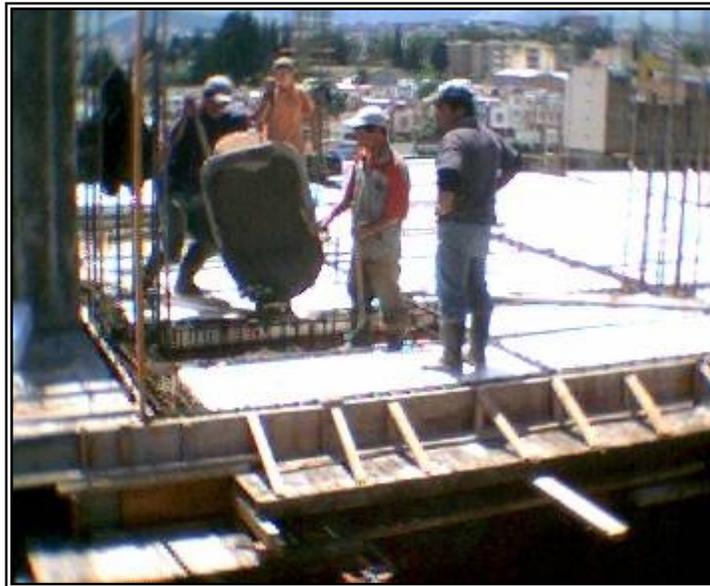
**Figura 82. Vaciado de mortero de loseta inferior.**
