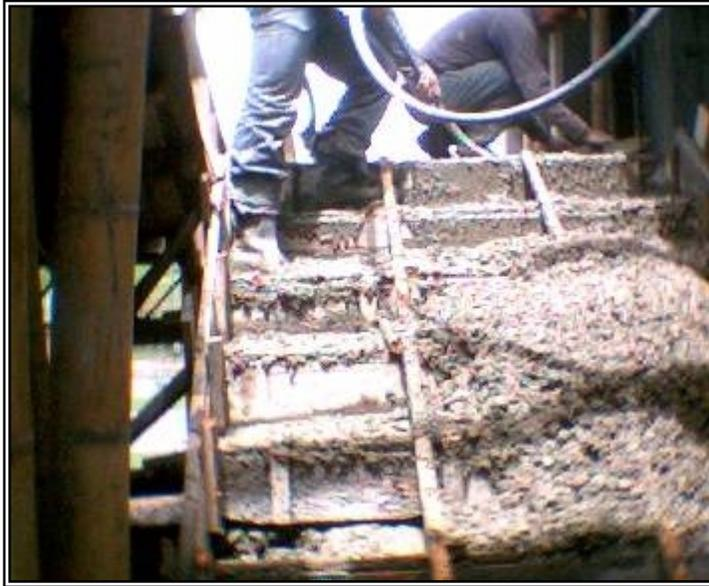
**Figura 101. Vaciado de concreto en peldaños de escalera**
