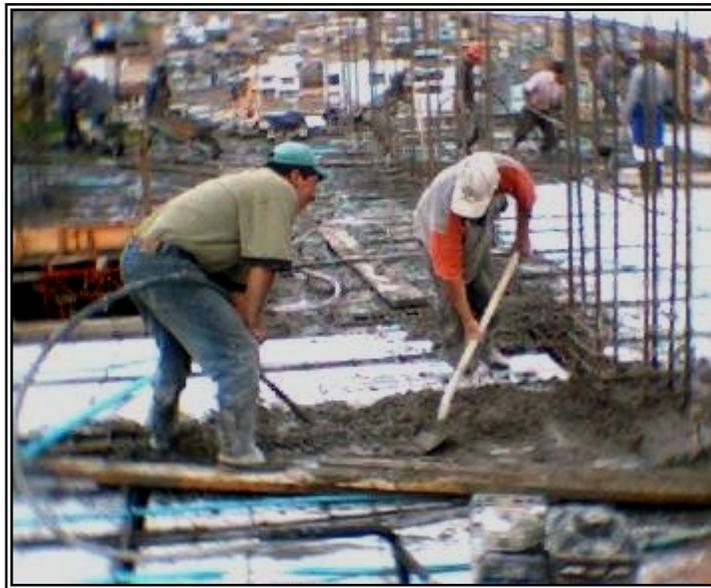
**Figura 58. Vibrado de viga C B1 Piso 4**
