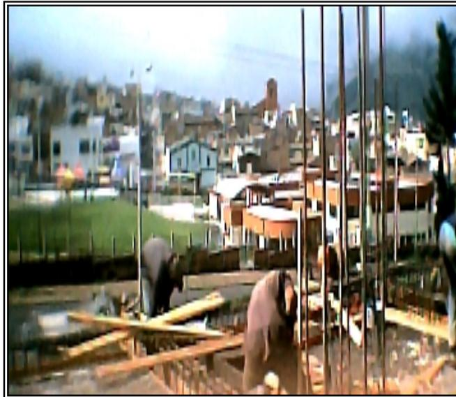
**Figura 49. Colocación de formaleta lateral para vigas B1 piso 5**
