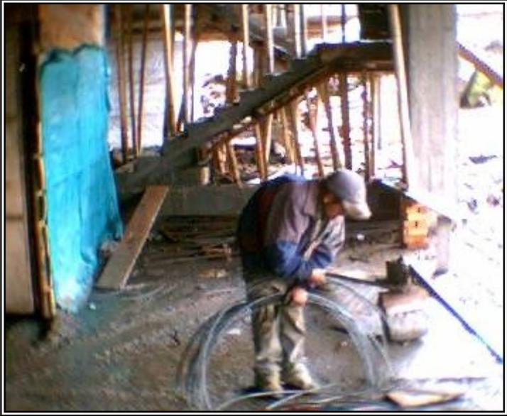
**Figura 64. Corte de hierro No. 2 para flejes de nervaduras**
