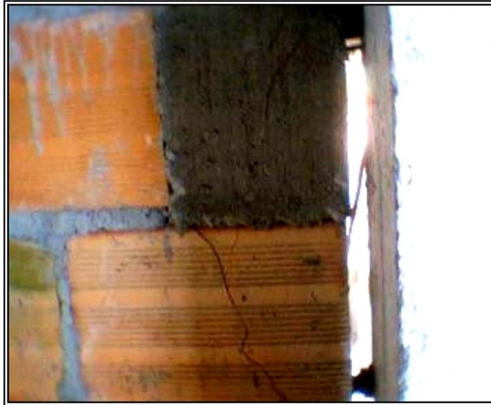
**Figura 110. Dilatación entre muro y columna.**
