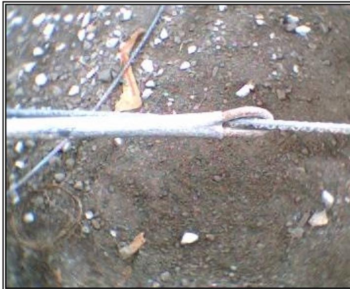
**Figura 63. Método para desdoblar hierro No. 2 y No.3 para nervios de losa**
