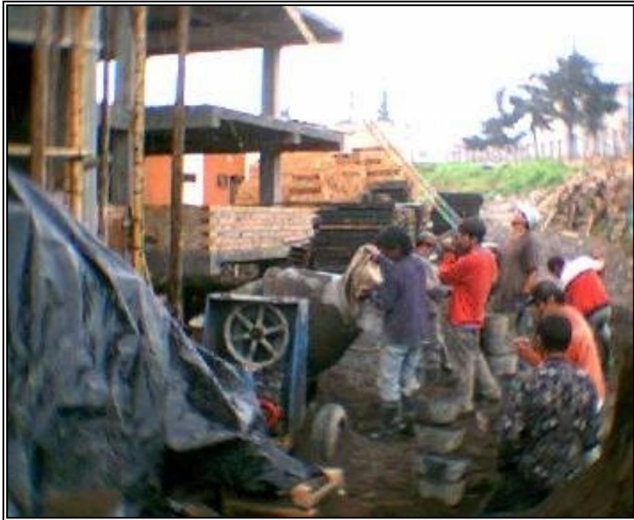
**Figura 54. Elaboración de concreto en mezcladora**
