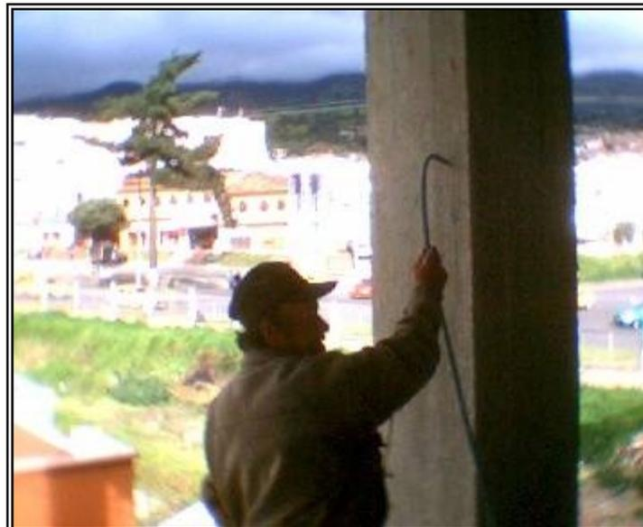
**Figura 30. Curado de columnas.**
