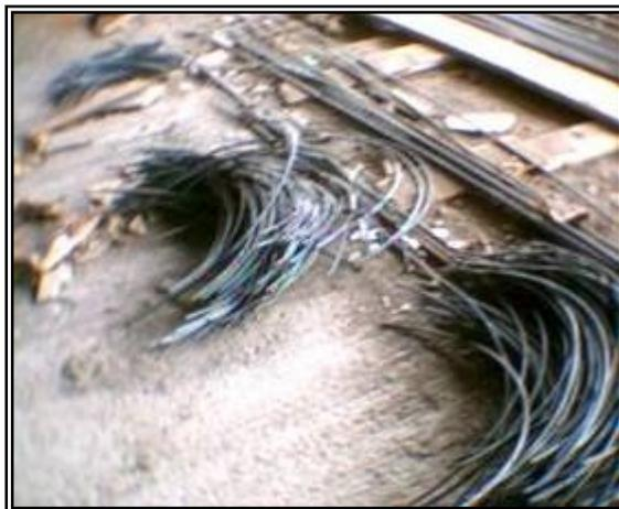
**Figura 3. Hierro No. 3 cortado para refuerzo transversal de columnas**
