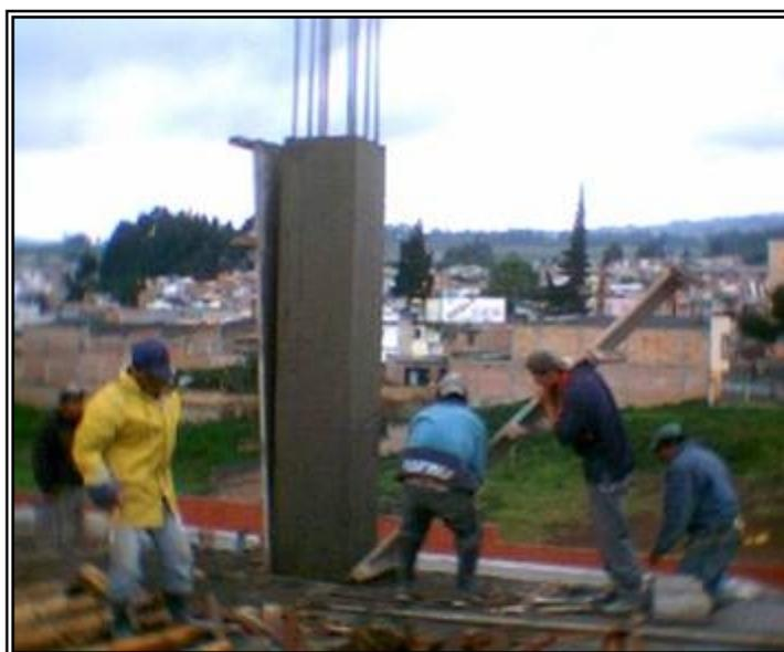
**Figura 28. Descimbrado de Columnas I10 B2 piso 4**
