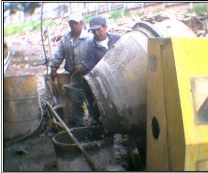
**Figura 22. Vaciado de concreto del trompo de mezcladora al balde de pluma grúa**
