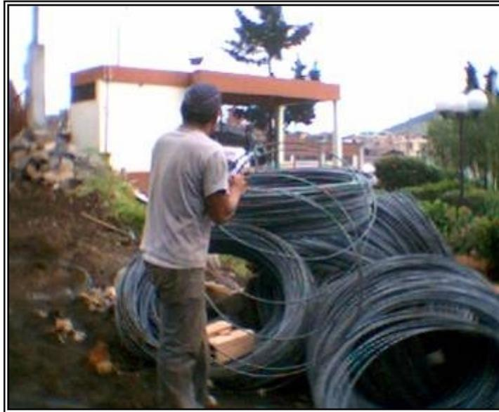
**Figura 62. Hierro para nervaduras de losa**
