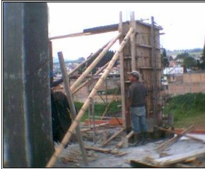
**Figura 36. Formaleta lista para la fundición**
