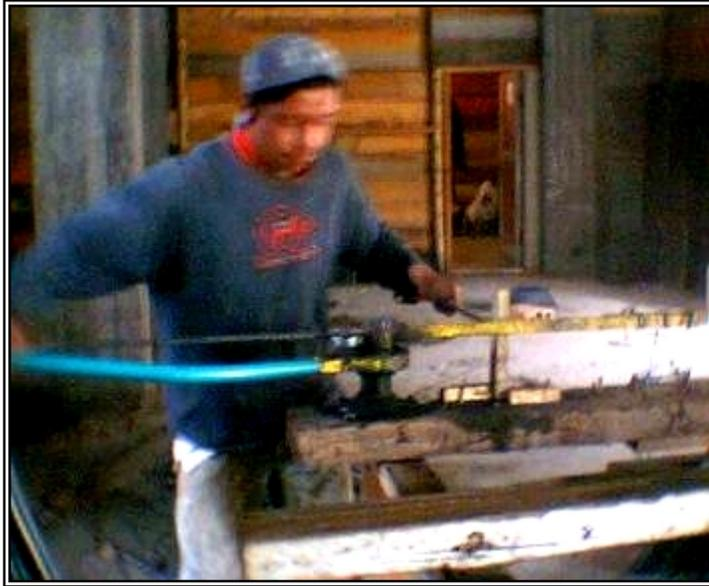
Figura 44. Figurado de hierro para flejes de vigas.
