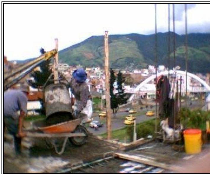
**Figura 56. Transporte de concreto por medio de pluma grúa.**
