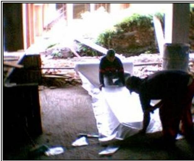
**Figura 78. Recubrimiento de casetón con tela aligflex.**
