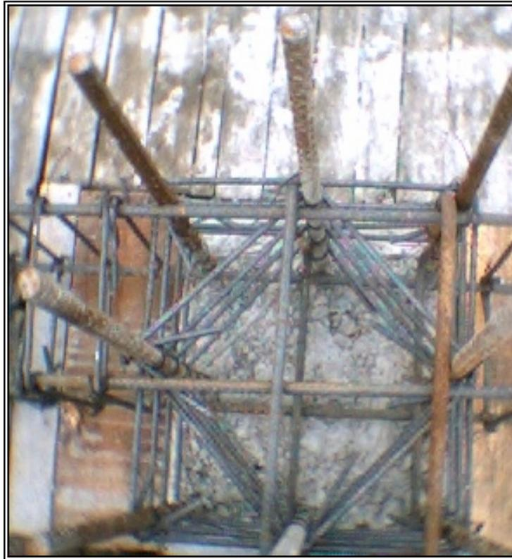
**Figura 11. Flejes de columnas**
