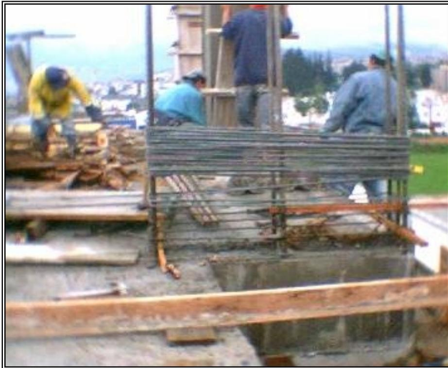
**Figura 33. Armado de Pantalla**
