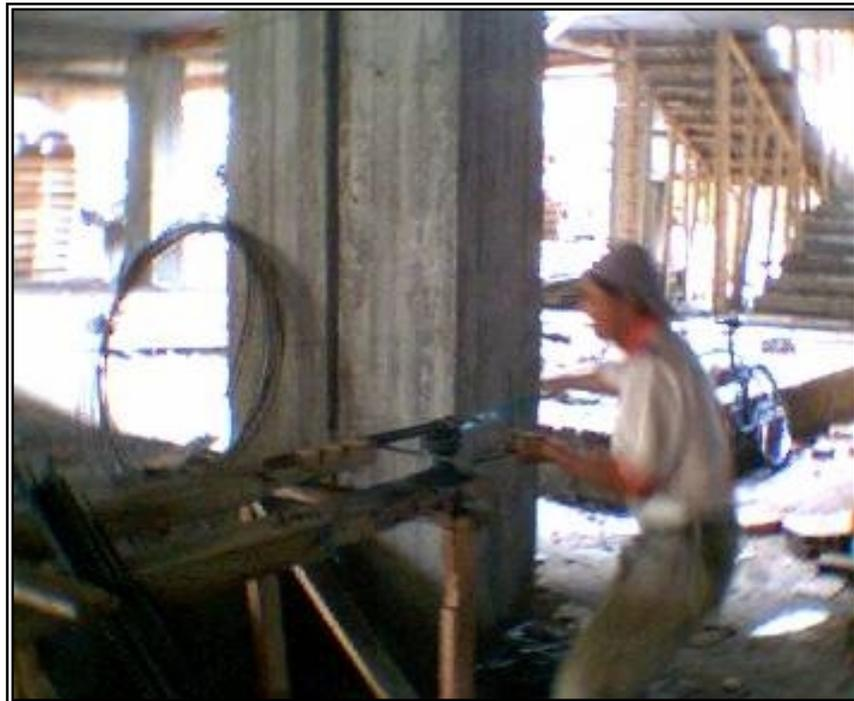
**Figura 4. Figurado de hierro No. 3 para armado de columnas**
