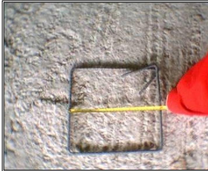
**Figura 5. Verificación de medidas de flejes**
