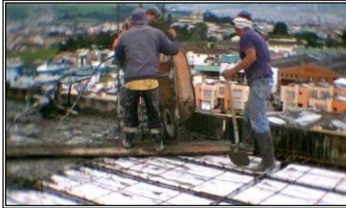
**Figura 57. Vaciado de concreto en la viga A B1 Piso 4**
