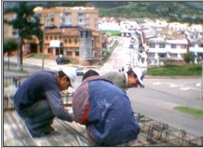
**Figura 71. Armado de varillas del nervio 2 B2 piso 4**
