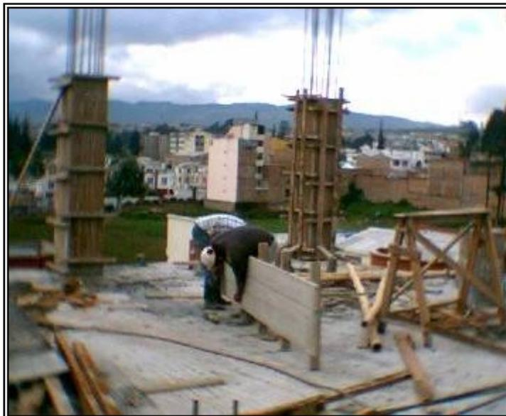
**Figura 14. Colocación de Tableros para formaleta de columna.**
