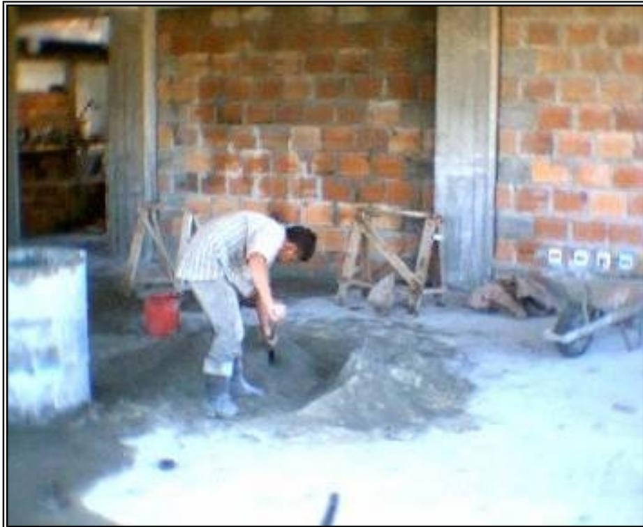
Figura 112. Elaboración de mortero y humedecimiento de muro
