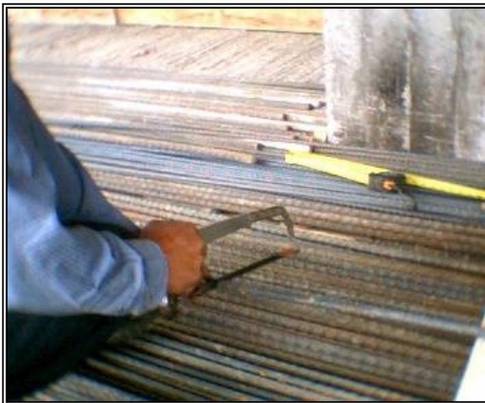
Figura 47. Corte de varilla para refuerzo por flexión de vigas
