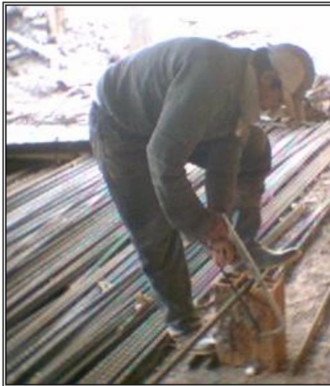
Figura 1. Corte de varilla No. 7 para armado de columnas.
