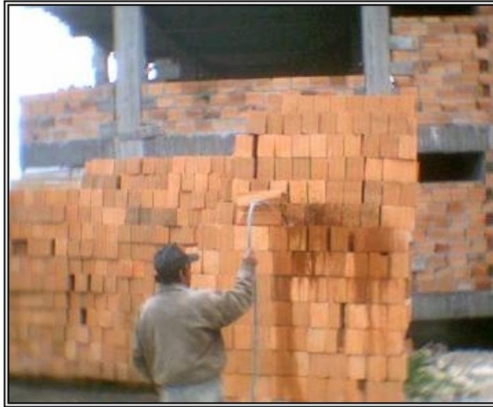
**Figura 107. Saturación de Bloque No. 5.**
