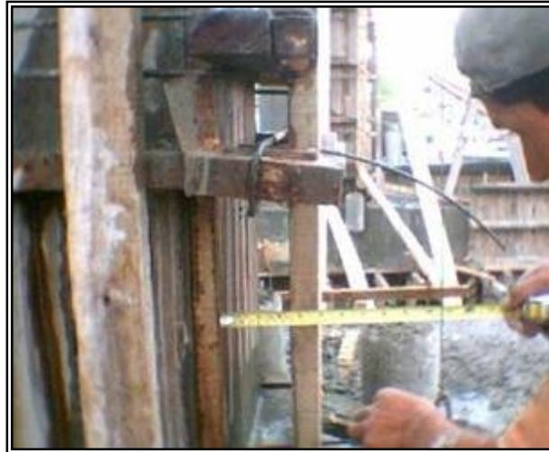
**Figura 16. Verificación de verticalidad Columna C2 B1 Piso 3**
