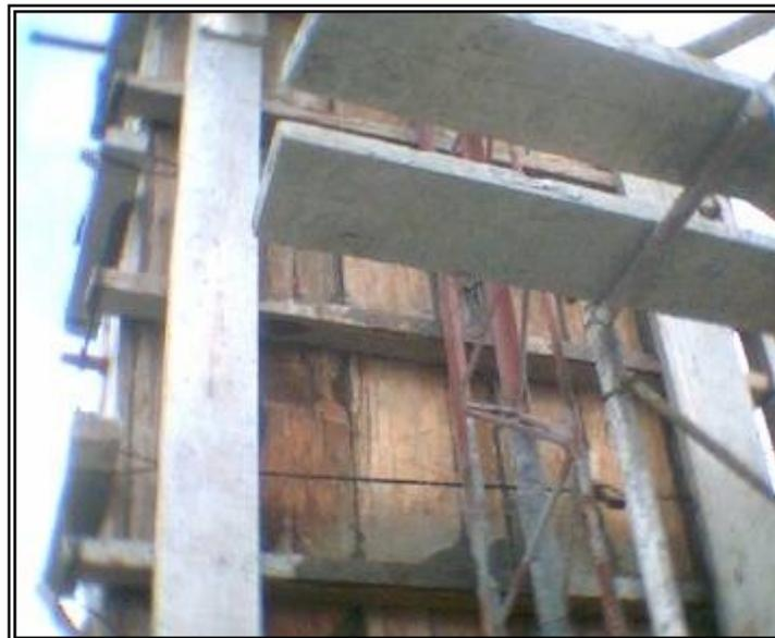
**Figura 35. Andamios para la fundición de la Pantalla**
