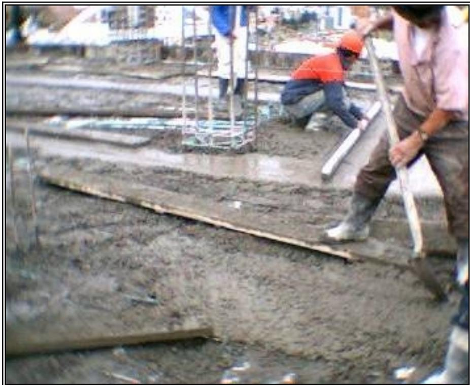
**Figura 89. Vaciado de concreto para loseta superior.**
