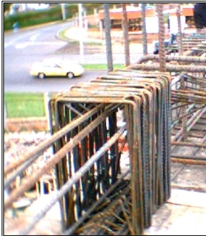
**Figura 51. Armado de refuerzo longitudinal y flejes de viga 10 B2 piso 4**
