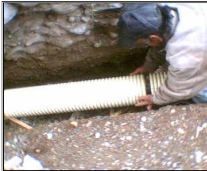
Figura 115. Instalación de tubería Novafort 8"
