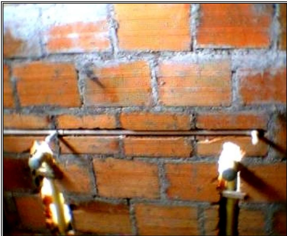
Figura 119. Vista de puntos hidráulicos.
