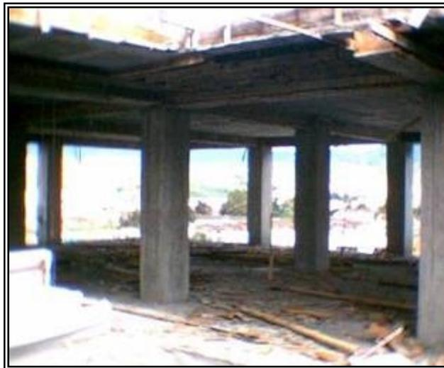
**Figura 93. Desencoframiento de losa**
