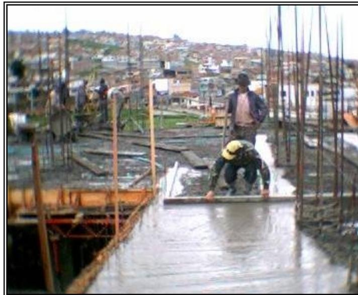
**Figura 91. aspecto del recubrimiento luego de tallar.**
