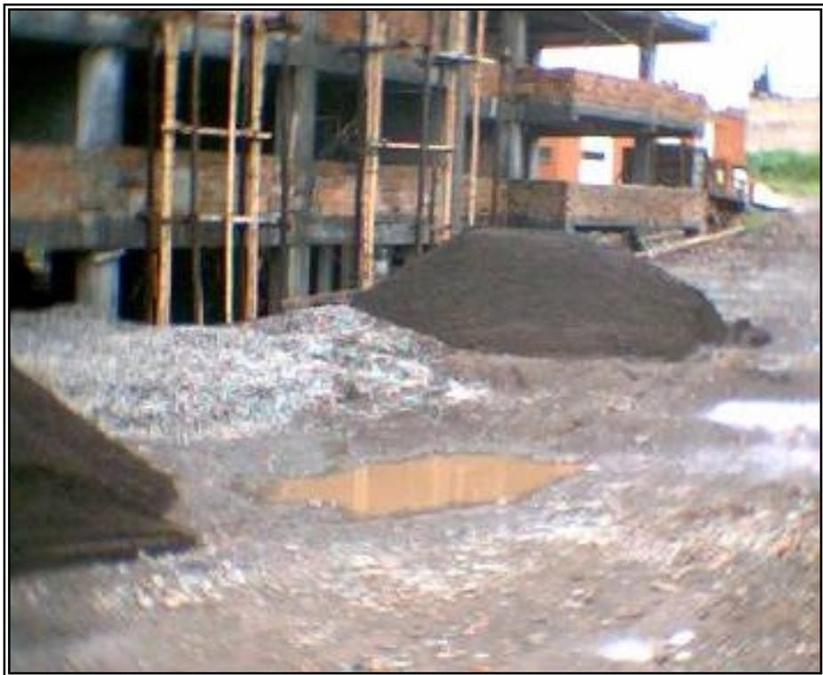
**Figura 20. Disposición de los agregados en obra**
