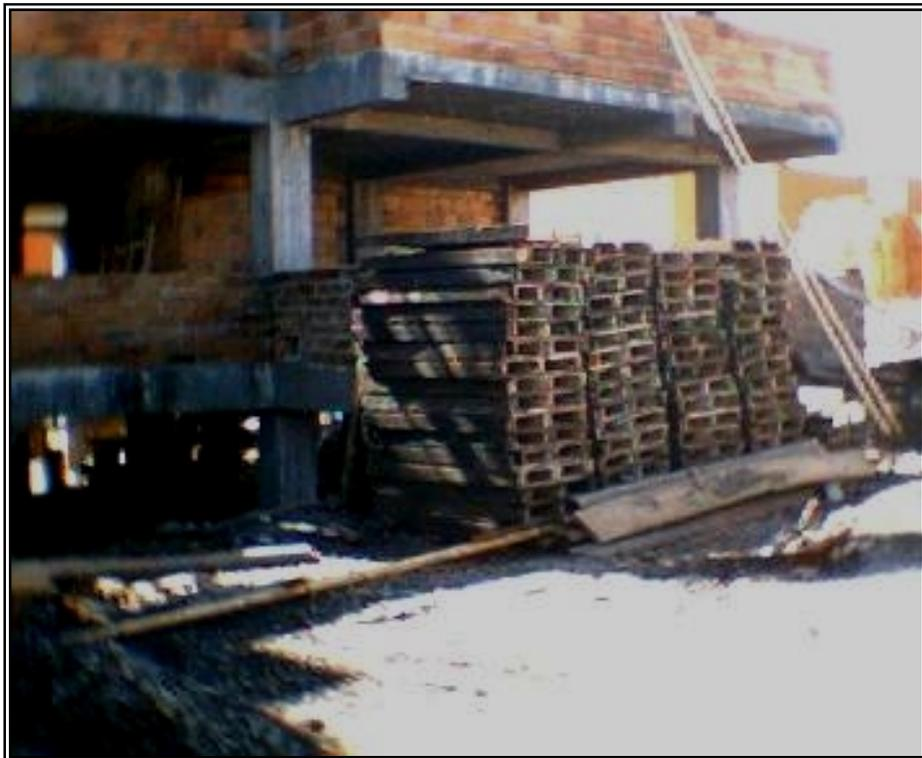
**Figura 66. Tableros y teleras para formaleta de losa de entrepiso**
