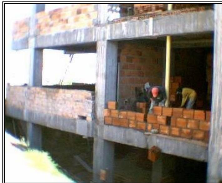
**Figura 108. Pega de muros en Bloque 2 Piso 2.**
