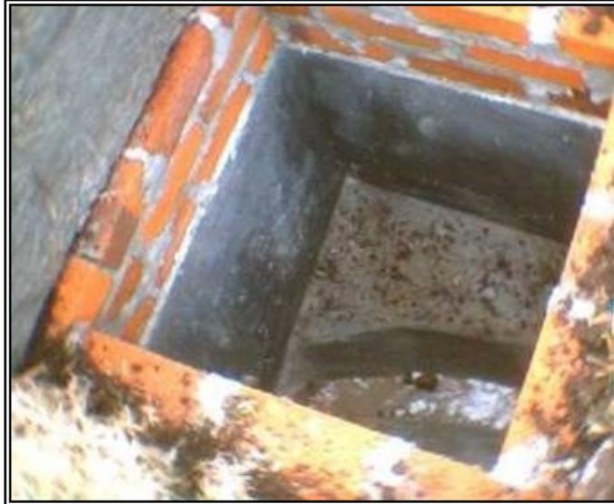
**Figura 116. Caja de inspección 1x1m.**
