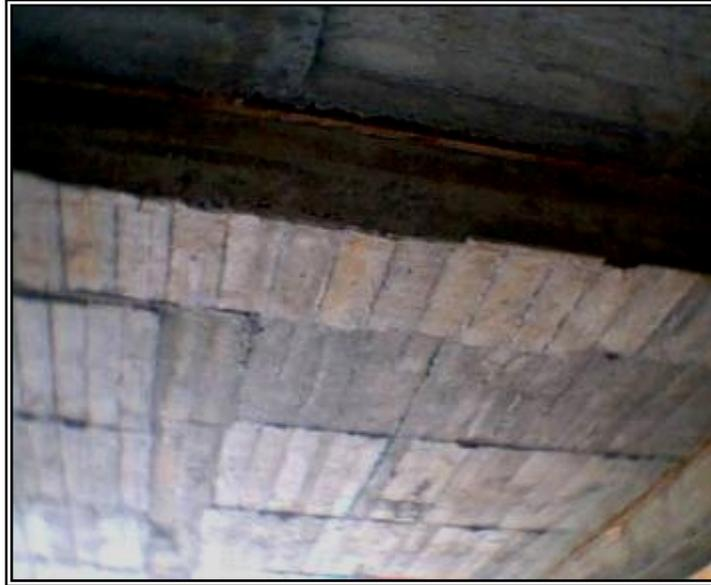
**Figura 59. Desencofrado de viga C piso 4 a los 21 días.**
