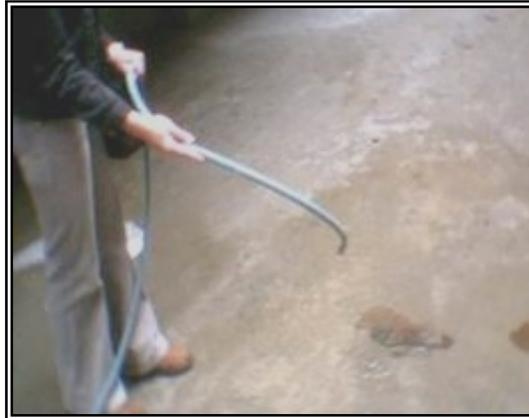
**Figura92. Curado de concreto de losa**
