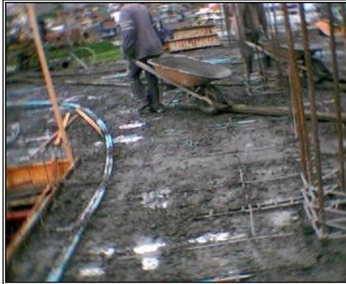
Figura 87. Transporte de concreto en buggys
