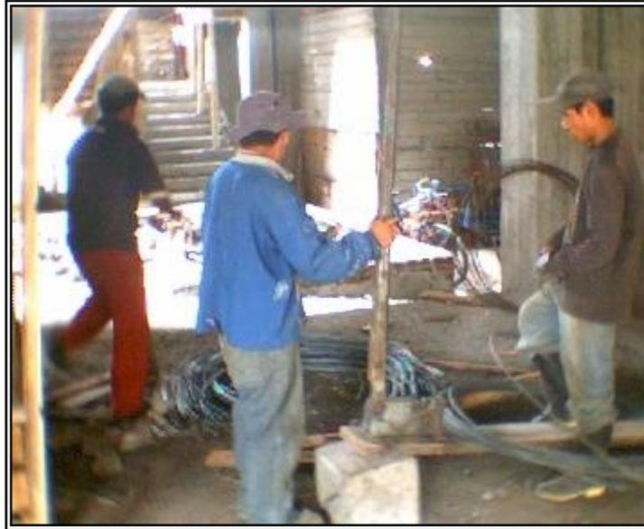
**Figura 42. Corte de hierro No. 3 con cizalla**
