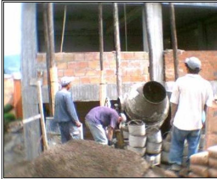
**Figura 85. Elaboración de concreto en mezcladora**
