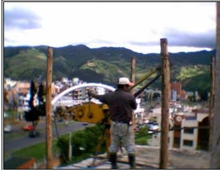
**Figura 24. Elevación de concreto por medio de una Pluma Grúa**
