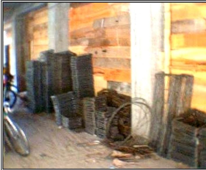
Figura 46. Almacenamiento de Flejes de vigas
