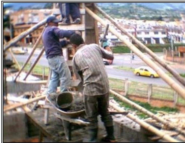
**Figura 25. Vaciado de concreto Columna L10 B2 piso 4**
