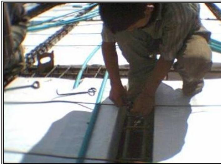
**Figura 76. Colocación de refuerzo por retracción de fraguado y temperatura.**
