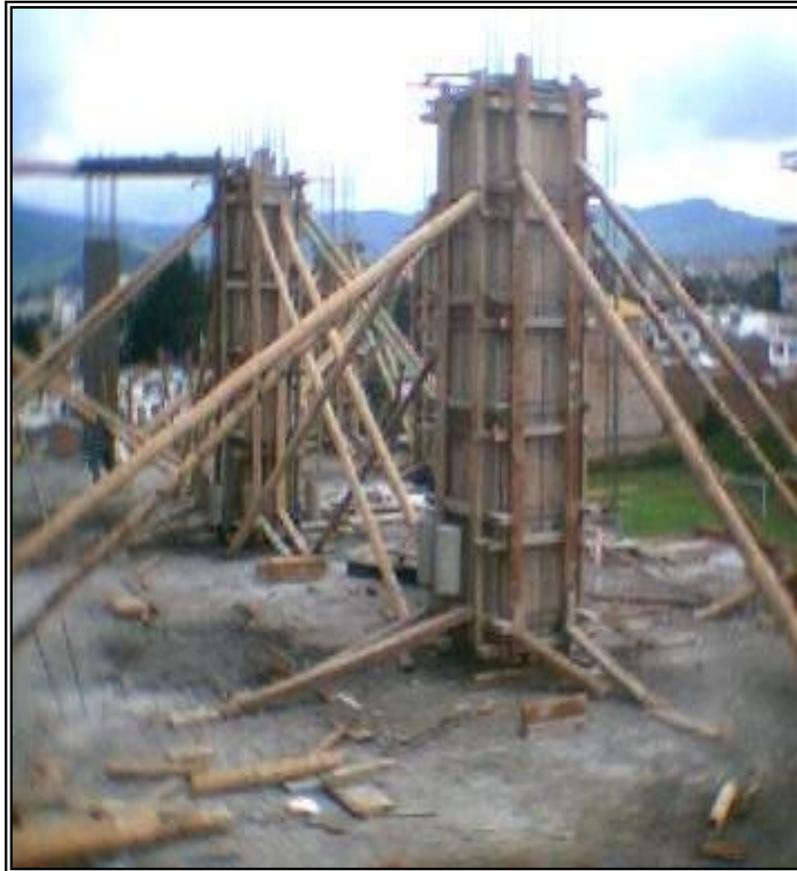
**Figura 12. Formaleta columnas B2 piso**
