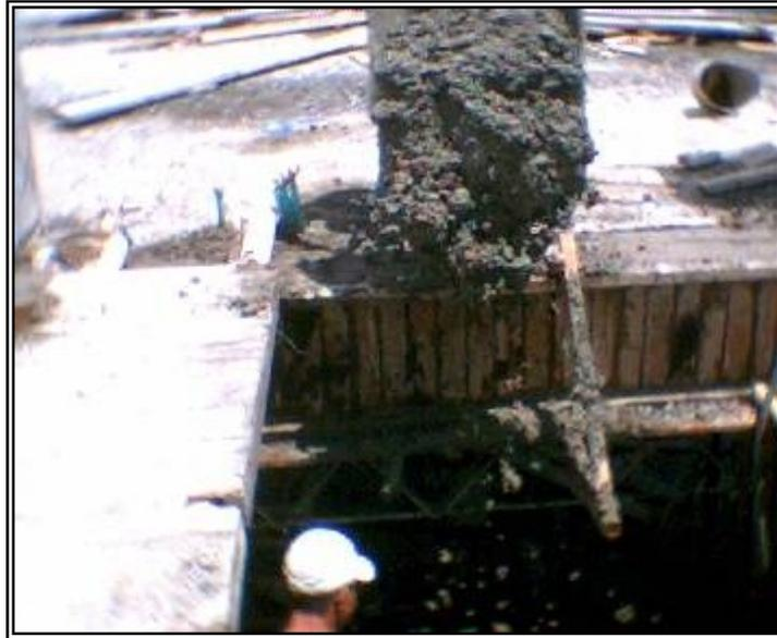
**Figura 99. Vaciado de concreto en la escalera**
