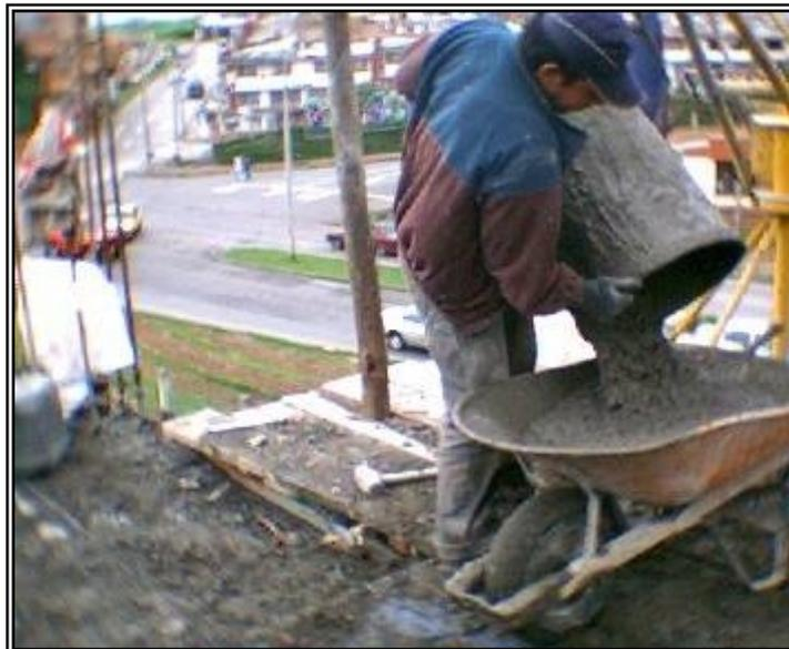
**Figura 86. Vaciado de concreto de la pluma a la carretillas que lo distribuyen**
