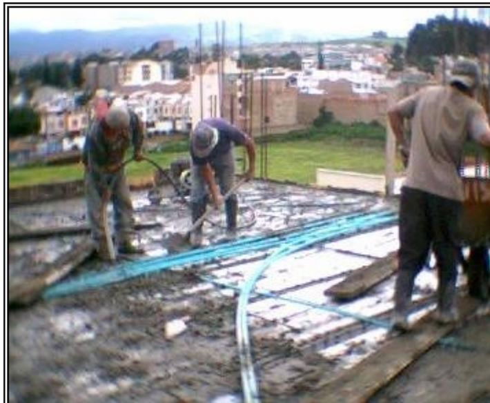
Figura 88. Vibrado de concreto de nervaduras
