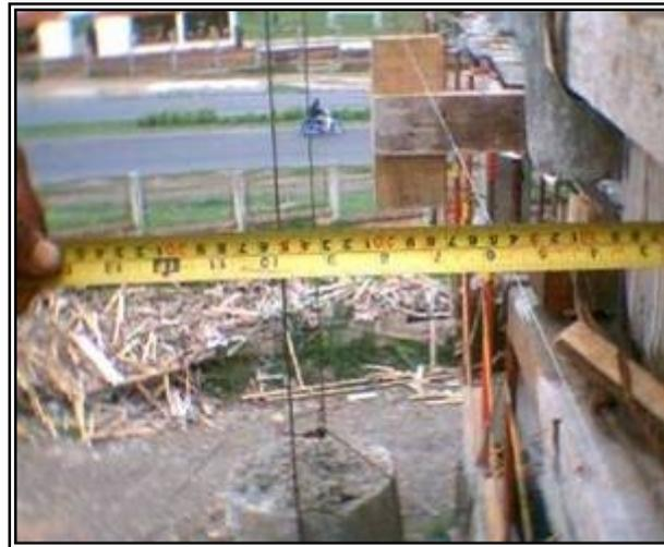
**Figura 17. Verificación de la alineación de la columna L10 B2 piso 4**
