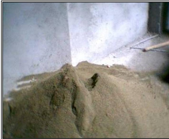
**Figura 106.** Mezcla de arena con cemento, en proporción 1: 4
