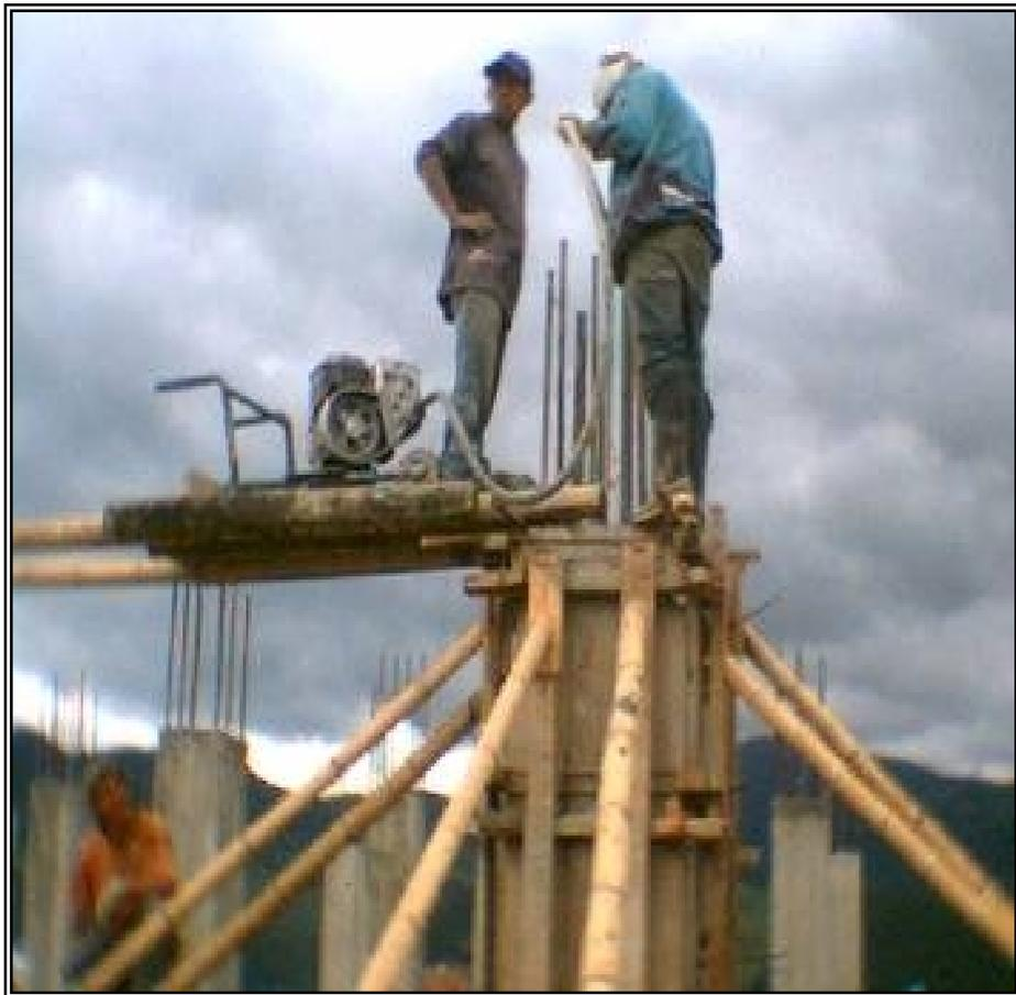
**Figura 26. Vibrado de concreto en la columna k8 B2 piso 4**
