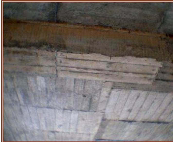
**Figura 60. Desencofrado de viga C piso 5 a los 21 días.**
