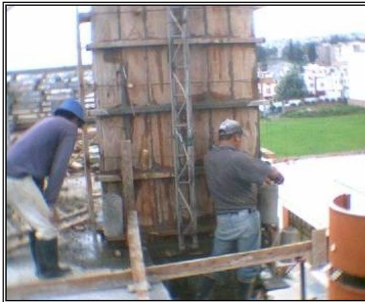
**Figura 37. Chequeo de los alineamientos de la Formaleta después de la fundición**
