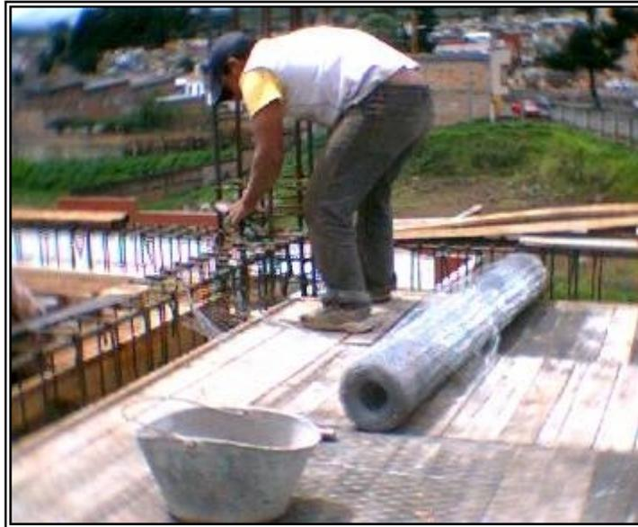
**Figura 81. Colocación de malla de gallinero para loseta inferior.**
