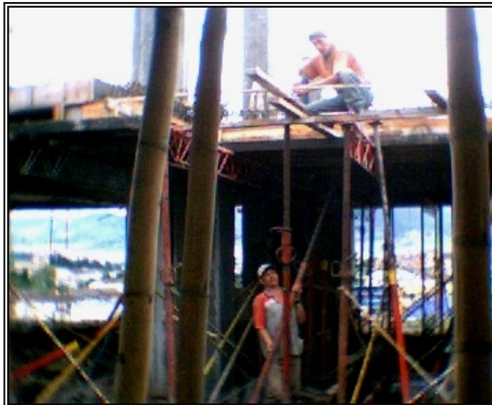
Figura 68. Colocación de vigas y tableros para armado de formaleta.
