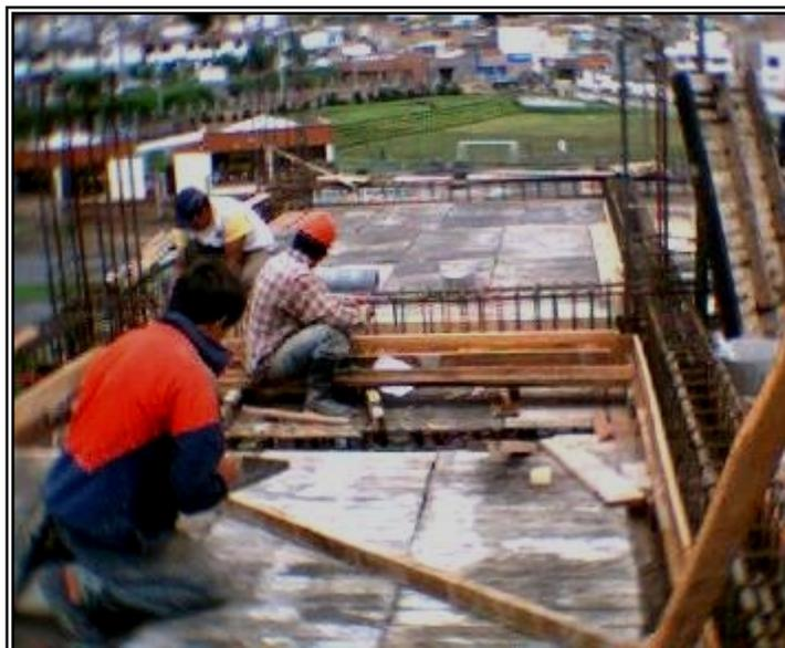
**Figura 50. Formaleta lateral de vigas armadas**
