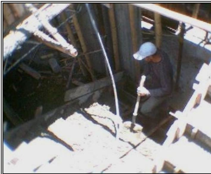
**Figura 102. Vibrado de concreto en peldaños de escalera**
