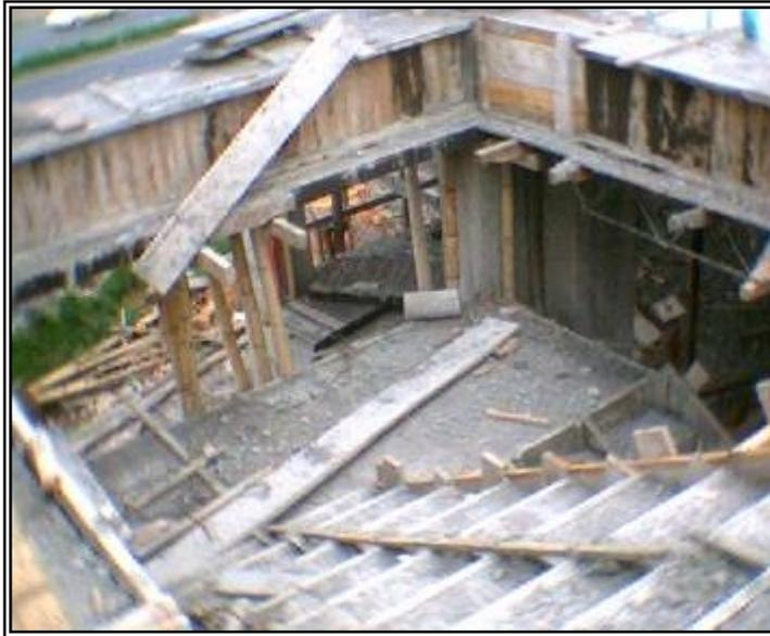
**Figura 103. Aspecto de la escalera después de la fundición**
