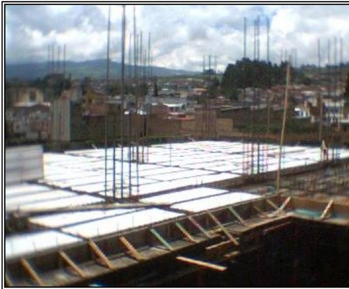
**Figura 80. Colocación de casetones en losa de entrepiso B2 piso 4**
