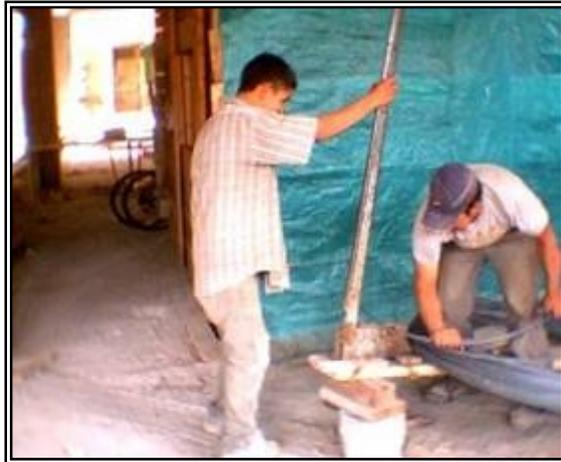
**Figura 2. Corte de hierro con cizalla**
