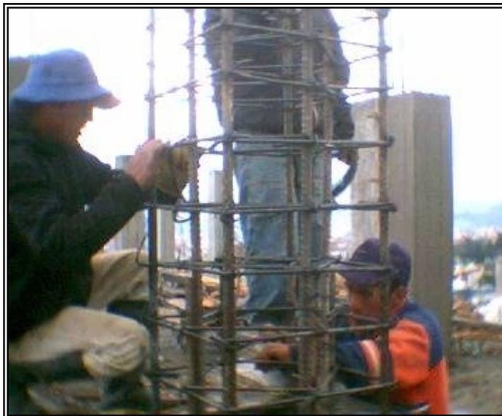
Figura 8. Armado de refuerzo para Columna C3 B1 piso 5
