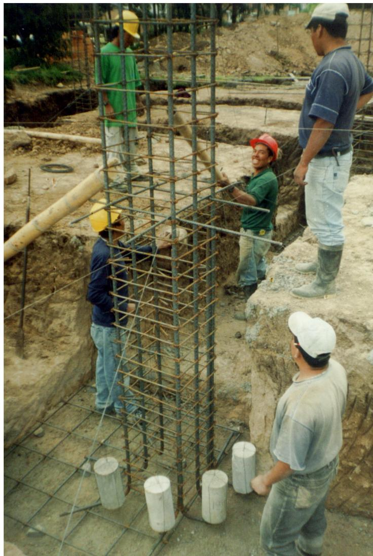
2. Se hace el parabo de la columna sobre su eje exacto, respetando para ello el recubrimiento de la columna que es fácilmente comprobable con los hilos de paramento, dichas medidas son 2.5 cms al fleje, 3.5 a la varilla que sostiene los estribos.
