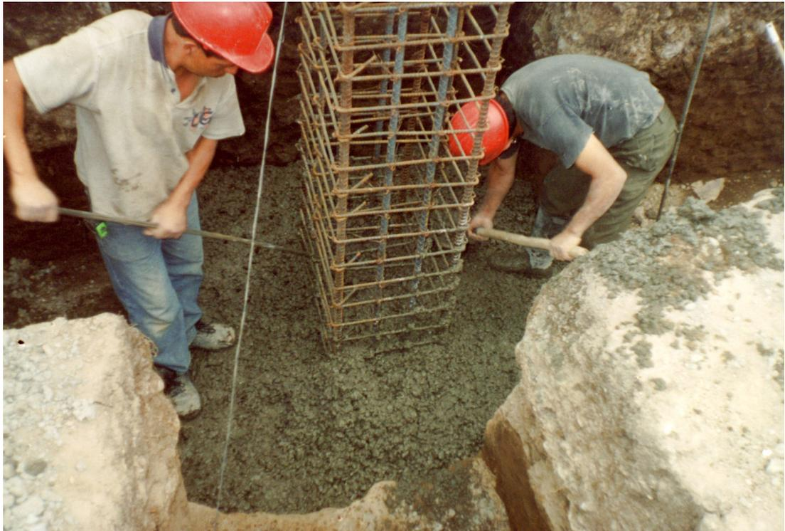
Las zapatas poseen un peralte de 0.40 mtrs, como se ve en la Figura 19, no se hace uso de formleta ya que desde el inicio de las excavaciones, se ha
