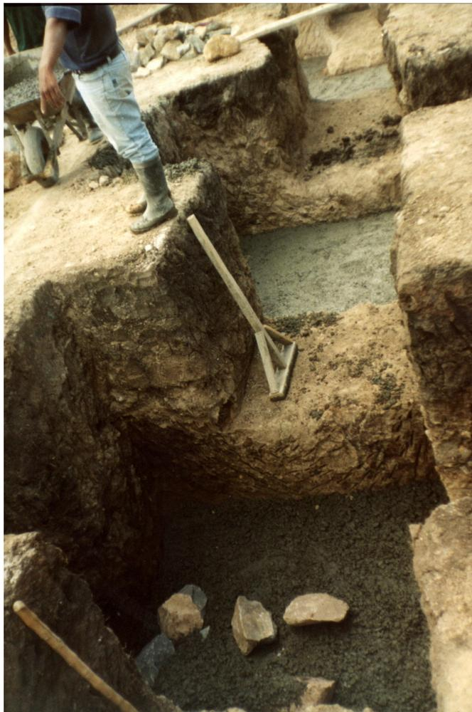
Después de esta profundización de las zapatas proseguimos con la fundición del concreto ciclópeo con una dosificación de 1:3:3, que posee una resistencia a los 28 días 3200 P.S.I , el concreto ciclópeo como su nombre lo indica es la combinación de rajón en un 40% y mezcla de concreto en un 60% que permite el relleno mas rápidamente de las zapatas. La totalidad de rajón utilizada en la cimentación es de 50 m<sup>3</sup>.
