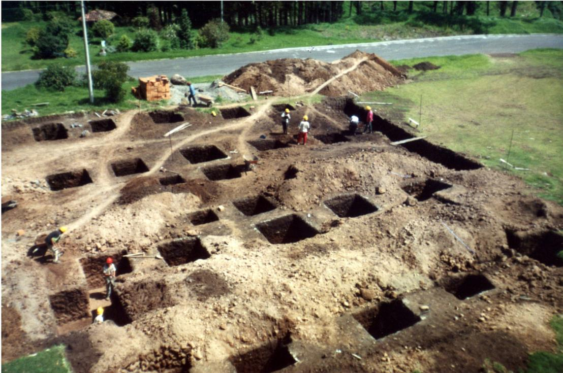
Terminada la excavación de Zapatas se da inicio a las labores concernientes al replanteo y señalización de las vigas de cimentación, utilizando los puentes que sirven para ubicar los ejes, se hace la demarcación de las vigas de cimentación y se procede a su excavación.
