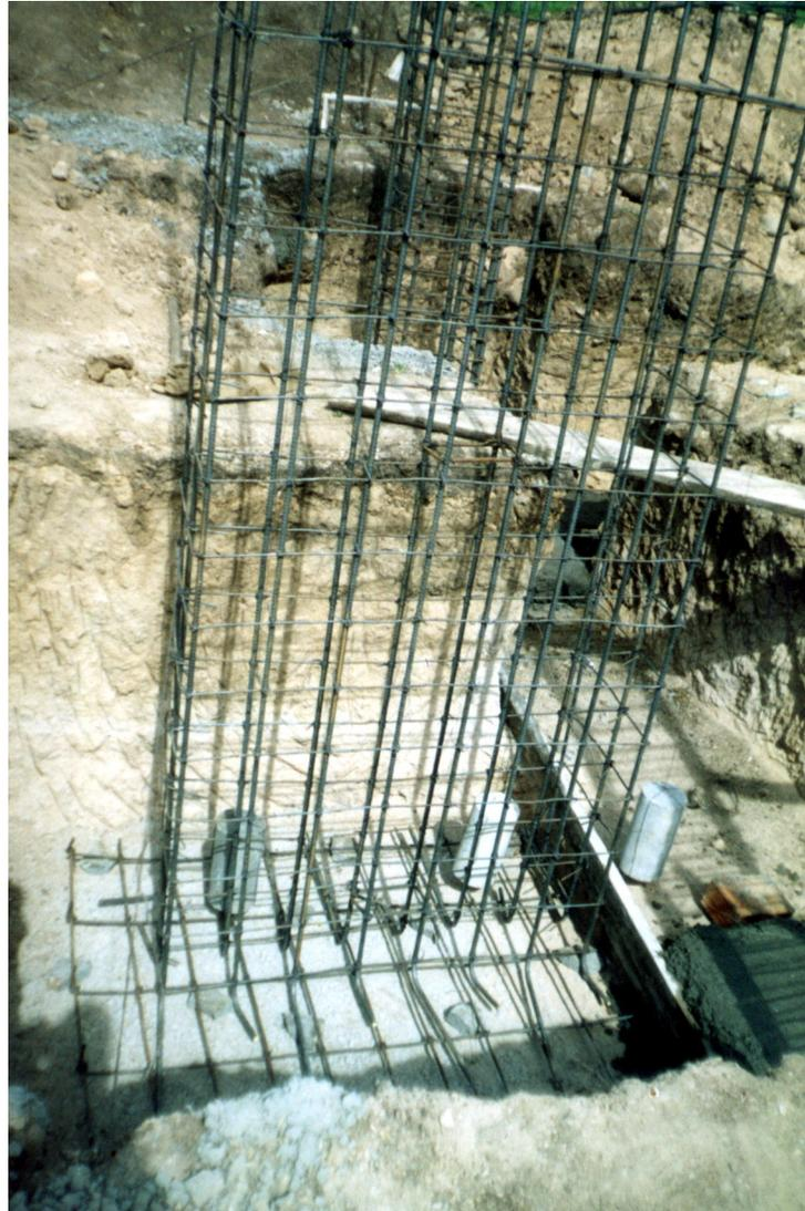
Utilizando el mismo método se hace el parado de los castillos correspondientes a los ductos eléctricos y ductos de aguas lluvias que se conforman con varillas de 5/8" 1/2" y flejes de 1/4", dichos conductos no poseen ningún tipo de actividad estructural en el bloque y no hacen parte del sistema porticado del edificio. Esta
