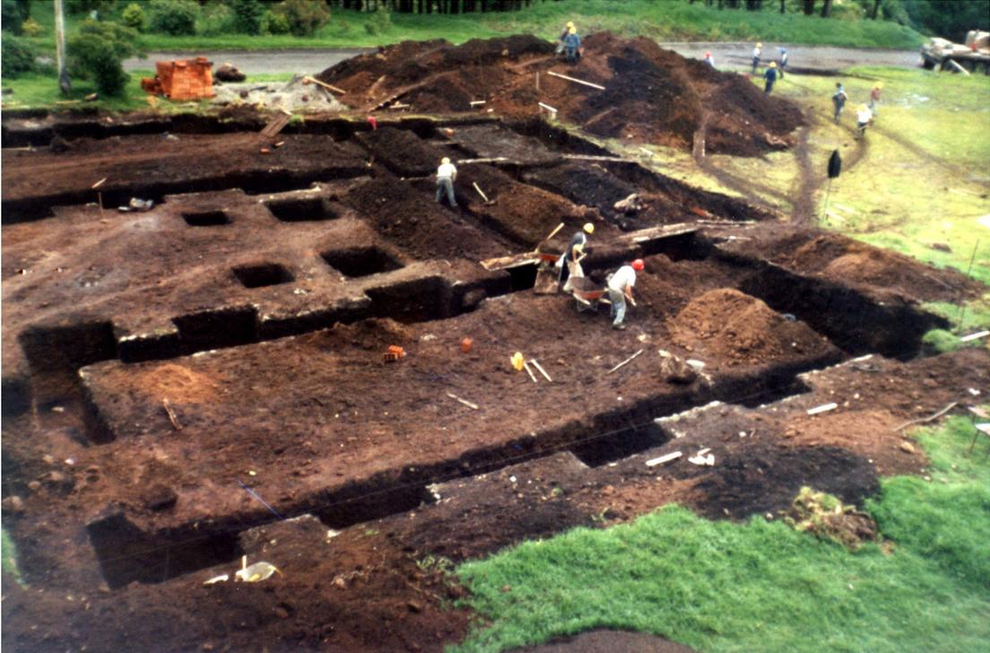
Figura 7. Finalización de Excavaciones Vigas de Alimentación Bloque de Medicina
