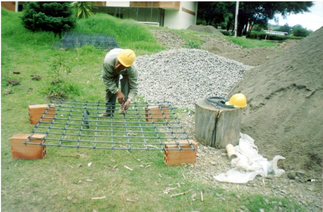
Posteriormente se hace el corte de hierro para parrillas de zapatas que en su mayoría se compone de acero de 1/2". Flejado la totalidad de hierro para estribos se inicia el armado de las columnas (castillos). Las columnas en su mayoría requieren hierro de 7/8", 5/8", 1"
