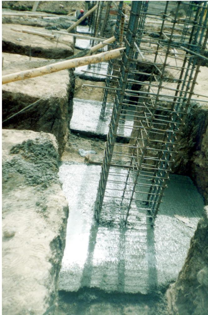
Terminado este trabajo proseguimos con la fundición de solados de limpieza, el solado de limpieza es una mezcla en concreto pobre que permite ubicar de forma segura las vigas de cimentación para su armado en cada uno de los ejes de cimentación. La dosificación utilizada para este solado es 1:3:3. (Enero 3 – Enero 16, de 2003).
