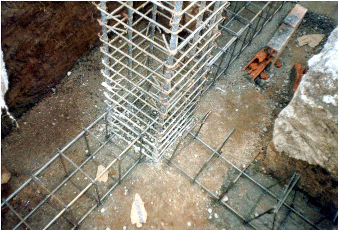
Las vigas de cimentación son insertadas al interior de la columna, y se procede a su armado teniendo en cuenta las varillas correspondientes a cada una de las vigas para todos los ejes. Los estribos están separados a 0.20 mtrs uno de otro como se indica en los planos estructurales y se hace la revisión de todas las vigas por parte
