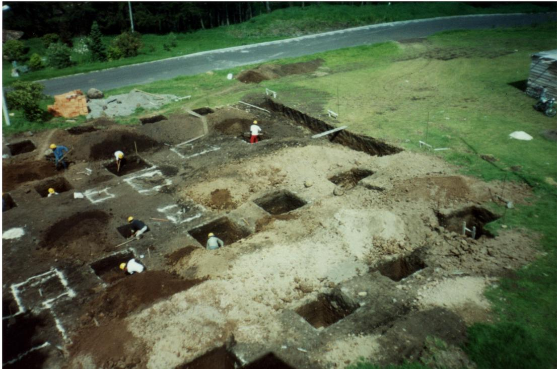
Figura 5. Excavación de Zapatas Bloque de Medicina
