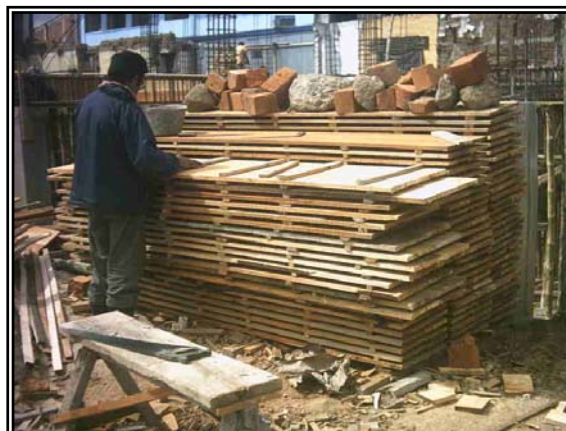
Figura 63. Formaleta para vigas de entrepiso nivel N+0,00
