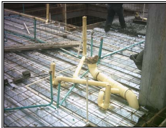
Figura 103. Instalaciones hidrosanitarias.
