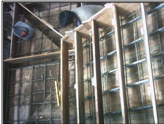
Figura 83. Laterales de peldaños escaleras.
