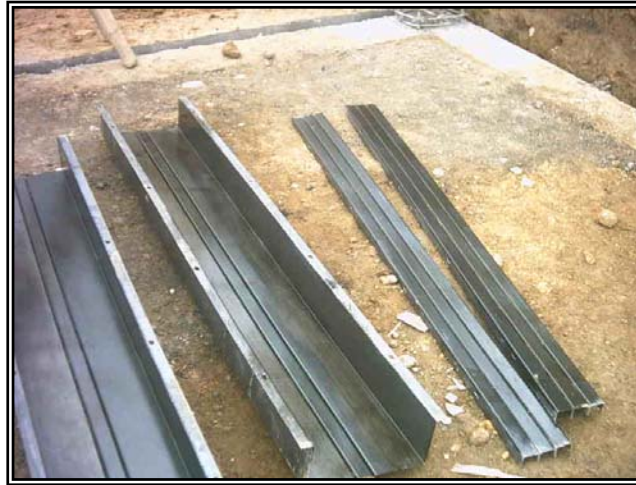
Figura 53. Formaleta metálica para columnas (b)
