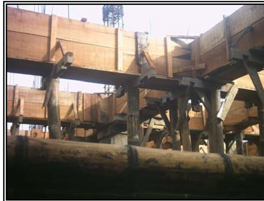
Figura 62. Encofrado vigas entrepiso nivel N+0,00
