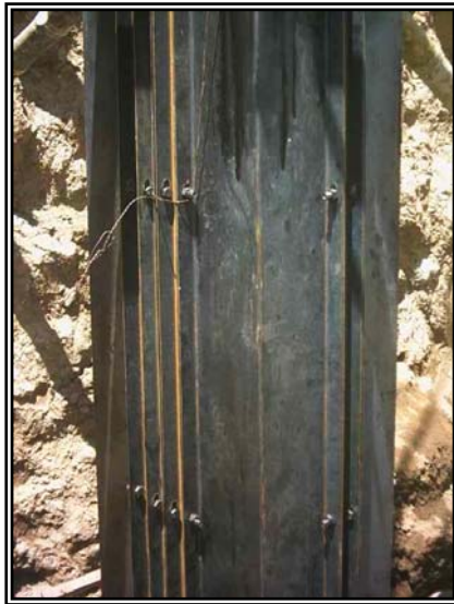
Figura 91. Encofrado formaleta metálica columnas nivel N + 0,00.
