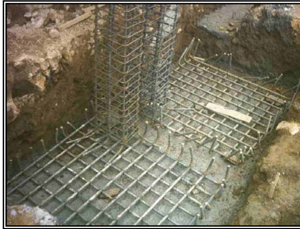
Figura 40. Anclaje parrilla – castillo (Junta de dilatación).
