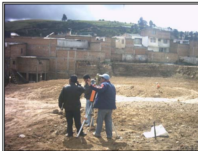
Figura 19. Nivelación del terreno
