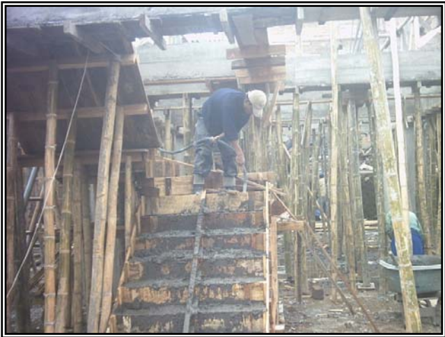
Figura 84. Vibrado del concreto para escaleras.
