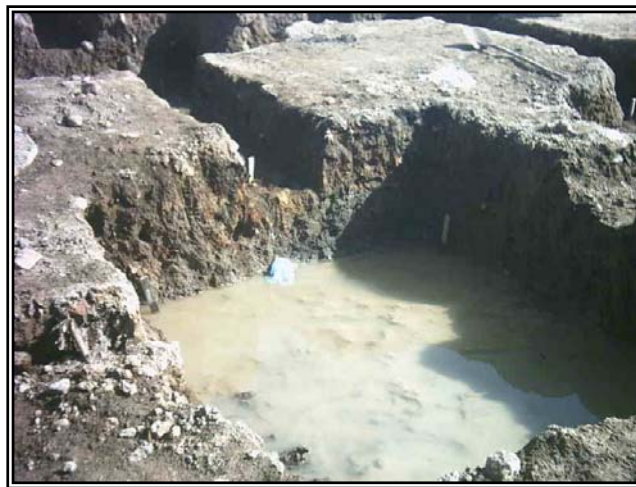
Figura 35. Excavación zapatas, presencia de nivel freático.
