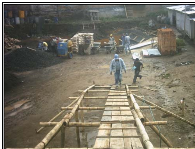
Figura 105. Rampa provisional para fundición.
