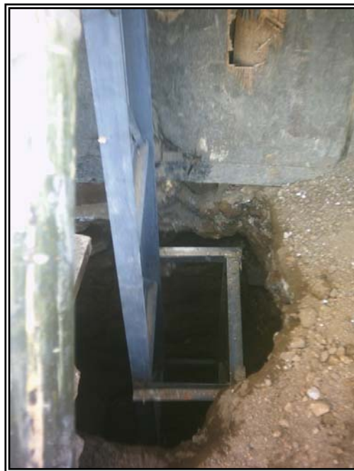
Figura 71. Instalación torre metálica
