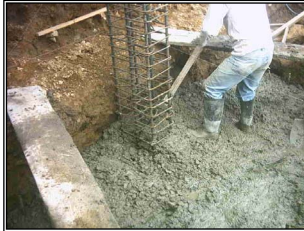
Figura 42. Fundición zapatas (b).
