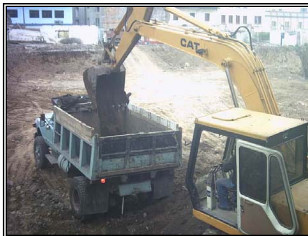
Figura 17. Cargue material de excavación
