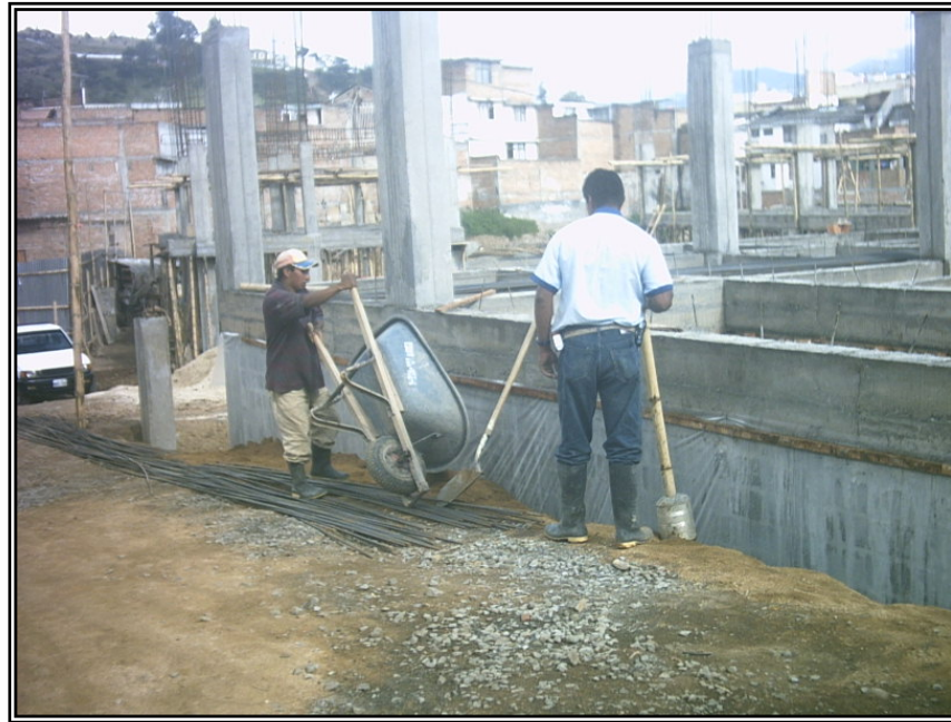
Figura 77. Compactación con pisón de mano.
