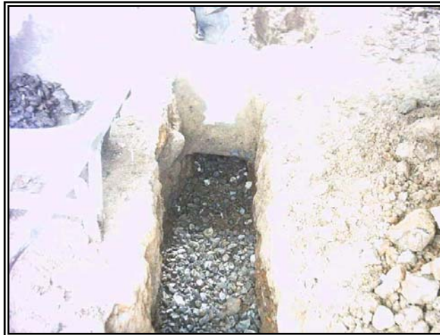
Figura 117. Capas de triturado. h=0.15 m.
