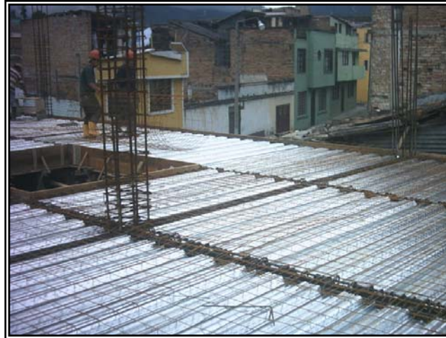
Figura 129. Tendido de la malla electro-soldada.
