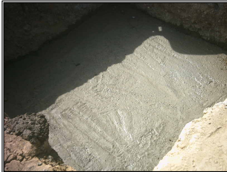
Figura 37. Solado de zapatas.
