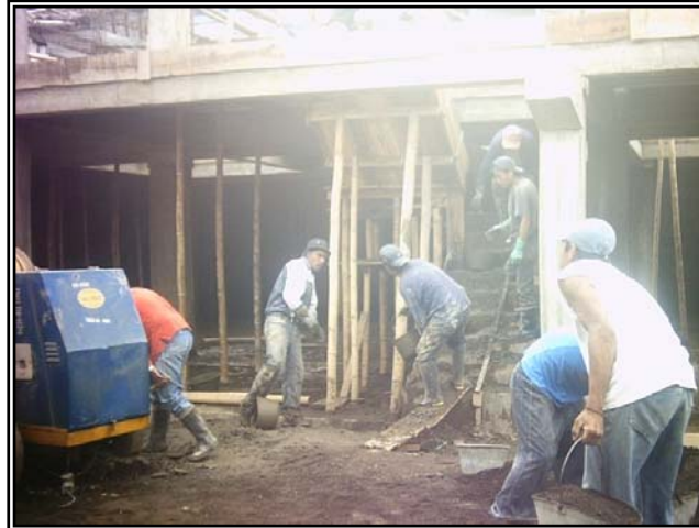
Figura 106. Fundición losa nivel N + 0,00 bloque 2.
