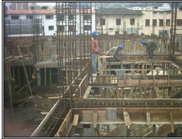
Figura 123. Laterales de formaleta vigas entrepiso segundo nivel.
