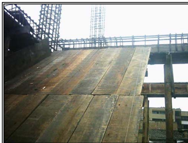
Figura 130. Formaleteo escaleras segundo nivel.
