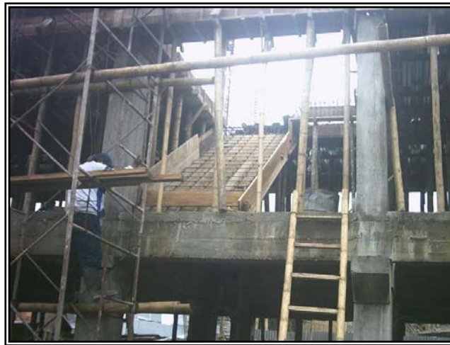
Figura 131. Refuerzo escaleras segundo nivel.
