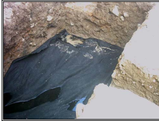
Figura 36. Instalación geotextil.
