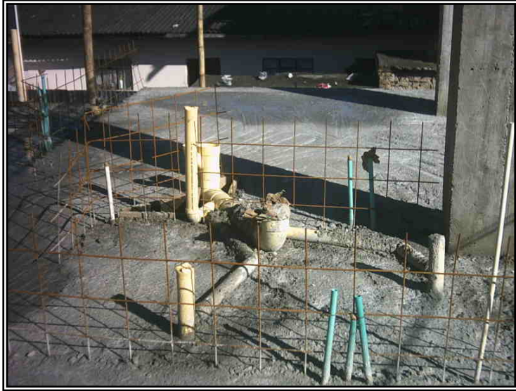
Figura 110. Acabado, losa nivel N + 0,00
