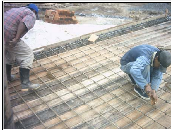
Figura 68. Armado parrilla para rampa de acceso.
