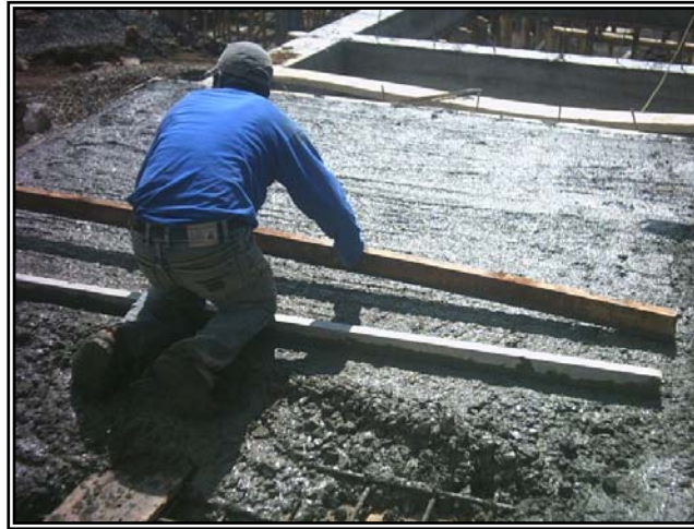
Figura 70. Tallado concreto rampa de acceso peatonal.
