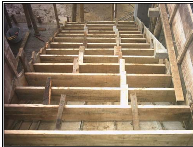
Figura 132. Peldaños escalera segundo nivel.
