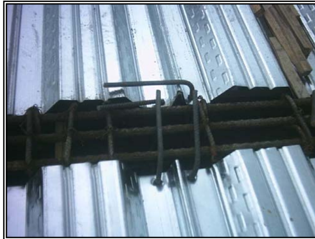
Figura 127. Conectores de cortante.
