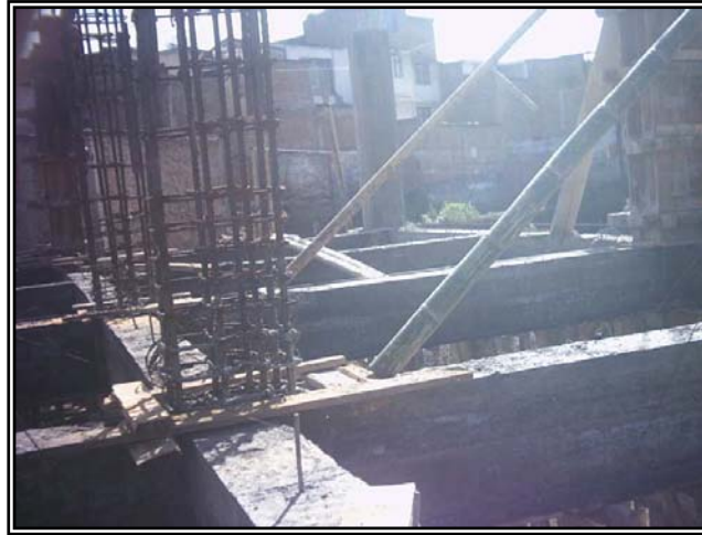
Figura 87. Armado columnas nivel N + 0,00. (b)
