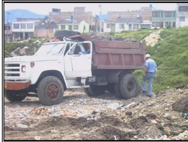
Figura 18. Desalojo escombrera El Chambú
