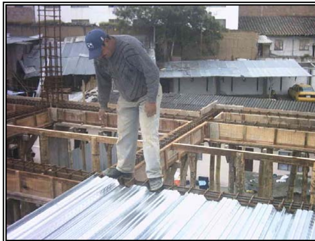
Figura 125. Colocación METALDECK.
