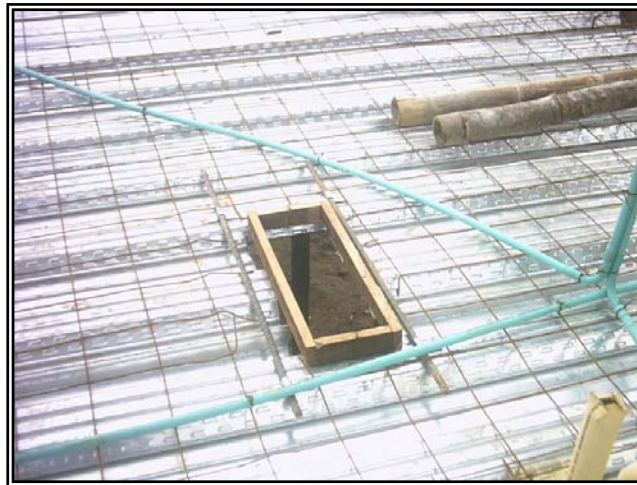
Figura 128. Refuerzo corte buitrones.
