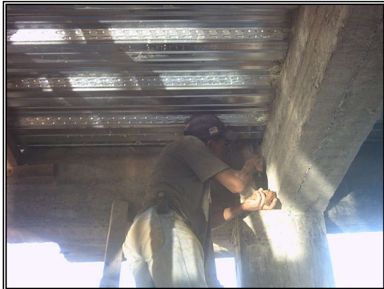
Figura 111. Resanes losa nivel N + 0,00.
