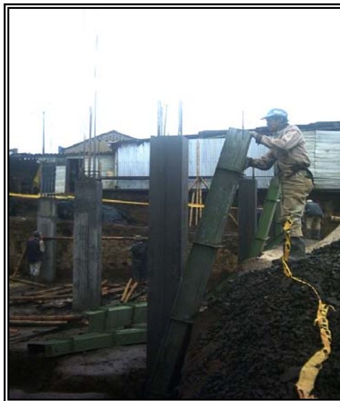
Figura 56. Remoción formaleta de columna
