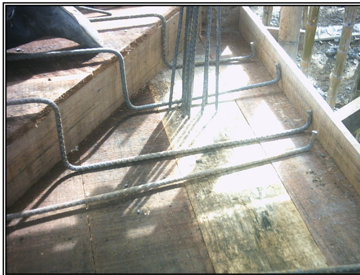
Figura 81. Armado de refuerzo escaleras.
