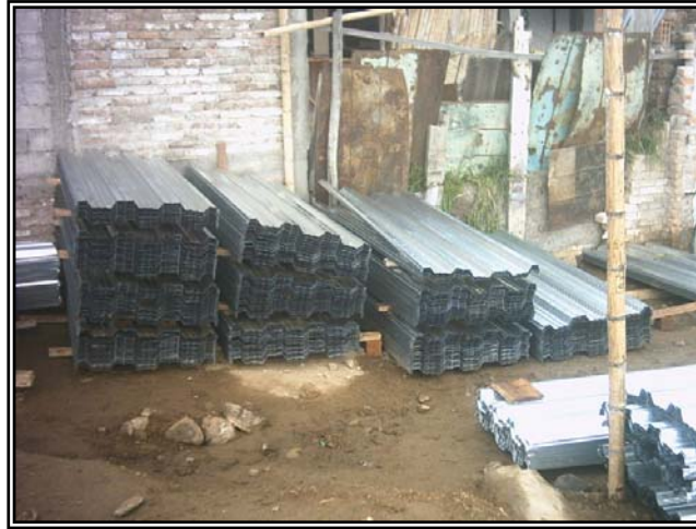
Figura 94. Almacenamiento láminas METALDECK.
