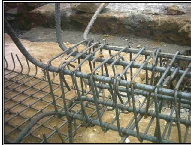
Figura 48. Refuerzo de columnas
