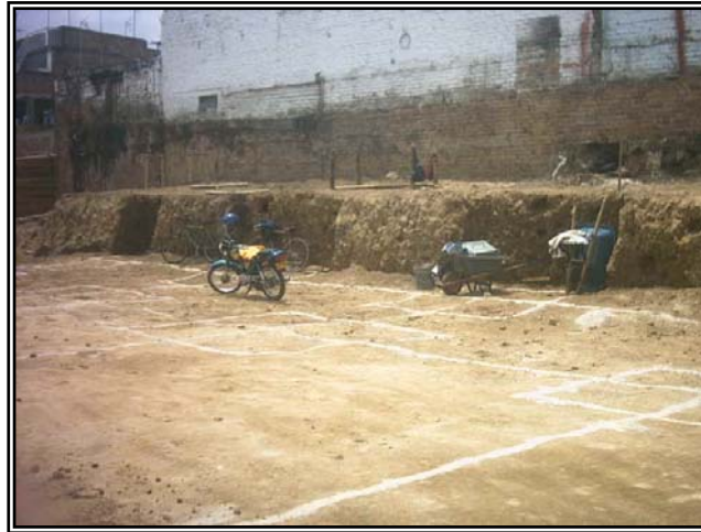
Figura 28. Replanteo de bloques
