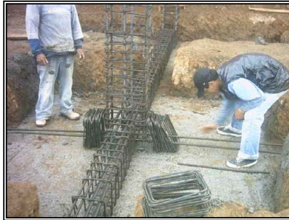
Figura 43. Armado vigas de cimentación
