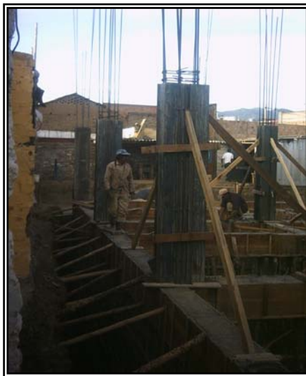
Figura 91. Encofrado formaleta metálica columnas nivel N + 0,00.
