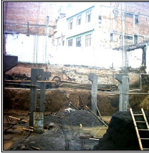
Figura 57. Vista ménsulas tránsito peatonal interno bloques 2 y 3
