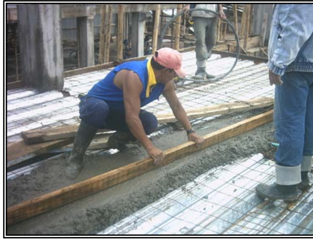
Figura 108. Tallado del concreto losa nivel N + 0,00.
