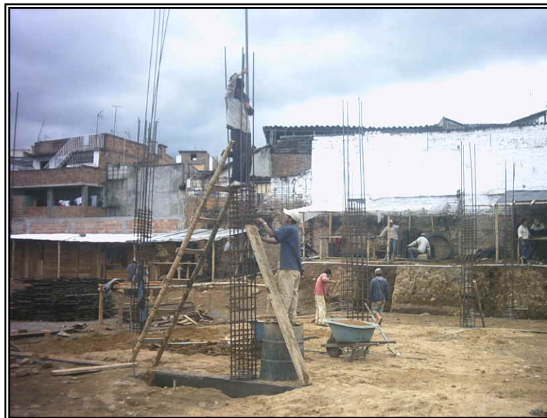
Figura 49. Traslado de columnas
