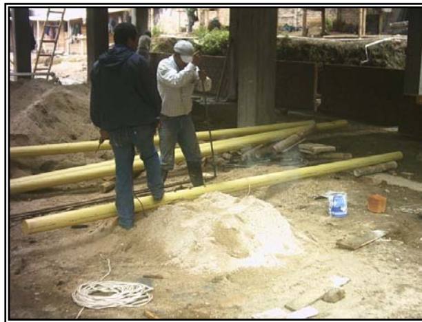
Figura 119. Perforaciones tubería PVC.
