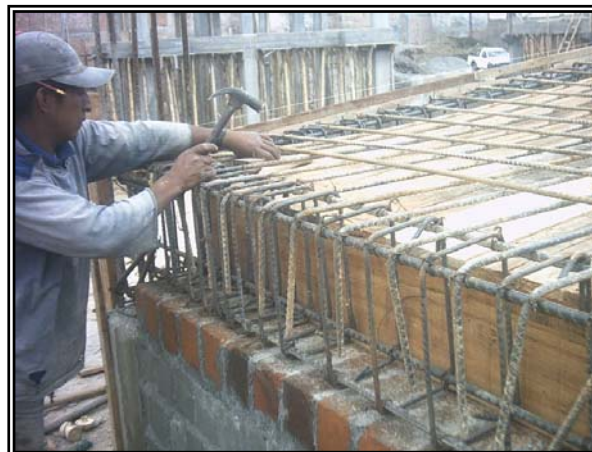
Figura 65. Refuerzo rampa de acceso peatonal.
