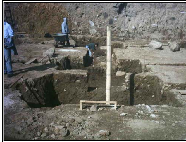
Figura 34. Excavación zapatas.
