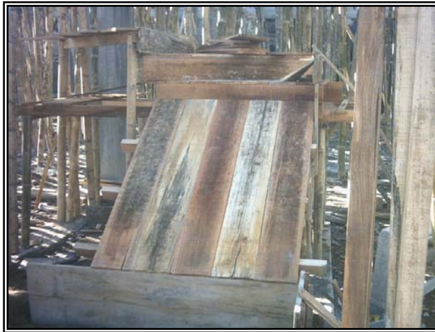
Figura 78. Rampa para escaleras.
