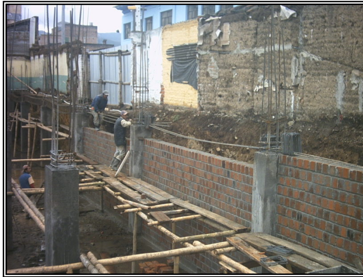
Figura 60. Andamios para vigas entrepiso nivel N+0,00.
