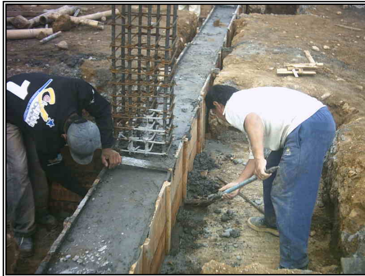
Figura 45. Fundición vigas de cimentación
