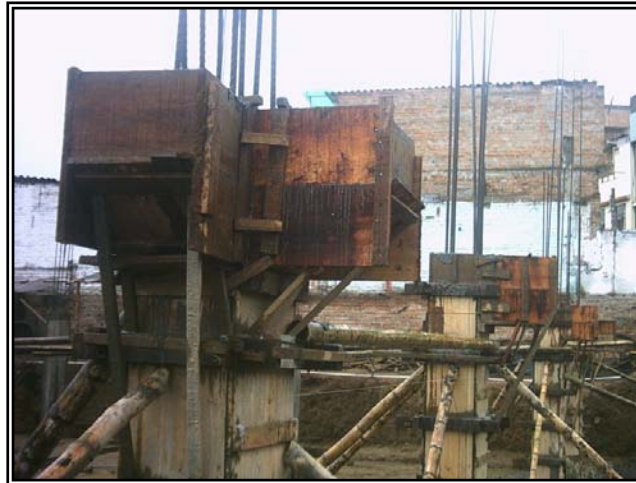
Figura 54. Encofrado de columnas y ménsulas
