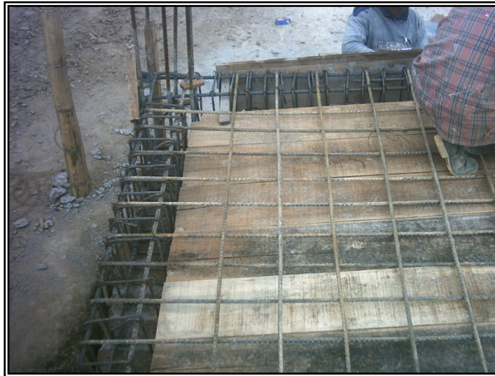
Figura 67. Detalle vigueta longitudinal rampa.
