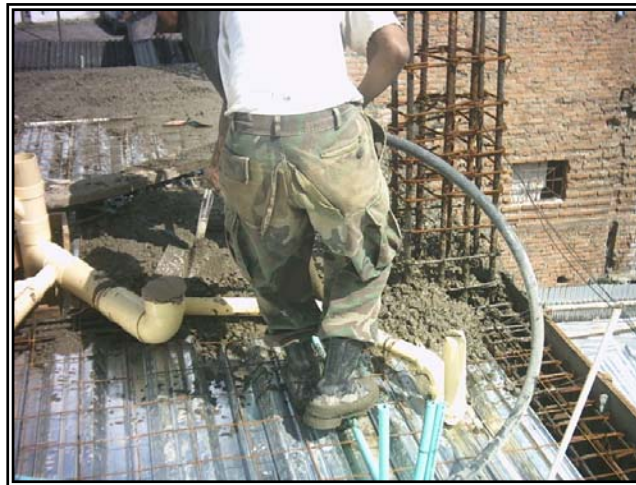
Figura 138. Vibrado concreto.
