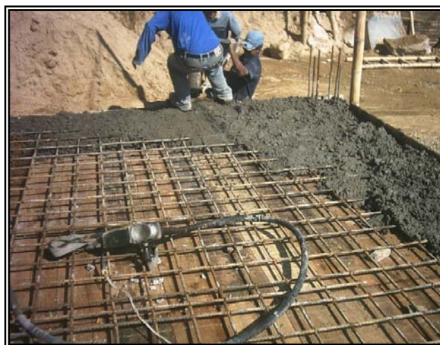
Figura 69. Fundición rampa de acceso peatonal.
