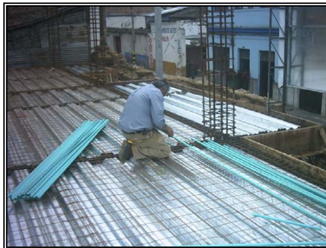
Figura 133. Tendido tubería eléctrica segundo nivel.
