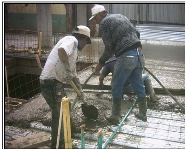
Figura 107. Vibrado del concreto losa nivel N +0.00.
