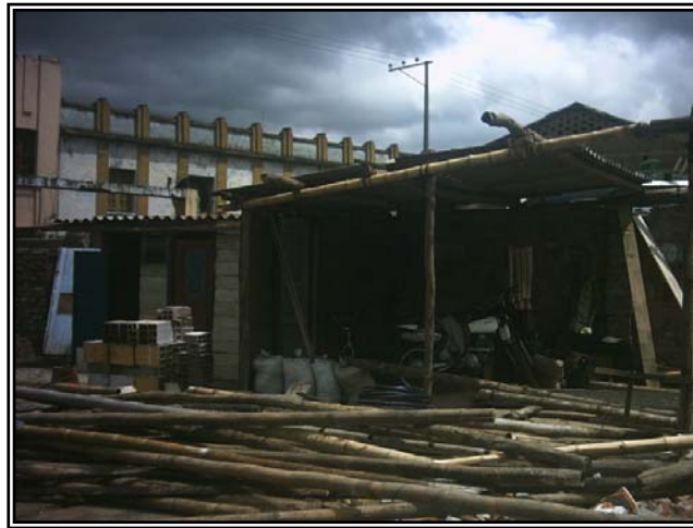
Figura 24. Construcción del campamento
