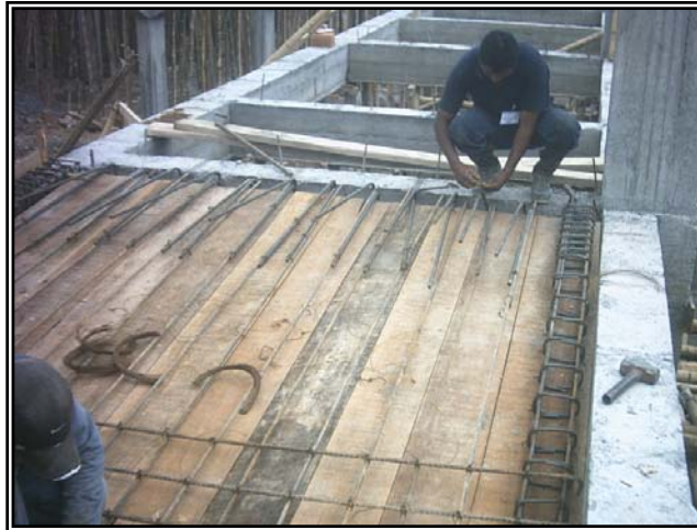
Figura 64. Detalle vigas entrepiso y rampa de acceso peatonal.
