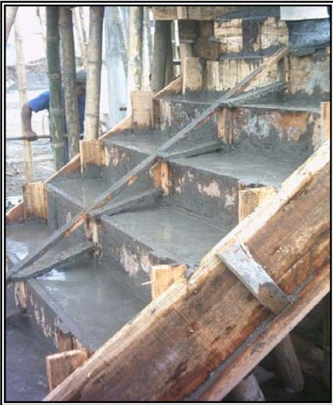
Figura 85. Acabado final escaleras.
