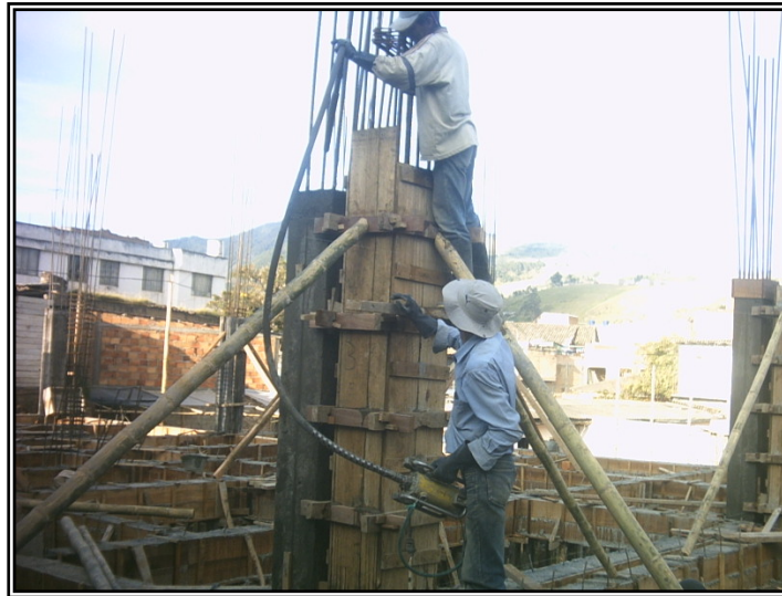
Figura 92. Vaciado y vibrado del concreto, columnas nivel N + 0,00.
