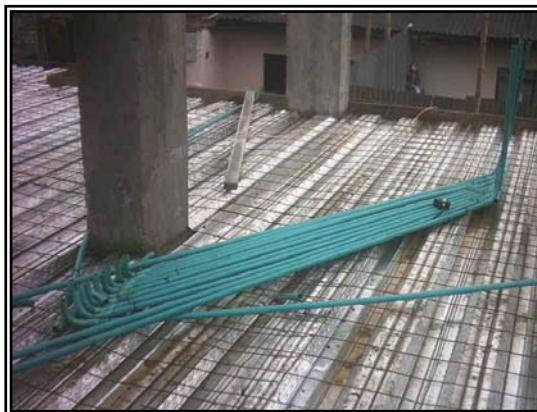
Figura 101. Ductos eléctricos instalados.
