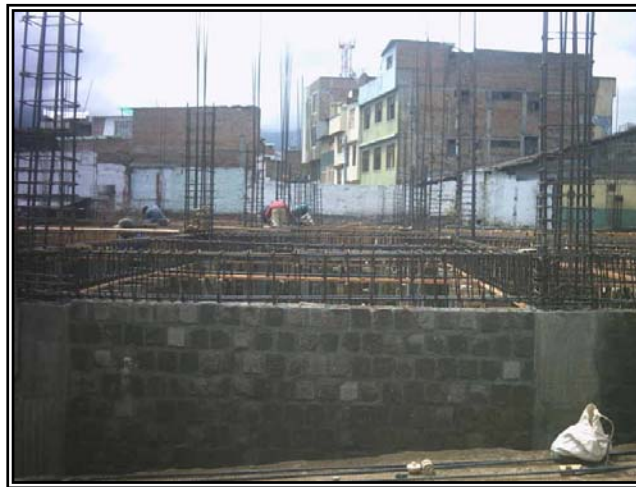
Figura 86. Armado columnas nivel N + 0.00. (a)
