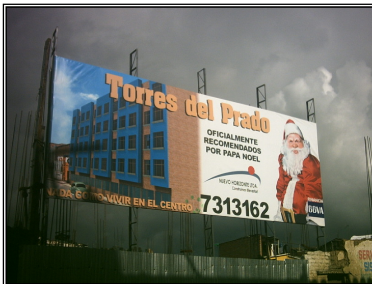
Figura 73. Instalación valla publicitaria
