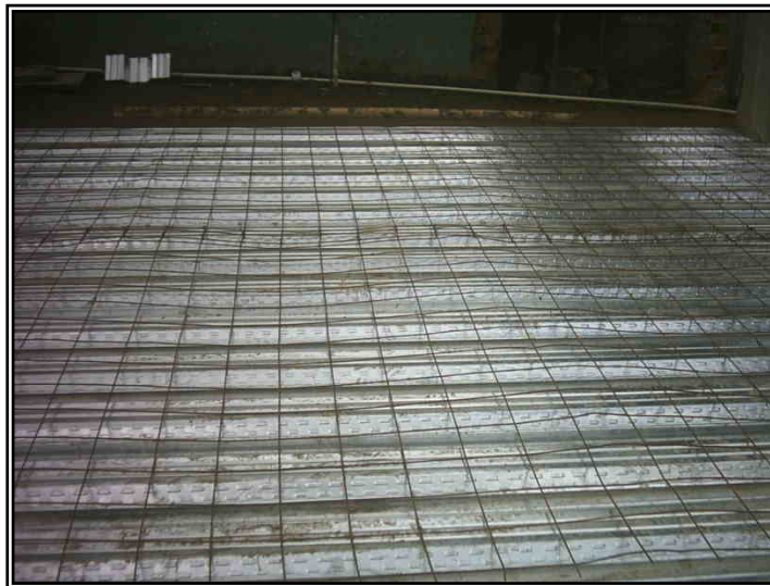
Figura 100. Tendido de la malla electro-soldada.
