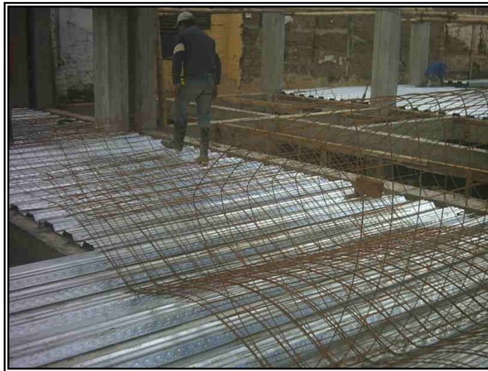
Figura 100. Tendido de la malla electro-soldada.
