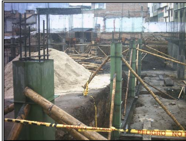
Figura 53. Formaleta metálica para columnas (b)
