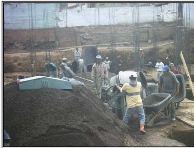
Figura 41. Fundición zapatas (a).
