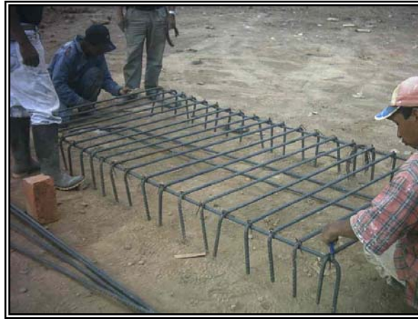
Figura 38. Armado de parrillas.
