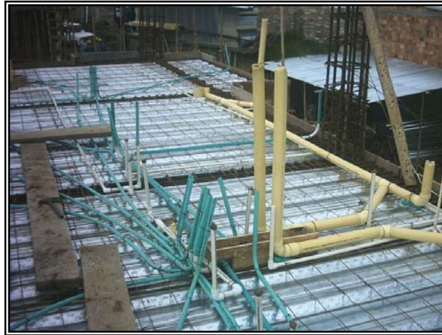
Figura 134. Instalaciones eléctricas segundo nivel.
