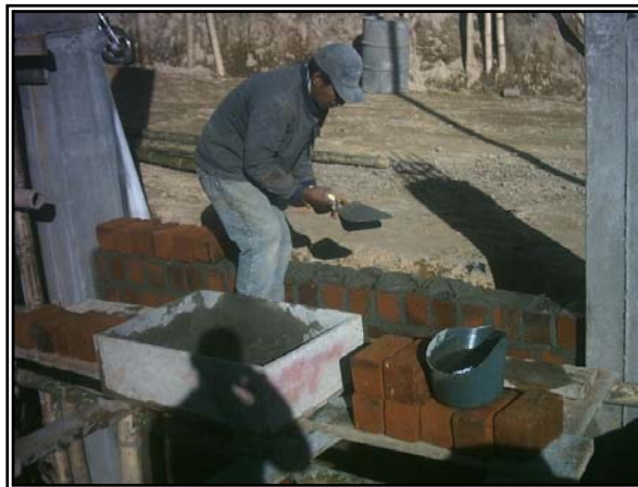
Figura 59. Muros en tizón bloque 1
