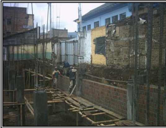
Figura 58. Muros en tizón nivel parqueadero bloques 1 y 2
