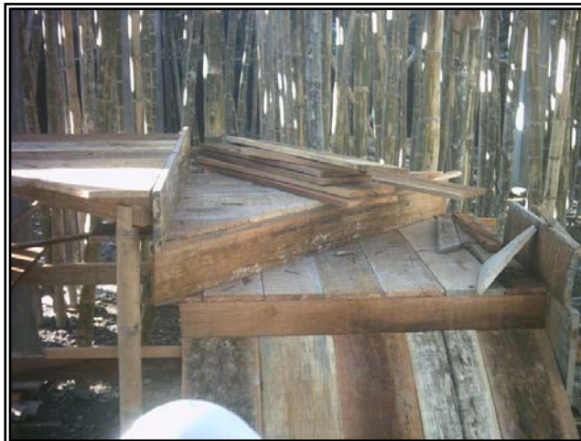
Figura 79. Mariposa tramo escaleras.
