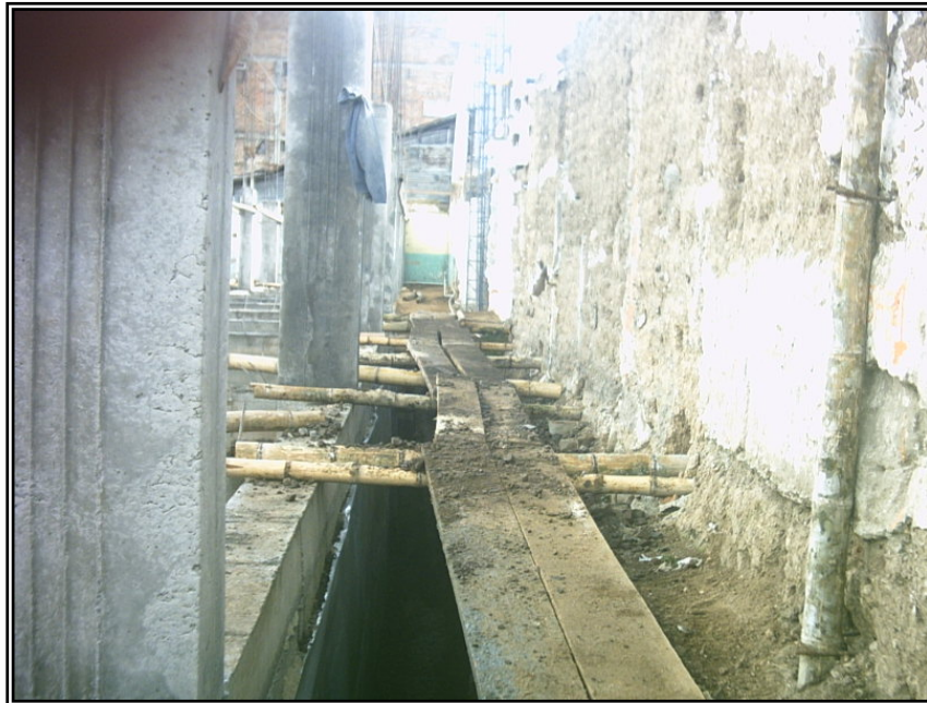
Figura 74. Relleno bloque 1 y 2
