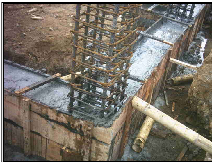
Figura 44. Fundición vigas de cimentación
