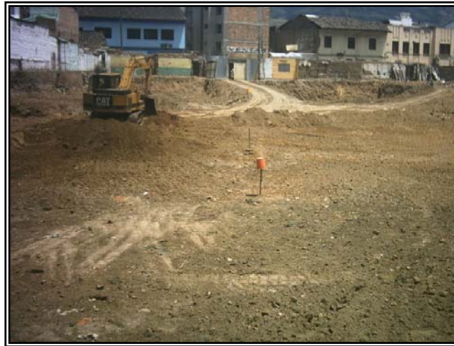
Figura 20. Nivelación terreno con retroexcavadora
