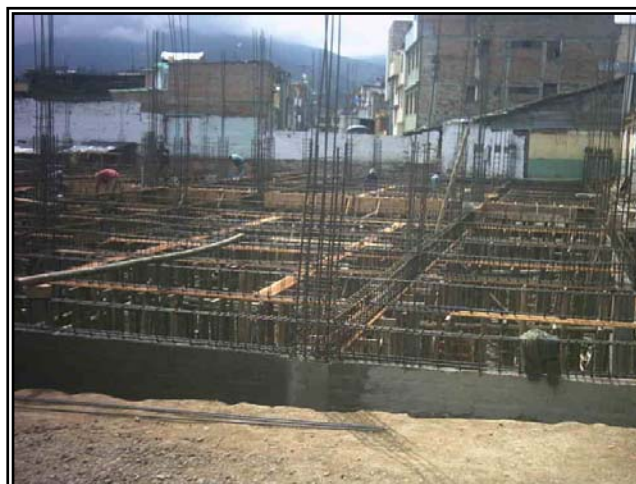
Figura 61. Armado vigas entrepiso nivel N+0.00
