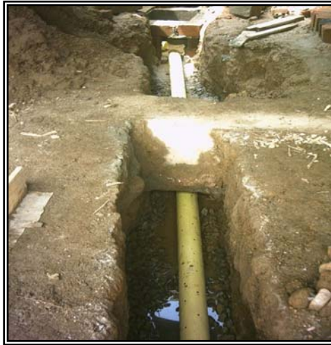
Figura 118. Ubicación tubería del filtro.
