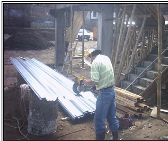
Figura 97. Corte de METALDECK.
