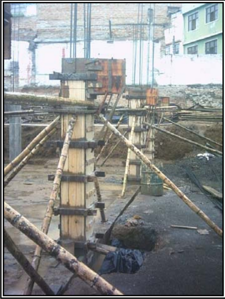
Figura 51. Formaleta en madera para columnas.
