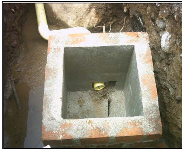
Figura 115. Caja de inspección 0,6*0,6 m.
