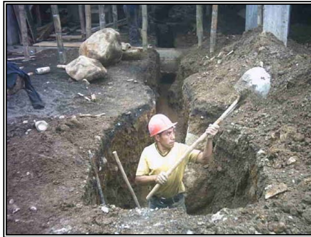
Figura 114. Excavación del filtro.
