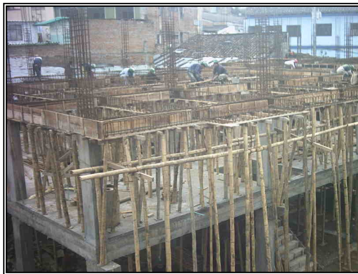
Figura 124. Tacos en guadua para voladizos.
