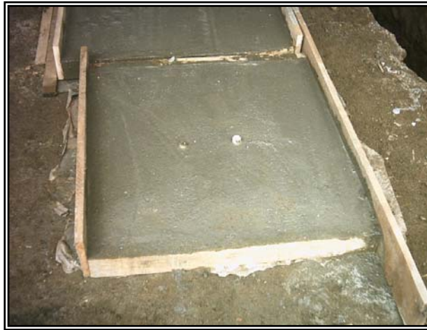
Figura 116. Tapas para las cajas de inspección.
