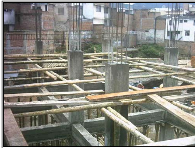
Figura 120. Andamios para vigas entrepiso segundo nivel.
