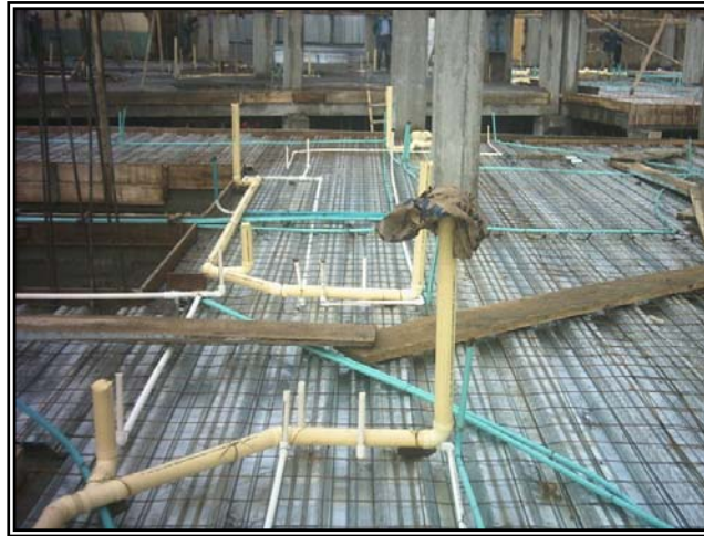
Figura 104. Instalaciones eléctricas e hidrosanitarias.
