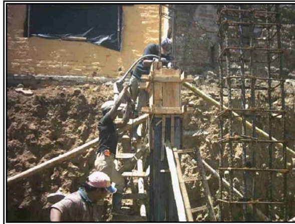
Figura 55. Vaciado y vibrado del concreto
