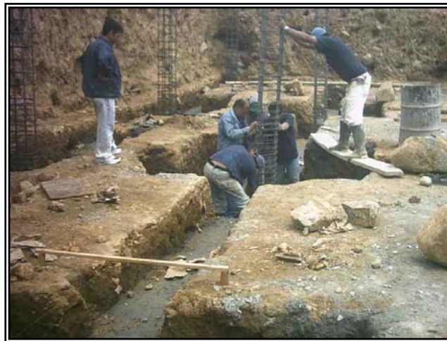
Figura 39. Colocación castillos columna.
