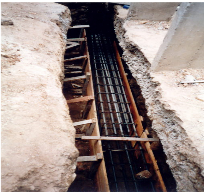
Formaleteado de la viga de cimentación
