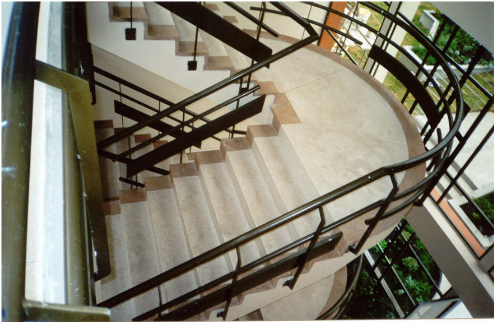
Terminación del granito pulido con la aplicación final de cera para pisos.
