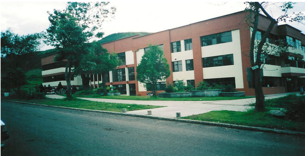
Terminación total de los acabados exteriores, en el cual se utilizó color blanco hueso y café rojizo en fachadas y color anoloc en pintura de puertas y ventanas.
