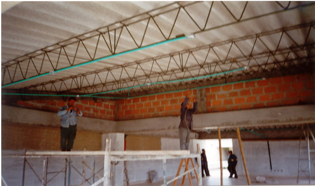
Instalación de tubería conduit interna para todo eléctrico, imagen voz y datos
