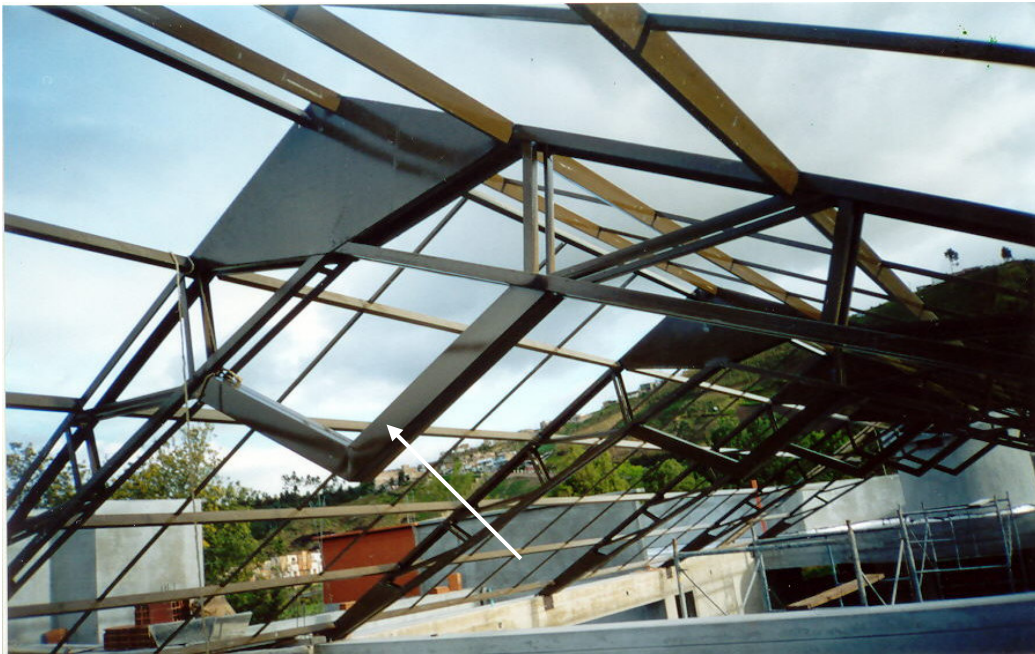
Unión en soldadura de perlines dobles en V de 12 * 6 – 0.9
