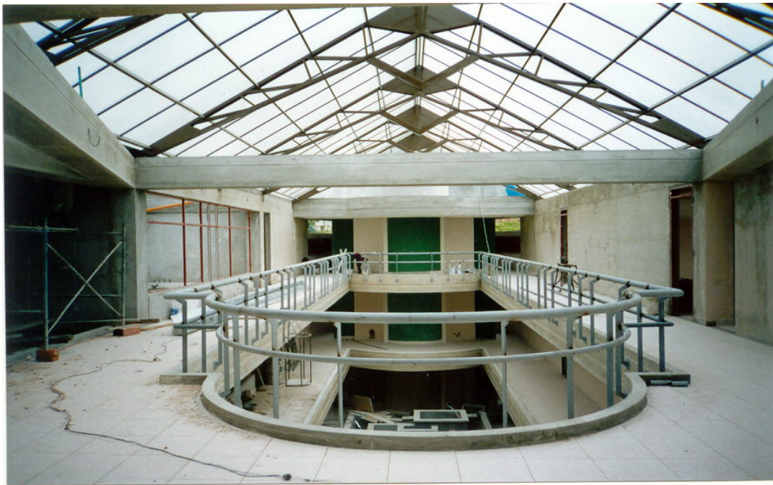
Estructura de pasamanos en la cual se utilizo tubo estructural de 2 1/2, 1 1/2.
