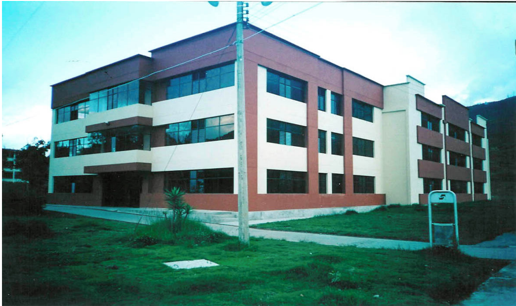
Detalle fachada posterior y fachada lateral derecha.
