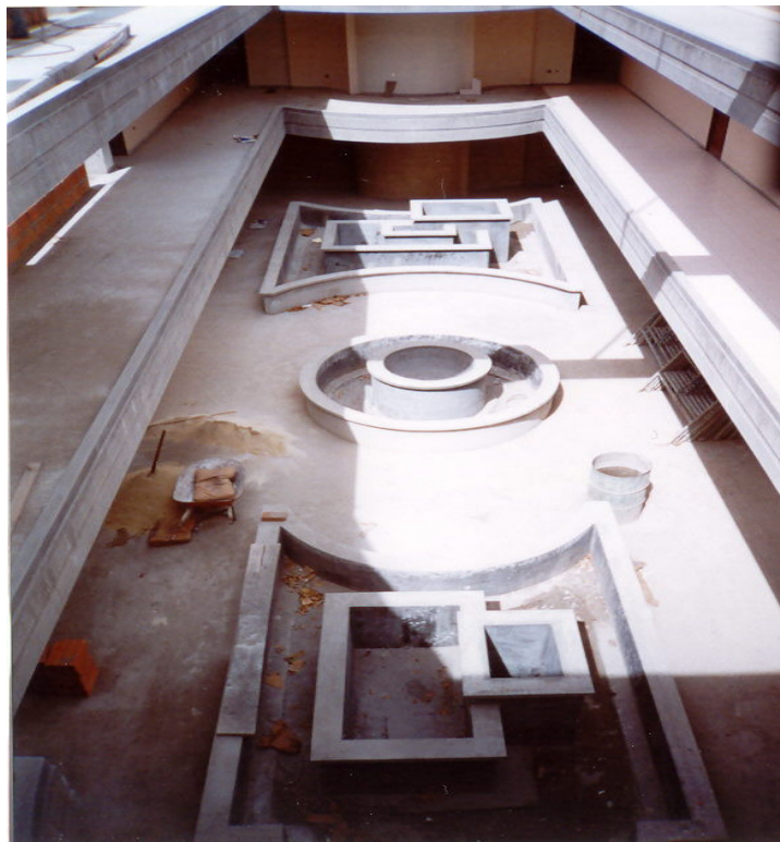
Salones proyección en su acabado final con sus respectivas sillas fijas.
