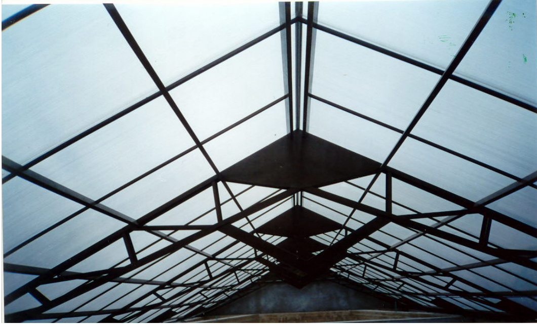
Vista inferior de la cubierta en policarbonato estructural
