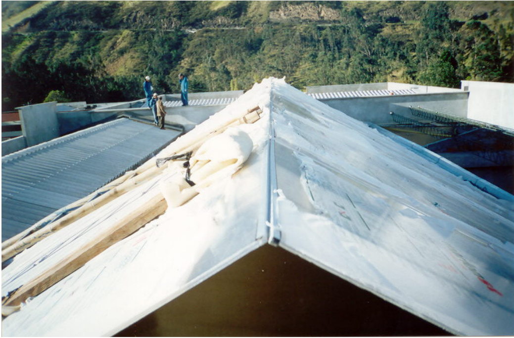
La cubierta en policarbonato terminada antes de quitarle el recubrimiento plástico
