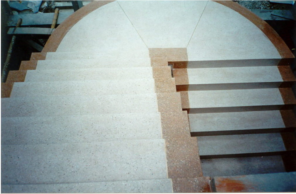
Terminación del granito pulido con la aplicación final de cera para pisos.
