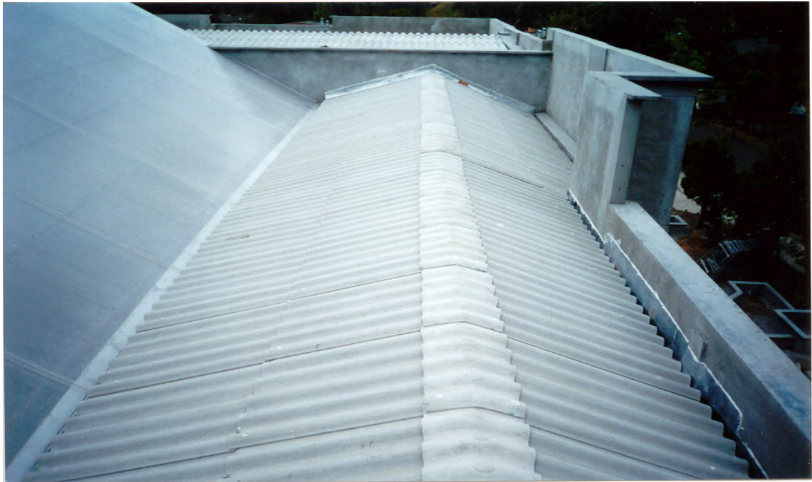
Relleno de mortero en la parte del asentamiento de las laminas
