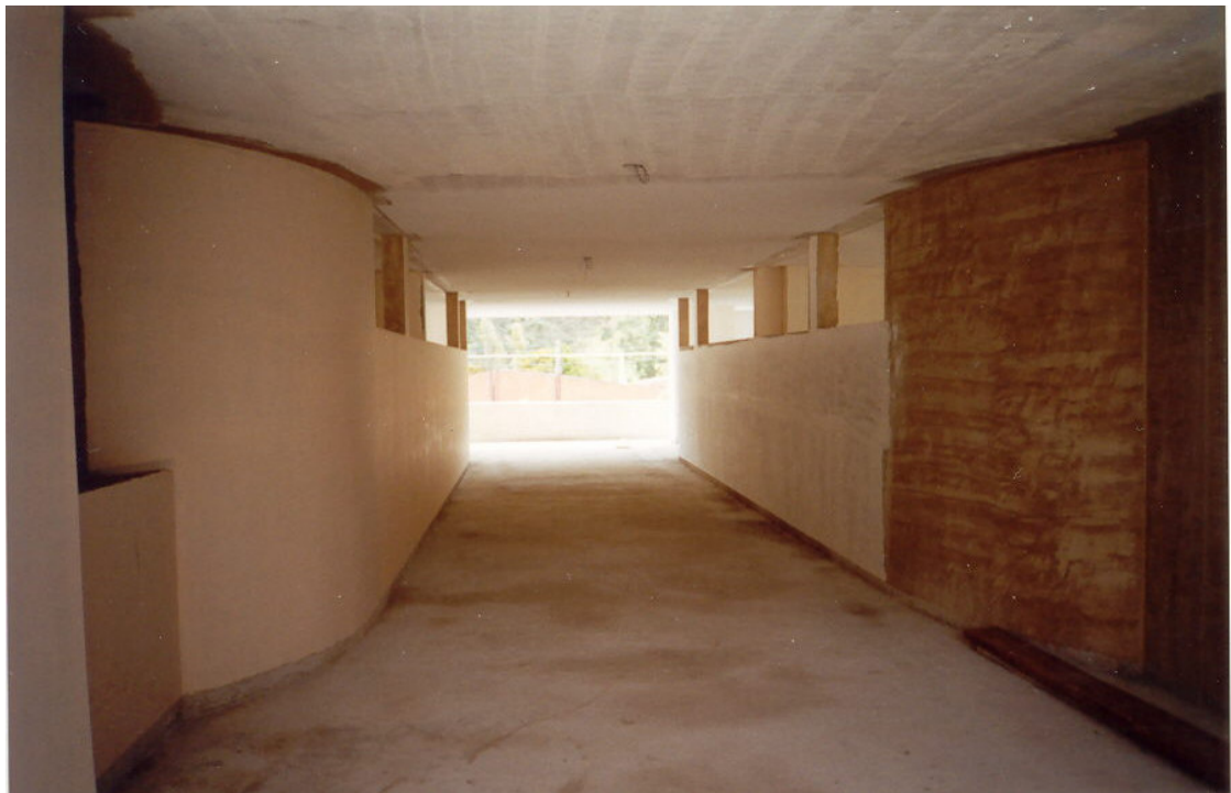
Aplicación de estuco convencional el cual es realizado con yeso caolín y cemento, este se aplico en todo el edificio, a excepción de algunas partes en donde se utilizo el estuco profesional.
