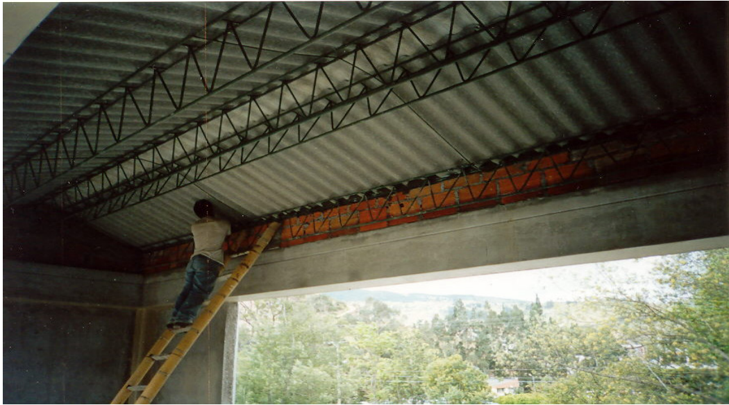
Relleno de mortero en la parte del asentamiento de las laminas
