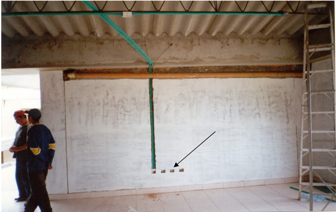
Conexión de tubería con las cajas de lo eléctrico, imagen, voz y datos.
