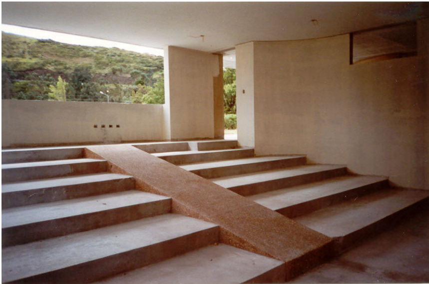
Salones del primer piso, estilo auditorio los cuales presentan niveles escalonados
