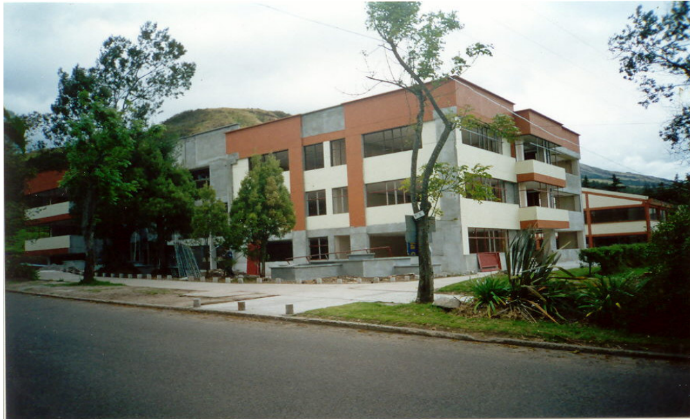
Detalle de fachada, ya pintada la \frac{3}{4} partes del edificio.
