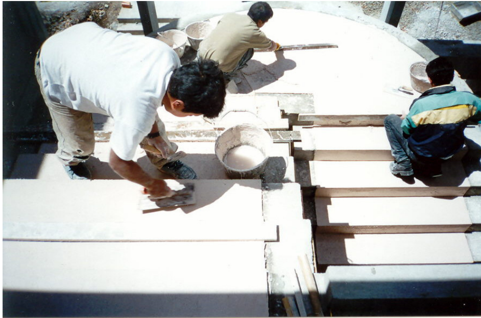
Aplicación del granito blanco, el cual se lo realiza con cemento blanco, marmolina mineral blanca y el granito.
