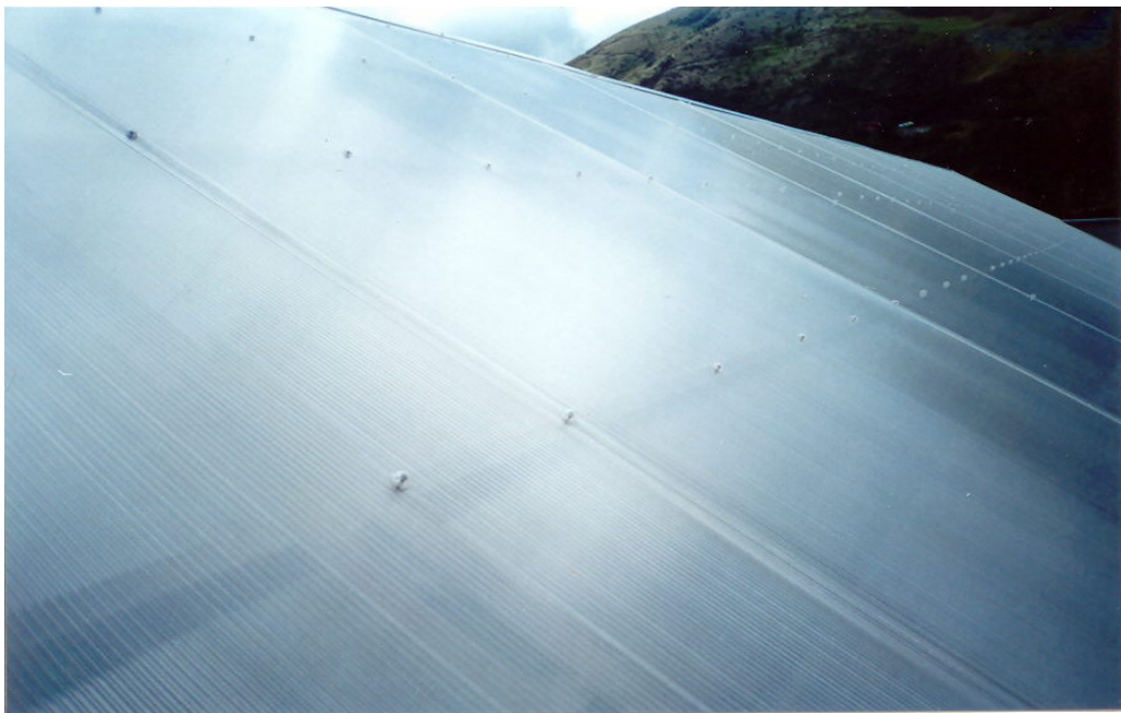
Vista lateral de la cubierta terminada.
