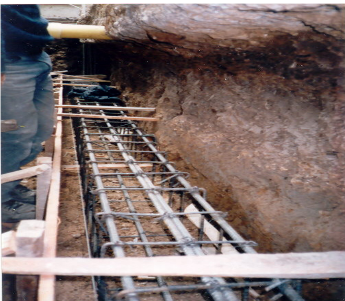
Formaleteado de la viga de cimentación
