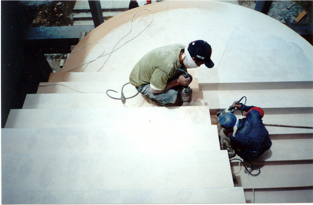
Pulimento del granito, esto se lo hace con una pulidora convencional.
