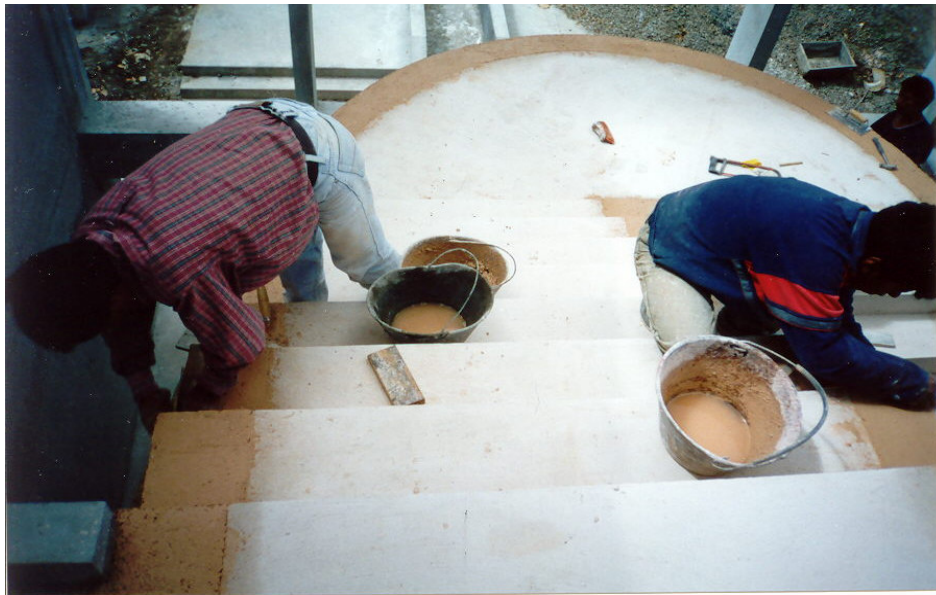
Aplicación del granito café, y su realización es igual a la del blanco pero con mineral café.
