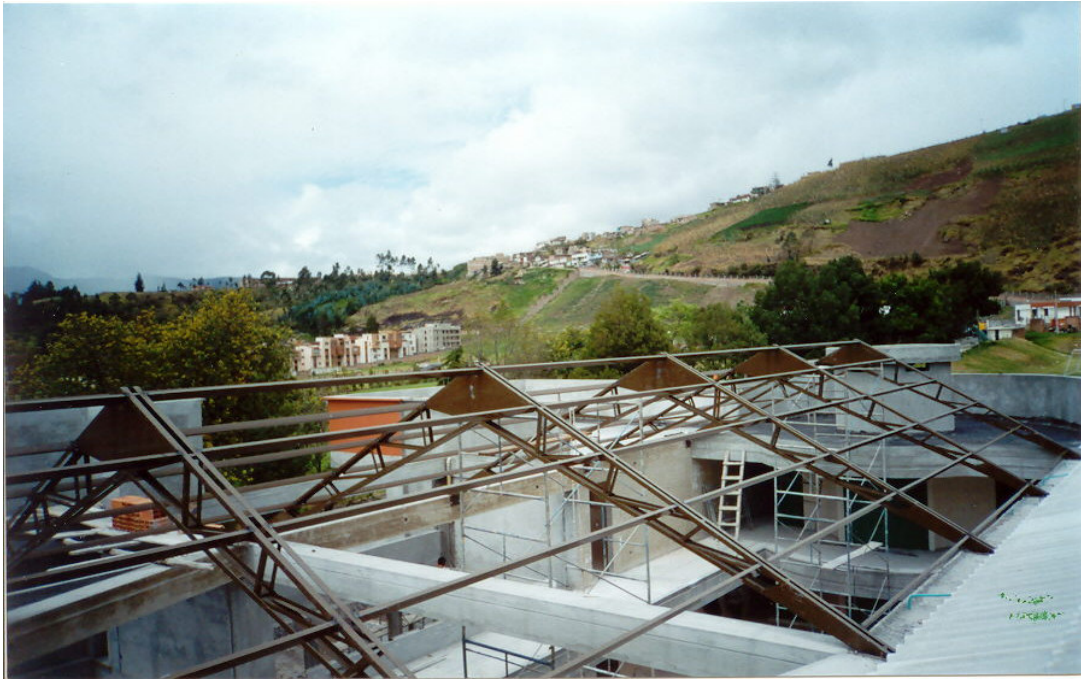
Instalación total de todas las correas de toda la estructura metálica.
