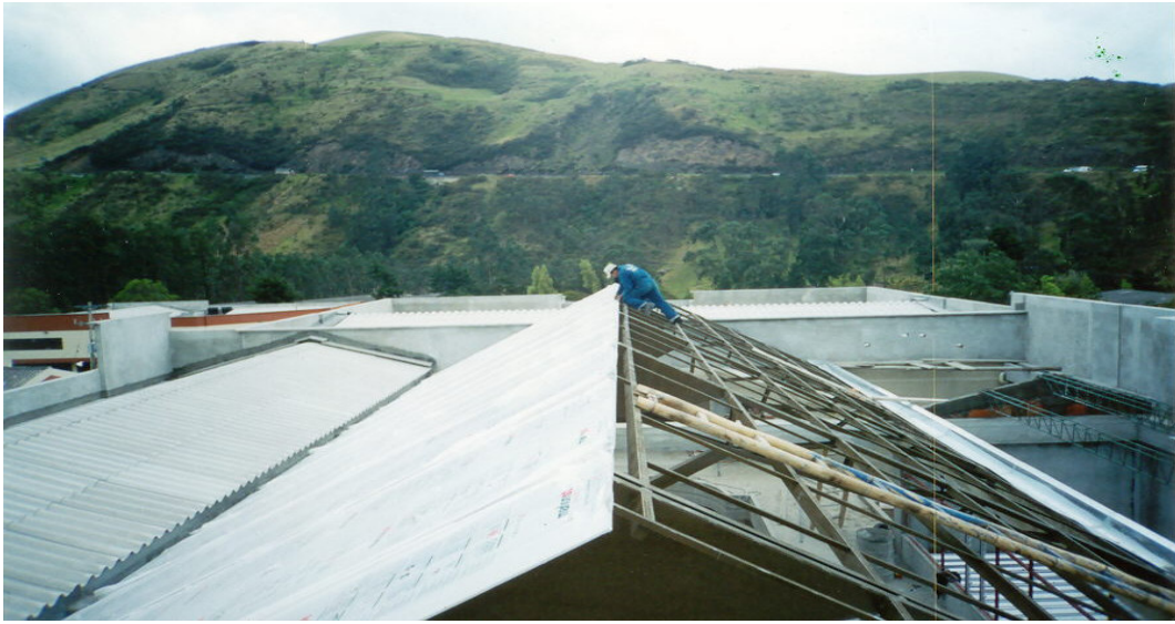
Instalación de las laminas de un solo lado de la estructura metálica
