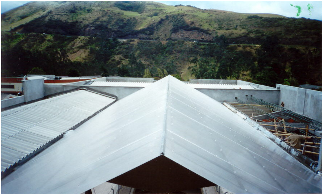
Vista de la cubierta totalmente terminada, con la adición de un ángulo metálico con el fin de prevenir filtraciones por el espacio dejado en medio de las dos aguas.
