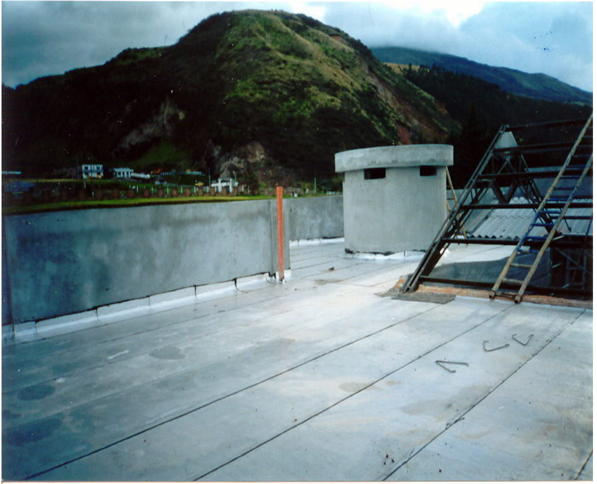
Terminación de la impermeabilización de la losa de cubierta.
