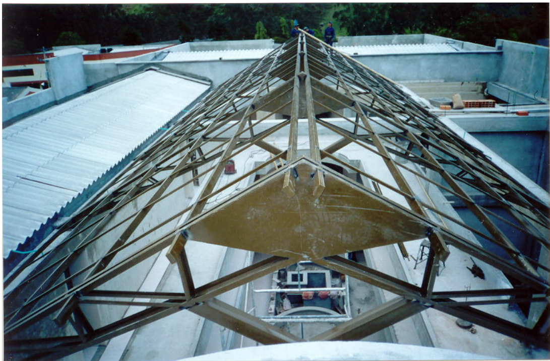
Terminación total de la cubierta en estructura metálica del bloque de aulas
