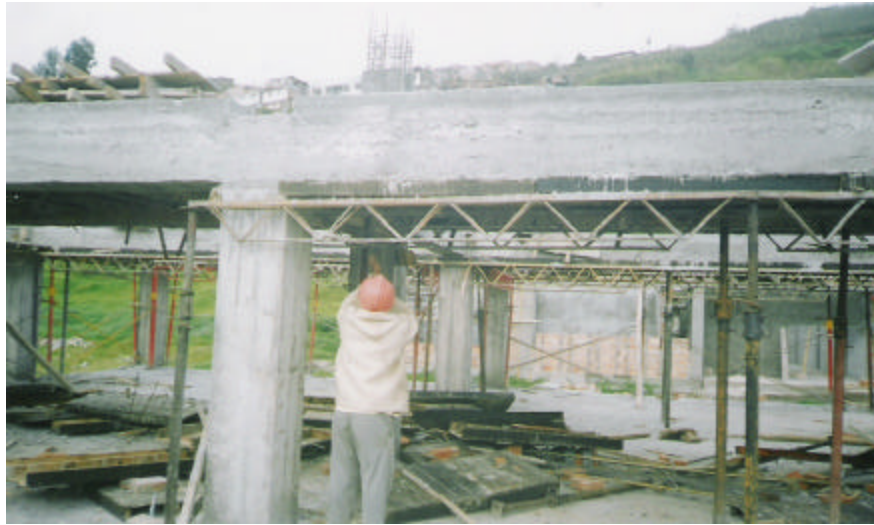
Figura 96. Retiro de la formalería
