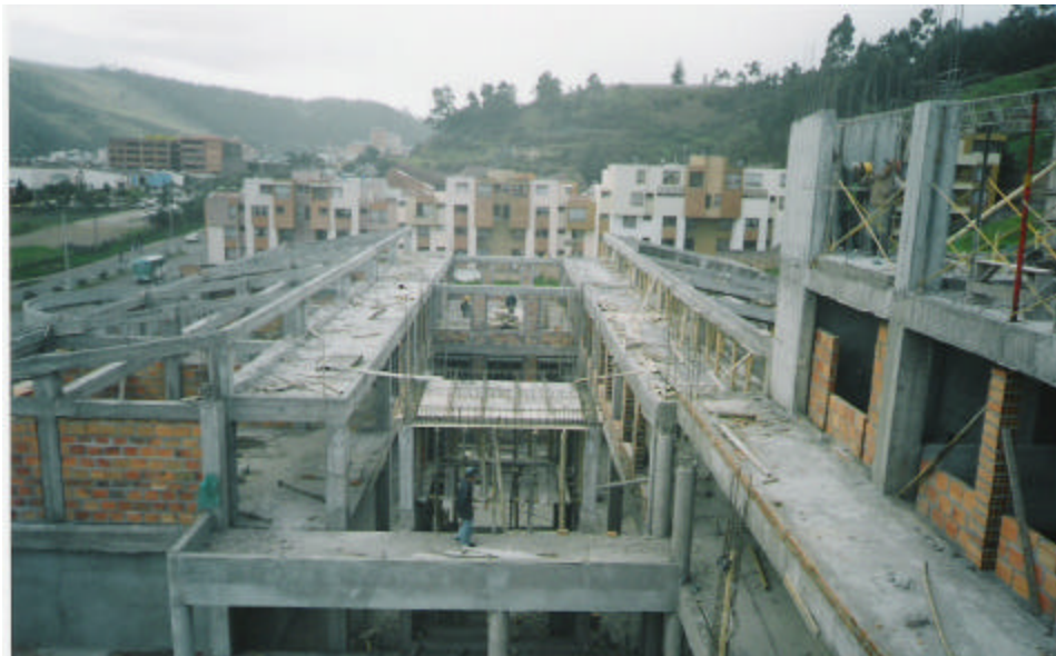
Figura 138. Avance de obra
