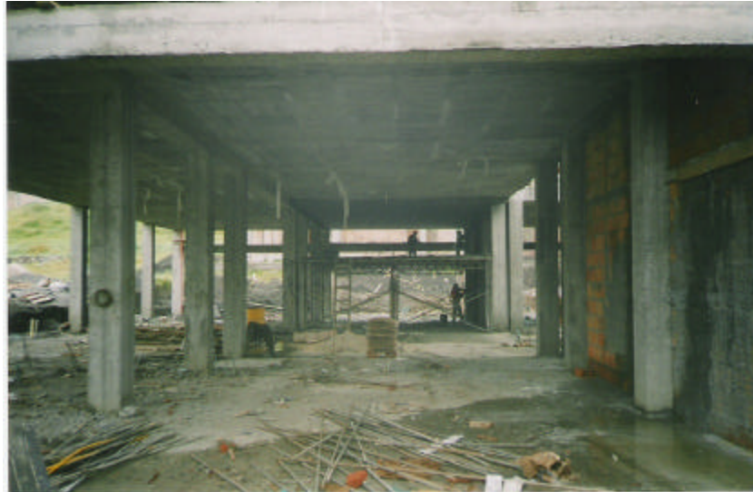
Figura 85. Vista general bloque 1 primer piso
