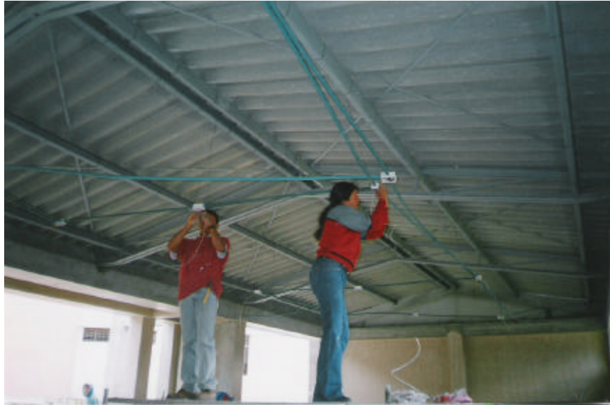
Figura 50. Instalación de alambrado
