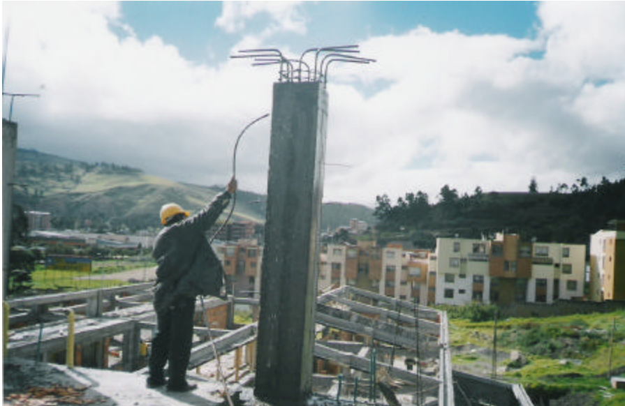
Figura 155. Curado del concreto
