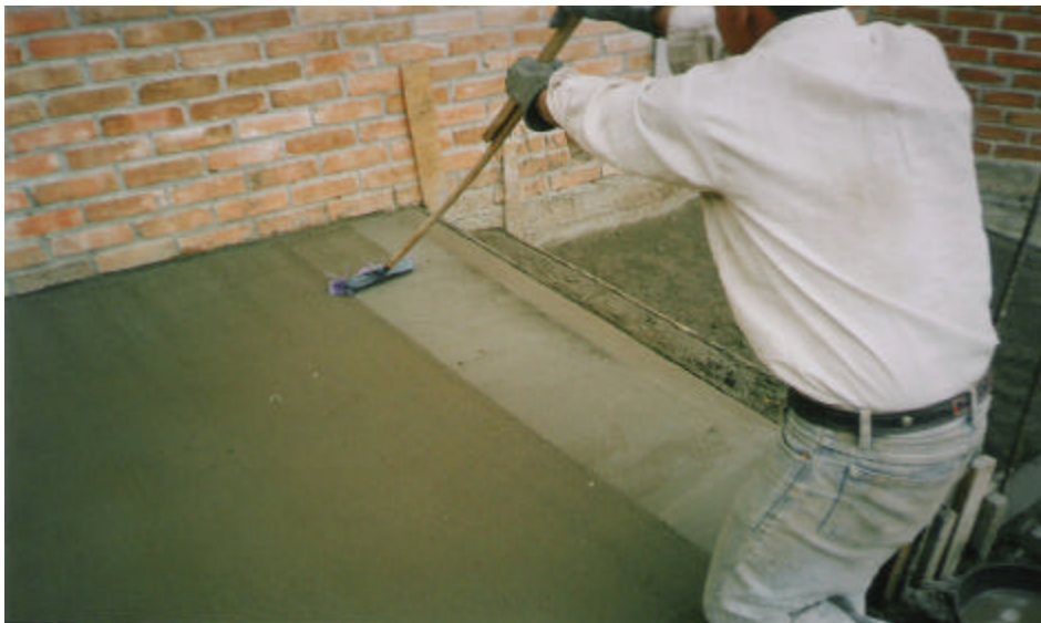
Figura 19. Escobillado
