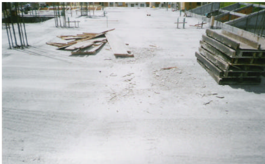
Figura 81. Vista general de la losa
