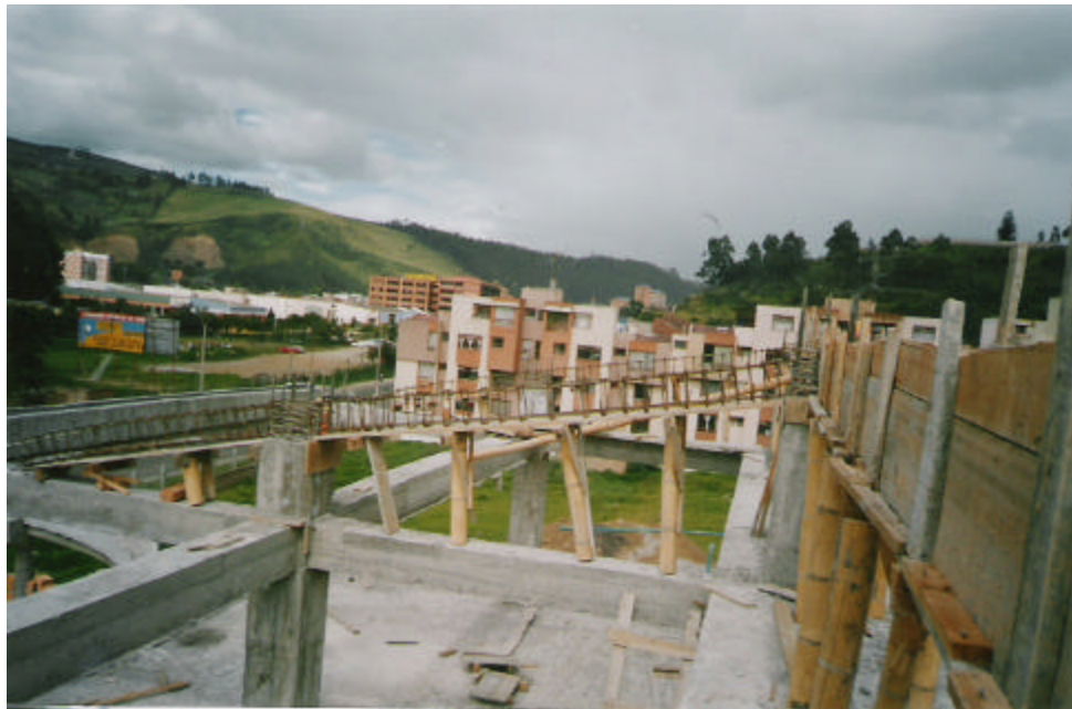
Figura 105. Armado de vigas inclinadas
