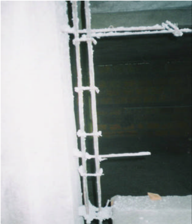
Figura 117. Columna y columneta
