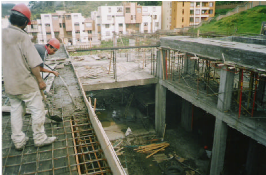
Figura 91. Fundición y vibrado
