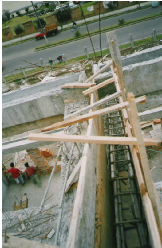
Figura 107. Revisión del encofrado
