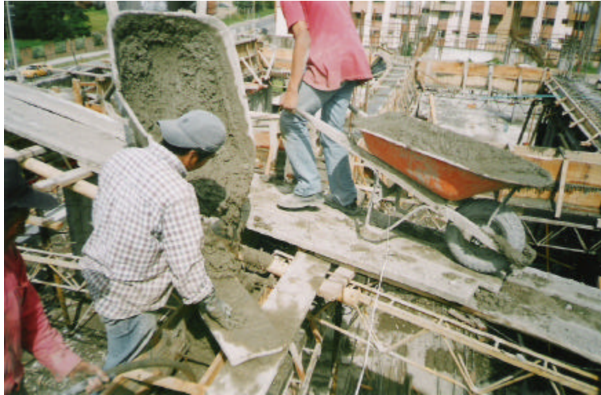
Figura 87. Vaciado de las vigas aéreas y canal
