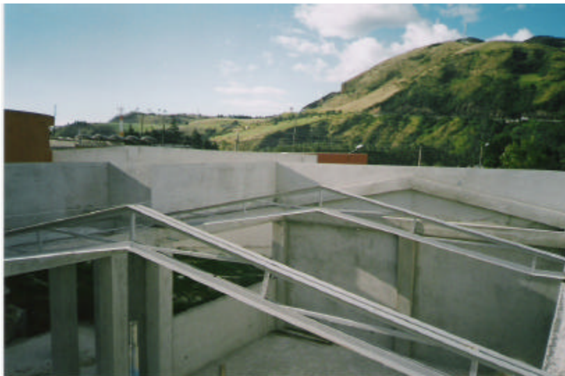
Figura 43. Alineamiento de las cerchas
