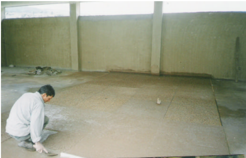
Figura 59. Aplicación de la mezcla
