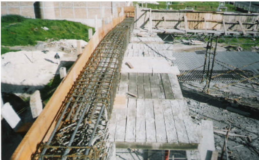
Figura 156. Vigas aéreas para cubierta bloque 4
