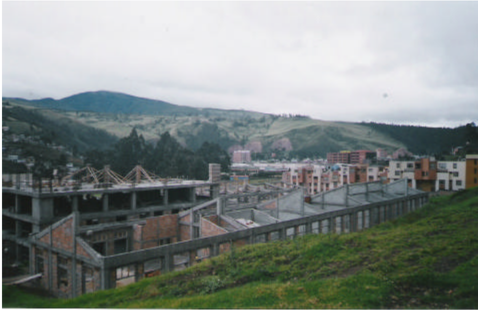
Figura 131. Vista general bloques 1-3-4-taller
