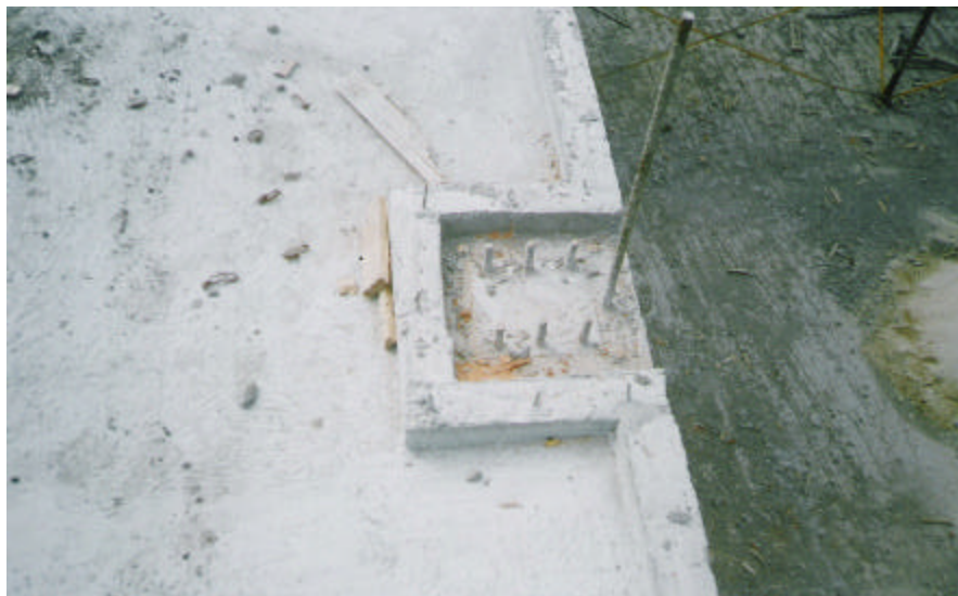
Figura 95. Anclajes instalados
