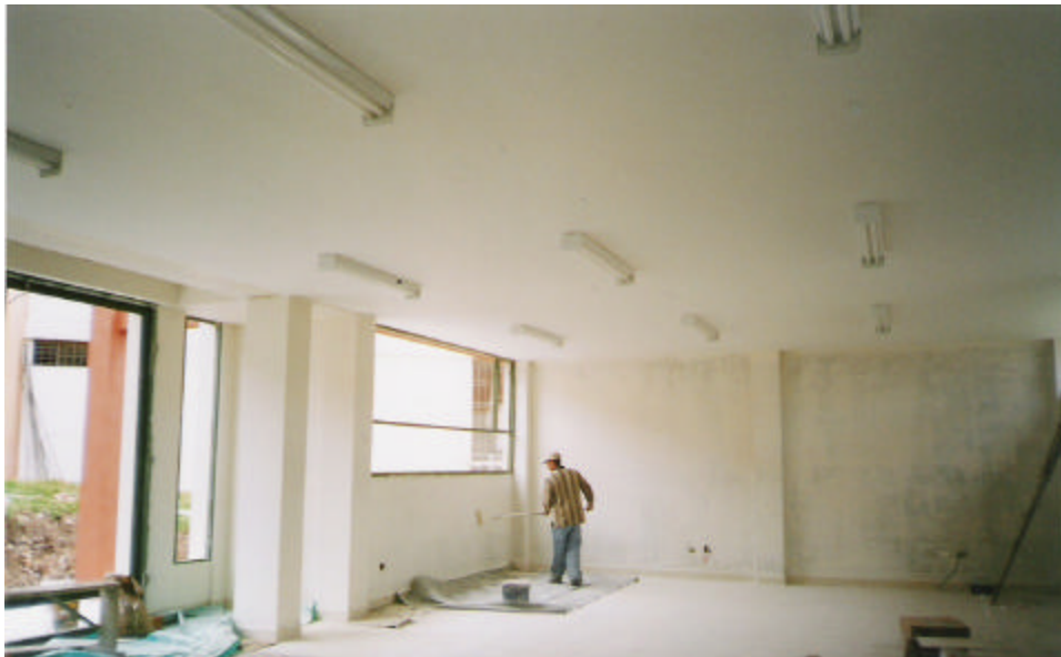
Figura 62. Pintura de interiores
