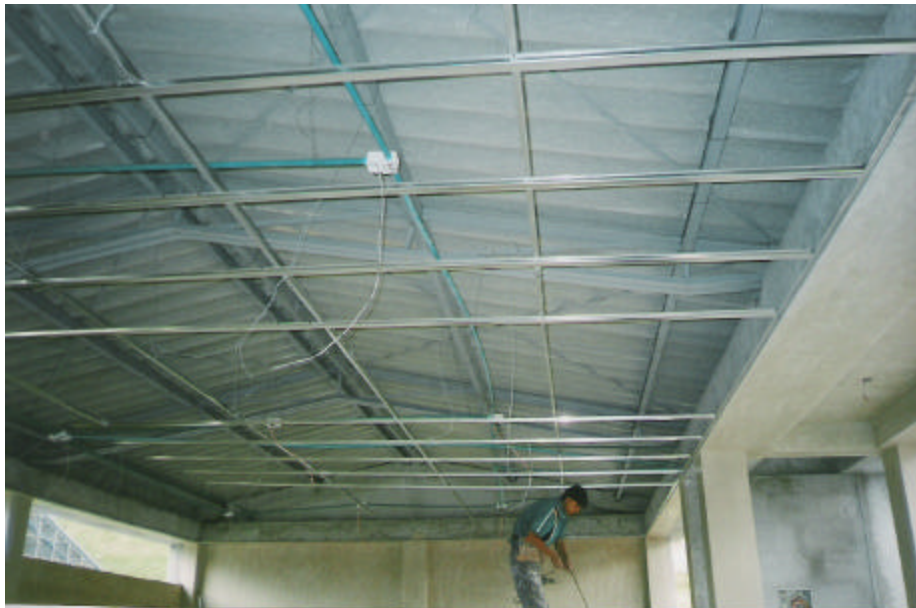
Figura 51. Instalación de soportes metálicos
