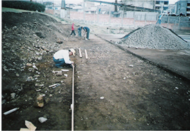
Figura 5. Instalación de formaletas
