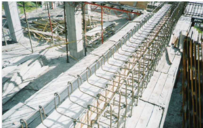
Figura 158. Detalle de viga canal
