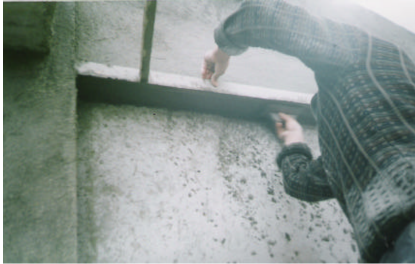
Figura 144. Conformación de fillos
