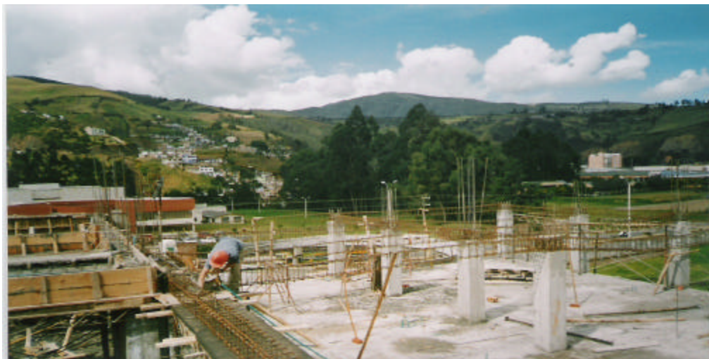
Figura 84. Vista general del bloque 1 N+6.80
