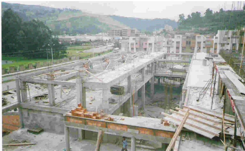
Figura 130. Vista general en planta bloques 1-2-3-5
