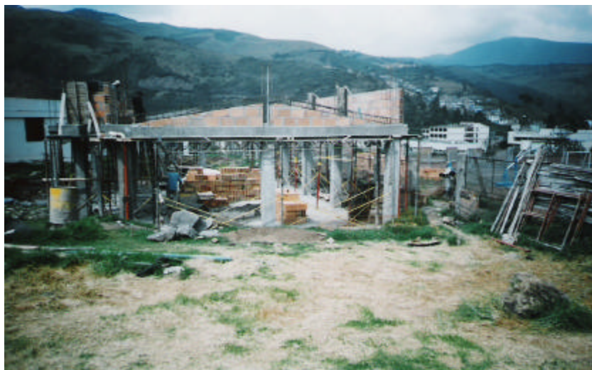
Figura 23. Vista general de la obra
