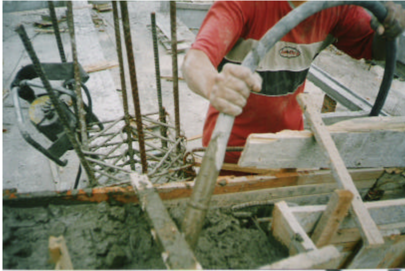
Figura 110. Fundición de las vigas
