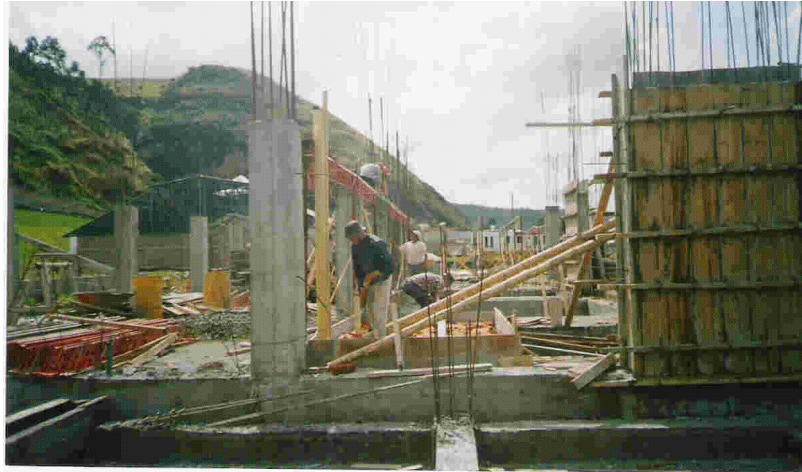
Figura 151. Apuntalado de formaleta para las columnas y pantallas
