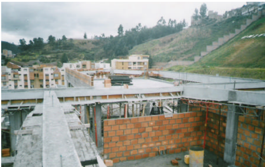
Figura 164. Construcción de muros bloque 4 nivel 4
