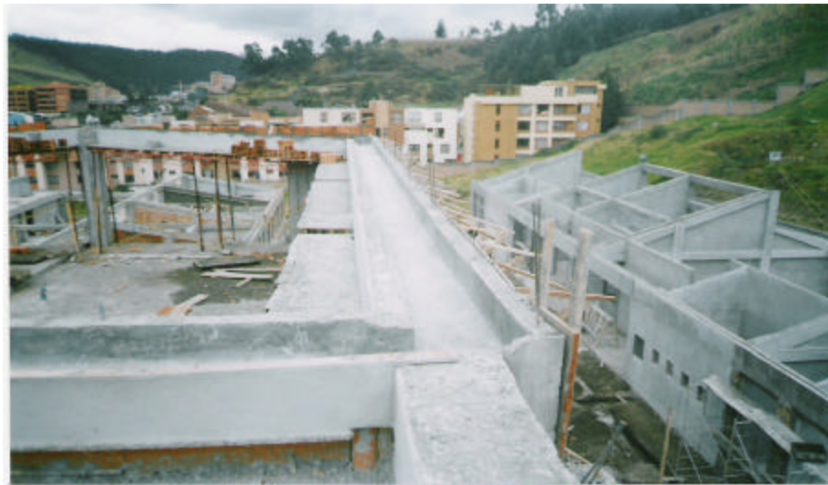
Figura 160. Vigas canal fundidas
