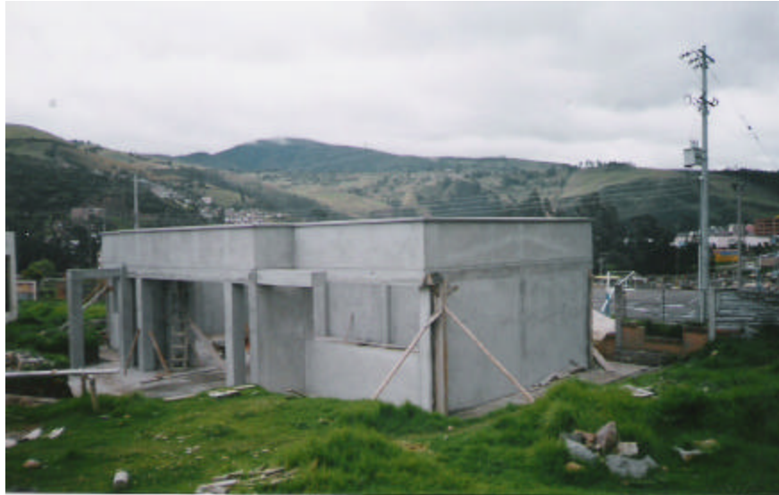
Figura 40. Vista general de la obra
