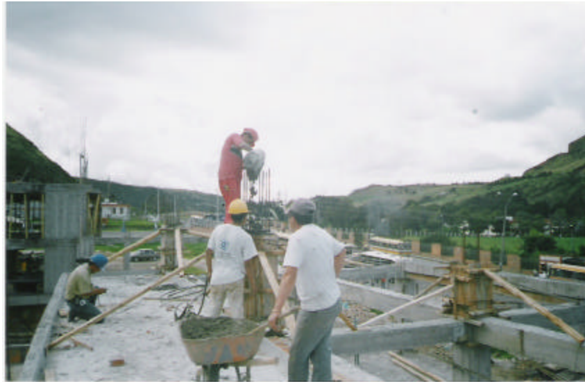
Figura 100. Vaciado de la mezcla
