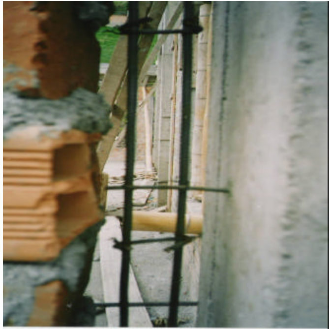
Figura 119. Columna, columneta y muro
