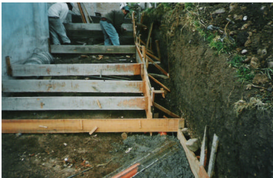
Figura 12. Encofrado
