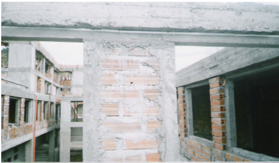
Figura 140. Avance de obra y confinamiento de muros
