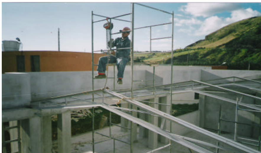
Figura 41. Montaje de cerchas
