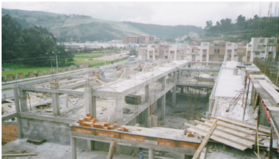
Figura 97. Vista general de las losas
