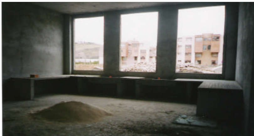
Figura 142. Construcción de mesones
