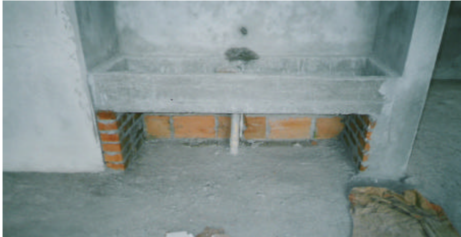
Figura 141. Construcción de pozetas
