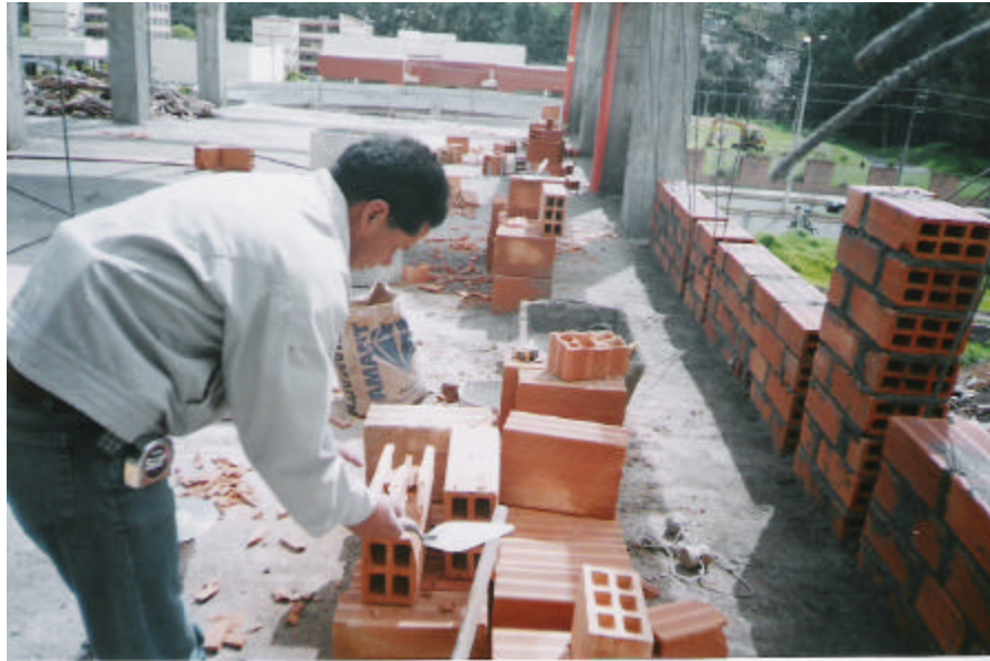
Figura 121. Acondicionamiento del ladrillo
