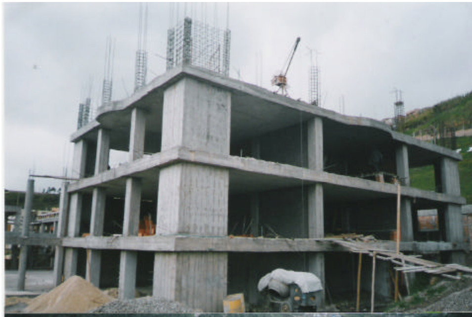
Figura 148 vista general de los bloques 4-5
