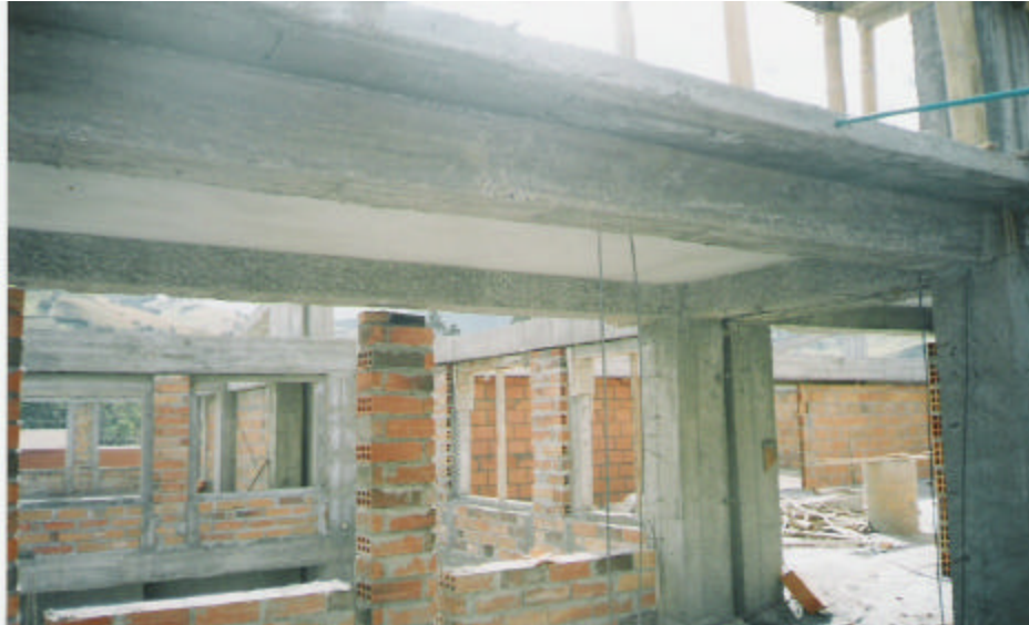
Figura 139. Avance de obra muros de fachada
