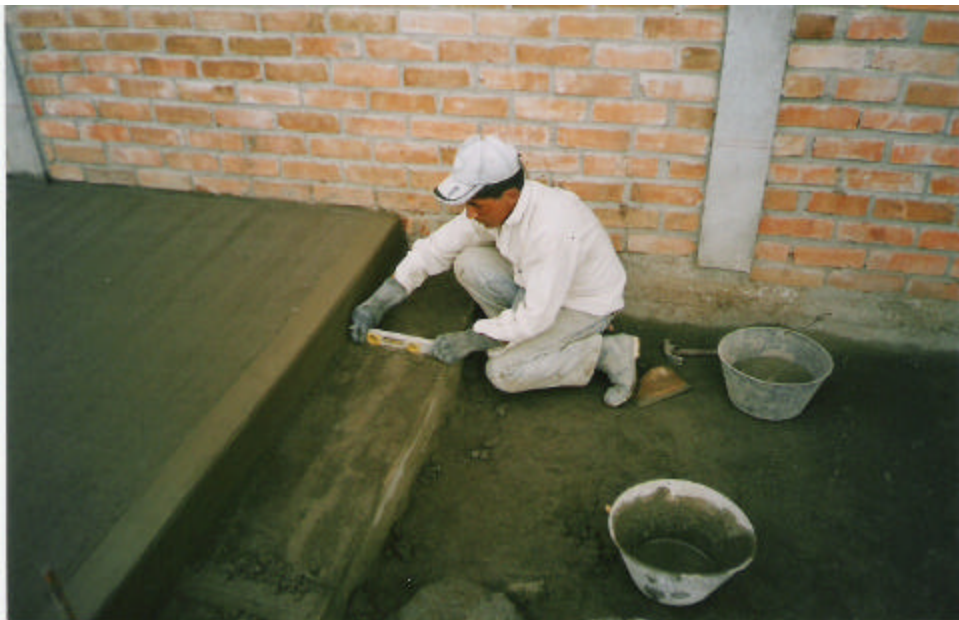
Figura 17. Nivelación del pañete
