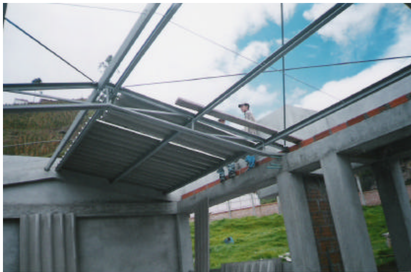
Figura 47. Instalación de tejas
