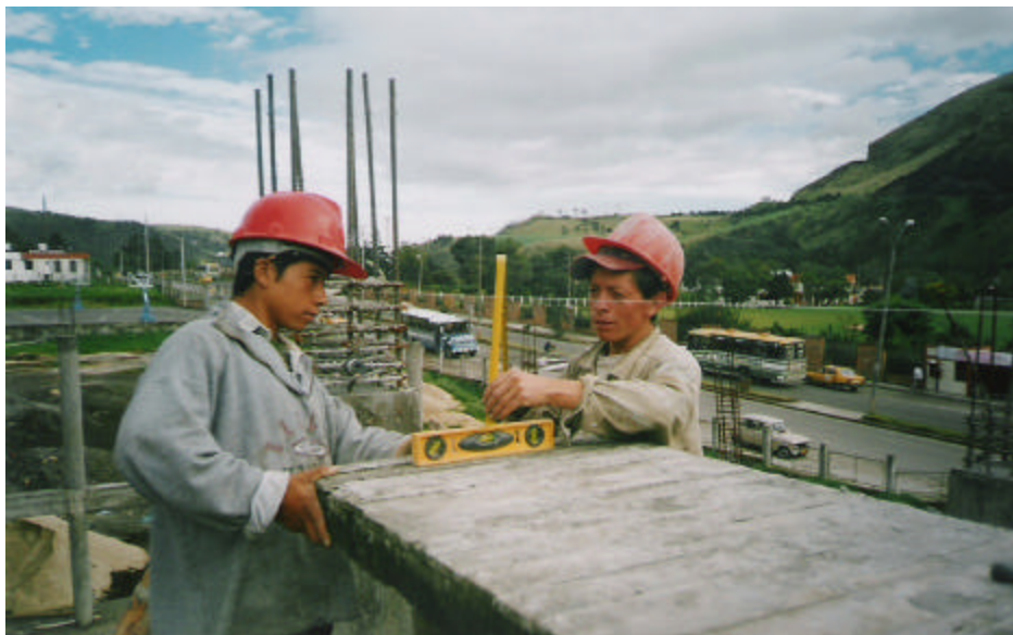
Figura 103. Nivelación de tableros
