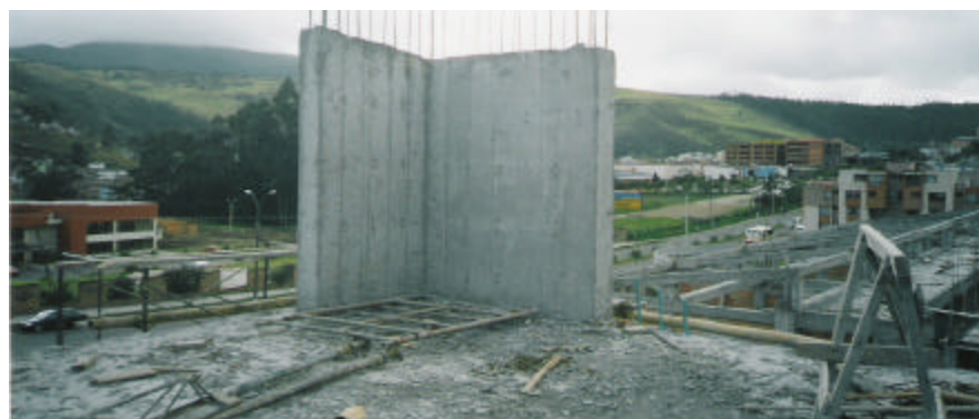
Figura 154. Pantalla doble fundida
