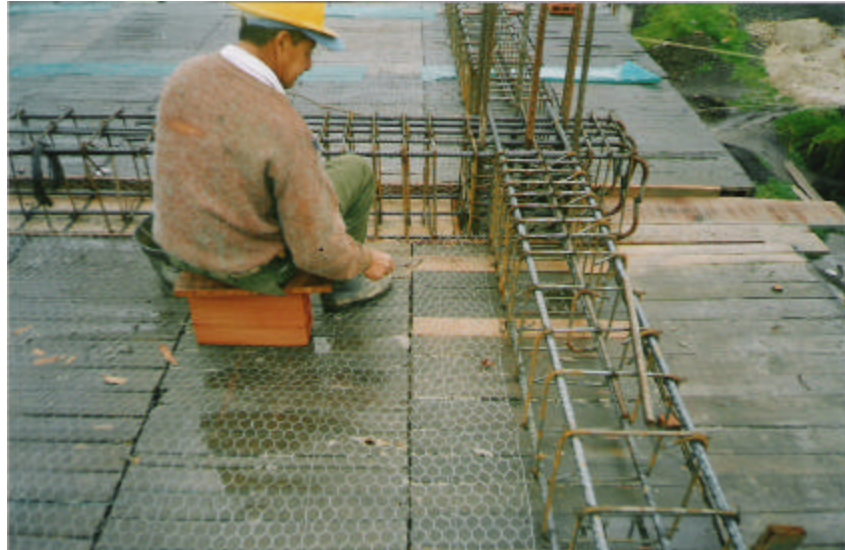
Figura 66. Armado de vigas cargueras y riostras
