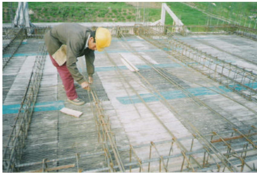
Figura 67. Armado de nervios
