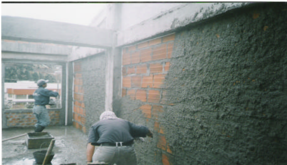
Figura 143. Repello de muros bloque 2 segundo nivel
