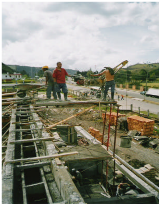
Figura 86. Instalación de la pluma
