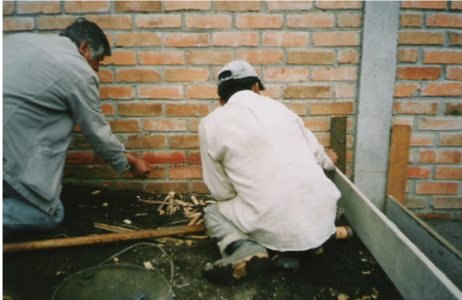
Figura 11. Cimbrado y encofrado
