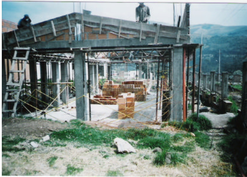
Figura 27. Encofrado para la fundición de las vigas
