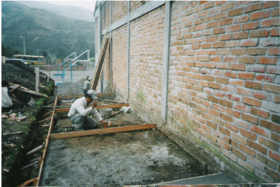
Figura 13. Construcción de juntas para andenes
