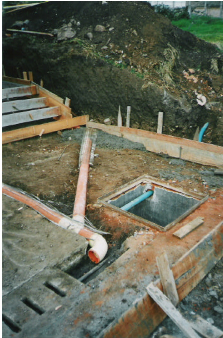
Figura 14. Instalación de desagües
