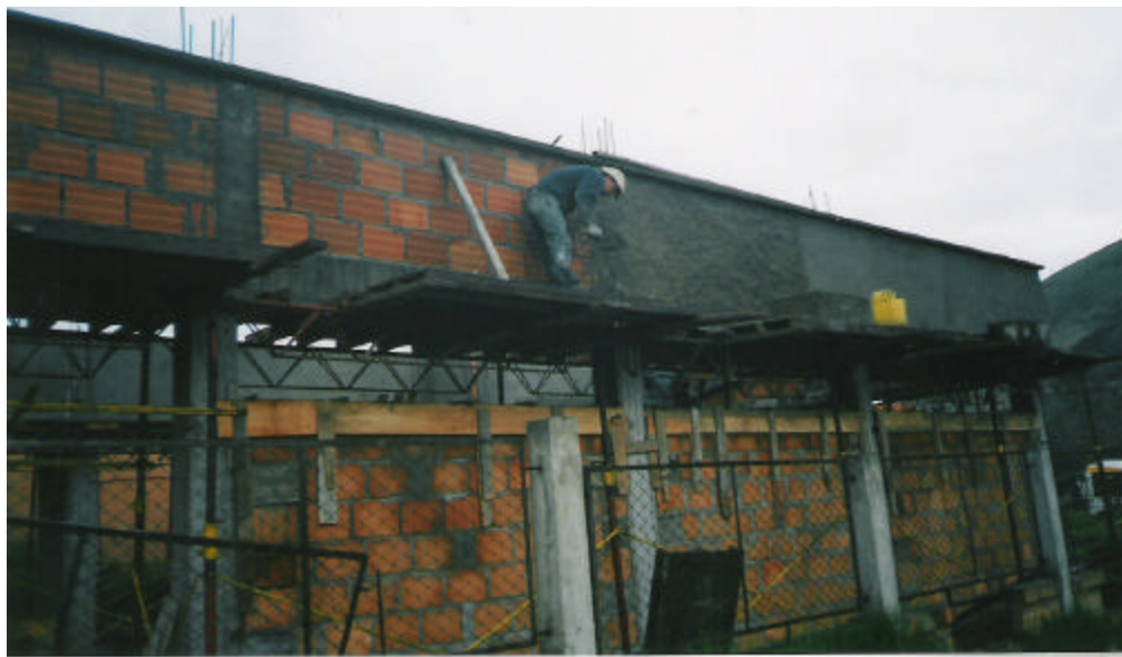
Figura 33. Repellado y afinado (externo)
