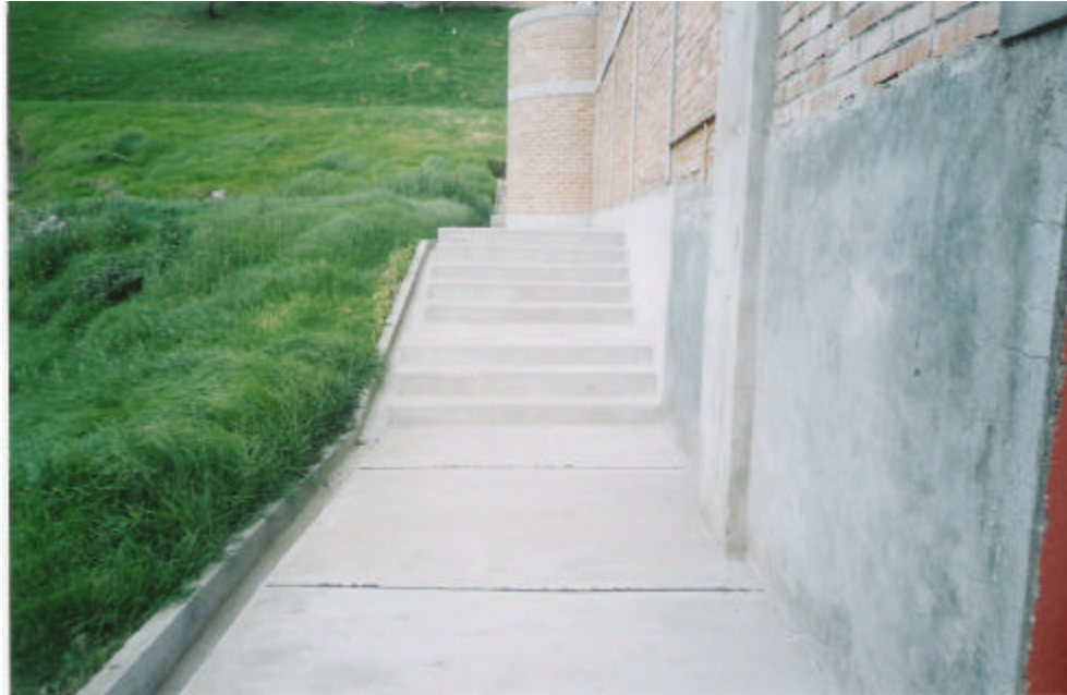
Figura 22. Vista general del trabajo realizado
