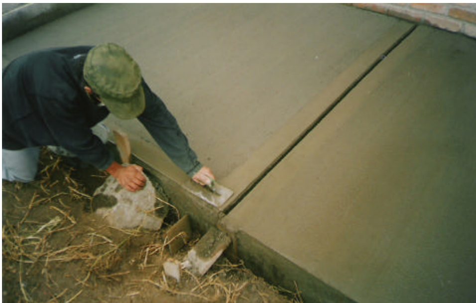
Figura 21. Acolillado de juntas
