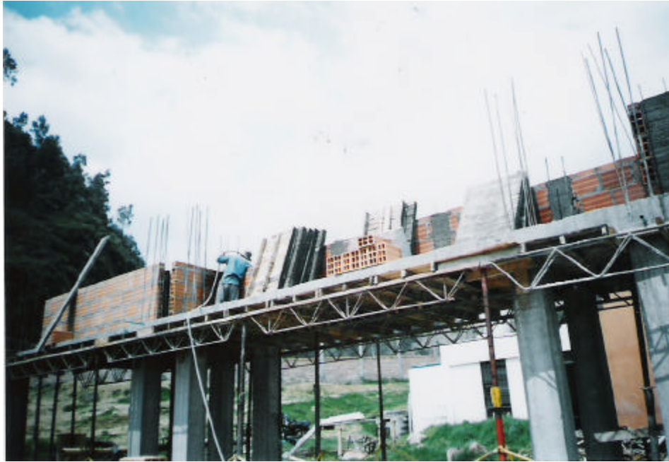
Figura 30. Confinamiento de la cumbrera
