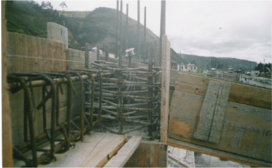
Figura 106. Encofrado de vigas
