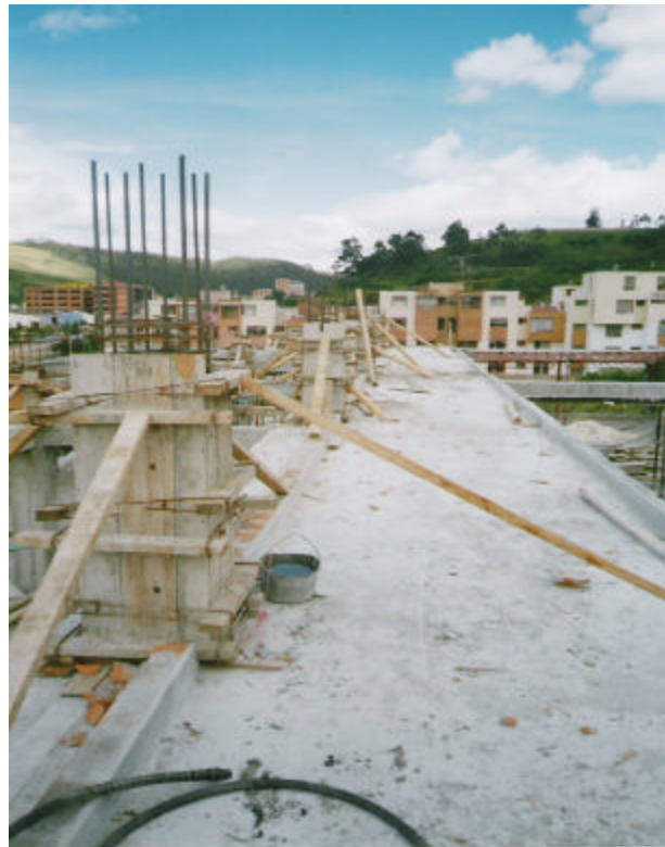
Figura 99. Encofrado y apuntalamiento
