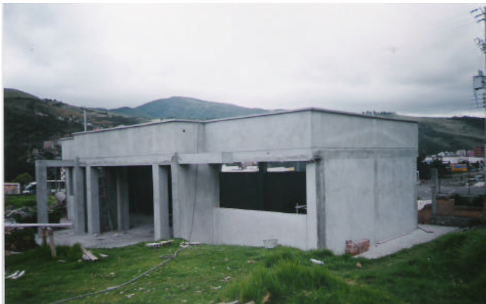
Figura 55. Panorama general de la obra
