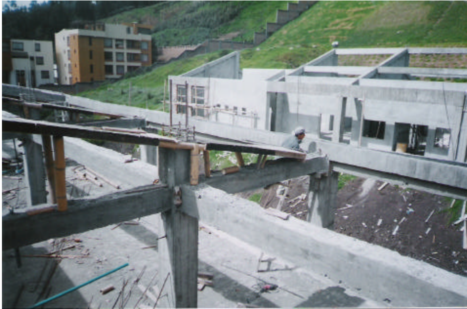
Figura 105. Armado de vigas inclinadas
