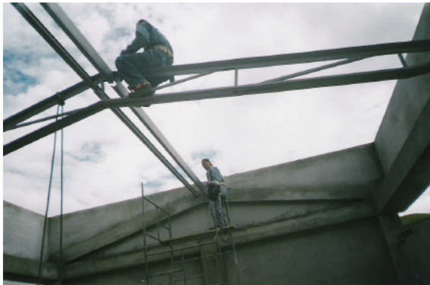
Figura 45. Verificación de los alineamientos
