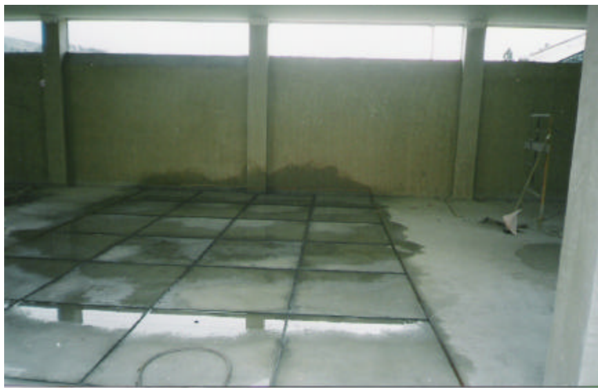
Figura 57. Juntas terminadas
