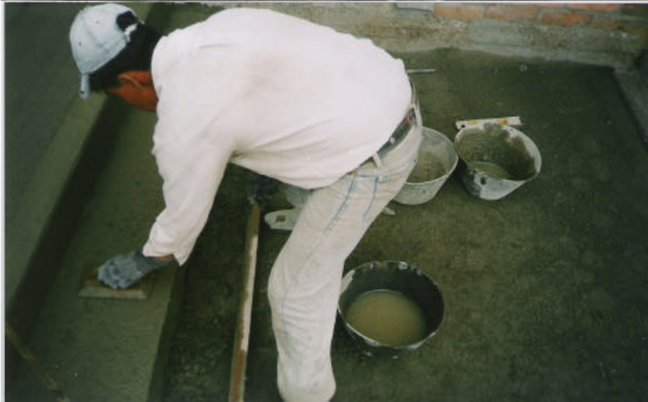
Figura 18. Repellado y llanado
