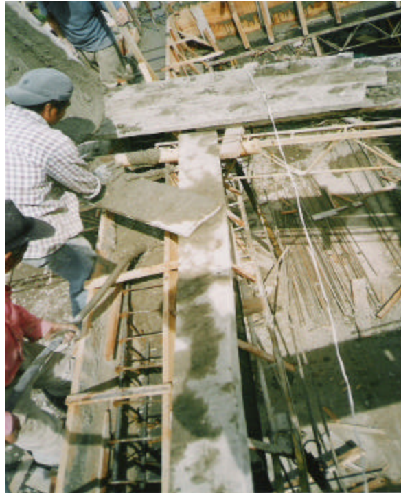
Figura 28. Fundición y vibrado de vigas
