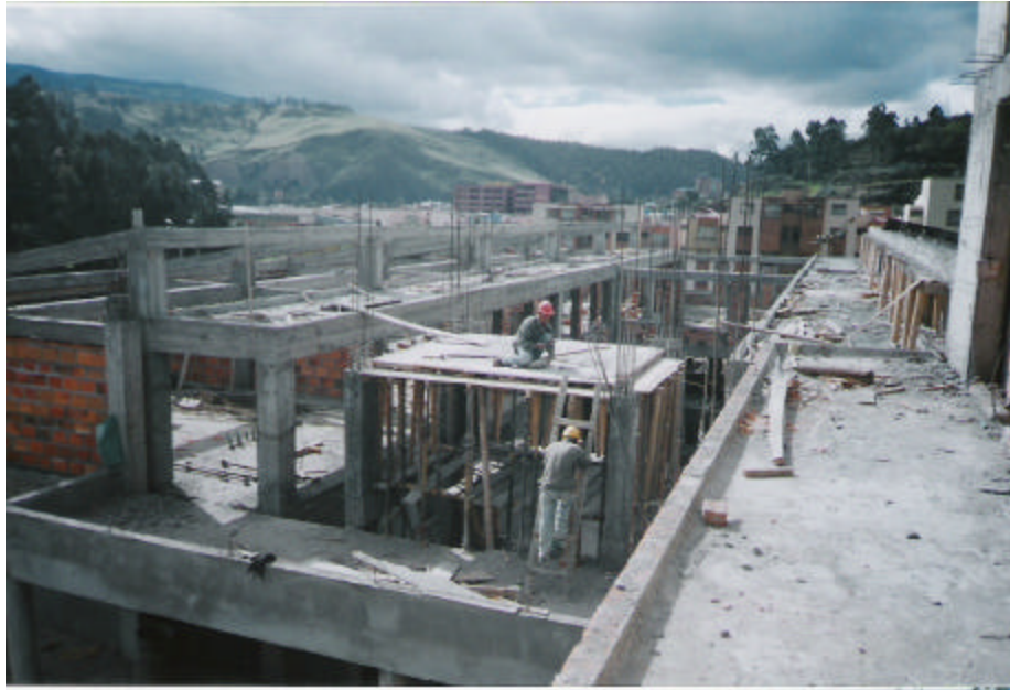
Figura 137. Pantallas fundidas y armado de losa
