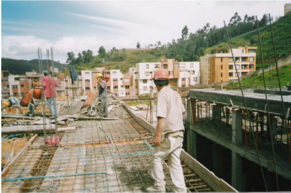
Figura 90. Fundición de vigas de losa
