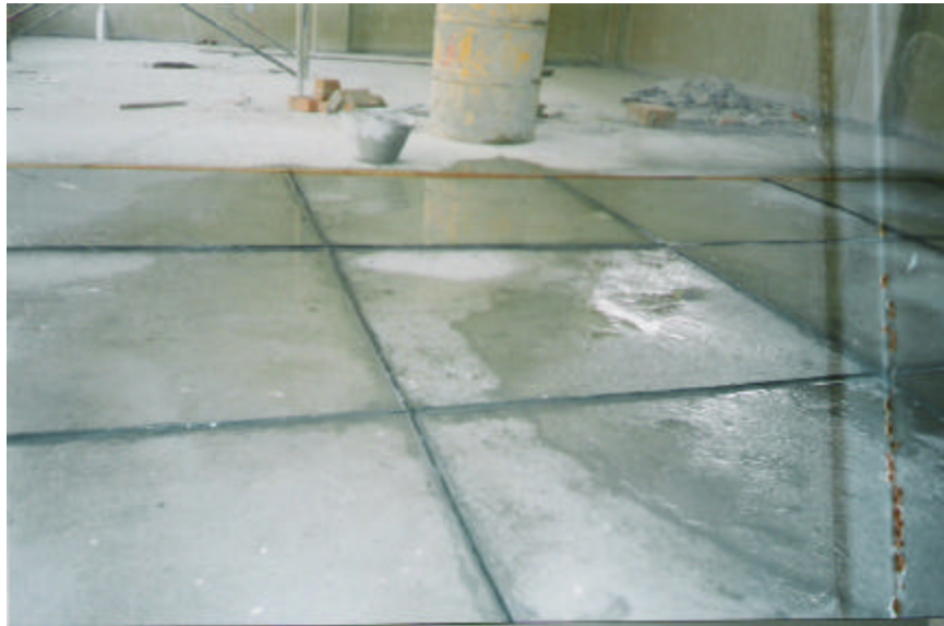
Figura 56. Instalación de juntas de dilatación
