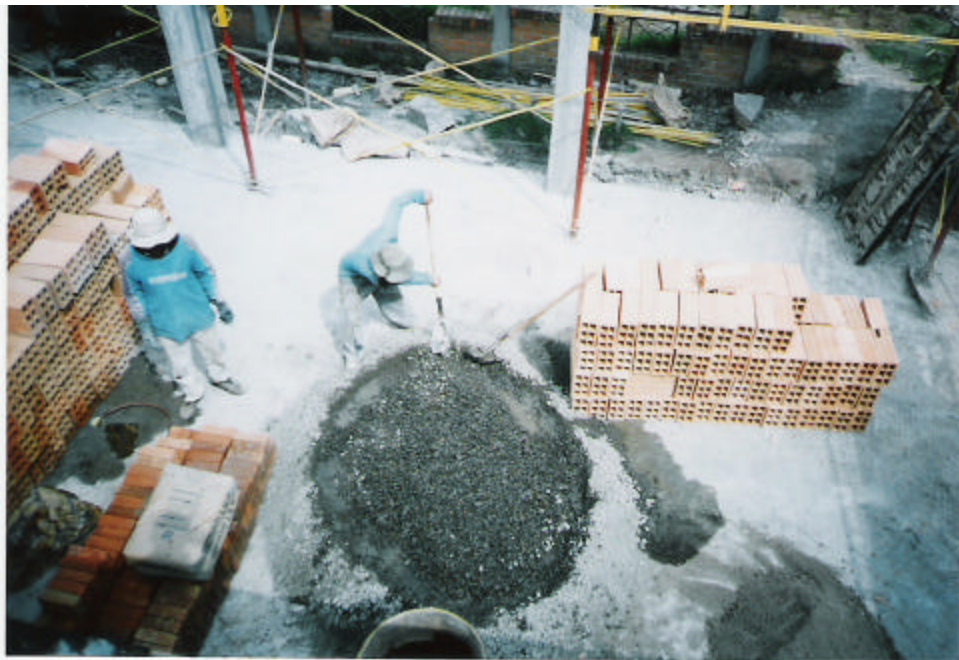
Figura 31. Mezclado del material
