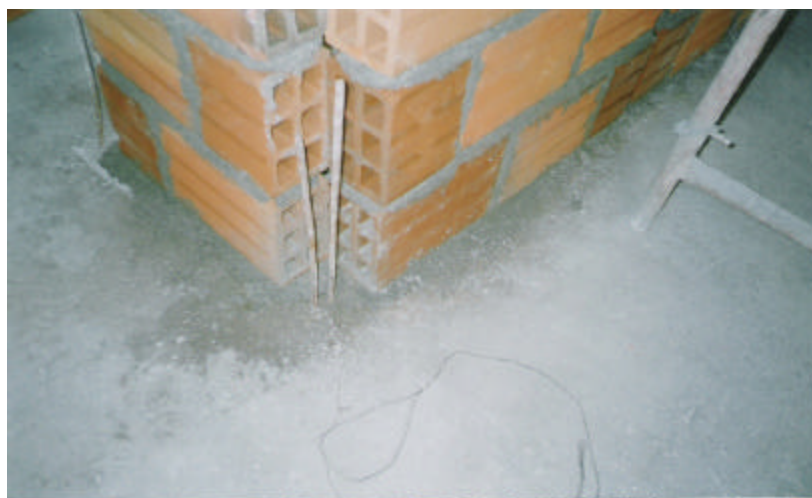
Figura 114. Anclado de las columnetas
