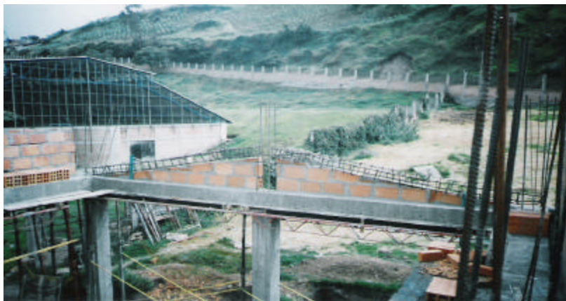
Figura 24. Vista general del despiece
