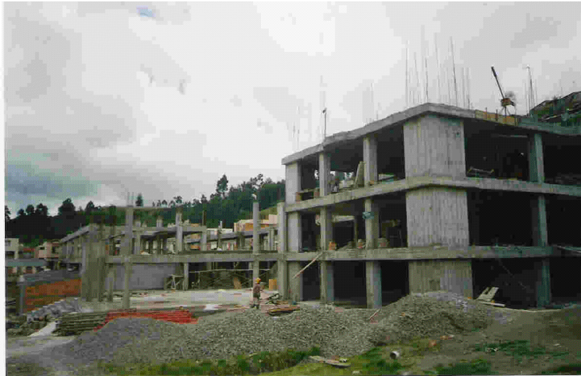
Figura 129. Vista general de los bloques 4-5
