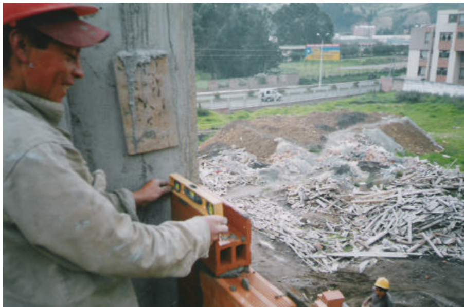
Figura 122. Nivelado
