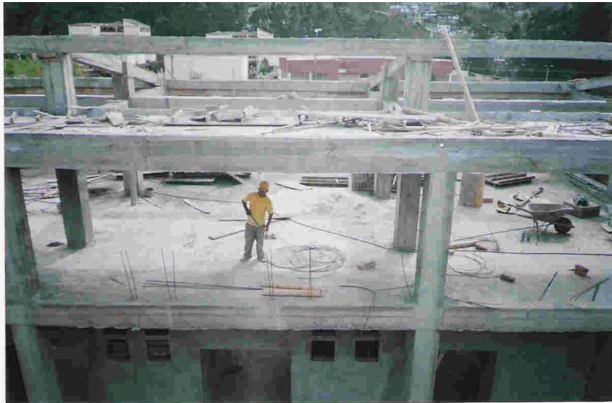
Figura 128. Vista general de la obra antes del convenio n° 076- 04 bloques 1-2-3
