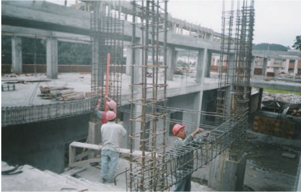
Figura 135. Vigas y pantallas bloque 5 – escaleras
