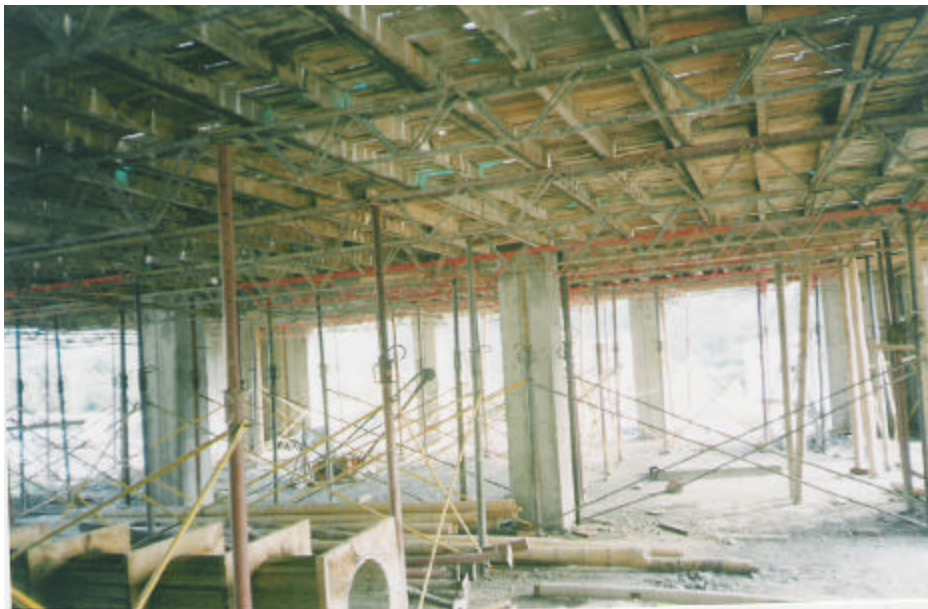
Figura 65. Apuntalamiento de la losa
