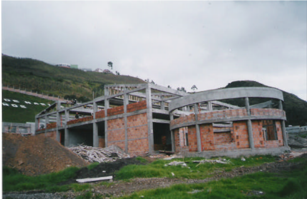
Figura 133. Construcción muros nivel 2 eje A
