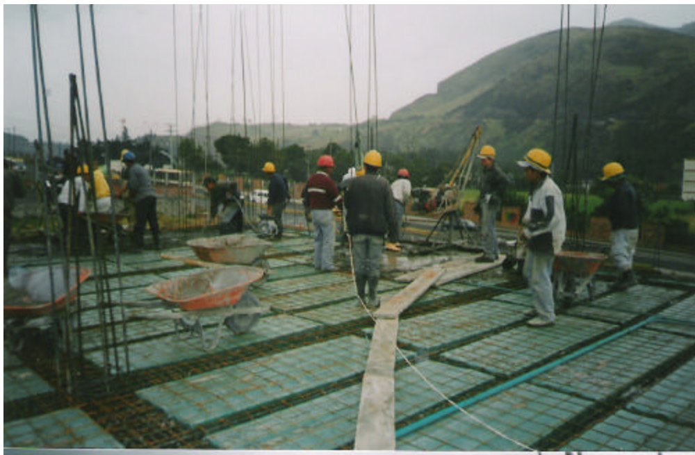
Figura 77. Vaciado de la mezcla de concreto
