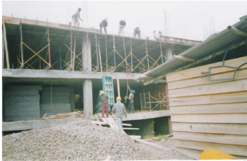
Figura 72. Instalación de casetones en el sitio
