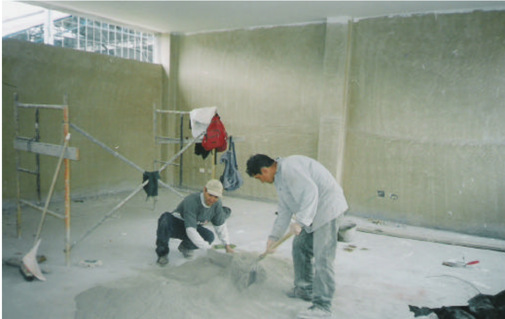
Figura 58. Mezcla de los materiales
