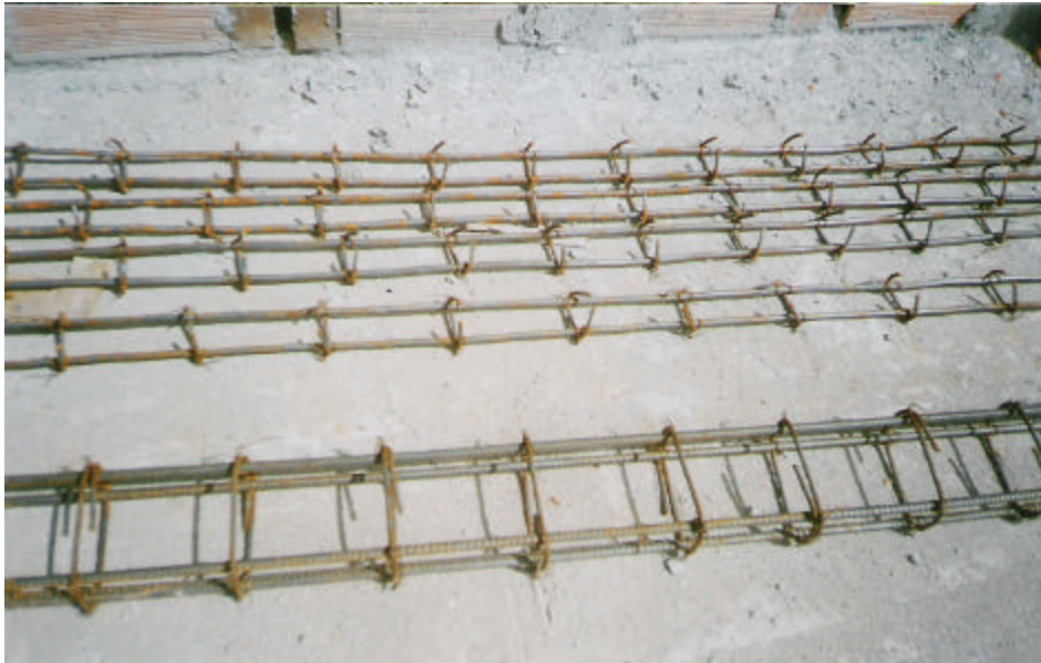
Figura 116. Castillos para viguetillas y columnetas
