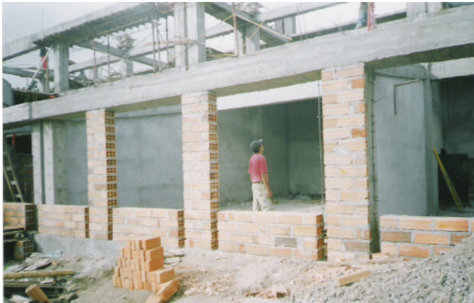
Figura 134. Muros de fachada y columnetas
