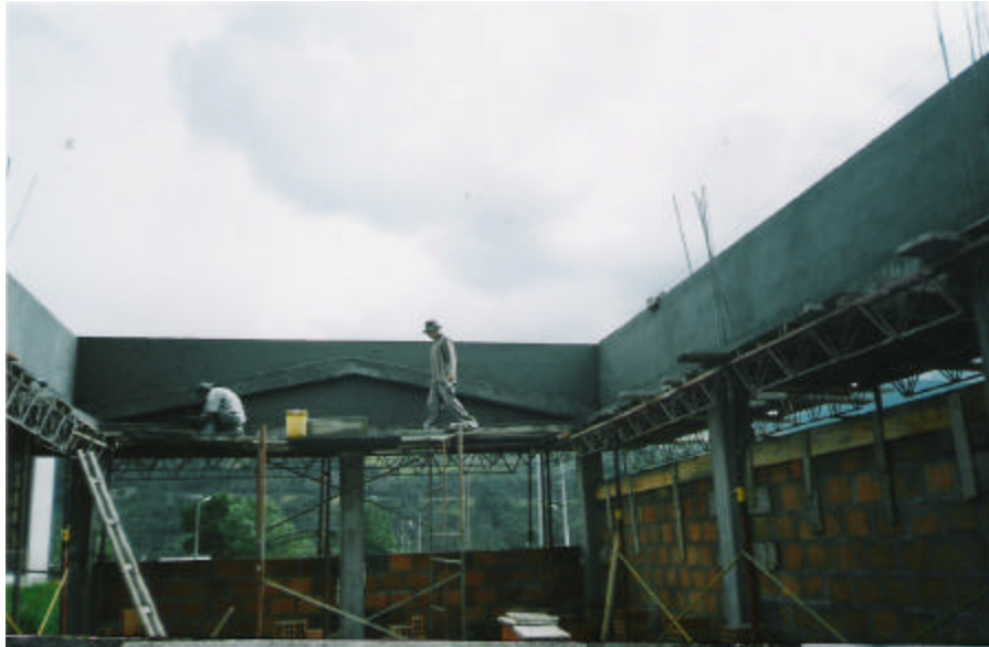
Figura 34. Repellado y afinado (interno)
