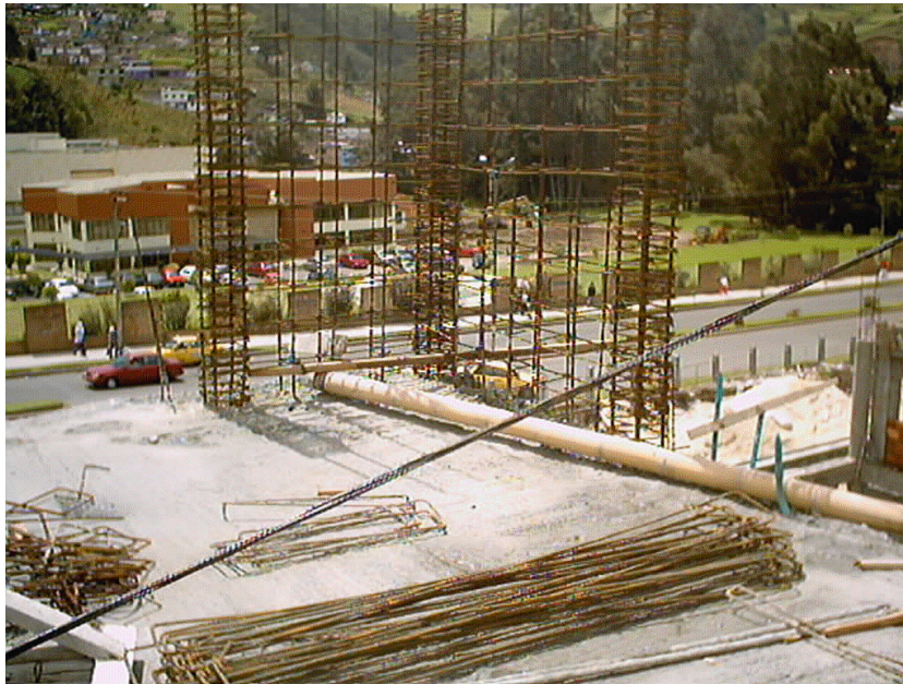
Figura 150. Castillos de pantalla doble
