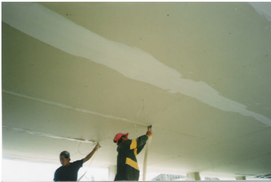
Figura 53. Sellado de juntas
