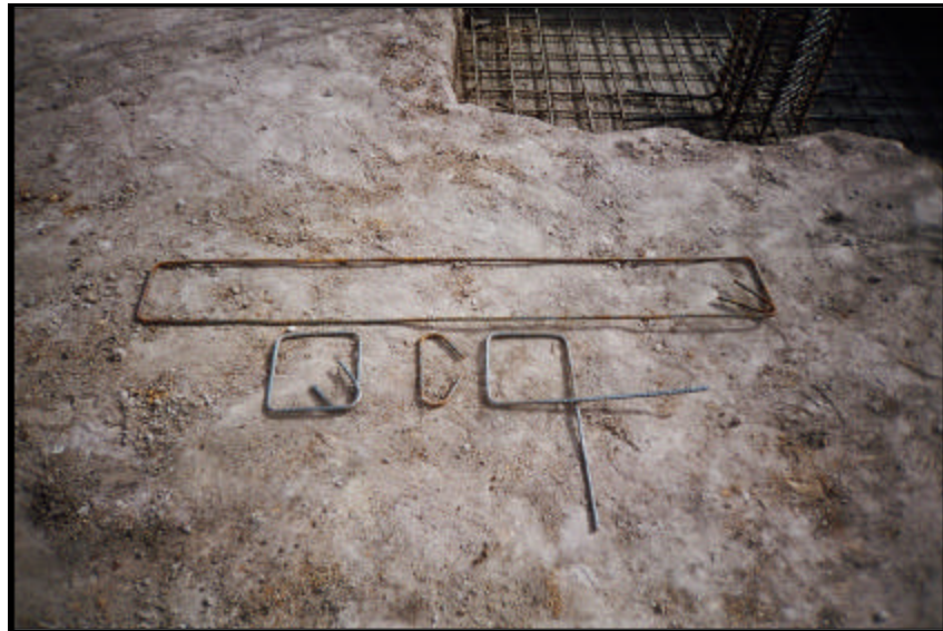
Figura 150. Castillos de pantalla doble
