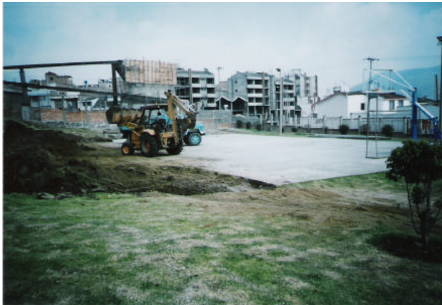
Figura 2. Retiro del material sobrante
