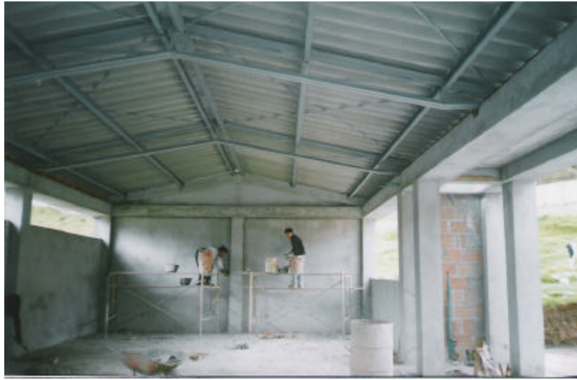
Figura 48. Aplicación de estuco
