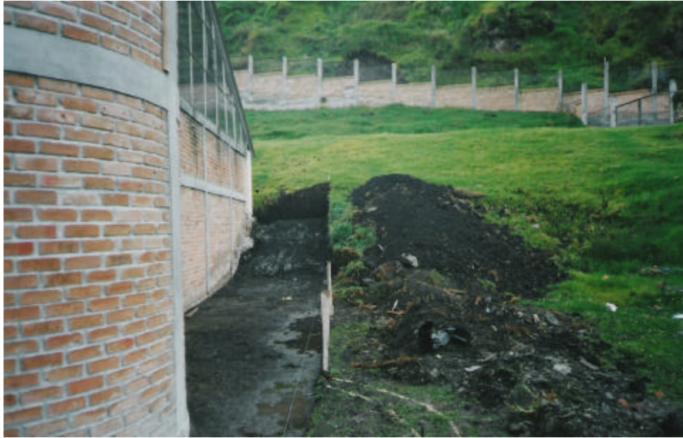
Figura 9. Suelo firme para la fundición
