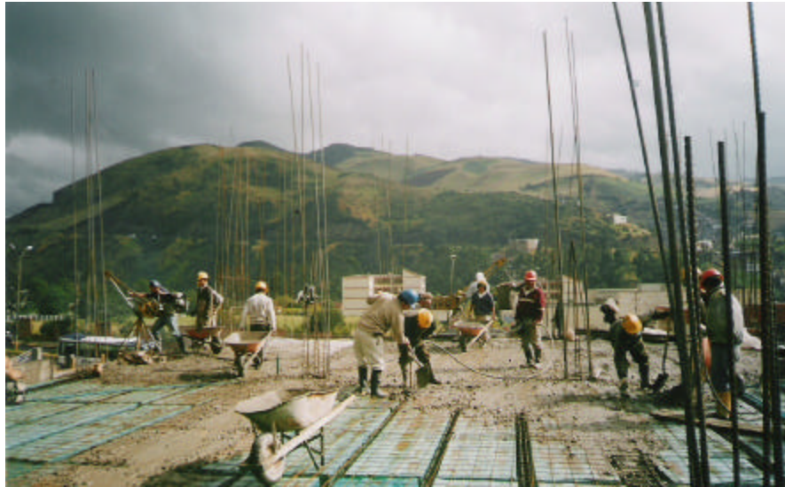
Figura 78. Vibrado del concreto
