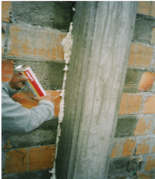
Figura 38. Aplicación de espuma de relleno
