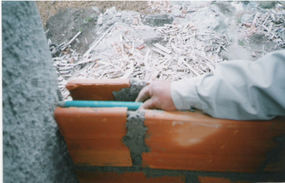
Figura 125. Colocación del tubo conduit
