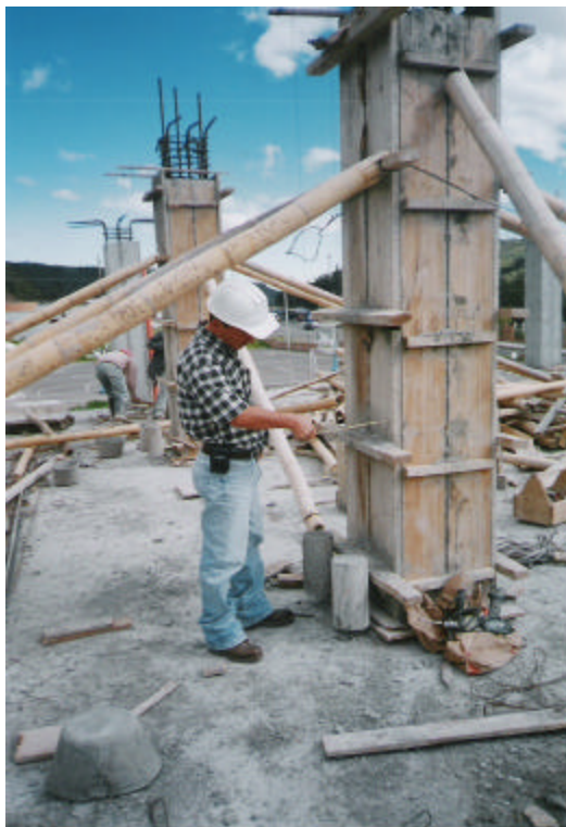
Figura 152. Chequeo del plomo de la formaleta
