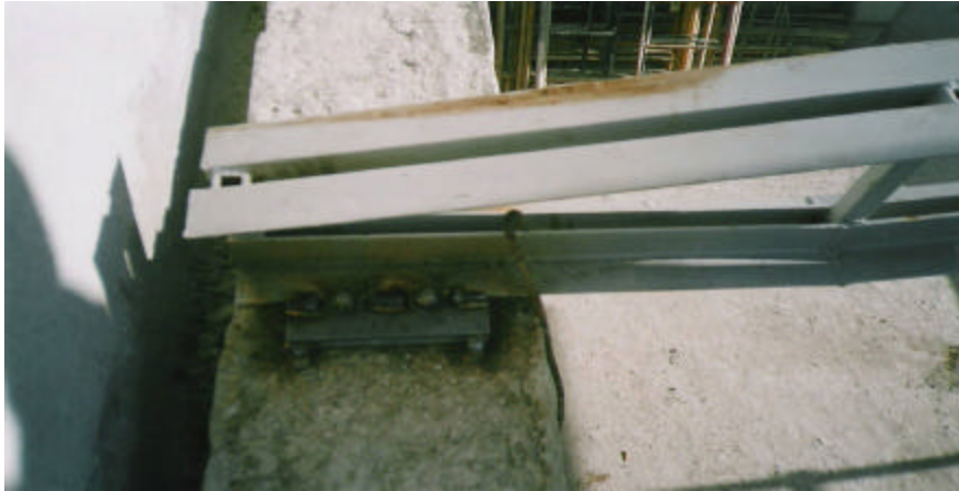
Figura 42. Detalle de apoyos de la cercha
