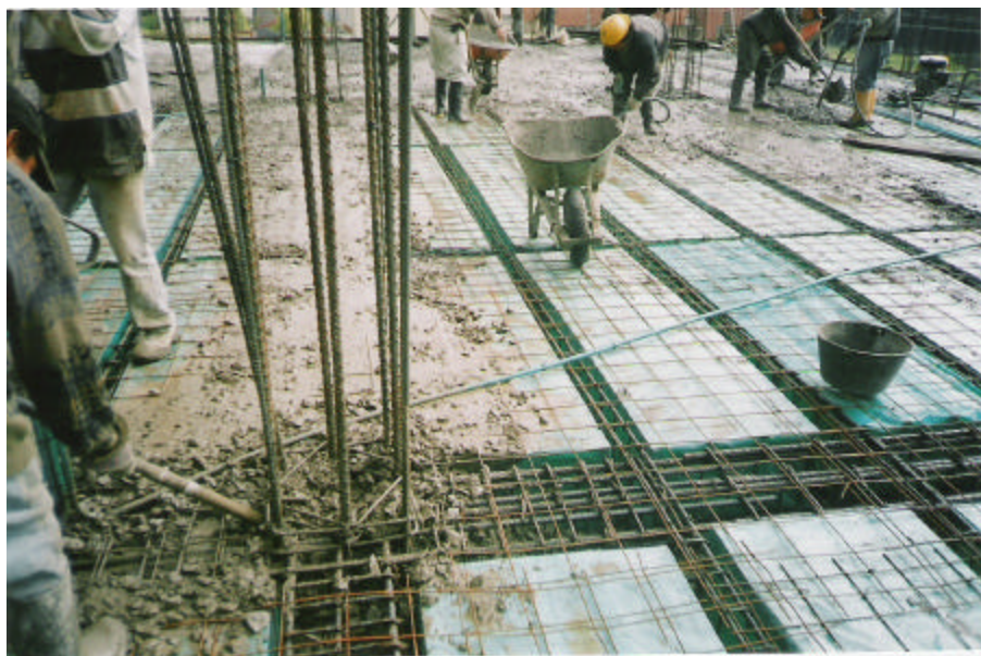
Figura 79. Vaciado y vibrado en los nodos
