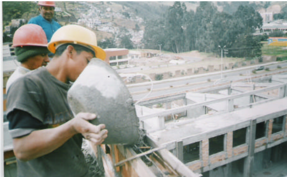
Figura 126. Vaciado de mezcla para viguetillas
