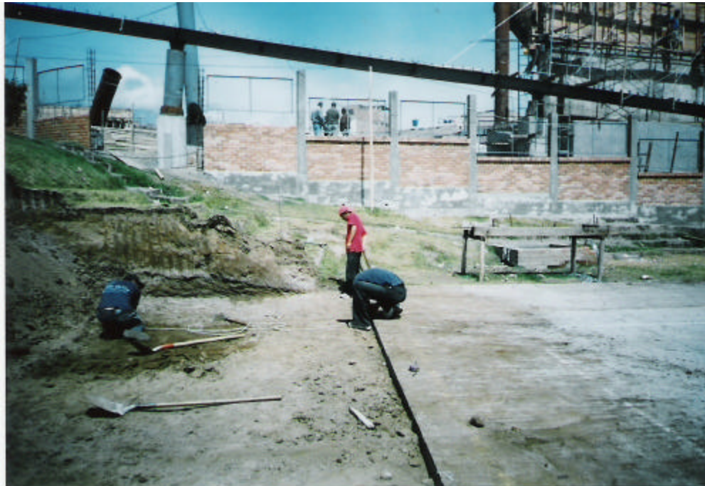
Figura 4. Nivelación de piso para construcción de losa maciza
