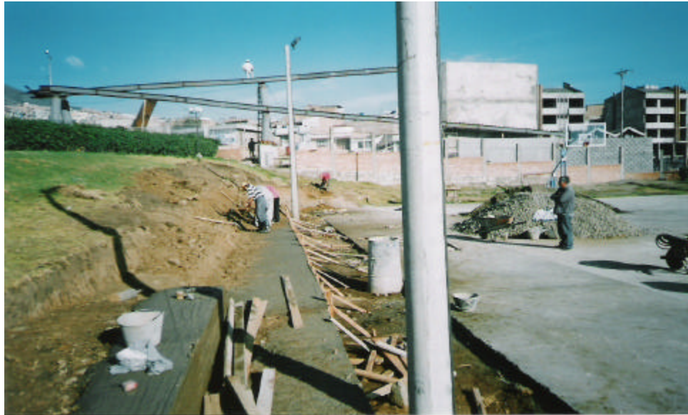
Figura 7. Fundición de escaleras
