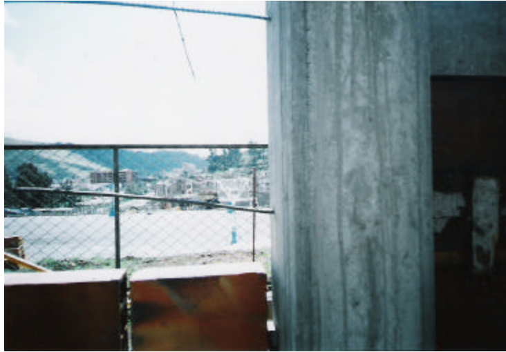
Figura 37. Construcción de Dados
