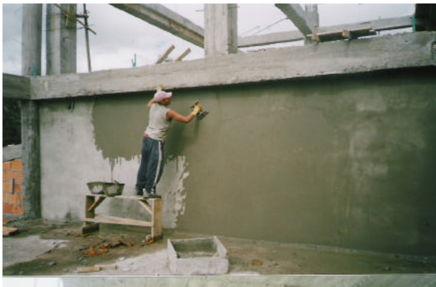
Figura 145. Afinado de muros
