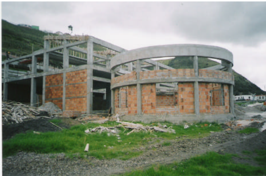
Figura 132. Vista lateral bloque 1 y cilindro
