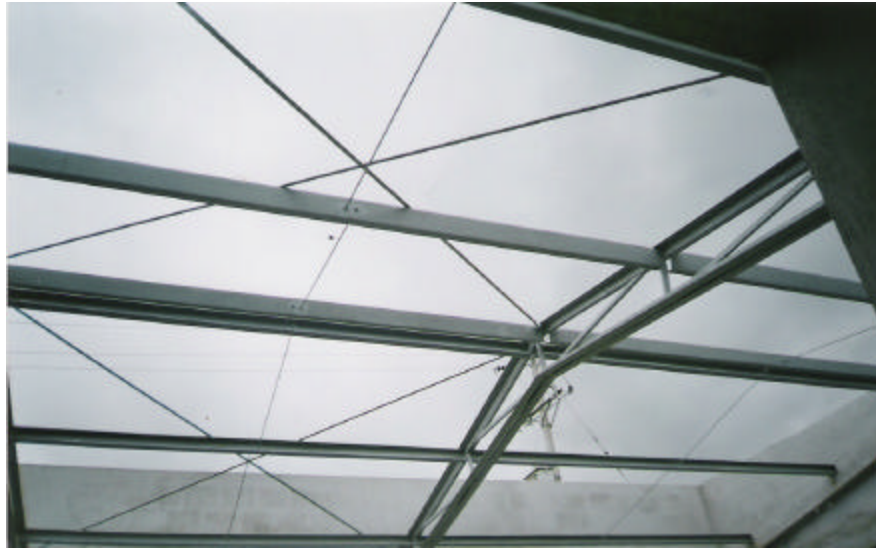
Figura 46. Instalación de tensores y arriostrillos
