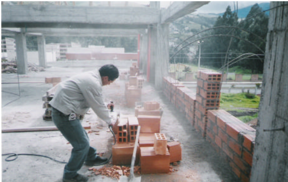
Figura 120. Corte del ladrillo farol
