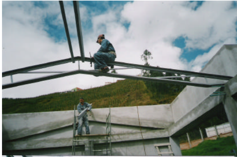
Figura 44. Instalación de vigas metálicas
