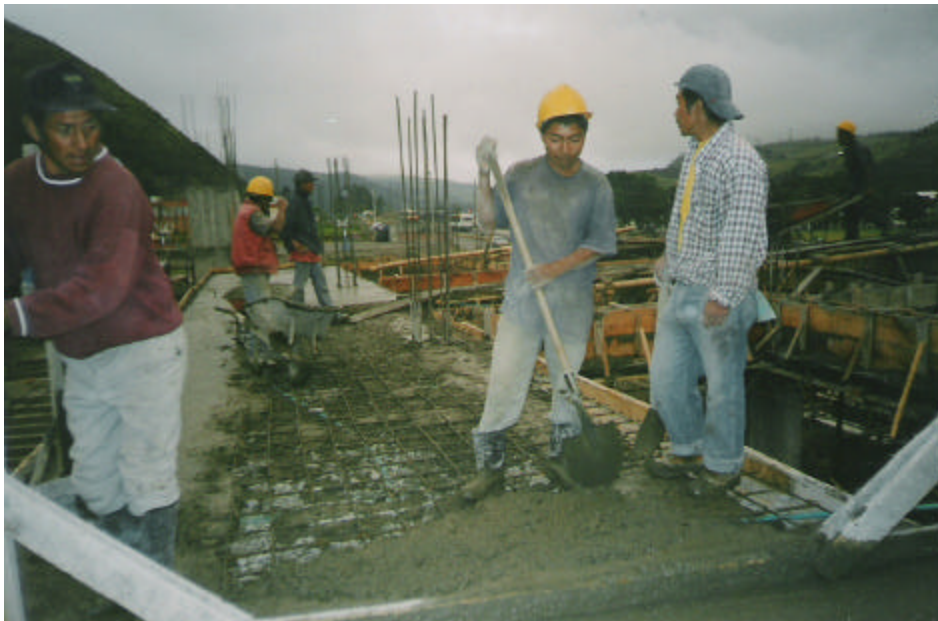
Figura 93. Vaciado de la mezcla
