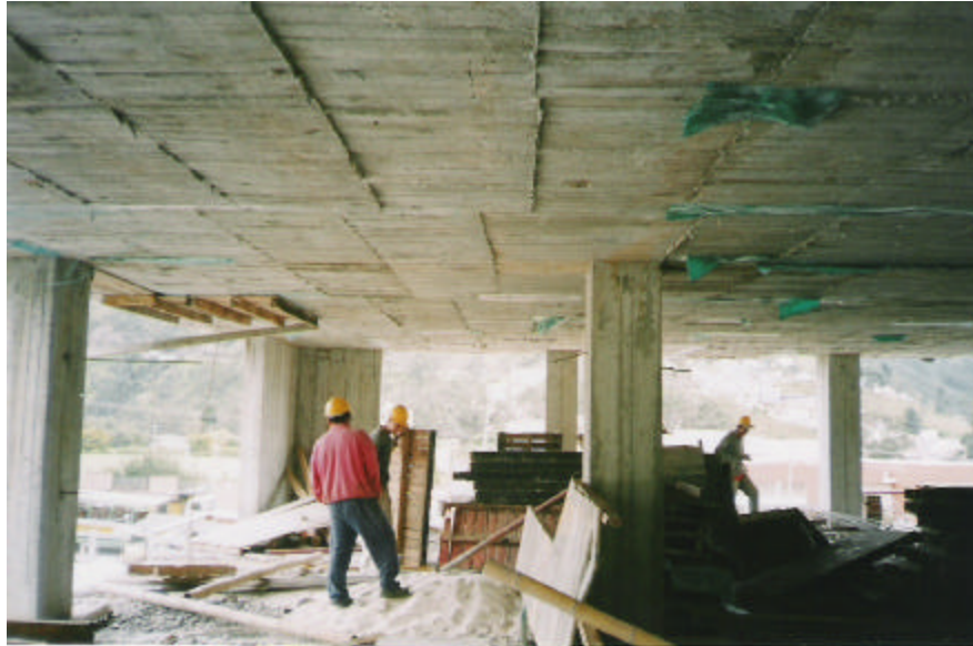
Figura 83. Retiro de la formaletería
