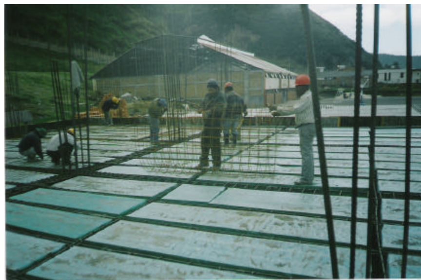
Figura 73. Instalación de la malla electro soldada
