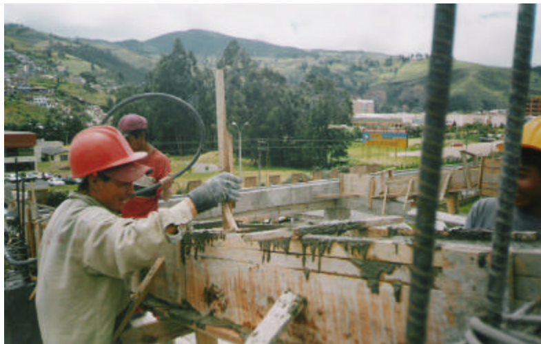
Figura 111. Mejoramiento de la superficie
