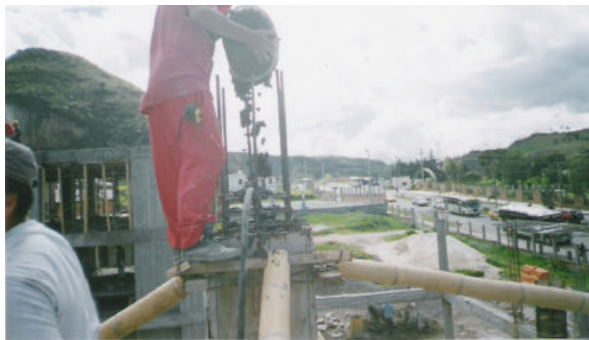
Figura 101. Vaciado y vibrado
