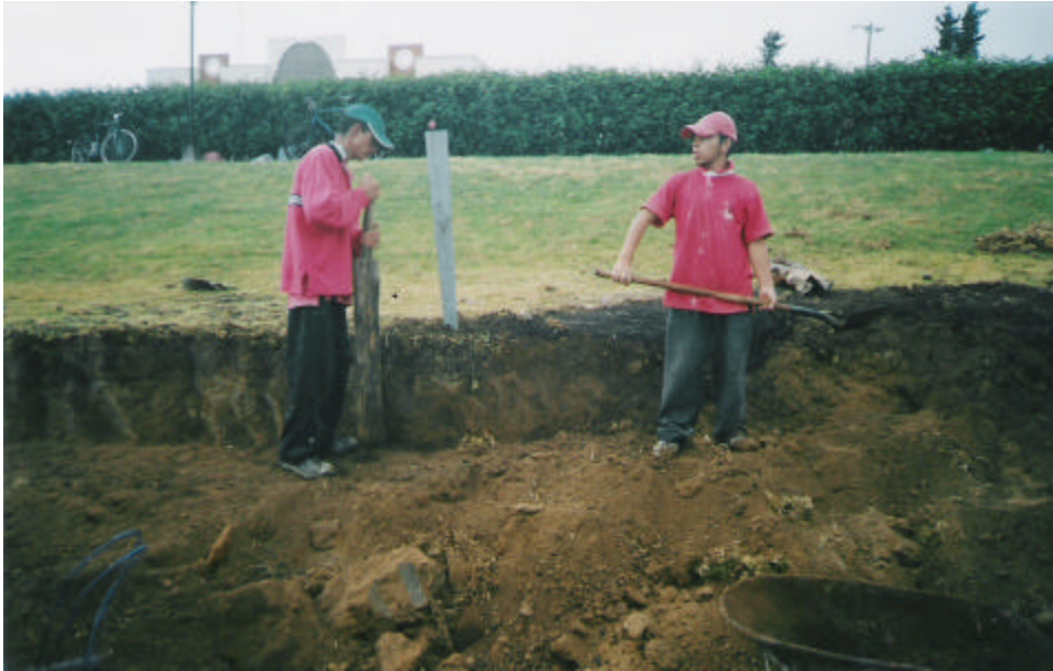
Figura 3. Nivelación y conformación de escalones manualmente
