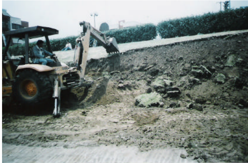
Figura 1. Excavación, conformación y desalojo del material excavado
