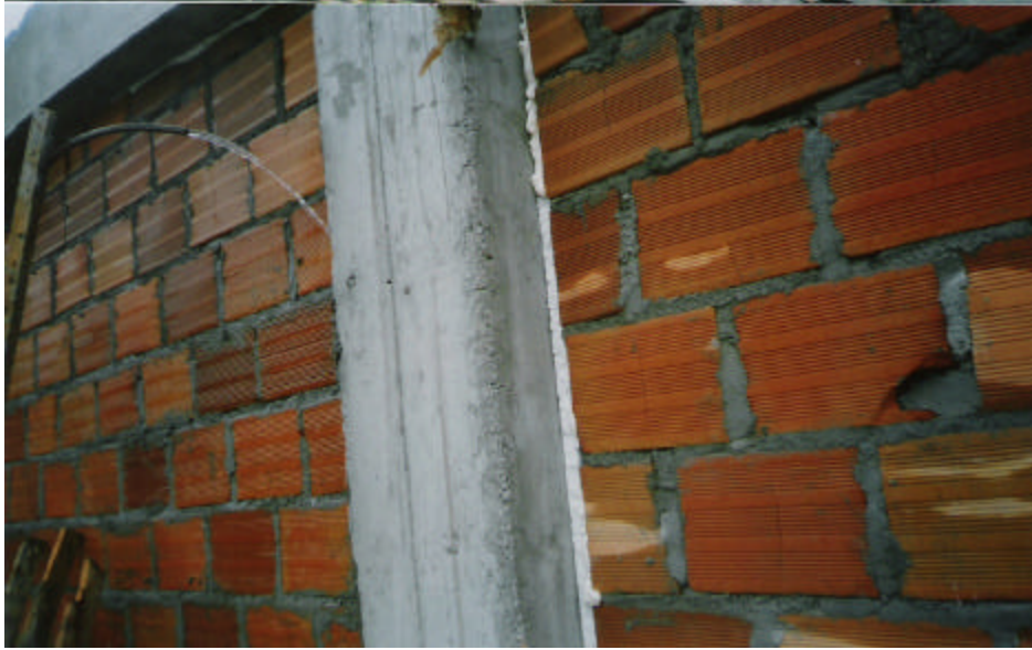
Figura 165. Repello de muros bloque 4 nivel 4
