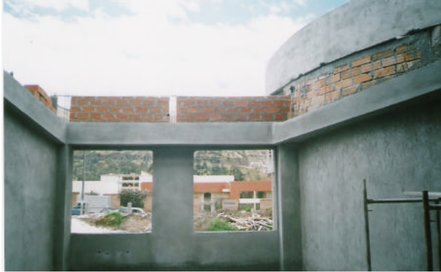
Figura 146. Muros afinados
