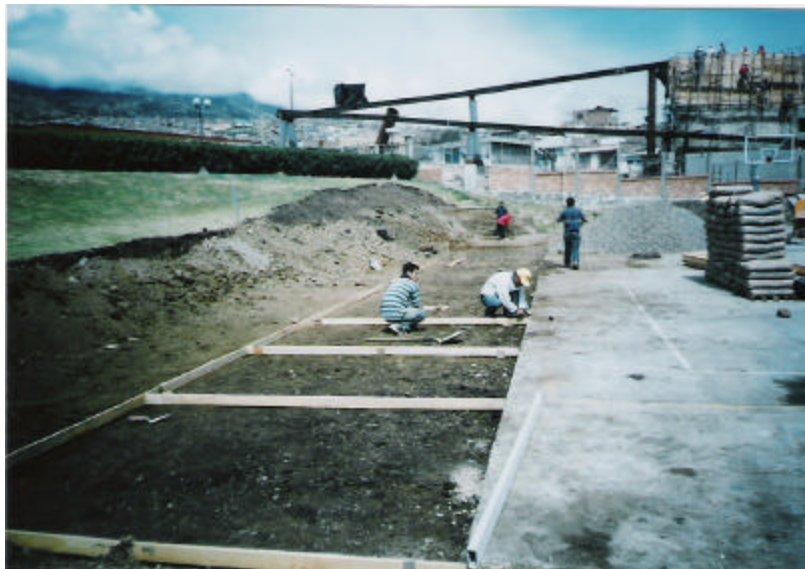
Figura 6. Construcción de juntas
