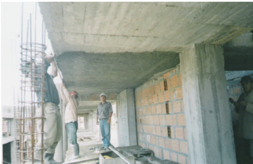
Figura 147. Repello de losas cielo raso
