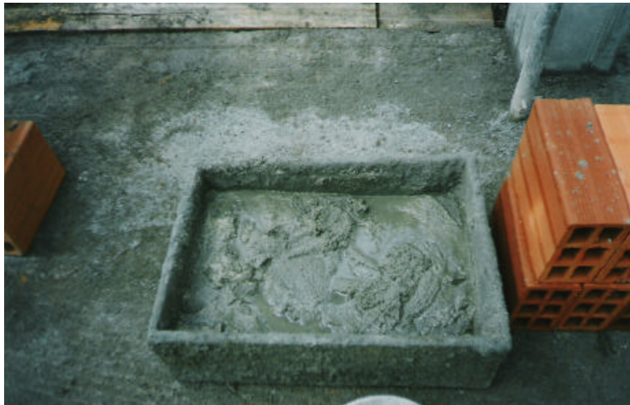
Figura 36. Plantillado de muros
