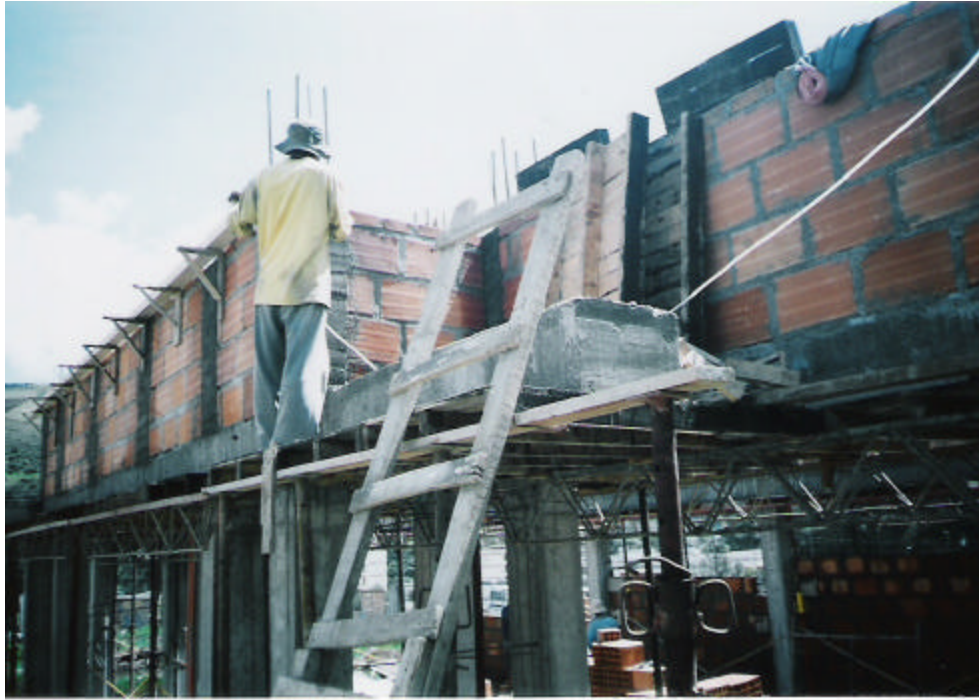
Figura 33. Repellado y afinado (externo)
