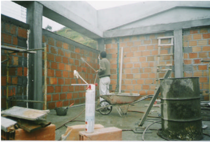
Figura 39. Repello de muros (internos y externos)
