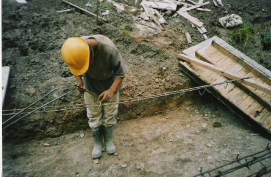
Figura 115. Figurado y armado del hierro
