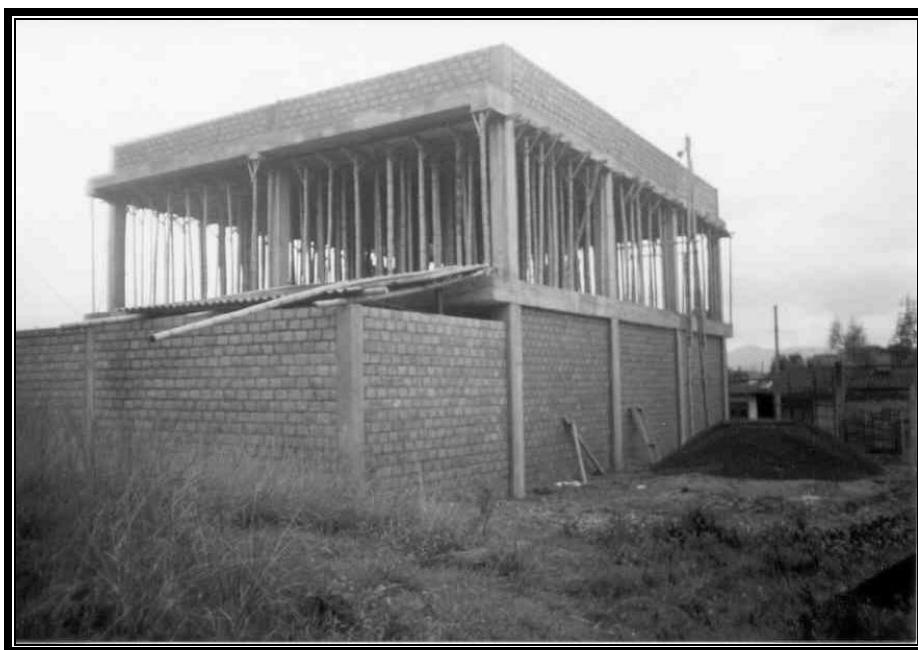
Figura 30. Avance de obra hasta 8 Octubre / 2003
