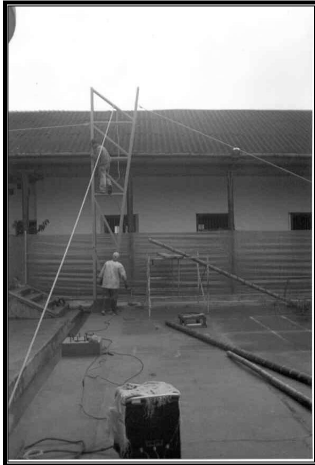
Figura 48. Izada y nivelada de columnas
