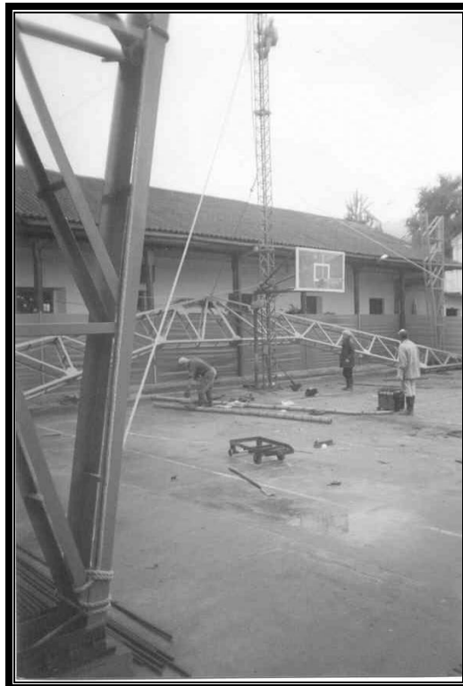
Figura 49. Levantamiento de cerchas por medio de una torre metálica
