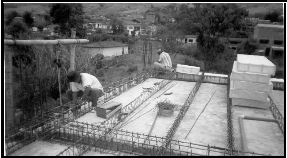
Figura 14. Refuerzo viga amarre losa 1er nivel
