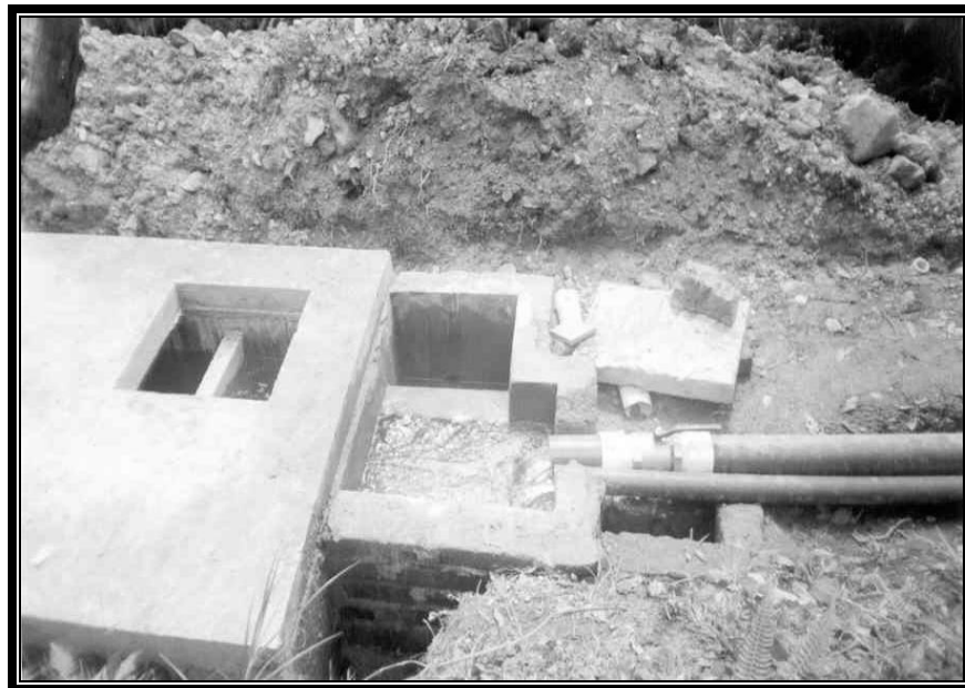
Figura 80. Puesta en funcionamiento entrada del agua a la cámara de rebose
