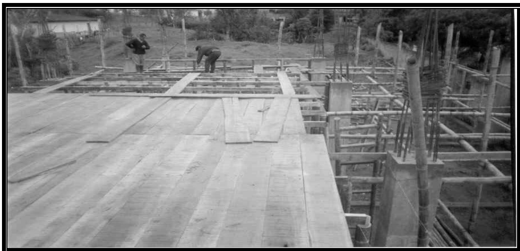
Figura 13. Encofrado losa 1er nivel
