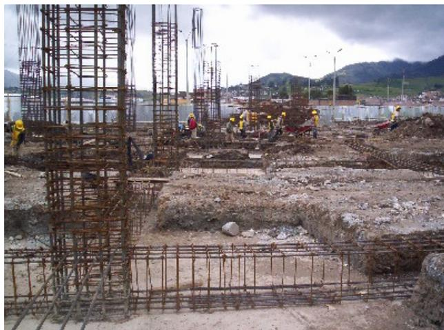
En el proceso de fundición se realizaron los cortes al tercio para posteriormente realizar su empalme en la siguiente fundición. Puente de adherencia utilizado Sikadur 32 Primer. (Ver figura 16)
