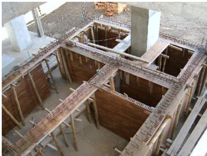
**Figura 50. Fundición de vigas de corona – zona de policía**
