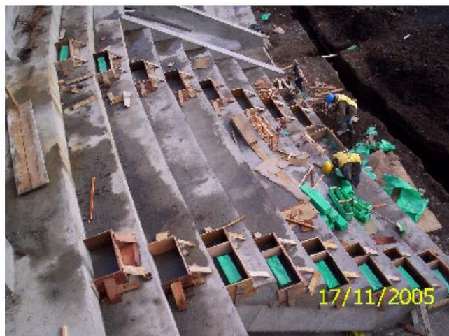
El proceso constructivo de estos elementos comprende la localización, fabricación e instalación de casetones aligerados, encofrado y fundición con concreto de 3000 psi. Es de anotar, que previa a la fundición, se verificó que la superficie de la huella donde se ubicará el peldaño intermedio quede limpia, picada y humedecida para garantizar una buena adherencia del concreto nuevo. (Ver figuras 41 y 42)
