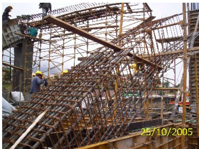
**Figura 25. Encofrado de vigas inclinadas y superiores.**
