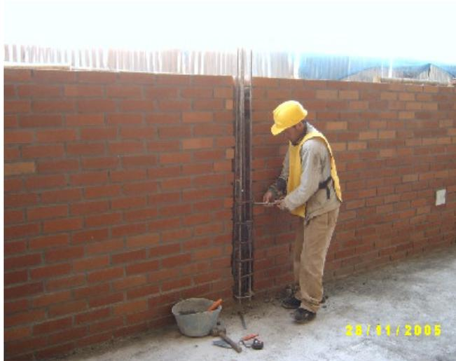
**2.6.2 Muro de cerramiento interno.** Esta actividad comprende la localización, excavación, armado de aceros y fundición de las zapatas, vigas de cimentación y columnetas, después se procede a la construcción del muro de cerramiento con ladrillo visto a dos caras y la instalación de la malla existente. (Ver figuras 39 y 40)
