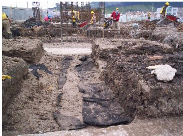
Actividad que comprende el armado del acero de refuerzo y colocación de cajones y testeros para conformar la viga T y la fundida de concreto mezclado en obra. (Ver figura 18)
