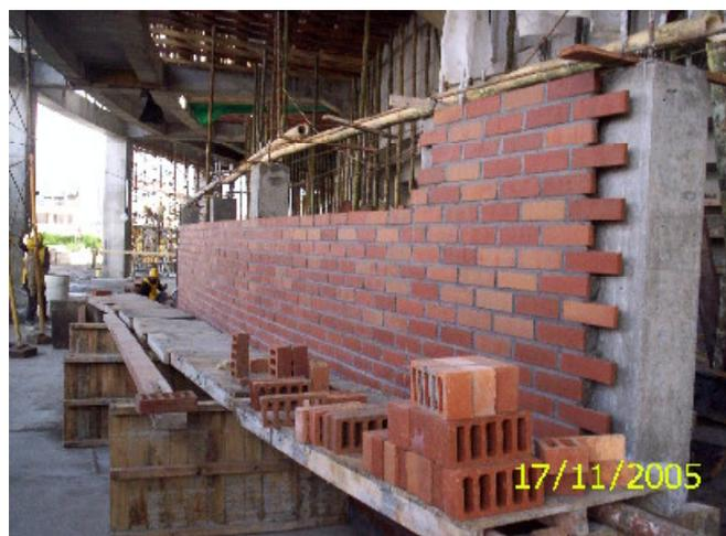
Antes de la colocación del ladrillo, este debe estar limpio, sin rajaduras y saturado; la dosificación en volumen del mortero de pega utilizado es de 1:3, finalmente, la parte superior donde se coloca el mortero de pega de la primera hilada se limpia, pica y humedece. (Ver figura 38)
