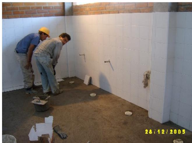
La colocación del enchape de pisos y muros se realizó mediante la aplicación de un mortero de base sobre el cuál se estampillan los enchapes con pasta de cemento puro rematando con el emboquillado final.
