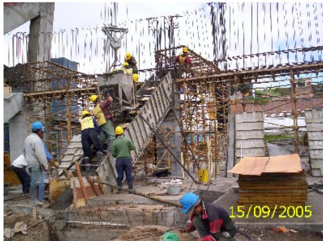
**2.4.3 Vigas intermedias 0,50\*0,60 m. y 0,60\*0,70 m. entre ejes 1 y 21.** Esta actividad comprende la localización con puntos de topografía, amarre del acero de refuerzo, encofrado y fundida de las vigas intermedias a N + 4,35 m. y N + 6,29 m.
