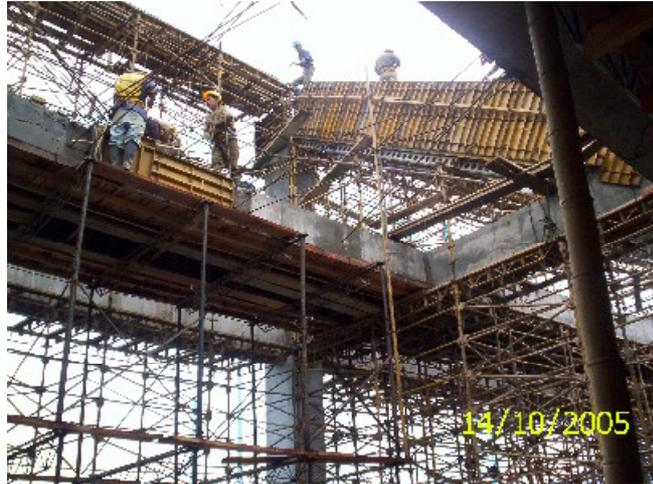
**2.4.6 Graderías entre los ejes 1 y 21.** Esta actividad comprende la localización, el armado de formaleta de fondo, armado de aceros de huellas y contrahuellas, colocación de formaleta superior y fundición. Cuando se utilizaba formaleta de madera, esta se forraba con una tela sintética para procurar un mejor acabado en los fondos de la gradería que van a ser visibles. (Ver figuras 30, 31 y 32)
