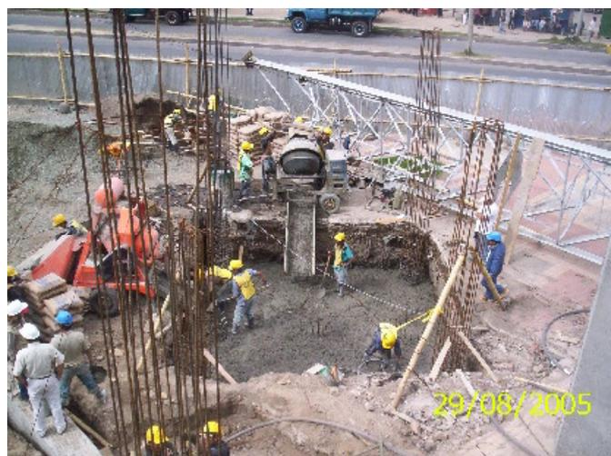
**Figura 14. Fundición de zapatas en el bloque 2**
