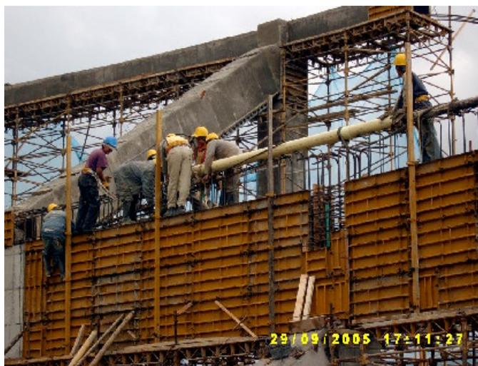
**2.4.5 Vigas superiores N +12,14 m.** Esta actividad comprende la localización con puntos de topografía sobre el eje **A**, amarre del acero de refuerzo, encofrado y fundida de las vigas. Estas vigas poseen una sección de 0.60 \*0.70 m. (Ver figura 29)
