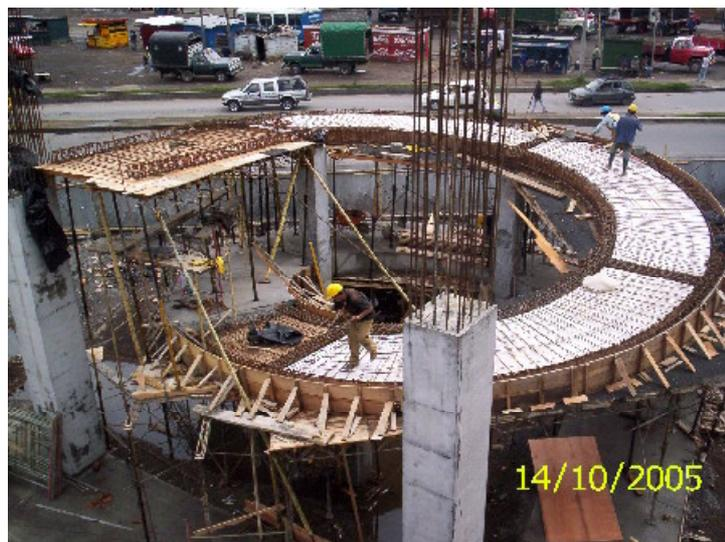
**2.5.3 Pórtico puerta principal.** En la Tribuna Norte se construyeron seis puertas principales de acceso (dos por cada bloque), y el pórtico se encuentra estructurado de la siguiente forma: Dos columnas de sección 0,25\*0,25 m. y una altura de 2,70 m. que están cimentadas sobre zapatas de 0,80\*0,80\* 0,40 m. y una viga superior de base 0,25 m. y altura 0,40 m. que llega al N + 3,10 m. (Ver figura 36)
