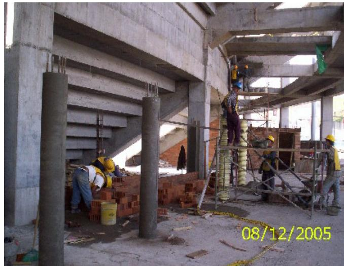
**2.9.2 Construcción de vigas de corona.** La actividad comprende la localización según lo indiquen los planos, armado de acero de refuerzo, limpieza de los hierros, colocación de la formaleta y fundida de las columnas con concreto mezclado en obra. (Ver figura 49)
