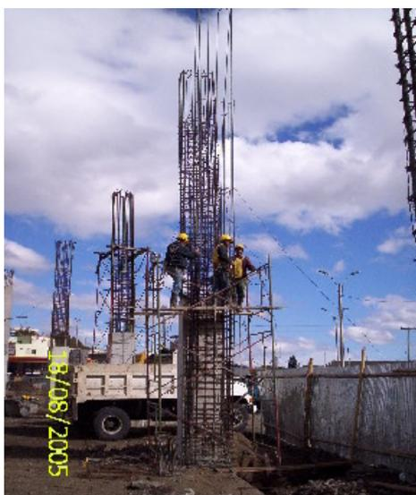
Para la mezcla del concreto de columnas se solicitó utilizar un agregado más fino que el de 1/2. Adicionalmente, el Constructor utilizó un aditivo reductor de agua de Toxement (Eucon 37) para tener mayor manejabilidad y facilidad en la colocación del concreto.
