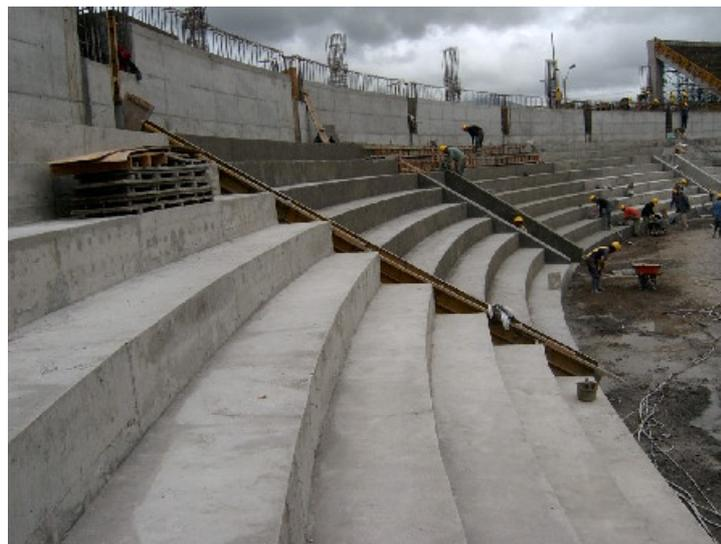
**2.4.7 Vigas inclinadas de vomitorios y viga de 0,40\*0,70 m. parte superior.** Esta actividad corresponde a la construcción de las vigas inclinadas de los vomitorios de 0,30\*0,60 m. y a la viga superior de cada vomitorio de 0,40\*0,70 m. que recibe la carga de las vigas inclinadas. Esta se realizaba paralelamente a la
