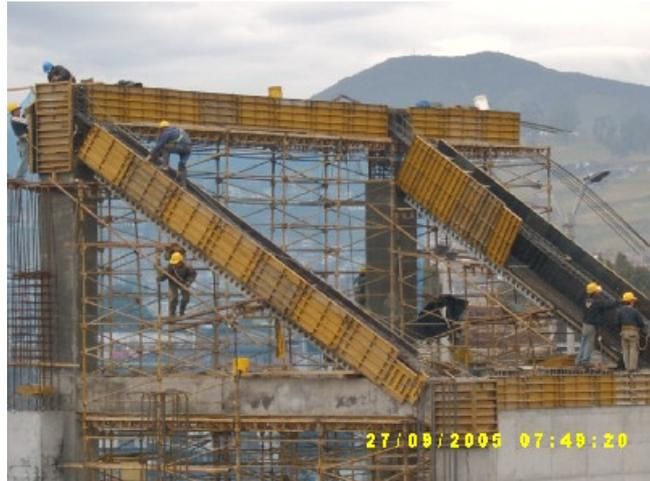
En la fundición de las vigas se utilizó concreto de 3.000 psi mezclado en obra con acelerante de Toxement (Acceguard 25). Lo anterior; con el fin de disminuir los tiempos de desencofrado de la formaleta y optimizar su uso.
