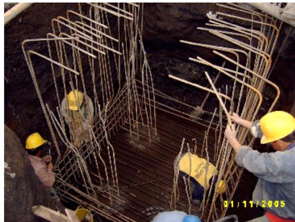
**Figura 45. Vista parcial de zapata mástil N-O.**
