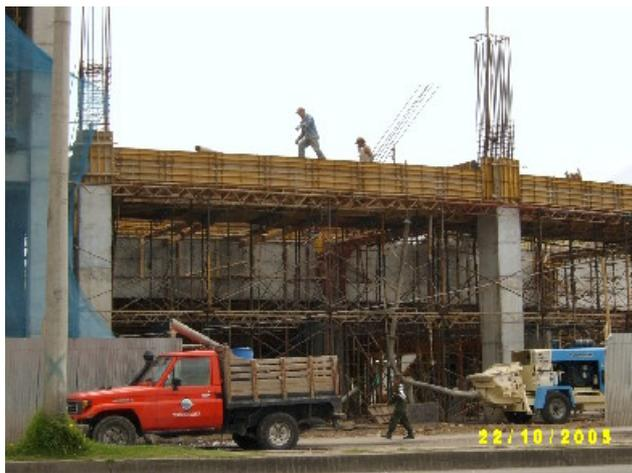
**2.4.4 Pantalla a N + 4,35 m.** Estas pantallas poseen una altura de 1,34 m.\* 0,4 m. de ancho; y se construyen después de la fundición de las vigas del eje B en el N + 4,35 m. Esta actividad comprende la localización con puntos de topografía, armado del acero de refuerzo, encofrado y fundida con concreto de 3000 psi.
