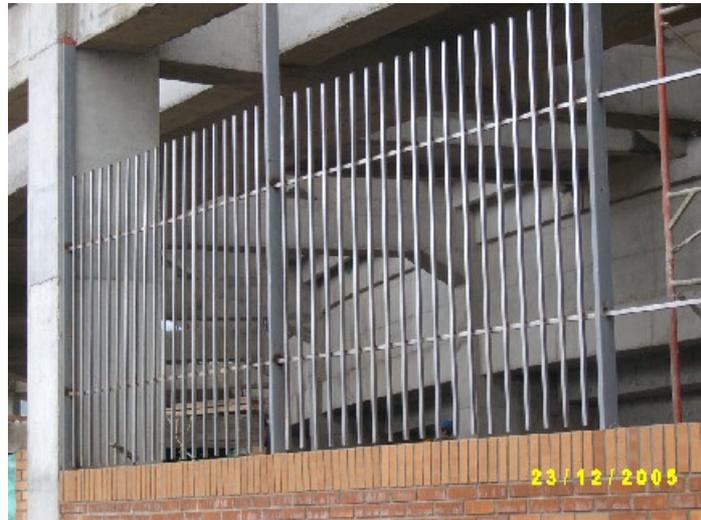
**Figura 56. Instalación de ventanas metálicas- zona de baños**
