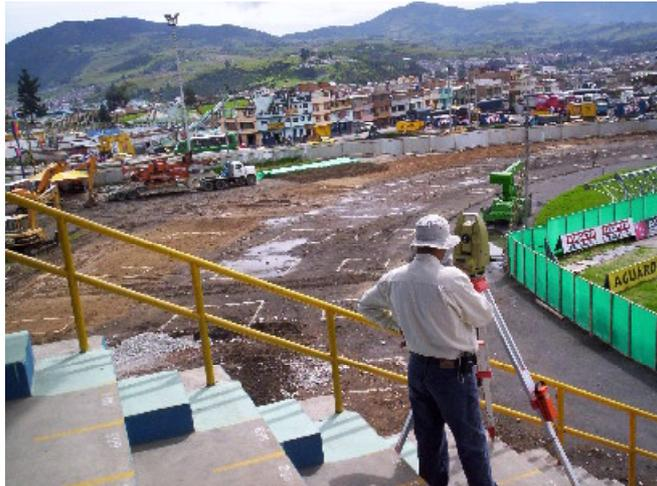
Descapote y excavaciones menores: Se realizó en las áreas aledañas a las obras, considerando un sobrecorte de 1 m. aproximadamente. Paralelamente, se iba efectuando el cargue y retiro del material sobrante. (Ver figura 7)
