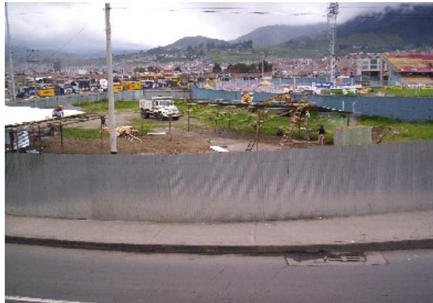
Construcción de cerramiento provisional externo en teja de zinc y construcción de cerramiento provisional interno en lona: Comprende la demarcación tanto externa como interna de las áreas de trabajo. (Ver figura 3)
