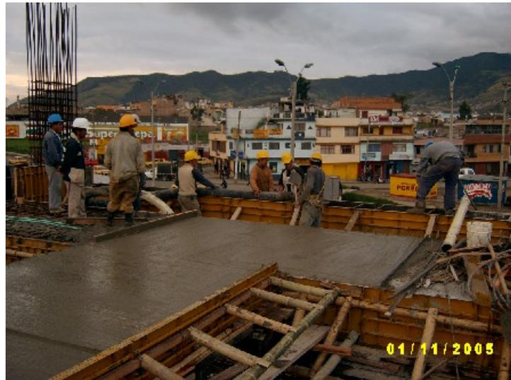
**Figura 35. Armado de formaleta y aceros en rampas.**
