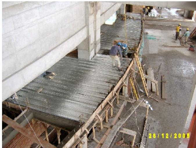
El proceso constructivo de esta actividad que aplica para las zonas de administración, ventas de alimentos y policía; comprende la colocación de la lámina de metaldeck y del acero de refuerzo (malla electrosoldada); enseguida se verifica que toda la plataforma esté completa, adecuadamente sujeta y con el soporte necesario en todos los bordes para proceder con el vaciado del concreto
