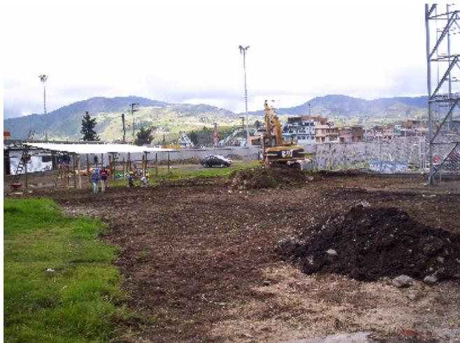
Desmante de torres de iluminación: Se realizó el desmante de las dos torres ubicadas en el costado Nor - Oriental y Nor - Occidental, con el uso de una grúa PH de 20 Ton. y el equipo de oxicorte. (Ver figura 8)
