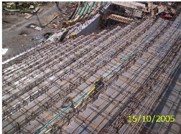
**Figura 31. Armado de formaleta de madera para la gradería de la primera bandeja del bloque 3.**
