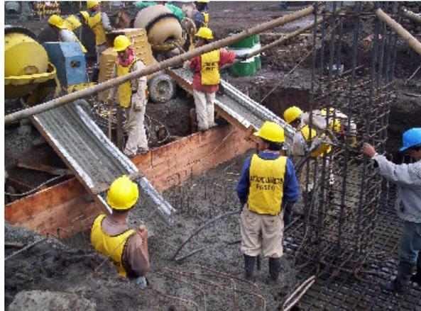
**2.1.4 Vigas de cimentación 0, 50\* 0, 60 m.** La construcción de las vigas de cimentación comprende la localización, y fundición de un concreto de solado para protección del acero de refuerzo, luego se procede al armado de aceros correspondiente al refuerzo principal, a los estribos y a los arranques que se deben dejar embebidos en la viga de acuerdo a los planos estructurales, encofrado y fundición con concreto de 3000 psi mezclado en obra. (Ver figura 15)
