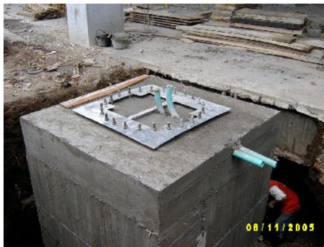
**2.8.2 Instalación de mástiles.** Esta actividad comprende el suministro, localización e instalación de los 2 mástiles tipo Roy Alpha (h =35 m.) en los cuales se acondicionarán los 40 reflectores desmontados de las anteriores torres
