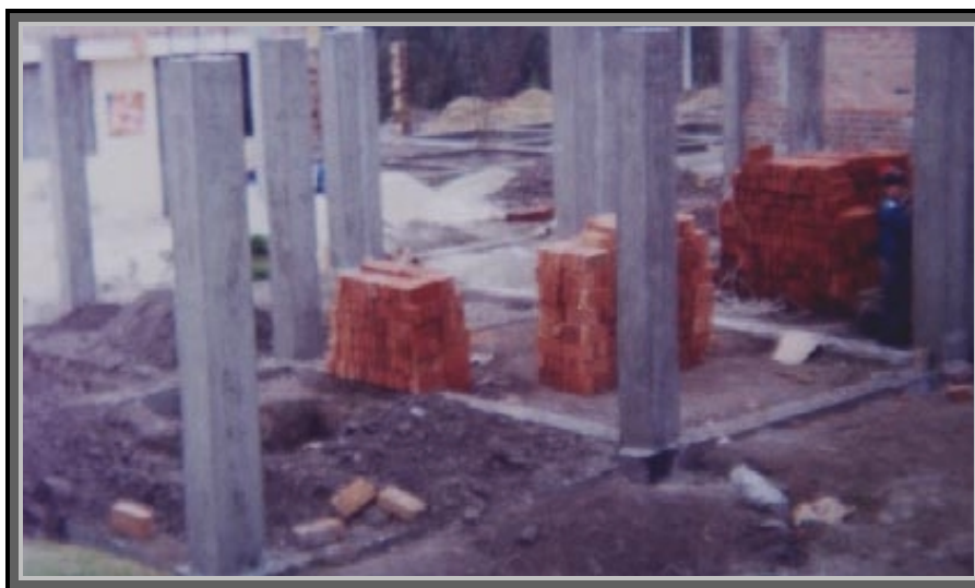
Figura 52. Remoción de encofrados
