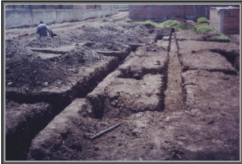
Figura 10. Material común de excavaciones de cimientos
