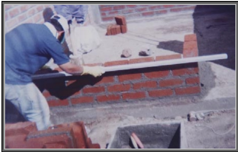
Figura 58. Nivelación de muros
