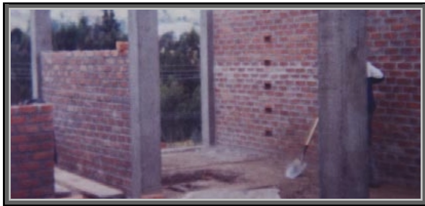
Figura 59. Muros medianeros y internos
