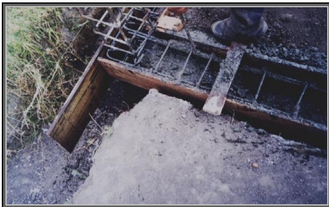
Figura 35. Colocación del concreto
