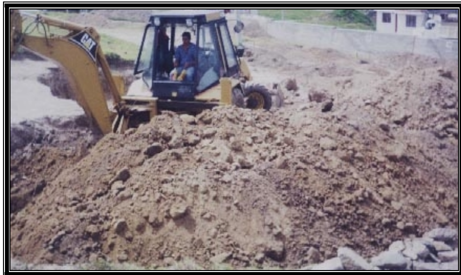
Figura 4. Desmonte con maquinaria pesada
