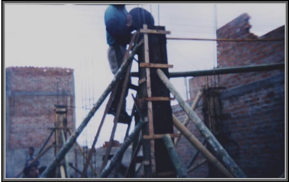
Figura 50. Colocación del concreto
