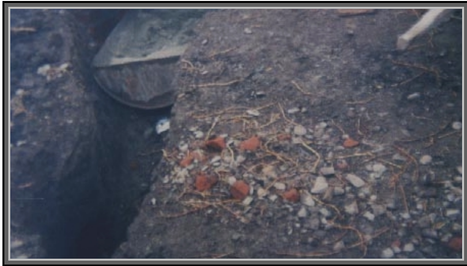
Figura 60. Excavación de zanja para alcantarillado
