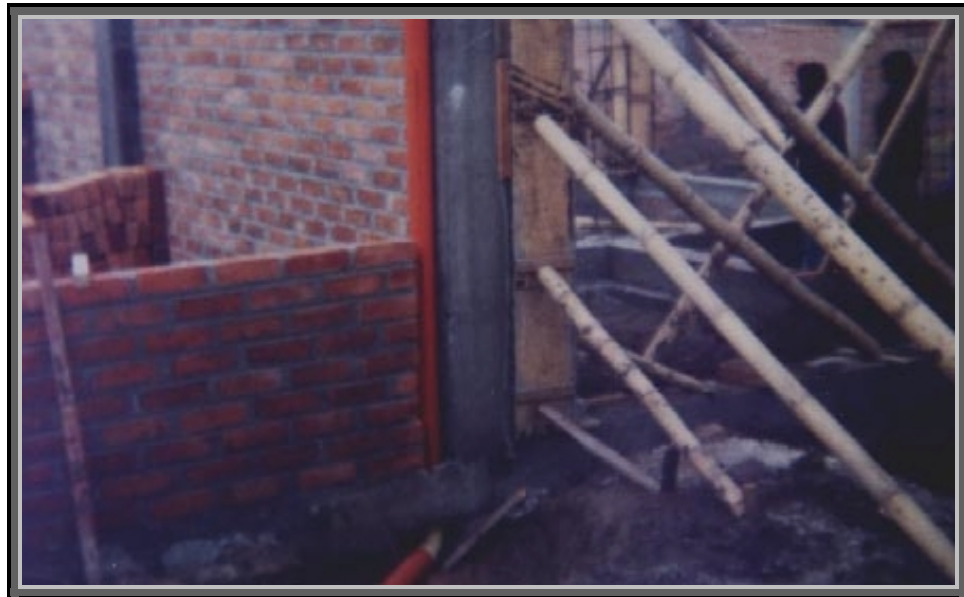
Figura 66. Instalación de bajante para aguas negras
