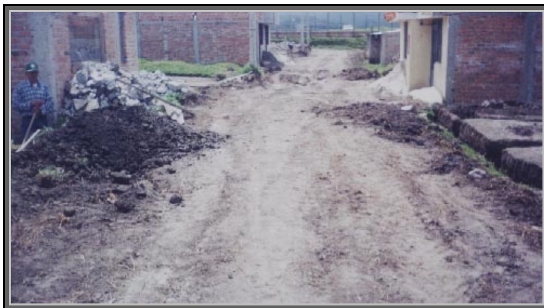
Figura 5. Limpieza de vías de acceso
