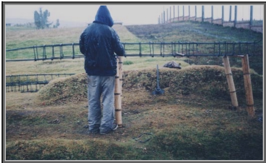
Figura 43. Hincado de columnas desde cimientos
