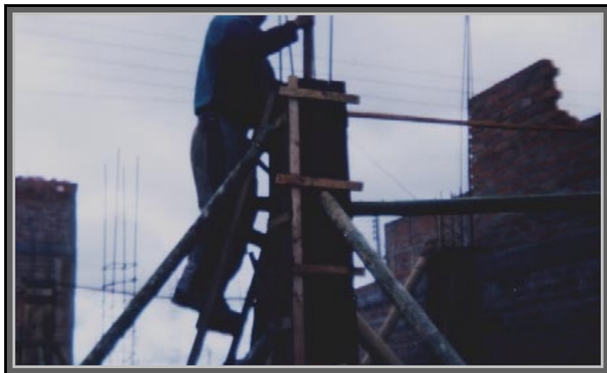
Figura 51. Vibrado de concreto
