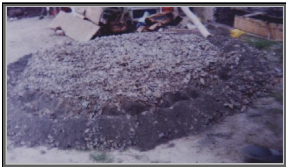
Figura 49. Mezcla para concreto
