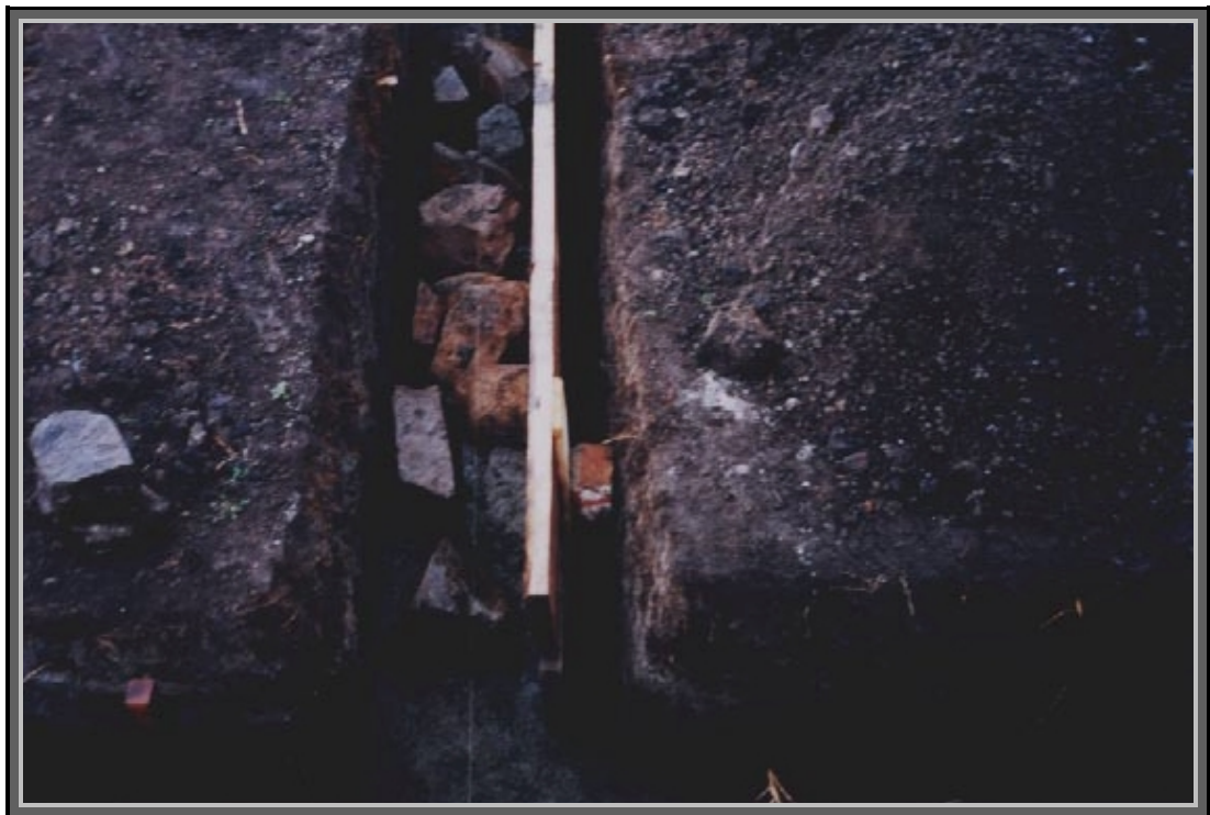
Figura 12. Colocación de rajón
