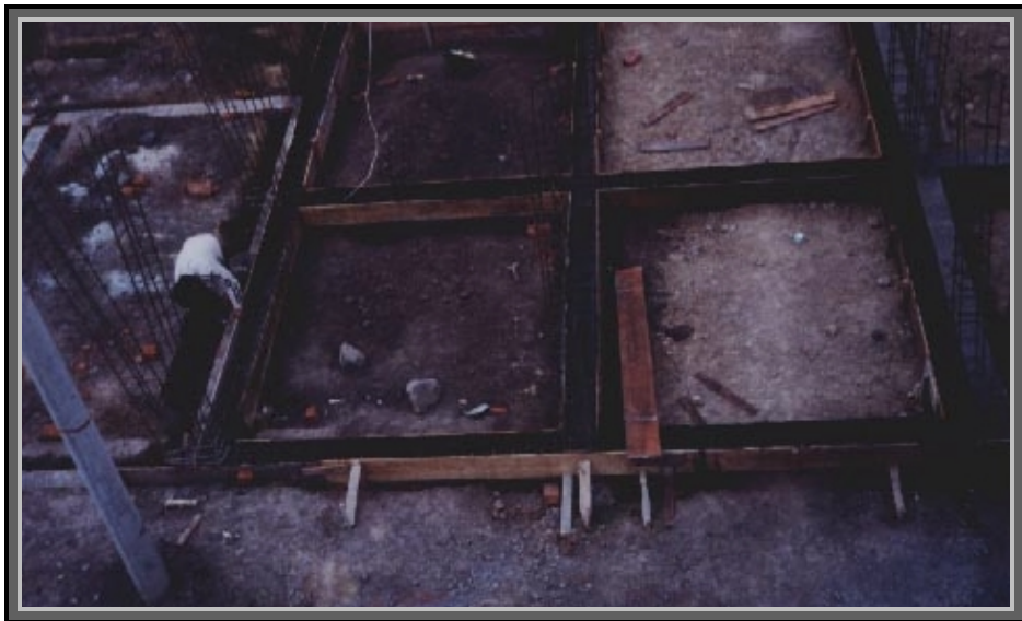
Figura 32. Encofrado para vigas
