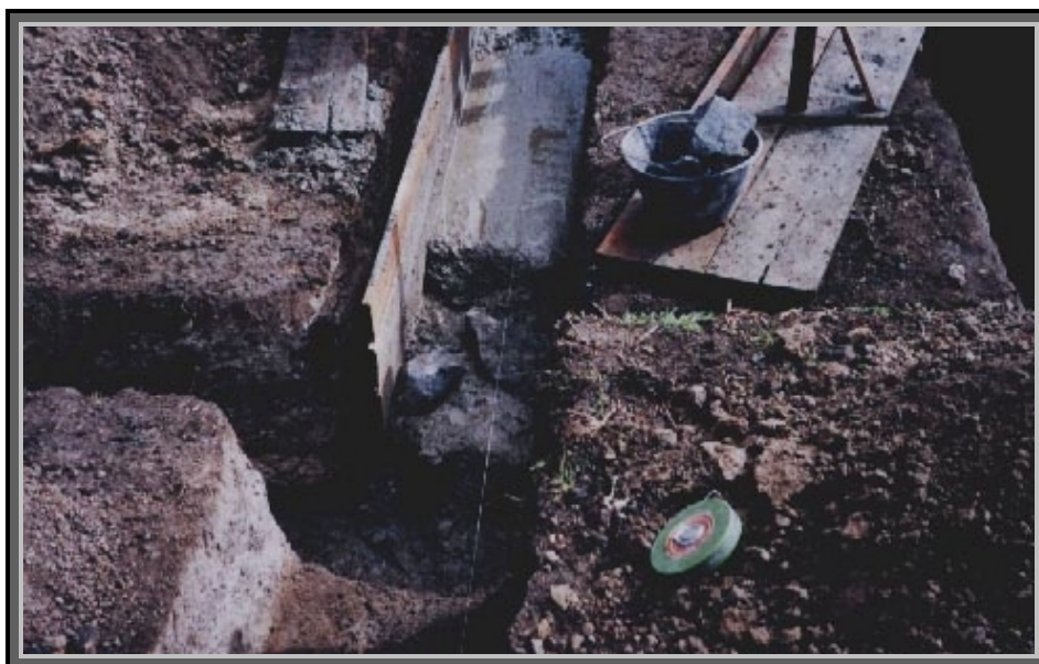
Figura 14. Fundición de ciclópeo
