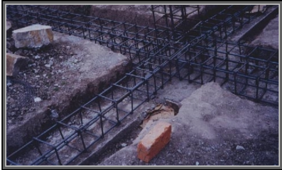
Figura 31. Intersección entre vigas
