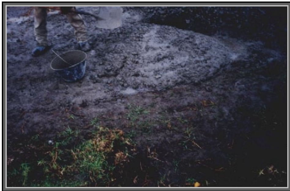
Figura 13. Mezcla para concreto ciclópeo
