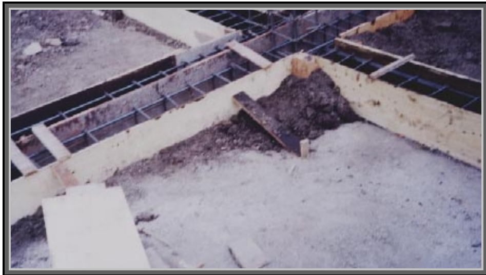
Figura 33. Detalle de encofrados
