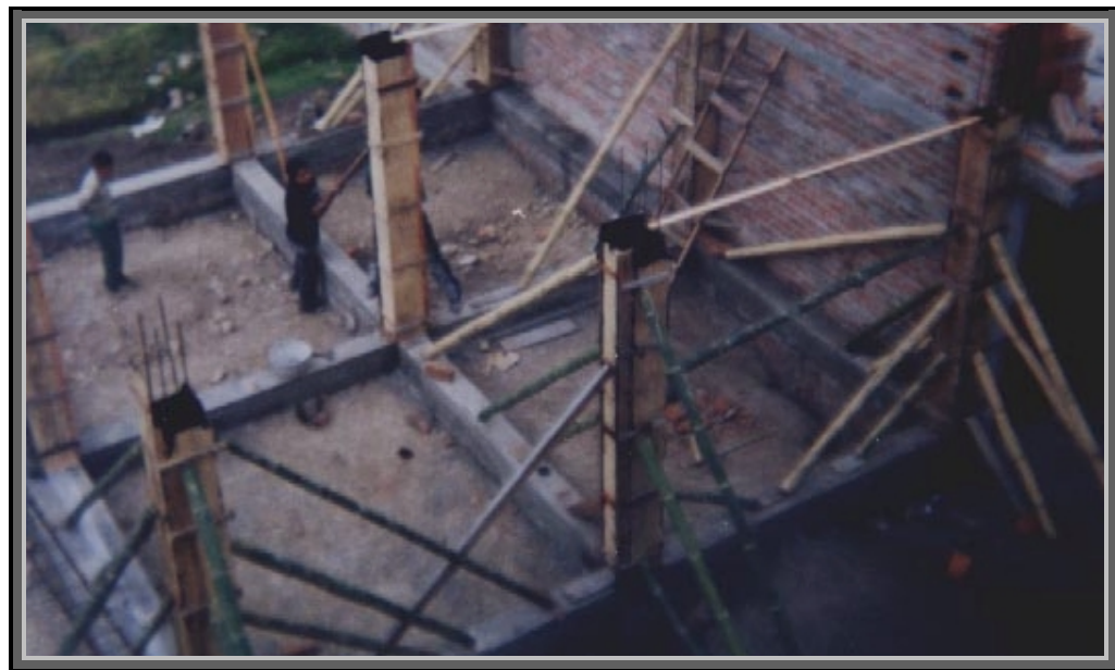
Figura 48. Formaletas para columnas
