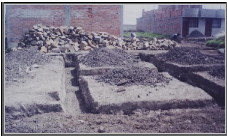
Figura 11. Desalojo de material excavado
