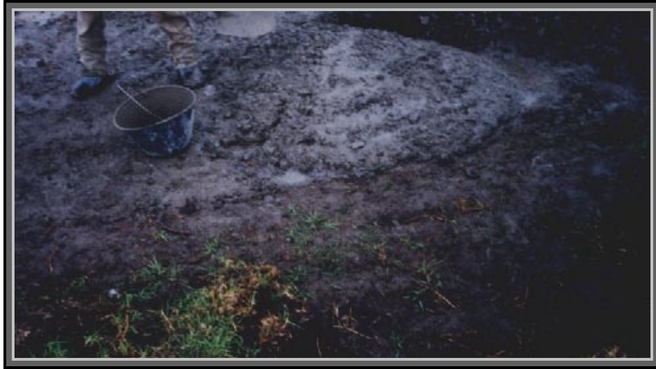
Figura 34. Mezcla para vigas de cimentación
