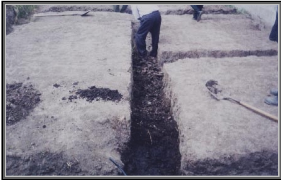
Figura 9. Excavación de cimientos
