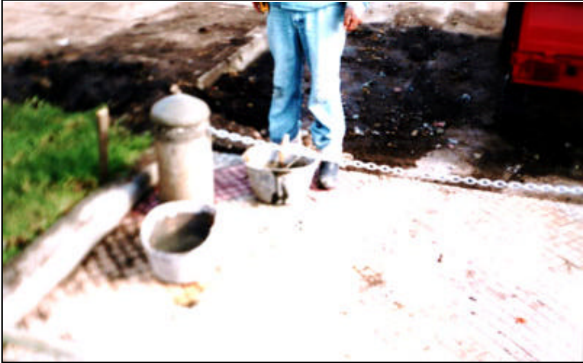
Figura 57. Colocación de formaleta para fundir placa
