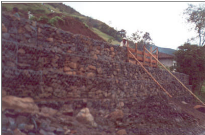
Figura 36. Muro de 4m de Altura
