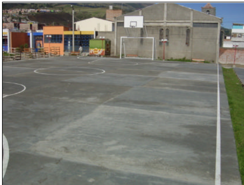
Figura 59. Placa cancha de voleibol terminada
