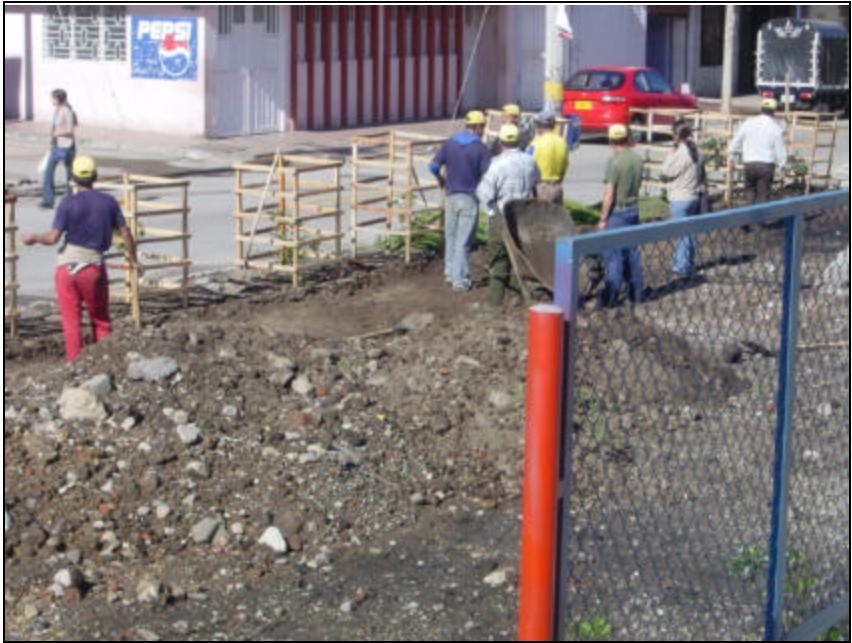
Figura 61. Adecuación terreno para plazuela
