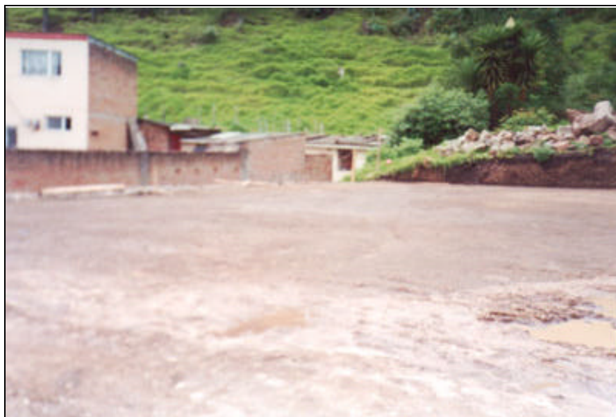
Figura 26. Base en Recebo Compactado vista al sur
