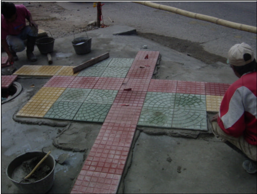
Figura 51. Colocación piso tipo Alfa en la peatonal
