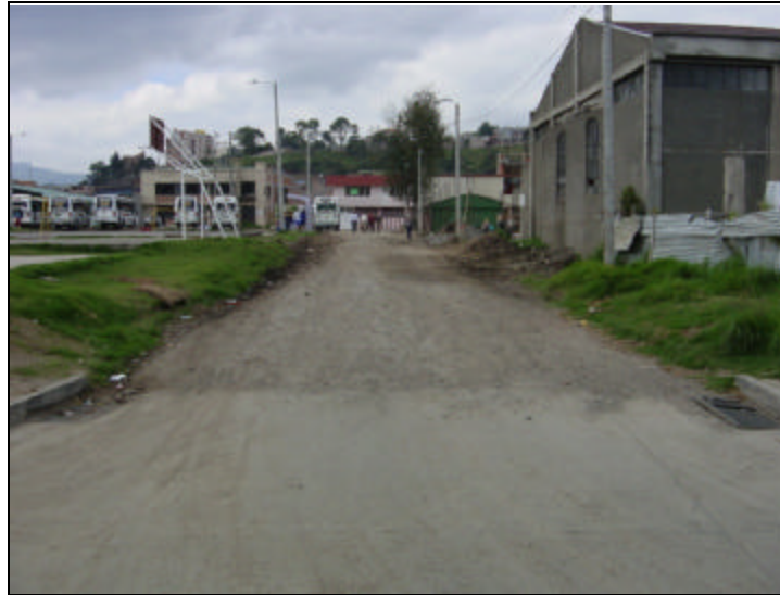
Figura 41. Vista inicial de la Peatonal
