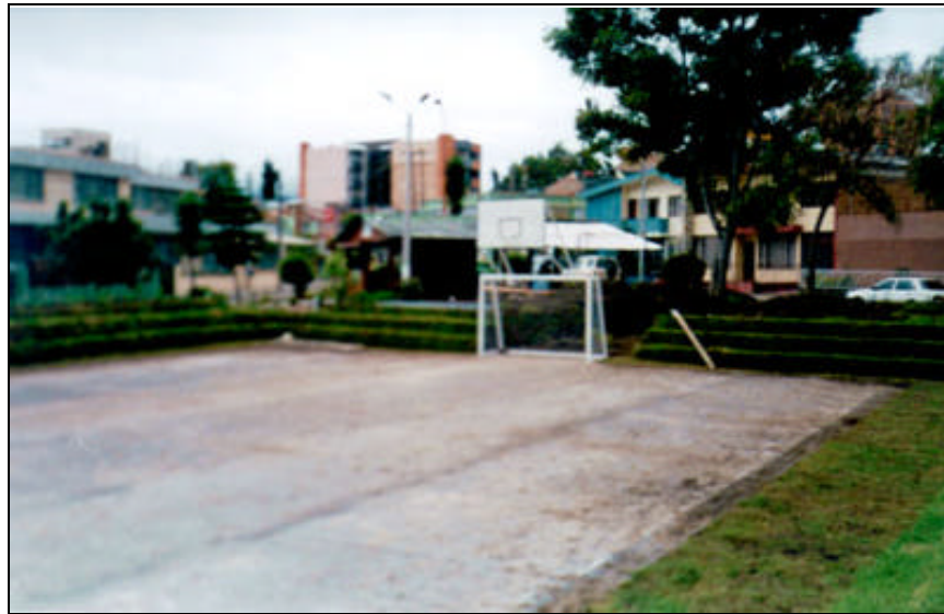
Figura 33. instalación de las Porterías
