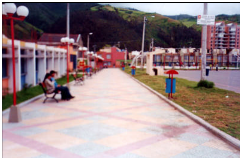
Figura 55. Panorámica del parque terminado
