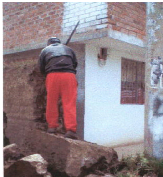
Figura 74. Demolición Parcial de La Tapia
