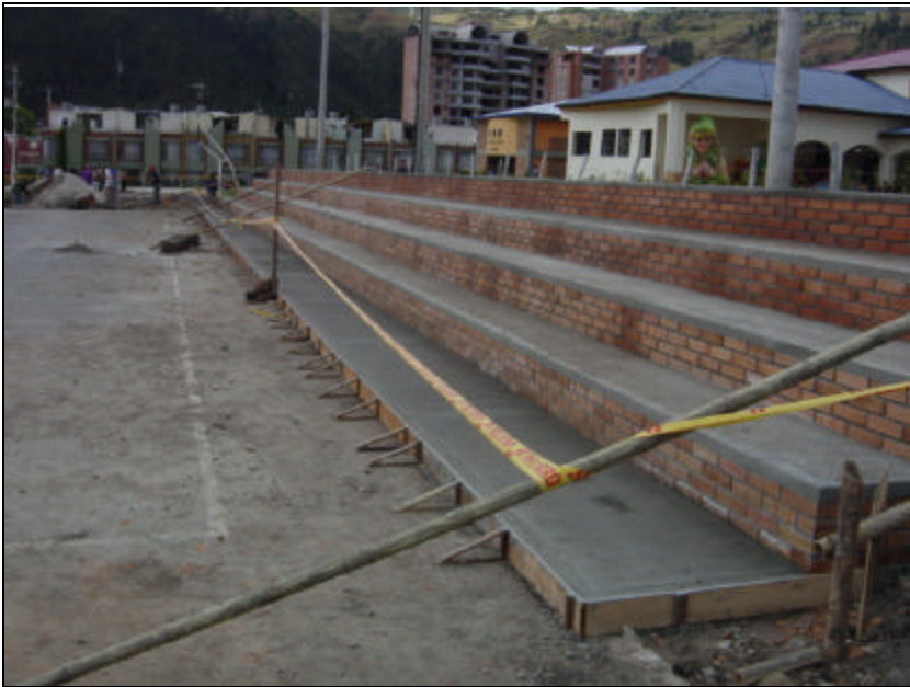
Figura 47. Fundición de la peatonal
