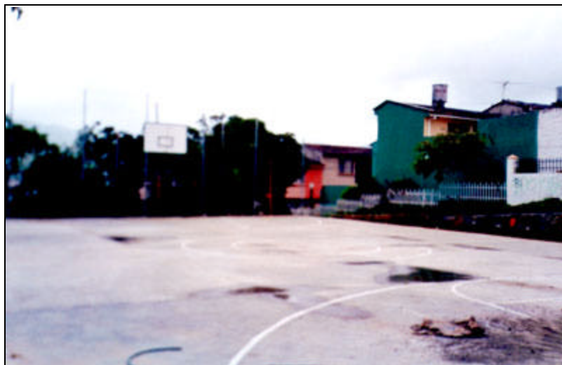
Figura 16. Placa de polideportivo terminado
