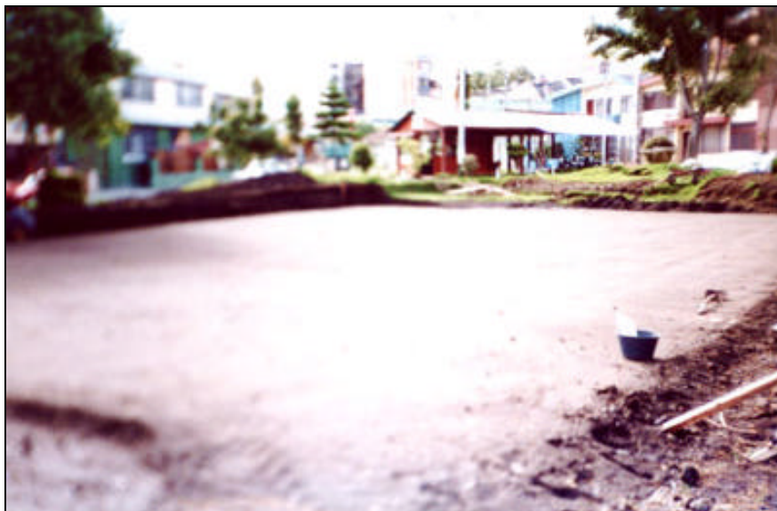
Figura 30. base en recebo Compactada
