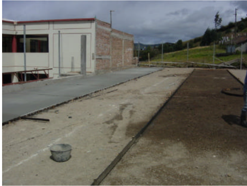
Figura 5 Elaboración de Juntas perdida
