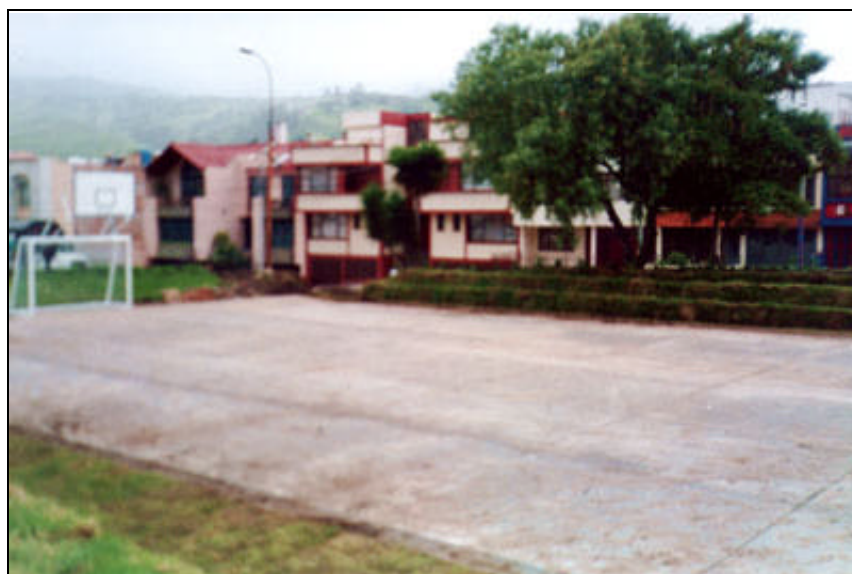
Figura 32. Placa de Concreto terminada
