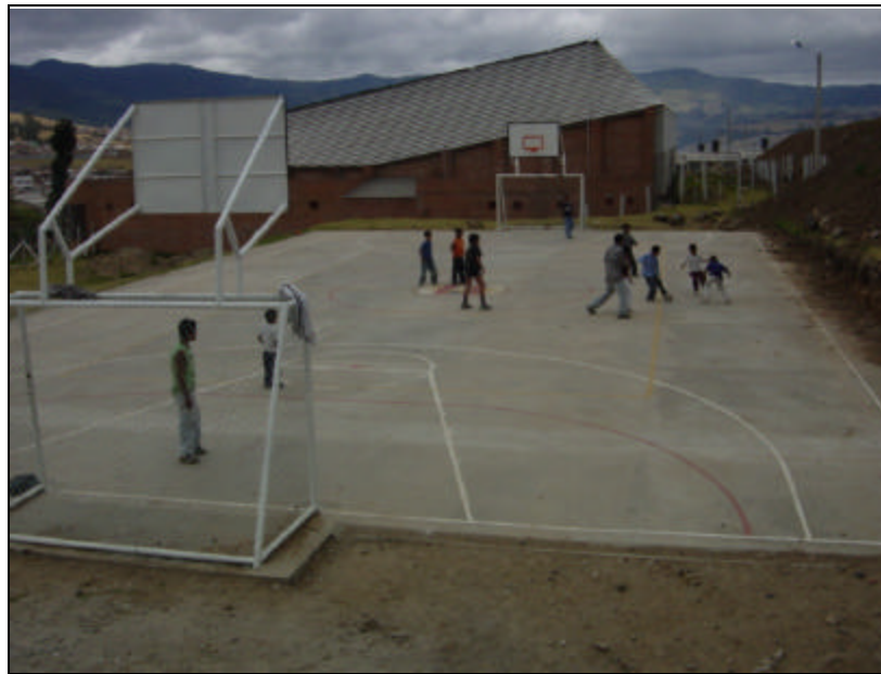
Figura 40. Vista general del Polideportivo Terminado
