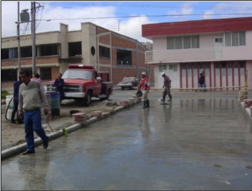
Figura 49. Colocación piso tipo Alfa en la peatonal
