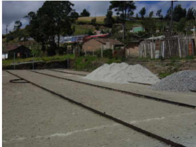
Figura 2. Colocación de la formaleta
