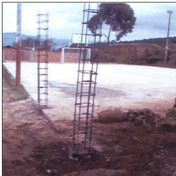
Figura 78. Formateo de columnas
