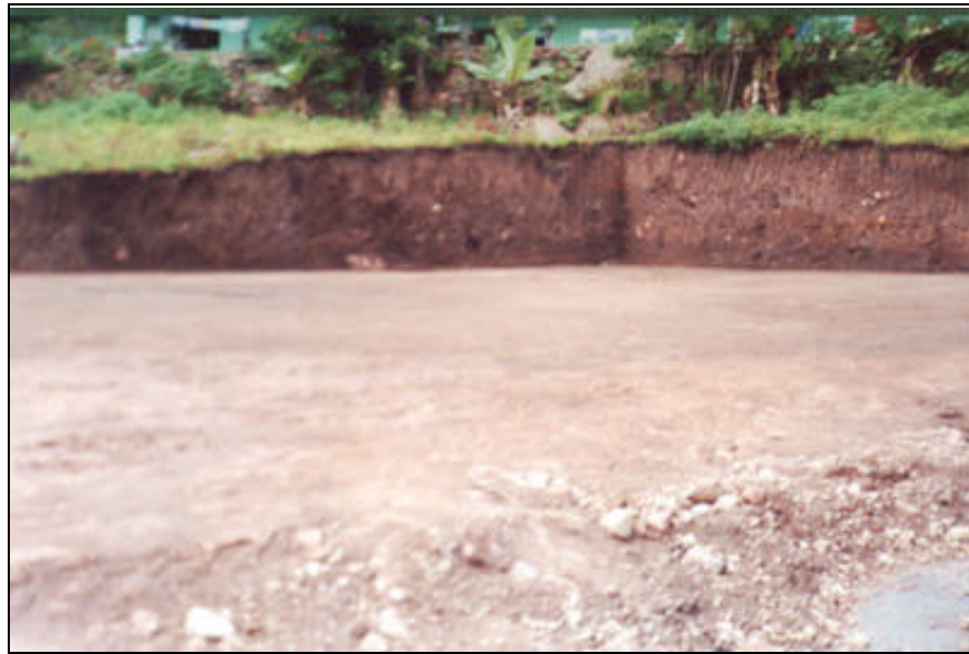
Figura 26. Base en Recebo Compactado vista al sur
