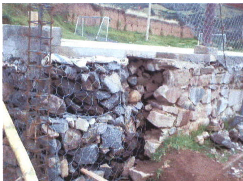
Figura 70. Los tubos y la malla se encuentran oxidados y parcialmente rotos
