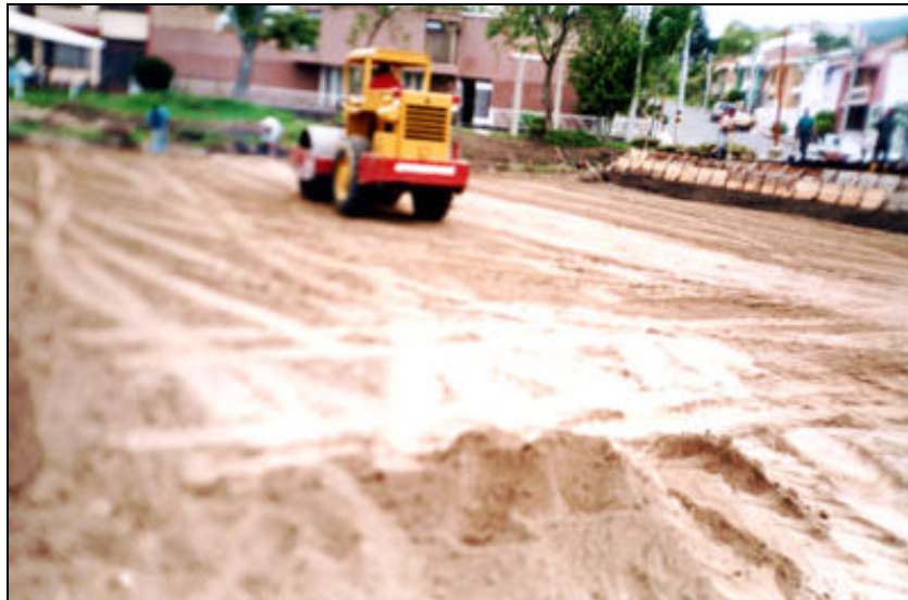
Figura 30. base en recebo Compactada
