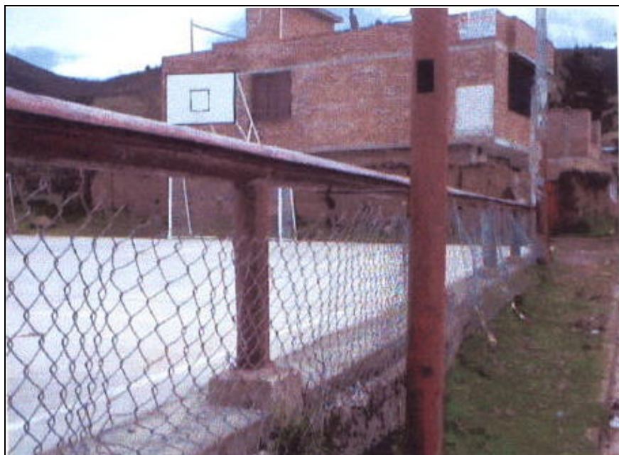
Figura 70. Los tubos y la malla se encuentran oxidados y parcialmente rotos
