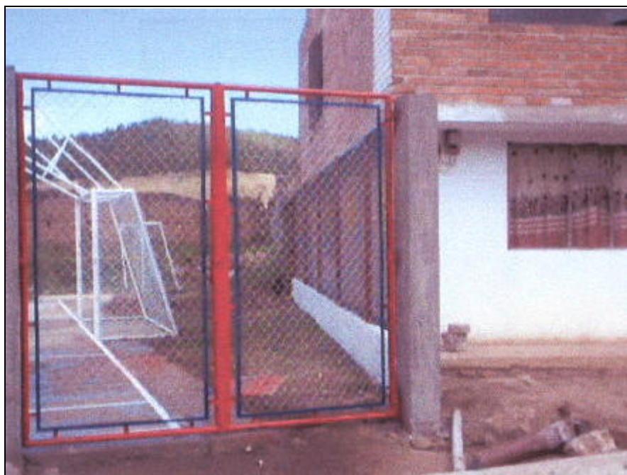
Figura 85. Vista Frontal puerta metálica
