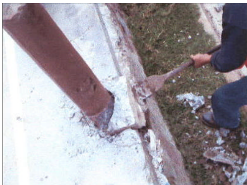
Figura 72. Retiro de los tubos que se encontraban anclados a la placa
