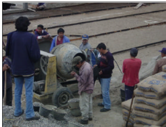
Figura 3. Preparación del concreto para la fundición de la placa
