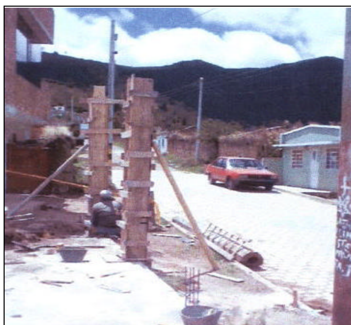
Figura 78. Formateo de columnas
