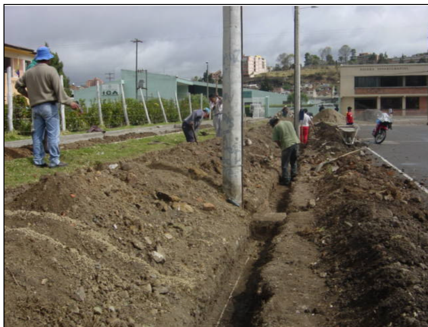
Figura 43. Excavación para graderías
