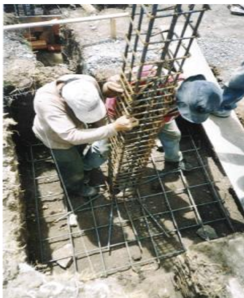
Figura 12. Armado de zapatas y columnas
