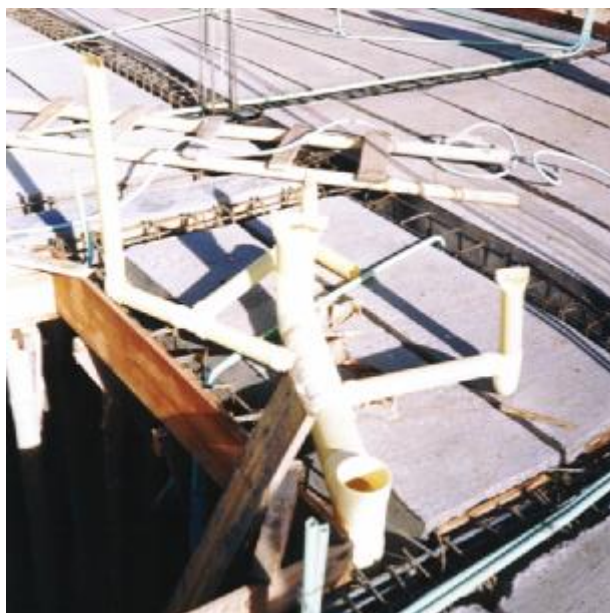
Figura 28. Instalación del muñeco sanitario segundo piso
