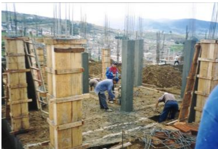
Figura 19. Columnas fundidas
