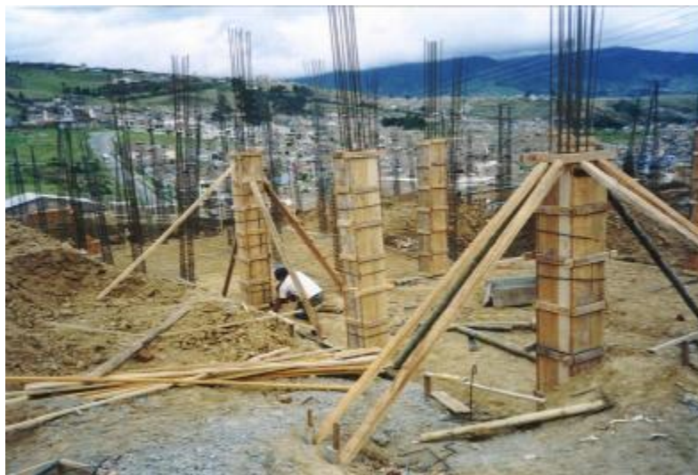
Figura 18. Fundición de columnas
