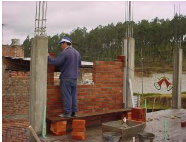
Figura 21. Pega de muros divisorios
