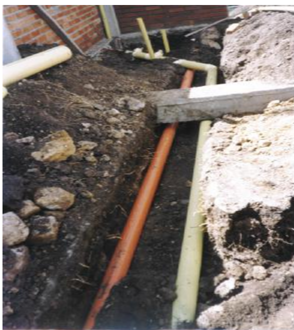
Figura 30. Tendido de tubería sanitaria
