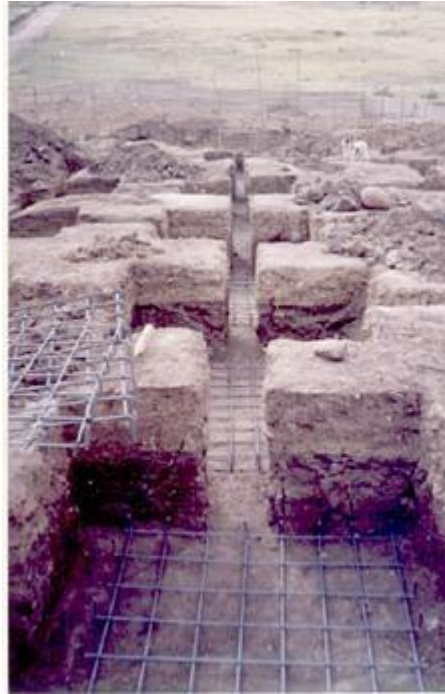
Figura 5. Excavaciones para cimentación
