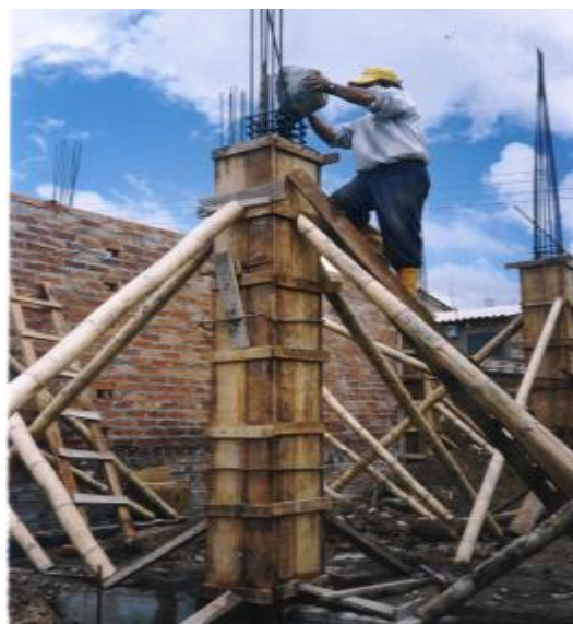
Figura 18. Fundición de columnas
