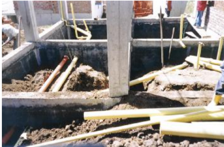
Figura 27. Instalación del muñeco sanitario primer piso
