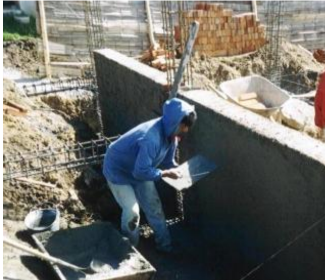
Figura 16. Repello e impermeabilizado de sobrecimiento
