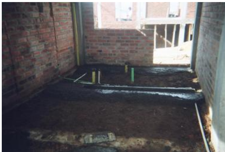
Figura 35. Fundición de loseta de contrapiso
