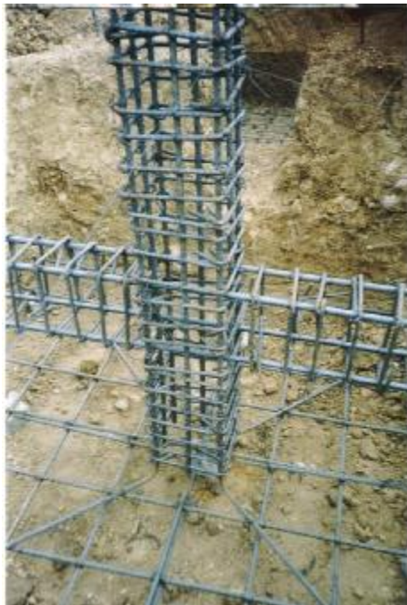
Figura 13. Armado de zapatas, vigas de cimentación y columnas
