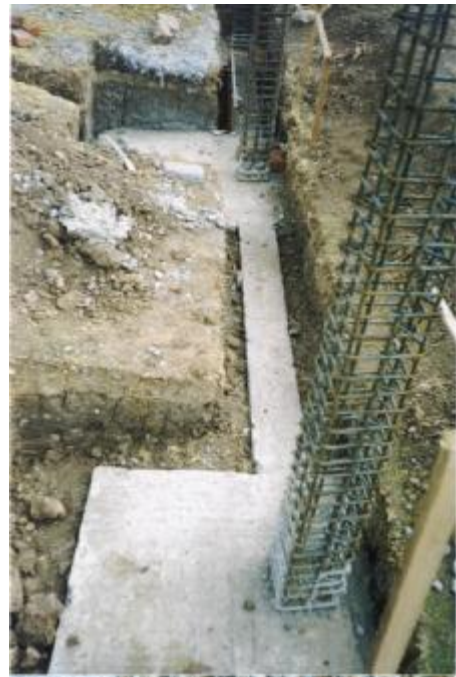
Figura 14. Fundición de zapatas y vigas de cimentación
