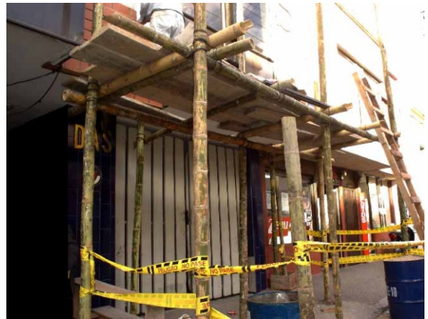
Figura 7: Andamio de madera
