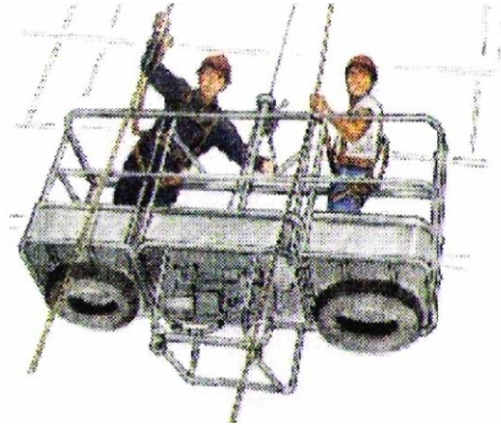
Figura 11: Obreros en andamio colgante
