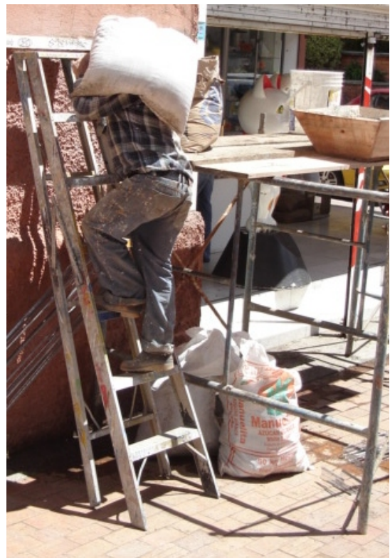
Figura 31: Adecuación de un andamio
