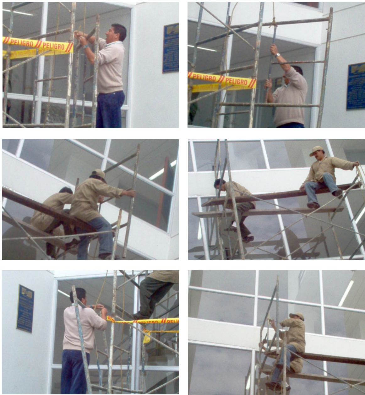
Figura 28: Instalación de andamio
