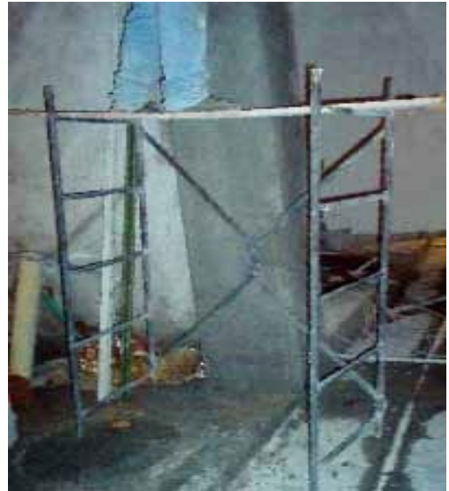
Figura 20: Andamio de reparaciones
