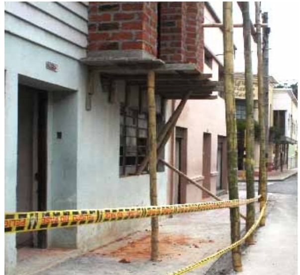
Figura 8: Andamio de apoyos
