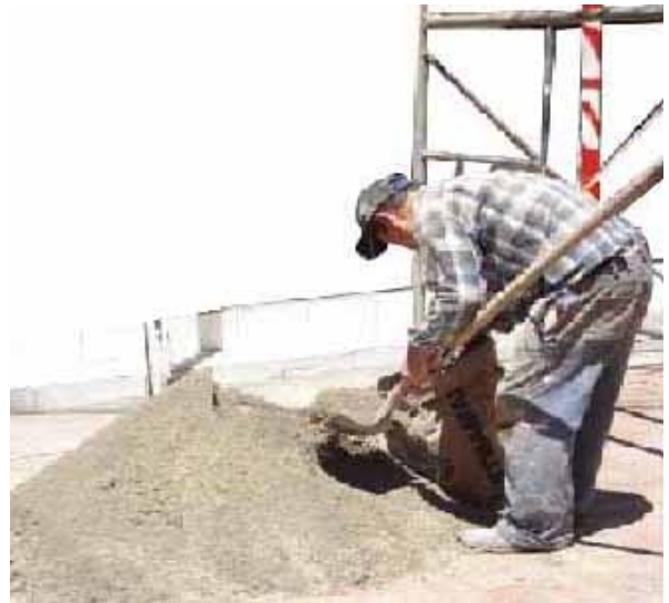
Figura 13: Obrero de construcción
