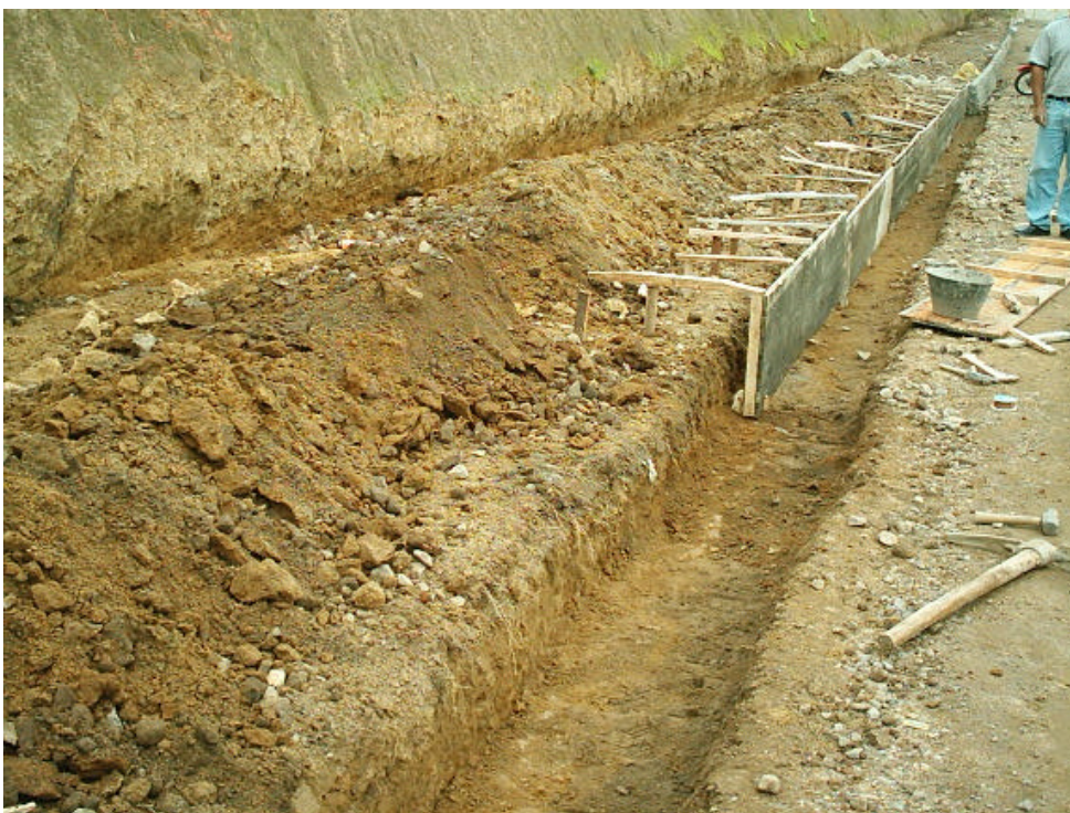
Figura 41. Excavación manual para construcción de sardineles
