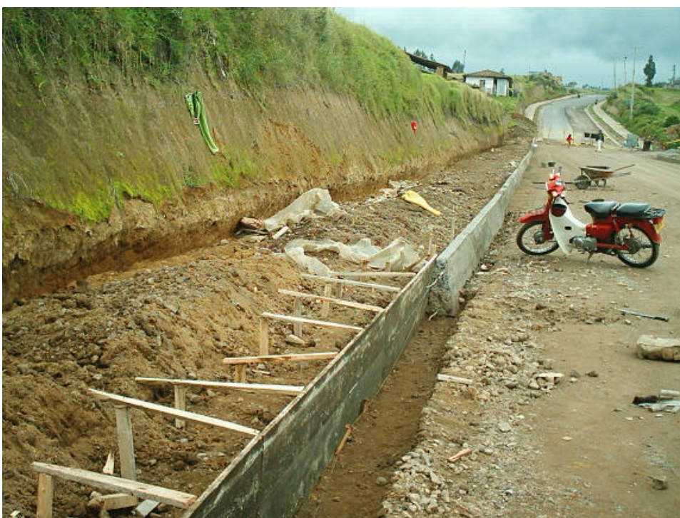
Figura 43. Construcción de sardineles
