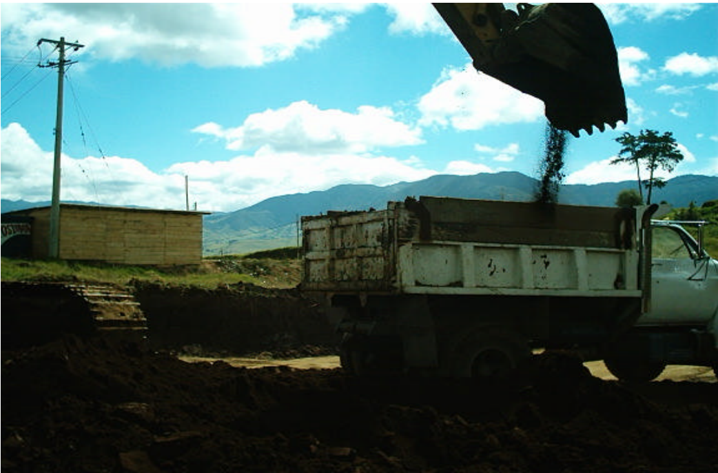
Figura 9. Desalojo material de excavación con retroexcavadora
