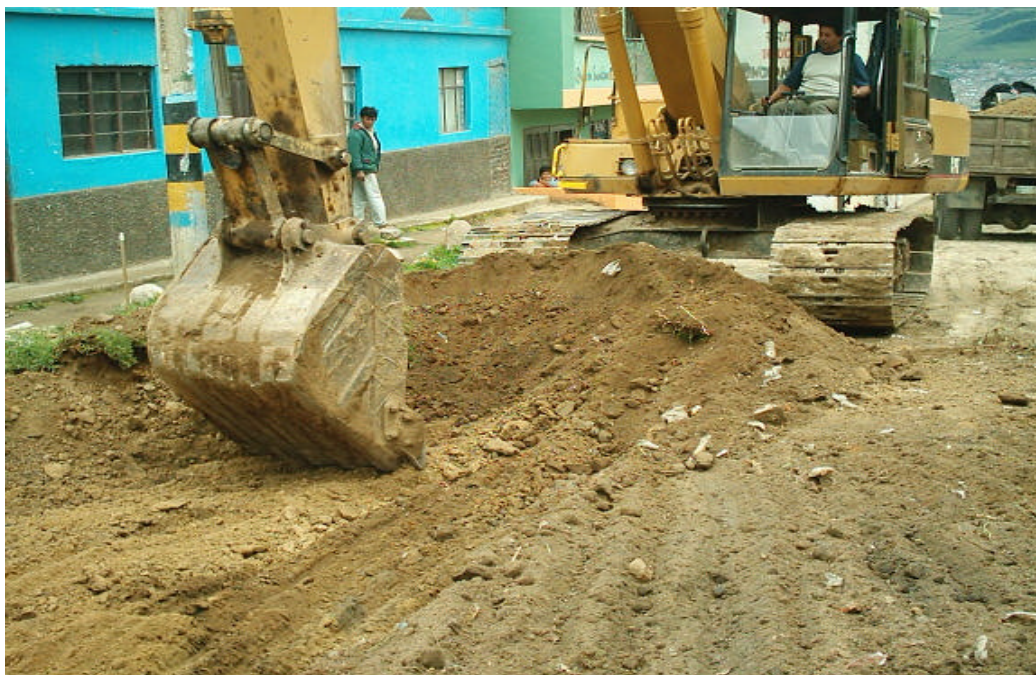
Figura 33. Excavación a máquina
