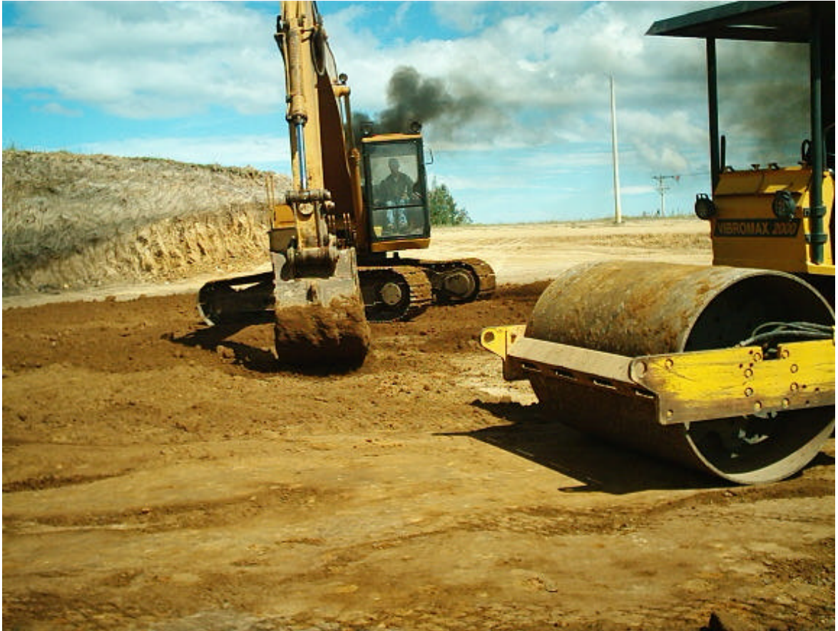
Figura 13. Tendido de material de relleno
