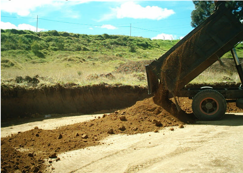
Figura 21. Descargue material de relleno
