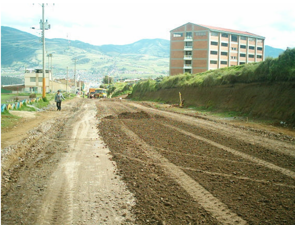
Figura 35. Colocación de base granular
