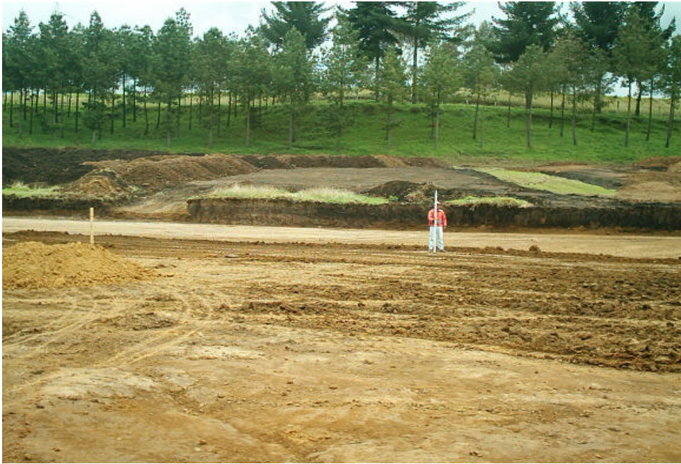
Figura 24. Nivelación del terreno
