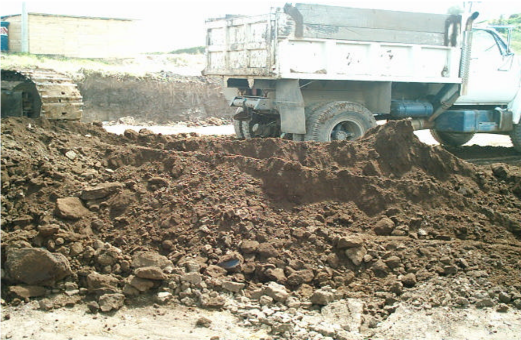
Figura 9. Desalojo material de excavación con retroexcavadora
