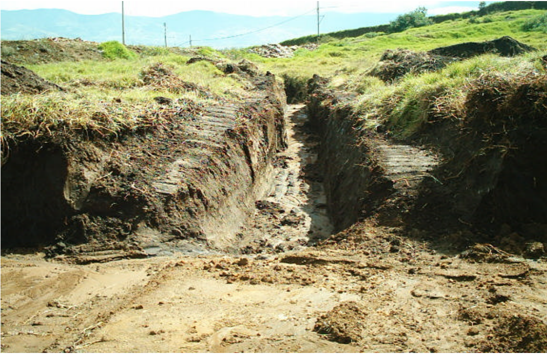
Figura 17. Excavación para tramo final de tubería
