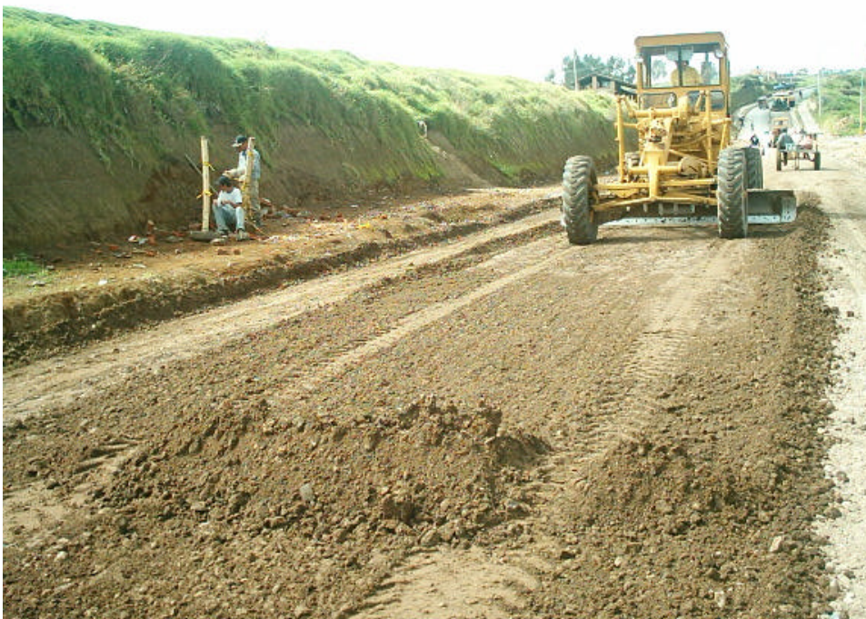
Figura 37. Motoniveladora para conformación de base granular
