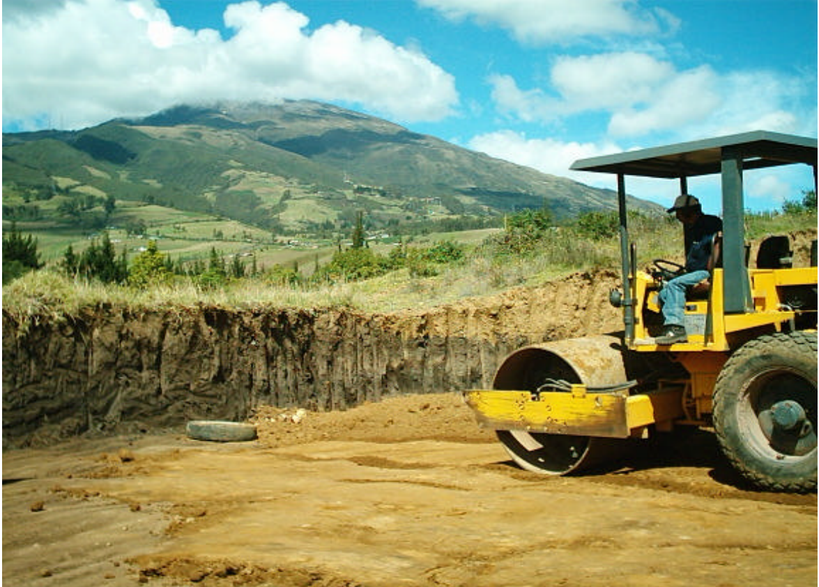
Figura 14. Compactación de material
