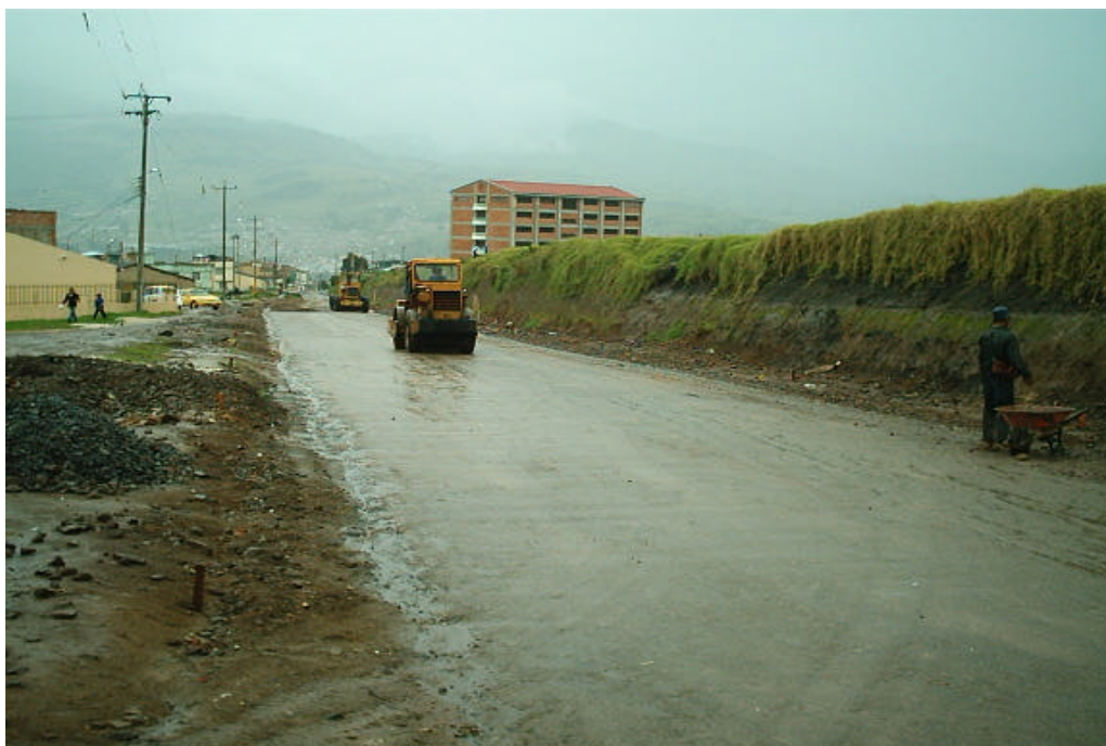
Figura 39. Compactación por capas del material de base
