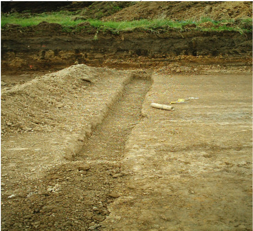
Figura 32. Compactación de zanjas con material de excavación
