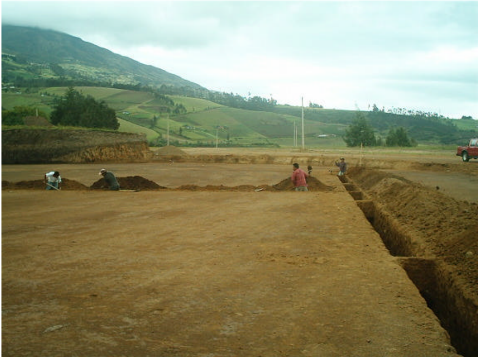
Figura 26. Zanjas para instalación de tubería
