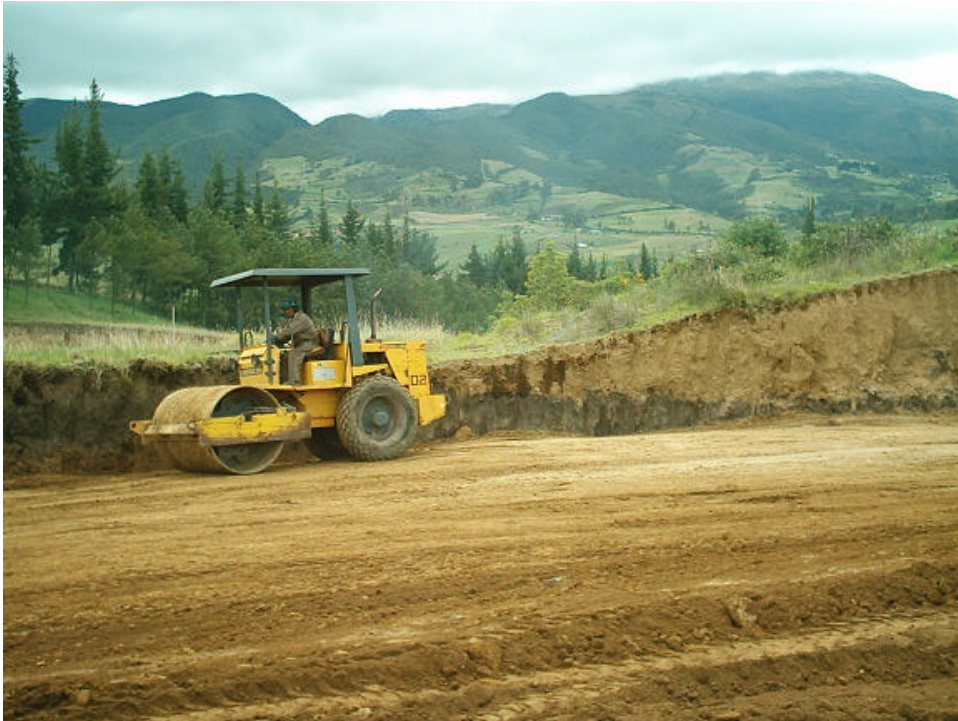
Figura 23. Compactación con Vibrocompactador
