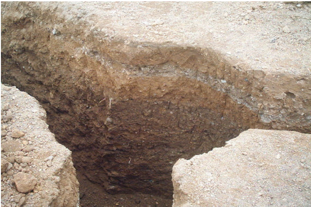
Figura 28. Excavación para pozo de inspección
