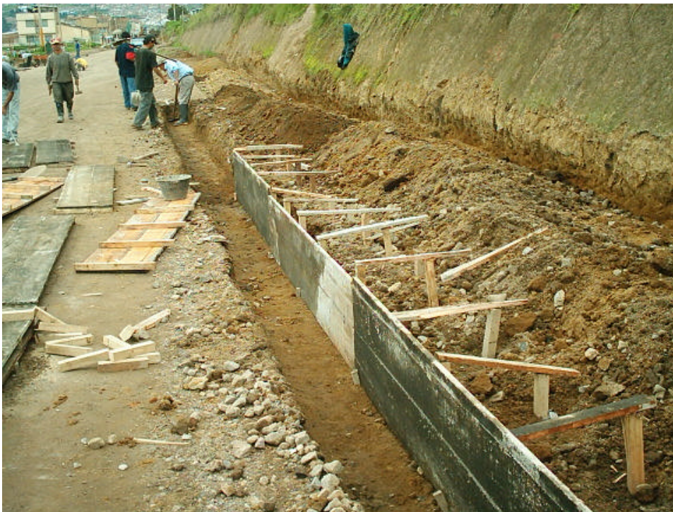
Figura 43. Construcción de sardineles
