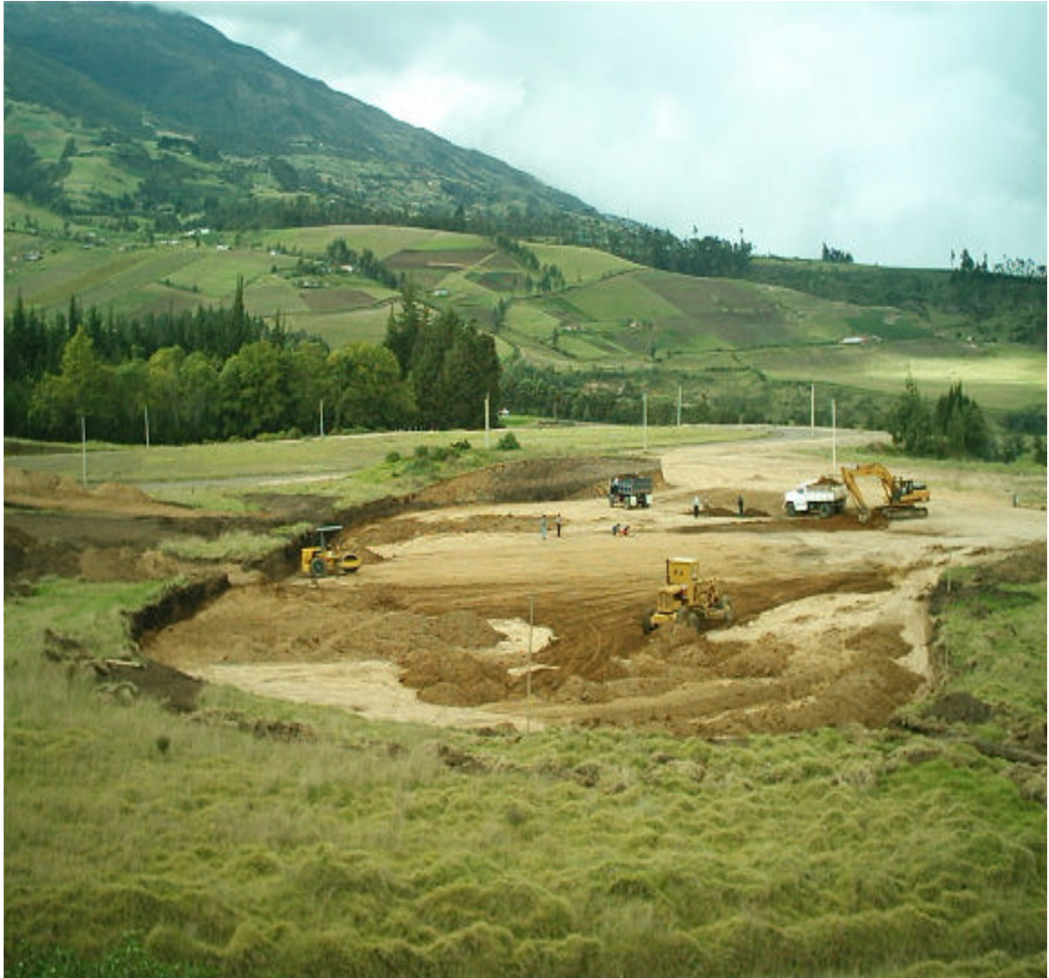
Figura 4. Panorámica de las obras de adecuación
