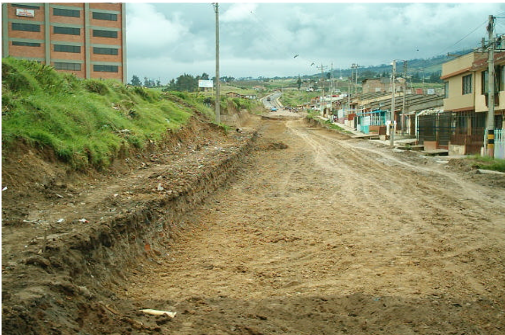
Figura 35. Colocación de base granular
