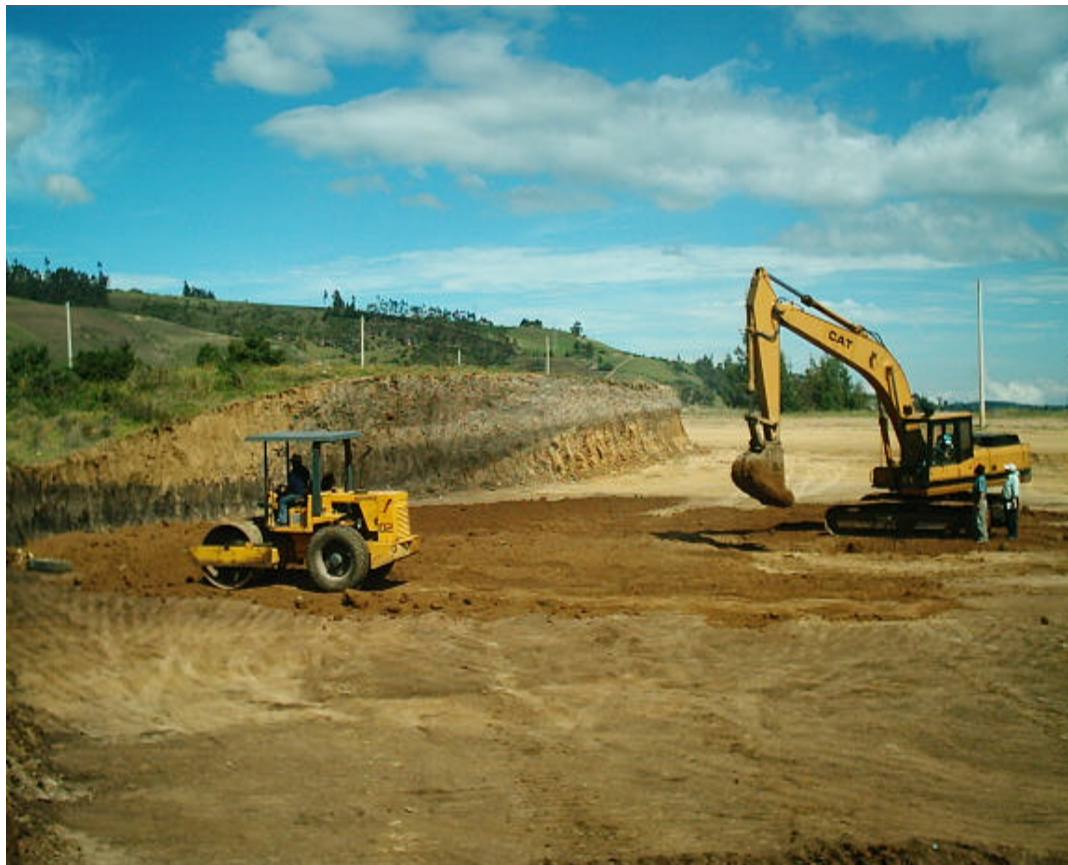
Figura 12. Compactación con vibrocompactador
