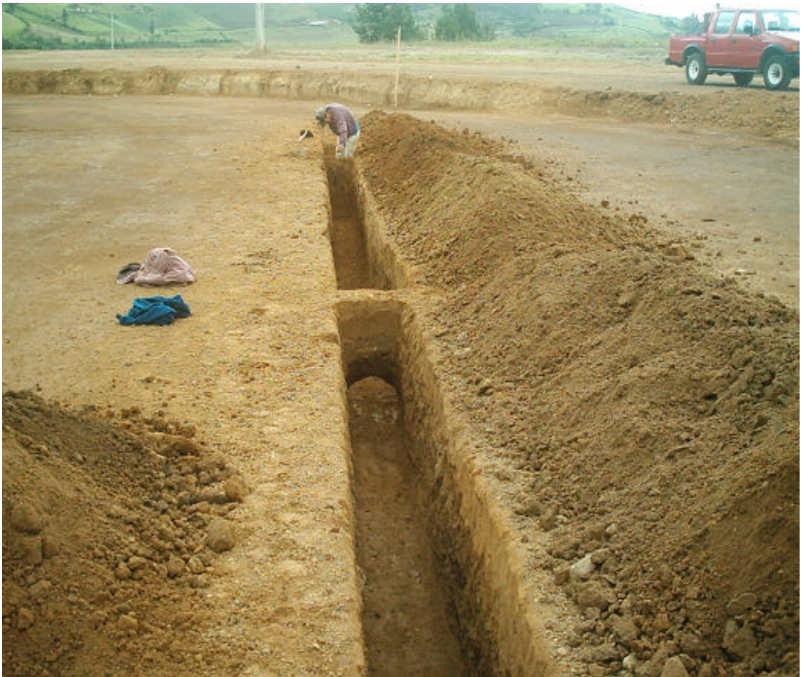
Figura 25. Excavación manual para instalación de tubería
