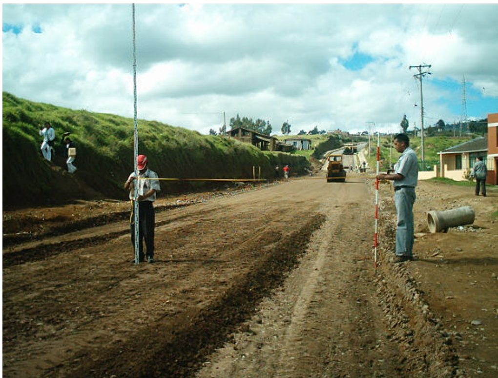
Figura 39. Compactación por capas del material de base
