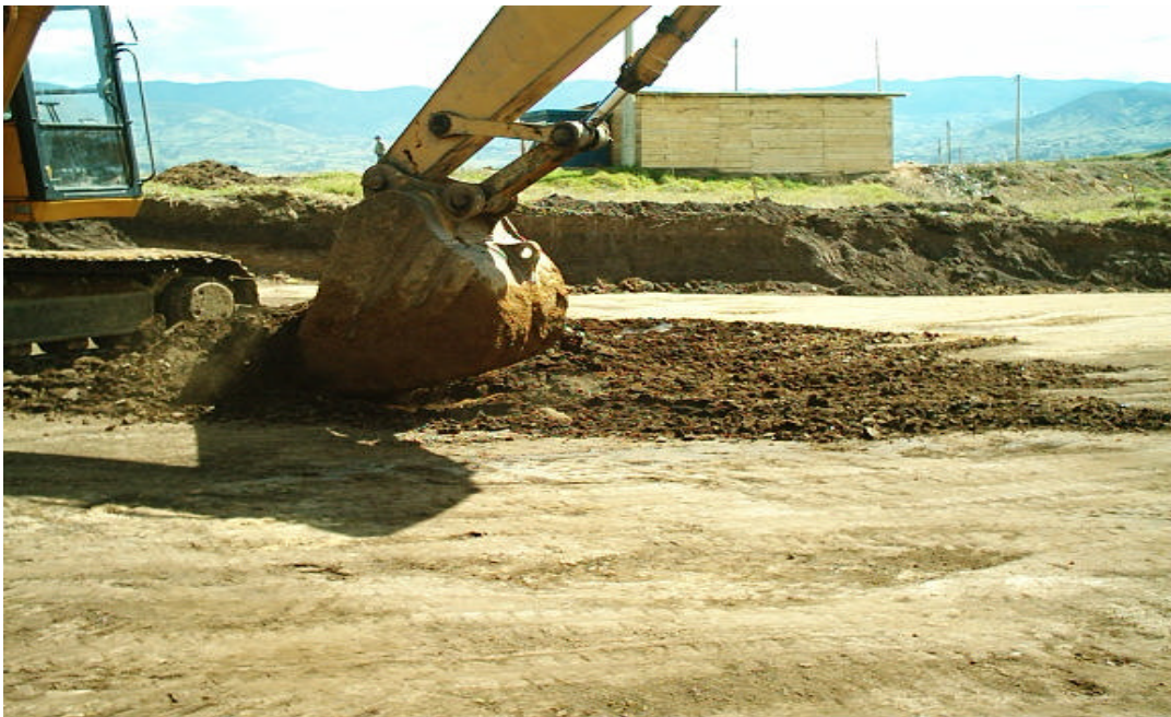
Figura 7. Retiro material de excavación (Capa vegetal)
