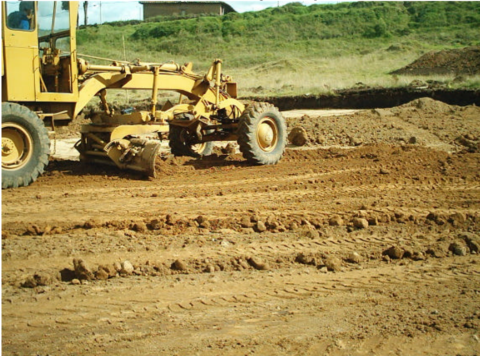
Figura 22. Tendido de material mejorado para relleno
