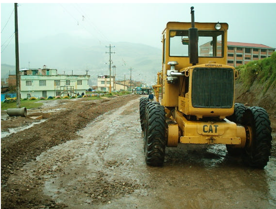
Figura 37. Motoniveladora para conformación de base granular
