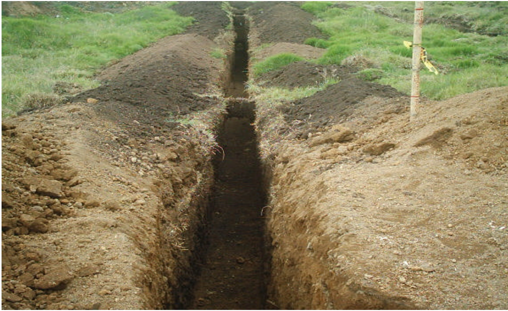
Figura 28. Excavación para pozo de inspección
