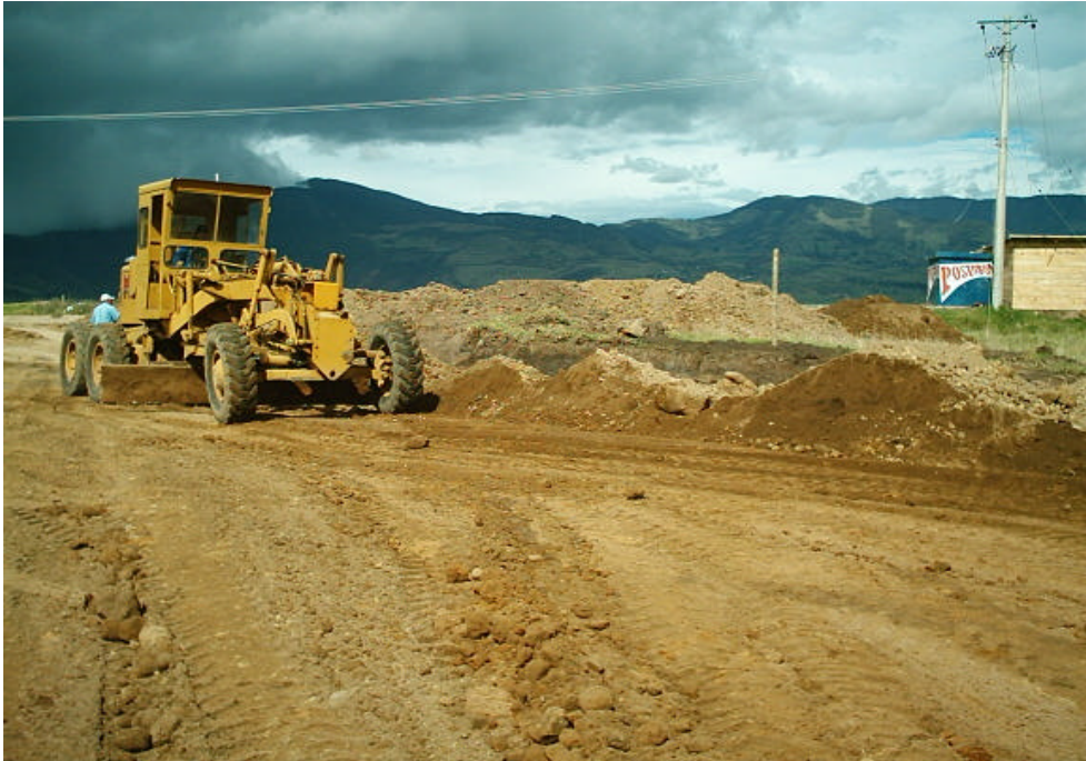
Figura 18. Tendido de material de relleno con motoniveladora
