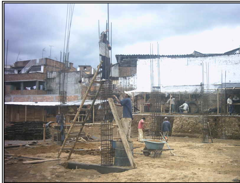
Figura 50. Traslazo de columnas
