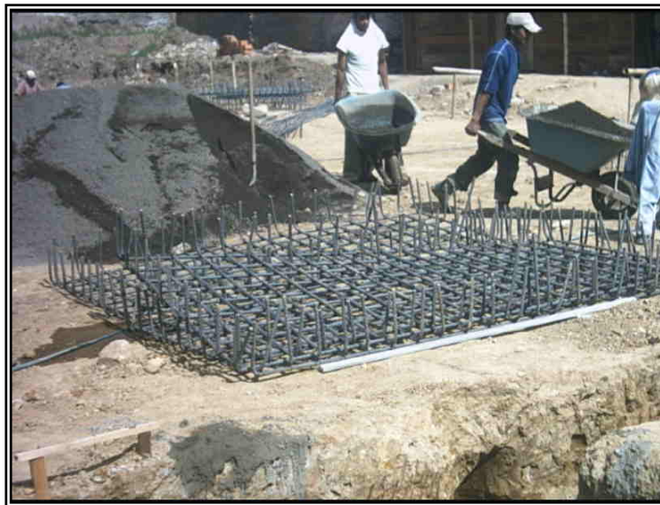
Figura 39. Armado de parrilla para zapatas.
