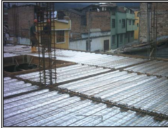
Figura 131. Tendido de la malla electro-soldada.
