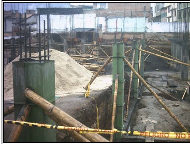
Figura 54. Formaleta metálica para columnas (b).
