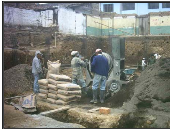
Figura 42. Fundición zapatas (a).
