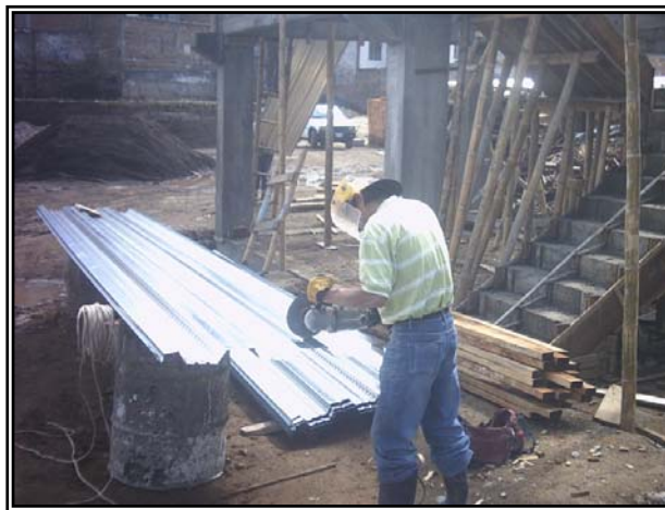
Figura 99. Corte de METALDECK.
