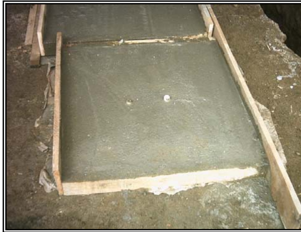
Figura 118. Tapas para las cajas de inspección.
