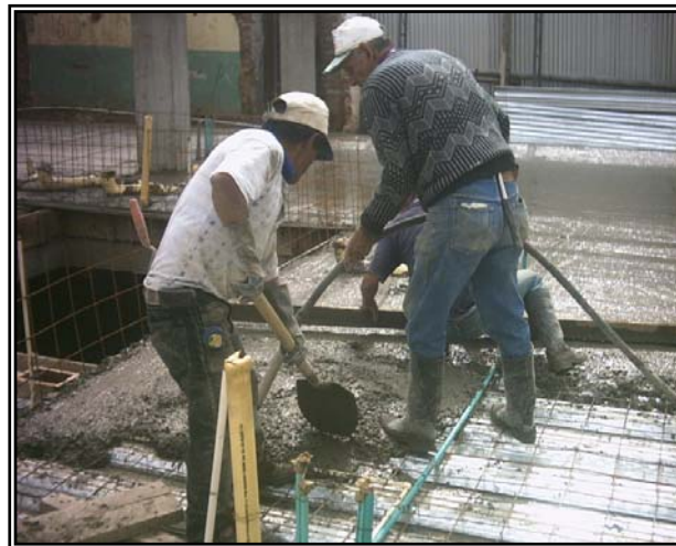
Figura 109. Vibrado del concreto losa nivel N+0,00.
