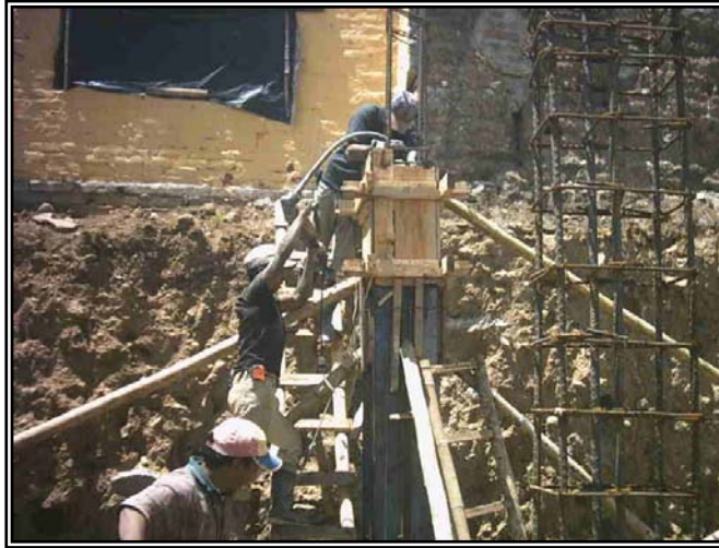
Figura 56. Vaciado y vibrado del concreto.
