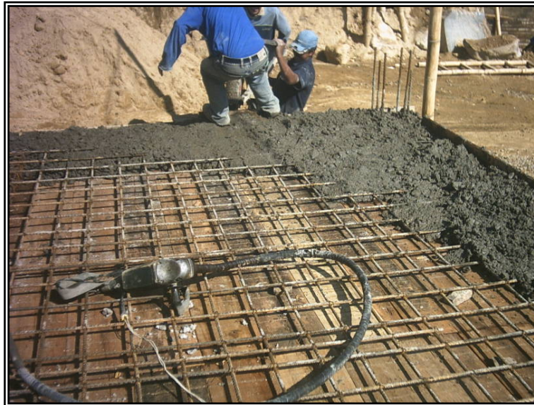
Figura 71. Fundición rampa de acceso.
