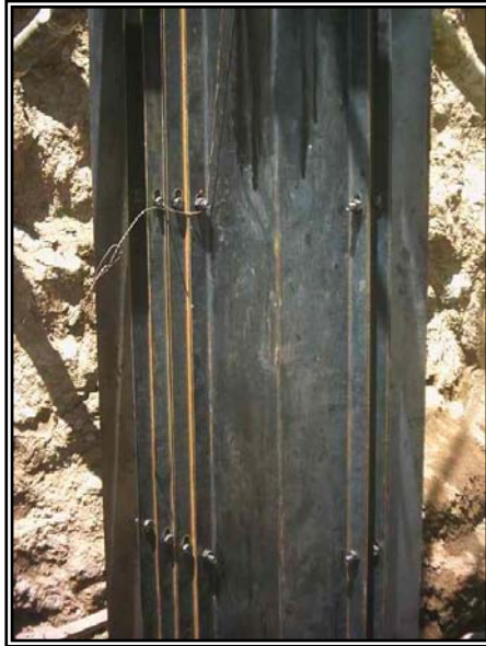
Figura 92. Formaleta metálica columnas nivel N+0,00.
