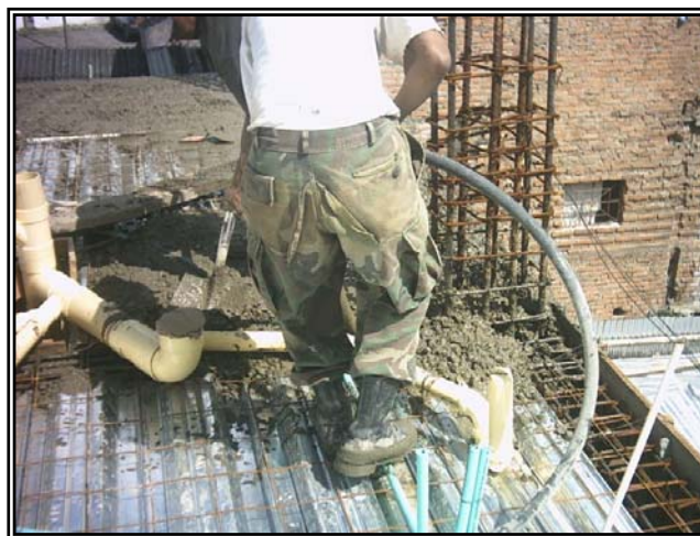
Figura 140. Vibrado concreto.
