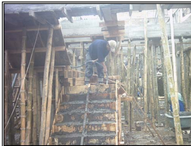
Figura 86. Vibrado del concreto para escalera.
