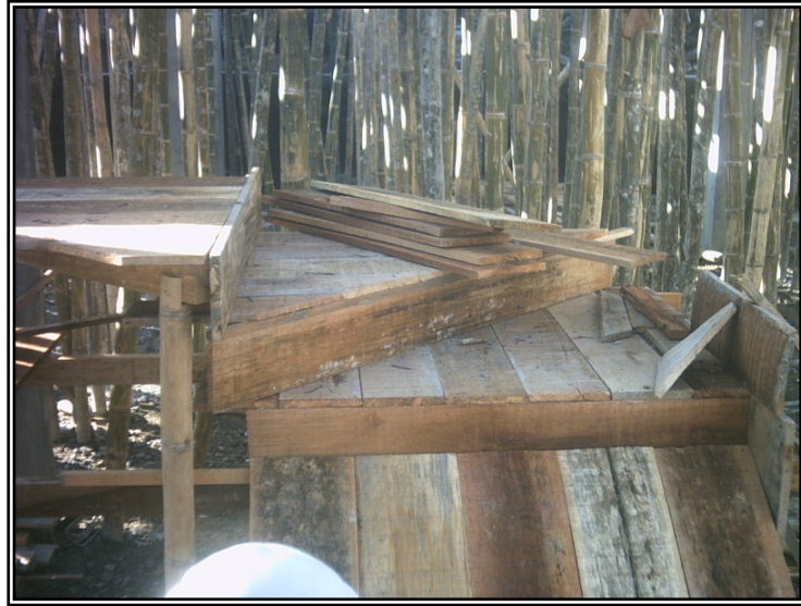
Figura 81. Mariposa tramo escalera bloque 3.
