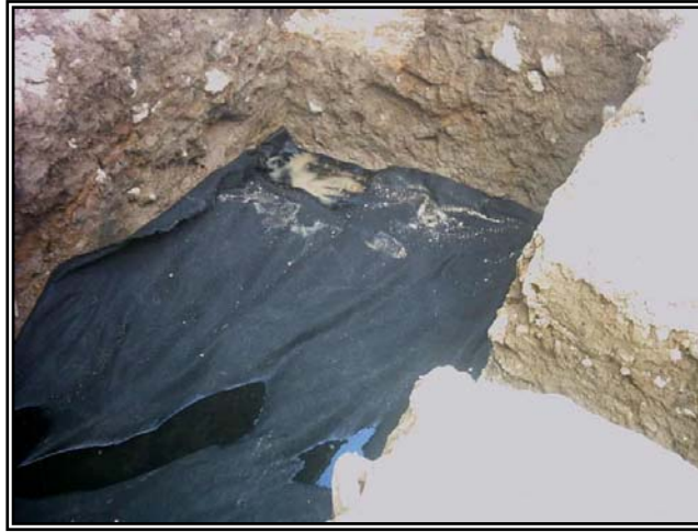
Figura 36. Colocación de Geotextil tejido 1600.
