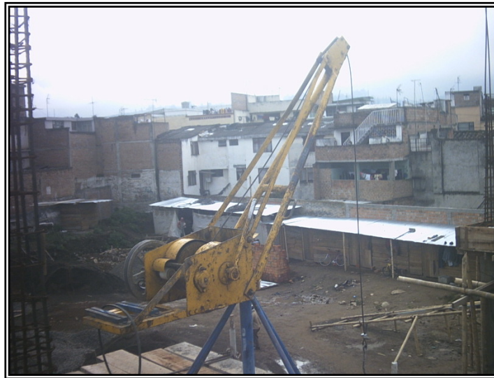
Figura 138. Pluma eléctrica
