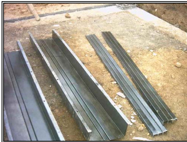
Figura 54. Formaleta metálica para columnas (b).
