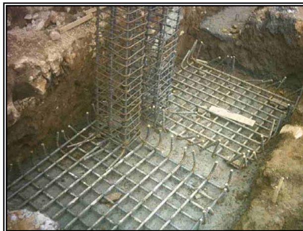
Figura 41. Anclaje parrilla – castillo (Junta de dilatación).
