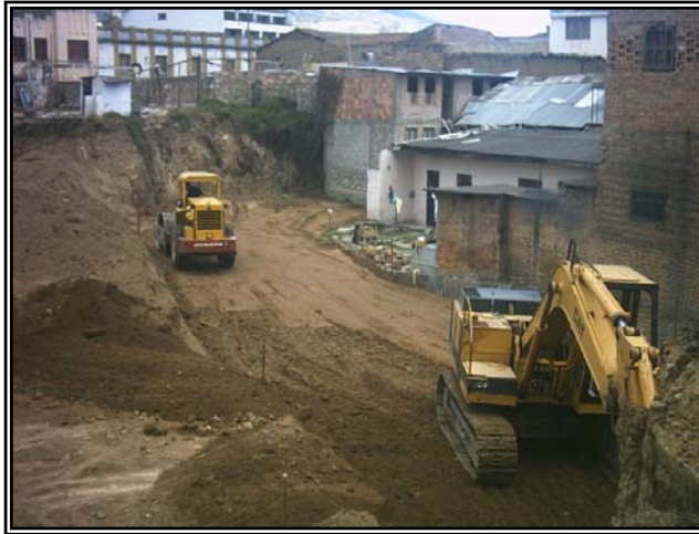
Figura 22. Nivelación con vibro – compactador.
