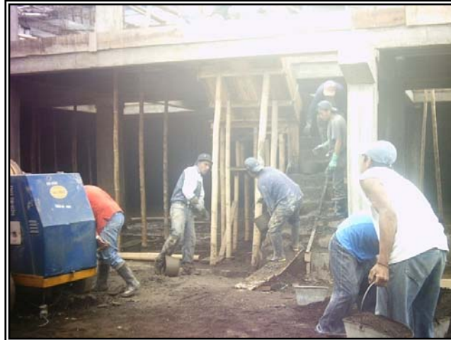
Figura 108. Fundición losa nivel N+0,00 Bloque 2.
