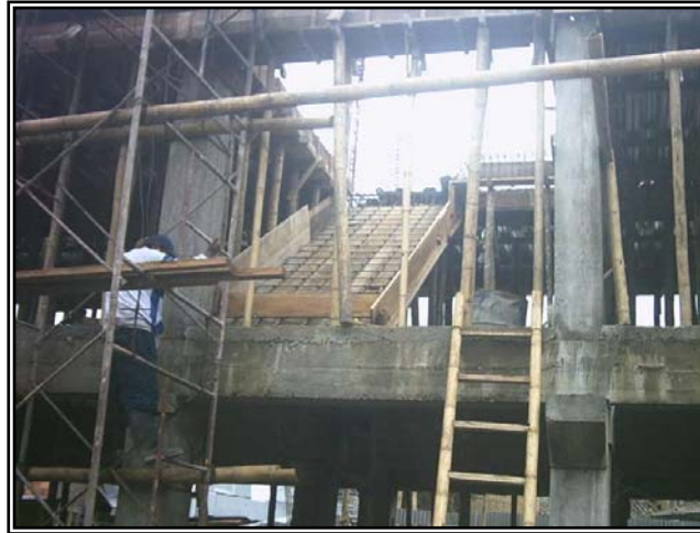
Figura 133. Refuerzo escaleras segundo nivel.
