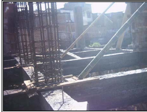
Figura 89. Armado columnas nivel N+0,00 (b).
