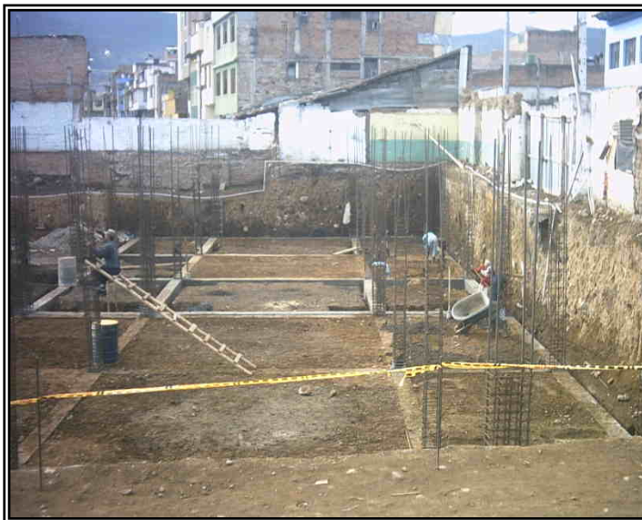
Figura 48. Vista general relleno bloques 1 y 2.
