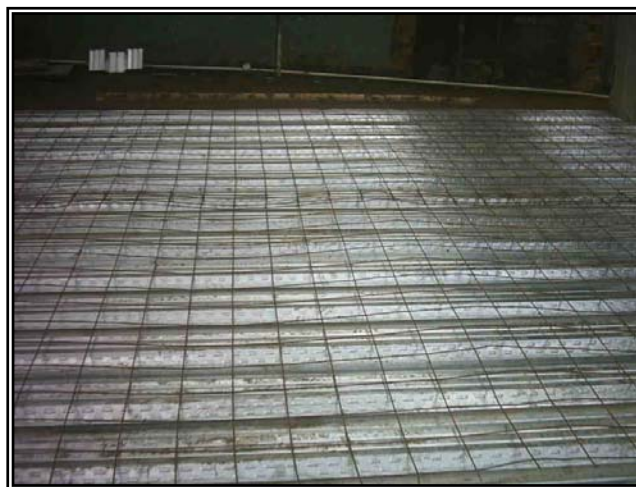
Figura 102. Tendido de la malla electro-soldada.
