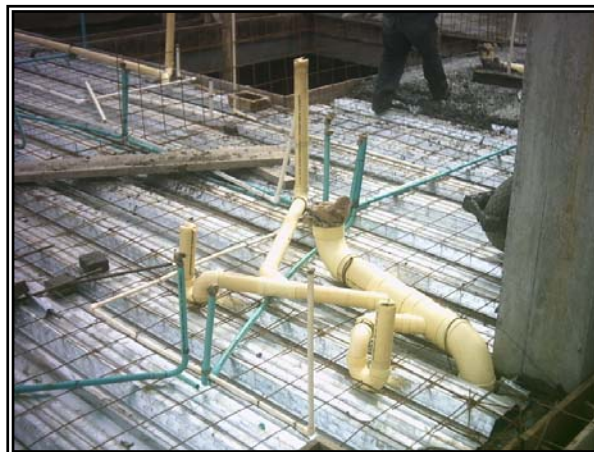
Figura 105. Instalaciones Hidrosanitarias.
