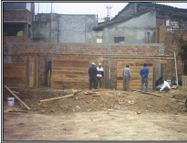
Figura 26. Campamentos contratistas (b).
