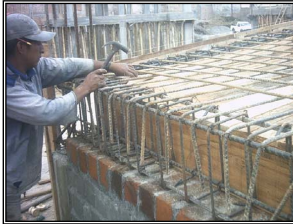
Figura 67. Refuerzo rampa de acceso peatonal.
