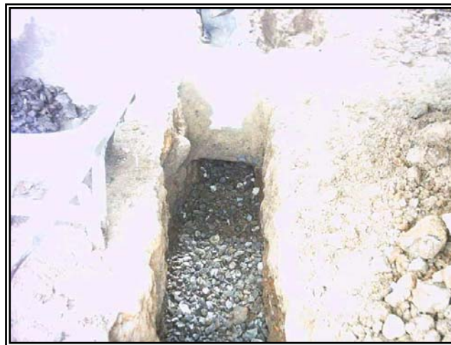
Figura 119. Capas de triturado. h= 0,15m .
