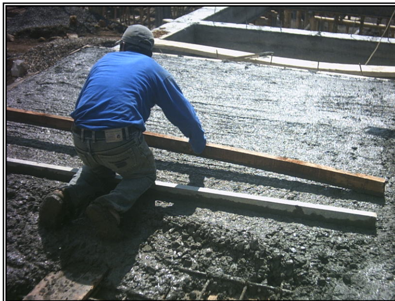
Figura 72. Tallado concreto rampa de acceso peatonal.
