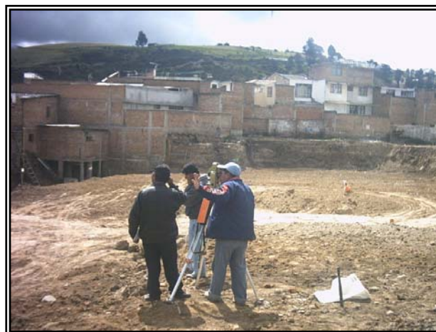
Figura 19. Nivelación del terreno.
