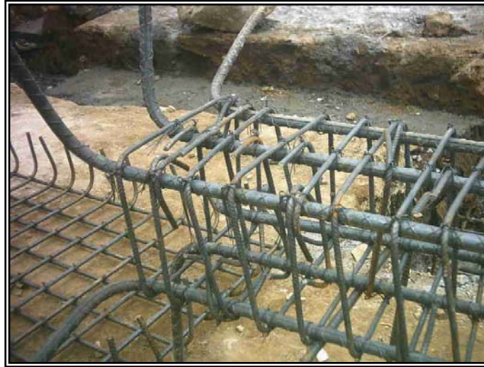
Figura 49. Refuerzo de columnas
