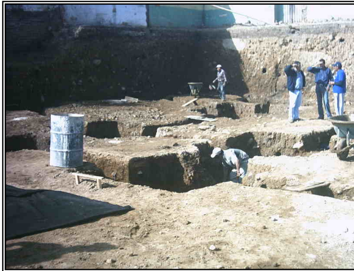
Figura 34. Excavación zapatas.
