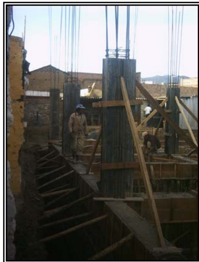
Figura 93. Encofrado formaleta metálica columnas nivel N+0,00.
