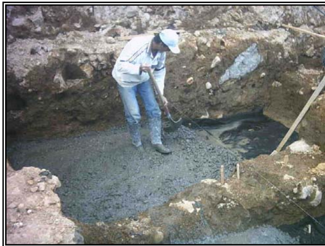
Figura 37. Solado concreto simple zapatas.
