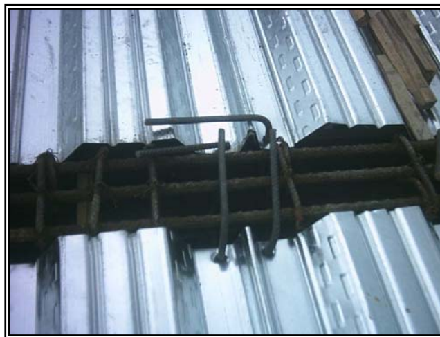
Figura 129. Conectores de cortante.
