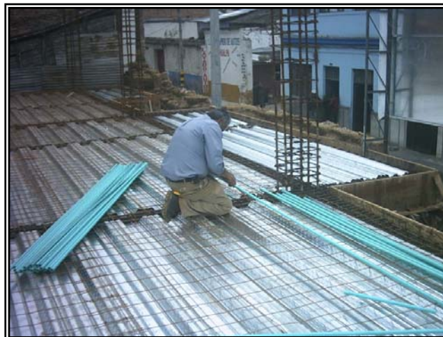
Figura 135. Tendido tubería eléctrica segundo nivel.
