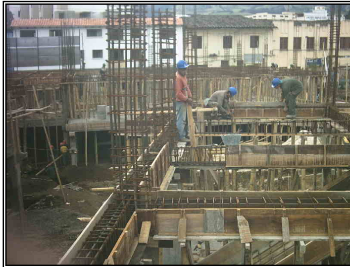
Figura 125. Laterales de formaleta vigas entrepiso segundo nivel.
