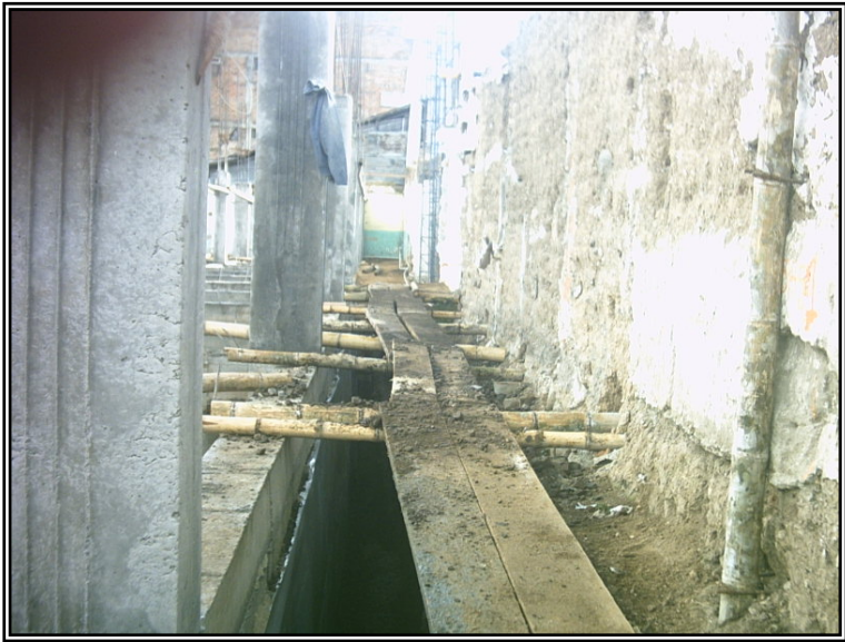
Figura 76. Relleno bloques 1 y 2.
