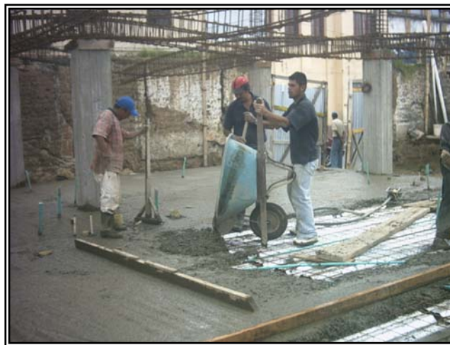
Figura 111. Fundición losa nivel N+0,00.
