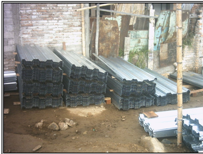
Figura 96. Almacenamiento láminas METALDECK.
