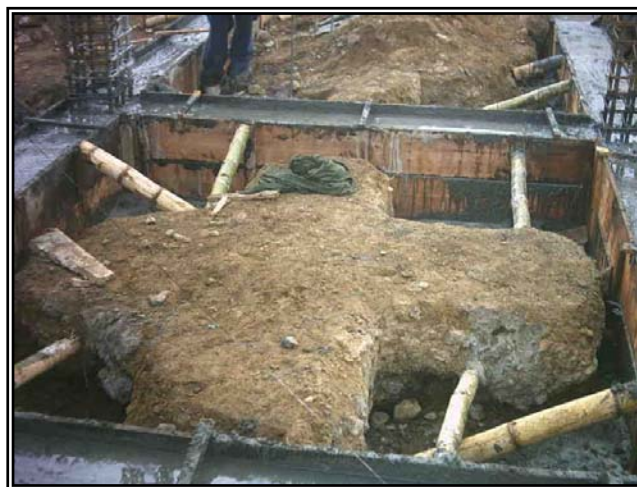
Figura 46. Fundición vigas de cimentación.
