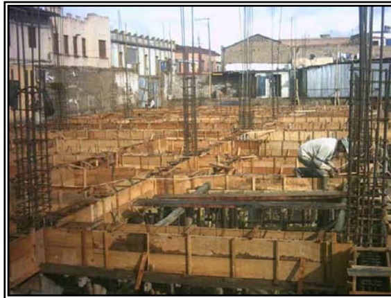
Figura 63. Encofrado vigas entrepiso nivel N+0,00.
