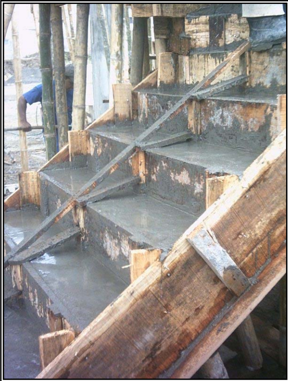
Figura 87. Acabado final escalera.
