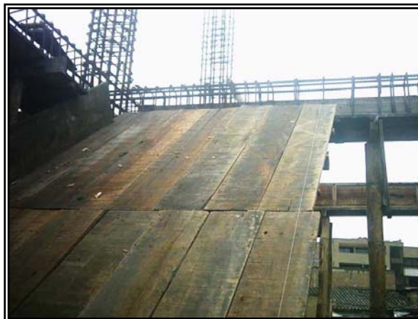
Figura 132. Formaleteo escaleras segundo nivel.
