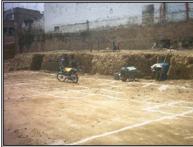
Figura 28. Replanteo de bloques.
