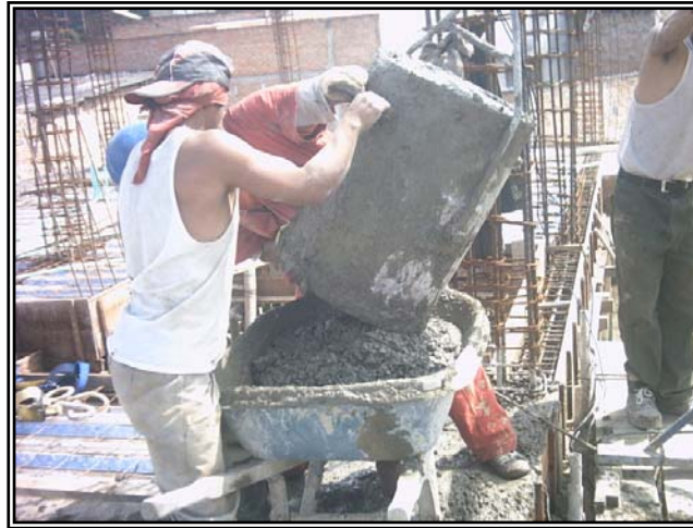
Figura 139. Fundición losa segundo nivel.
