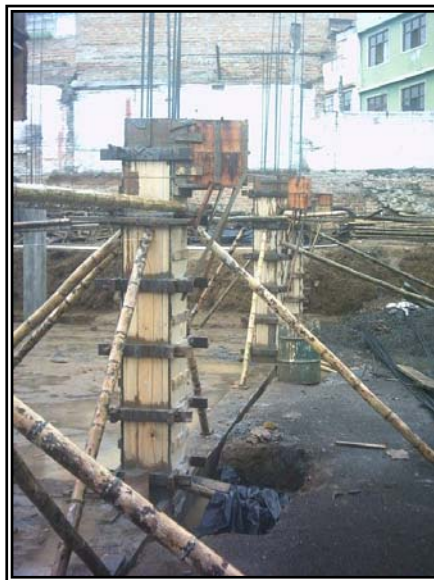
Figura 52. Formaleta en madera para columnas.
