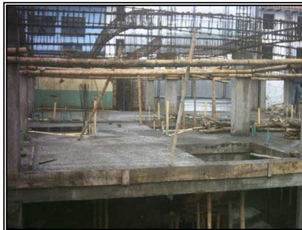
Figura 123. Vigas aéreas segundo nivel.
