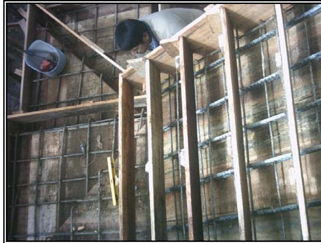
Figura 85. Laterales de peldaños escalera.
