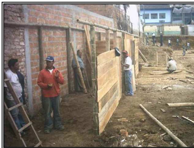
Figura 25. Campamentos contratistas (a).
