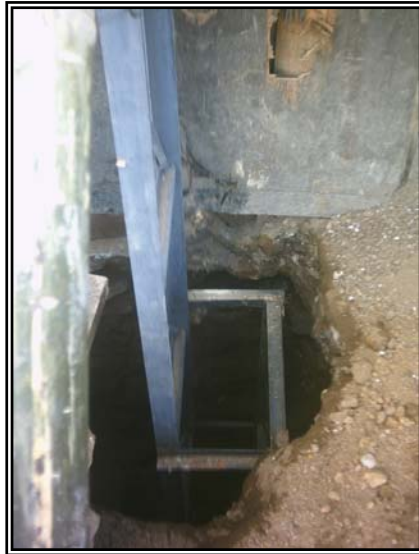
Figura 73. Instalación torre metálica
