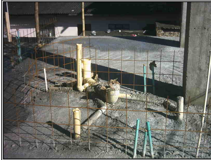
Figura 112. Fundición losa nivel N+0,00.
