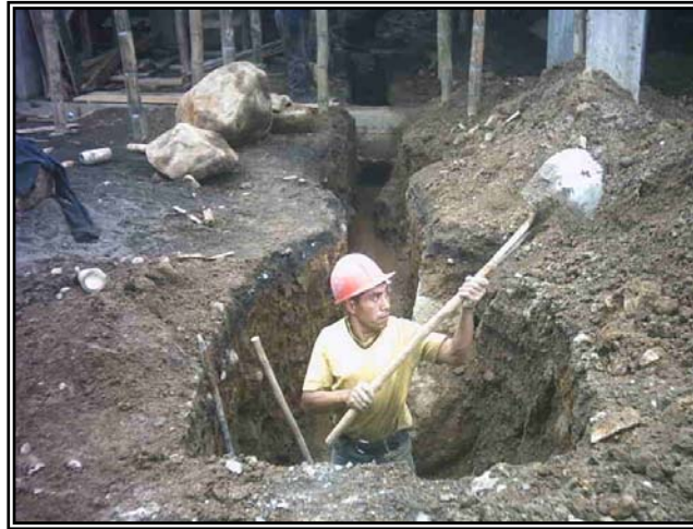
Figura 116. Excavación del filtro.
