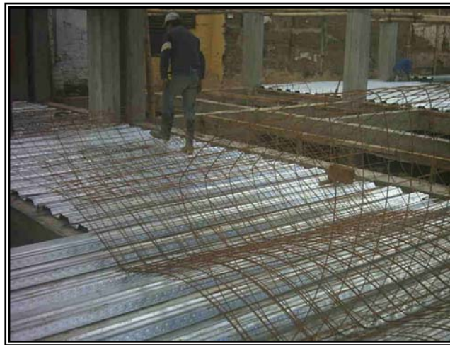
Figura 102. Tendido de la malla electro-soldada.
