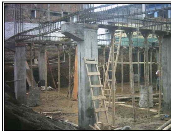
Figura 62. Armado vigas entepiso nivel N+0,00.
