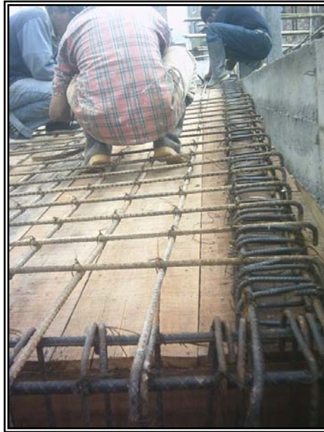
Figura 69. Detalle vigueta longitudinal rampa.
