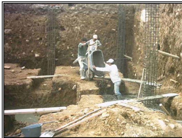
Figura 43. Fundición zapatas (b).
