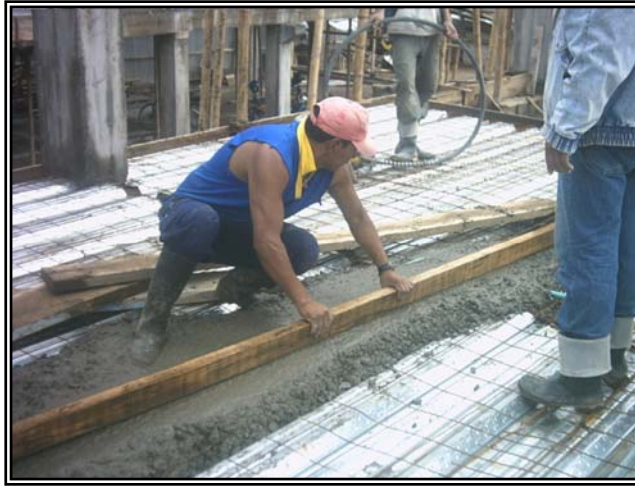
Figura 110. Tallado del concreto losa nivel N+0,00.
