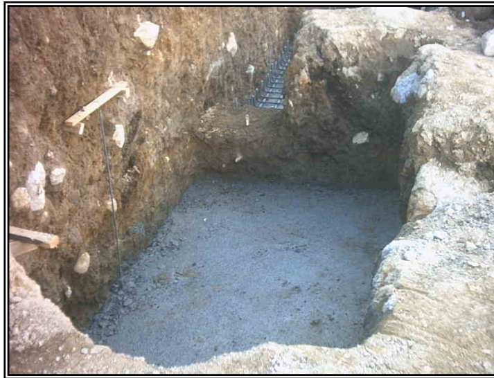
Figura 38. Solado para zapatas.
