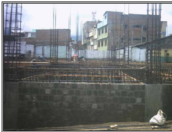
Figura 88. Armado columnas nivel N+0,00 (a).
