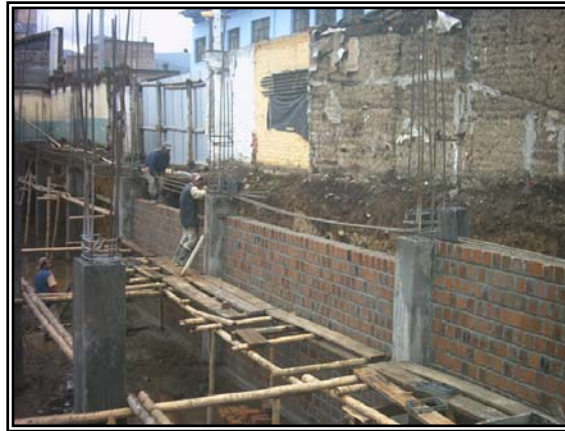
Figura 61. Andamios para vigas entepiso nivel N+0,00.
