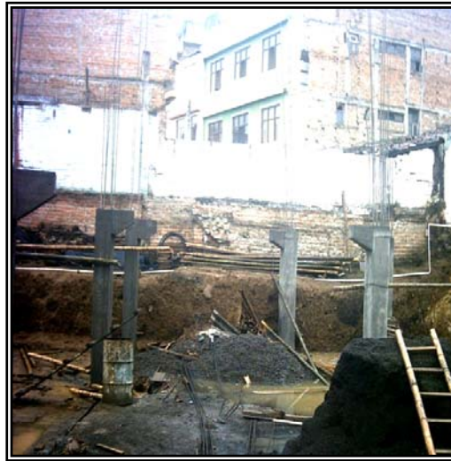
Figura 58. Vista ménsulas tránsito peatonal interno bloques 2 y 3.
