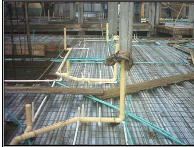
Figura 106. Instalaciones Eléctricas e Hidrosanitarias.
