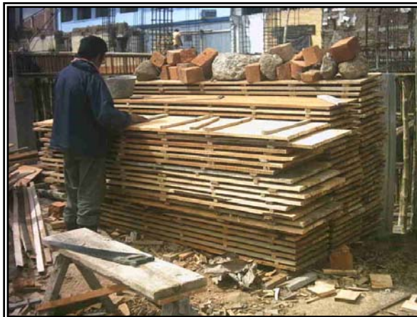
Figura 64. Formaleta para vigas de entrepiso nivel N+0,00.
