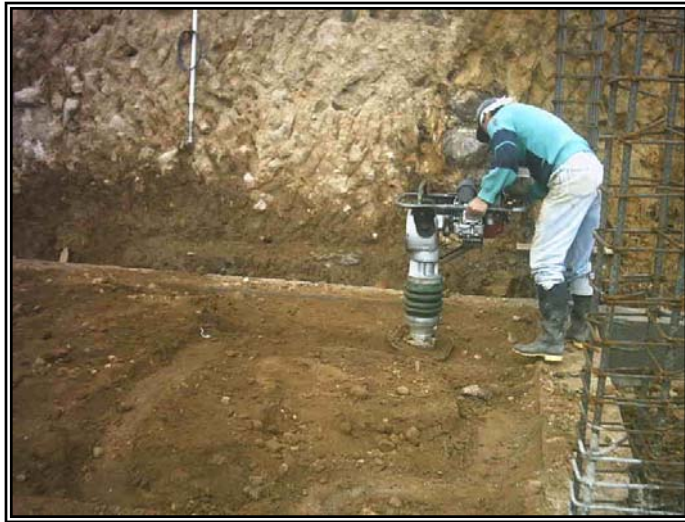
Figura 47. Relleno compactado con saltarín.
