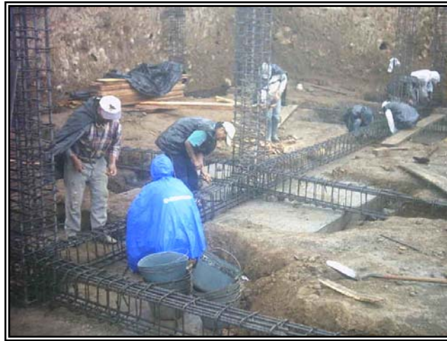
Figura 45. Armado vigas de cimentación.
