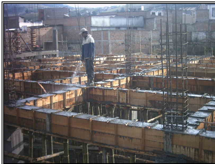
Figura 65. Curado vigas entrepiso nivel N+0,00 bloque 3
