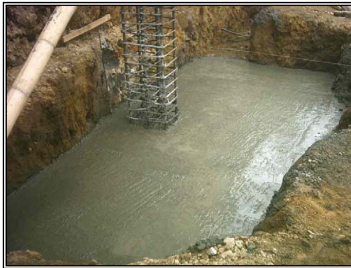
Figura 44. Fundición zapatas (c).
