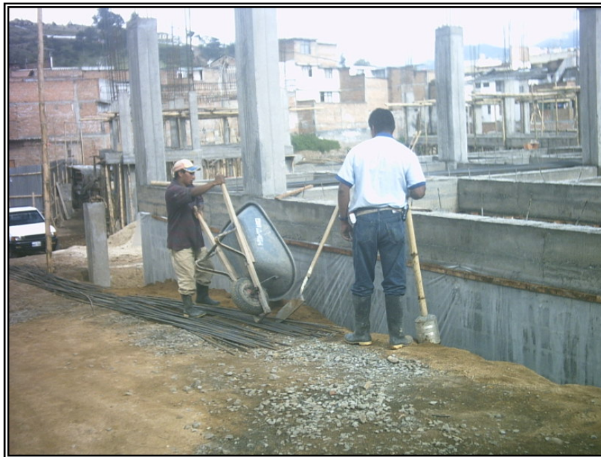
Figura 79. Compactación con pisón de mano bloque 1.
