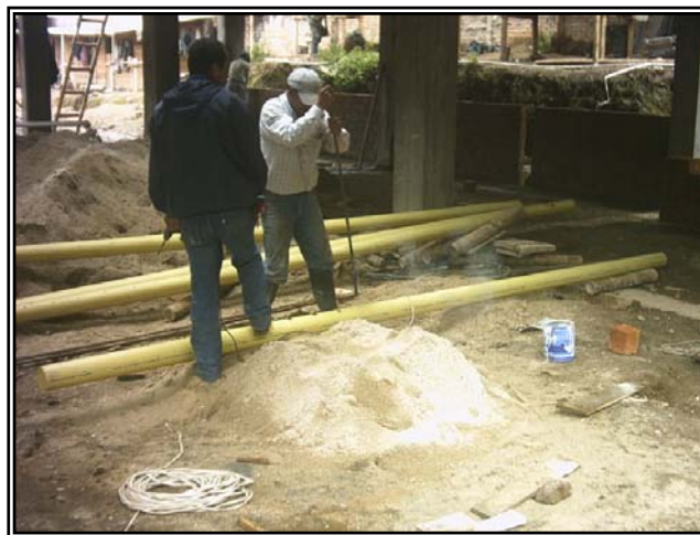
Figura 121. Perforaciones tubería PVC.
