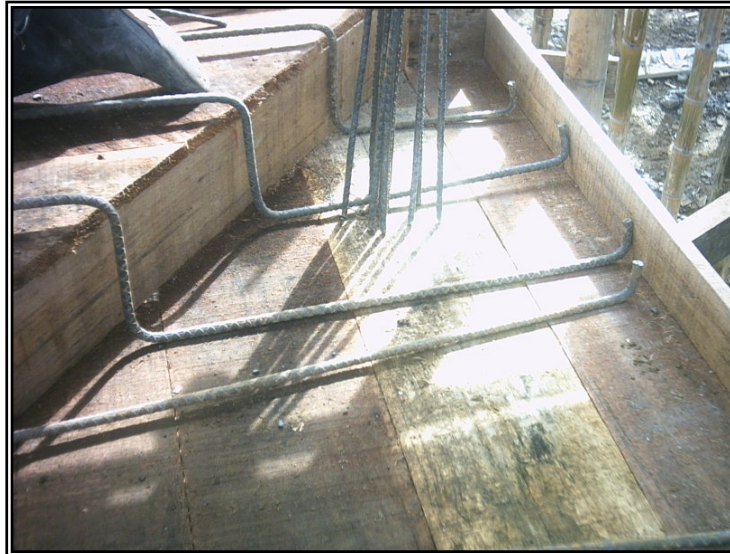
Figura 83. Armado de refuerzo escalera
