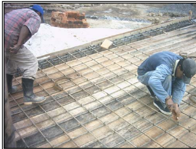
Figura 70. Armado parrilla para rampa de acceso.
