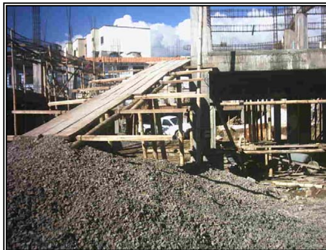
Figura 107. Rampa provisional.
