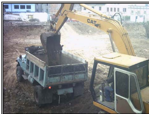
Figura 17. Cargue material de excavación.
