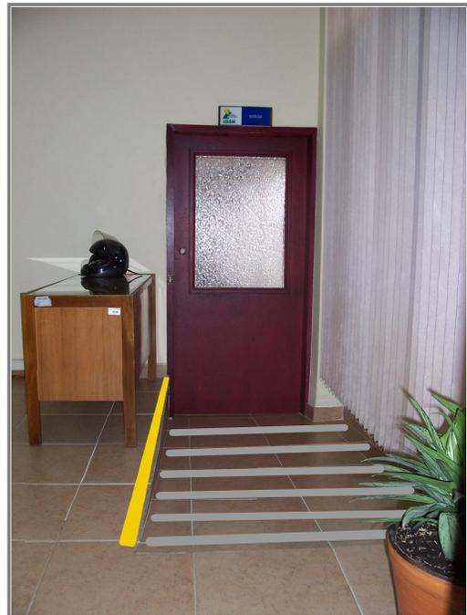
**b) Propuestas realizadas:** Colocar señalización de desnivel y granito antideslizante en la rampa para evitar posibles accidentes que puedan afectar a los empleados que usen este pasaje
