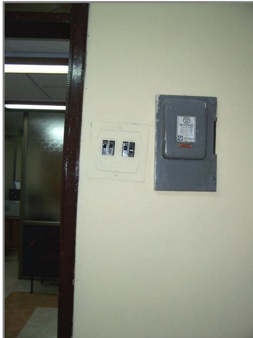
**b) Propuestas realizadas:** Mantenimiento inmediato de la caja de los fusibles para evitar posibles cortos circuitos o incendios, a su vez es necesario colocar la señalización pertinente para su ubicación
