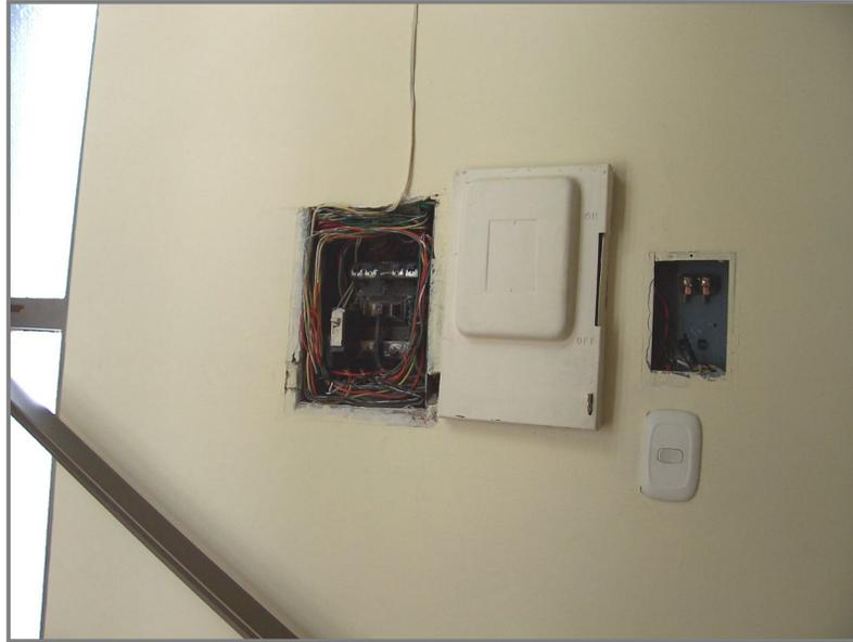
Figura 97: Caja de fusibles de escaleras del cuarto piso
