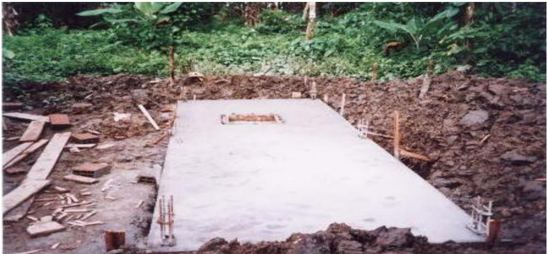
**1.2.26 Torre para Tanques.** Esta se hizo con 2 zapatas de 1.0 x 1.0 x 0.4 m con hierro de 1/2 " cada 0.20 m en ambos sentidos; 2 columnas de 0.30 x 0.30 m con 4 varillas de 1/2 " y estribos el primero a 0.05 m, luego en los nudos en una distancia de 1.0 m se colocaron estribos cada 0.10 m y en el resto de la longitud cada 0.15 m, las viga de cimentación y aéreas son de 0.30 x 0.30 m con la misma distribución de hierro que las columnas.
