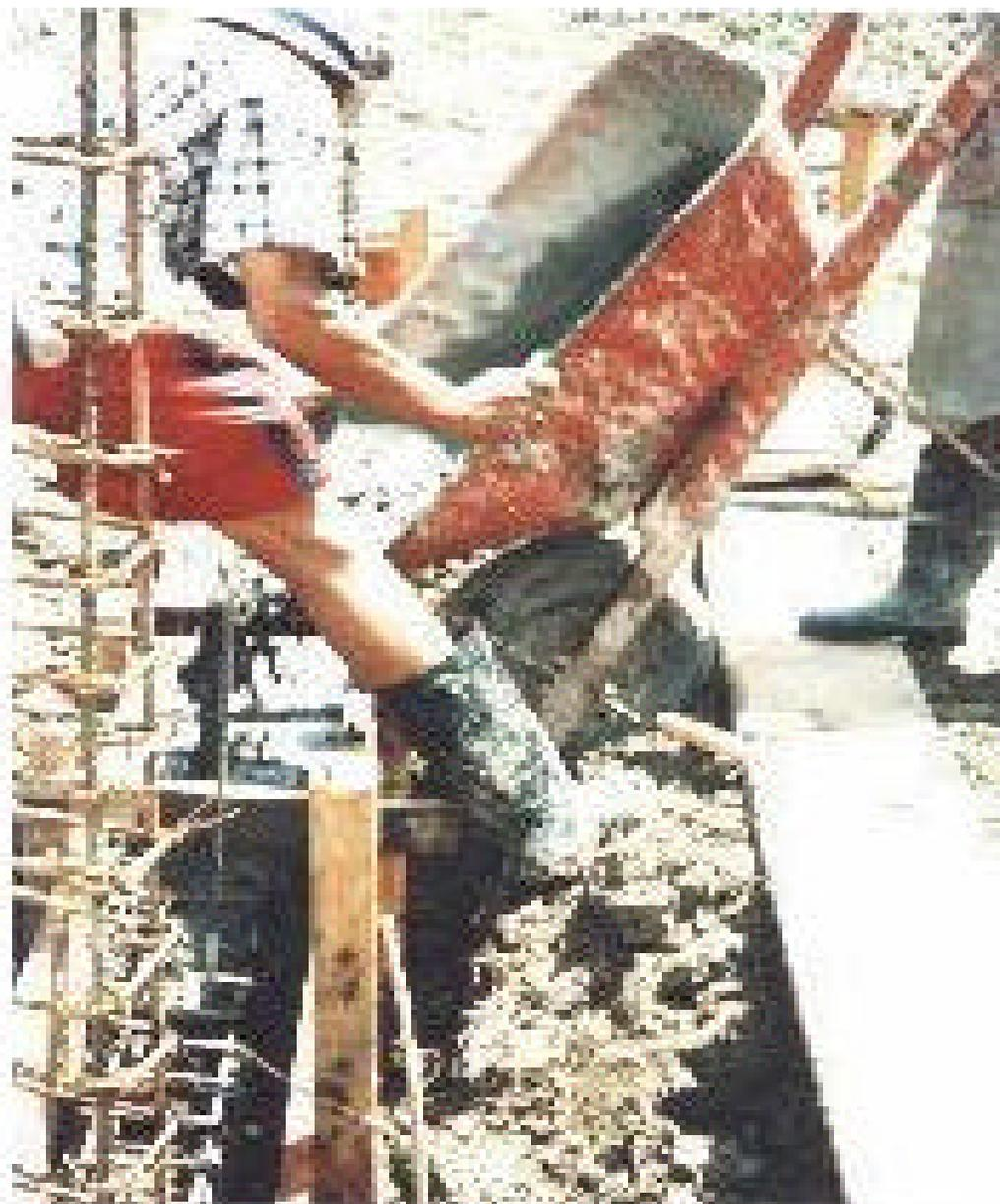
**1.2.6.3 Vigas de Cimentación Fundidas (0.30 x 0.30) m.** Como se observa en las figuras las vigas se fundieron en su totalidad correspondiente al modulo 1.
