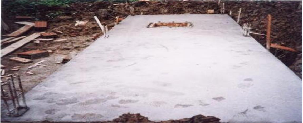
**Figura 48. Pozo Séptico Fundido (6.0 X 2.0 X 1.5) m**
