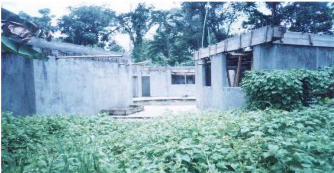
**1.2.31 Vigas Aéreas Fundidas (0.30 X 0.30) m** Se fundieron todas las vigas aéreas utilizando concreto con la misma especificación técnica que se utilizó en la fundición de las otras obras descritas anteriormente.
