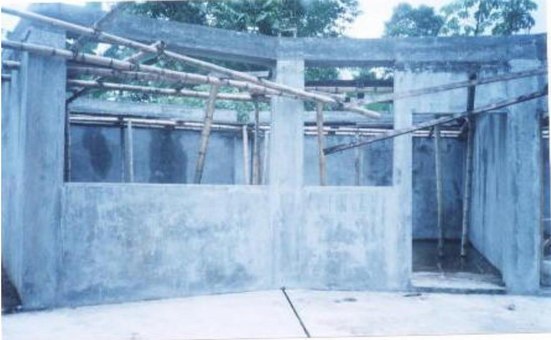
**1.2.30 Encofrado Vigas Aéreas (0.30 x 0.30) m.** Las formaletas se hicieron con madera nueva y se procedió a formaletear como se observa en la figura 54.
