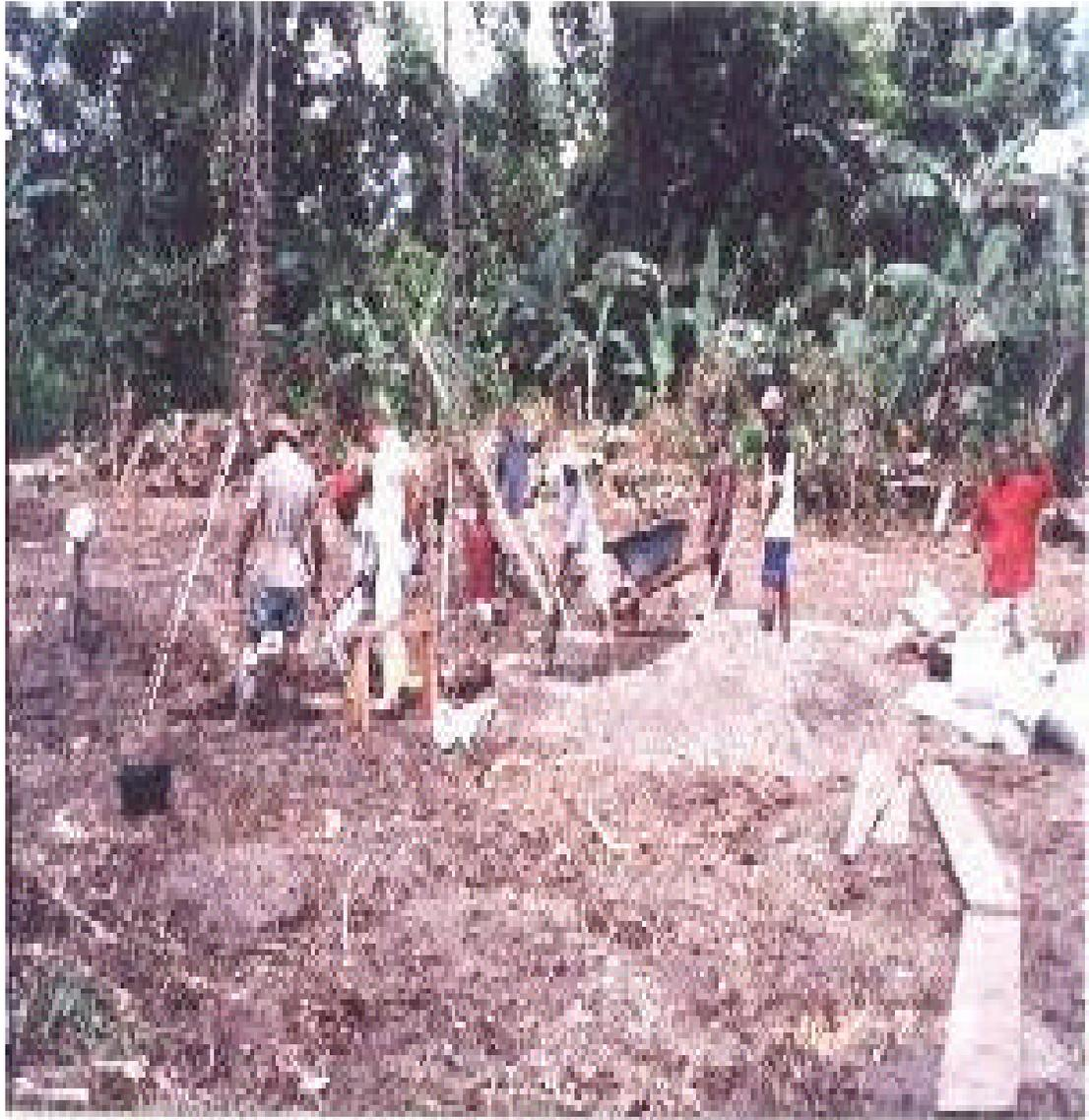
**1.2.5.1 Fundición Zapatas (1.0 x 1.0 x 0.4) m** El proceso de fundición se realizo así: se le agrego una capa de material río (mixto), se fundió un solado de 0.10 m, posteriormente se coloco la parrilla y se amarro con el castillo de la columna, por ultimo se realizo la fundición de la zapata en concreto .
