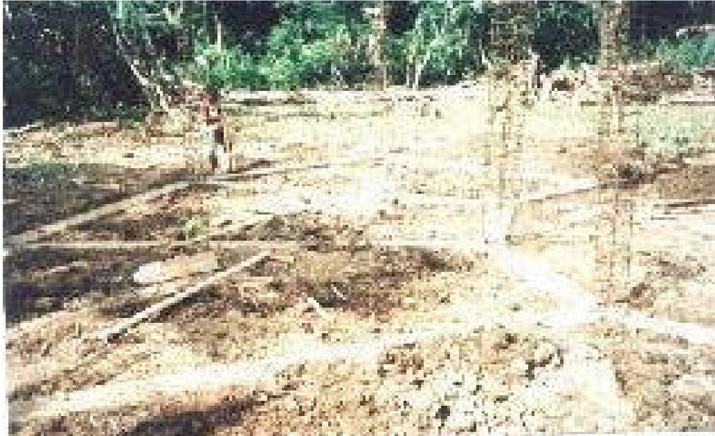
**Figura 13. Vigas de Cimentación Fundidas (0.30 x 0.30) m**
