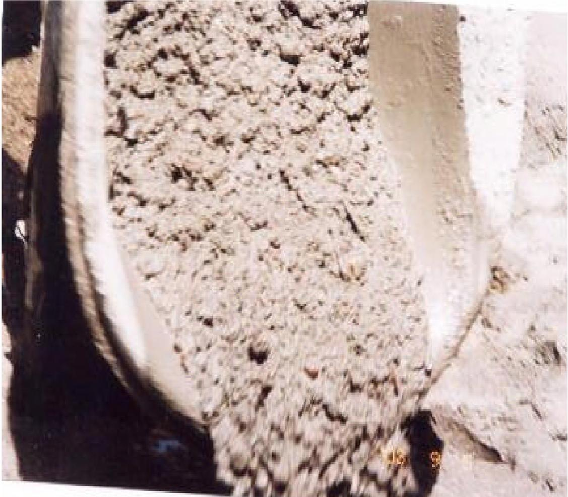
**1.2.19 Fundición Pisos de las Aulas y la Dirección.** Se hizo el retiro de las raíces de los árboles cortados, se excavo 0.30 m y se relleno con material, se apisono bien y se le echo una capa de material mixto como se ve en la figura; luego se procedió a fundir el piso con la misma especificación del concreto utilizado anteriormente, el espesor de este piso fue de 0.10 m.
