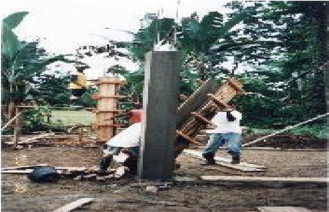
**1.2.9.3 Columnas Fundidas.** Se puede apreciar las columnas fundidas con una superficie lisa, estas tienen unas dimensiones de 0.30 x 0.30 m y 2.70 m de alto.
