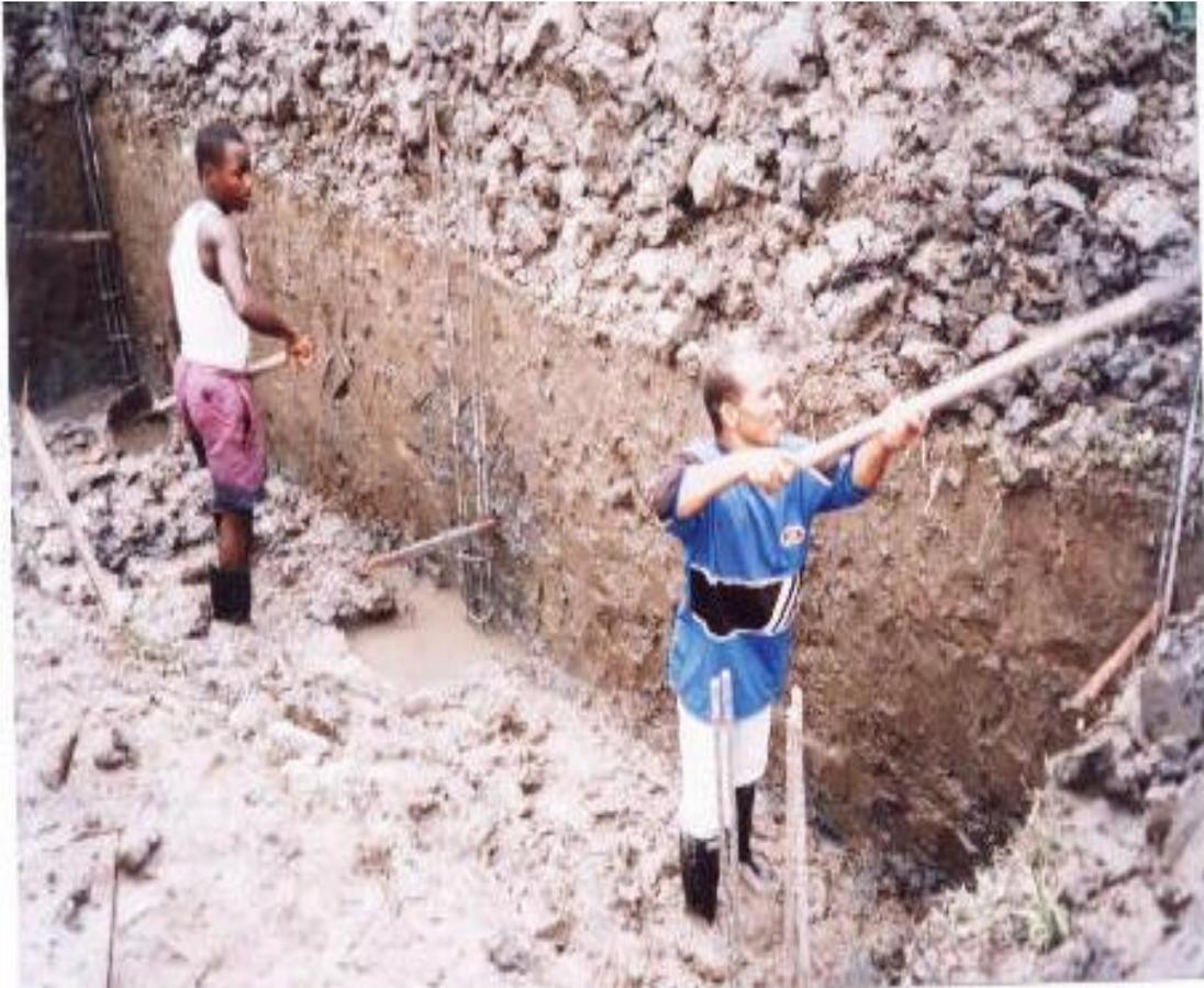
**1.2.25 Pozo Séptico Fundido (6.0 X 2.0 X 1.5) m.** El diseño del pozo fue cambiado por decisión de la Interventoría, en vez de utilizar tanques plásticos se hará un pozo en concreto conservando las dimensiones de este.
