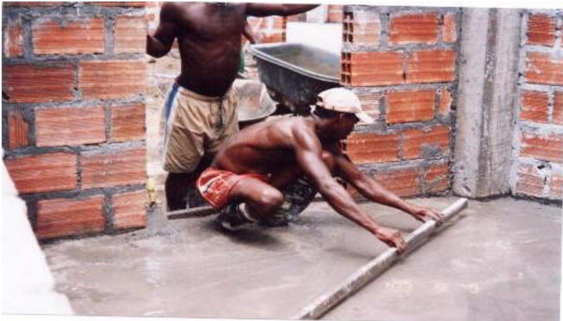
**1.2.21 Fundición Andenes.** Estos andenes son de forma circular como lo muestra el diseño del proyecto, la fundición se realizo con concreto de la misma especificación de los anteriores.
