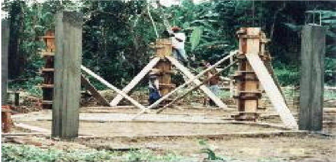
**Figura 20. Fundición de Columnas (0.30 x 0.30) m**
