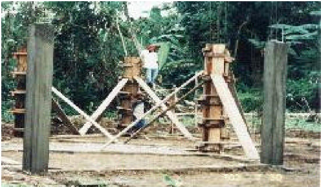
**1.2.9.2 Desencofrado de Columnas.** Se retiraban las formaletas al siguiente día de fundir el concreto, con estas mismas se encofraban las demás para volver a repetir el proceso de fundición.
