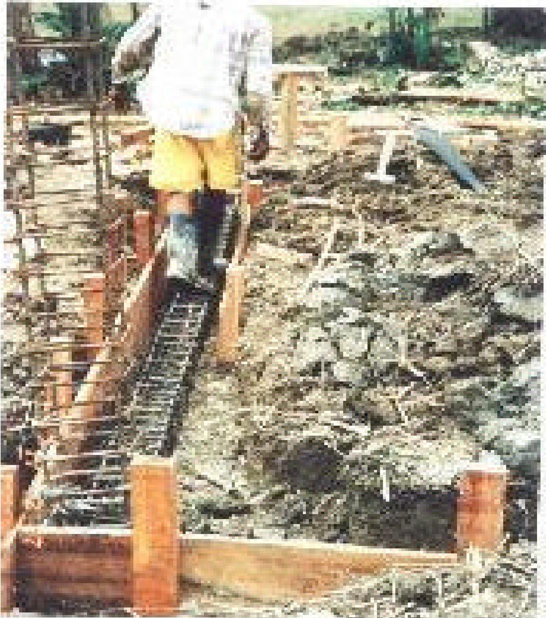
**1.2.6.2 Fundición Vigas de Cimentación Modulo 1 (0.30 x 0.30) m.** La fundición de estas vigas se hizo con concreto que se preparo al 2:1, dos carretadas de material mixto (balastro) y un bulto de cemento gris, se le agregaba 3 baldes de agua.
