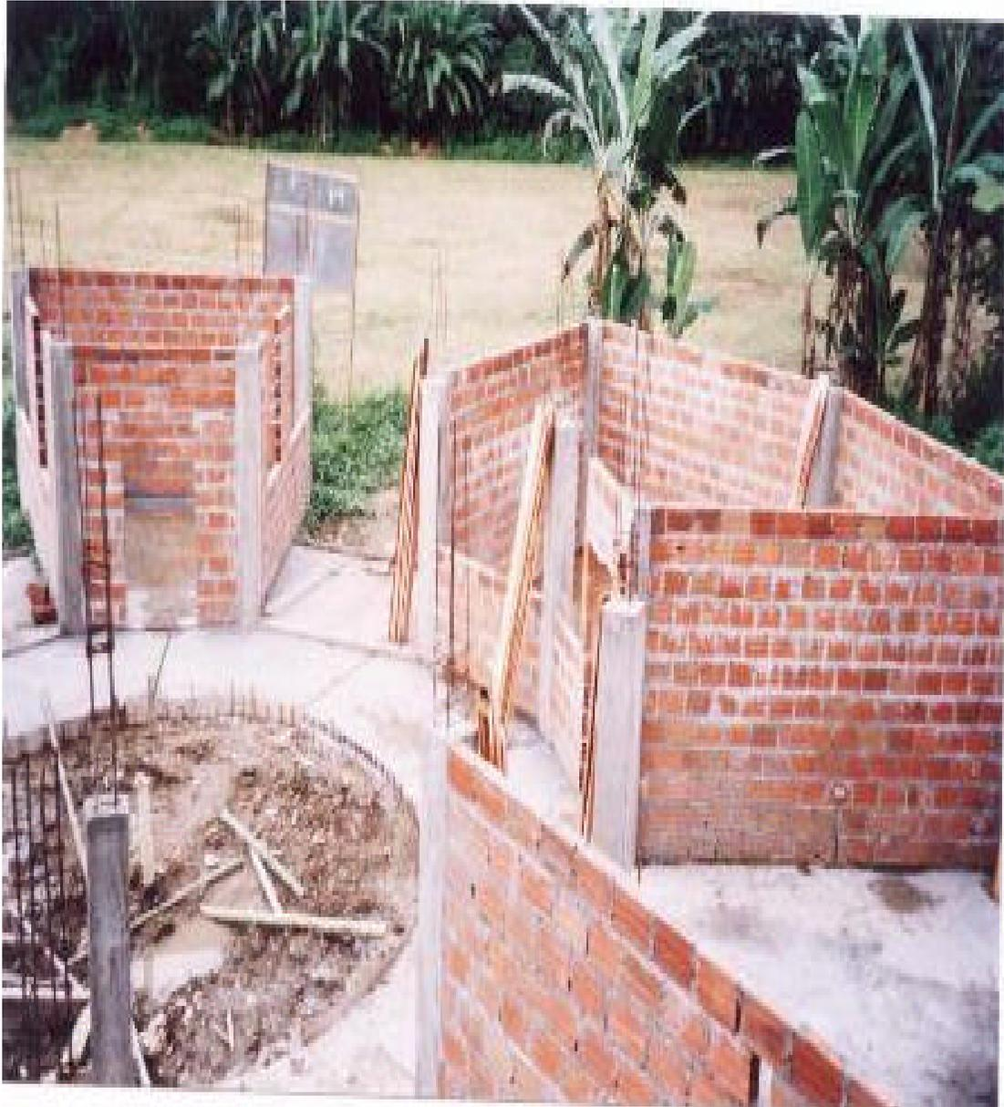
**1.2.24 Excavación Pozo Séptico (6.0 X 2.0 X 1.5) m.** Esta excavación se llevo a cabo en un terreno barroso como se puede observar en la figura, a 1,20 m de profundidad empezó a salir agua en el hueco.
