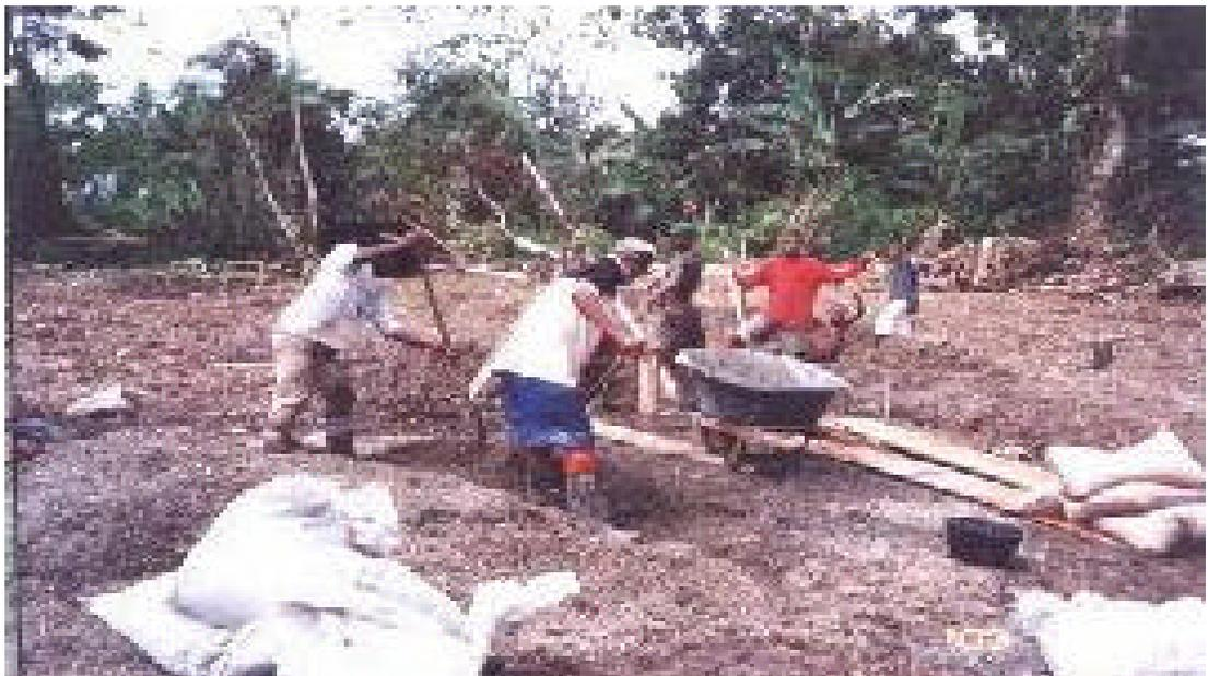
**1.2.6 Excavación Vigas de Cimentación Modulo 1.** Se procedió a realizar la excavación de las vigas de cimentación del modulo 1, esta tenia 0.45 m de ancho por 0.40 m de profundidad, se apisonaba el terreno hasta que tuviera listo sin altibajos para poder formaletear.
