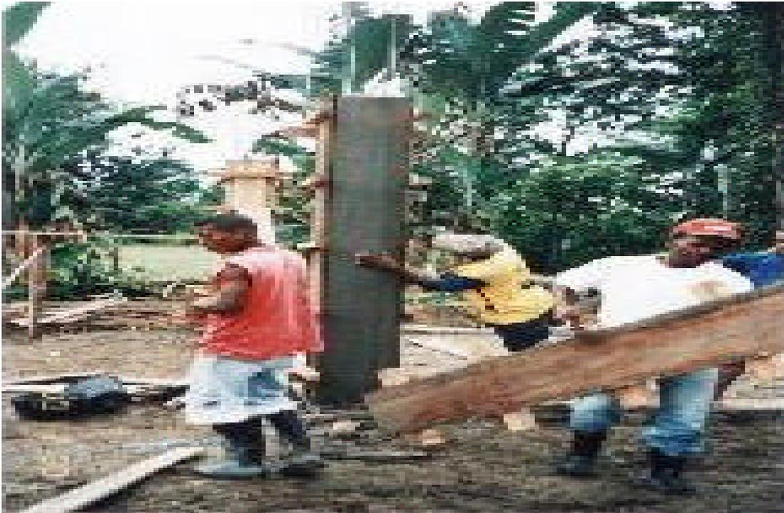
**Figura 22. Desencofrado de Columnas**
