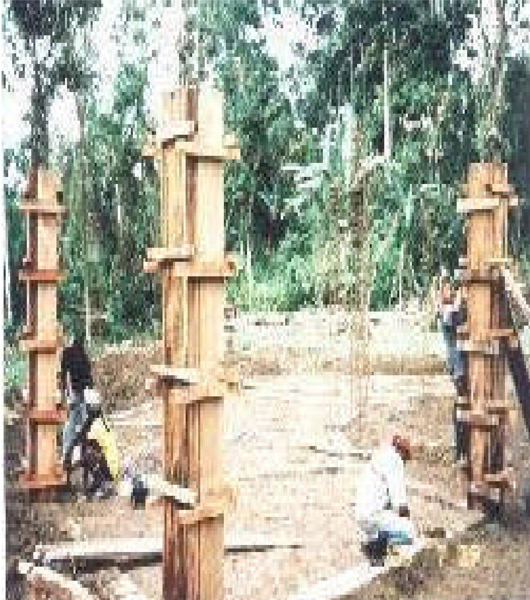
**1.2.9.1 Fundición de Columnas (0.30 x 0.30) m.** Se aplomaron las columnas y se procedió a fundirlas; cabe destacar que se forraron las formaletas con triple por la parte interior lo que permitió que la superficie quedara lisa. A medida que se vacía el concreto, se golpea la formaleta con un martillo para evitar que las columnas queden con hormigueros.
