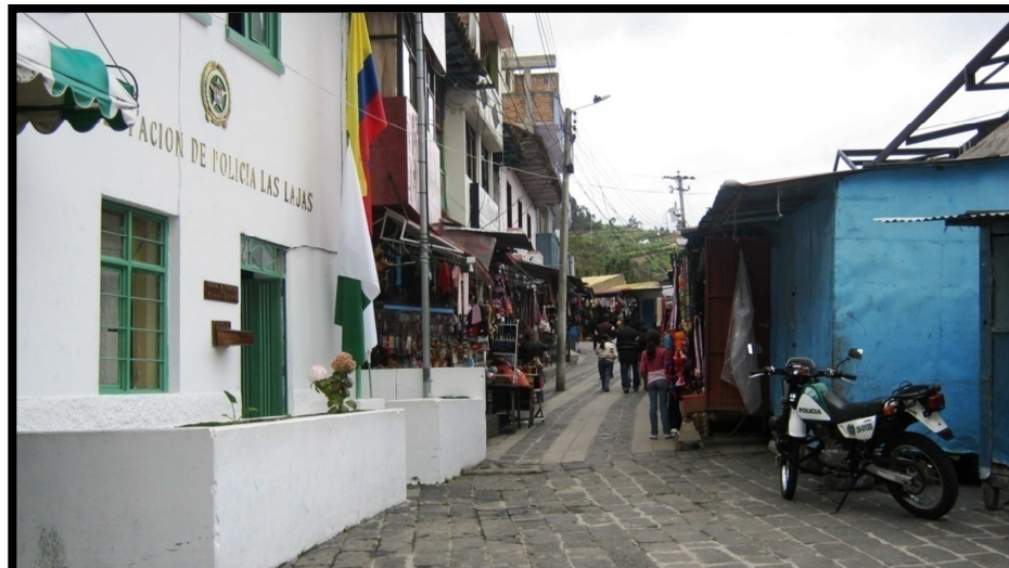
FOTO N°29 : Equipamiento. Infraestructuras inadecuadas. FUENTE: Trabajo de Campo.
