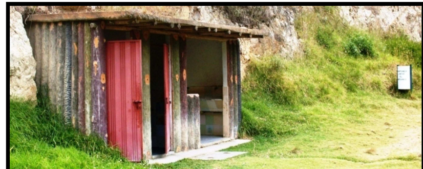
FOTO N° 2: Baterías sanitarias. Deterioro de la Imagen. FUENTE: Trabajo de campo
