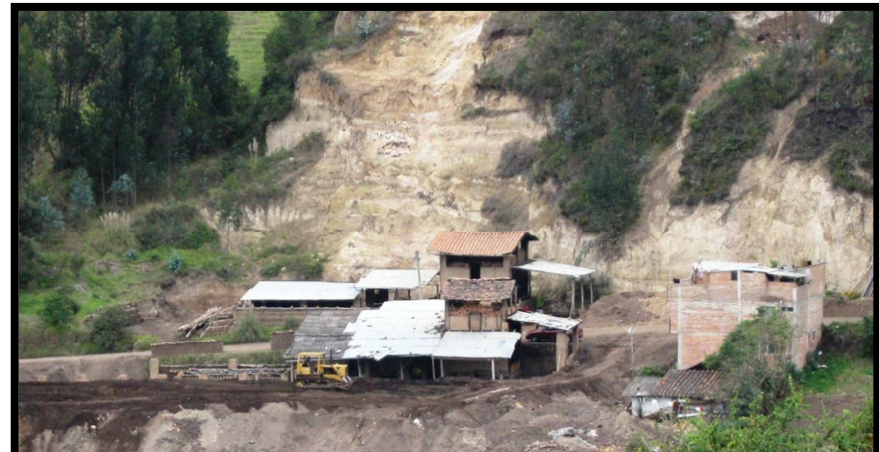
FOTO N°25 : Ladrilleras. Corredor. FUENTE: Trabajo de Campo.
