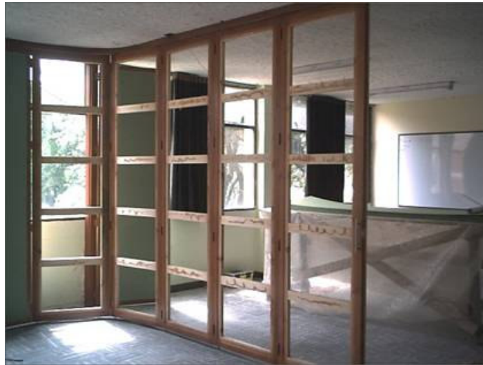
Figura 58. Armazón de la puerta
