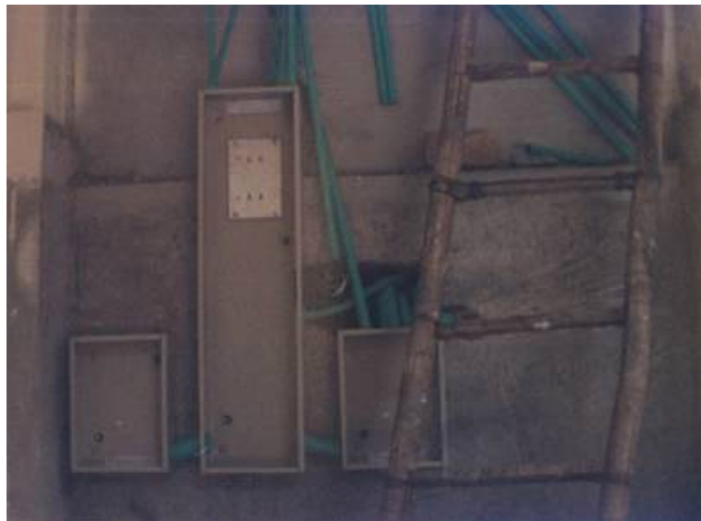
Figura 25. Tubería eléctrica existente
