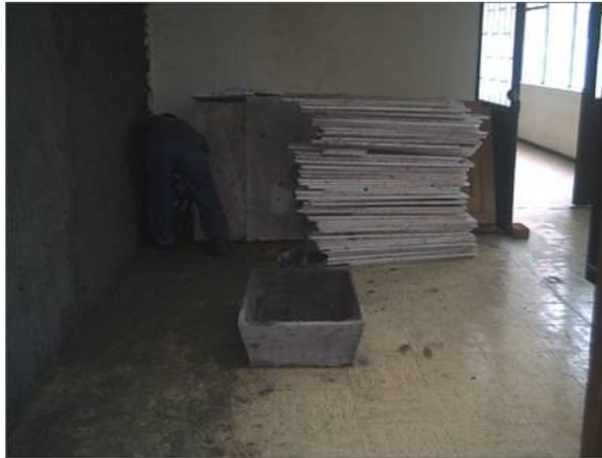
Figura 46. Apilamiento de paneles de icopor
