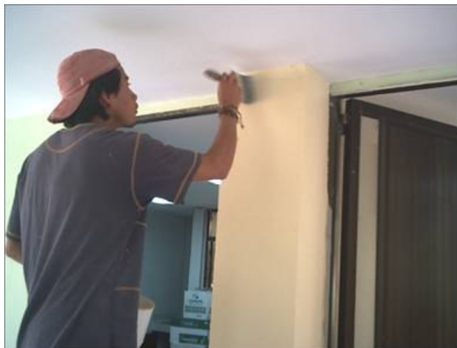
Figura 66. Aplicación de pintura sobre muros
