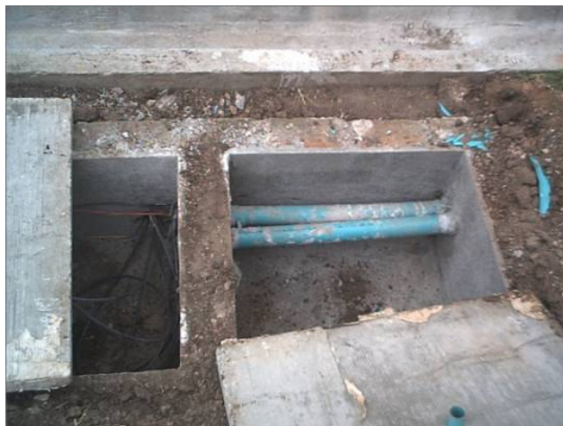
Figura 34. Caja de paso en mampostería
