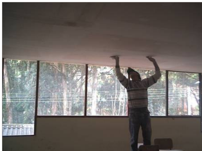
Figura 56. Lijado de la superficie
