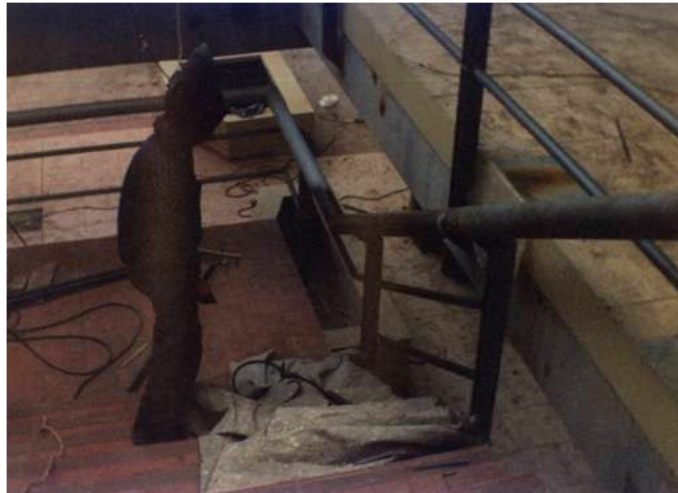
Figura 14. Instalación de pasamanos
