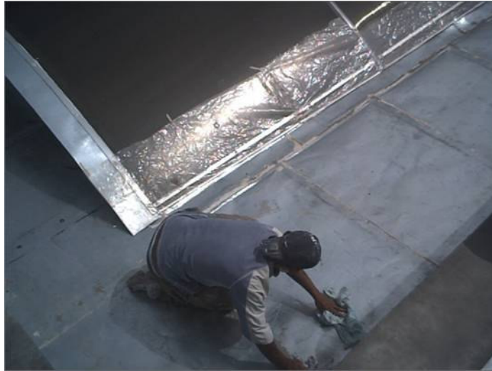
Figura 22. Limpieza de la canaleta
