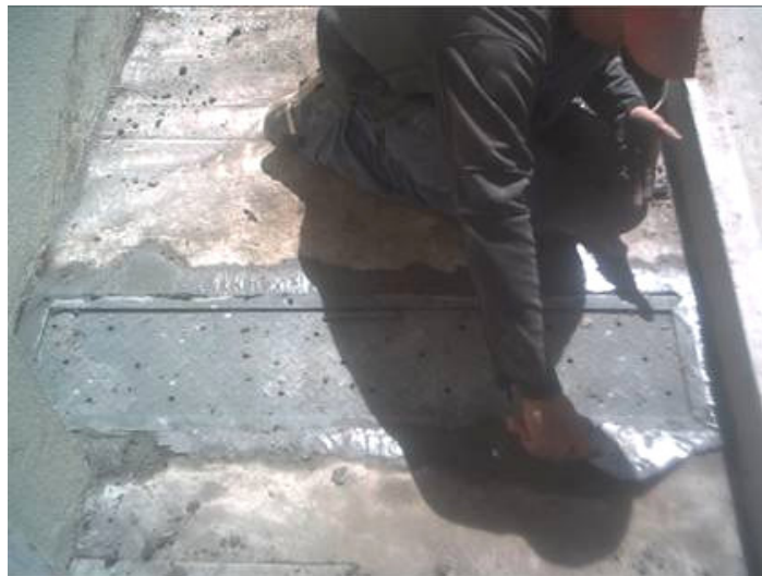
Figura 42. Colocación de tapas en las cajas de captación
