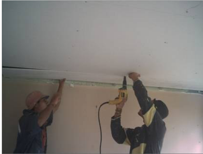
Figura 63. Atornillado de las placas de yeso
