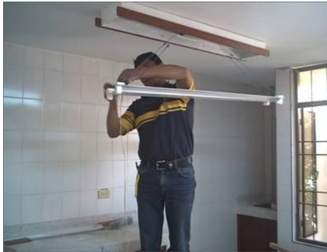
Figura 65. Colocación de lámparas
