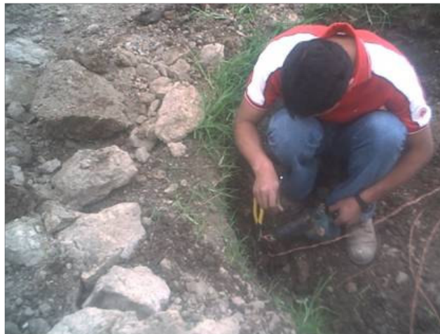
Figura 32. Aplicación de soldadura de estaño
