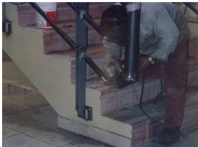
Figura 15. Masillado y pulido del pasamanos
