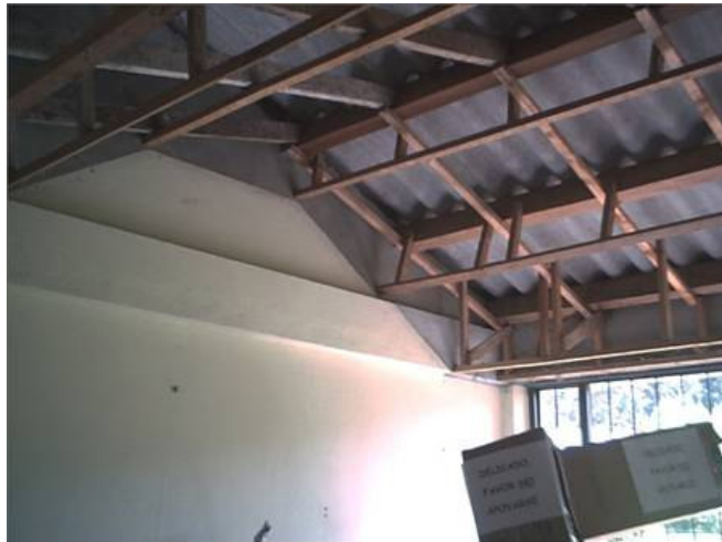
Figura 60. Desmonte del cielo raso existente
