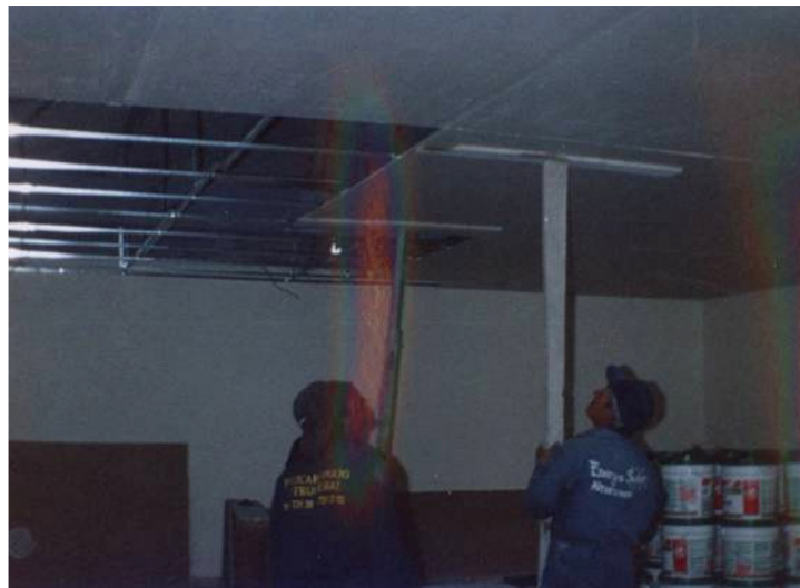
Figura 18. Ubicación de las placas de yeso
