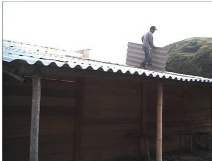
Figura 35. Desmote de la cubierta.
