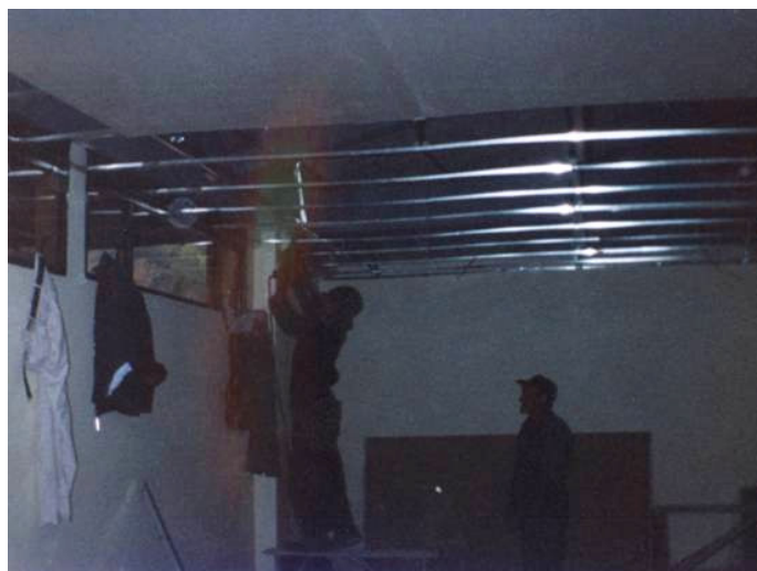
Figura 17. Estructura metálica de soporte
