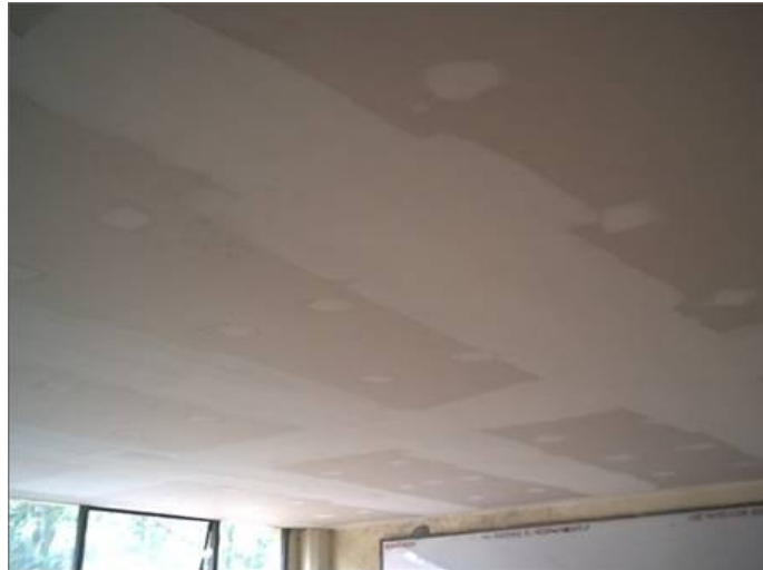
Figura 55. Sellamiento de juntas
