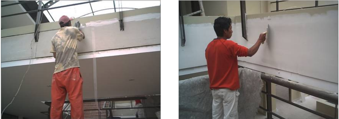
Figura 21. Encintado y masillado con productos plásticos en los remates y juntas
