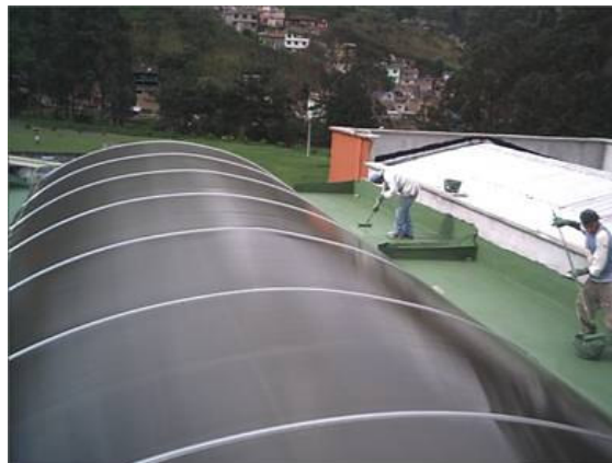
Figura 24. Aplicación del impermeabilizante
