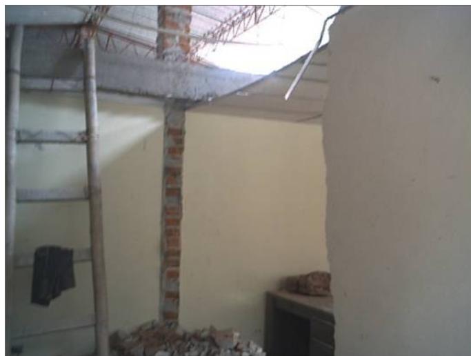
Figura 47. Demolición de muro
