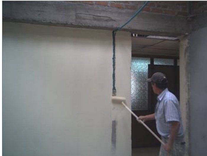
Figura 50. Pintura de muros
