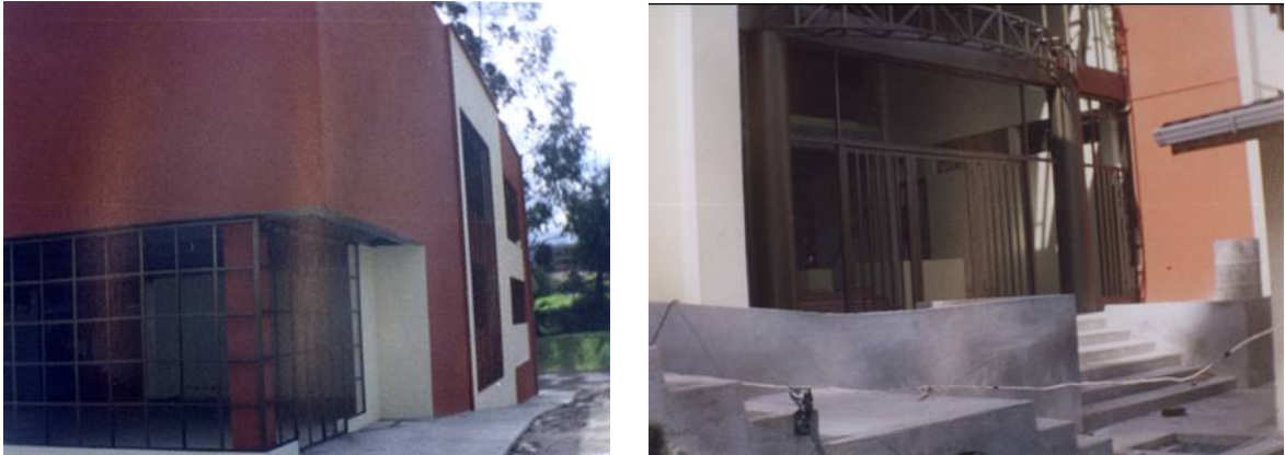
Figura 11. Muros exteriores y carpintería metálica existentes
