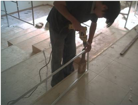
Figura 40. Instalación de marcos en el cielo falso
