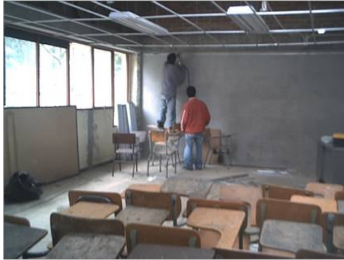
Figura 51. Nivelación de la estructura de soporte
