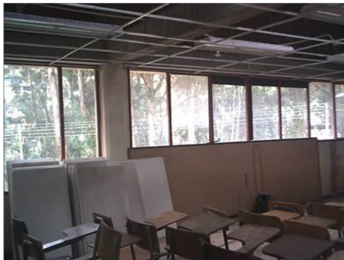
Figura 45. Retiro total de paneles de icopor
