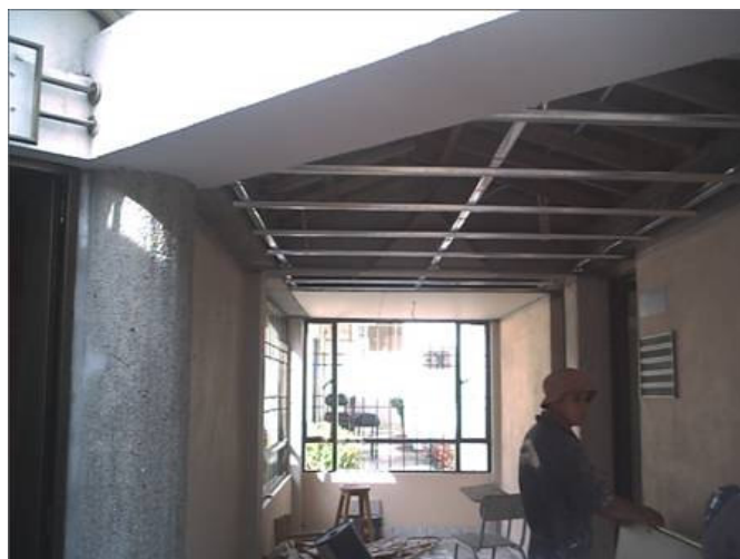
Figura 61. Estructura metálica de soporte
