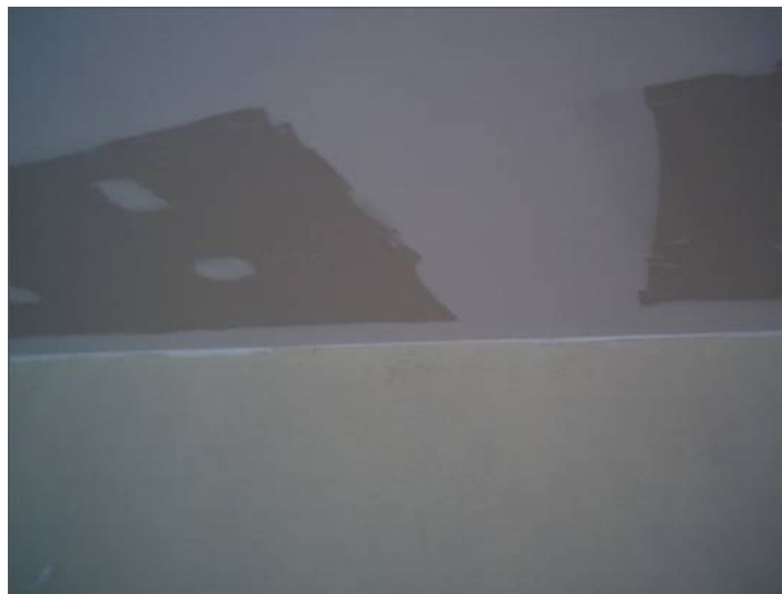
Figura 19. Masillado y encintado
