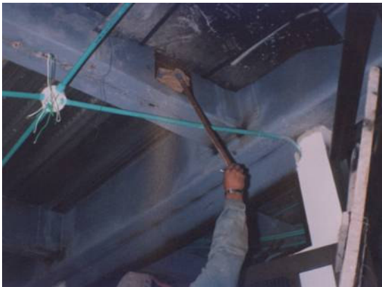
Figura 38. Secado interno con fuego
