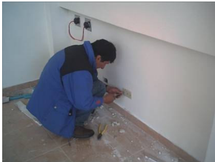
Figura 28. Instalación de aparatos eléctricos
