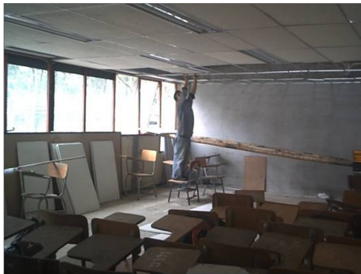
Figura 52. Reacomodamiento de paneles de icopor
