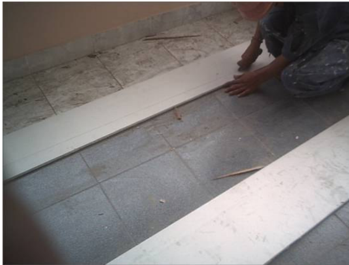
Figura 62. Recorte de las placas de yeso
