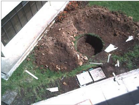
Figura 29. Excavación y ubicación de las varillas
