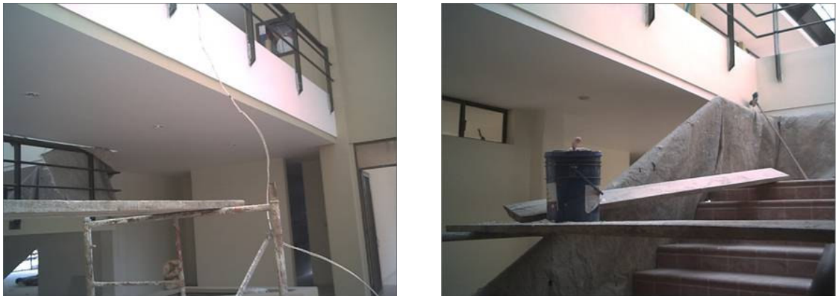
Figura 20. Sitios de instalación del sistema superboard
