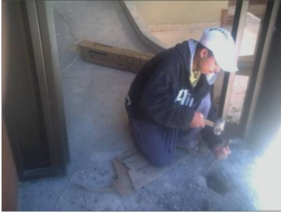
Figura 41. Corte y retiro de piso
