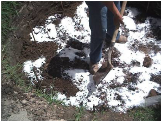
Figura 30. Relleno de la excavación
