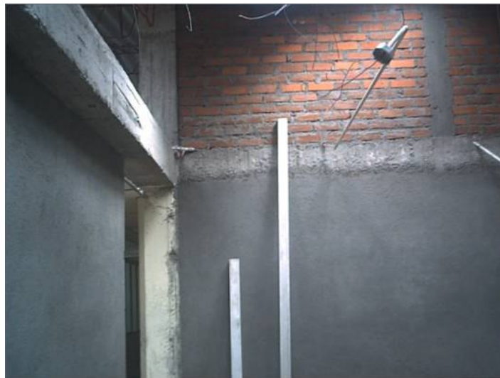
Figura 48. Construcción de tímpanos
