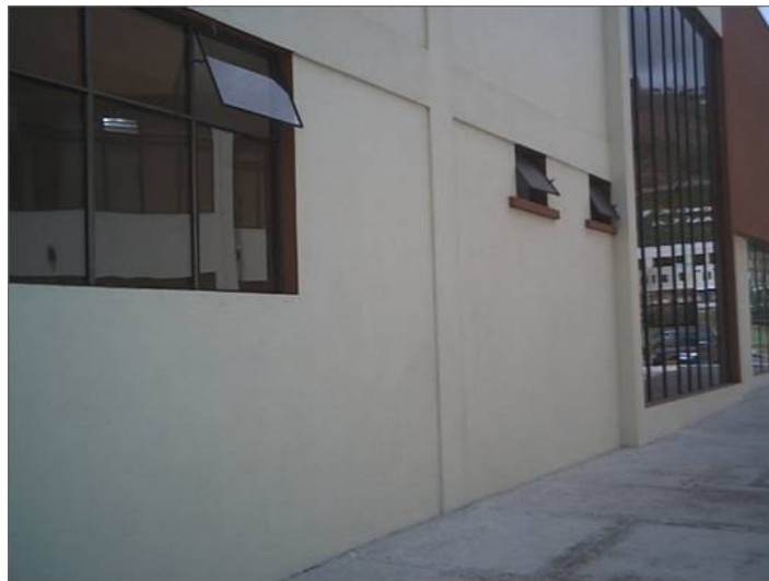
Figura 16. Colocación de vidrios
