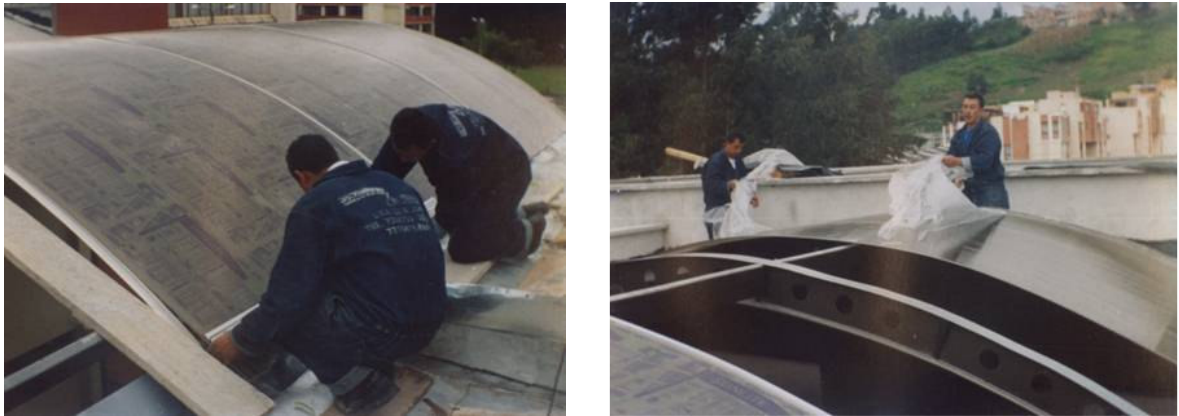
Figura 13. Ubicación de las láminas y retiro del plástico de protección
