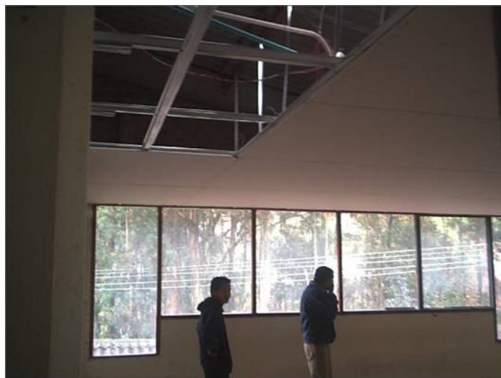
Figura 53. Estructura metálica de soporte y colocación de paneles
