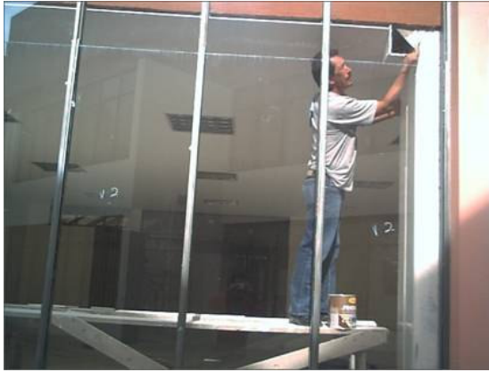
Figura 43. Retoques en la pintura y arreglo de filos
