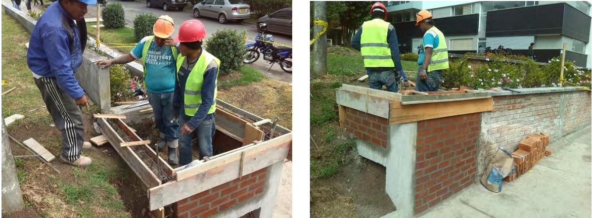
Figura 2.13. Muro en ladrillo común.
