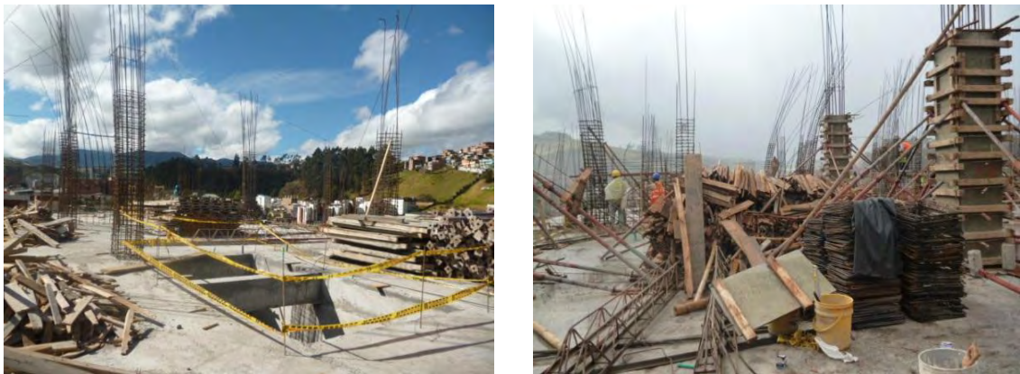
Figura 3.4. Figurado y encofrado para pantallas y columnas.
