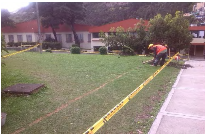
Figura 2.6. Localización y replanteo.
