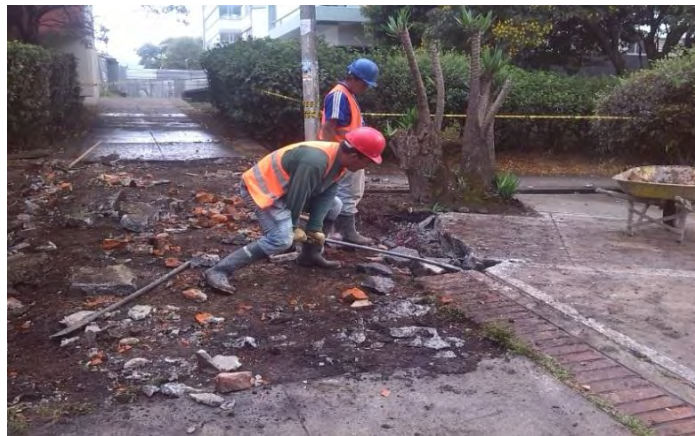
Figura 2.8. Demolición de andenes y placas en el bloque de Medicina.
