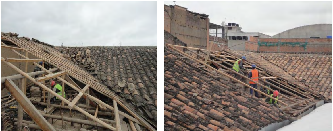
Figura 1.15. Instalación de teja de barro.
