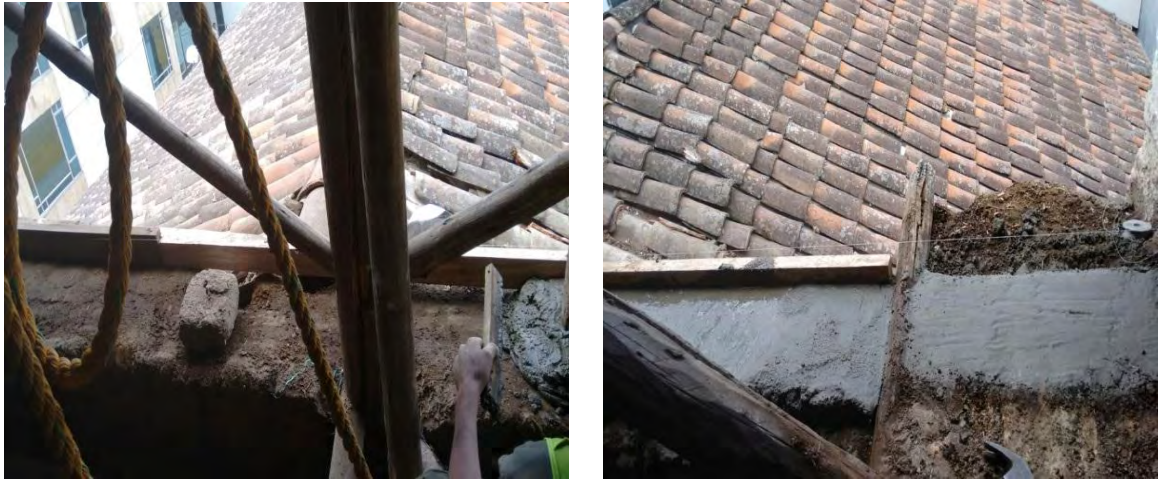
Figura 1.35. Placa 10 cm en concreto.
