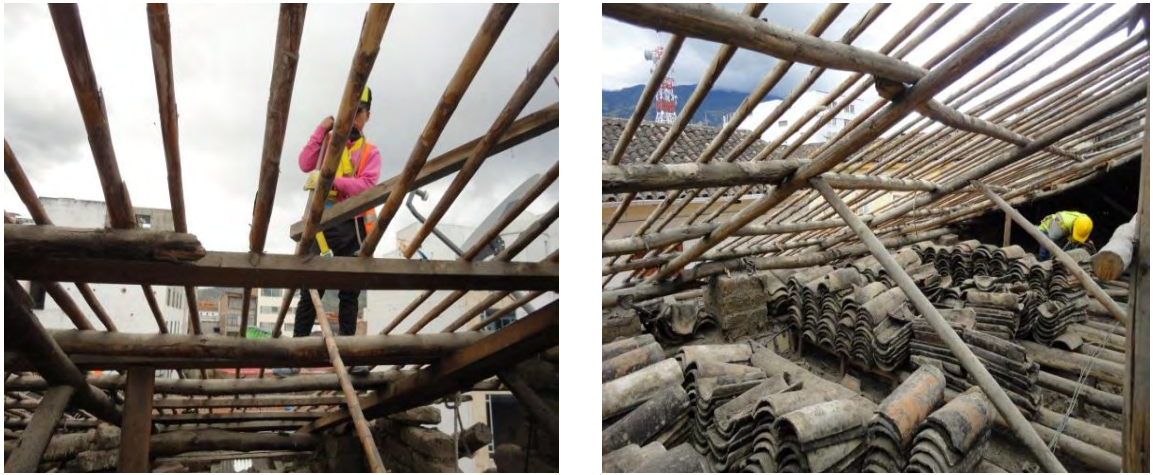
Figura 1.23. Colocación de caña brava.
