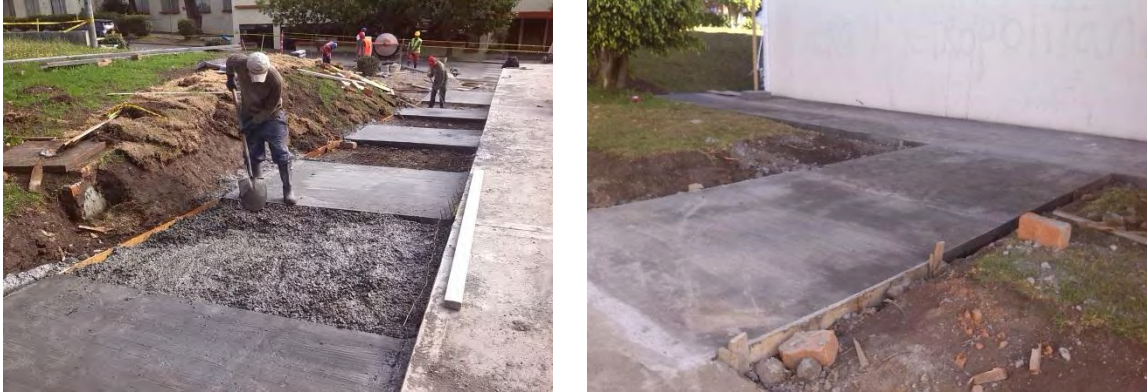
Figura 2.17. Losa en concreto.
