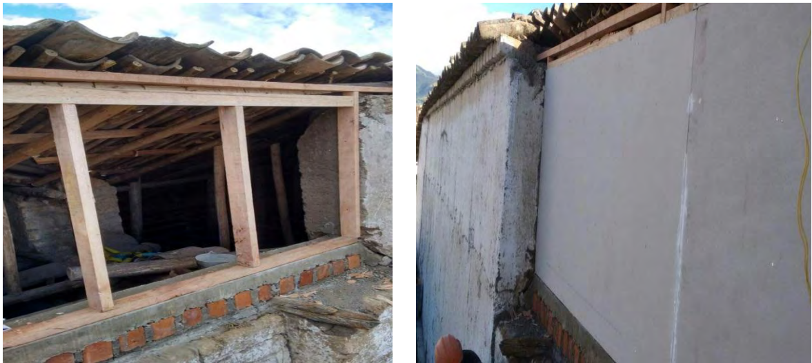
Figura 1.36. Muro en fibrocemento.
