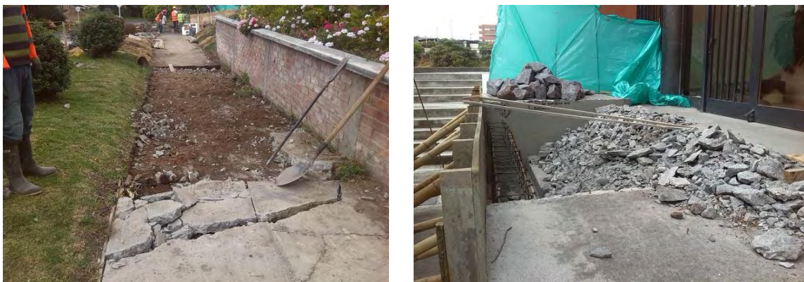
Figura 2.16. Demolición de andenes y placa.
