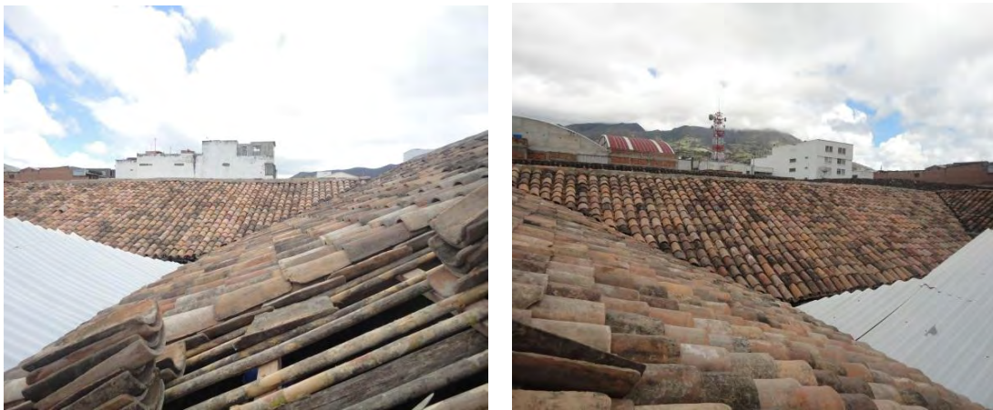
Figura 1.16. Teja de barro subida e instalada.
