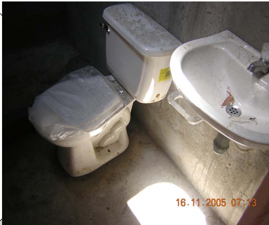
INSTALACION DE COMBO SANITARIO
