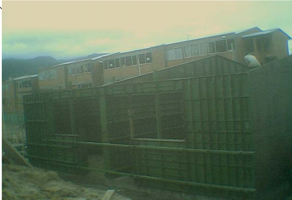
FORMALETA METALICA UTILIZADA EN VIVIENDAS TIPO I
