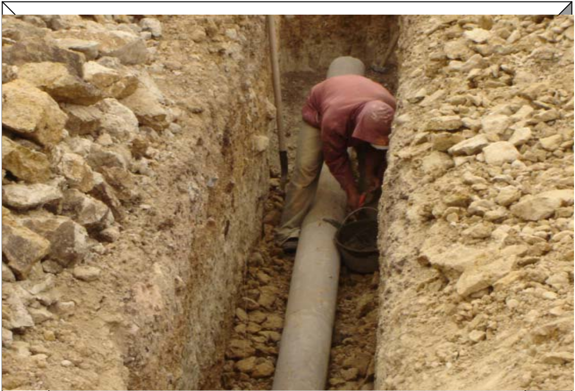
INSTALACION DE TUBERIA DE 6" PARA ACOMETIDA DE ALCANTARILLADO
