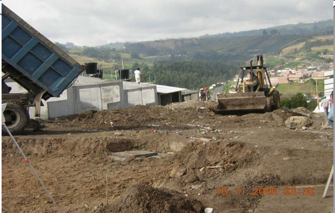
DESALOJO DE MATERIAL EN LAS VIAS INTERNAS
