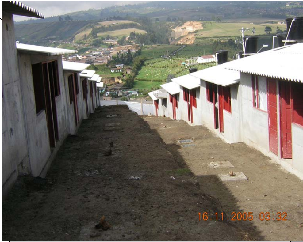
PATIOS CONFORMADOS CON CAJILLAS DESARENADORAS.
