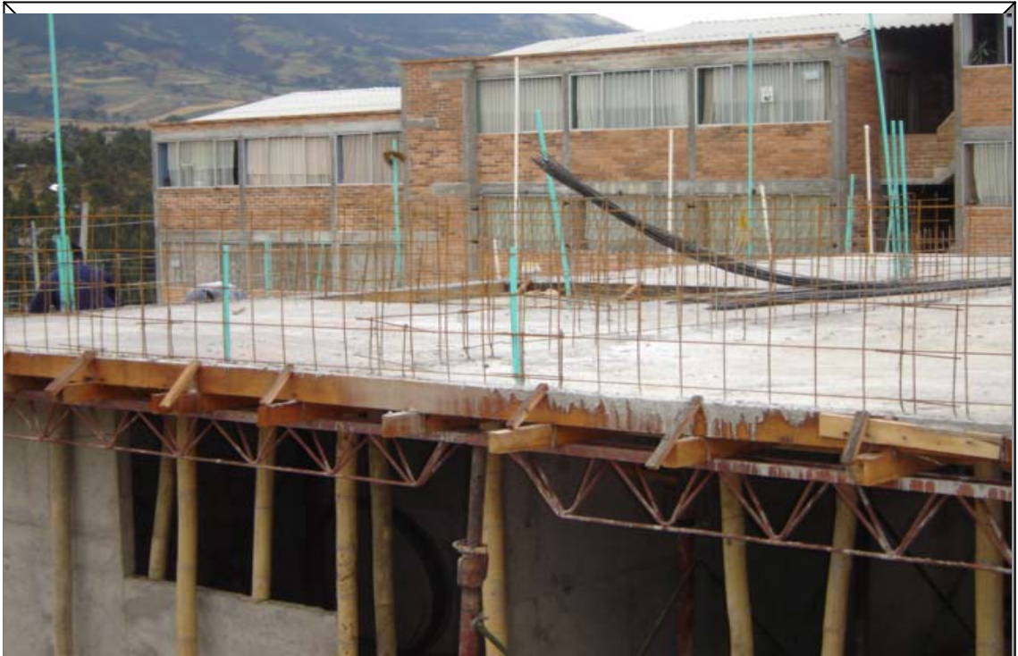
LOSA DE ENTREPISO, CON DOVELA DE ARRANQUE PARA MUROS DE SEGUNDO PISO
