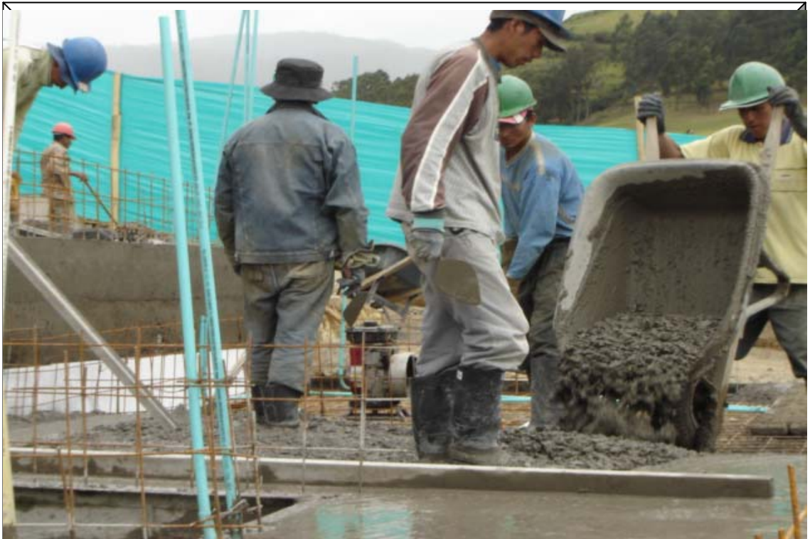
FUNDICION DE CIMENTACION
