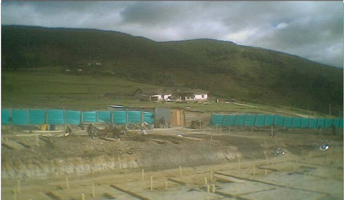
EXCAVACION PARA INSTALAR TUBERIA SANITARIA
