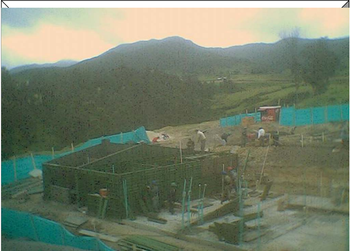
COLOCACION DE LA FORMALETA METALICA EN EL MODULO.
