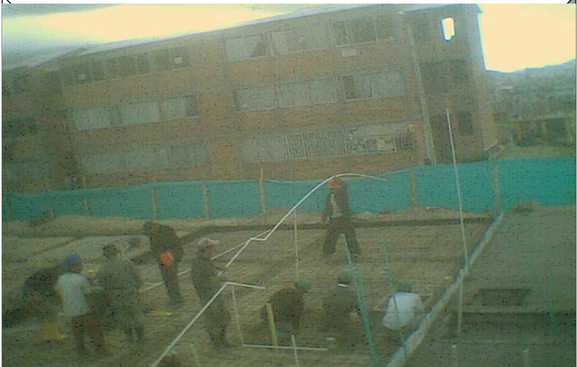
INSTALACION DE TUBERIA PVC 1/2" Y TUBERIA CONDUIT
