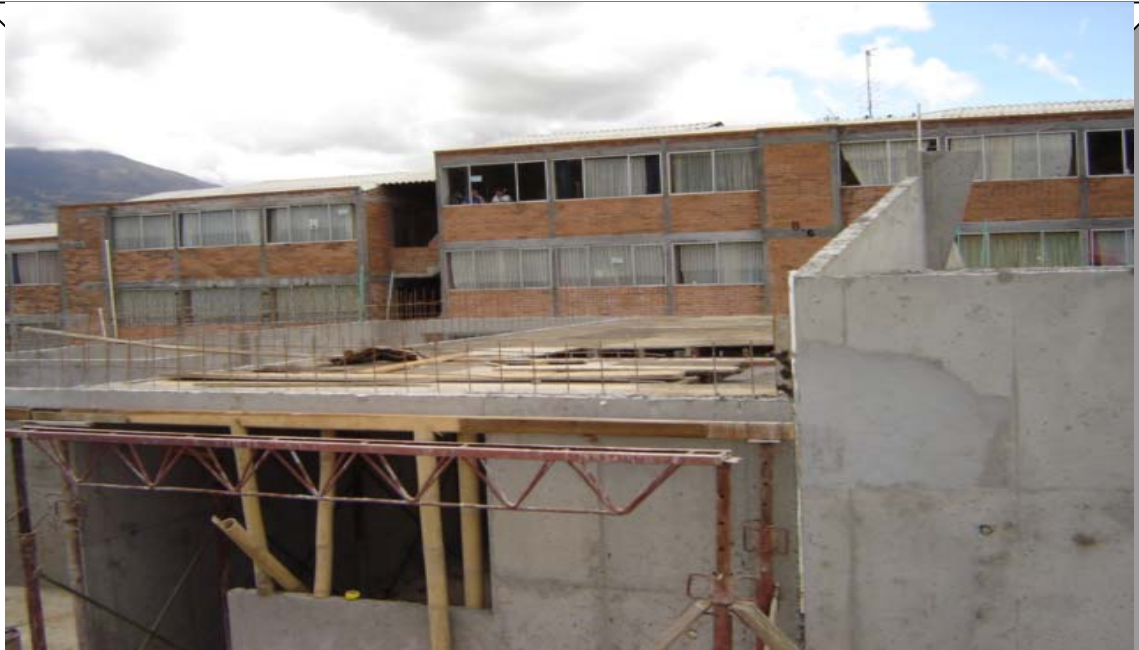
COLOCACION DE LA FORMAleta PARA LOSA
