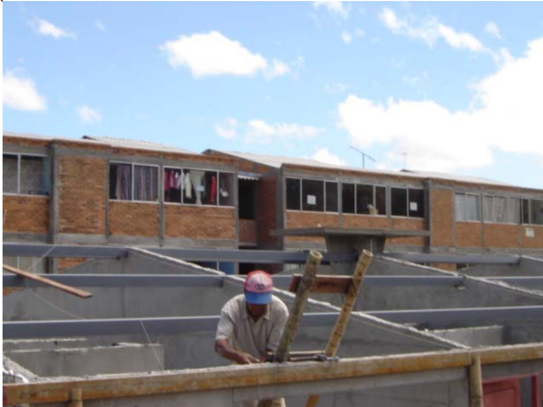
INSTALACION DE PERLINES METALICOS
