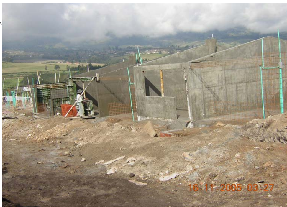
COLOCACION DE MALLA DE REFUERZO EN MUROS.
