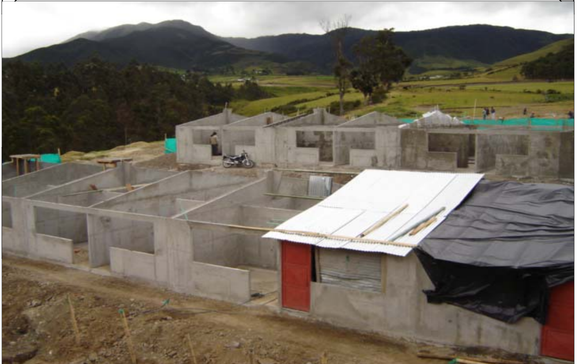
VIVIENDAS TIPO I, SIN CUBIERTA
