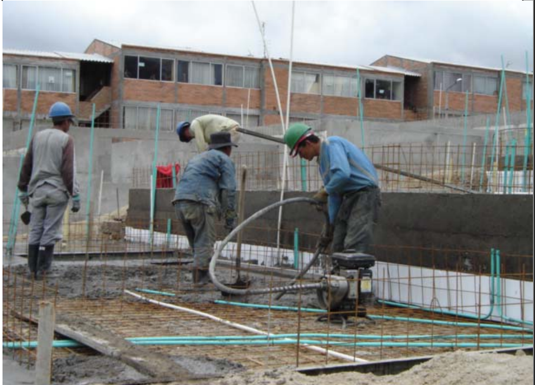
FUNDICION DE CIMENTACION. UTILIZACION DE VIBRADOR DE GASOLINA
