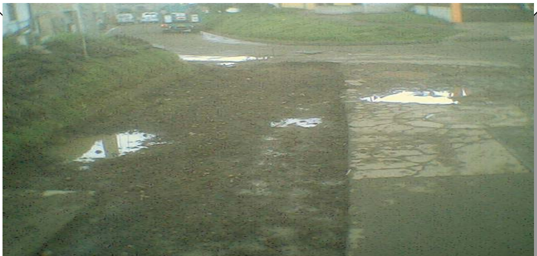
REHABILITACION DE CARPETA ASFALTICA EN BARRIO CHAMBU.
