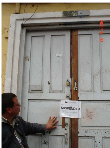
Figura 47. Suspensión de obra
