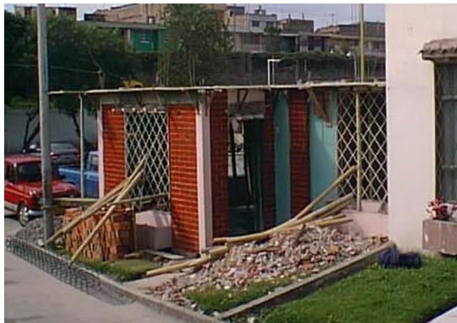
Figura 28. Cambio de cubierta a losa
