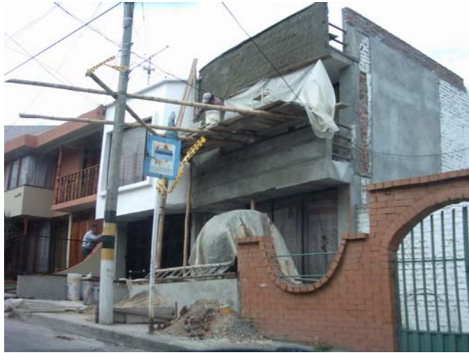
Figura 33. Cambio de Fachada
