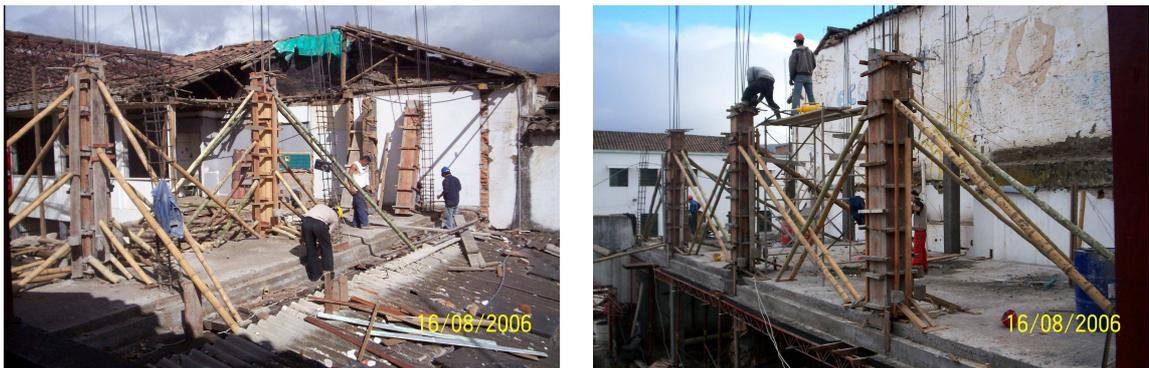
Cada elemento estructural exige un tiempo mínimo para el desencofrado, el cual se aplicó rigurosamente. En efecto, la formaleta para las columnas, fue retirada después de 24 horas de haber sido fundidas, los tableros laterales de vigas y zapatas se retiraban a las 36 horas, y el desencofrado de la losa se hizo a los 28 días, cuando adquirirían la resistencia esperada (no se utilizaron acelerantes).
