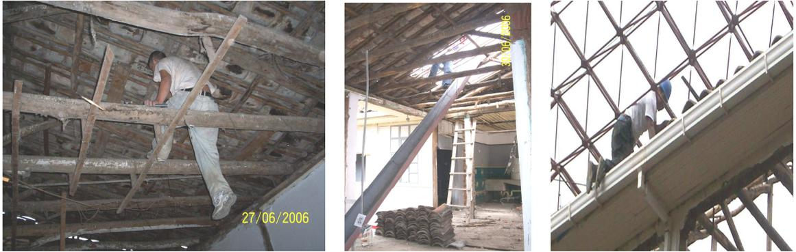
**2.1.5 Demolición de placa.** Se realizaron demoliciones totales y parciales de placas de piso existentes que impedían el correcto desarrollo de las obras para lo cual se tuvo las precauciones necesarias para no afectar las tapias existentes que se pretendían conservar. (Figura 6)
