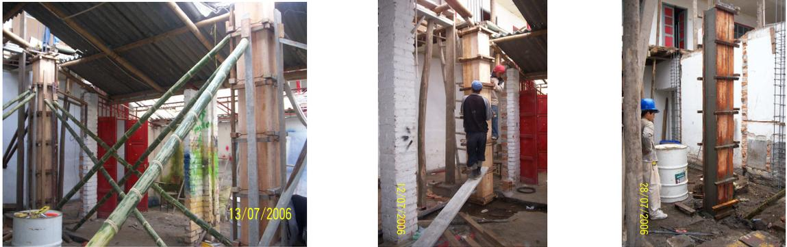
Figura 15. Formaleta para columnas de los bloques séptimo y décimo
