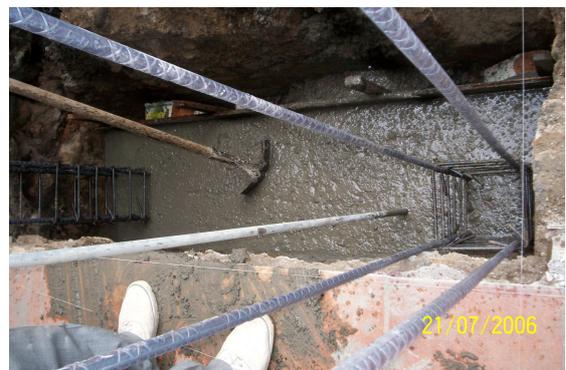
Se tomaron muestras del concreto mezclado en obra para verificar lo estipulado en la norma NSR 98 con respecto a resistencia y las normas ICONTEC 161, 116, 1920, 1925 y ASTM A-706.
