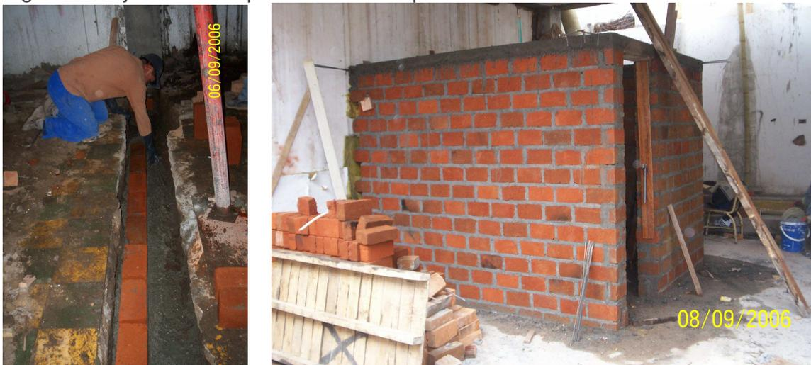
En los bloques séptimo y onceavo, cuyas instalaciones en modelo de cubículos estaban destinadas para la práctica musical, se realizó la pega de mampostería en papelillo, muros dobles, a los cuales se les introdujo en su espaciamento interno de 4 cm. espuma en fibra de vidrio, con el propósito de evitar que las ondas sonoras salieran del recinto en donde eran producidas. (Figura 45)
