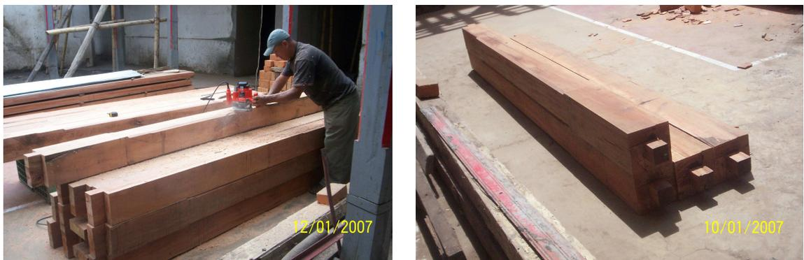
Por otra parte, las vigas que se amarraban en la parte superior de las pilastras, eran, igualmente, de chanul, con un ancho de 18 cm y un peralte fluctuante entre los 12 y 10 cm, el cual se adoptaba respectivamente, según, si la viga era de entrepiso o aérea.
