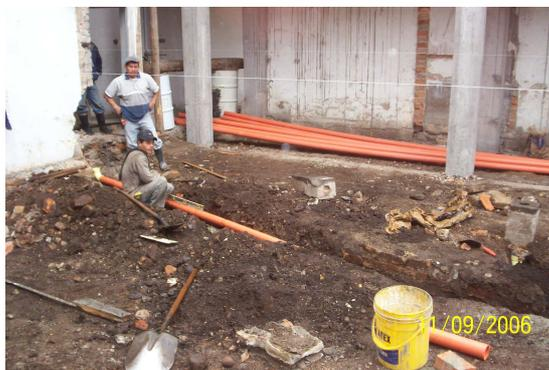
**8.1.1 Salidas sanitarias y de aguas lluvias.** Para dejar convenientemente instalados los puntos o salidas sanitarias y de aguas lluvias, inicialmente debía tenerse en cuenta la calidad de tubería y accesorios necesarios para llegar de la red al aparato respectivo, los cuales estaban indicados tanto en los planos sanitarios como en los arquitectónicos. La superficie de la tubería que se debía adherir primero debía ser limpiada para posteriormente pegarla de acuerdo con las
