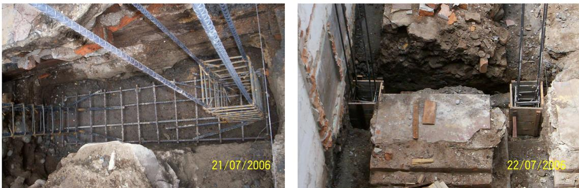
Ya en particular, el refuerzo de las columnas, en todos los bloques, comprendía seis barras longitudinales de diámetro 5/8 de pulgada, de las cuales, tres se traslaparon en el tercio central de la altura del primer nivel, las tres restantes se traslaparon en el tercio central de la altura del segundo nivel; lo anterior se decidió así dando conformidad a lo estipulado en el capítulo C.21 del título C de la NSR-98. Por otra parte, el refuerzo transversal estaba conformado por acero de 3/8 de
