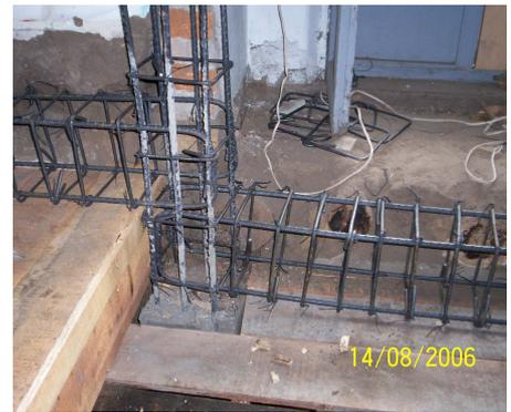
El refuerzo se colocaba de acuerdo con los planos estructurales. En las etapas de corte y enderezado, se utilizaron los elementos de trabajo y de protección adecuados. De igual manera se realizó la etapa de amarrado, para la cual se manejó el uso de alambre dulce calibre 18.
