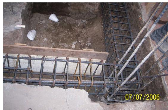
Figura 22. Encofrado y fundición de vigas de cimentación
