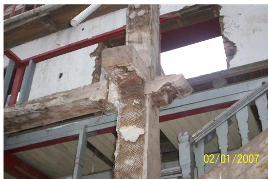
El material utilizado para la elaboración de las nuevas pilastras era madera del tipo chanul, la mayor parte traída de las ciudades de Ipiales y Tumaco; otra menor conseguida en aserríos de nuestra capital sureña. Los nuevos elementos prefabricados, tenían una sección transversal de forma octogonal, la cual se generaba cuando se achababan las aristas del producto maderero cuya sección originaria era de 18\*18 cm<sup>2</sup>, las alturas oscilaban de acuerdo a la altura de pisos existente.
