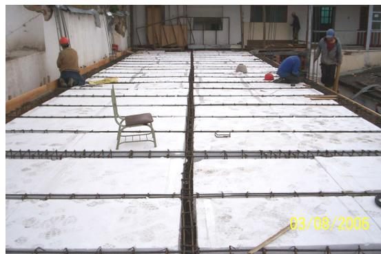
Figura 28. Amarre de refuerzo por retracción de fraguado y fundición de placa
