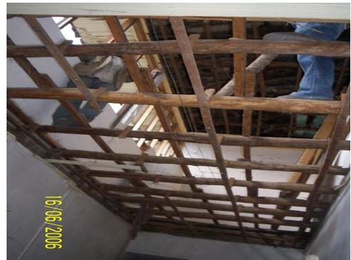
Figura 5. Desmante de cubierta en teja de barro y en marquesina
