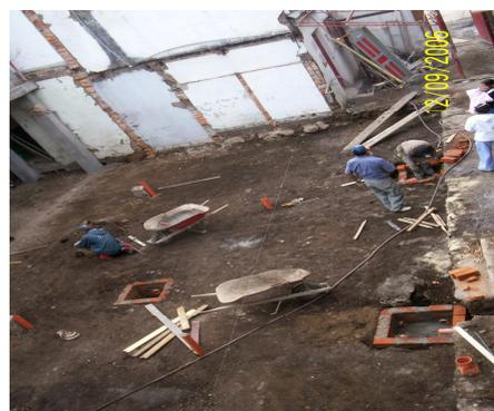
En los sifones de pisos se instalaron rejillas con sosco de conformidad a los diámetros de los accesorios y las tuberías PVC, selladas o revocadas con cemento blanco. Los bajantes se ubicaban de acuerdo a los planos; pero por las condiciones de la obra en ejecución, también podían ubicarse de acuerdo a las necesidades del proyecto.
