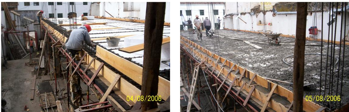
Las ménsulas se plantearon y construyeron, teniendo en cuenta que la relación entre el claro de cortante (distancia desde el paramento externo de la viga de apoyo hasta el paramento externo de la ménsula) y la altura, fuera no mayor de 1; del mismo modo se tuvo presente el concepto estructural que establece que el
