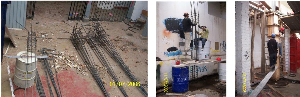
El proceso constructivo de las columnas requiere que estos elementos estructurales garanticen verticalidad, geometría y estética; debido a esto debían aplomarse apropiadamente, sus formaletas con las dimensiones especificadas en planos y además de contextura óptima.
