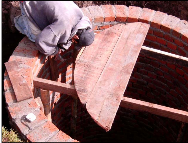
Figura 79. Encofrado placa pozo de infiltración
