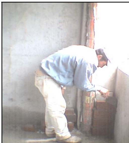
Figura 81. Instalación de malla con vena.
