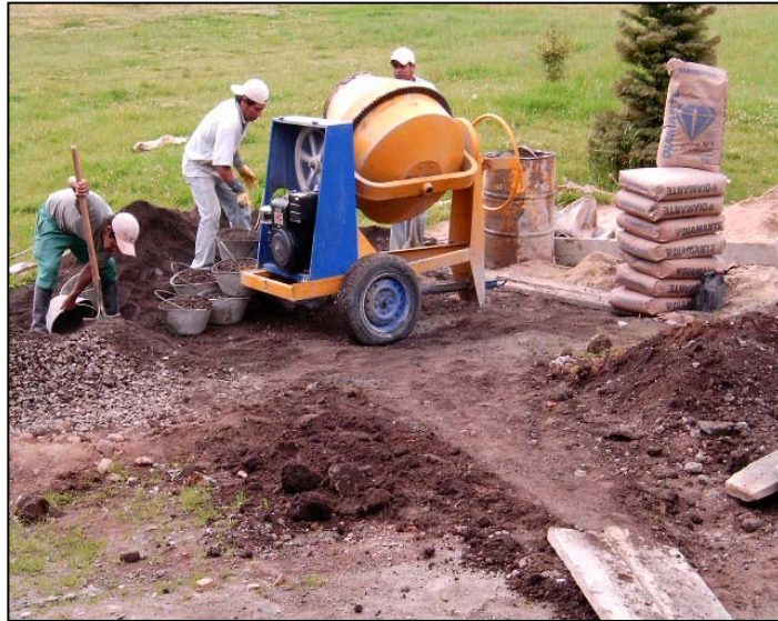
Figura 21. Producción del concreto en obra
