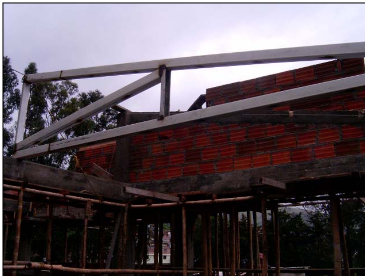
Figura 58. Montaje de cercha por partes
