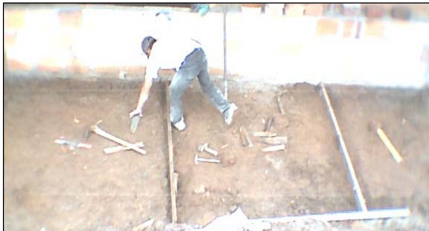
Figura 114. Encofrado de andén
