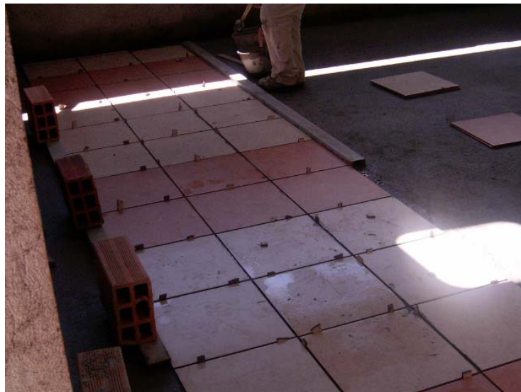
Figura 99. Colocación de cerámica
