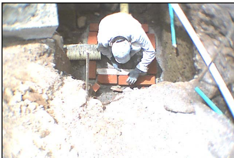
Figura 71. Muros en ladrillo tolete común
