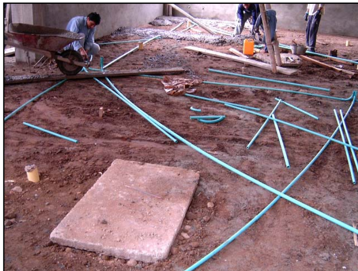
Figura 89. Instalación de ductos
