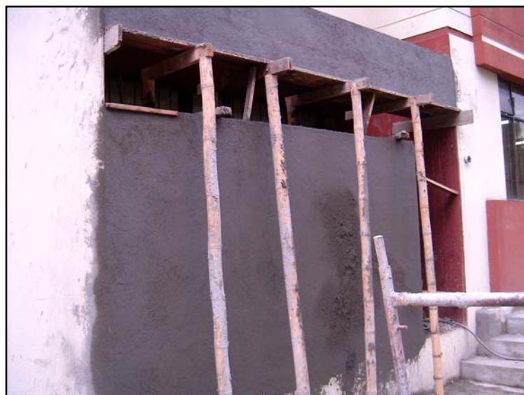
Figura 119. Repello de muros, piso y viga canal
