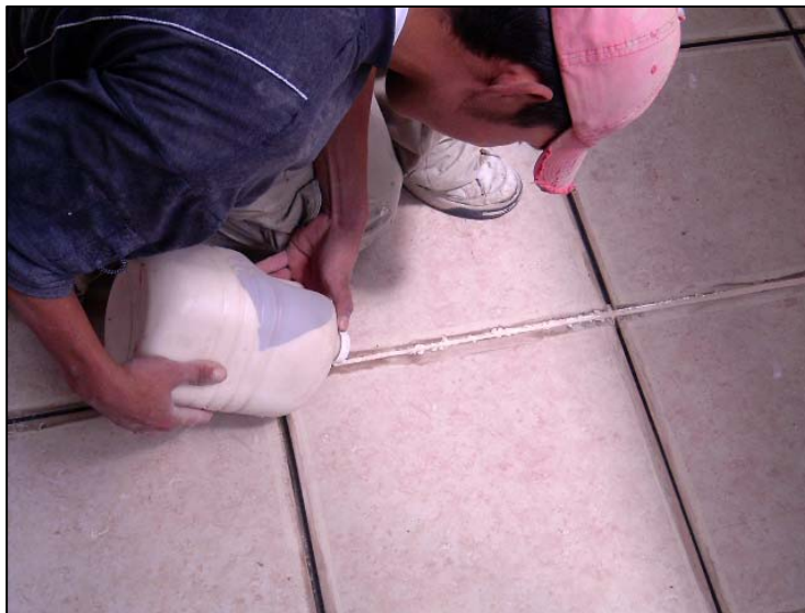
Figura 105. Aplicación de sellante
