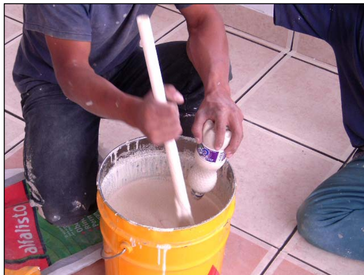
Figura 104. Preparación del relleno para junta
