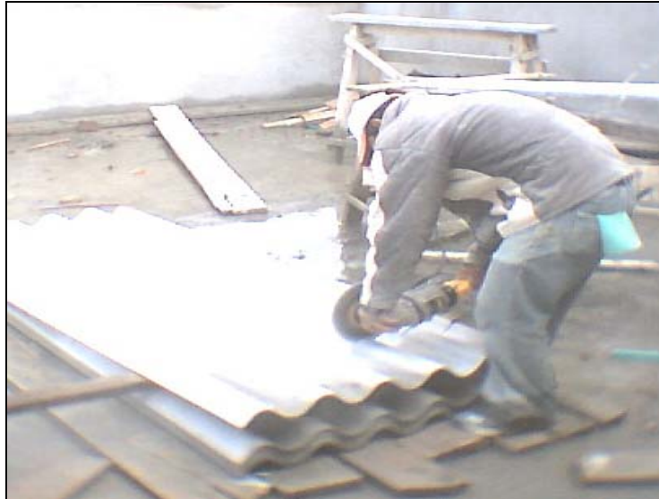
Figura 62. Corte con pulidora teja N° 8
