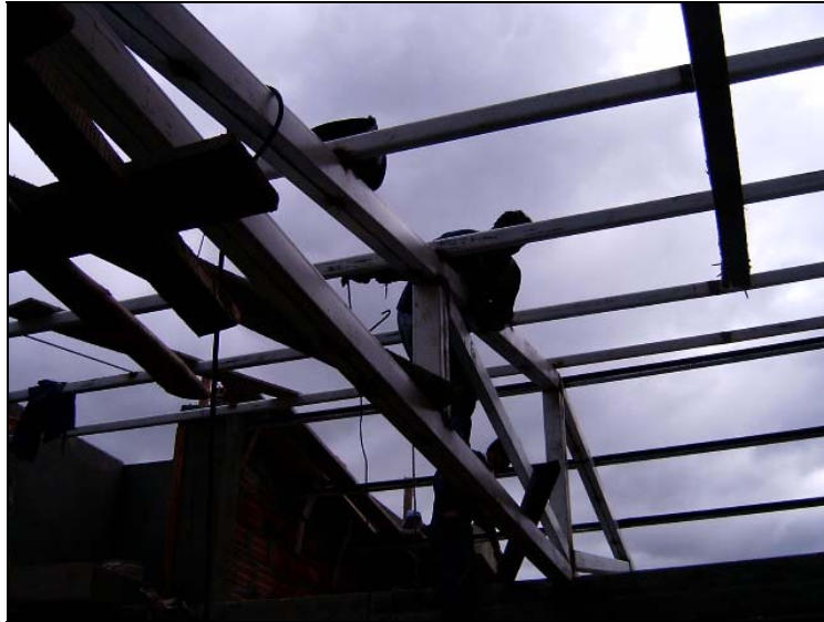
Figura 60. Anclaje de correas sobre cinta de amarre.
