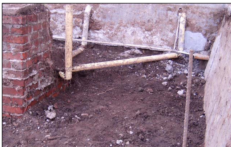
Figura 14. Excavaciones de material relleno.
