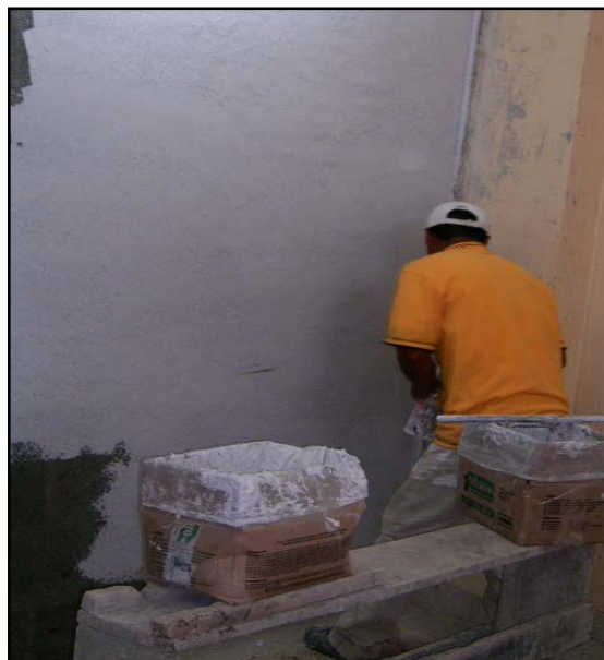
Figura 109. Aplicación de estuco plástico.
