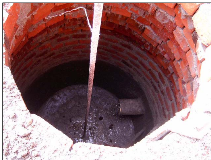
Figura 75. Cámara de inspección
