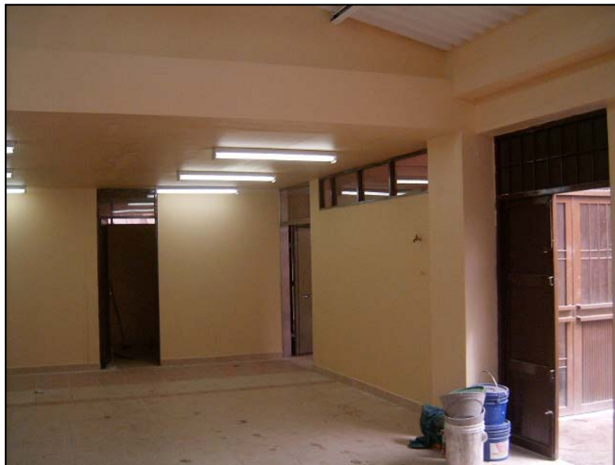
Figura 110. Pintura de partes metálicas.
