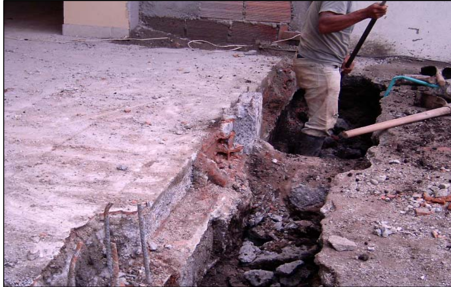
Figura 19. Excavación de zapata.
