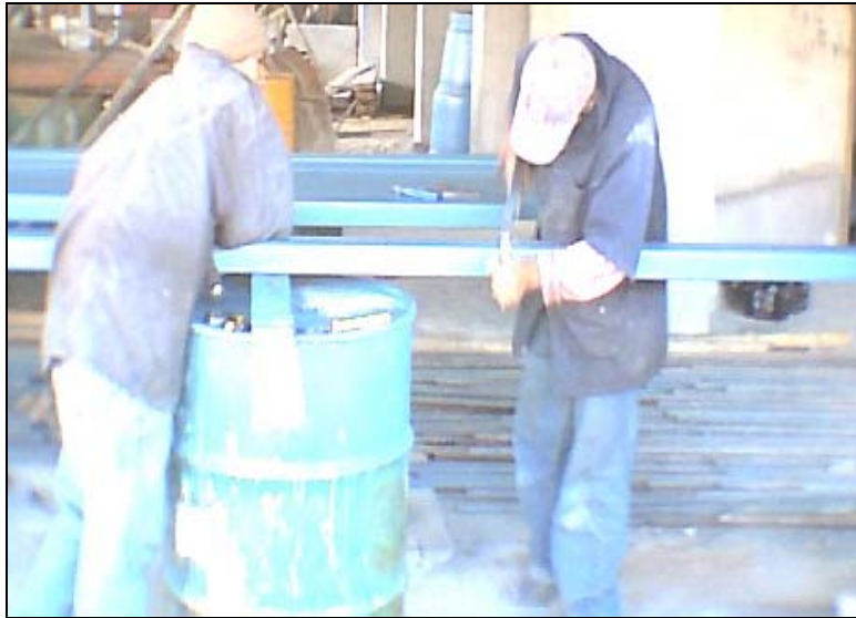
Figura 58. Montaje de cercha por partes
