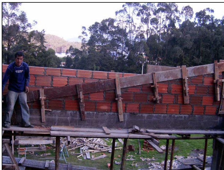
Figura 46. Viga cinta fundida.
