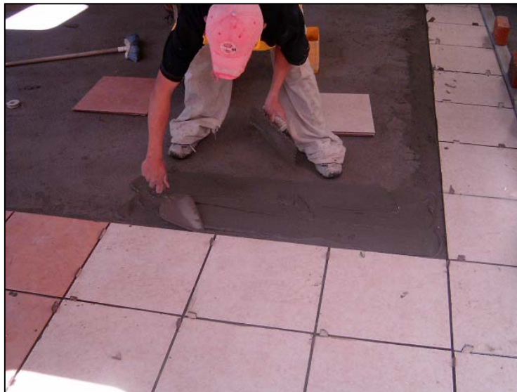
Figura 97. Colocación de pasta de cemento gris sobre piso.
