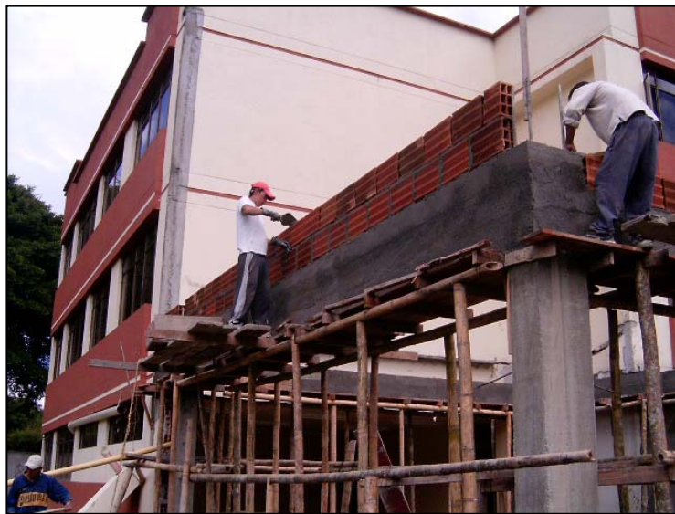
Figura 43. Construcción de parapetos
