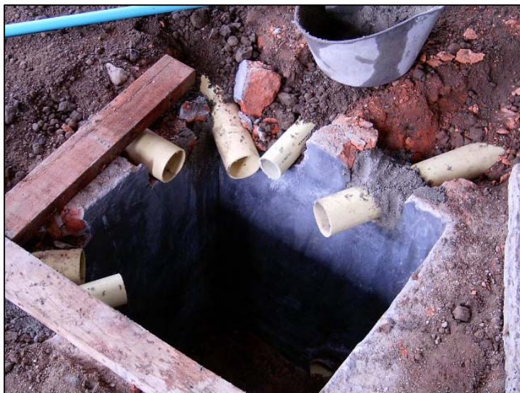
Figura 73. Instalación de tuberías en las cajas
