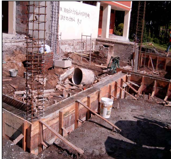
Figura 28. Muro de contención fundido.
