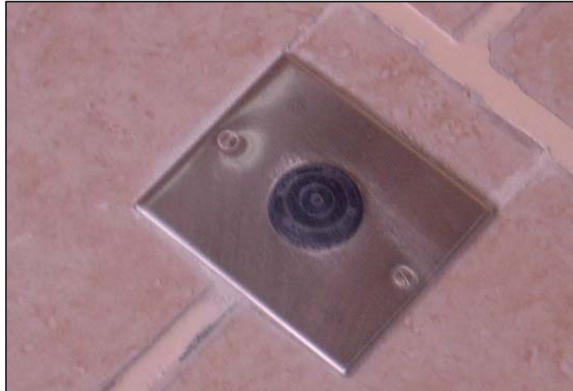
Figura 85. Válvula de piso instalada
