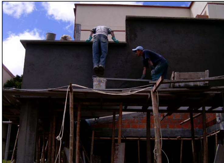
Figura 52. Refinado de muros
