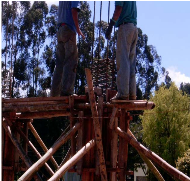
Figura 32. Fundición de columnas.
