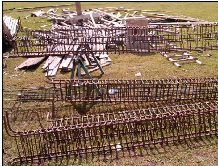
Figura 29. Castillos de columnas.
