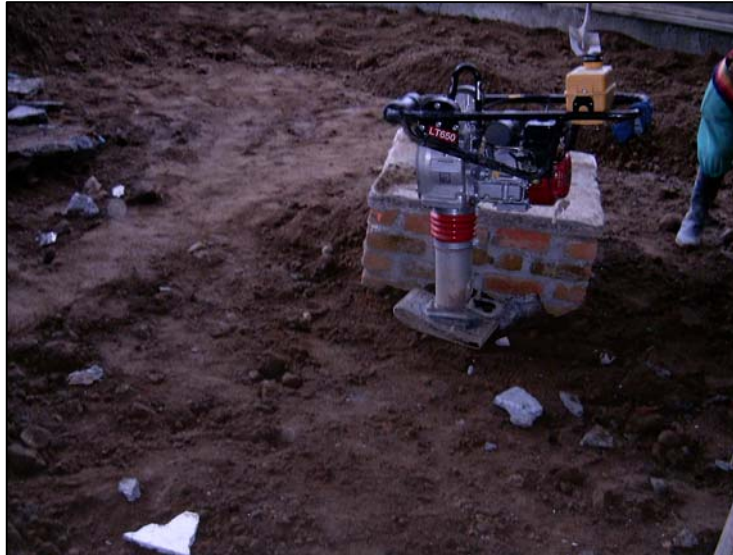
Figura 68. Relleno compactado.
