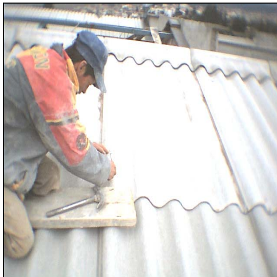
Figura 65. Instalación de caballetes a teja de cubierta.
