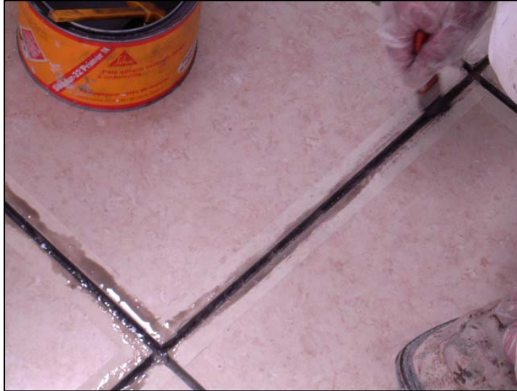
Figura 103. Aplicación de Sikadur 32 Primer
