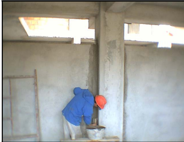
Figura 54. Estrías de muros interiores
