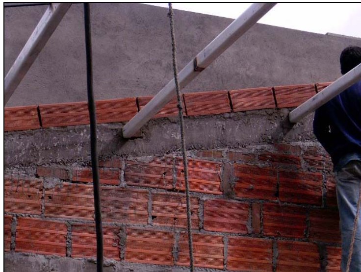
Figura 60. Anclaje de correas sobre cinta de amarre.
