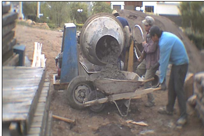
Figura 22. Transporte del concreto
