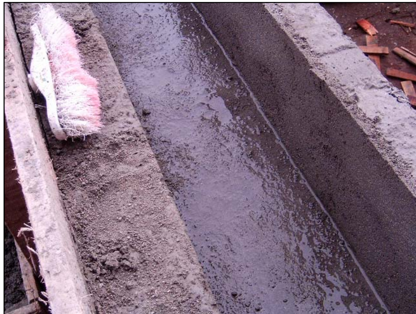
Figura 37. Esmaltado de vigas canal.
