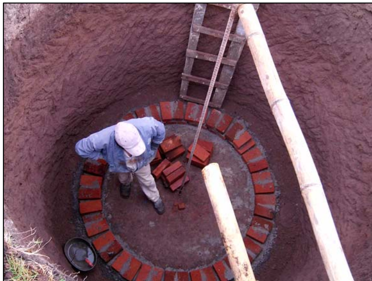
Figura 78. Pega de muros en soga a junta abierta.
