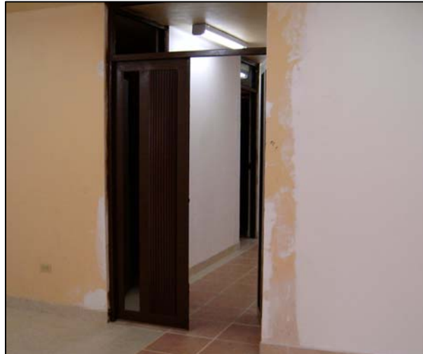
Figura 107. Instalación de puertas y ventanas
