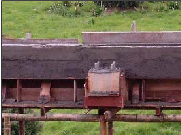
Figura 35. Ménsula para soporte de cubierta metálica.
