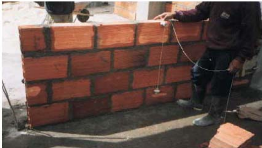
Figura 38. Verticalidad de muros
