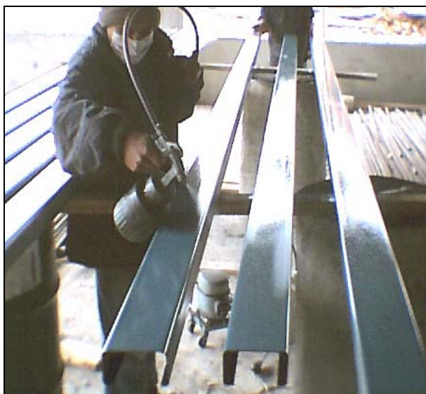
Figura 56. Pintura de perfiles con base anticorrosiva.
