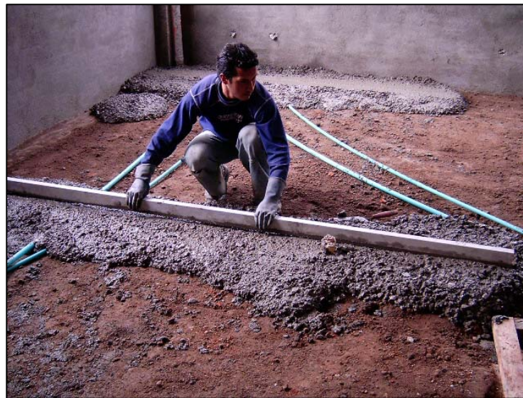
Figura 69. Fundición de placa de piso
