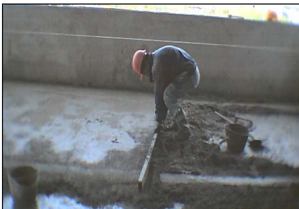
Figura 55. Repello de pisos
