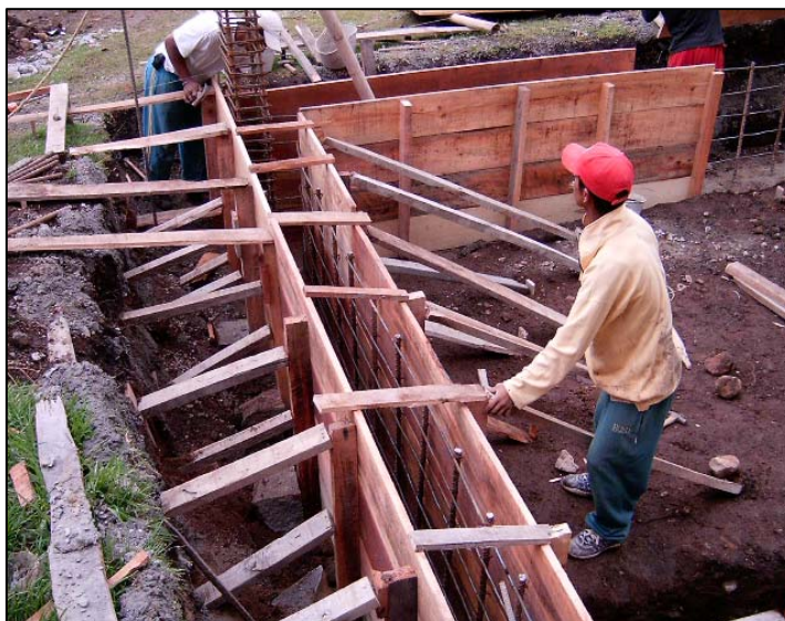
Figura 27. Encofrado de cuerpo de muro.
