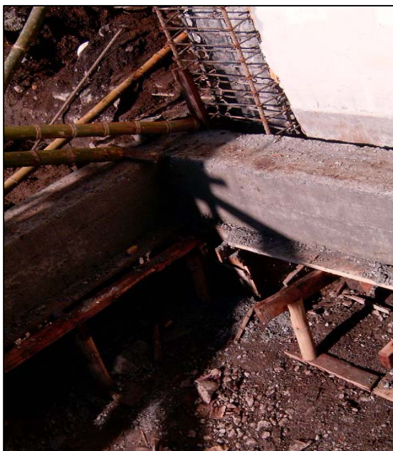
Figura 34. Refuerzo adicional columna existente.
