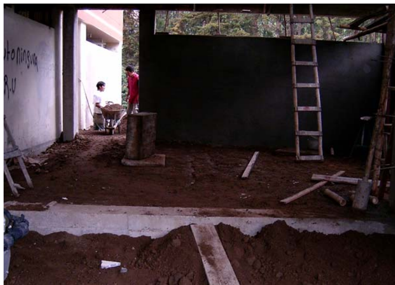
Figura 68. Relleno compactado.
