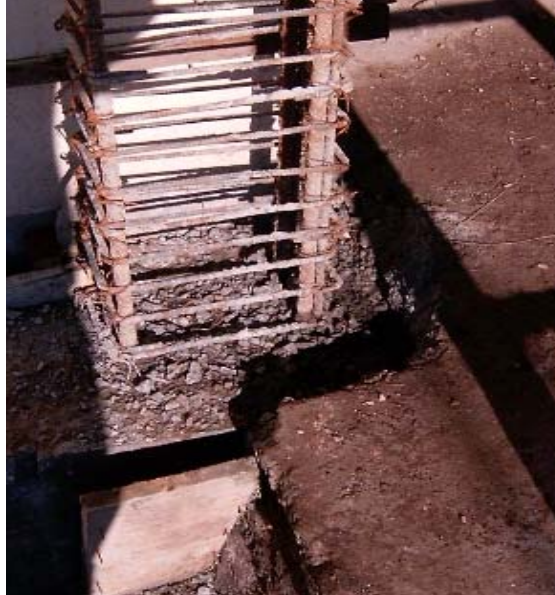
Figura 30. Columna anclada a muro de contención.
