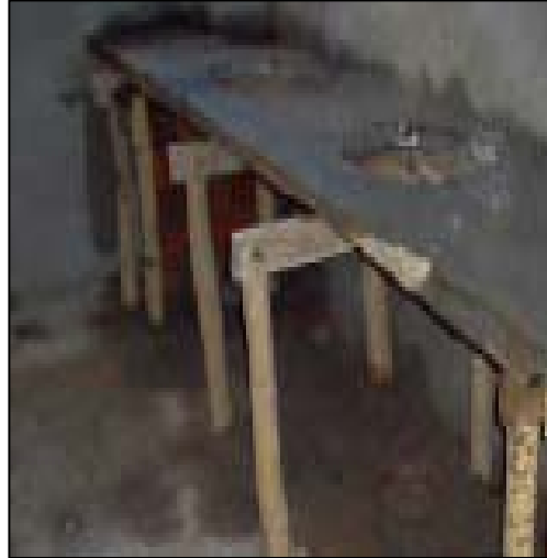
Figura 87. Fundición de mesón
