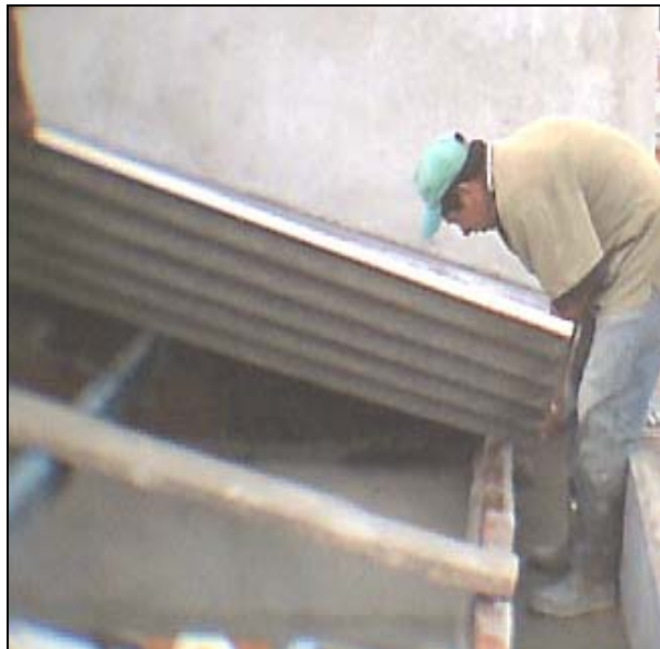
Figura 61. Instalación de teja de asbesto cemento
