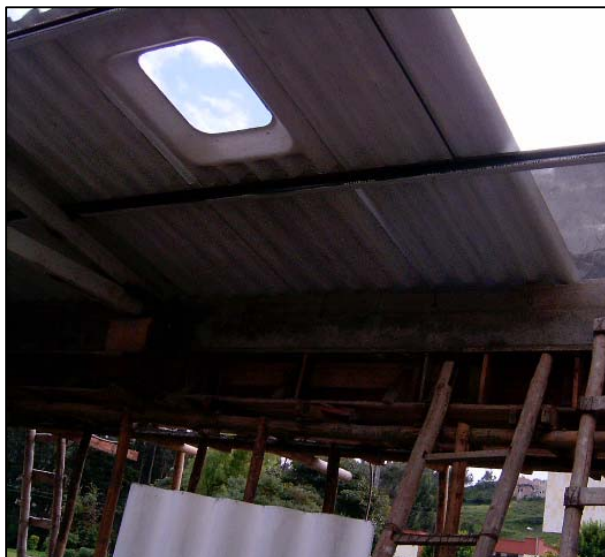
Figura 63. Instalación de teja con claraboya.
