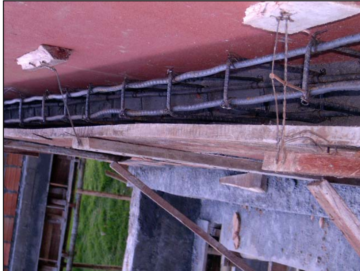
Figura 46. Viga cinta fundida.
