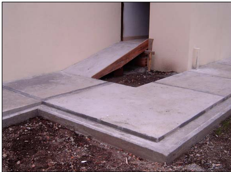
Figura 117. Rampa de acceso cuarto de gas.
