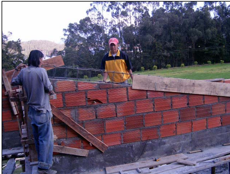
Figura 44. Refuerzo de cinta de amarre.
