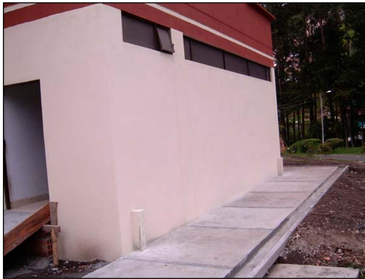
Figura 111. Pintura de muros exteriores terminada.
