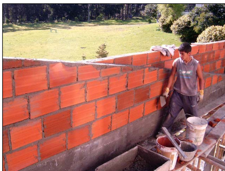
Figura 42. Construcción de tímpanos.
