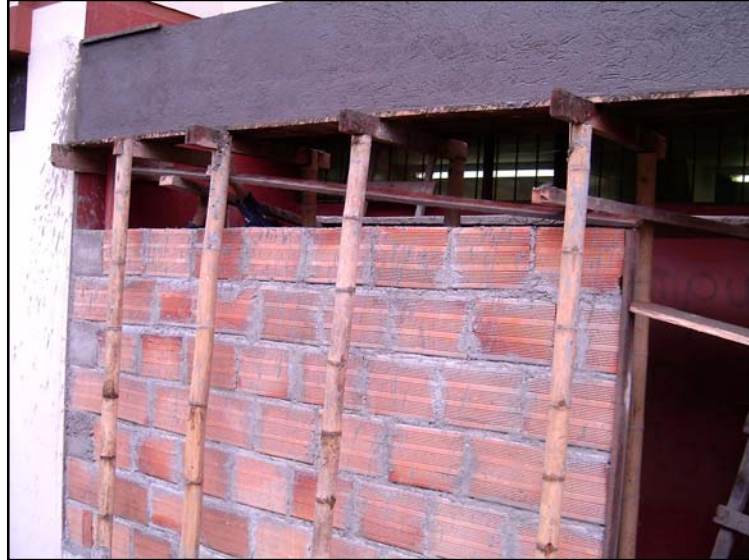
Figura 118. Muro en bloque farol No 5.
