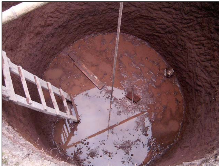
Figura 77. Excavación pozo de infiltración.
