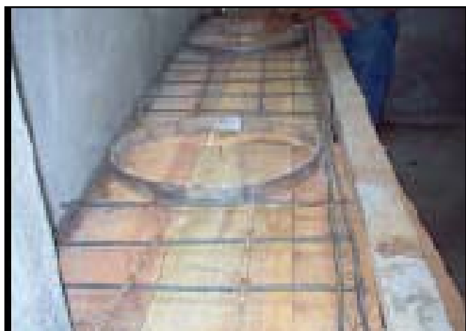
Figura 86. Armado de refuerzo.
