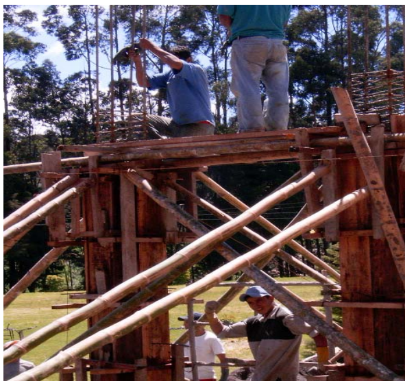
Figura 31. Encofrado de columnas.
