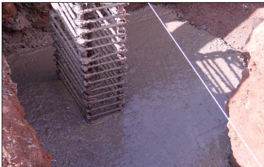
Figura 24. Zapata fundida.
