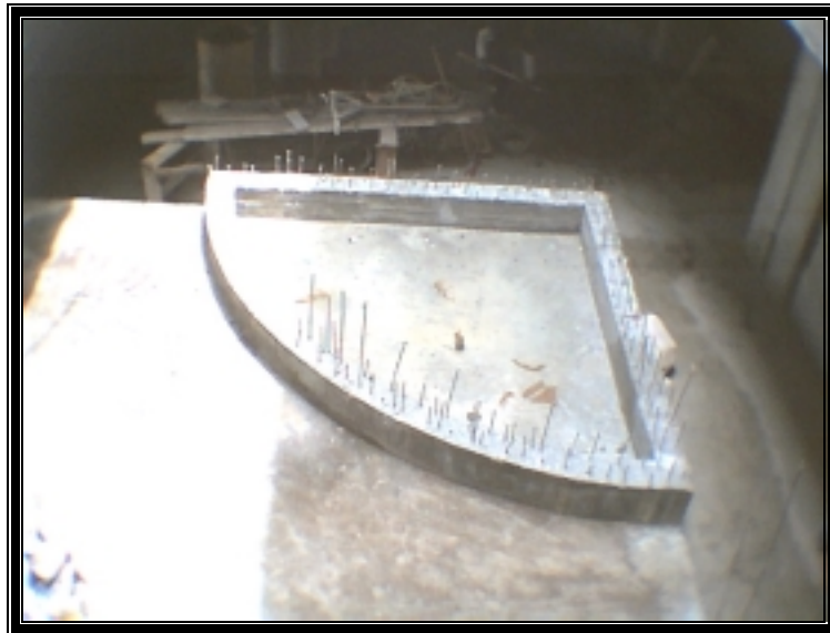
Figura 33. Desencofrado de fuente luminosa.
