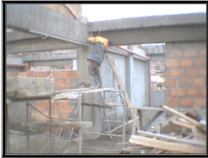
Figura 66. Mordazas utilizando codal.
