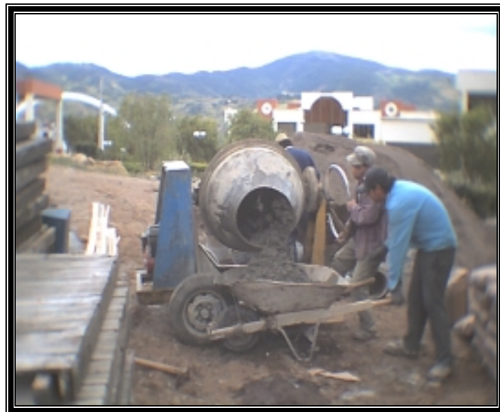
Figura 4. Transporte del concreto
