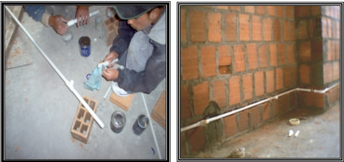
Figura 71. Instalación Hidráulica y Soldadura.
