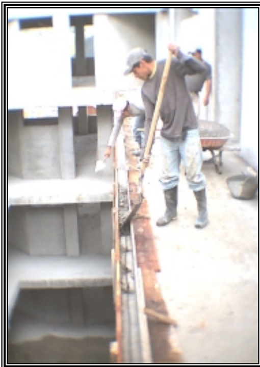
Figura 43. Fundición de bordillo y Repello afinado.
