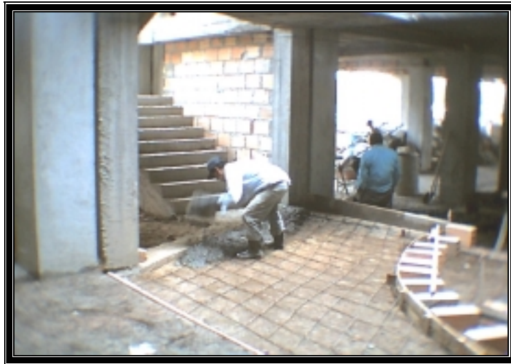
Figura 36. Vaciado del concreto.
