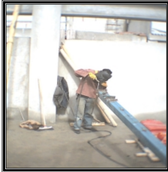
Figura 95. Soldadura de perfiles.
