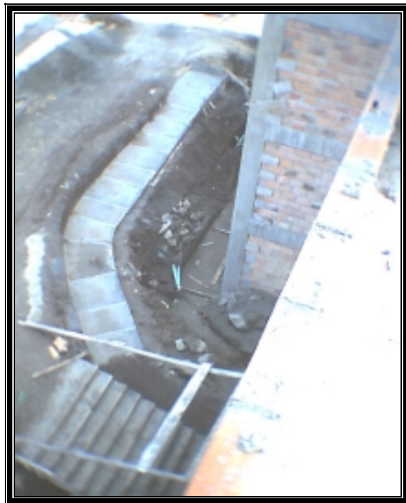
Figura 27. Rampa Discapitados terminada.
