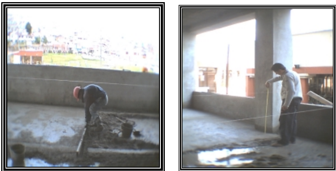
Figura 60. Repello de pisos.
