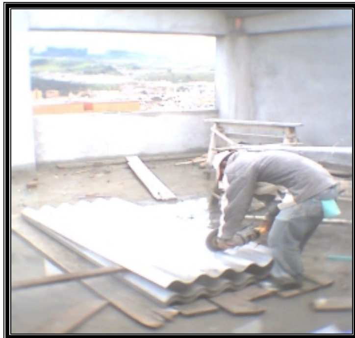
Figura 107. Corte con pulidora teja Nº 8.
