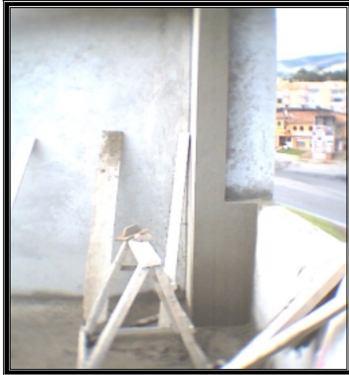
Figura 81. Repello de bajantes terminado.
