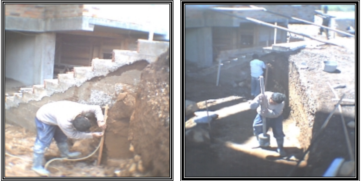
Figura 23. Nivelación y Relleno compactado.
