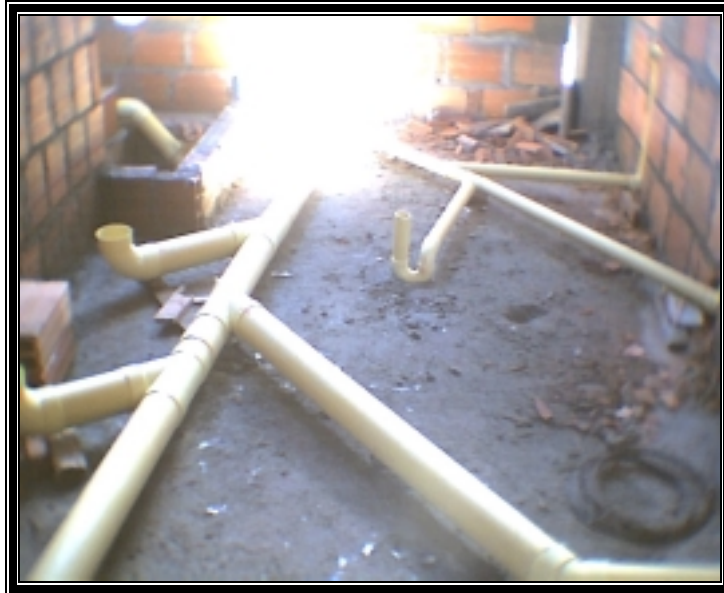
Figura 82. Instalación de tubería sanitaria.
