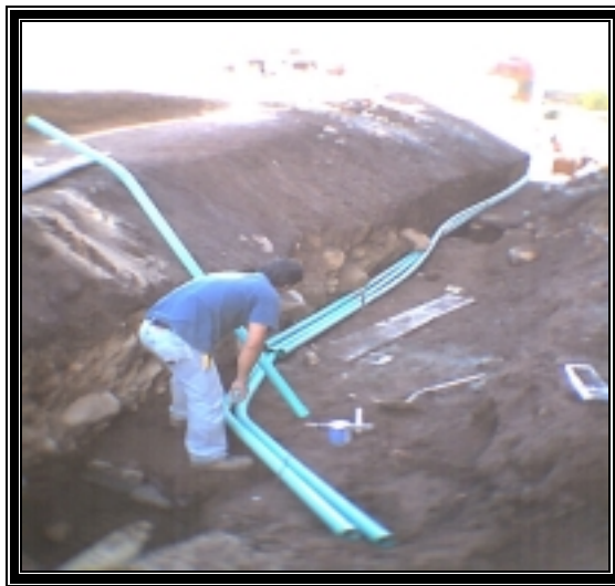
Figura 88. Tendido de tubería eléctrica.
