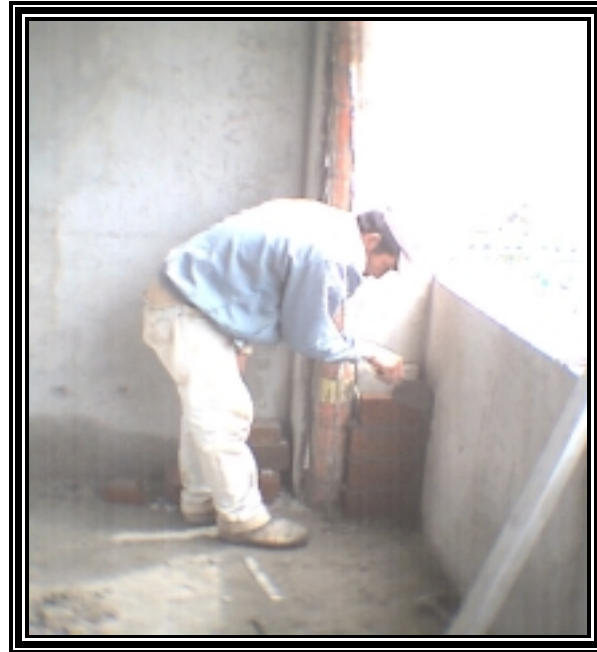
Figura 79. Colocación de Malla en vena.
