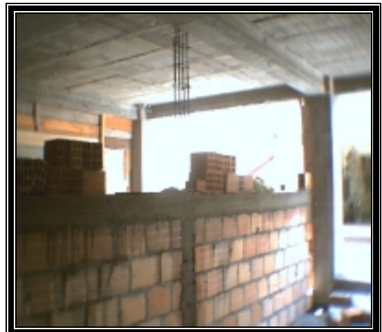
Figura 53. Figurado y fundición de cintas de amarre.
