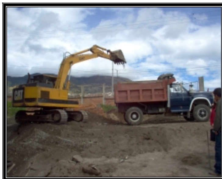
Figura 10. Retiro del material Sobrante.
