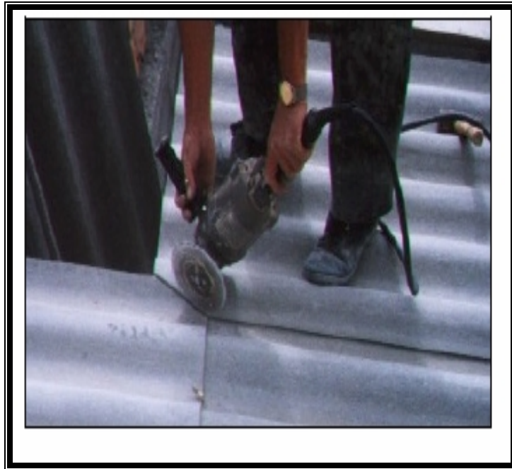
Figura 106. Despunte de teja eternit con pulidora
