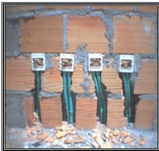
Figura 91. Instalación de cajas y ductos para lámparas.
