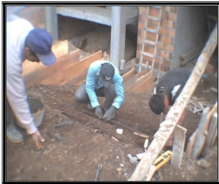
Figura 14. Figurado del hierro.
