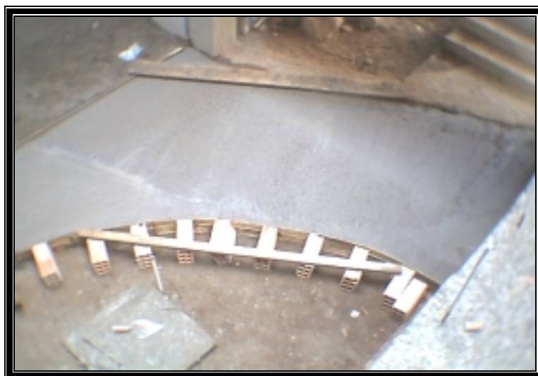
Figura 37. Fundición de piso terminada.
