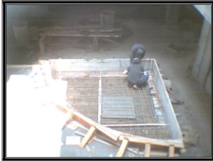
Figura 30. Encofrado y figurado de hierro en la fuente luminosa.
