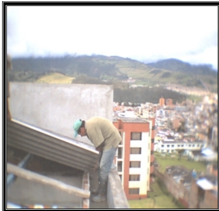
Figura 105. Distribución de tejas.
