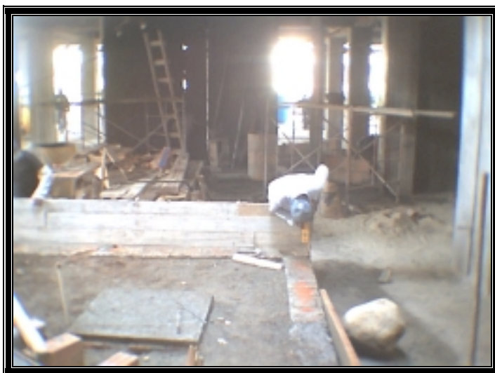
Figura 29. Verticalidad de tableros.
