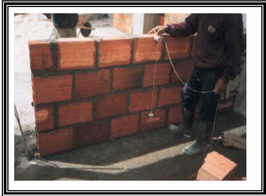
Figura 47. Verticalidad de muros.
