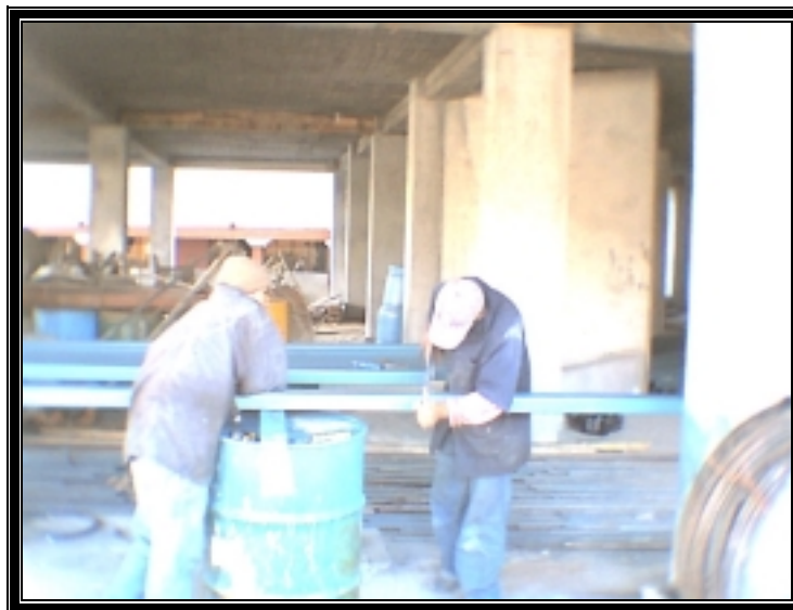
Figura 94. Corte de perfiles.
