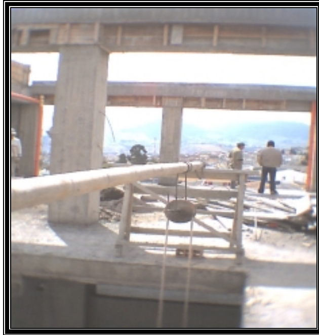
Figura 97. Detalle de Polea.
