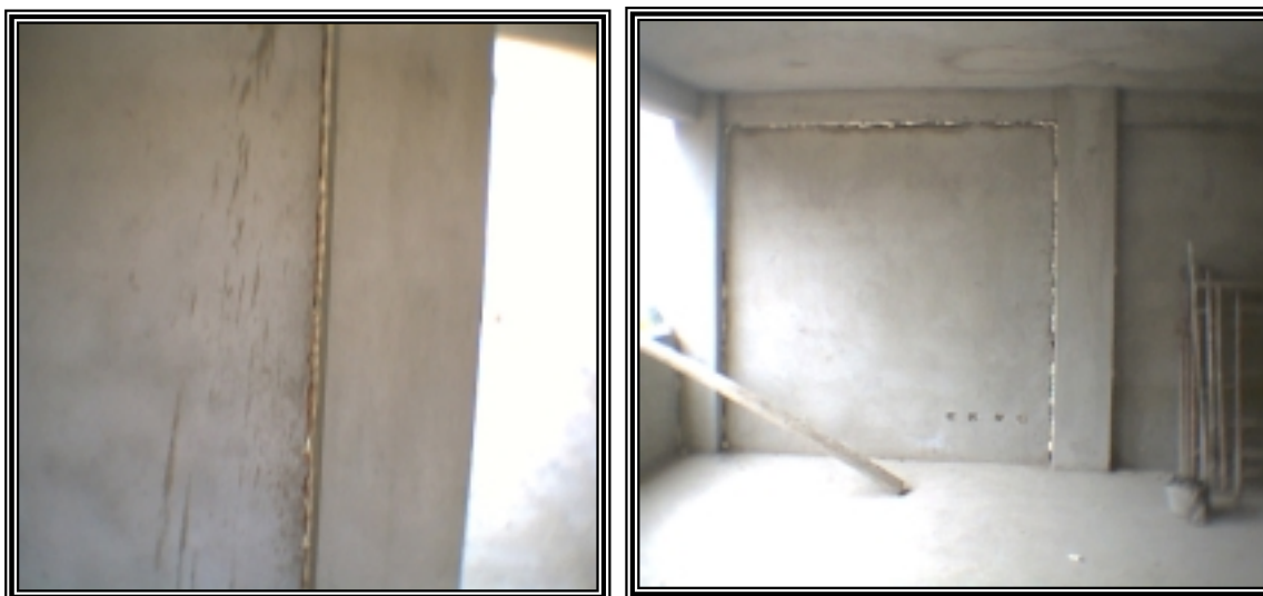
Figura 48. Juntas de dilatación.
