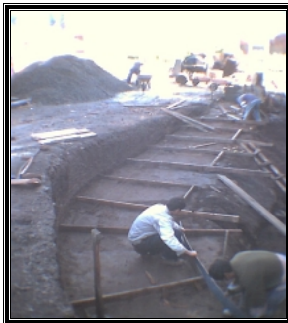
Figura 24. Encofrado de rampa.
