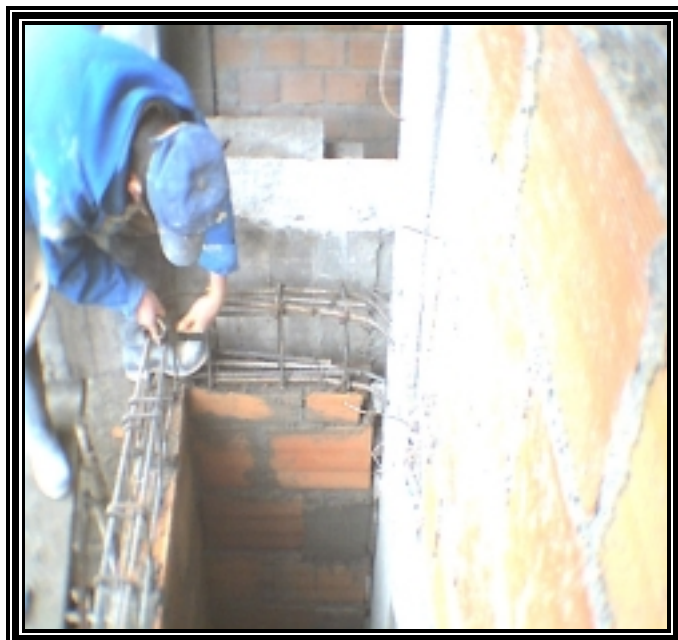
Figura 39. Armado de vigas de Buitrón
