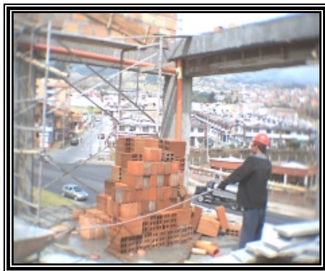
Figura 45. Humedecimiento del bloque N° 5.
