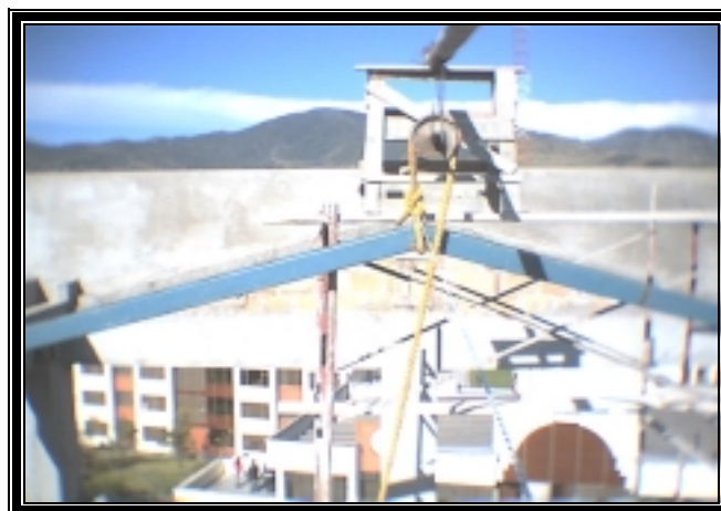
Figura 100. Alineamiento de cerchas.
