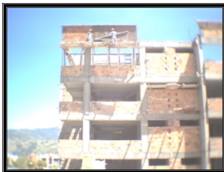
Figura 57. Pañete de parapetos.
