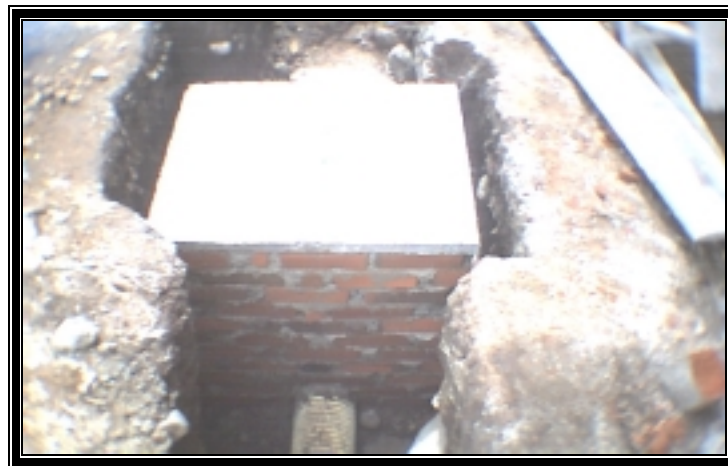
Figura 77. Caja de inspección terminada.
