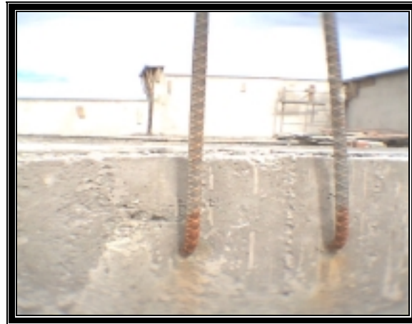
Figura 99. Anclajes de hierro de ½"
