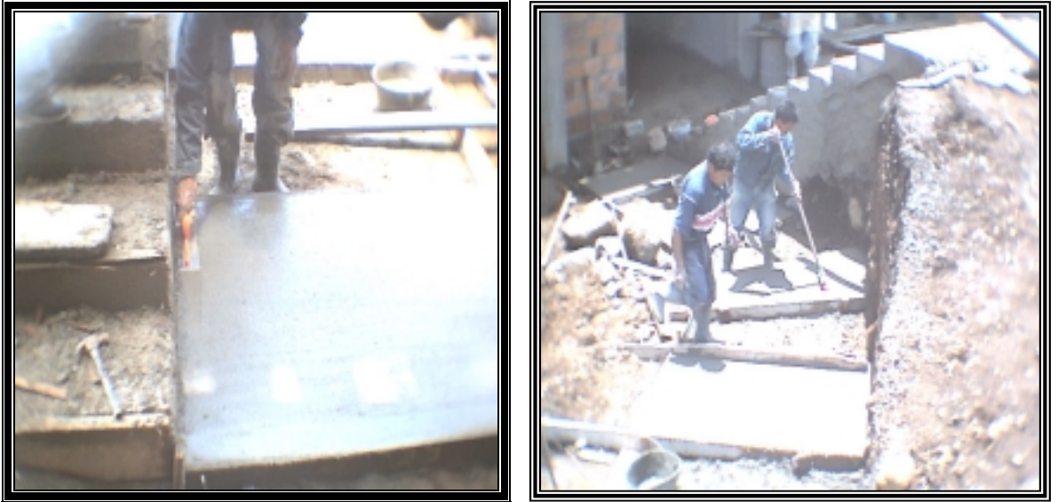
Figura 26. Acolillado y Escobillado de rampa.
