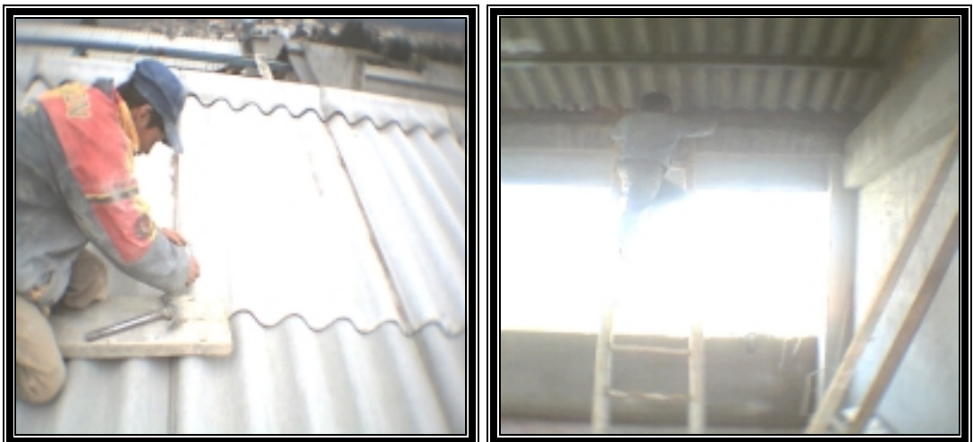
Figura 109. Remates de cubierta.
