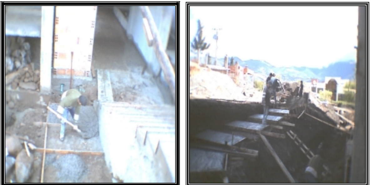
Figura 25. Fundición de rampa.
