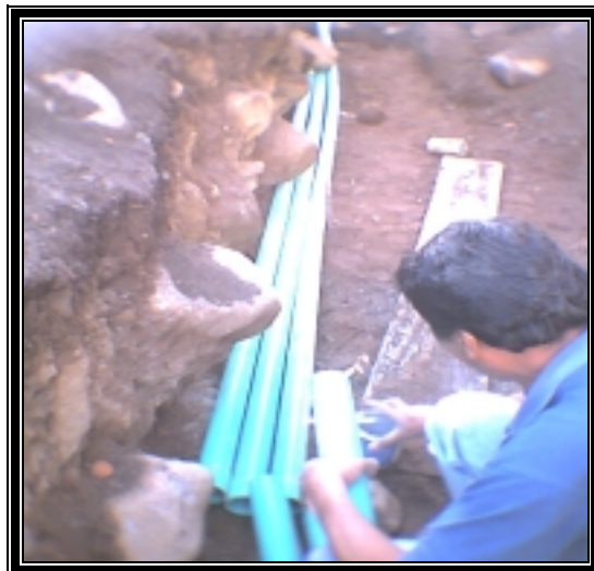
Figura 89. Soldadura de tubería eléctrica.
