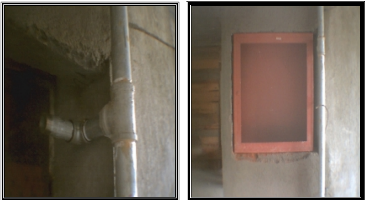
Figura 86. Instalación de gabinetes contra incendios.
