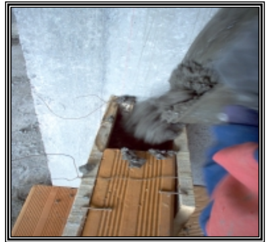
Figura 49. Fundición de dados.
