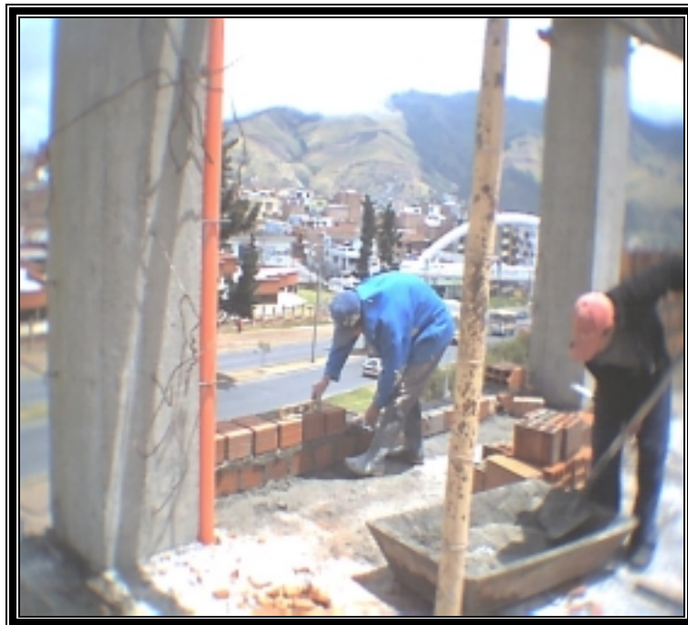
Figura 46. Verificación de horizontalidad.
