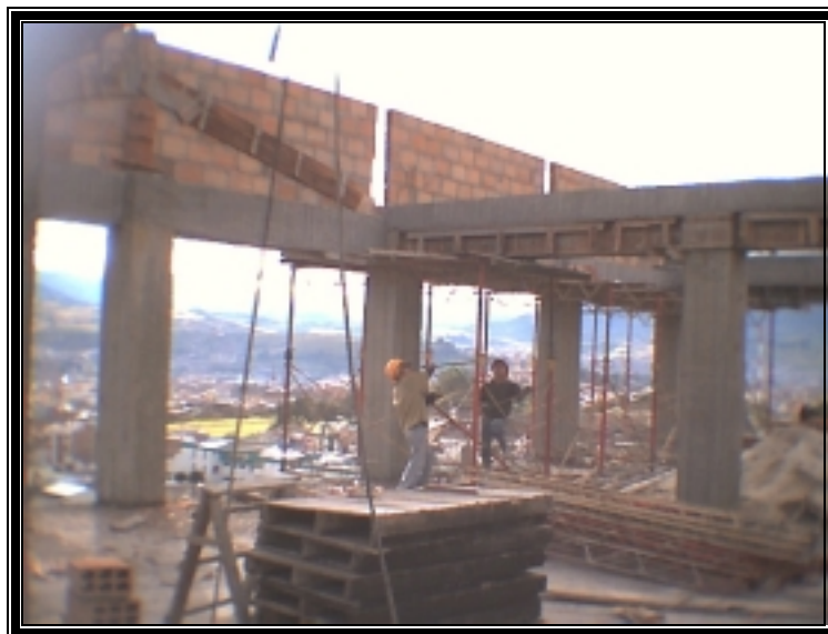
Figura 13. Vista estructura sin formaleta.
