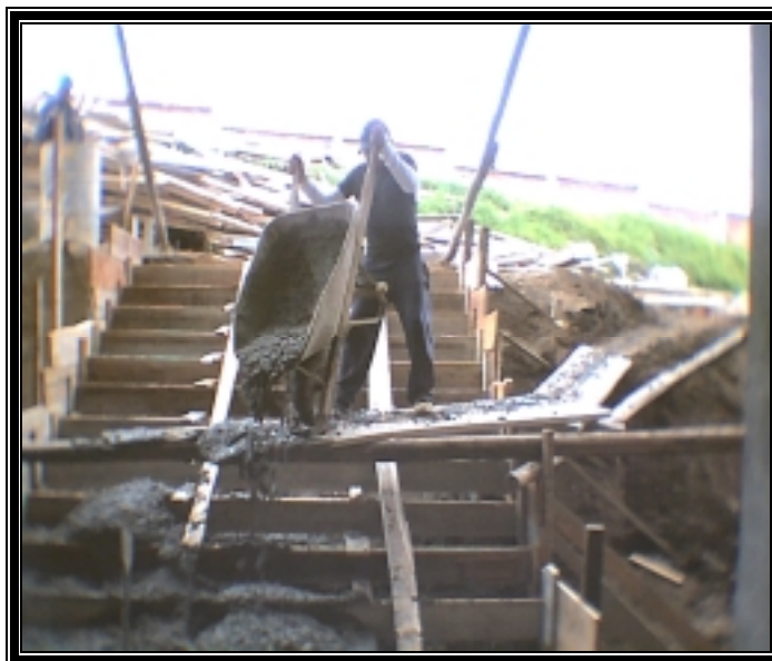
Figura 16. Fundición de escaleras.
