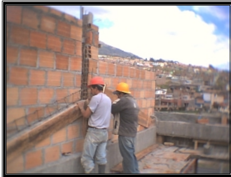
Figura 59. Cintas de confinamiento de tímpanos.
