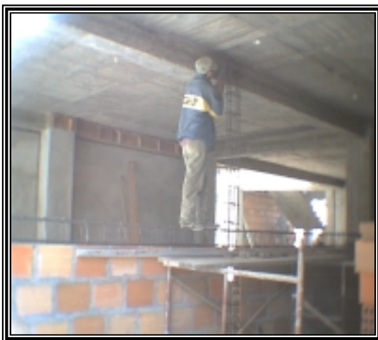
Figura 53. Figurado y fundición de cintas de amarre.
