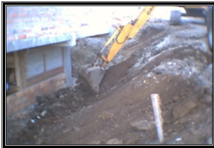
Figura 9. Conformación de niveles.
