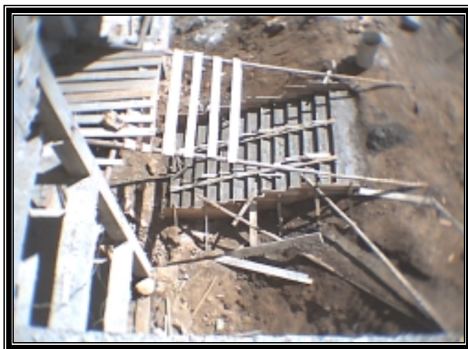
Figura 17. Fundición de escaleras terminada.
