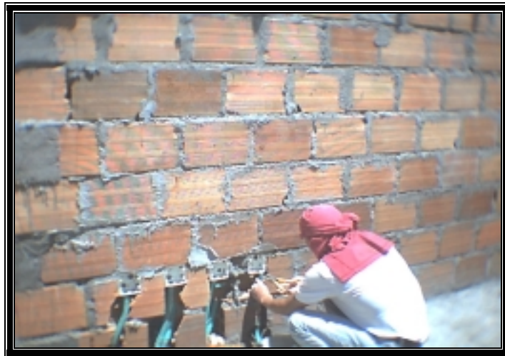
Figura 91. Instalación de cajas y ductos para lámparas.
