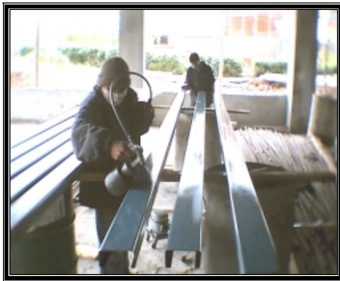
Figura 93. Pintura de perfiles.
