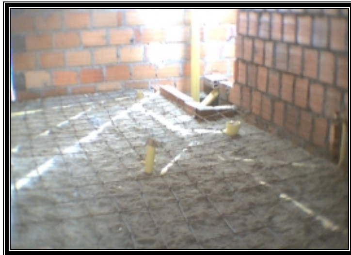
Figura 84. Figurado de malla.
