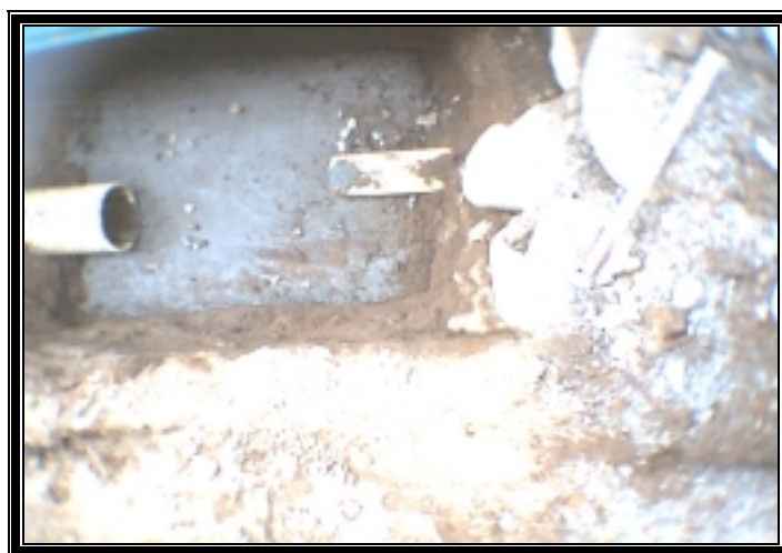
Figura 73. Solado de cajas.
