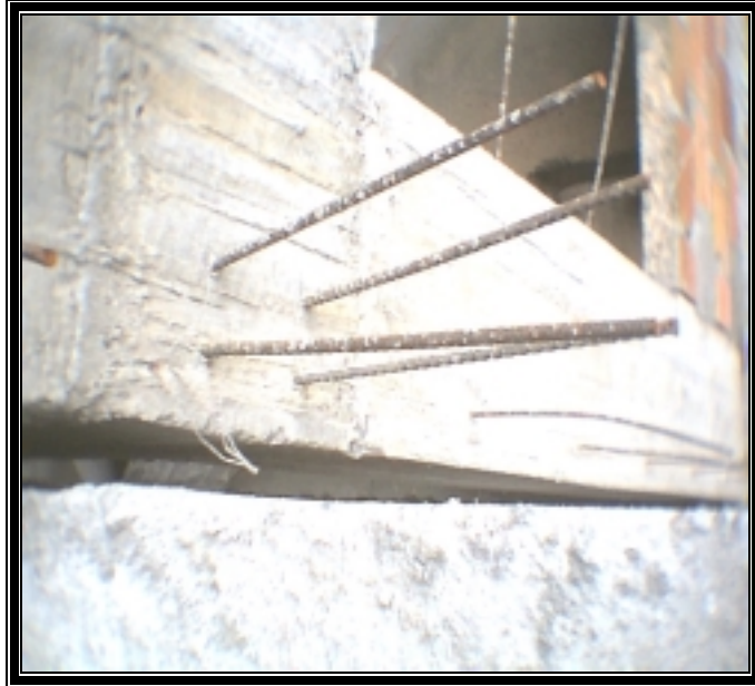
Figura 38. Anclajes de Vigas
