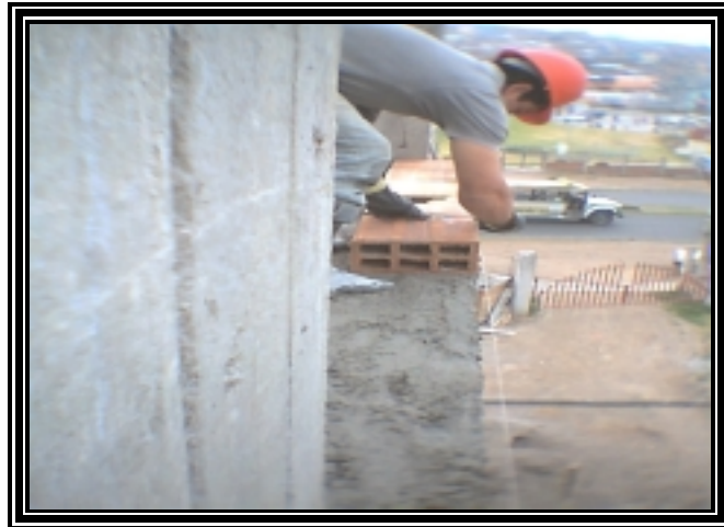
Figura 45. Humedecimiento del bloque N° 5.
