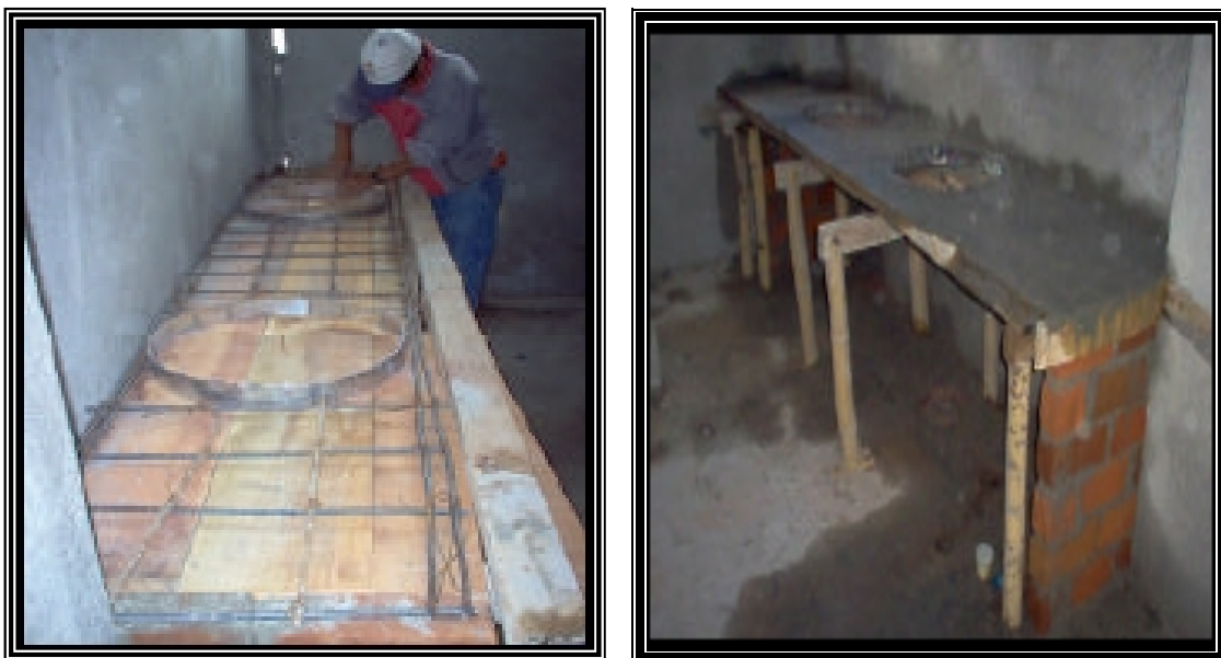
Figura 42. Armado de refuerzo y formaleta de mesones.
