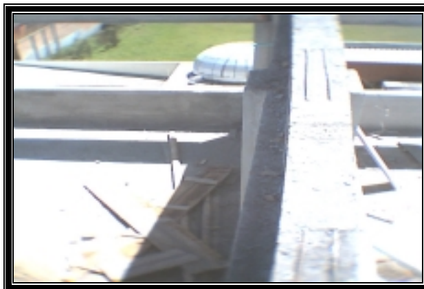
Figura 102. Anclajes para soldadura de correas.
