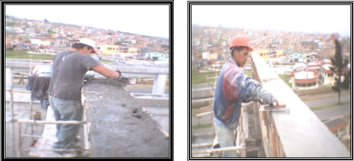
Figura 56. Fundición y Esmaltado de alfajía.
