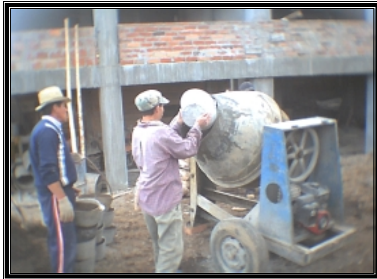
Figura 3. Producción del concreto en obra
