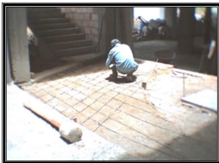
Figura 35. Figuración de la malla.
