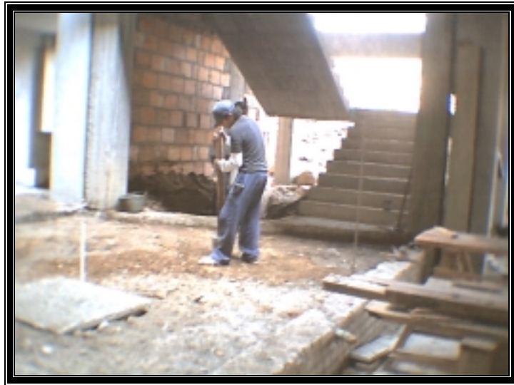
Figura 34. Compactación con pisón.
