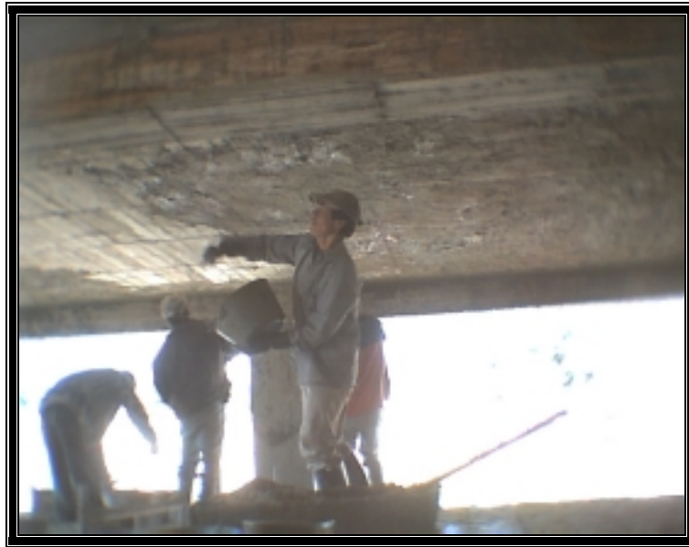
Figura 61. Repello cielo raso.
