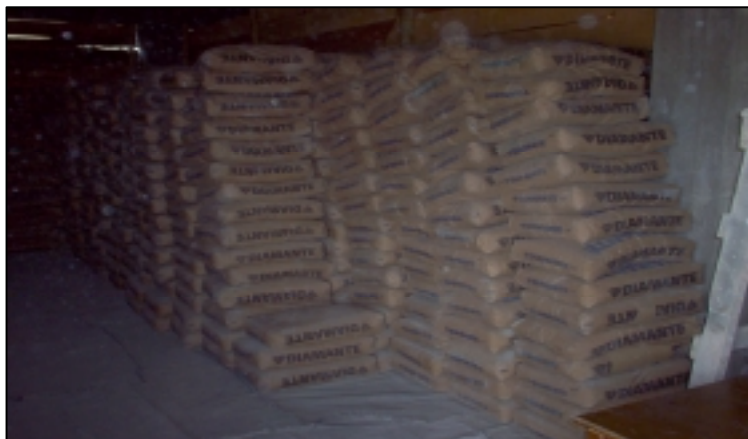
Figura 6. Almacenamiento del cemento.
