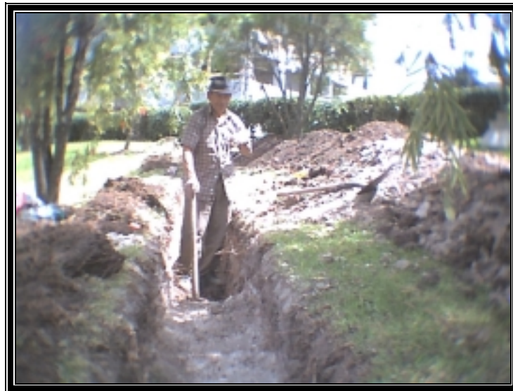
Figura 12. Excavación de chambas para instalación de tubería
