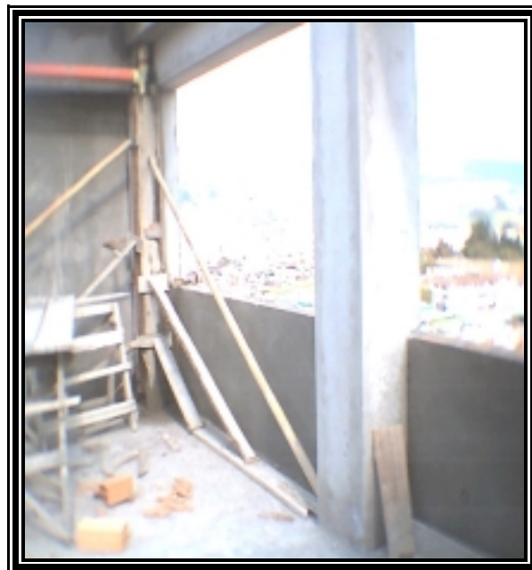
Figura 80. Formaleteo y fundición de bajantes.
