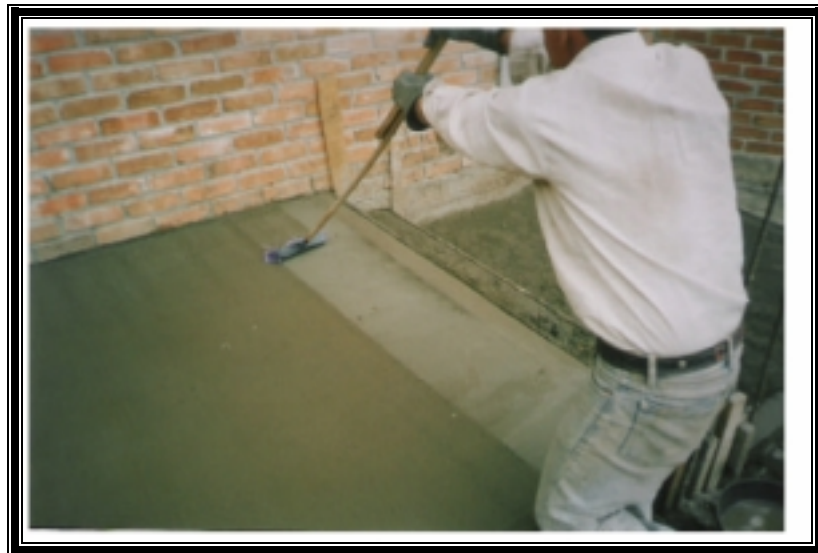
Figura 19. Escobillado.
