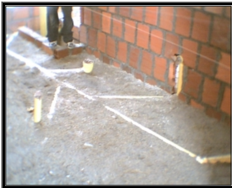
Figura 83. Relleno de sobrelosa.
