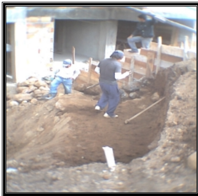
Figura 22. Perfilado de rampa.
