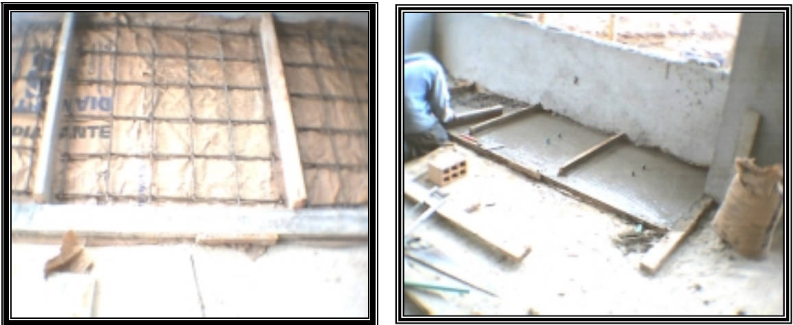
Figura 76. Figurado de hierro y fundición de tapa.
