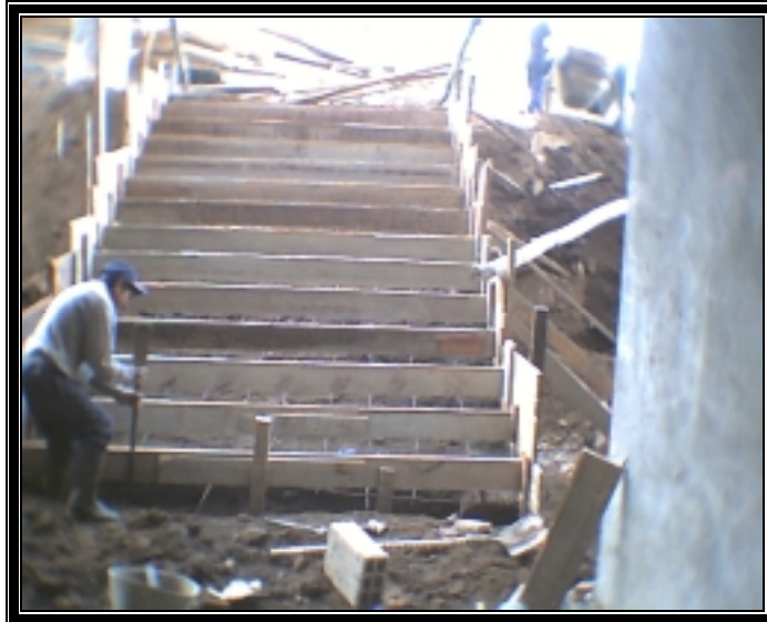
Figura 15. Encofrado de escaleras.
