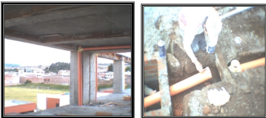
Figura 72. Instalación y Soldadura de tubería aguas lluvias.
