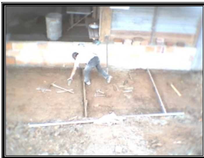
Figura 18. Encofrado de andén.
