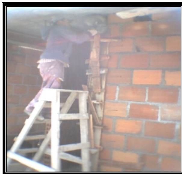
Figura 51. Fundición de columneta.
