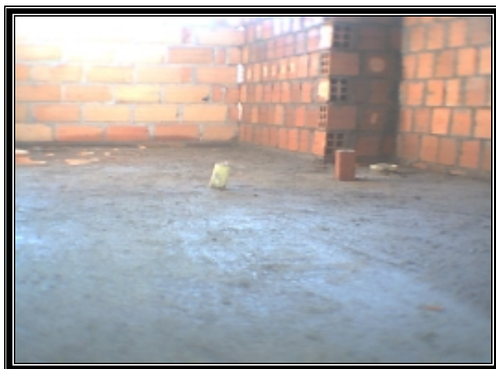
Figura 85. Fundición de sobrelosa.
