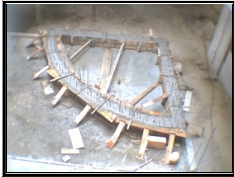
Figura 32. Fundición de fuente luminosa.
