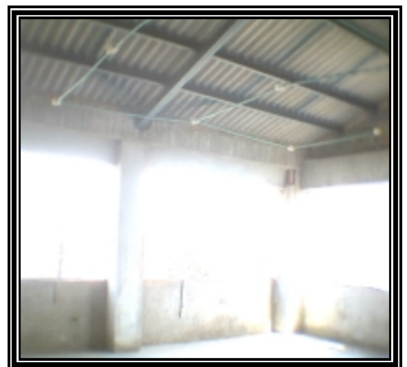
Figura 91. Instalación de cajas y ductos para lámparas.
