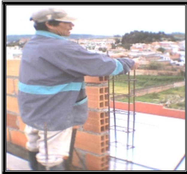
Figura 50. Armado de columneta.
